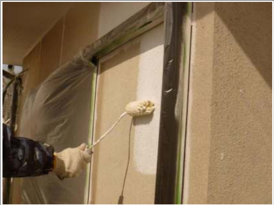
外壁塗装下塗り施工中
