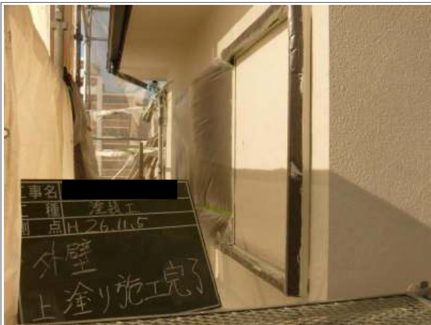
外壁塗装上塗り施工完了
