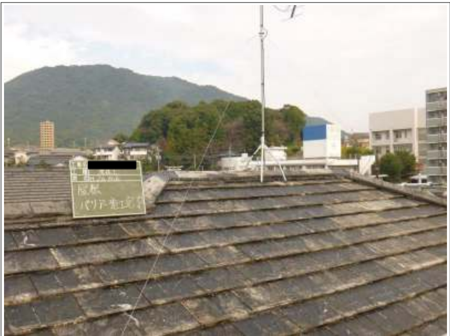
屋根バリアー施工完了
