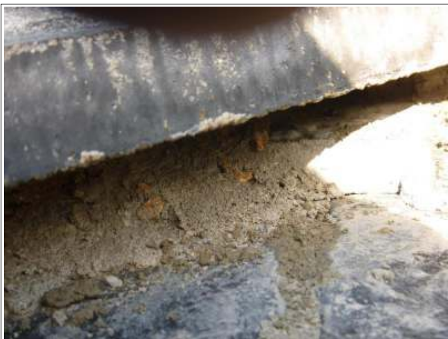
屋根瓦補修施工中
