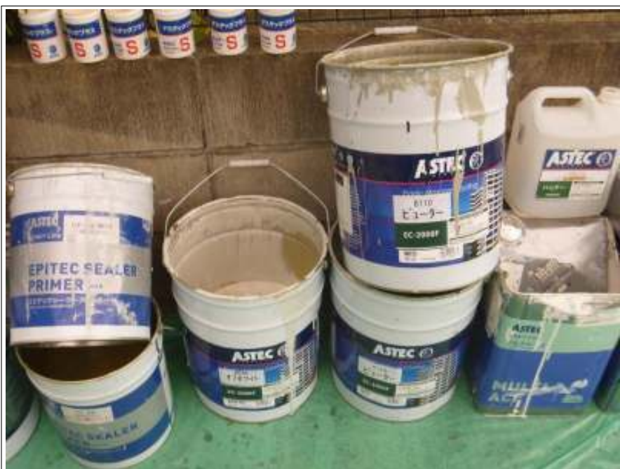
外壁上塗り使用材料空缶
