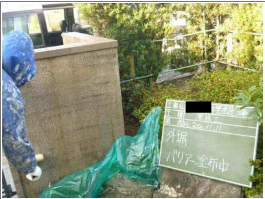
塀バリアー施工中
