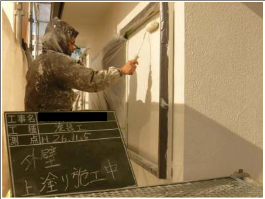
外壁塗装上塗り施工中
