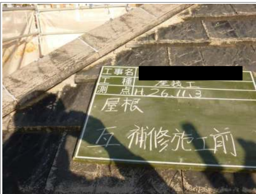
屋根瓦補修施工前
