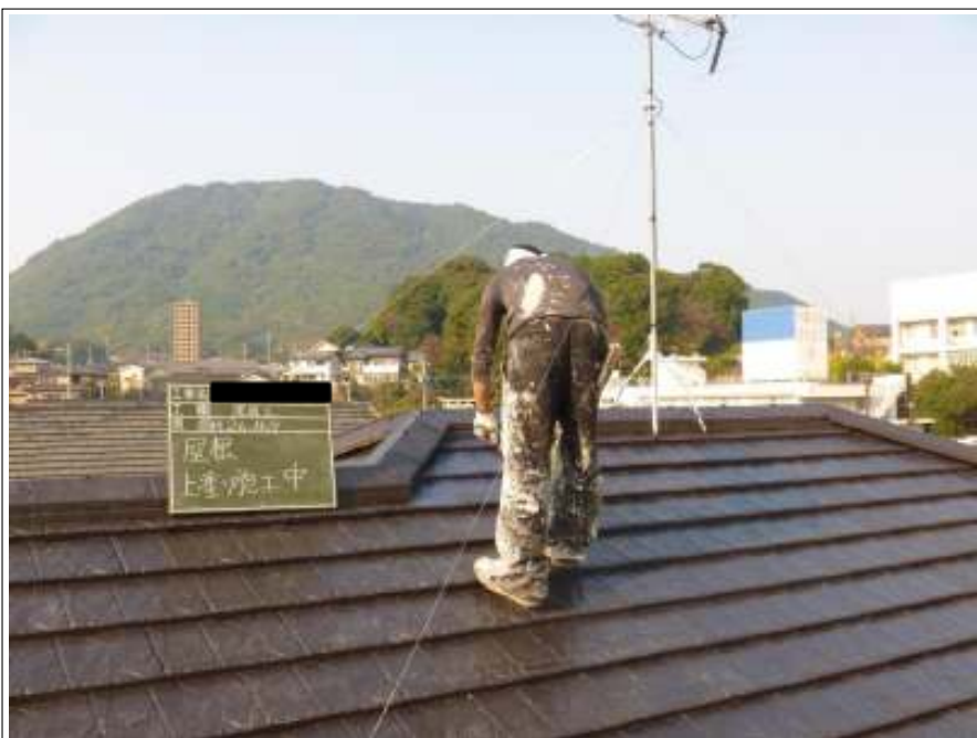
屋根塗装上塗り施工中
