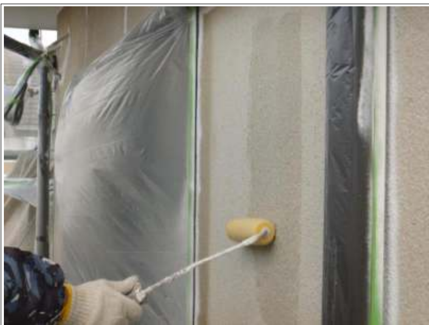
外壁バリアー施工中
