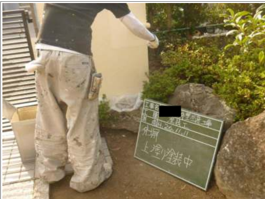
塀塗装上塗り施工中
