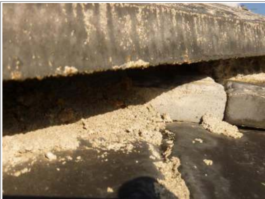
屋根瓦補修施工前
