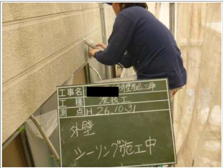
外壁シーリング補修施工中
