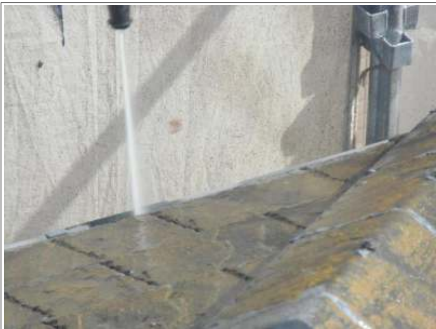
樋高压洗净施工中
