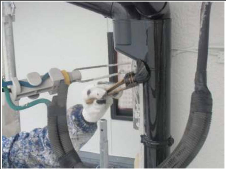
樋塗装施工中
