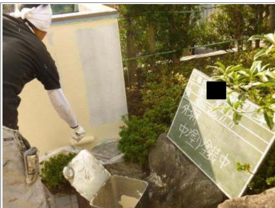
塀塗装中塗り施工中
