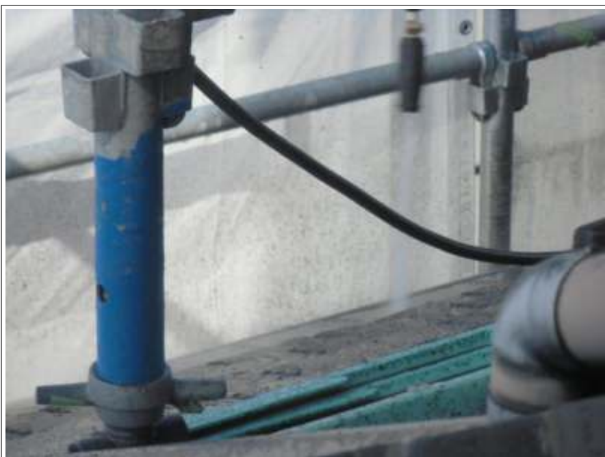
樋高压洗净施工中
