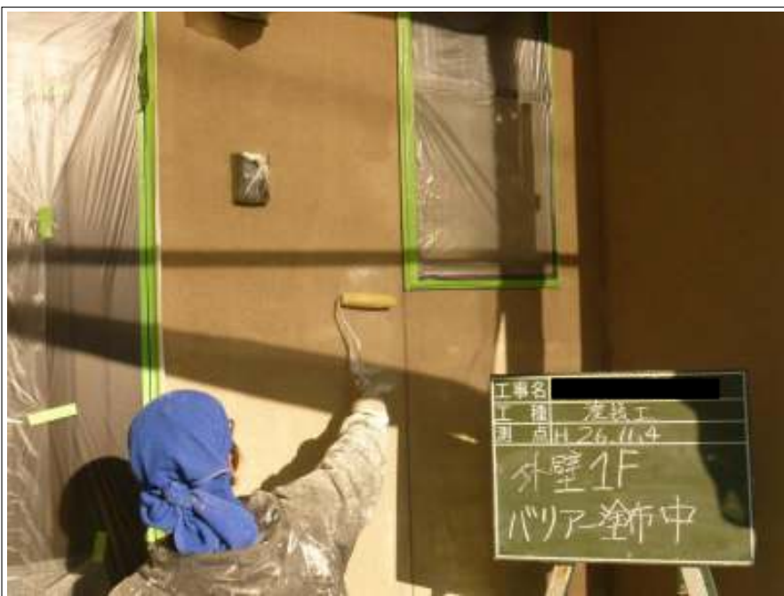
外壁バリアー施工中
