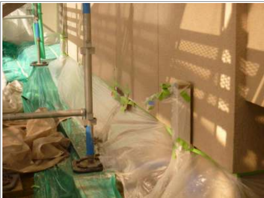
外壁補修施工完了
