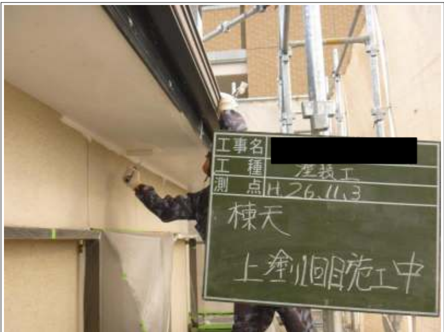
軒天塗装 1 回目施工中
