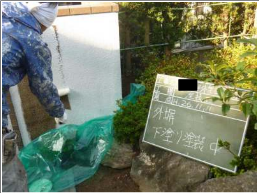
塀塗装下塗り施工中
