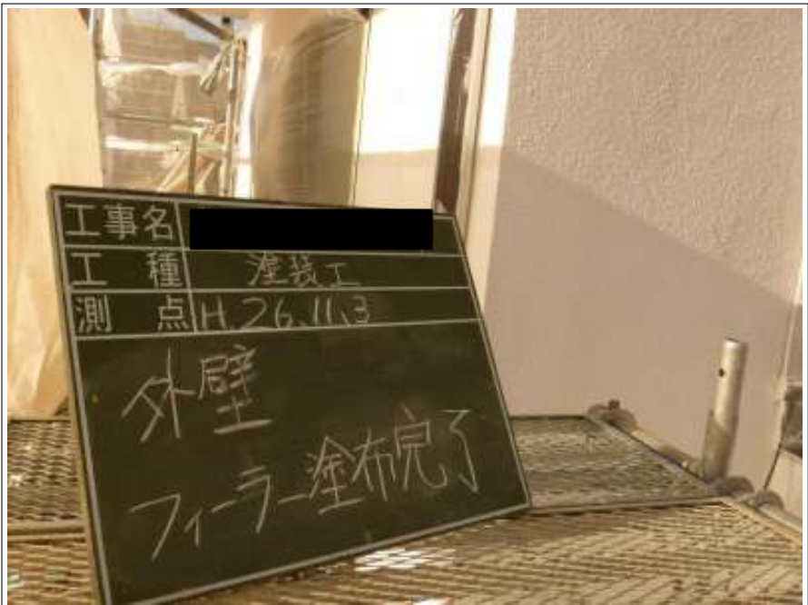
外壁塗装下塗り施工完了
