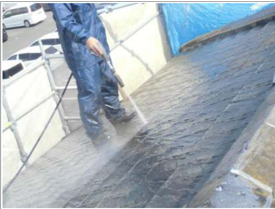
屋根高压洗净施工中
