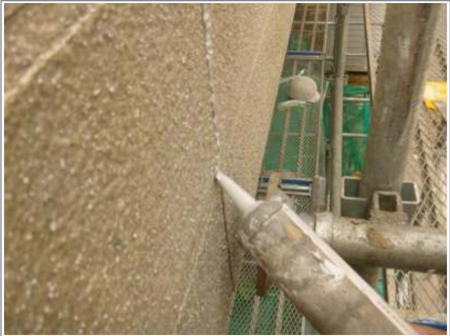
外壁シーリング補修施工中
