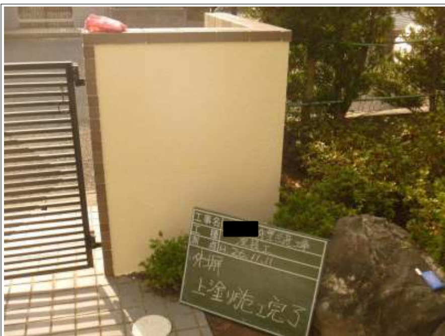
塀塗装上塗り施工完了
