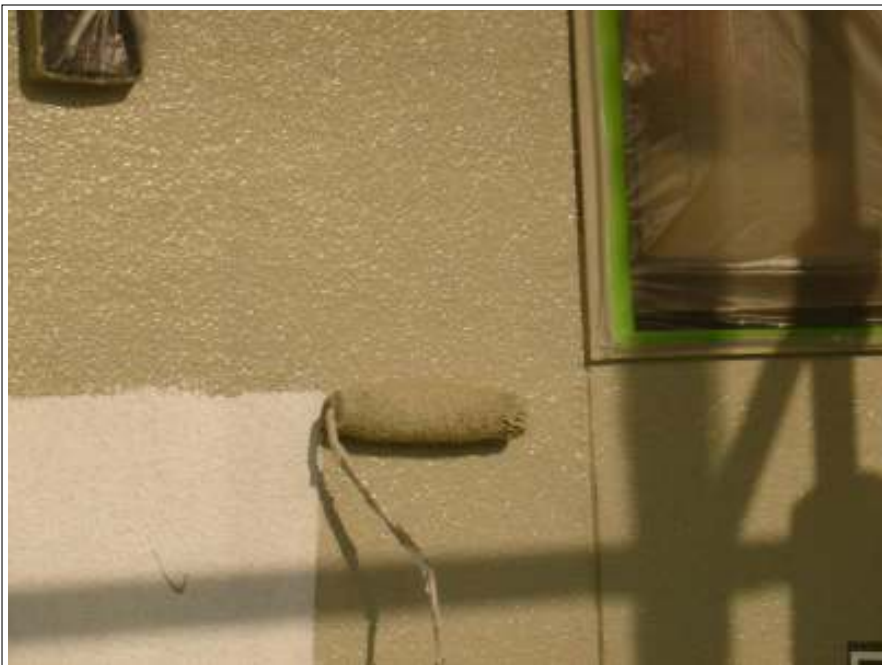
外壁塗装中塗り施工中
