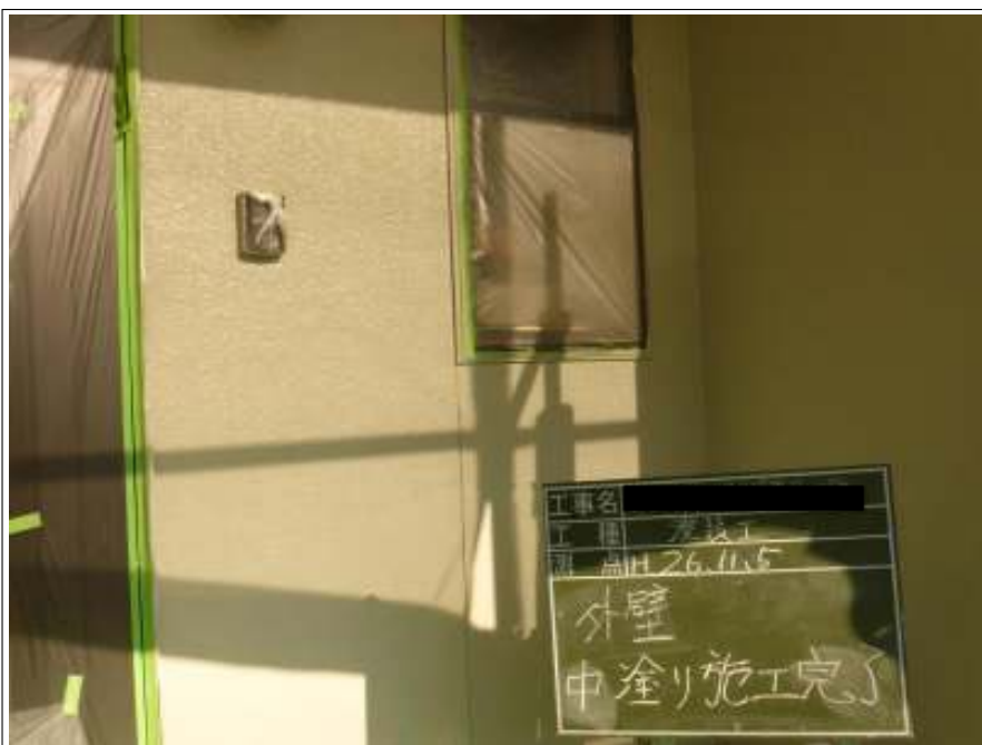
外壁塗装中塗り施工完了
