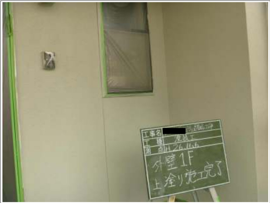
外壁塗装上塗り施工完了
