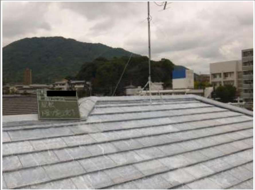
屋根塗装下塗り施工完了
