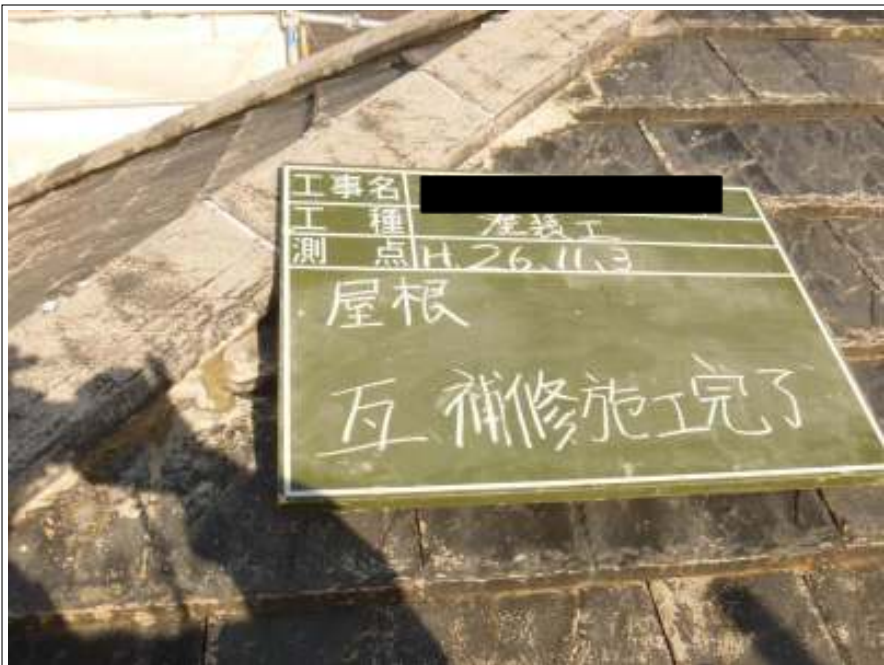
屋根瓦補修施工完了
