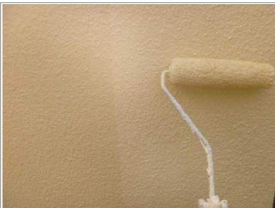
塀塗装上塗り施工中
