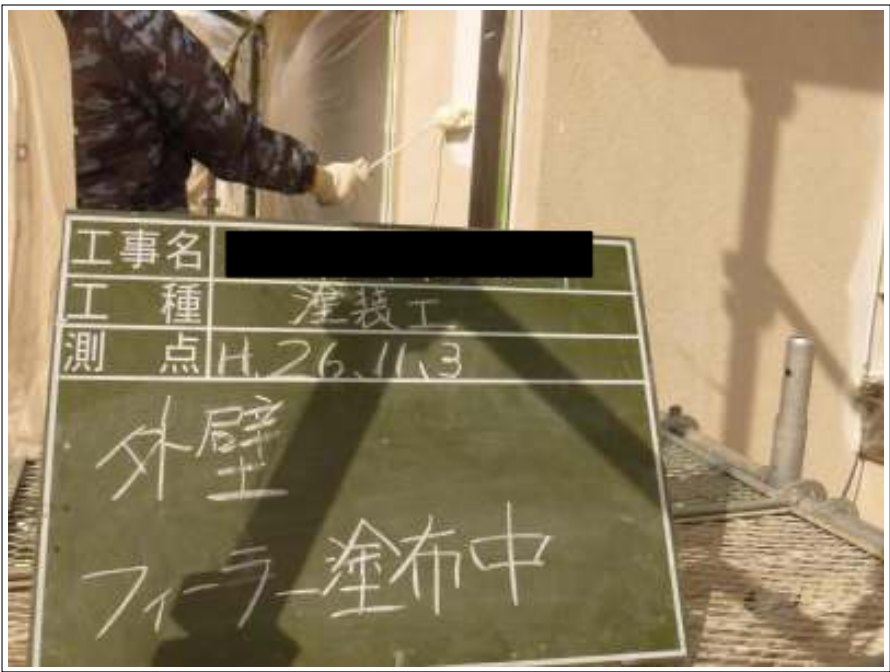
外壁塗装下塗り施工中
