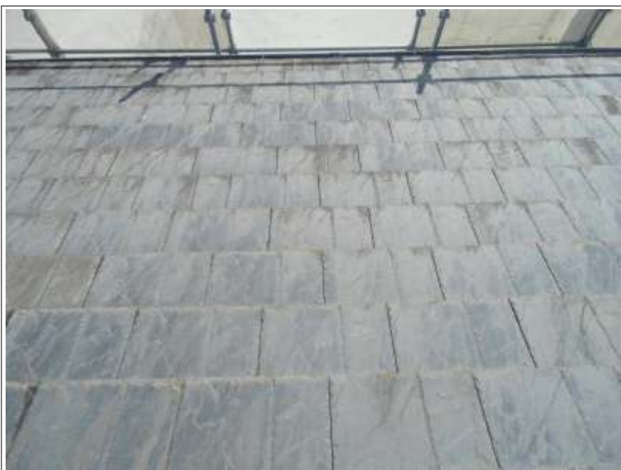
屋根高压洗净施工完了
