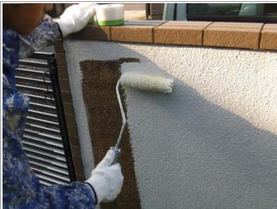
塀塗装下塗り施工中
