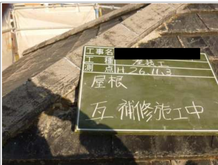
屋根瓦補修施工中
