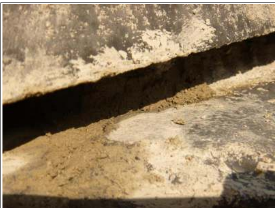
屋根瓦補修施工完了
