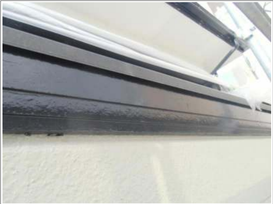
帯塗装施工完了
