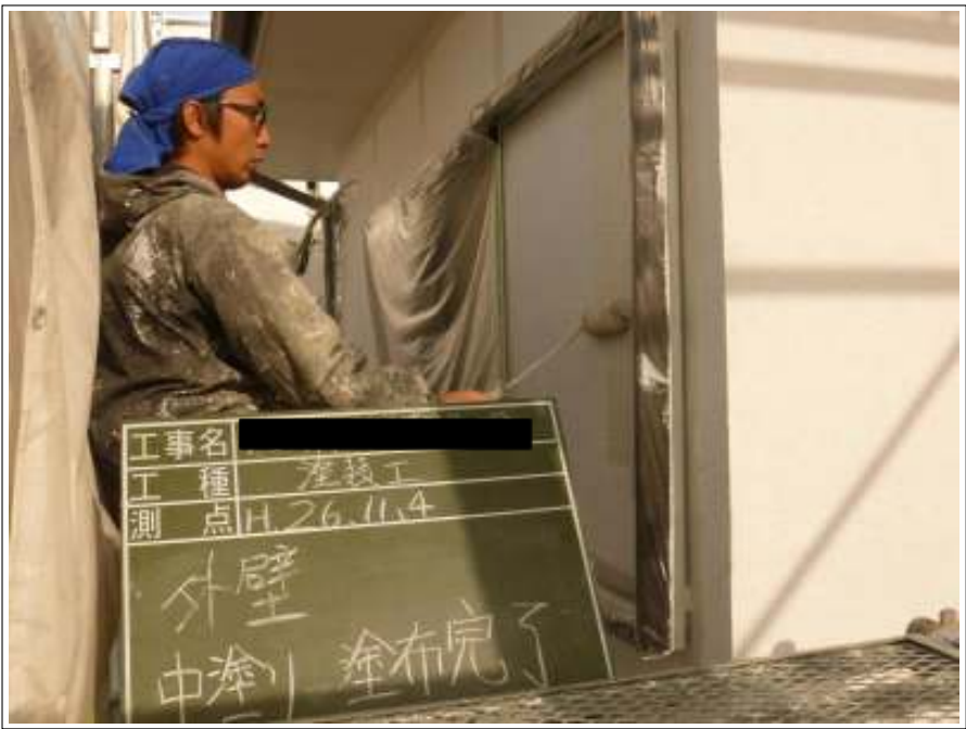
外壁塗装中塗り施工中
