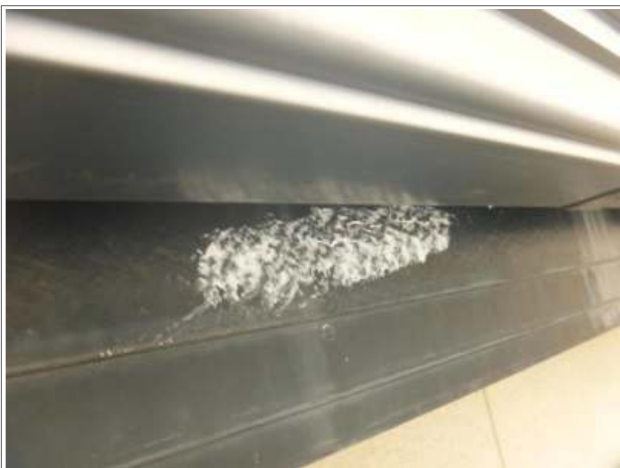
破風板パテ施工完了
