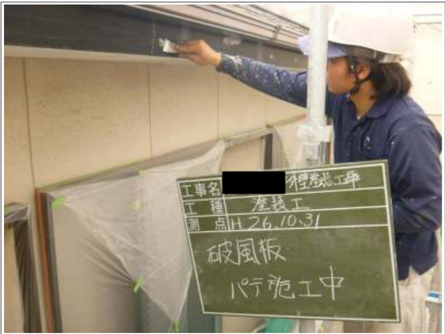
破風板パテ施工中
