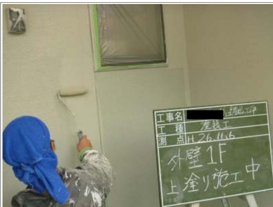
外壁塗装上塗り施工中
