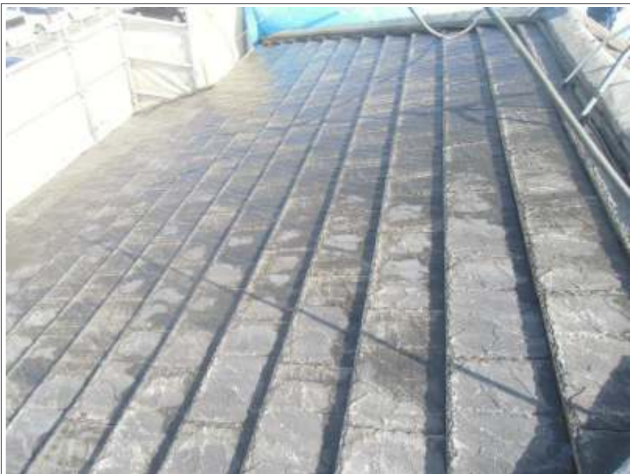
屋根高压洗净施工完了
