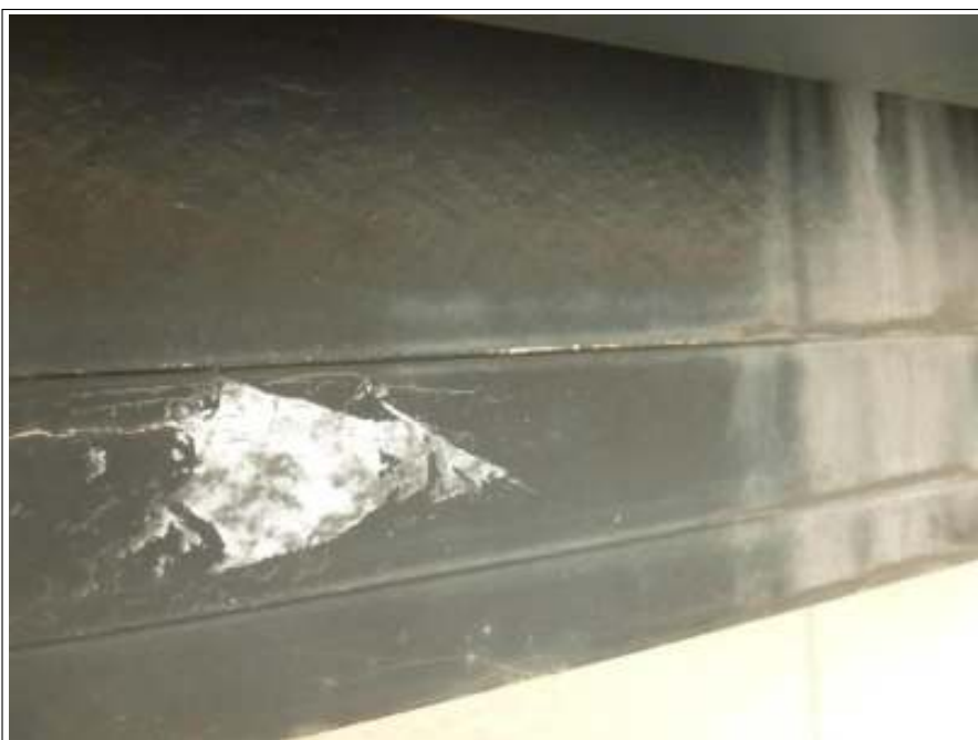
破風板パテ施工完了
