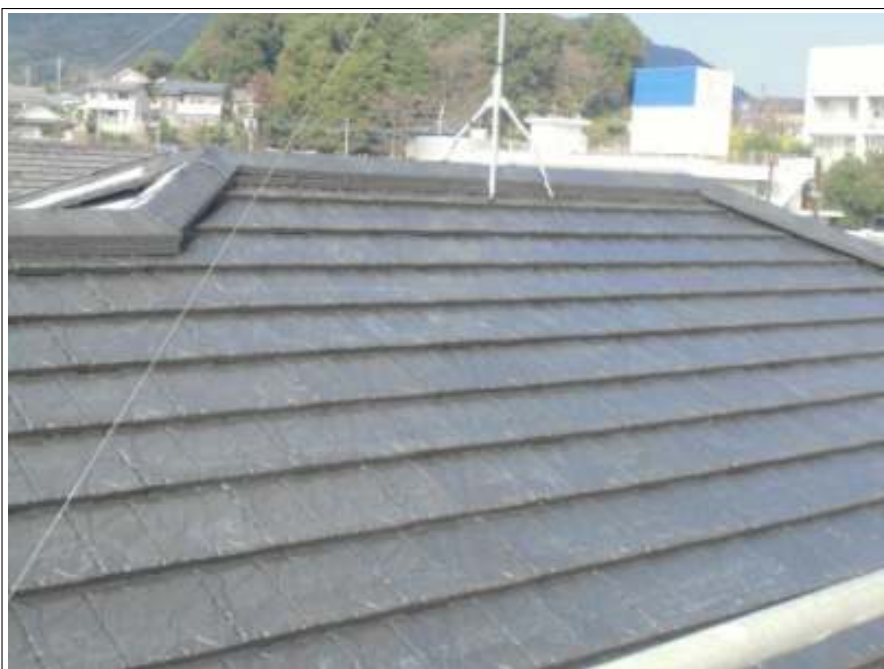
屋根塗装中塗り施工完了
