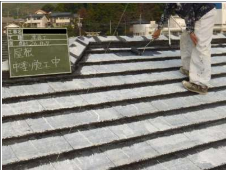
屋根塗装中塗り施工中
