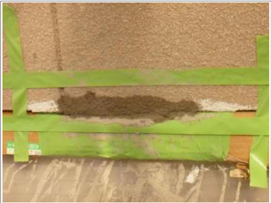
外壁補修施工完了
