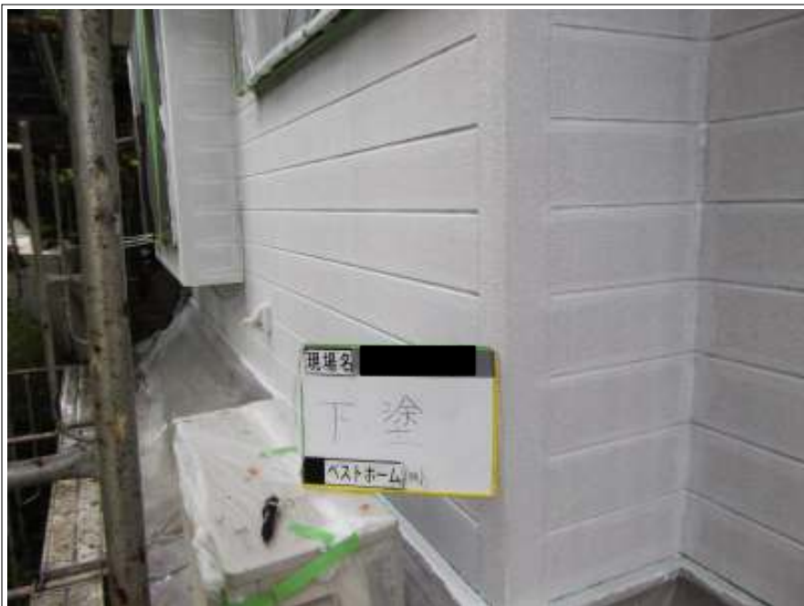
外壁下塗り施工完了
