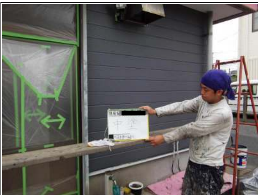
外壁中塗り施工完了
