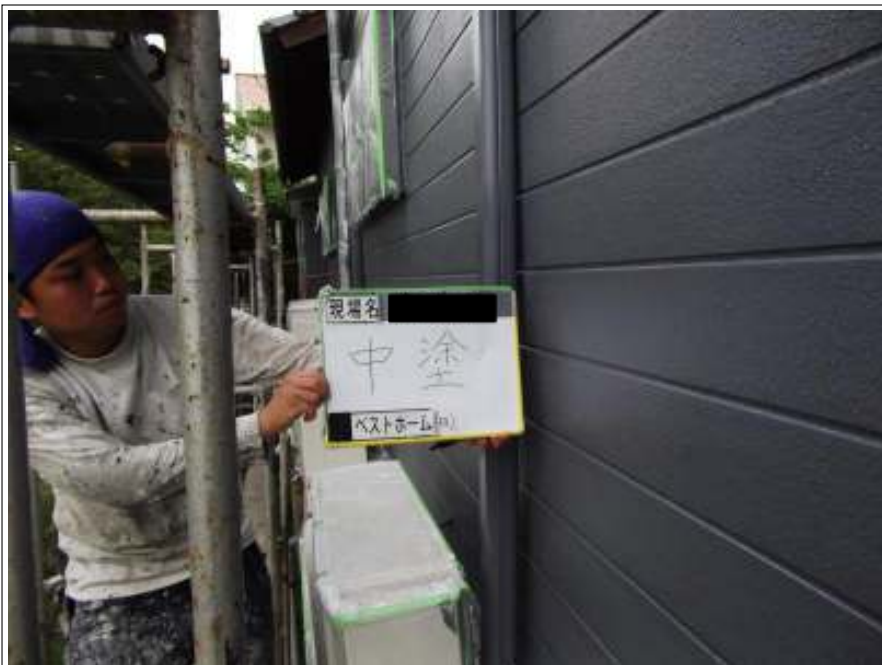
外壁中塗り施工完了
