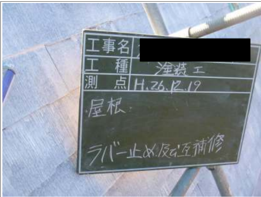
屋根ラバー止め・瓦補修施工中
