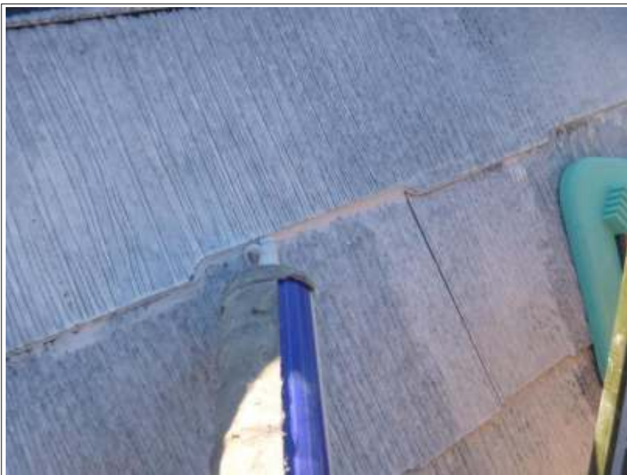
ラバー止め施工中
