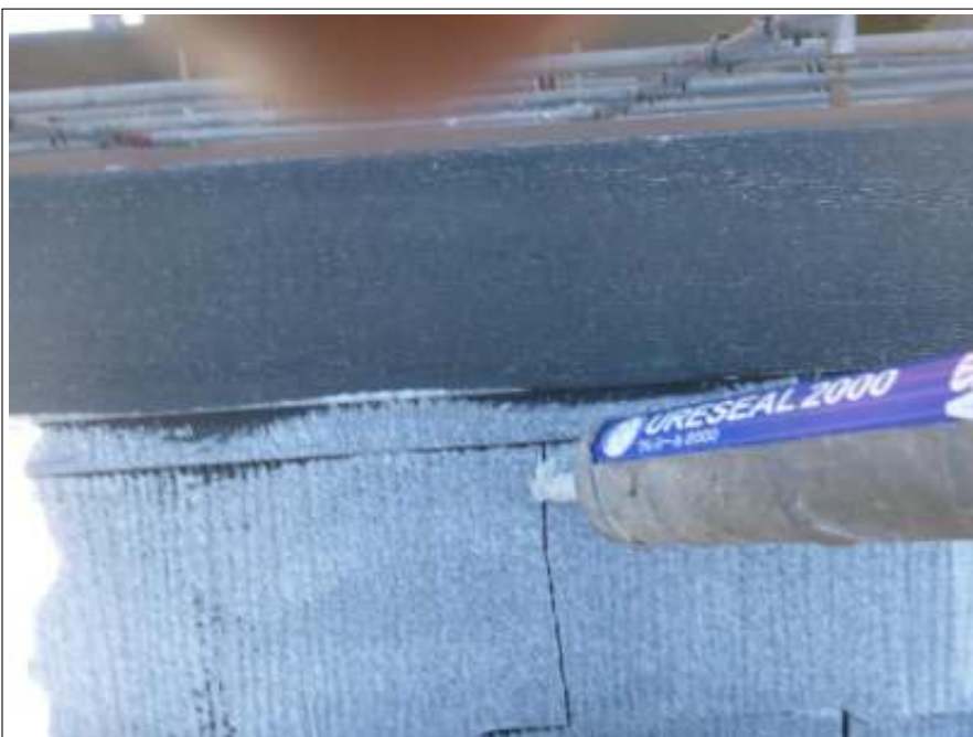
ラバー止め施工中
