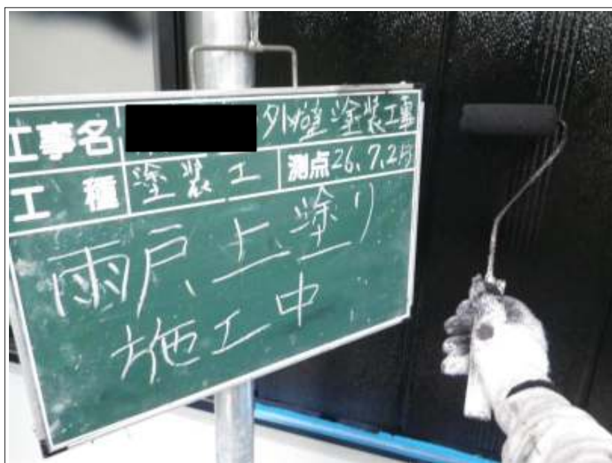
雨戸塗装上塗り施工中
