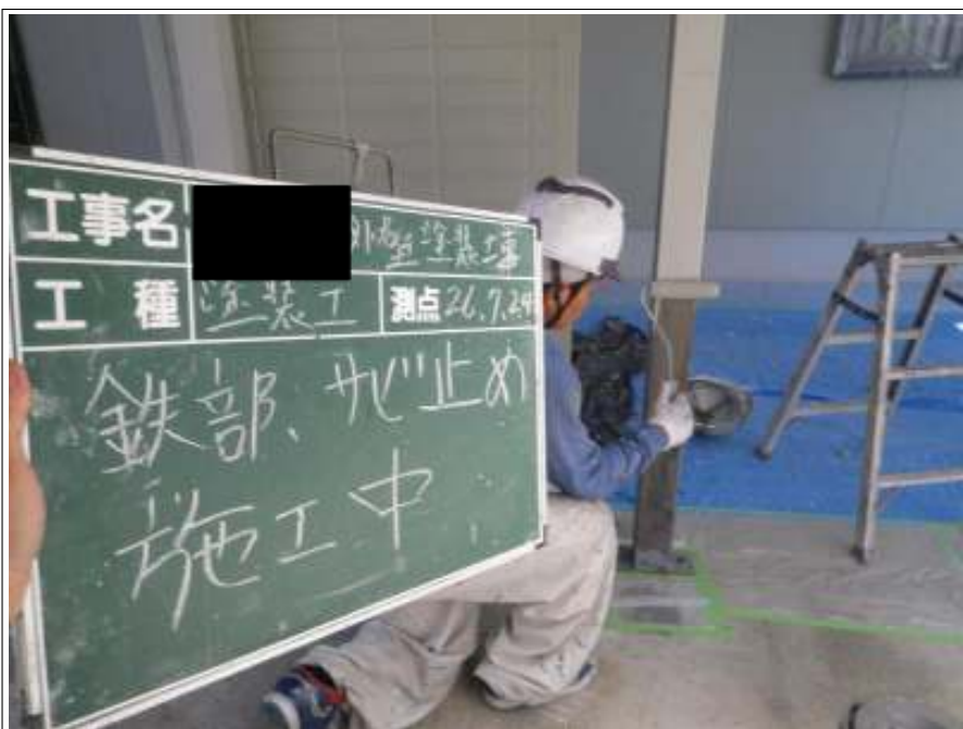
鉄部塗装下塗り施工中
