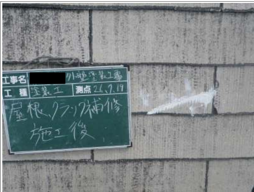
屋根クラック補修施工完了
