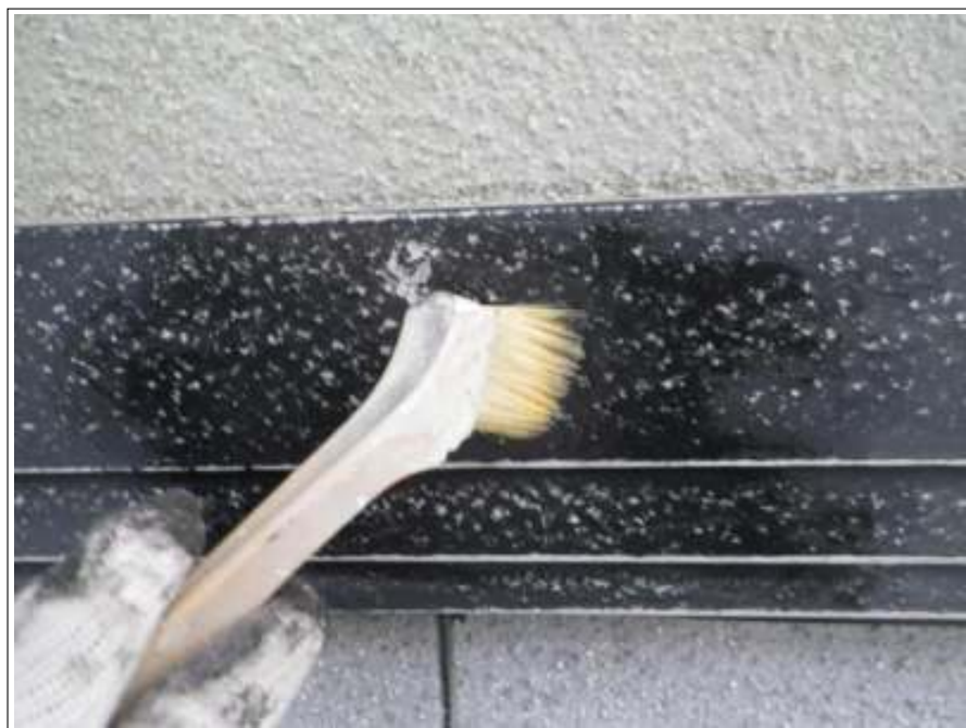
胴差し塗装下塗り施工中
