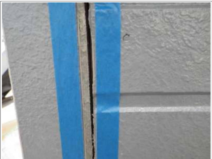
外壁シーリング除去施工完了
