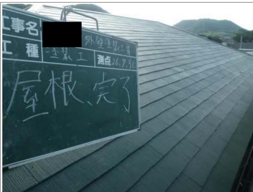
屋根塗装上塗り施工完了
