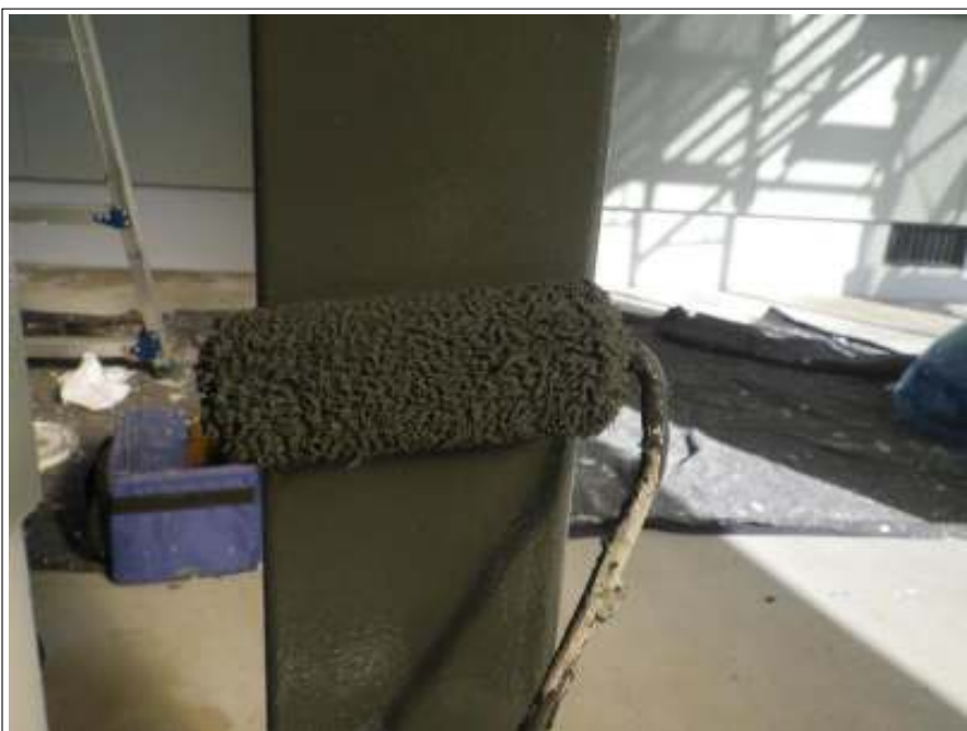
鉄部塗装上塗り施工中
