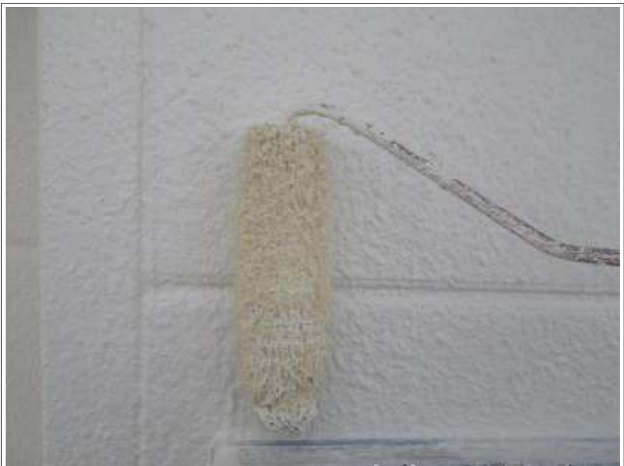
外壁塗装上塗り施工中
