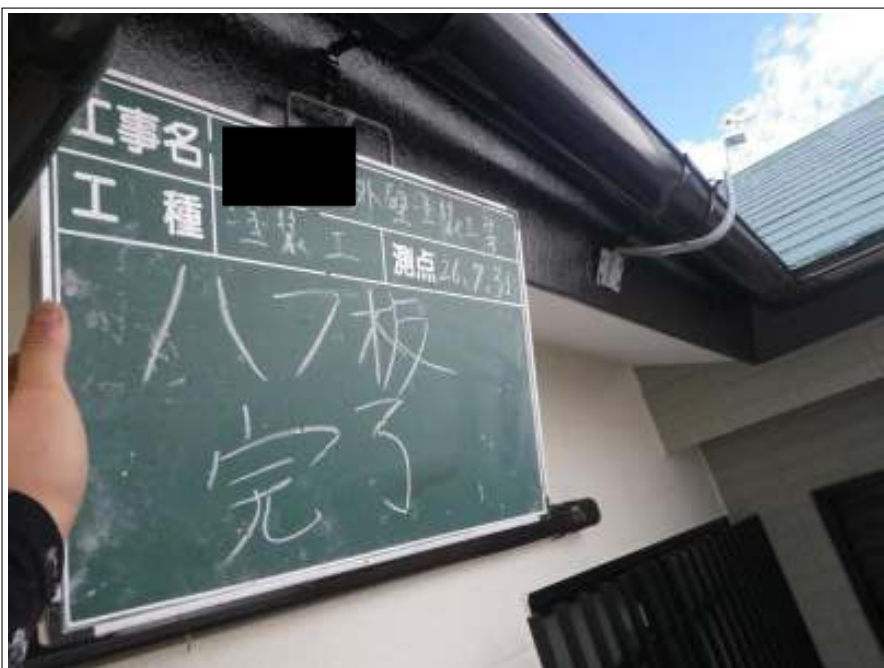
破風板塗装施工完了
