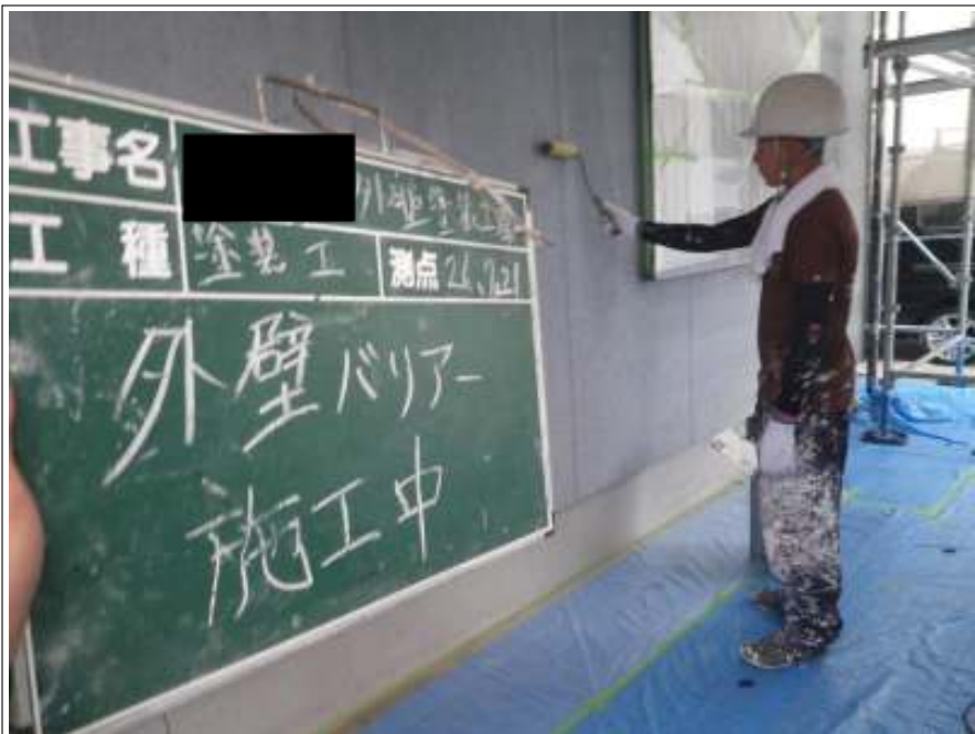
外壁塗装バリアー施工中
