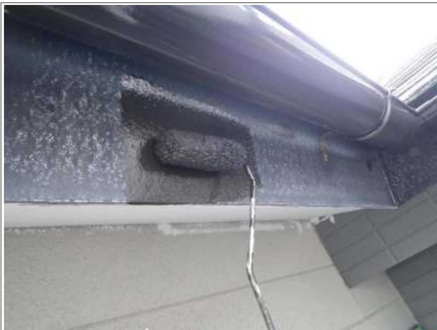
破風板塗装施工中
