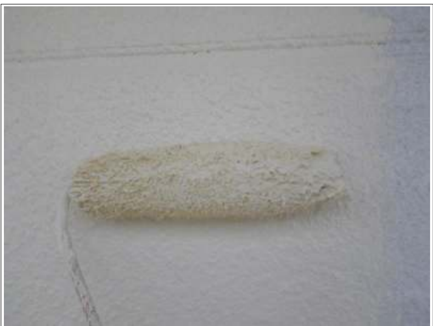
外壁塗装中塗り施工中
