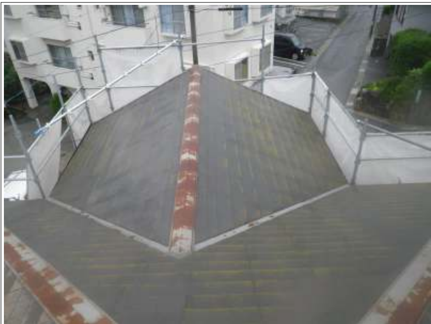
屋根高压洗净施工完了
