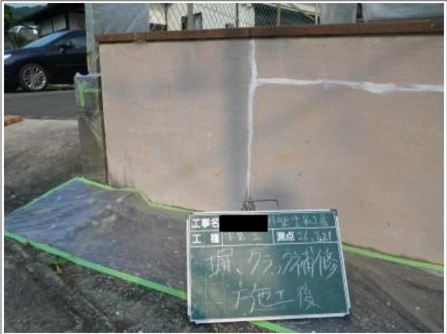
塀クラック補修施工完了
