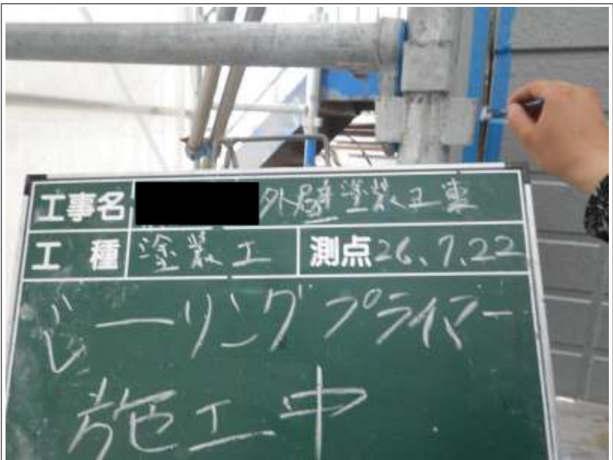
外壁シーリングプライマー施工中
