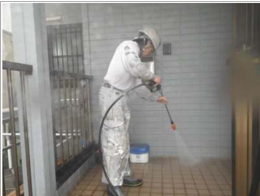
高压洗净施工中
