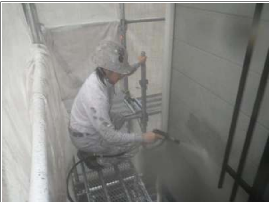
外壁高圧洗浄施工中
