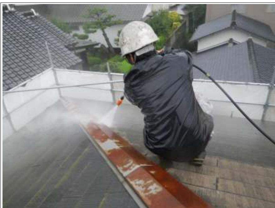
棟鉄板高圧洗浄施工中
