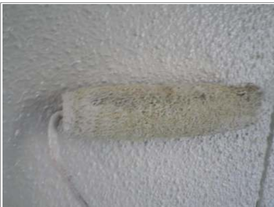
外壁塗装上塗り施工中
