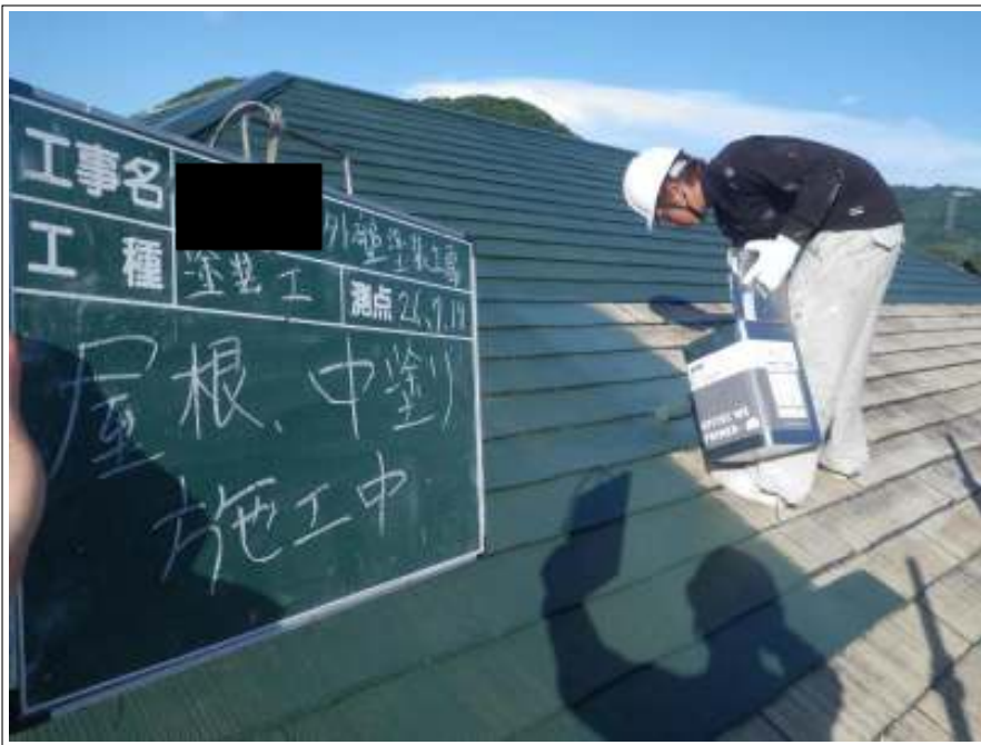
屋根塗装中塗り施工中
