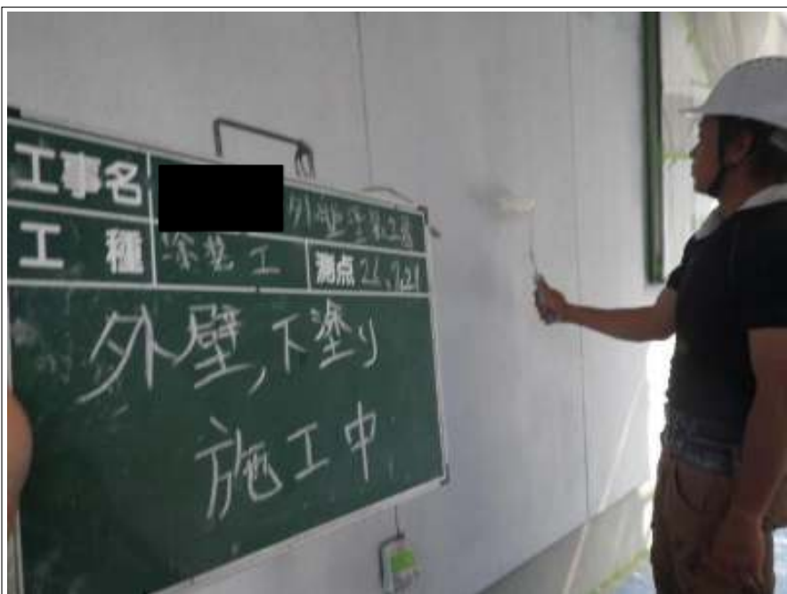
外壁塗装下塗り施工中
