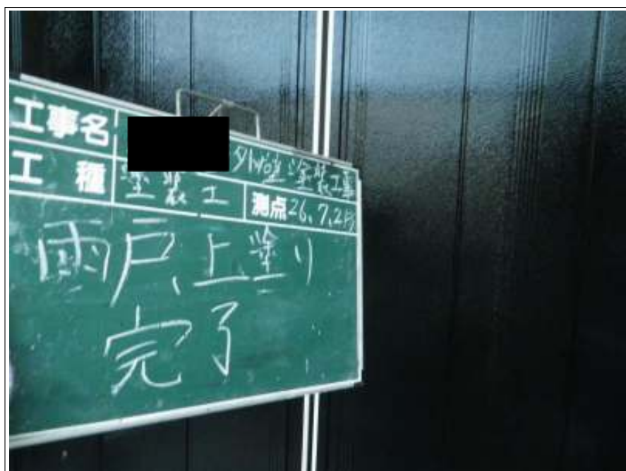
雨戸塗装施工完了
