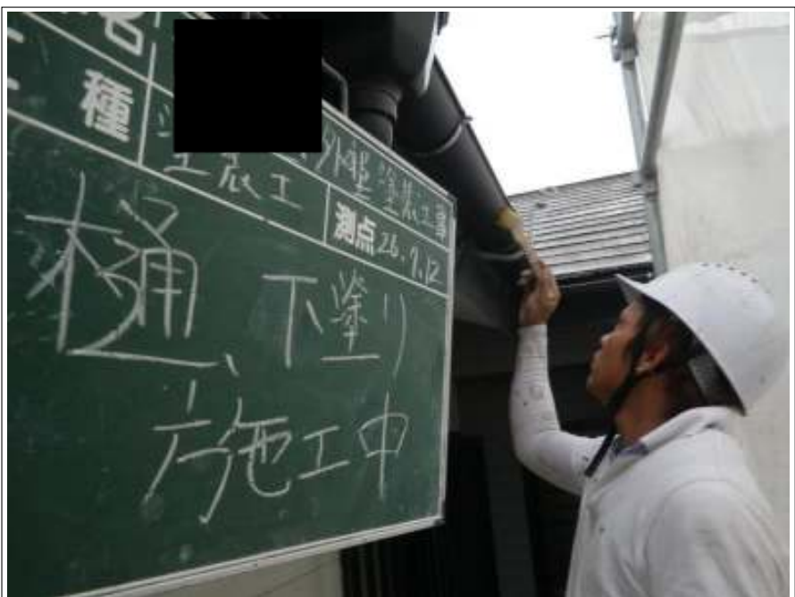
樋塗装施工中
