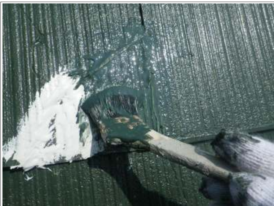
屋根クラック補修施工中
