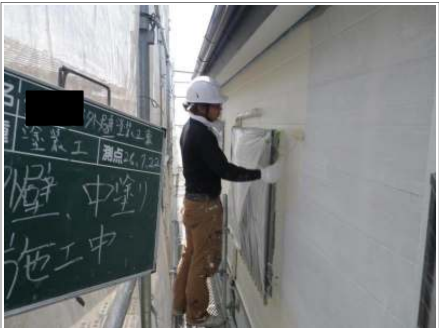
外壁塗装中塗り施工中
