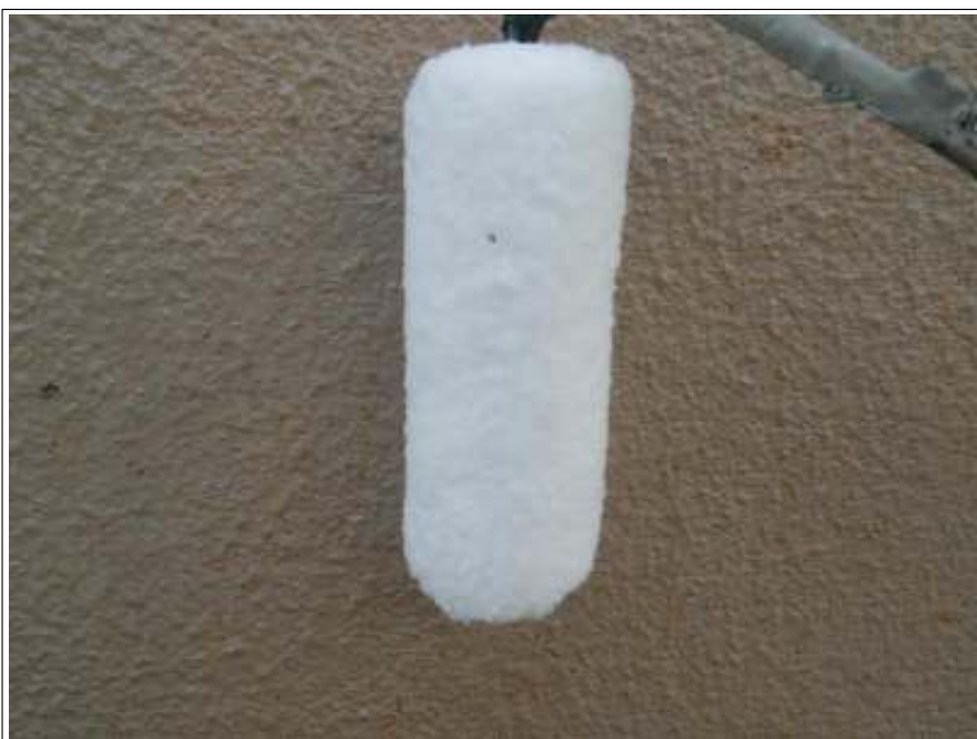
塙塗装 1 回目施工中
