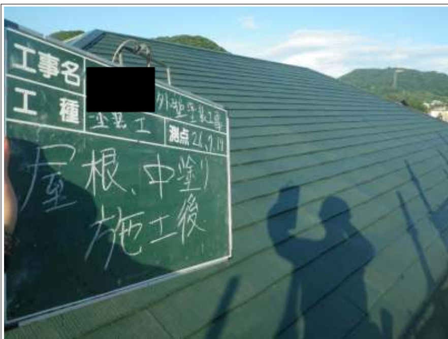
屋根塗装中塗り施工完了
