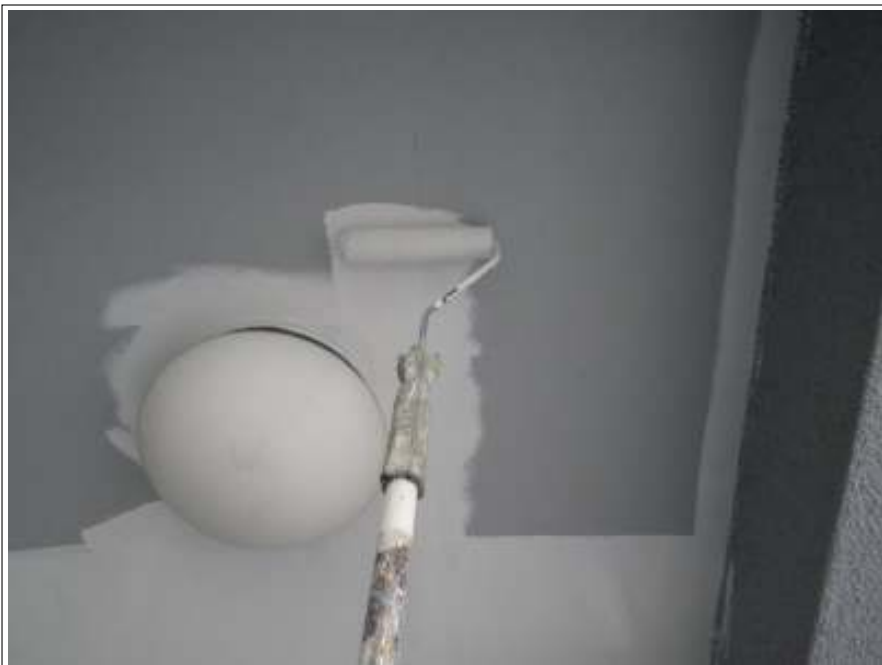
軒天塗装下塗り施工中
