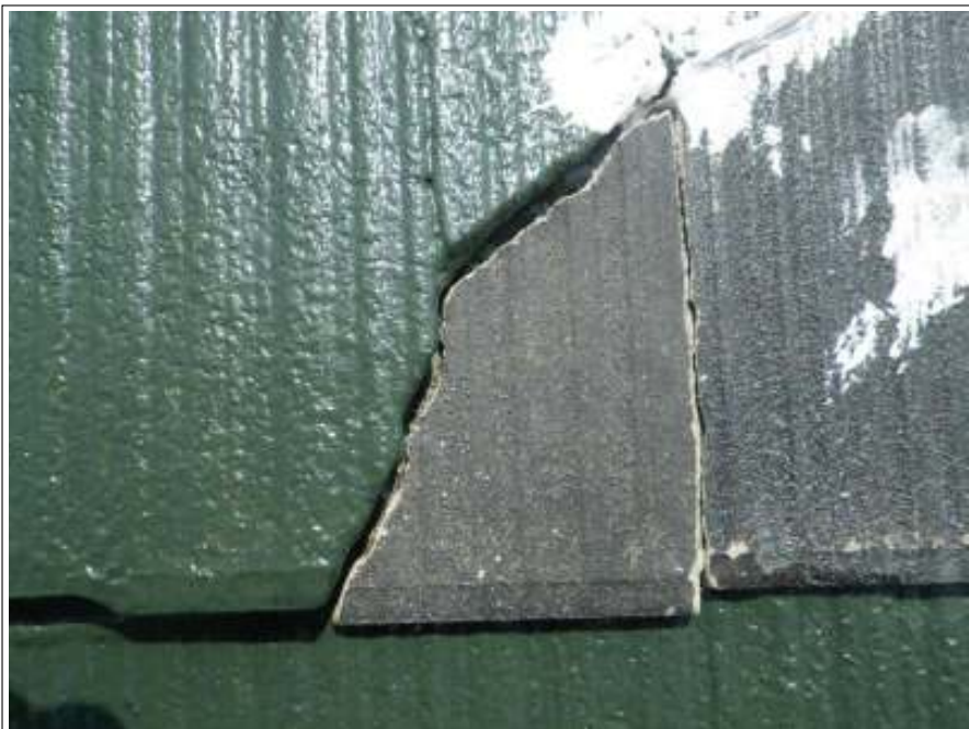
屋根クラック補修施工中
