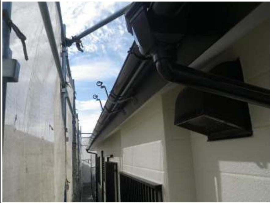
樋塗装施工完了
