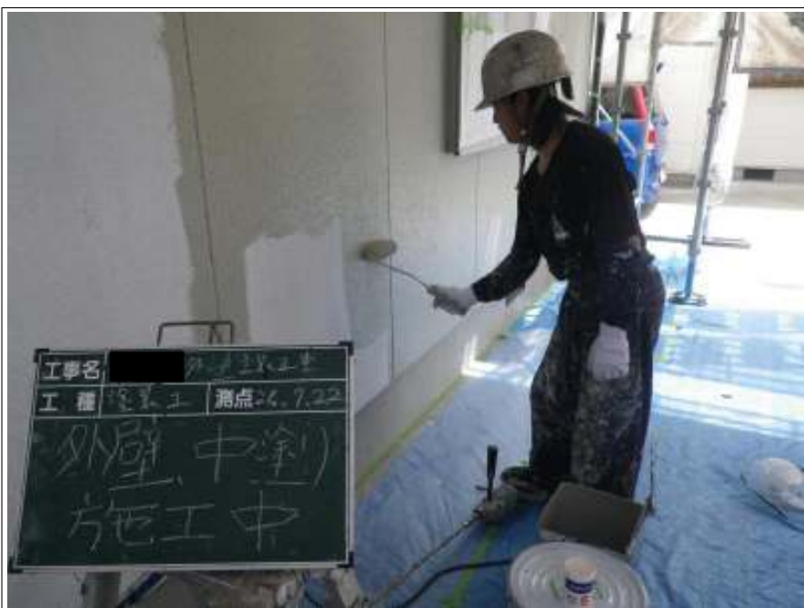
外壁塗装中塗り施工中
