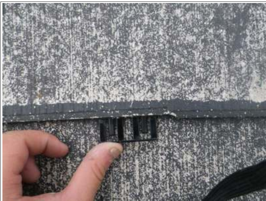
屋根タスペーサー施工中
