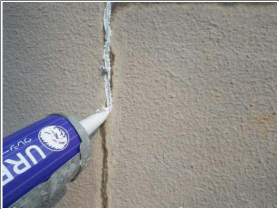
塀クラック補修施工中
