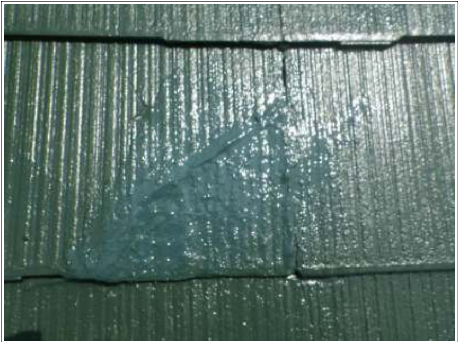
屋根クラック補修施工完了
