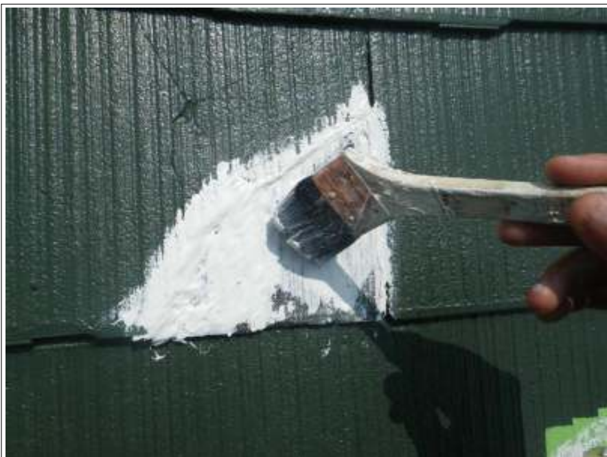
屋根クラック補修施工中
