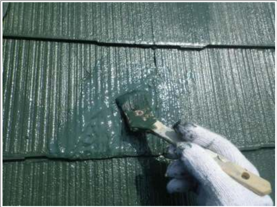
屋根クラック補修施工中
