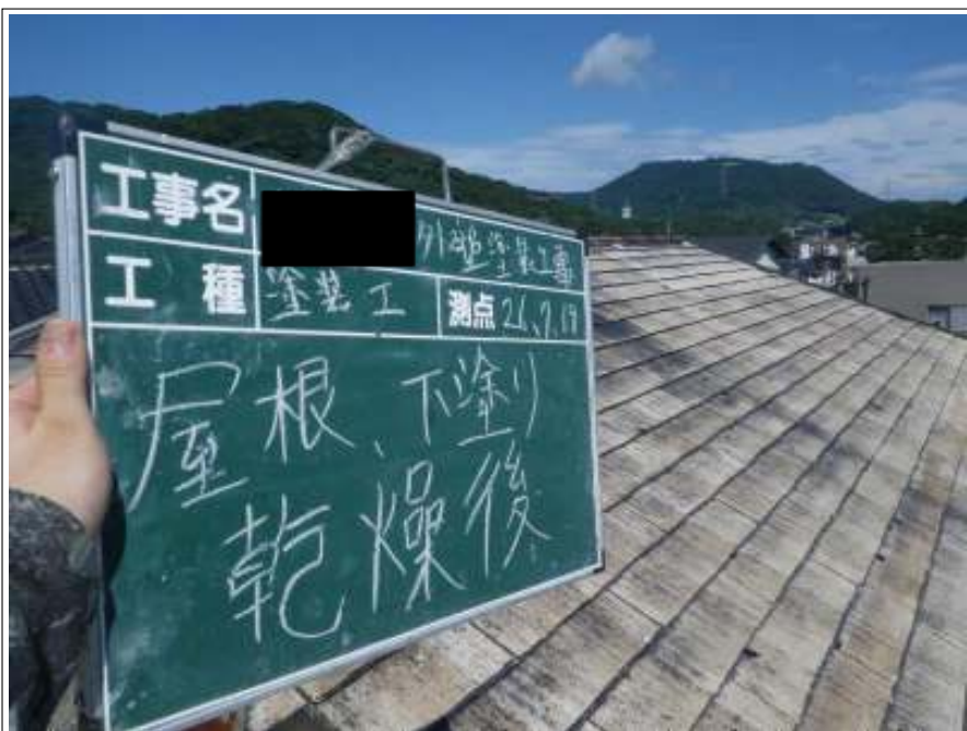
屋根塗装下塗り施工完了
