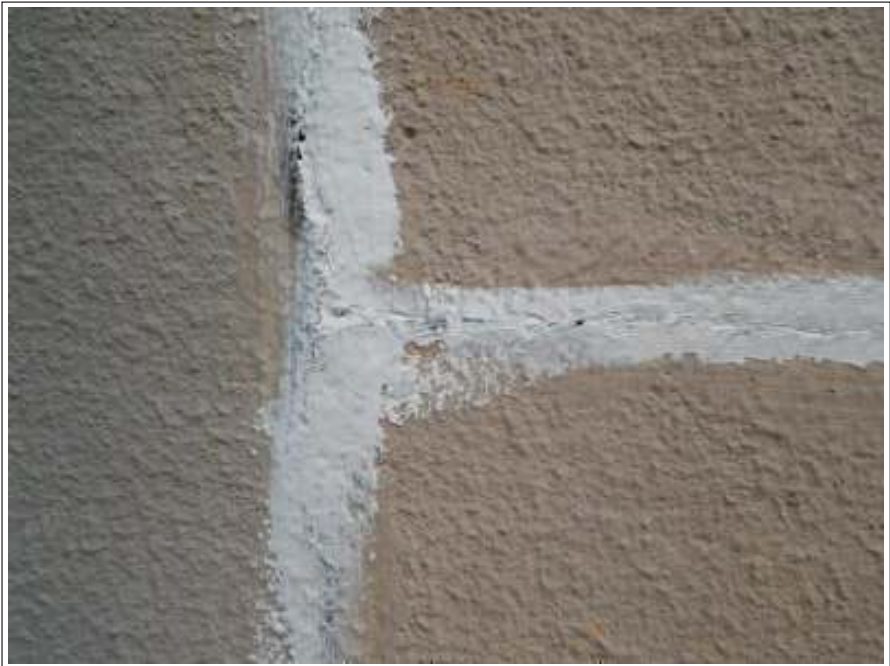
塀クラック補修施工完了
