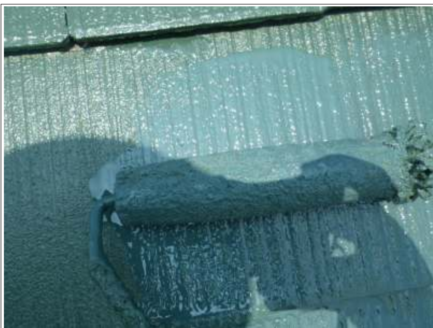
屋根塗装上塗り施工中
