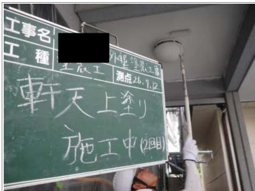
軒天塗装上塗り 2 回目施工中
