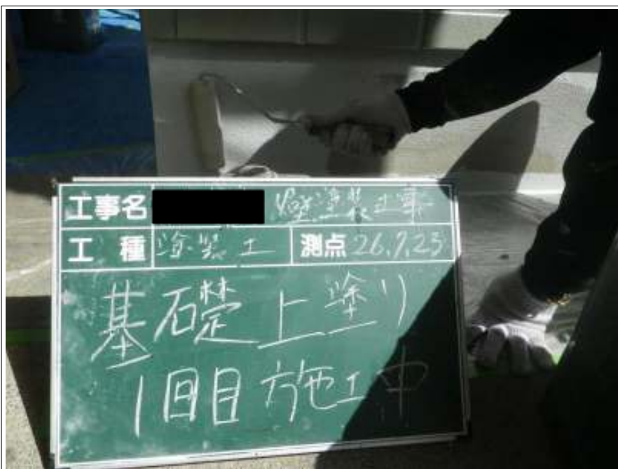
基礎塗装 1 回目施工中
