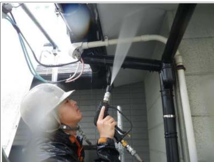
軒天高压洗净施工中
