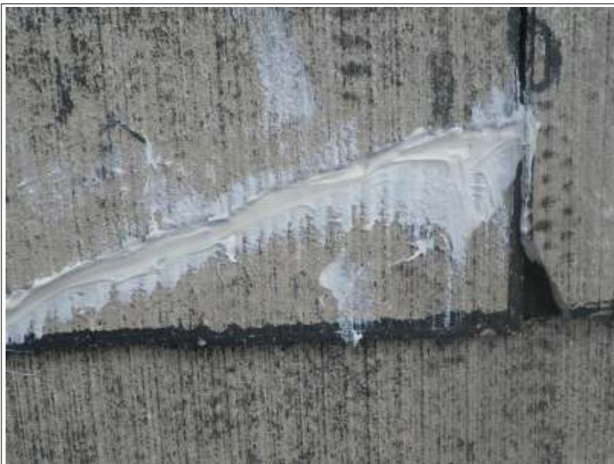
屋根クラック補修施工中
