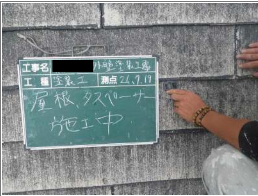
屋根タスペーサー施工中
