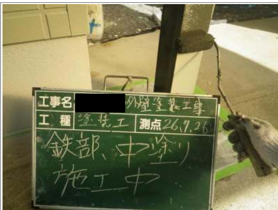
鉄部塗装中塗り施工中
