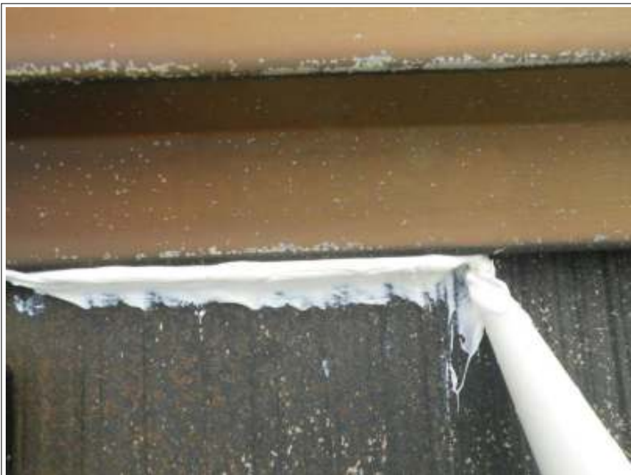
屋根棟鉄板ラバー止め施工中
