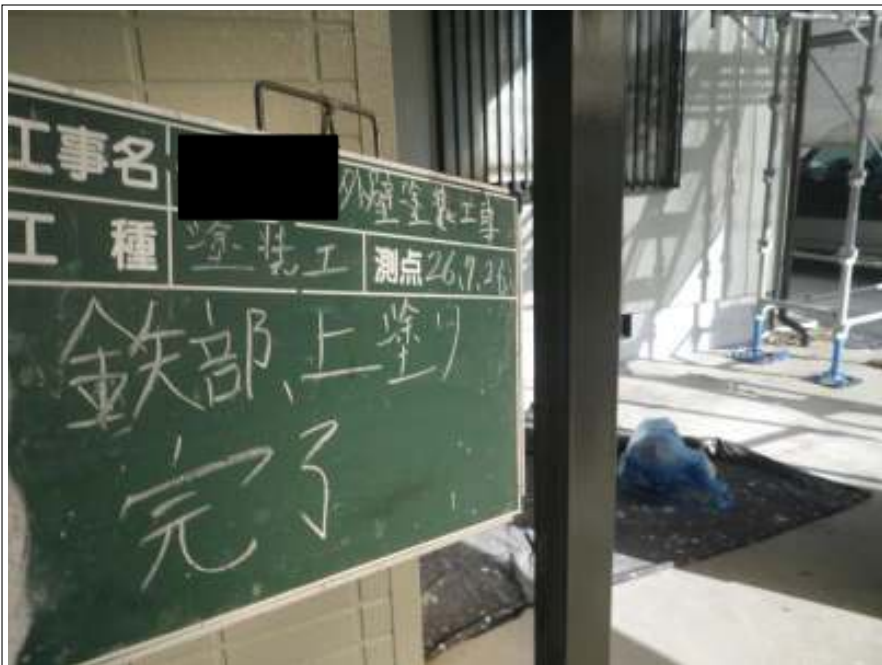
鉄部塗装上塗り施工完了
