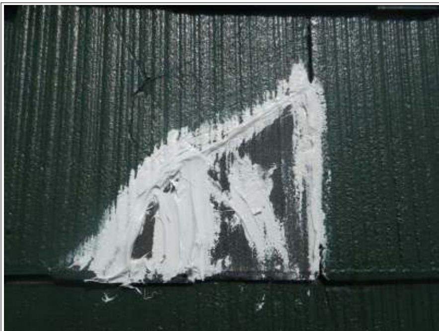
屋根クラック補修施工中
