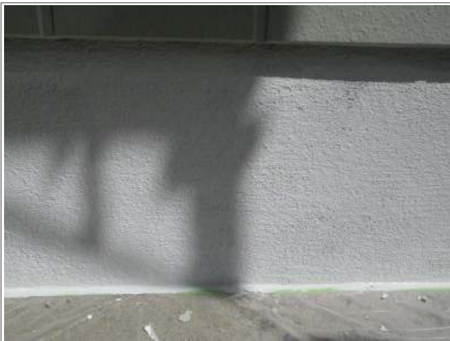
基礎塗装 1回目施工完了
