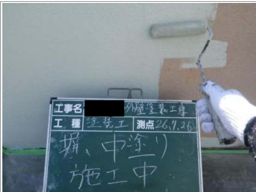
塀塗装2回目施工中
