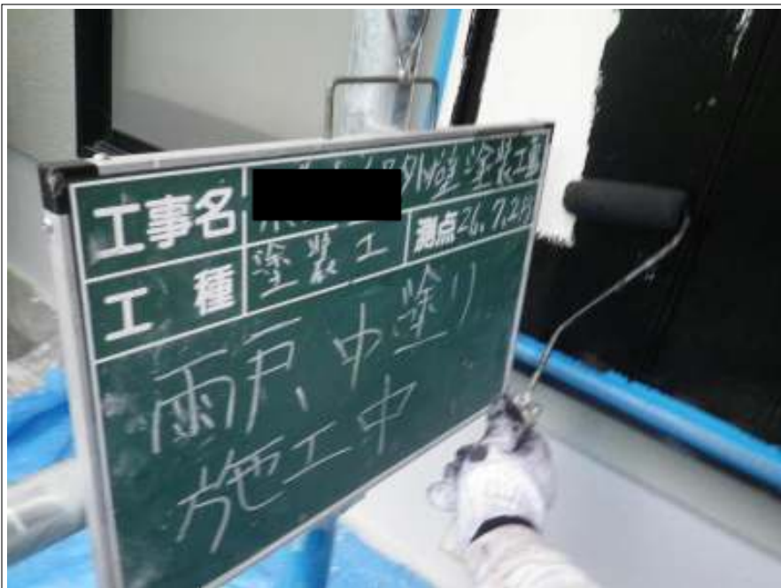
雨戸塗装中塗り施工中
