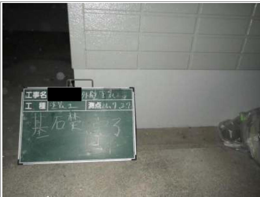
基礎塗装 2回目施工完了
