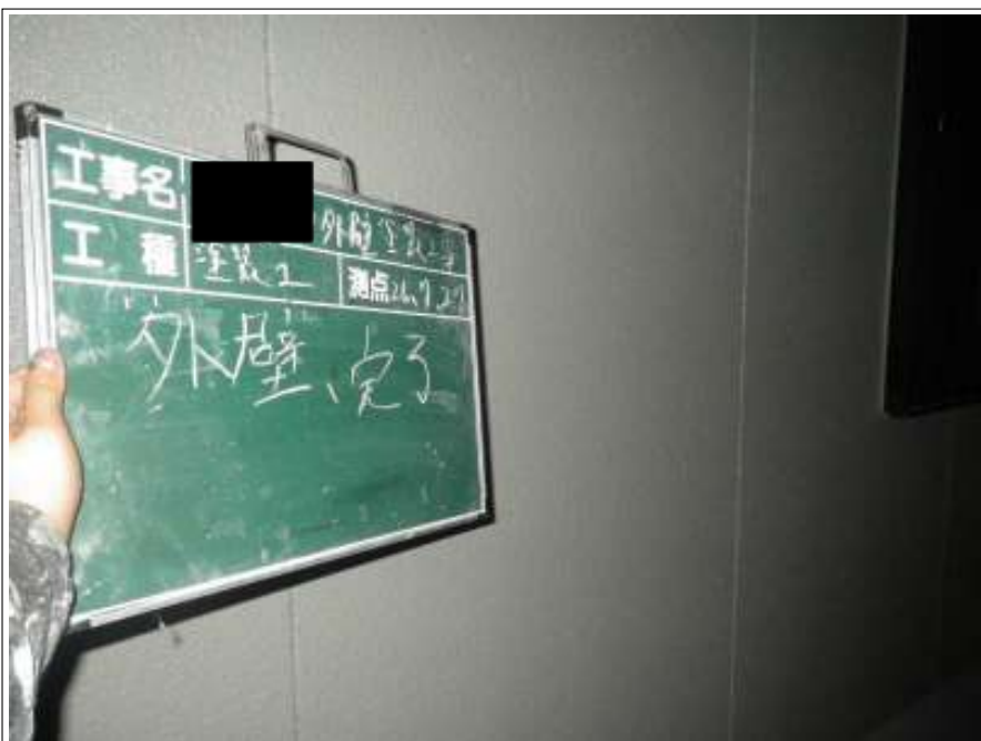
外壁塗装施工完了
