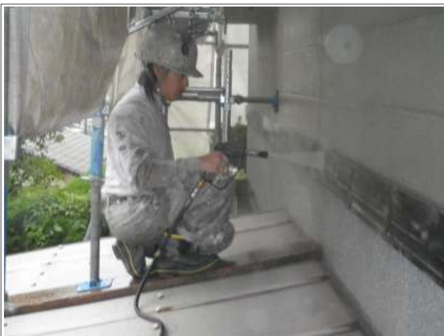
胴差し高圧洗浄施工中
