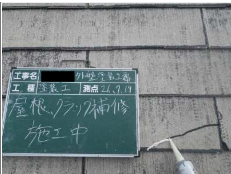
屋根クラック補修施工中
