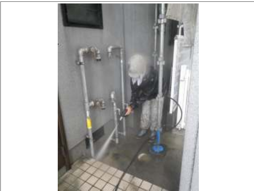
高圧洗浄施工中
