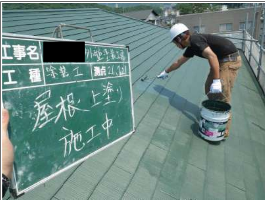
屋根塗装上塗り施工中
