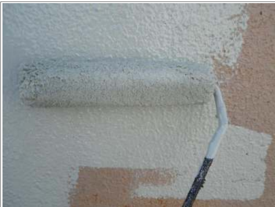
塀塗装2回目施工中
