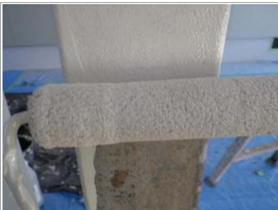
鉄部塗装下塗り施工中
