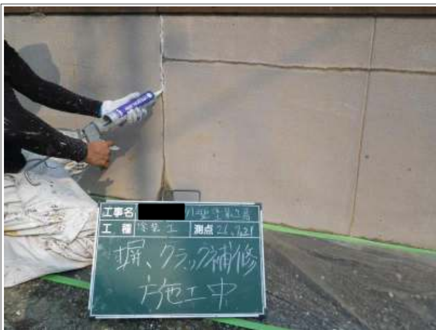
塀クラック補修施工中
