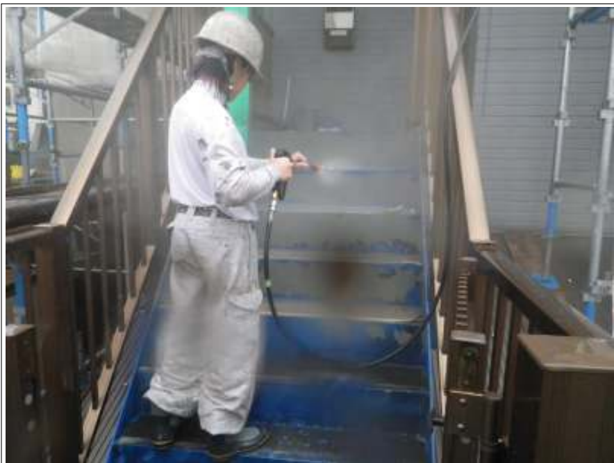
階段高压洗净施工中
