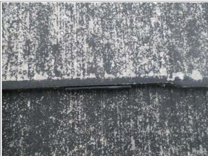
屋根タスペーサー施工完了
