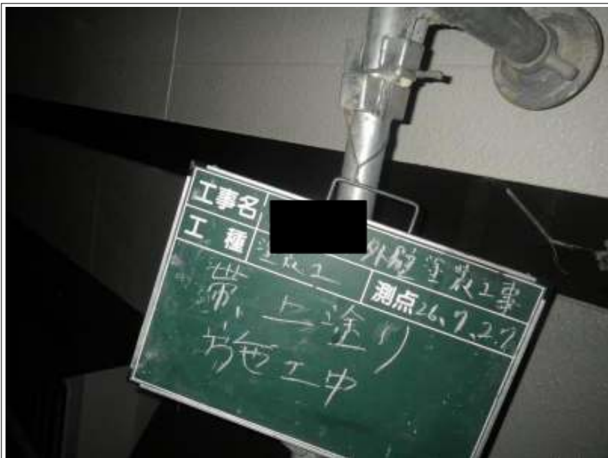
洞差し塗装上塗り施工中
