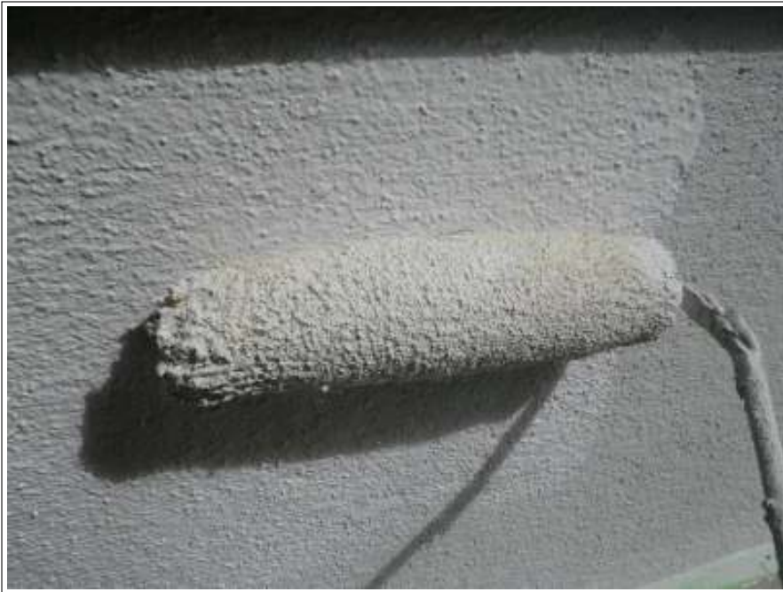
基礎塗装 2回目施工中
