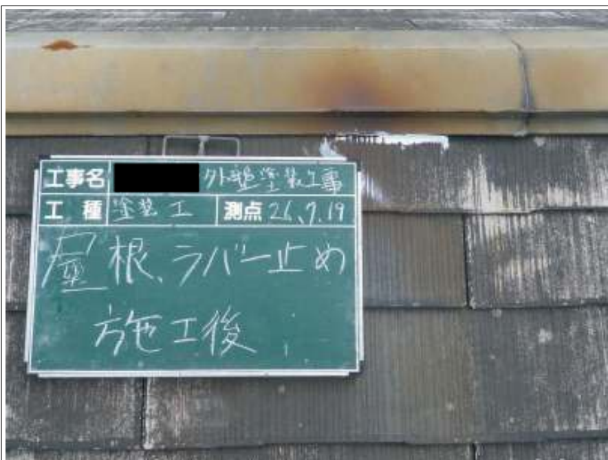
屋根棟鉄板ラバー止め施工完了
