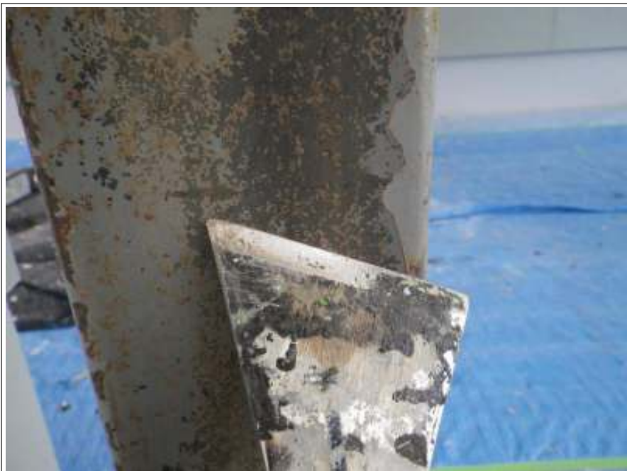
鉄部サビ落とし施工中
