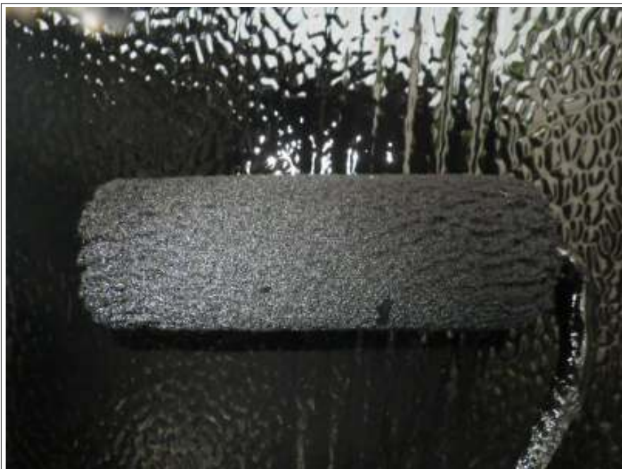
雨戸塗装上塗り施工中
