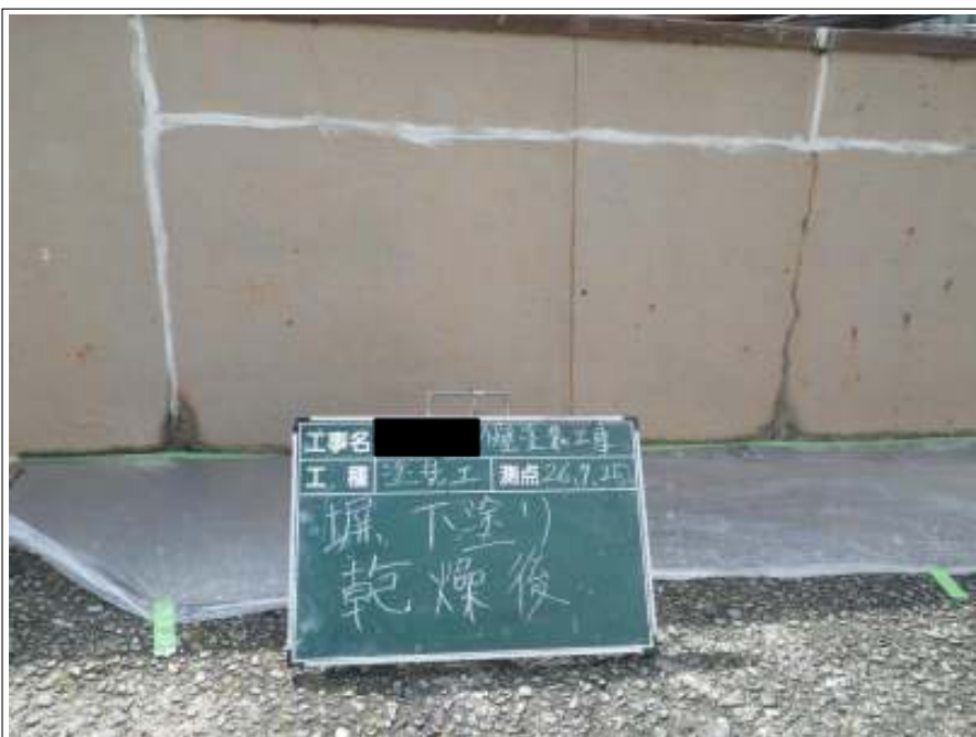
塙塗装 1 回目施工完了
