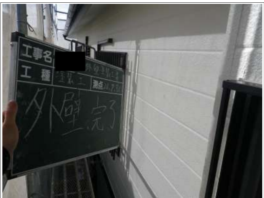
外壁塗装施工完了
