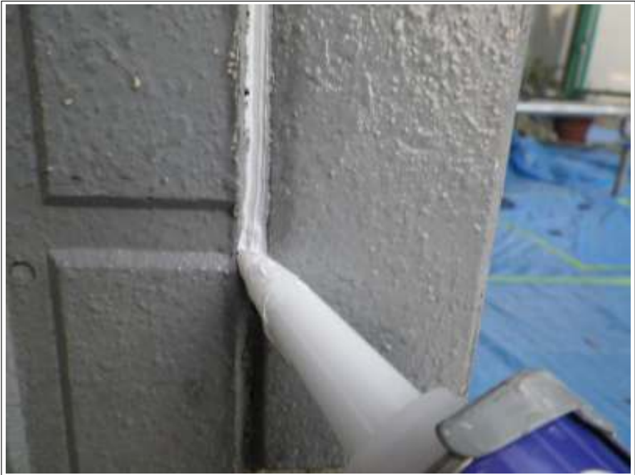
外壁シーリング増打ち施工中
