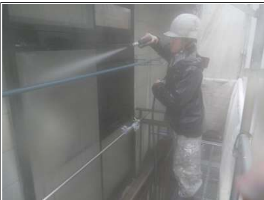
窓高圧洗浄施工中
