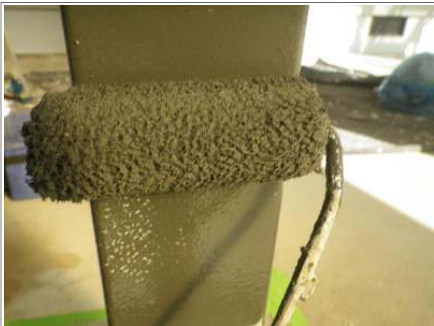
鉄部塗装中塗り施工中
