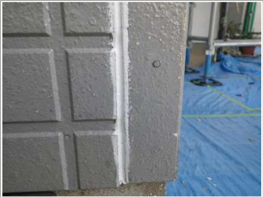
外壁シーリング増打ち施工完了
