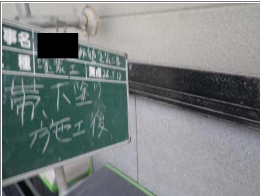
洞差し塗装下塗り施工完了
