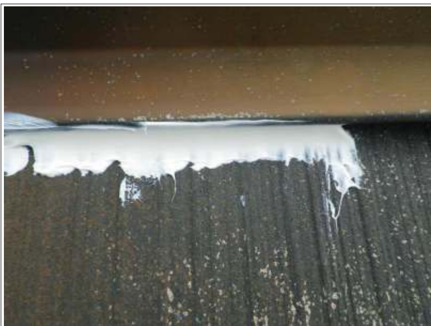
屋根棟鉄板ラバー止め施工完了
