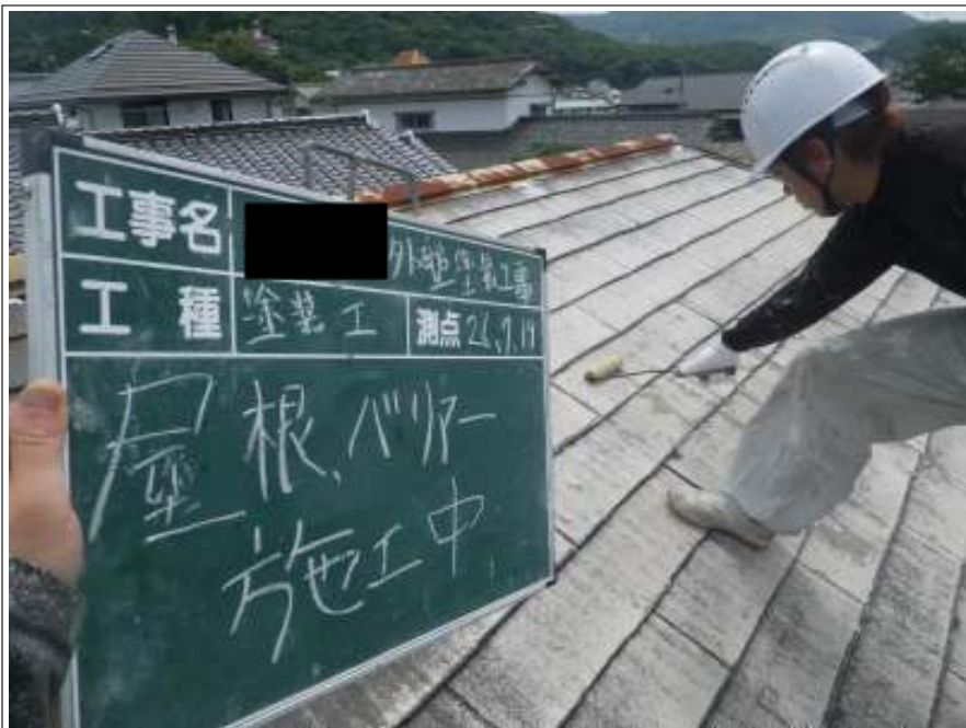
屋根塗装バリアー施工中
