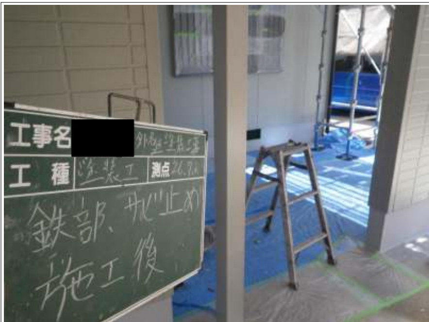
鉄部塗装下塗り施工完了
