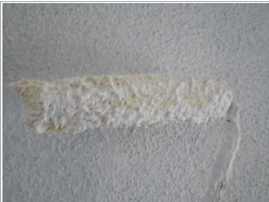
外壁塗装下塗り施工中
