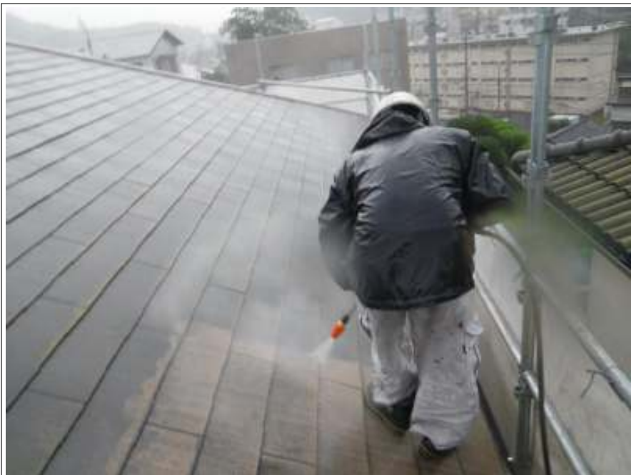
屋根高圧洗浄施工中
