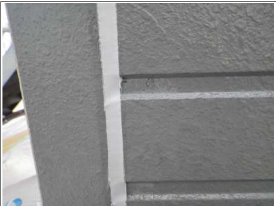
外壁シーリング打替え施工完了
