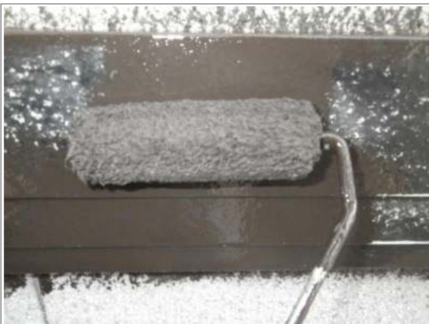
洞差し塗装中塗り施工中
