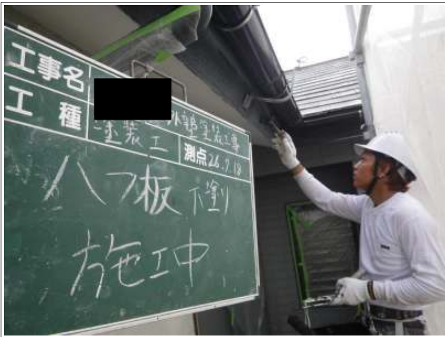
破風板塗装施工中
