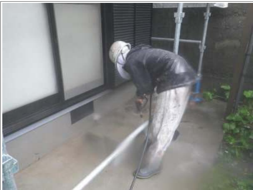
土間高圧洗浄施工中
