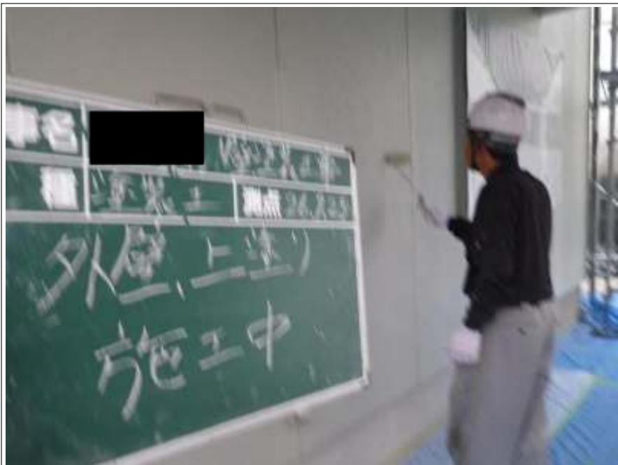
外壁塗装上塗り施工中
