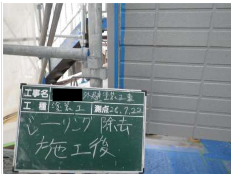
外壁シーリング除去施工完了
