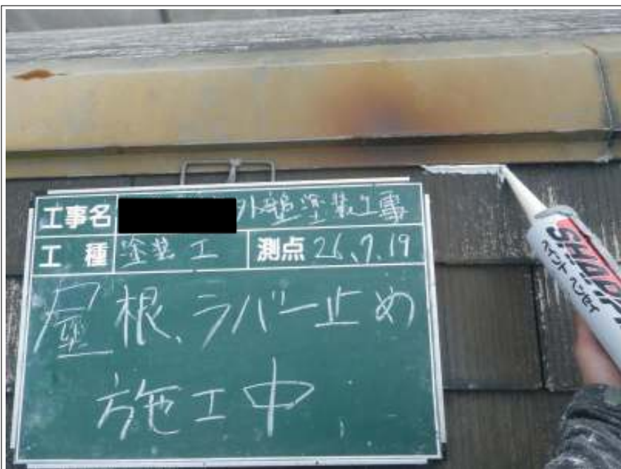
屋根棟鉄板ラバー止め施工中
