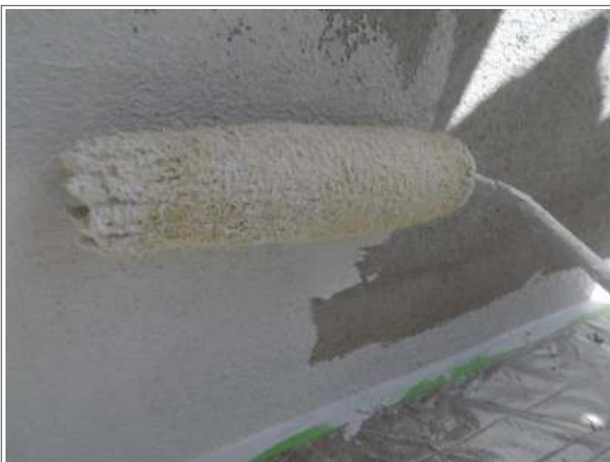
基礎塗装 1 回目施工中
