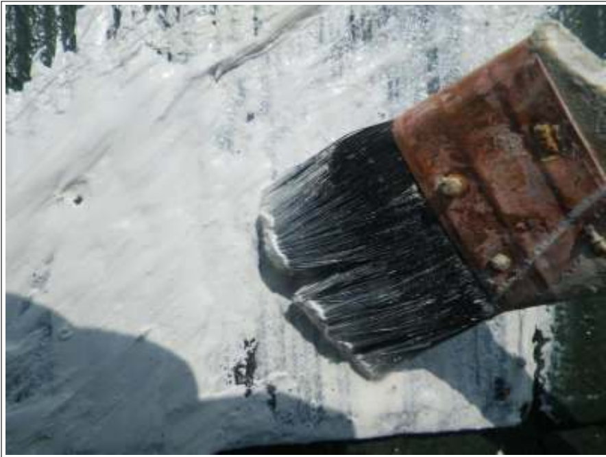
屋根クラック補修施工中
