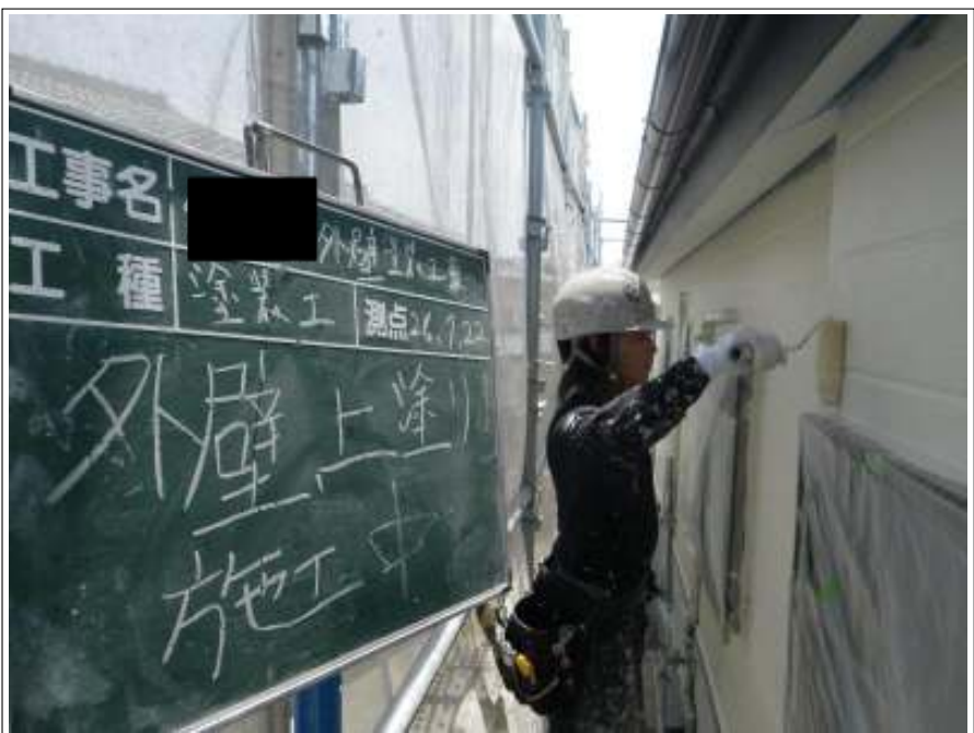
外壁塗装上塗り施工中
