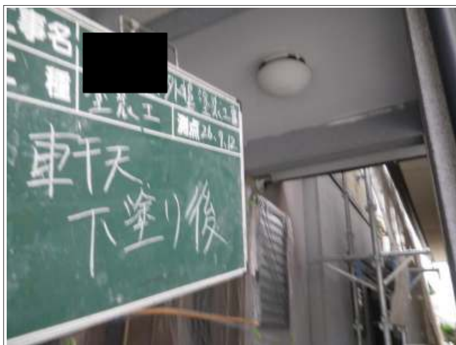
軒天塗装下塗り施工完了
