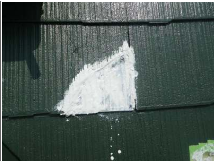
屋根クラック補修施工中
