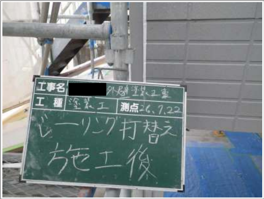
外壁シーリング打替え施工完了
