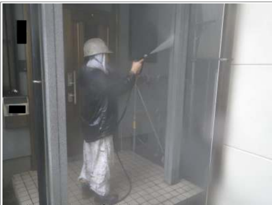
高压洗净施工中
