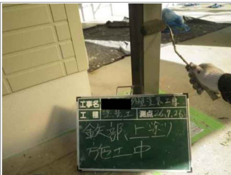
鉄部塗装上塗り施工中
