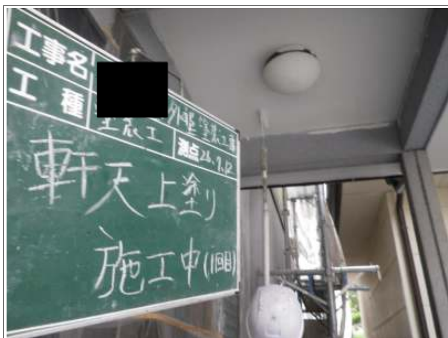
軒天塗装上塗り 1回目施工中
