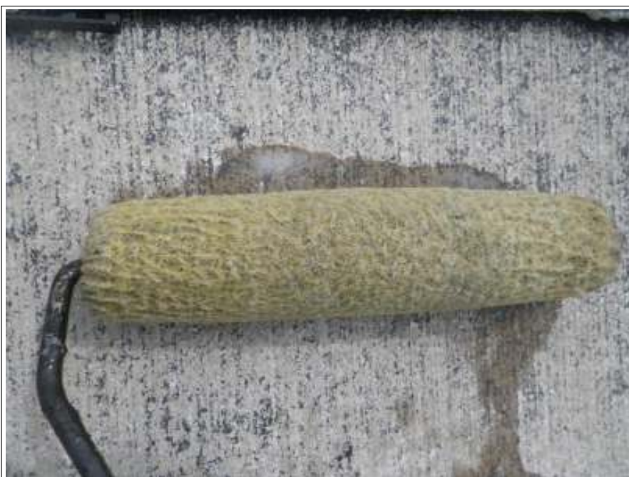
屋根塗装バリアー施工中
