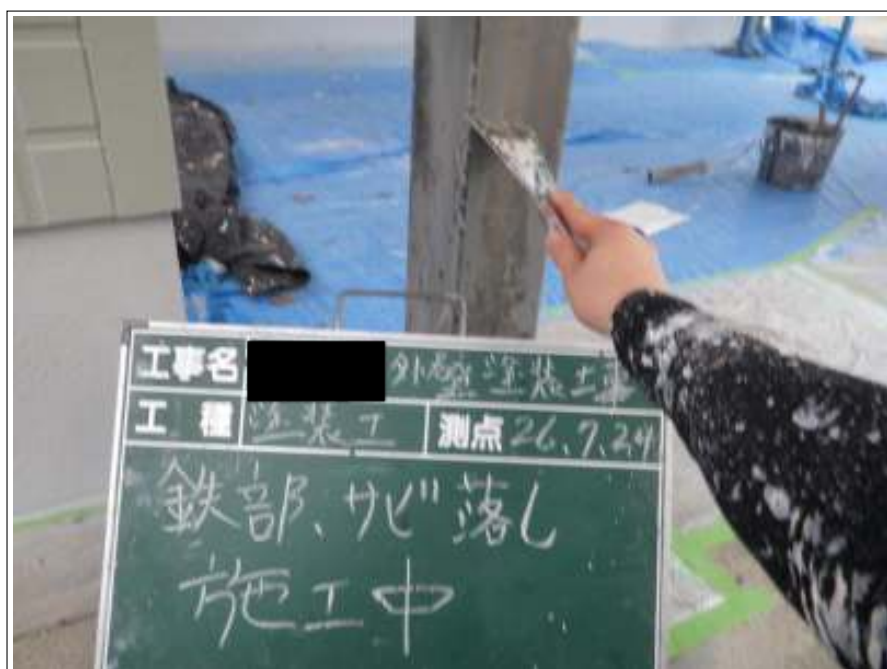
鉄部サビ落とし施工中
