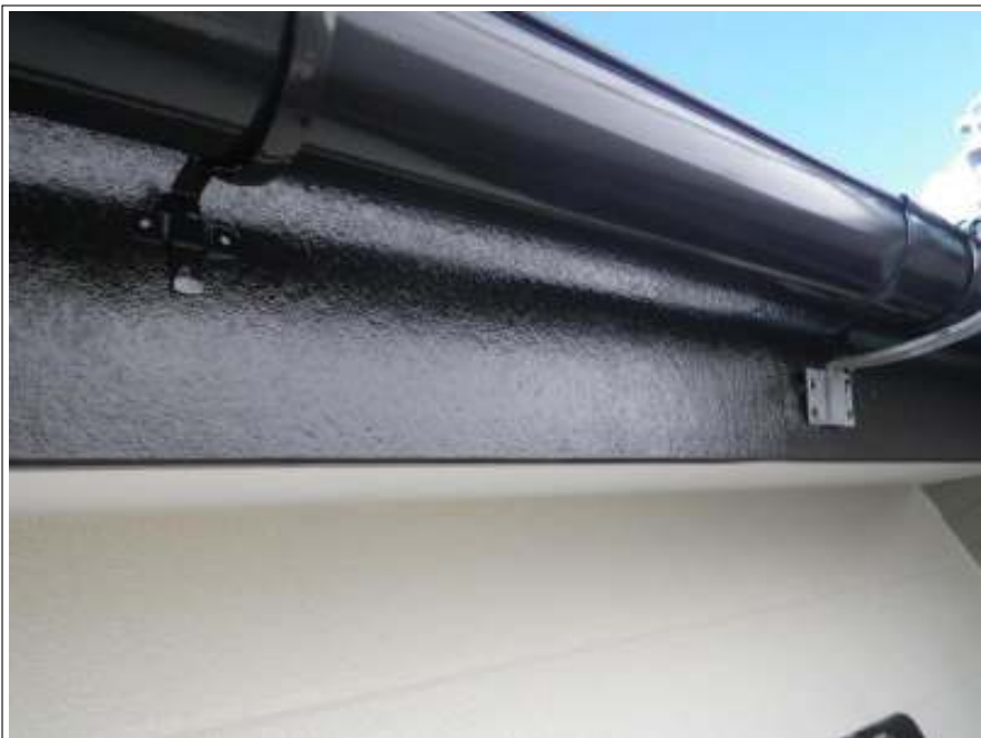
破風板塗装施工完了
