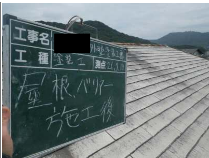
屋根塗装バリアー施工完了
