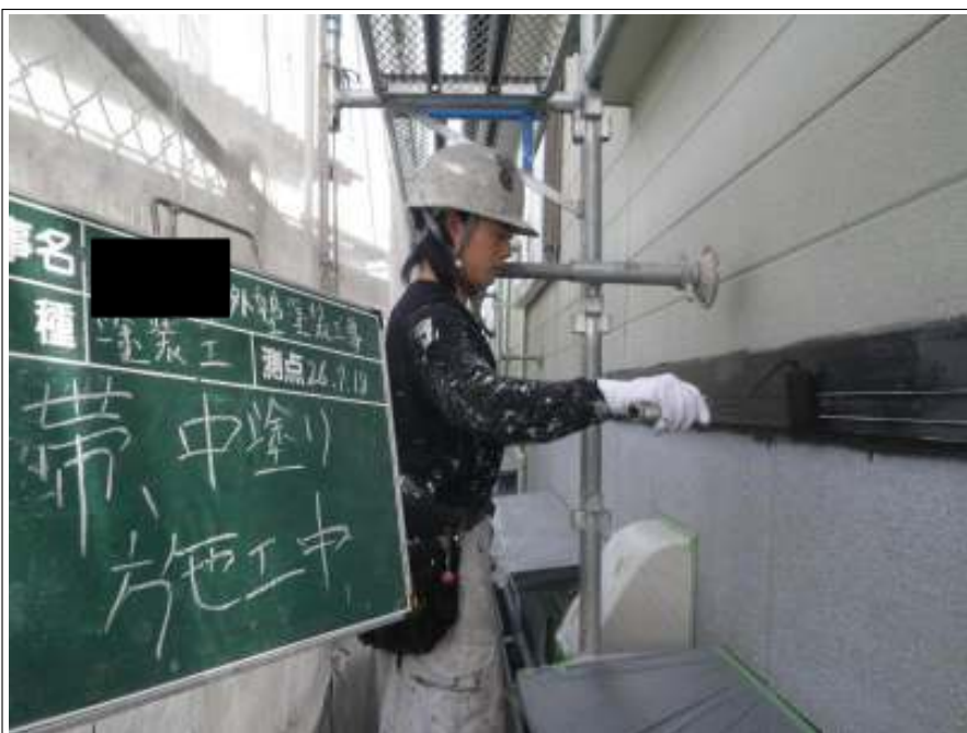
洞差し塗装中塗り施工中
