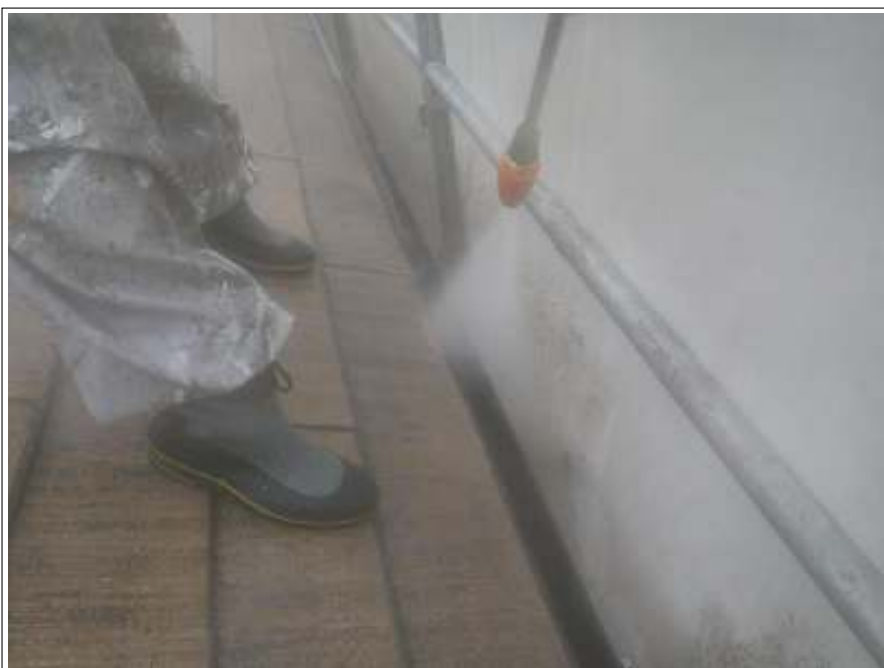
横樋高圧洗浄施工中
