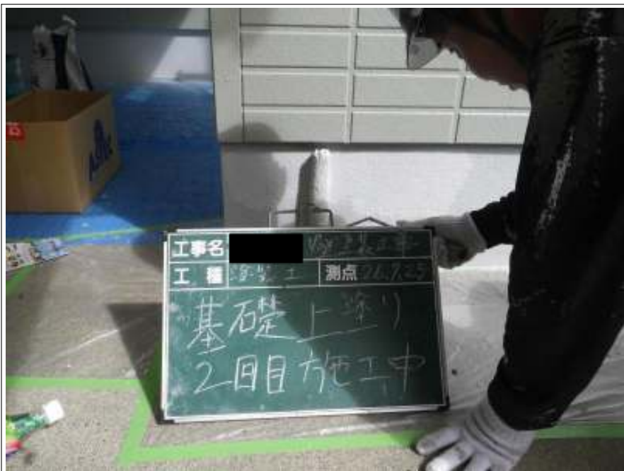
基礎塗装 2回目施工中
