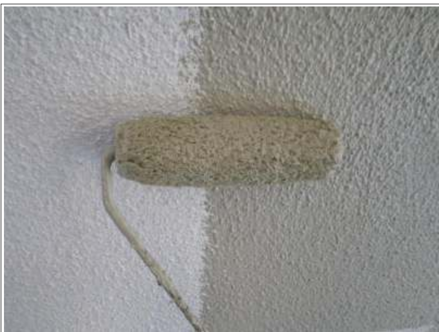
外壁塗装中塗り施工中
