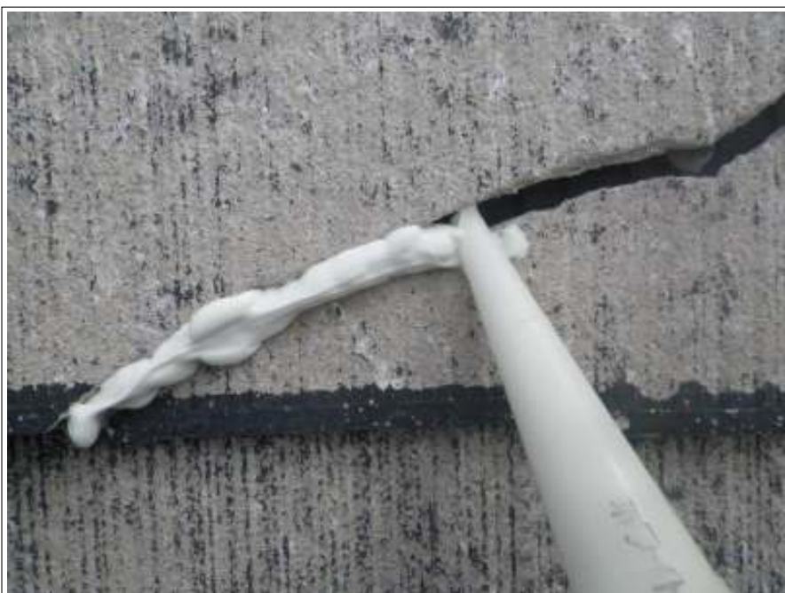
屋根クラック補修施工中
