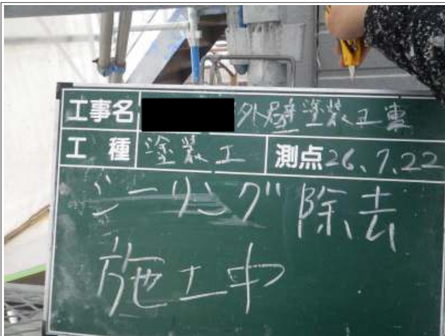
外壁シーリング除去施工中
