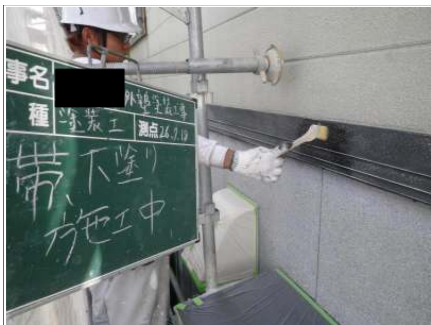
胴差し塗装下塗り施工中
