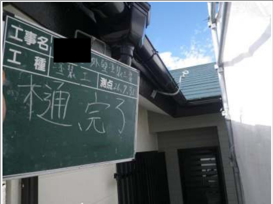
樋塗装施工完了
