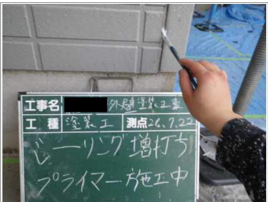
外壁シーリング増打ち施工中
