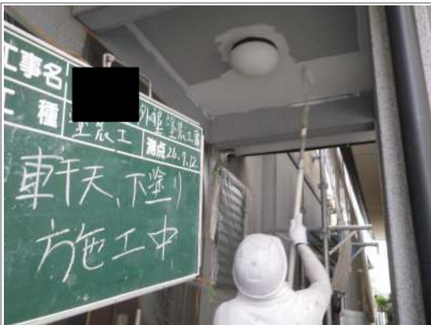
軒天塗装下塗り施工中
