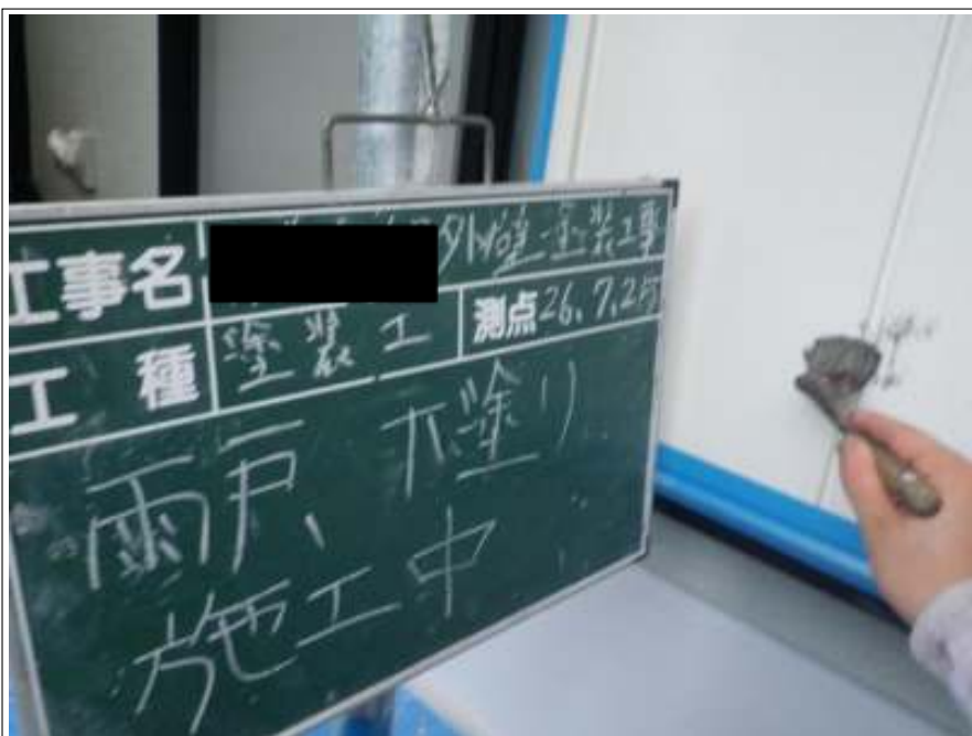
雨戸塗装下塗り施工中
