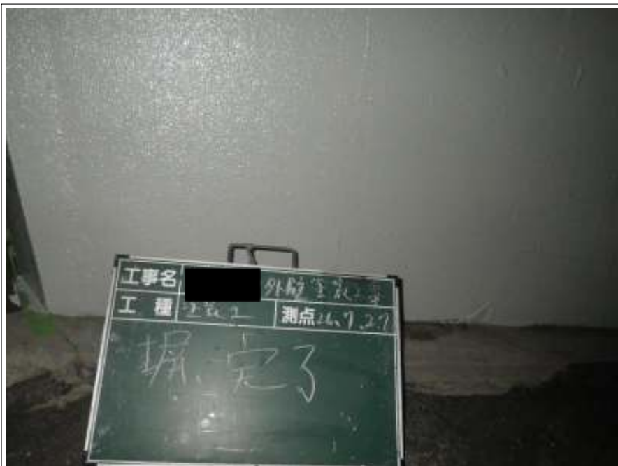
塀塗装施工完了
