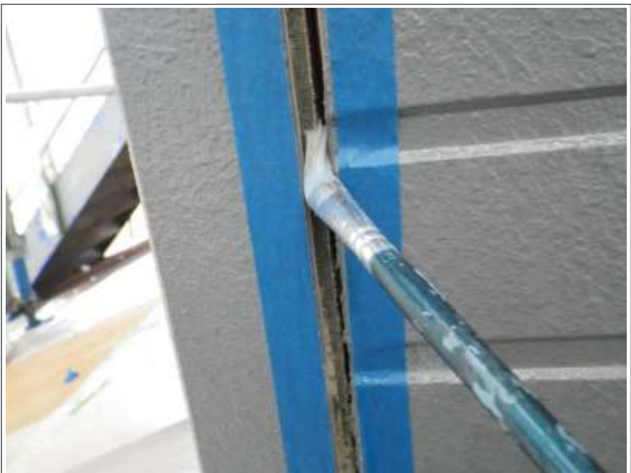
外壁シーリングプライマー施工中
