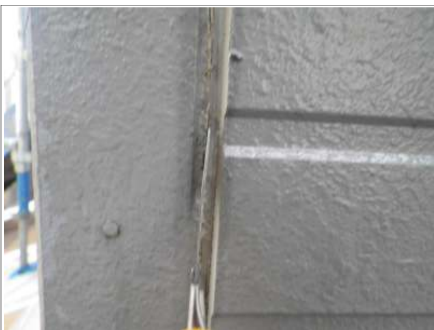
外壁シーリング除去施工中
