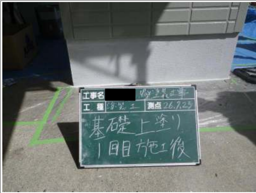
基礎塗装 1回目施工完了
