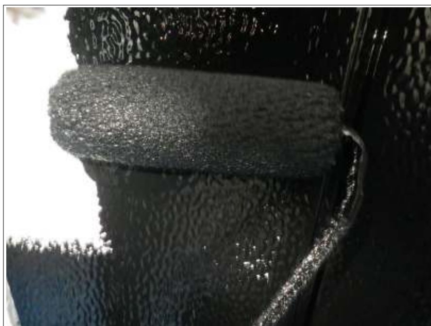
雨戸塗装中塗り施工中
