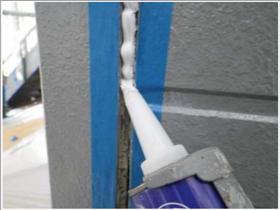
外壁シーリング打替え施工中
