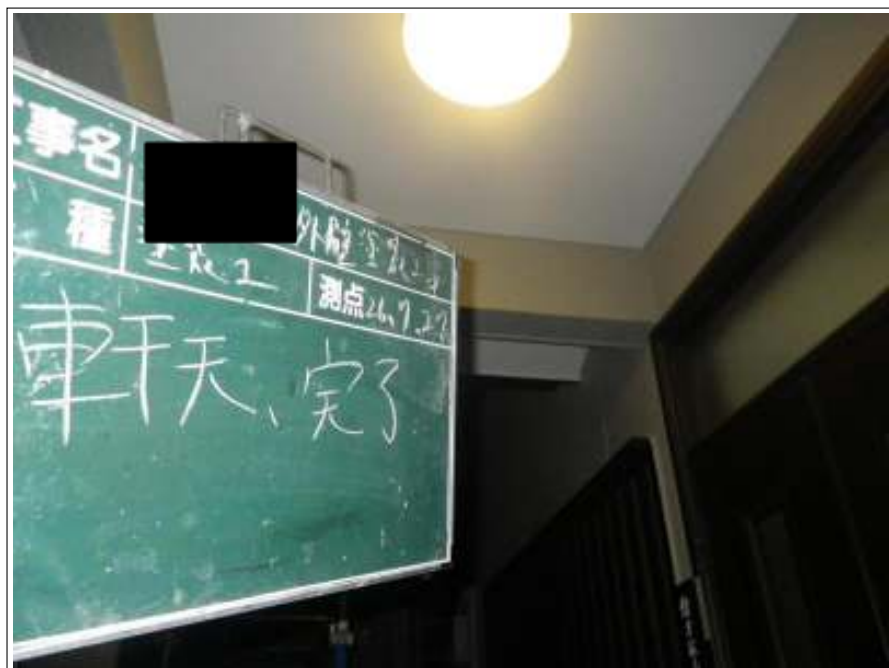
軒天塗装施工完了
