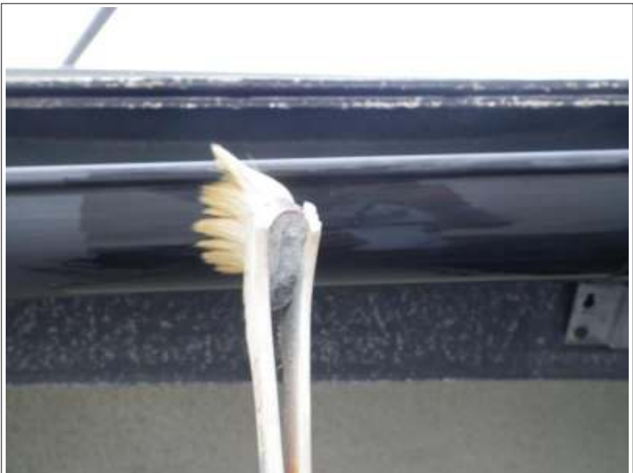
樋塗装施工中
