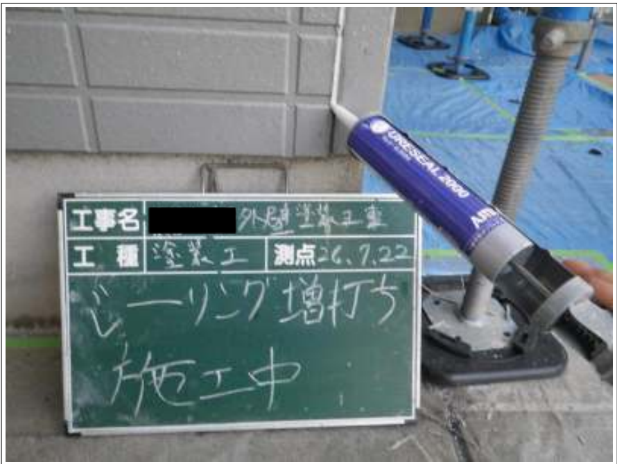
外壁シーリング増打ち施工中
