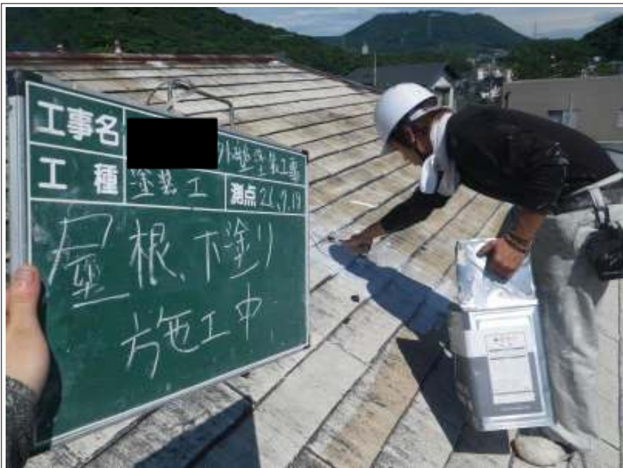
屋根塗装下塗り施工中
