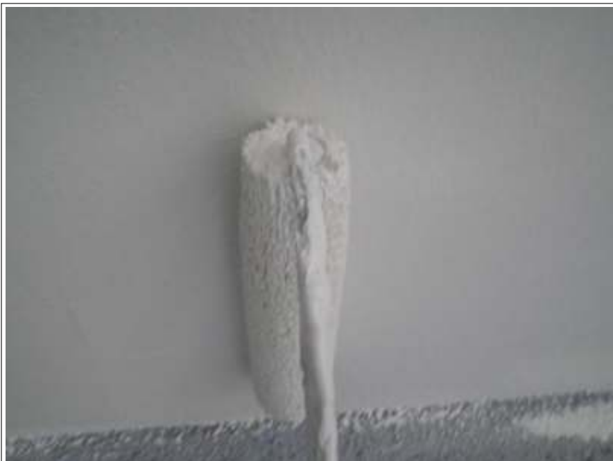
軒天塗装上塗り 1 回目施工中
