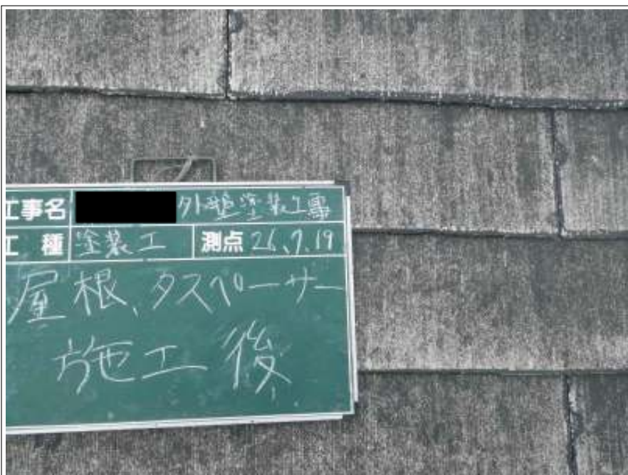
屋根タスペーサー施工完了
