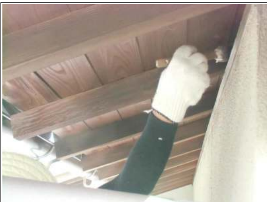
軒天塗装施工中
