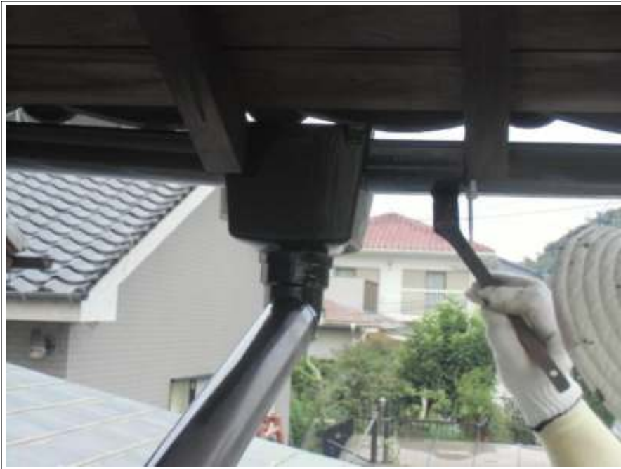
樋塗装施工中
