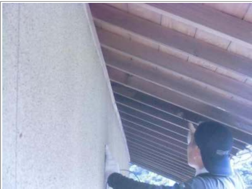
軒天塗装施工中
