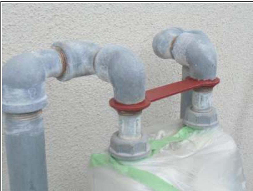
サビ止め施工完了
