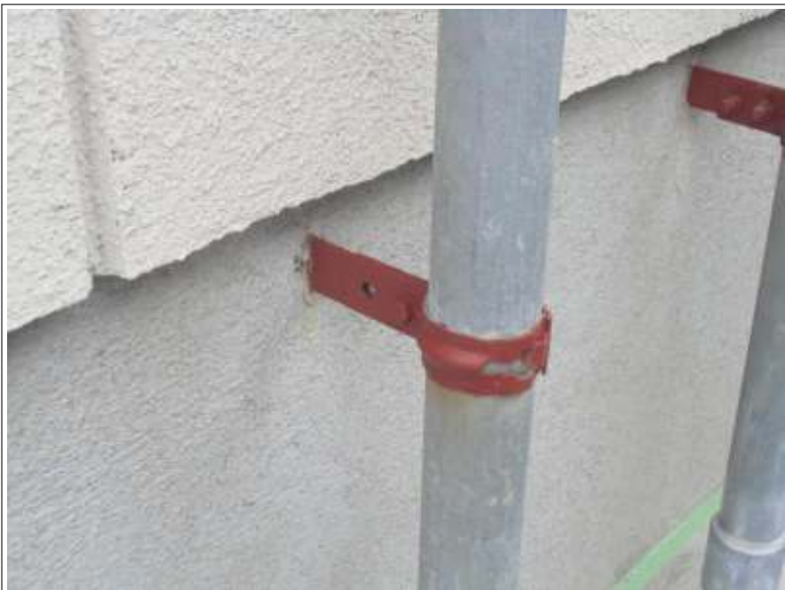
サビ止め施工完了
