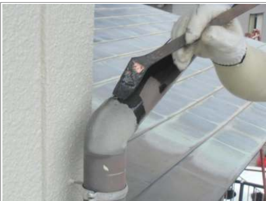
樋塗装施工中
