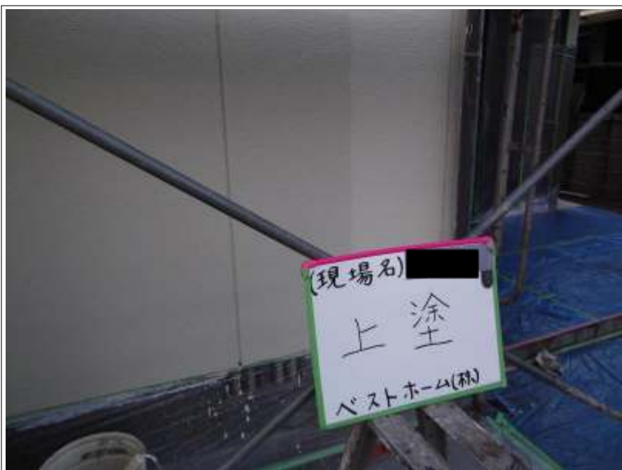
外壁塗装上塗り施工中
