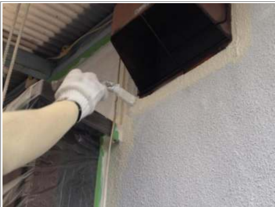
外壁塗装中塗り施工中
