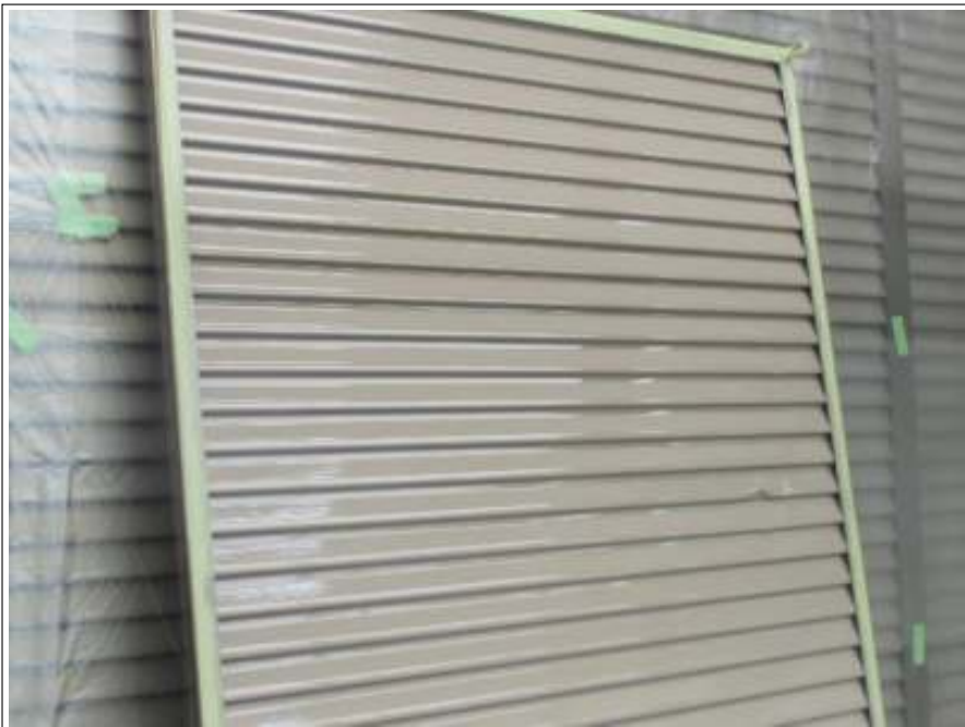
雨戸塗装施工完了
