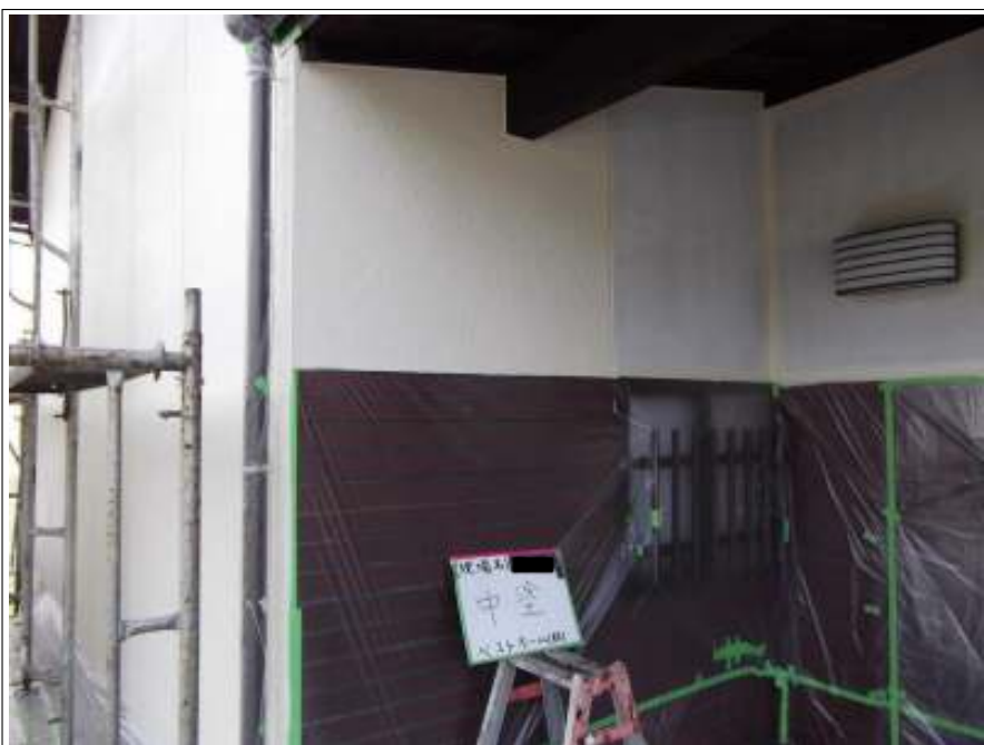
外壁塗装中塗り施工完了
