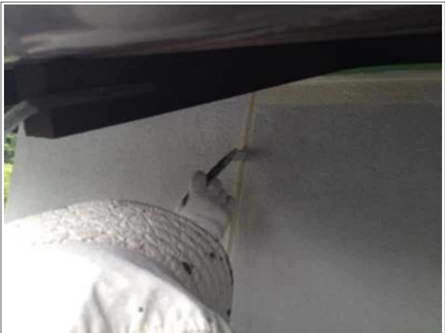
外壁塗装中塗り施工中
