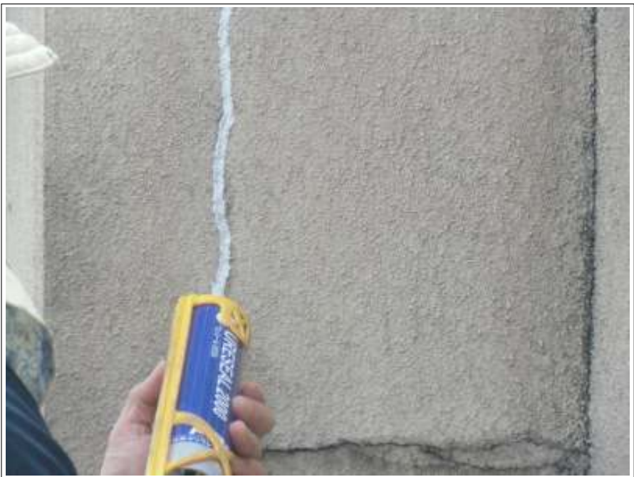
外壁クラック補修施工中
