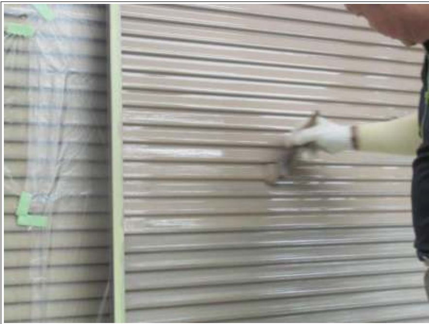
雨戸塗装施工中
