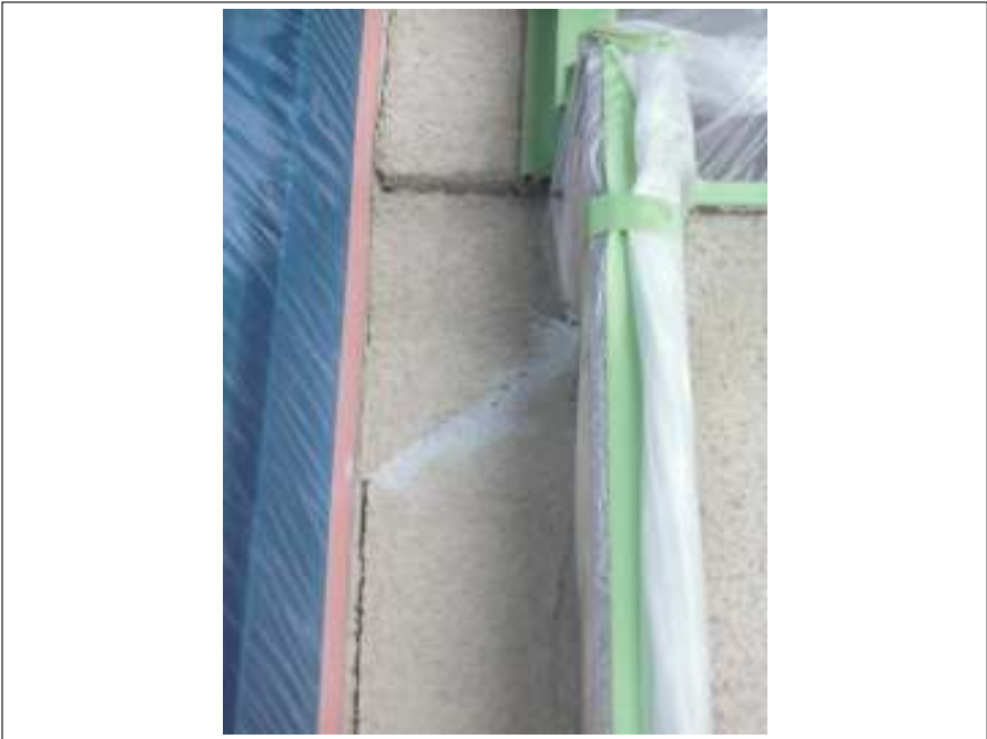
外壁クラック補修施工完了
