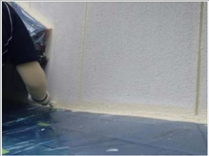
外壁塗装中塗り施工中
