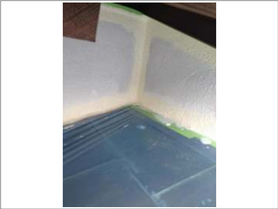
外壁塗装中塗り施工中
