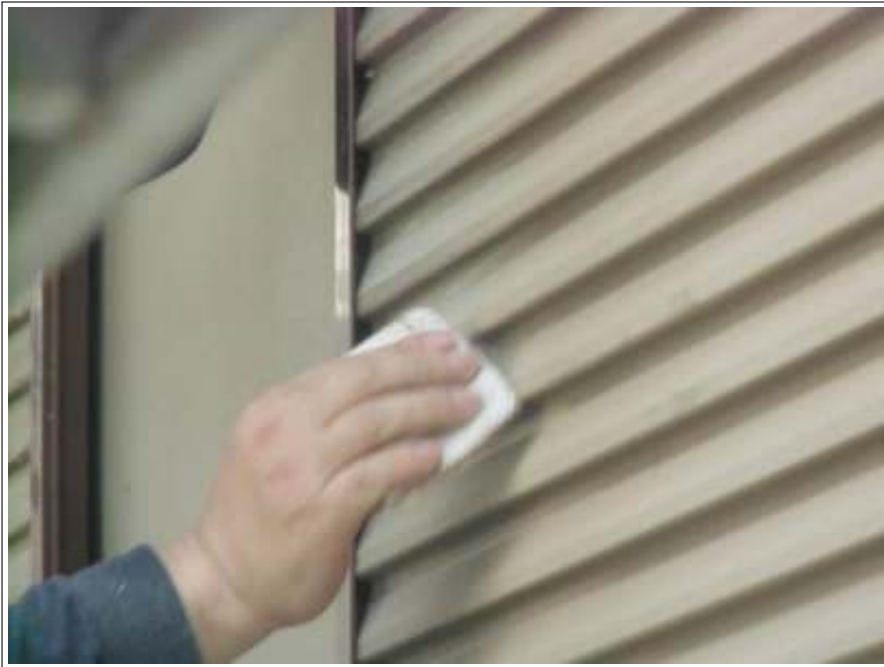
雨戸ケレン施工中
