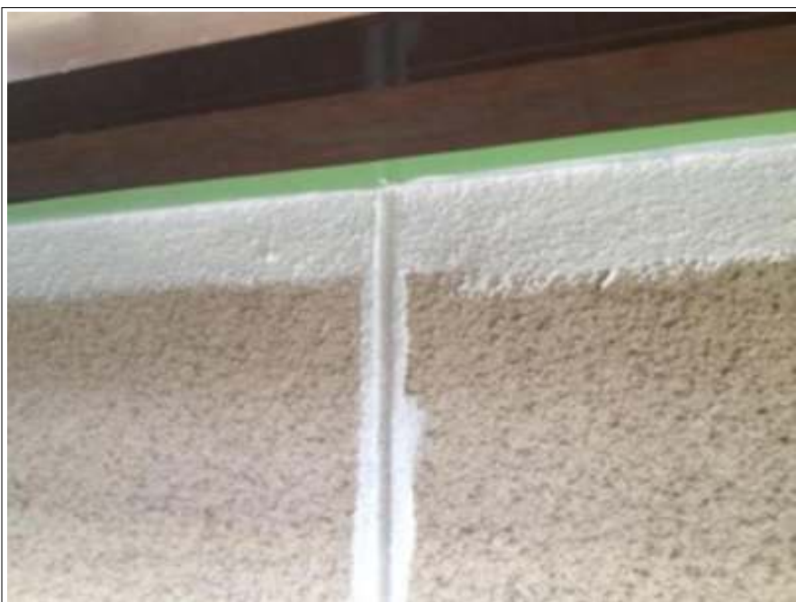
外壁塗装下塗り施工中
