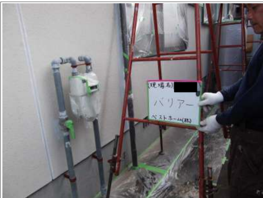
外壁塗装バリアー施工中
