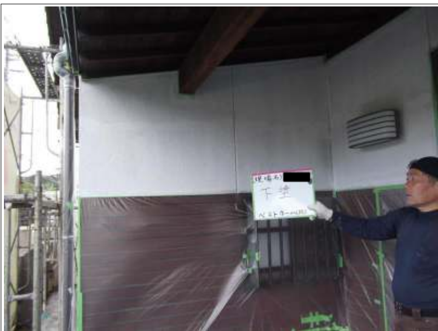
外壁塗装下塗り施工完了
