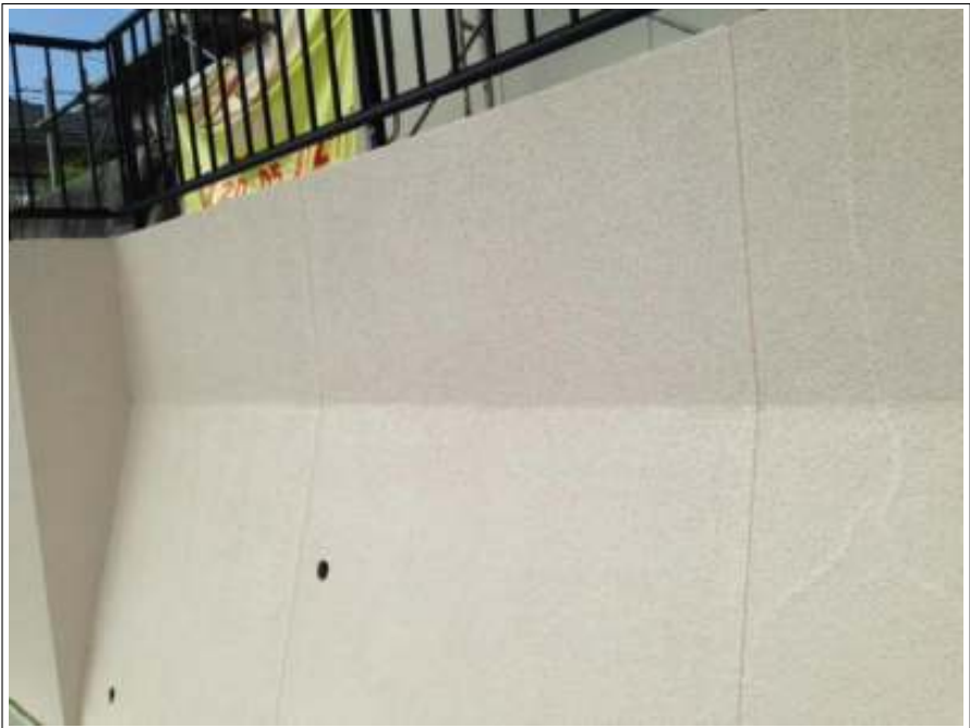
塀塗装施工完了
