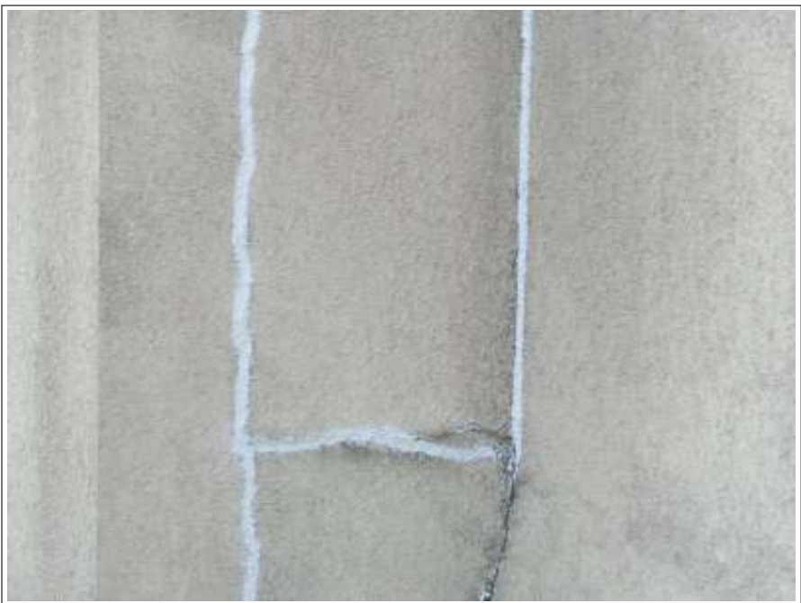
外壁クラック補修施工完了
