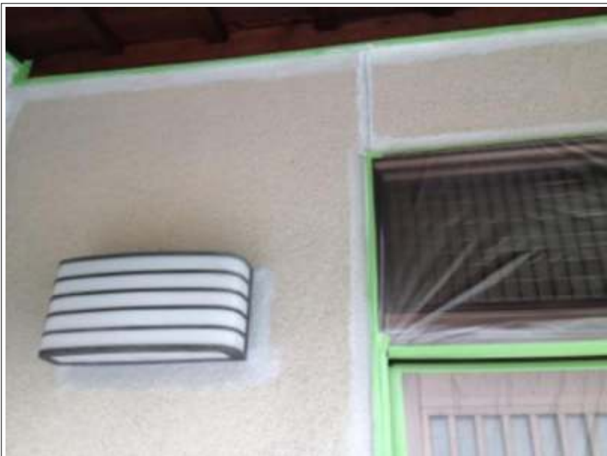
外壁塗装下塗り施工中
