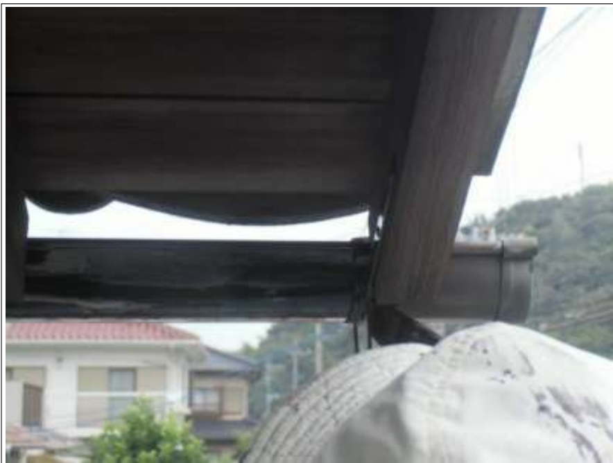
樋塗装施工中
