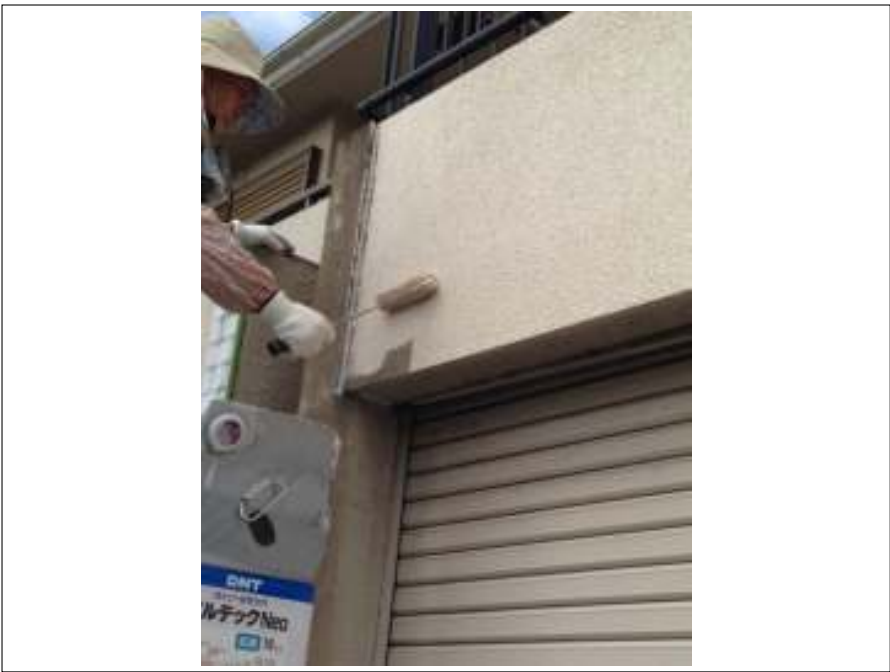
塀塗装施工中
