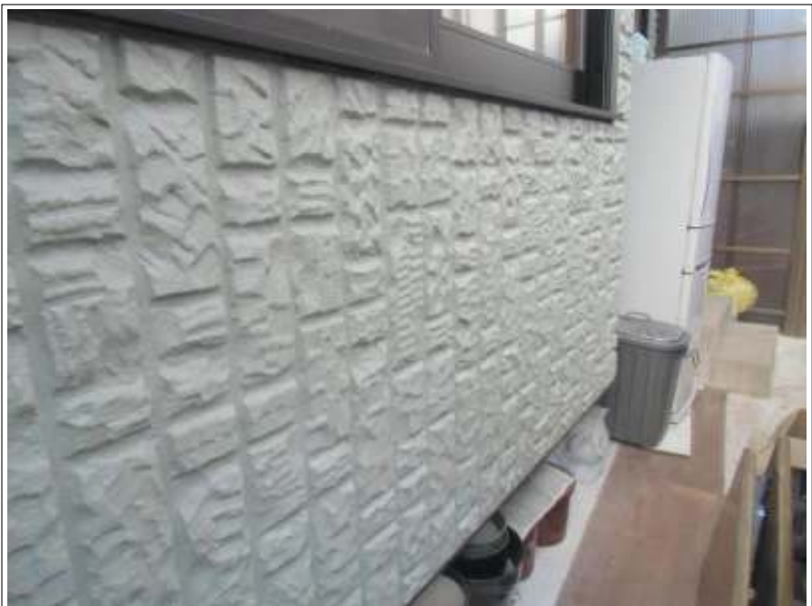
外壁塗装上塗り施工完了
