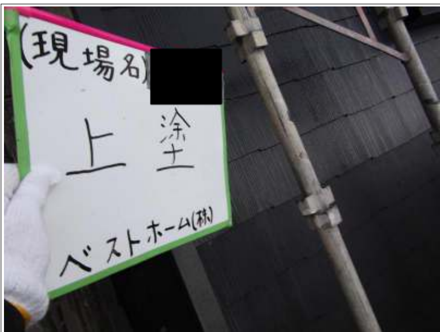
屋根塗装上塗り施工中
