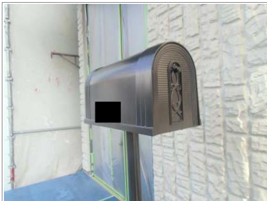
ポスト塗装施工完了
