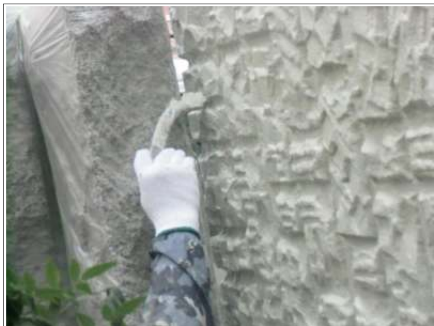
外壁塗装上塗り施工中
