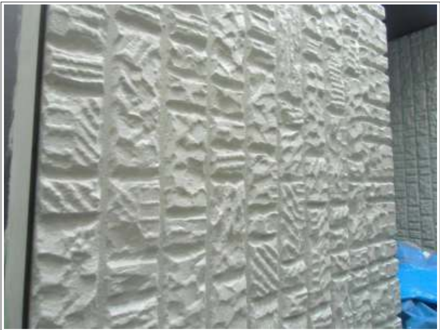
外壁塗装上塗り施工完了
