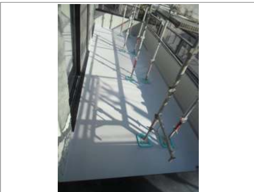
ベランダ塗装施工完了
