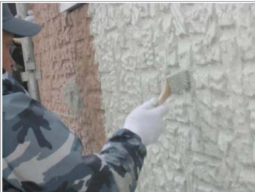
外壁塗装中塗り施工中
