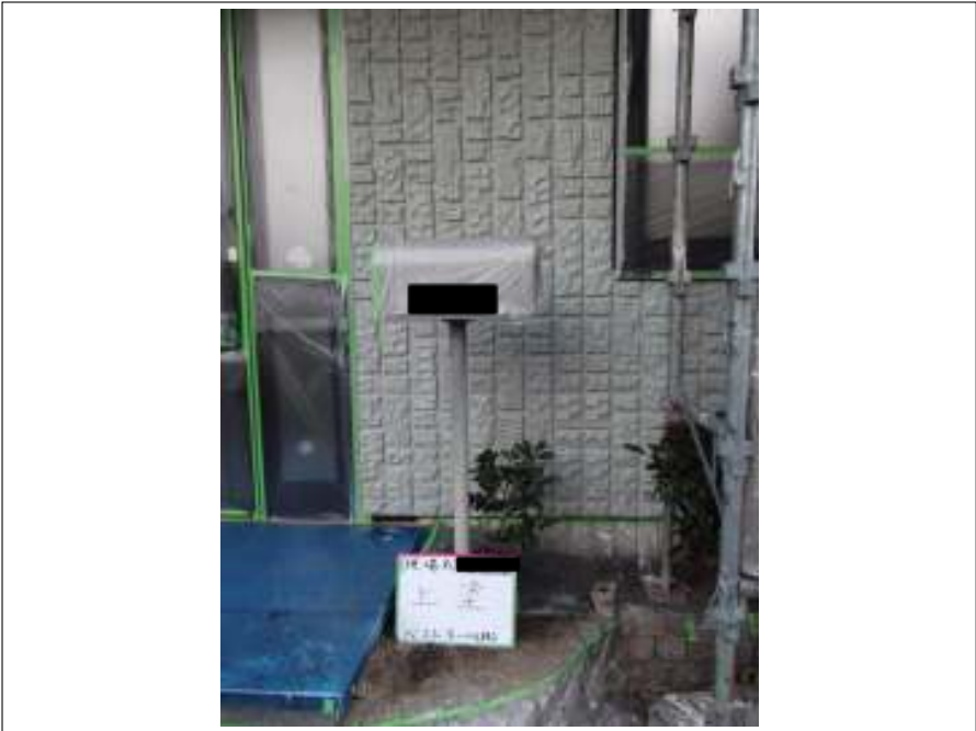
外壁塗装上塗り施工完了
