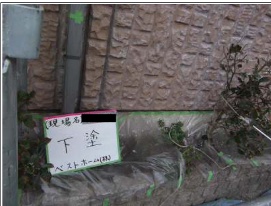
外壁塗装下塗り施工中
