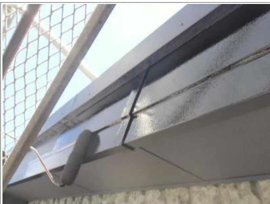
破風板塗装施工中
