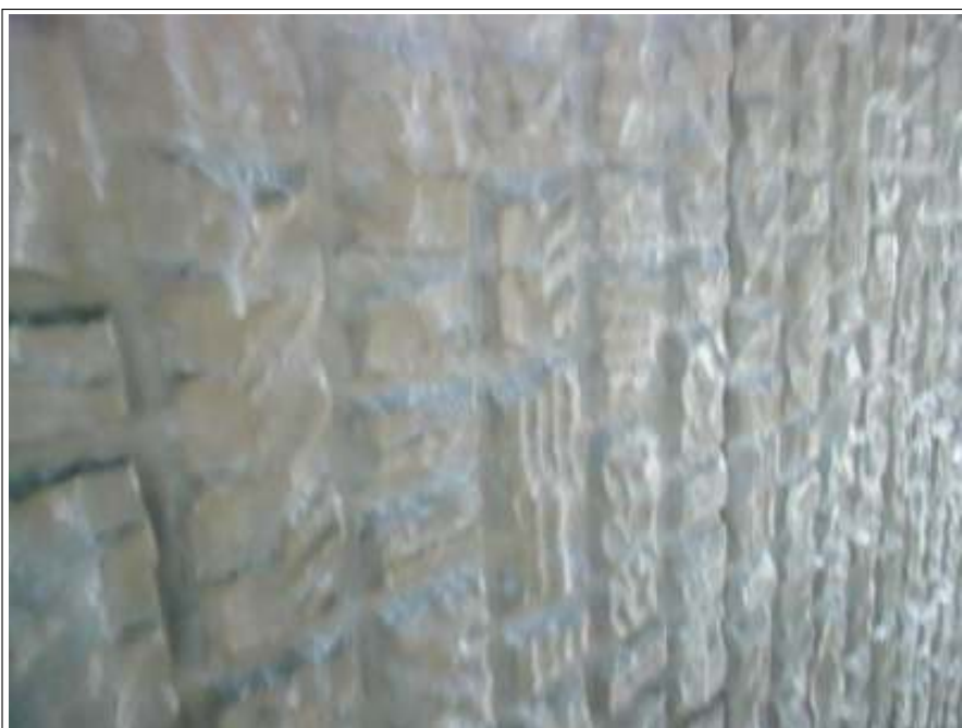
外壁塗装下塗り施工完了
