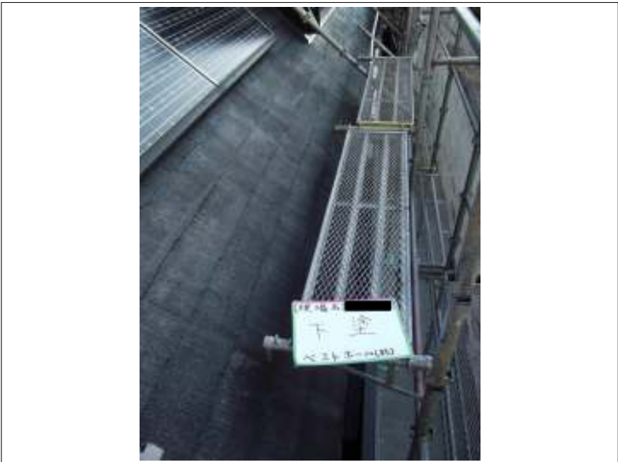
屋根塗装下塗り施工中
