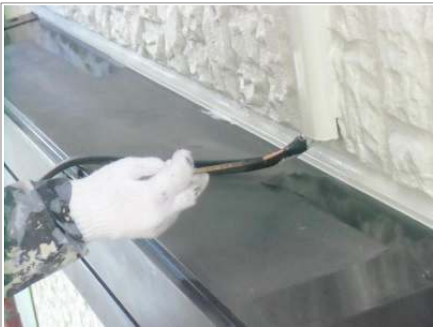
シャッターボックス塗装施工中
