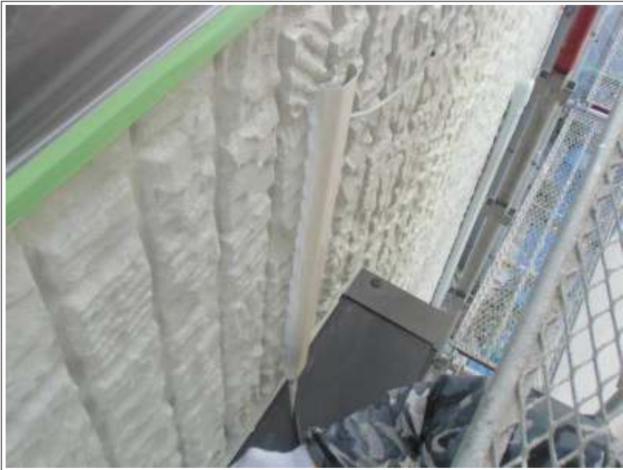
電気カバー取り付け施工完了
