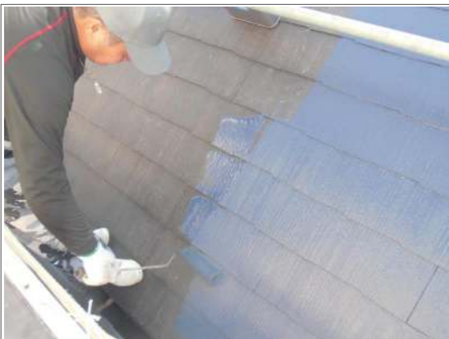
屋根塗装中塗り施工中
