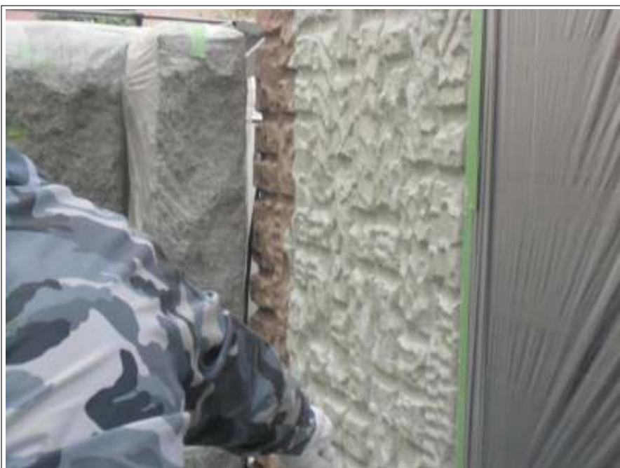
外壁塗装中塗り施工中
