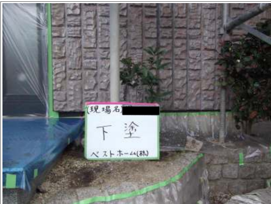
外壁塗装下塗り施工中
