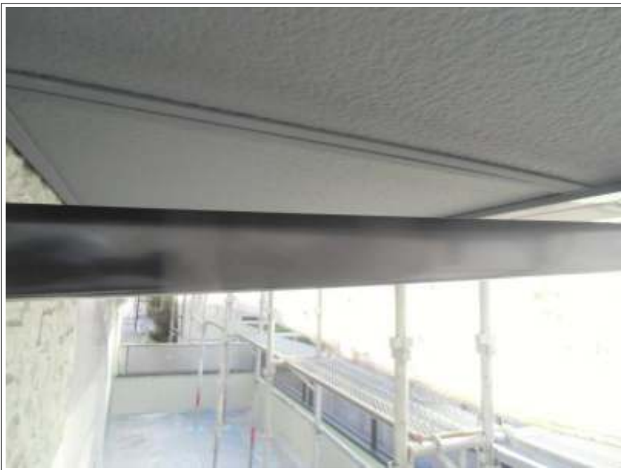
樋塗装施工完了
