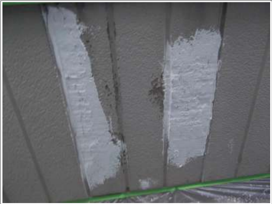
補修施工完了
