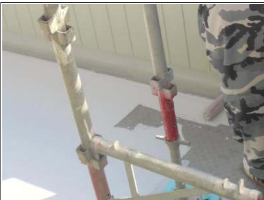
ベランダ塗装施工中
