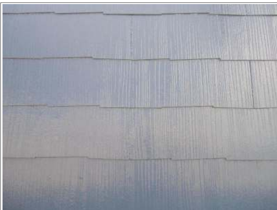
屋根塗装中塗り施工完了
