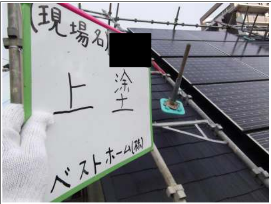
屋根塗装上塗り施工中
