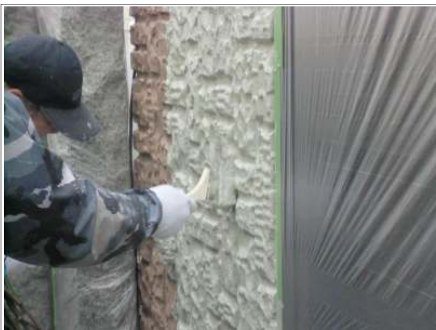
外壁塗装中塗り施工中
