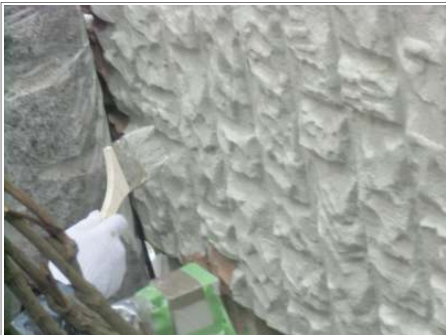
外壁塗装中塗り施工中
