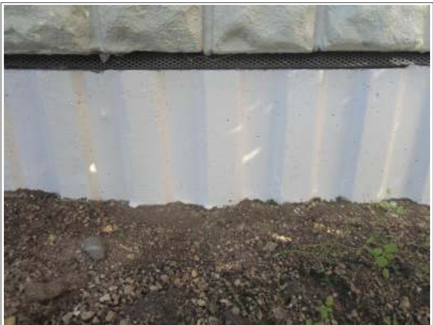
基礎塗装施工完了
