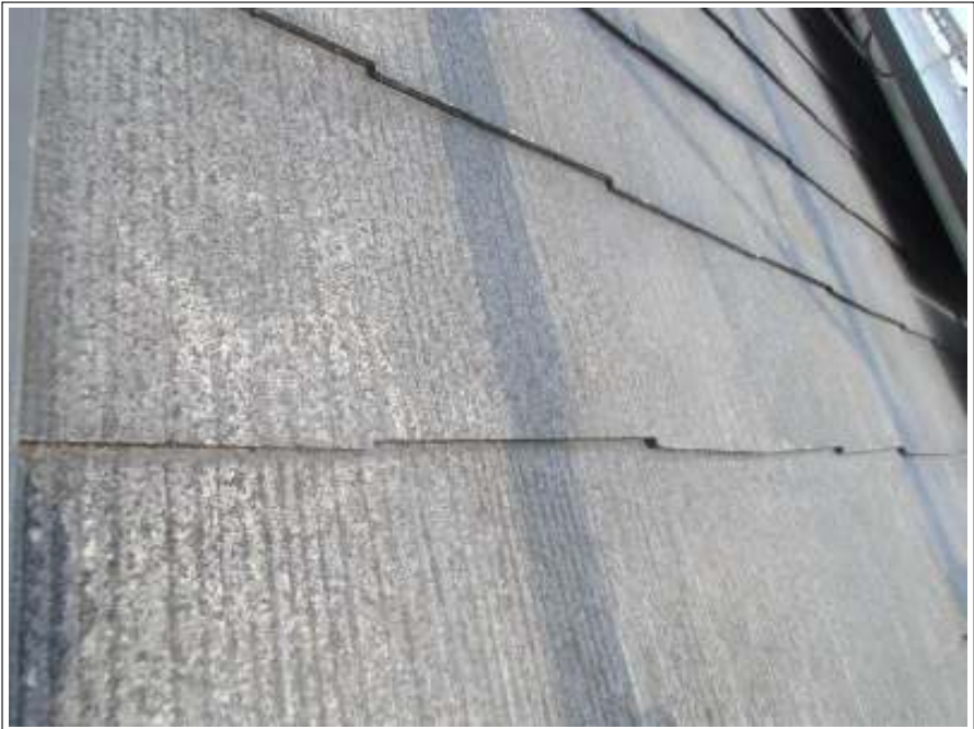
屋根塗装下塗り施工完了
