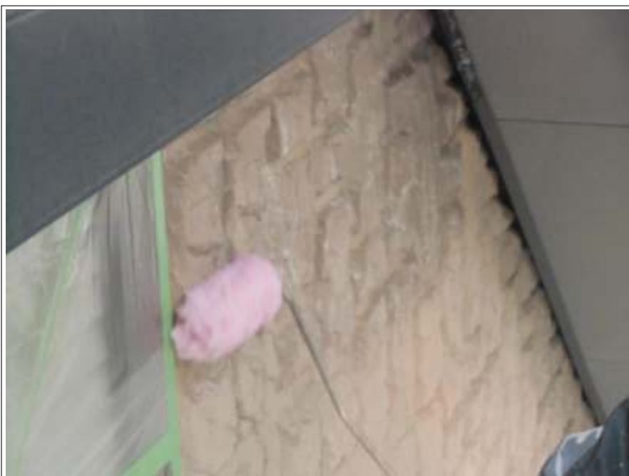
外壁塗装下塗り施工中
