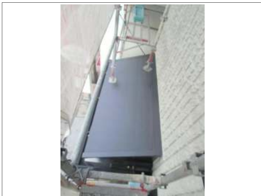
玄関屋根塗装施工完了
