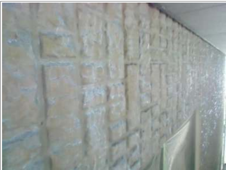
外壁塗装下塗り施工完了
