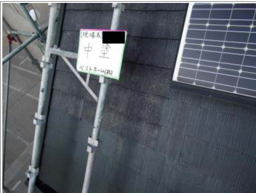
屋根塗装中塗り施工中
