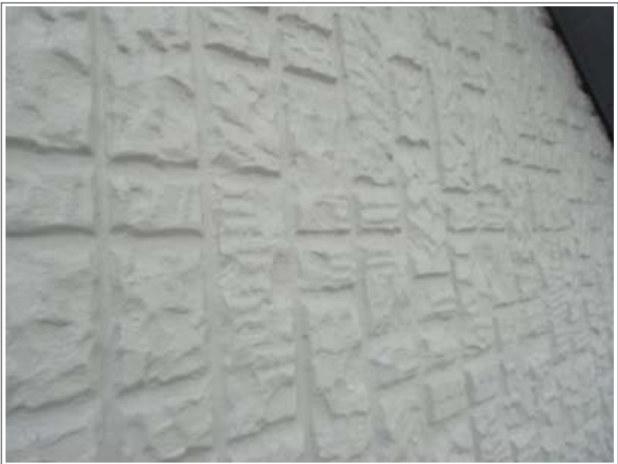
外壁塗装上塗り施工完了
