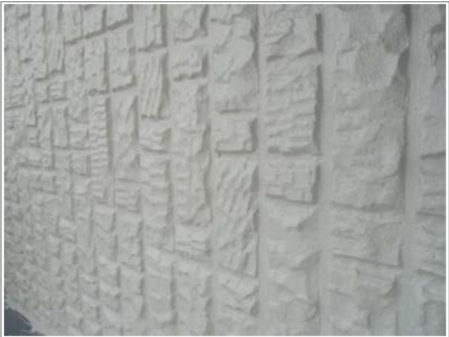
外壁塗装上塗り施工完了
