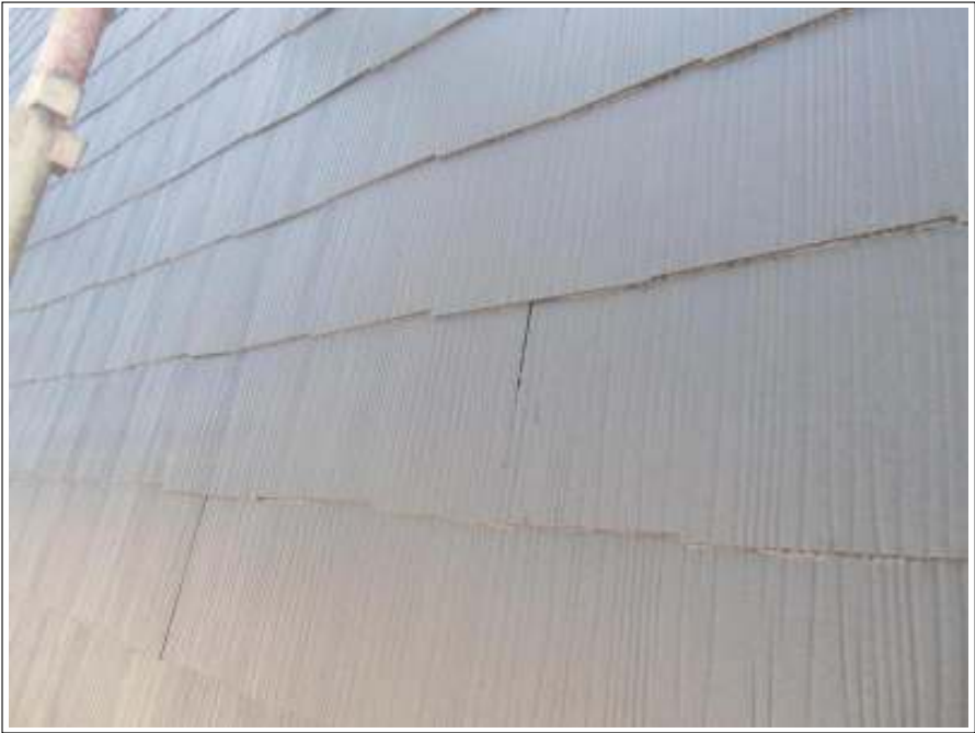
屋根塗装上塗り施工完了
