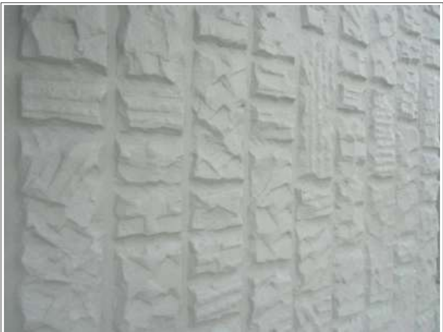
外壁塗装上塗り施工完了
