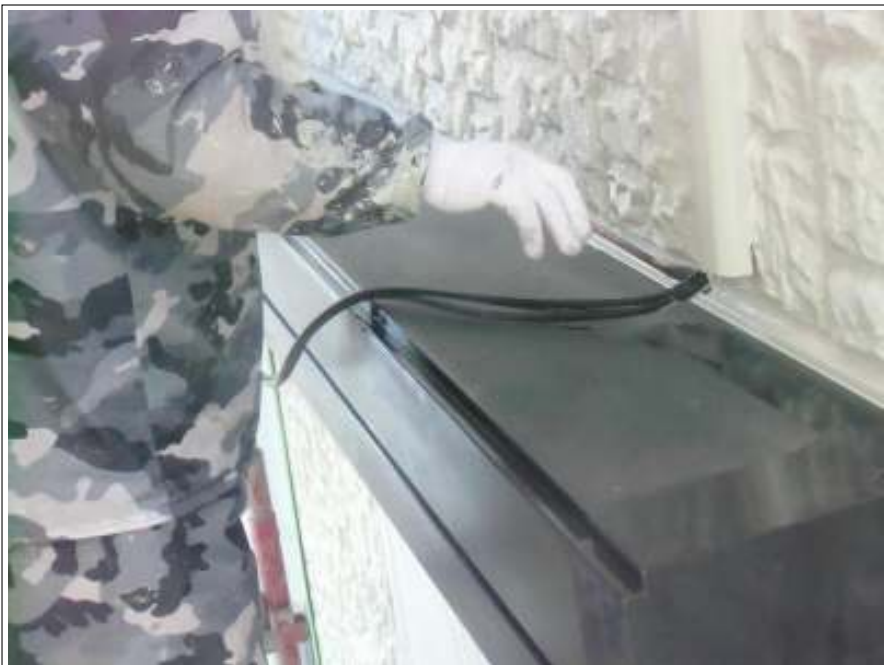
シャッターボックス塗装施工中
