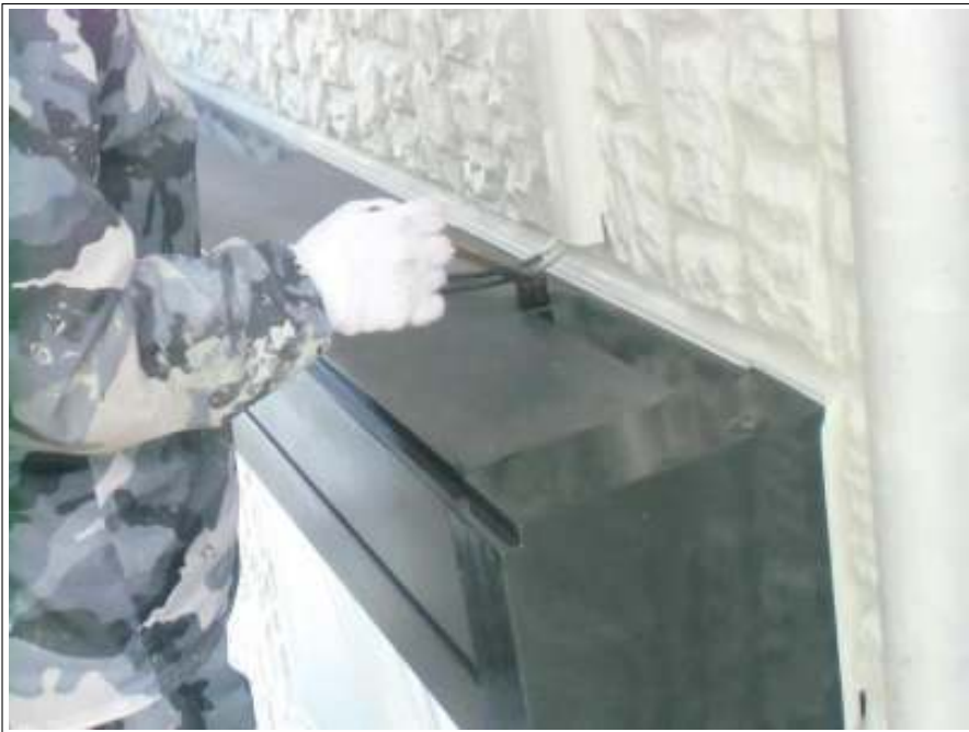
シャッターボックス塗装施工中
