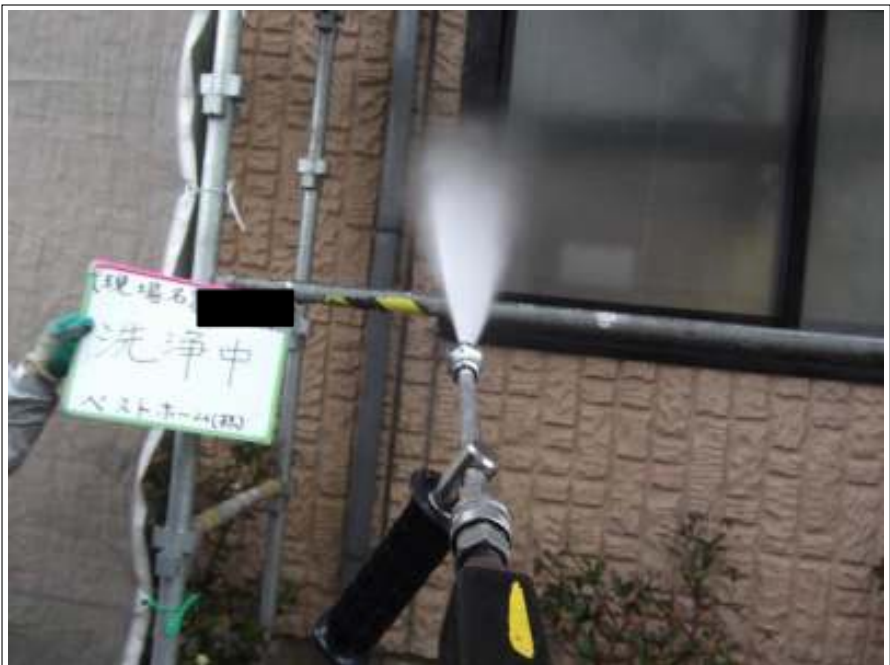
高圧洗浄施工中
