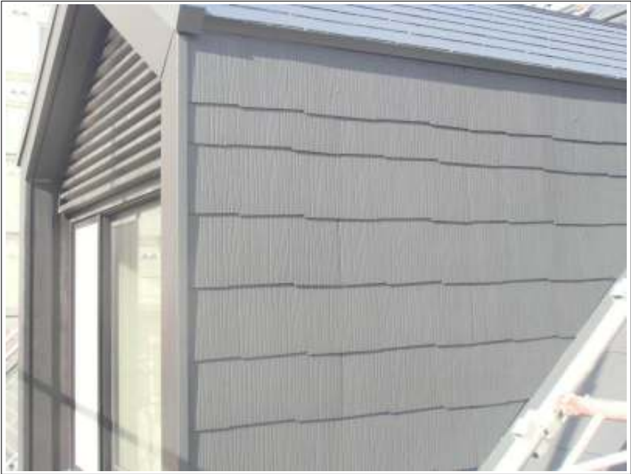
屋根塗装上塗り施工完了
