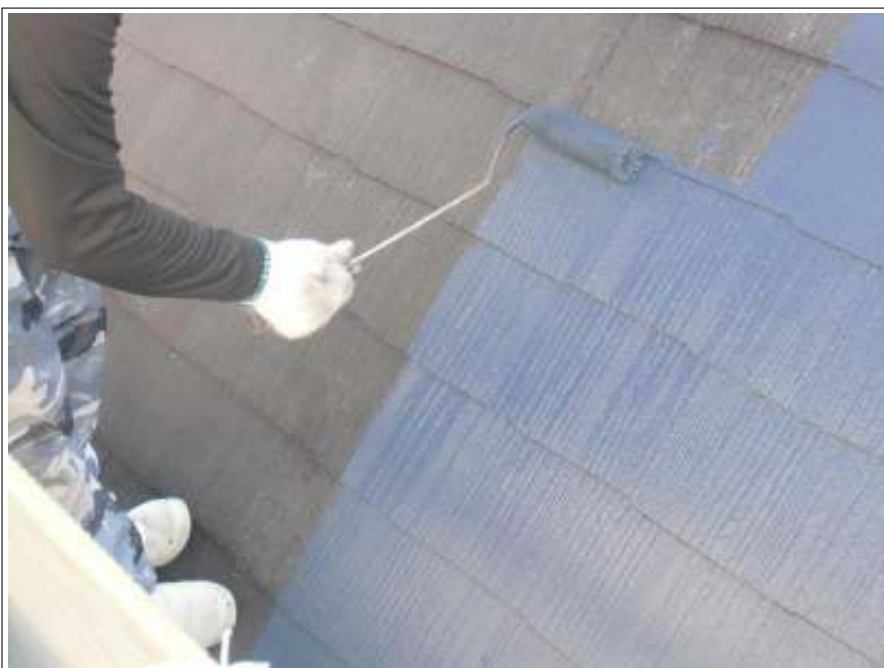
屋根塗装中塗り施工中
