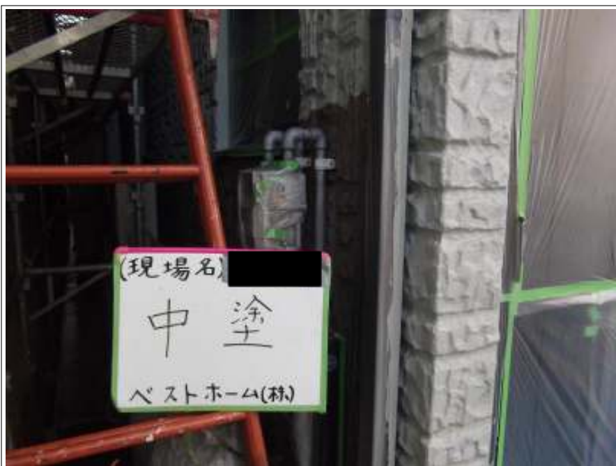
外壁塗装中塗り施工中
