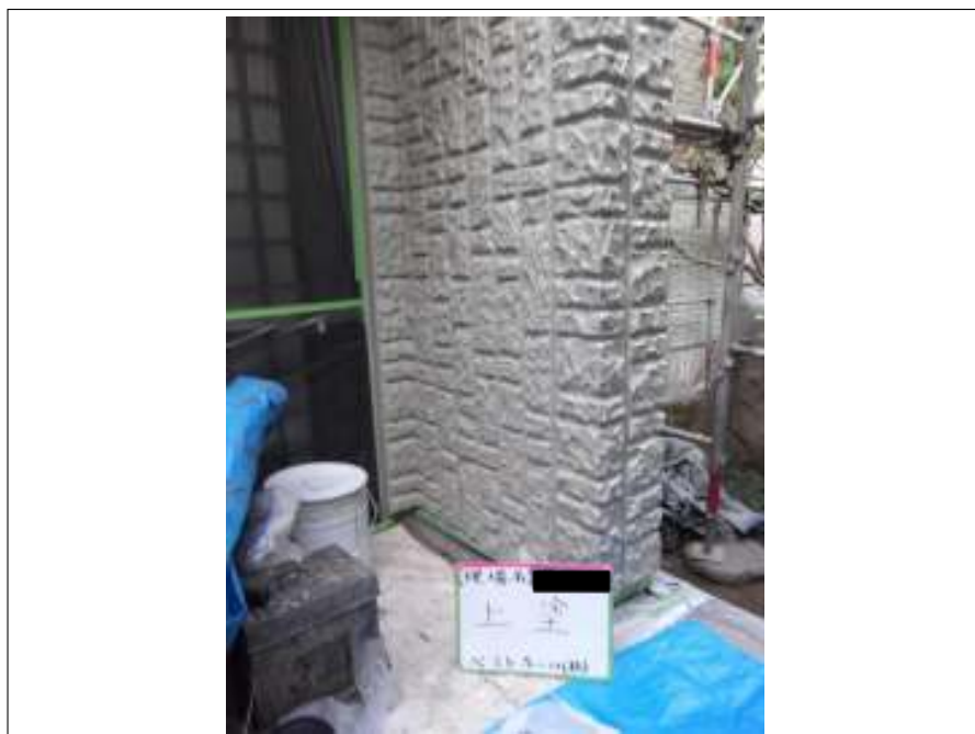
外壁塗装上塗り施工中
