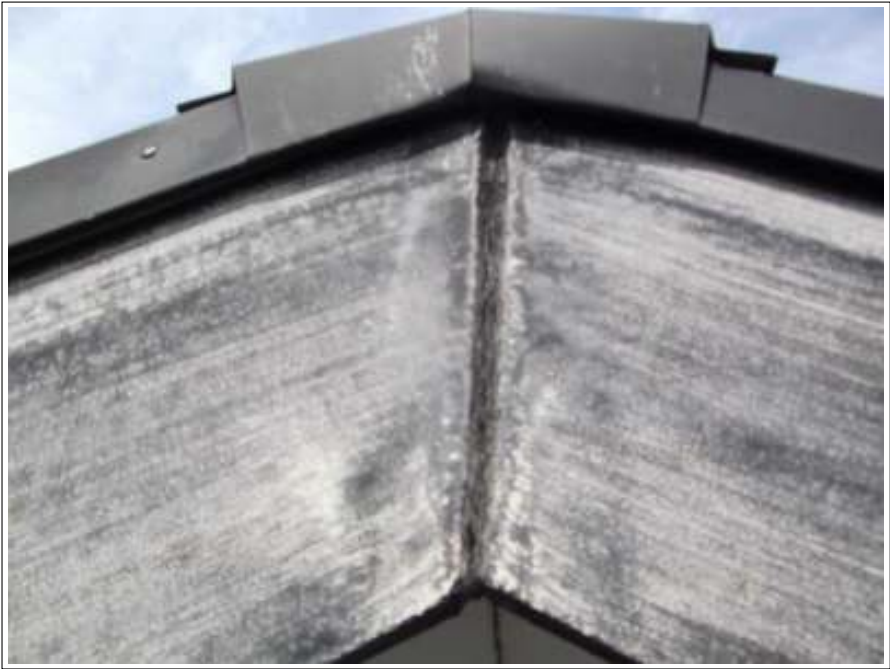
破風 シーリング打替え施工前
