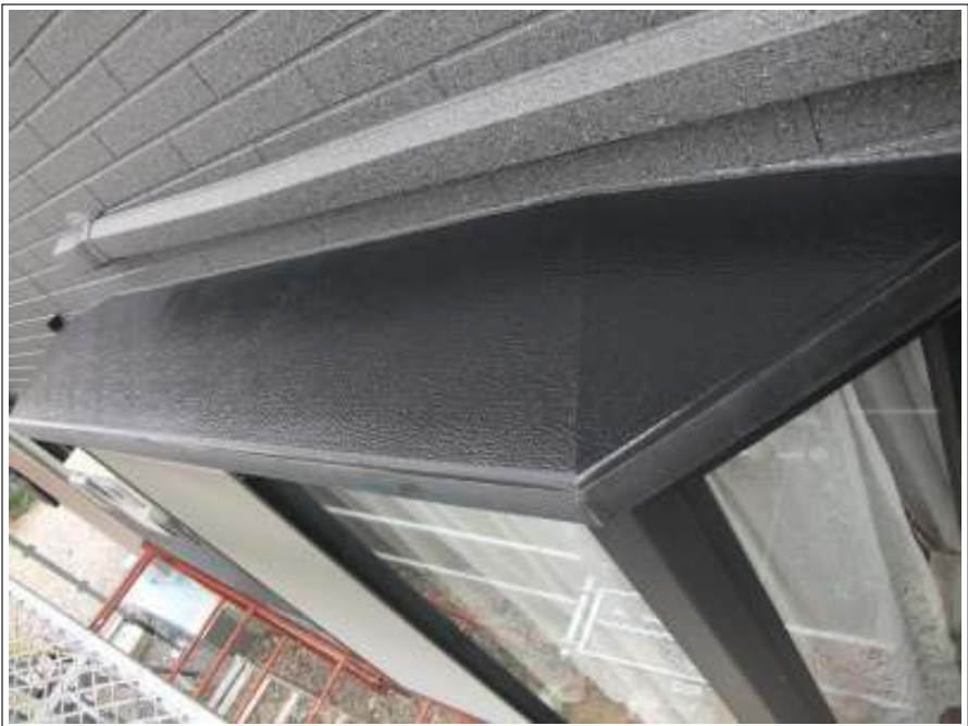
小庇 施工完了
