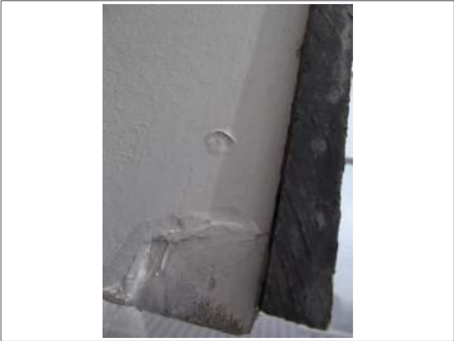
破風 施工完了
