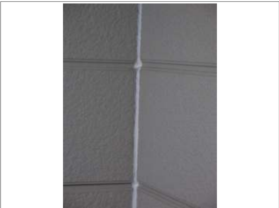
外壁 シーリング打替え施工完了
