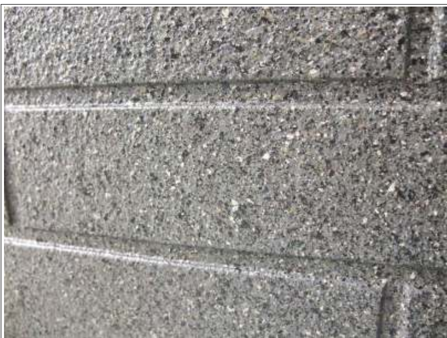
外壁 上塗り施工完了
