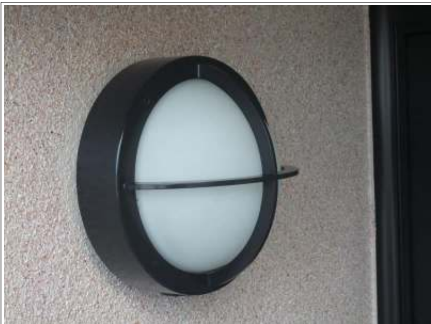
玄関ライト 施工完了
