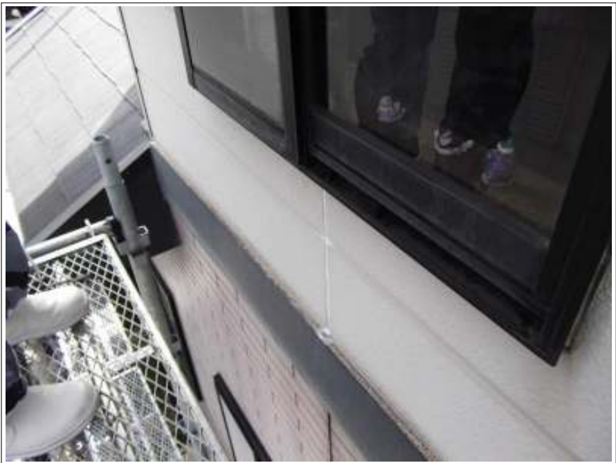
外壁 シーリング打替え施工完了
