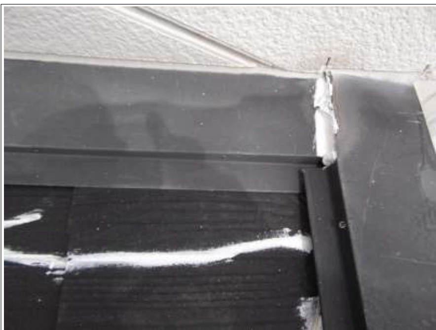
クラック補修施工完了
