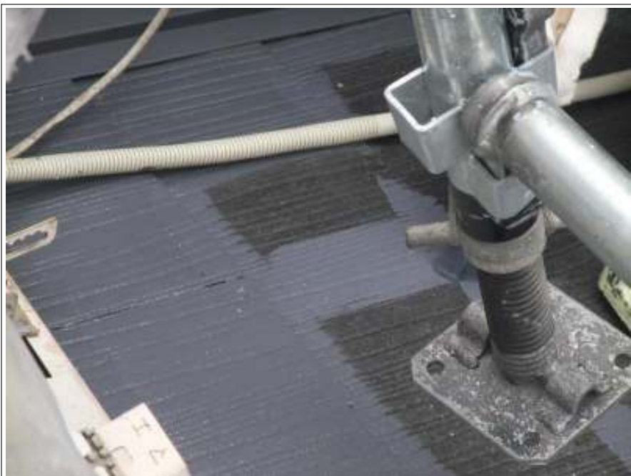
屋根 中塗り施工中
