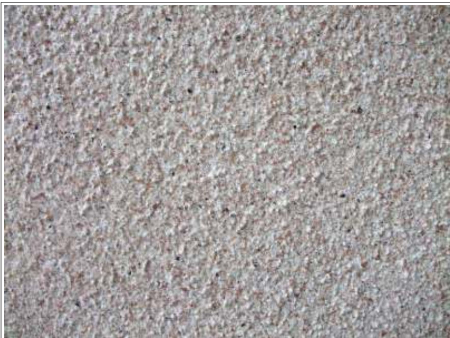
外壁 上塗り施工完了
