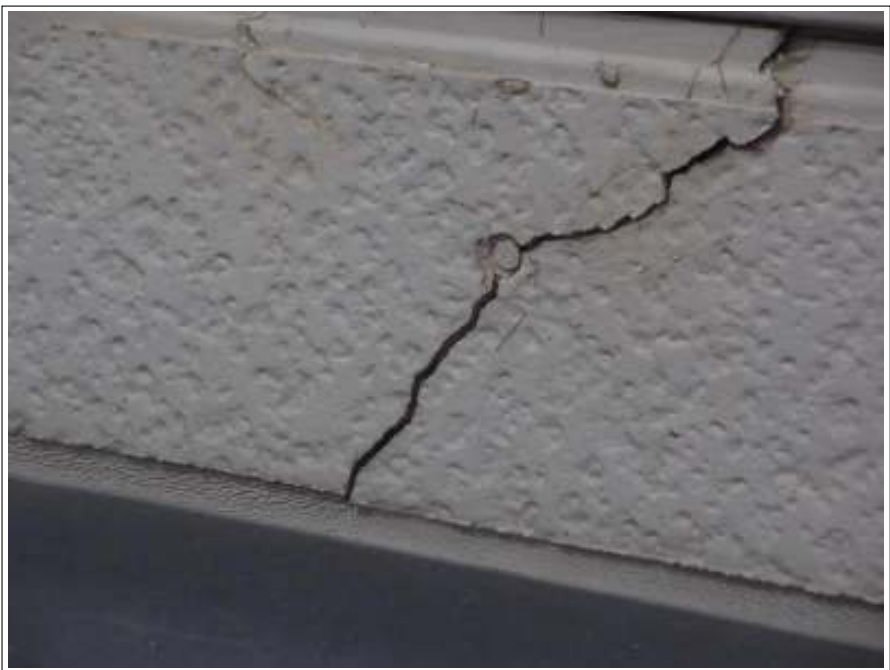
外壁 クラック補修施工中
