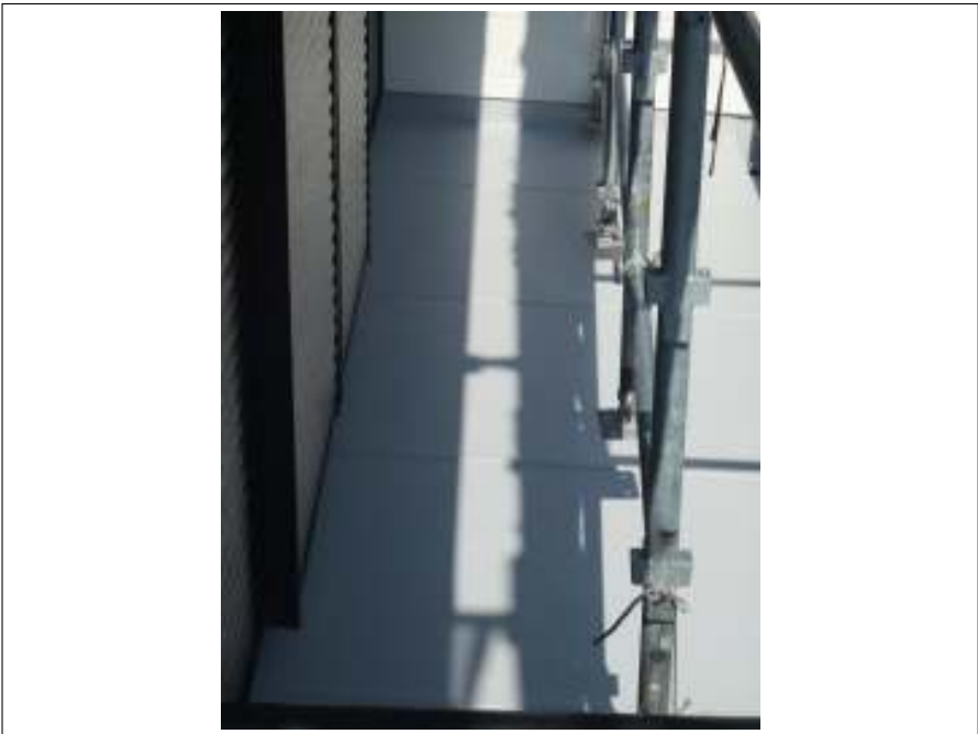
ベランダ床 施工完了
