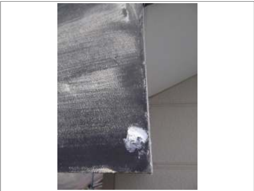
ビス補修 施工完了
