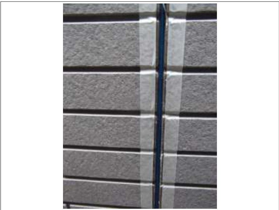
外壁 シーリング打替え施工中
