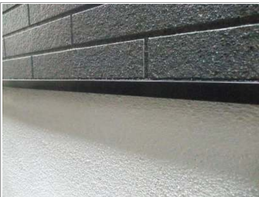
水切り 施工後
