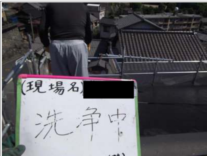
屋根 高圧洗浄中
