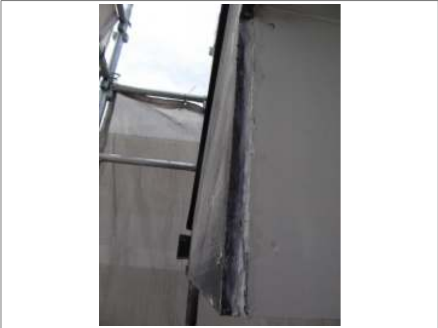
破風 シーリング補修施工完了
