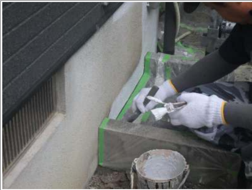
基礎塗装 施工中
