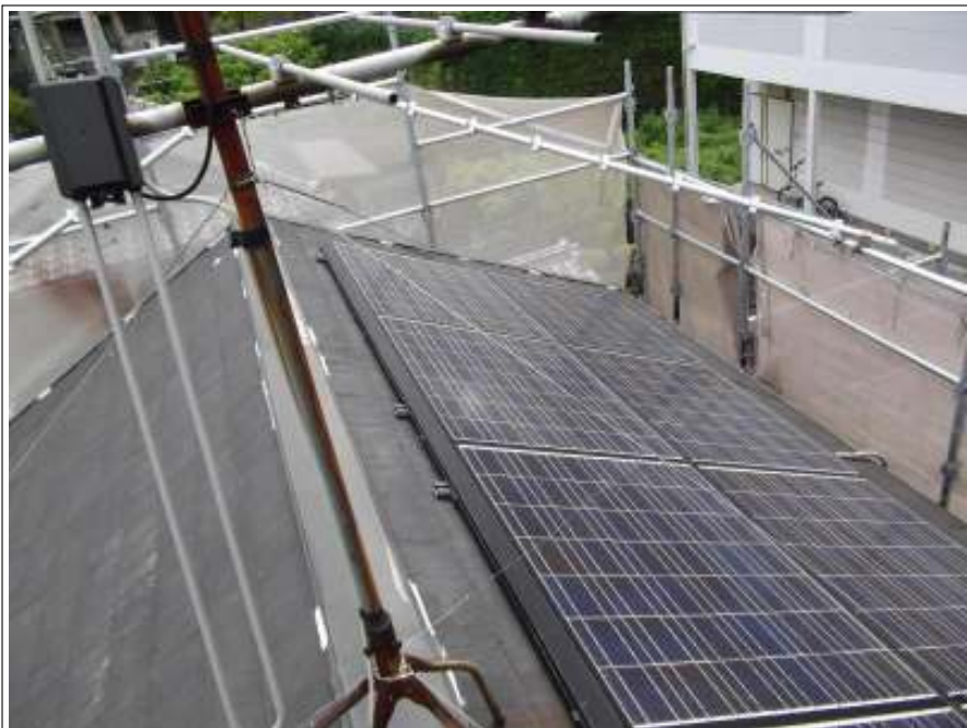
屋根 ラバー止め施工完了
