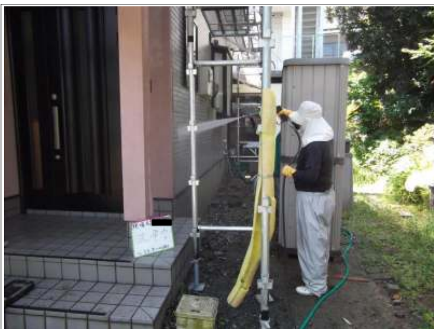
外壁 高圧洗浄中
