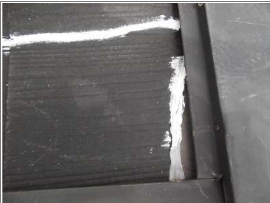
クラック補修施工完了
