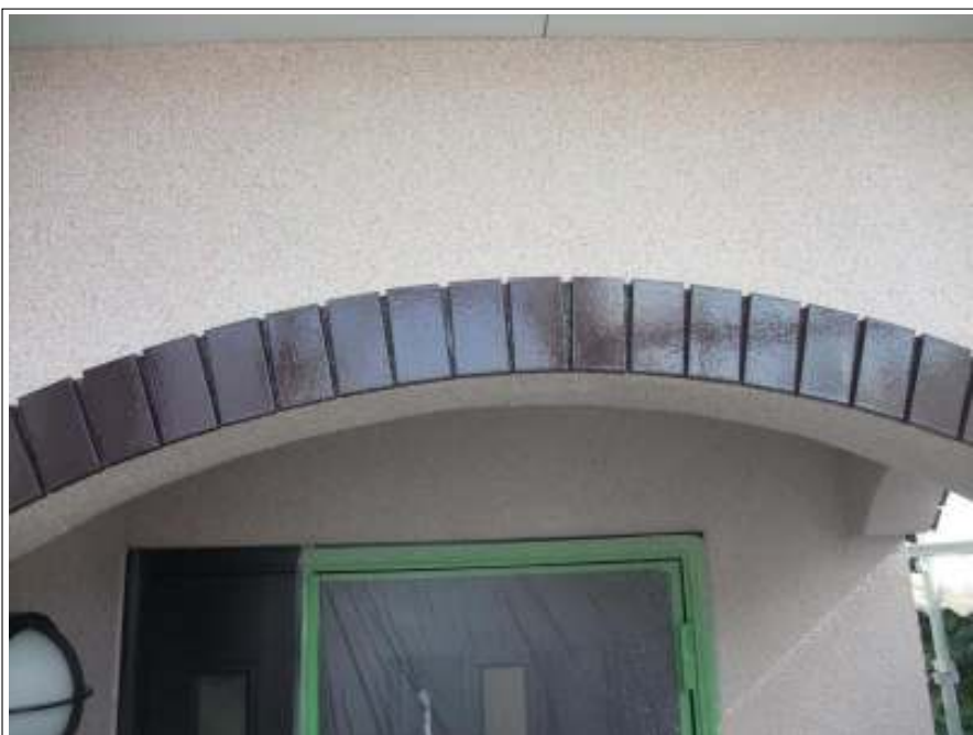
外壁（アクセント部）施工完了
