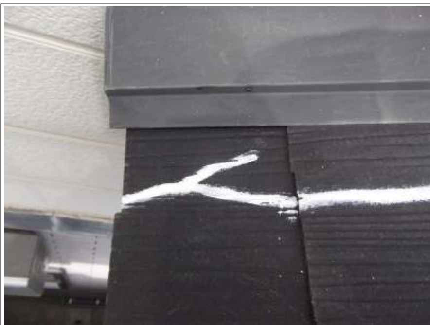
クラック補修施工完了
