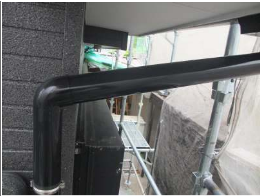
雨樋 施工完了
