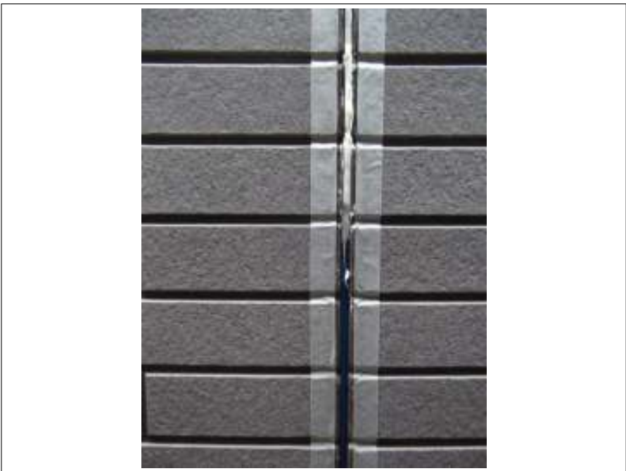
外壁 シーリング打替え施工中
