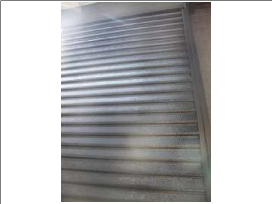
雨戸 施工完了
