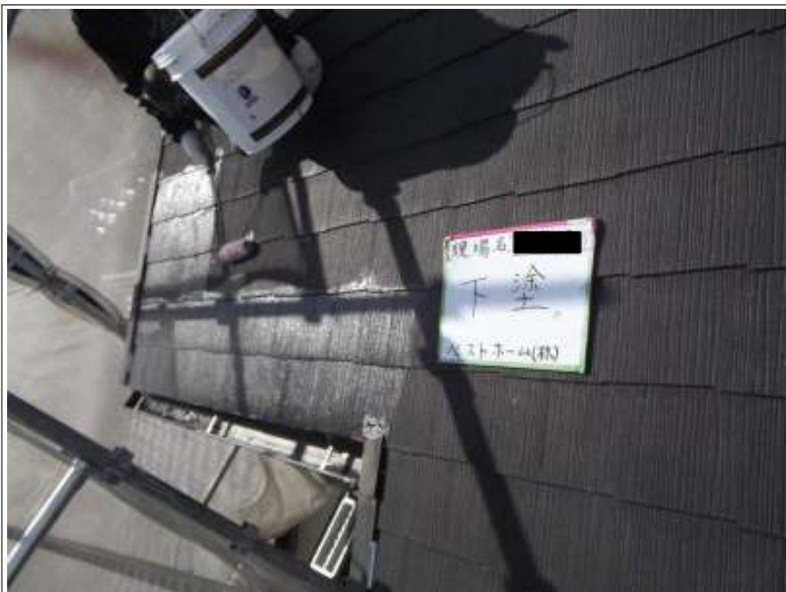
屋根 下塗り施工中
