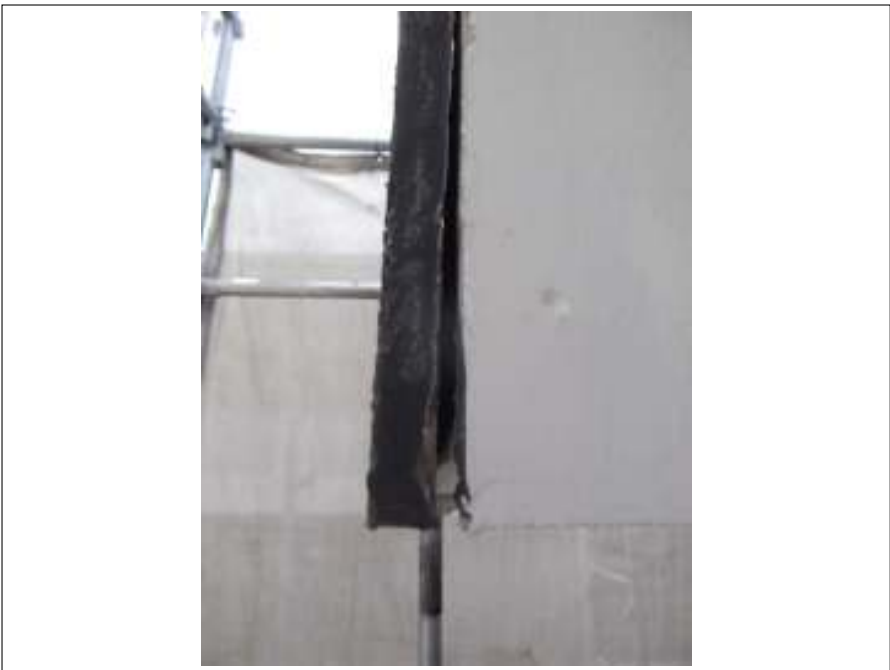
破風 シーリング補修施工前
