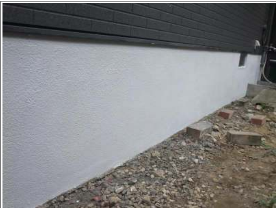
基礎塗装 施工完了
