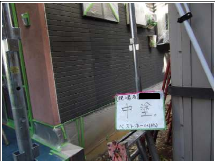
外壁 中塗り施工中
