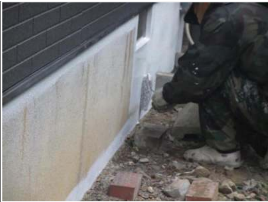
基礎塗装 施工中
