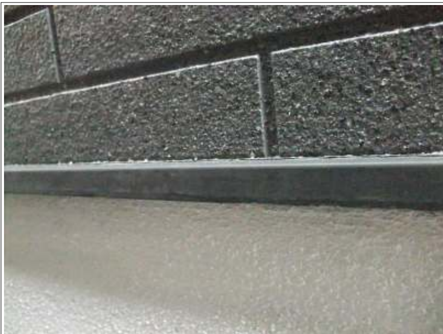
水切り 施工前
