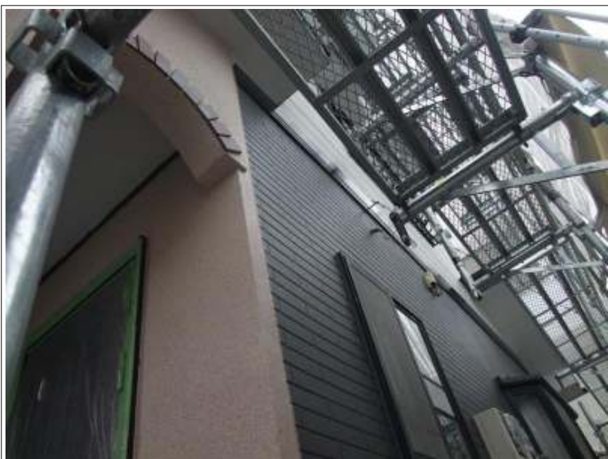
外壁 上塗り施工完了
