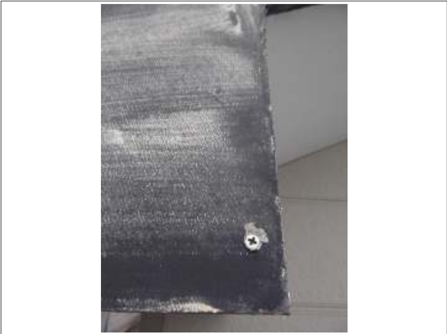
ビス補修 施工完了
