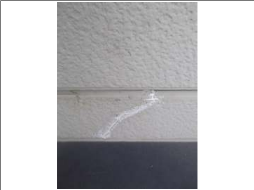
外壁 クラック補修施工完了
