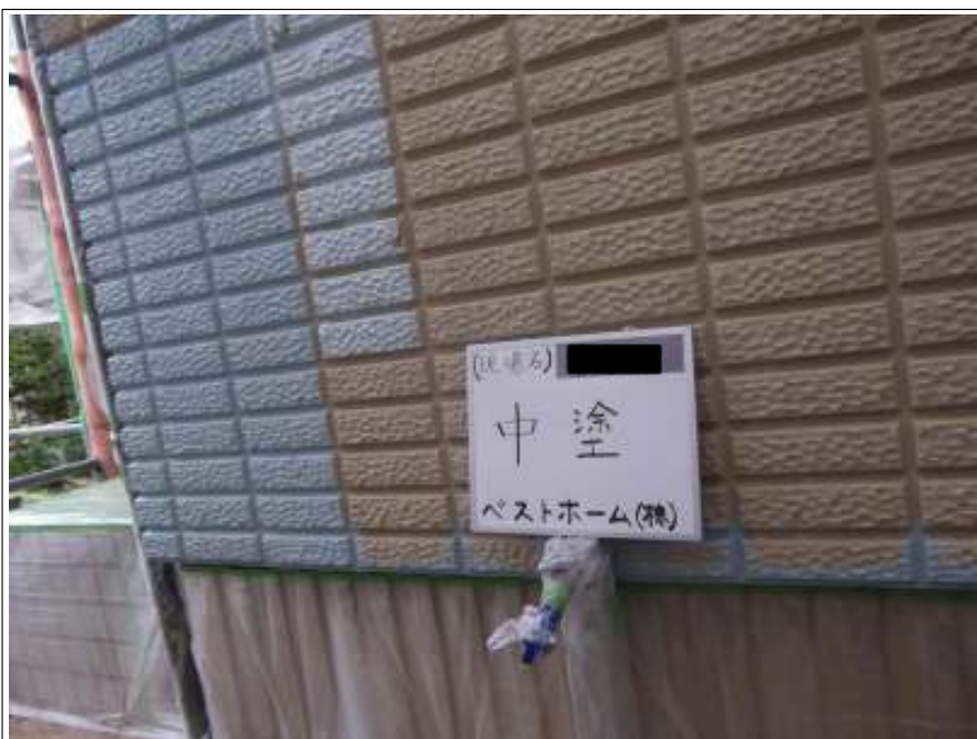
外壁 中塗り施工中
