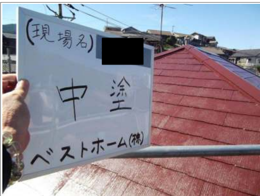
屋根 中塗り施工中
