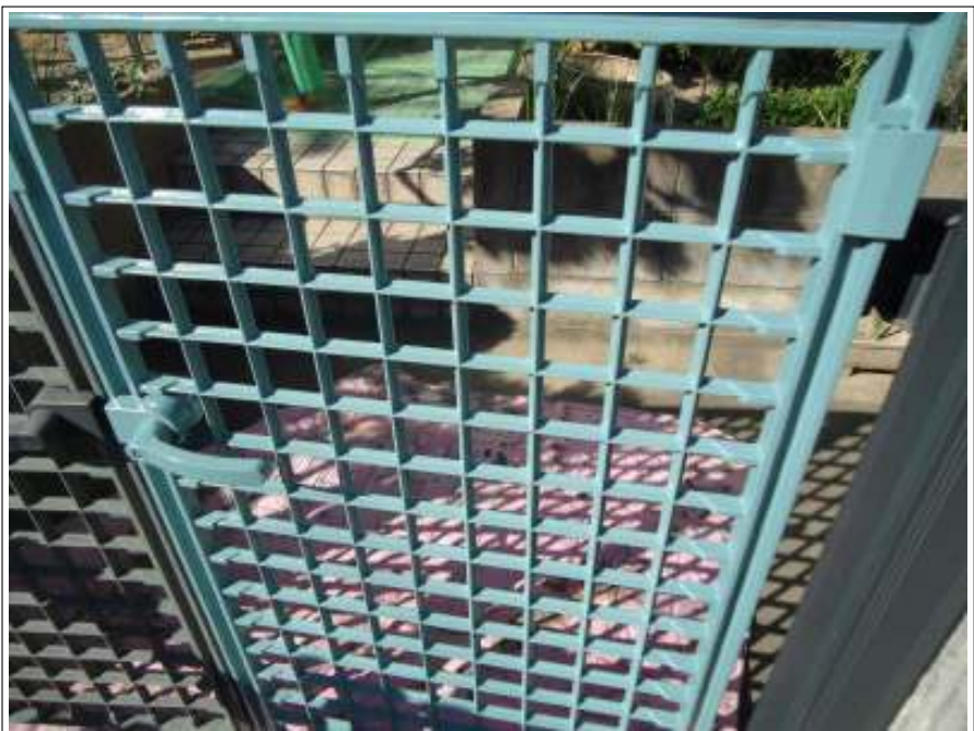
門扉 上塗り施工中
