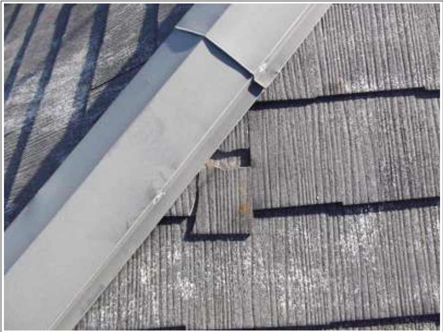
屋根 クラック補修 施工前
