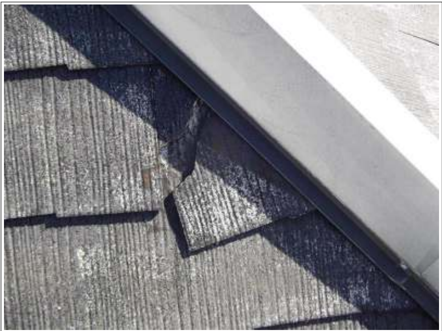
屋根 クラック補修 施工前
