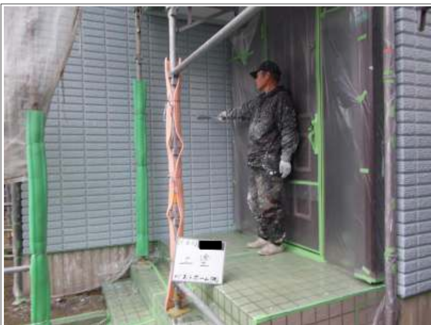
外壁 上塗り施工中
