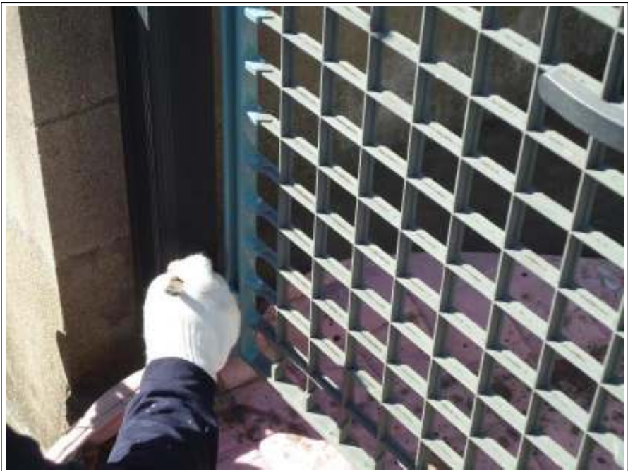
門扉 上塗り施工中
