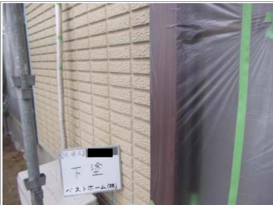
外壁 下塗り施工完了
