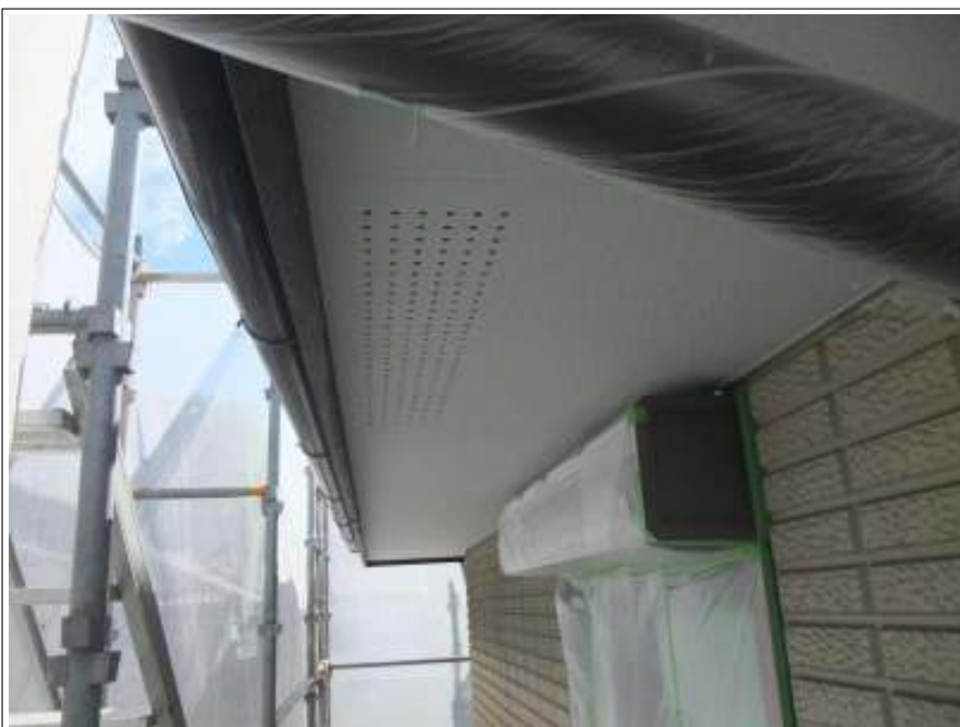
軒天 施工完了
