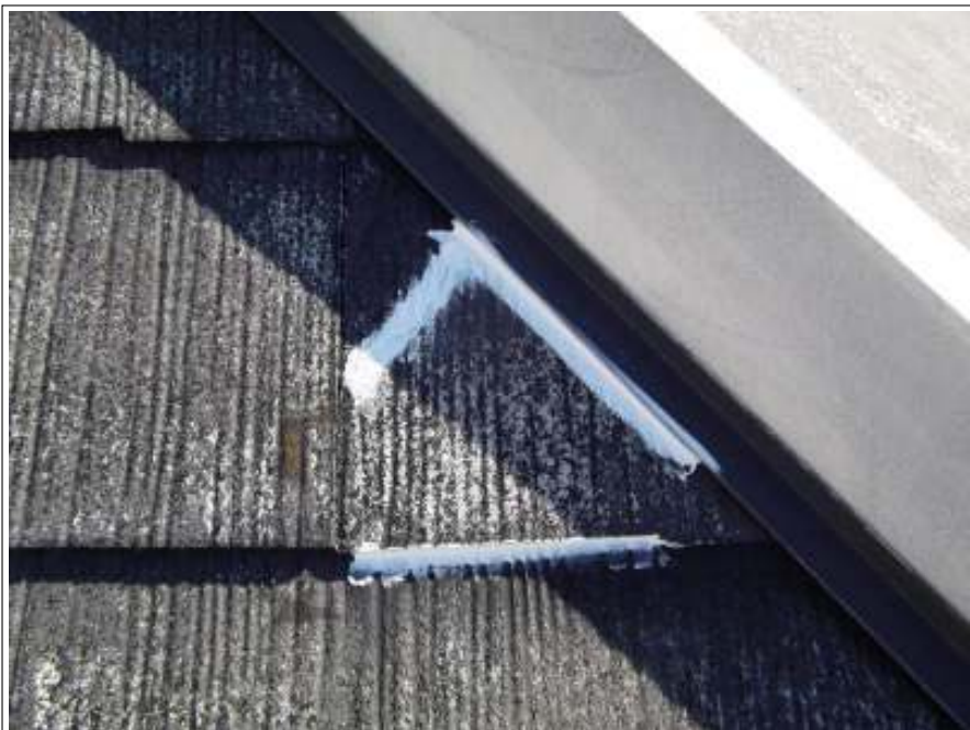
屋根 クラック補修 施工完了
