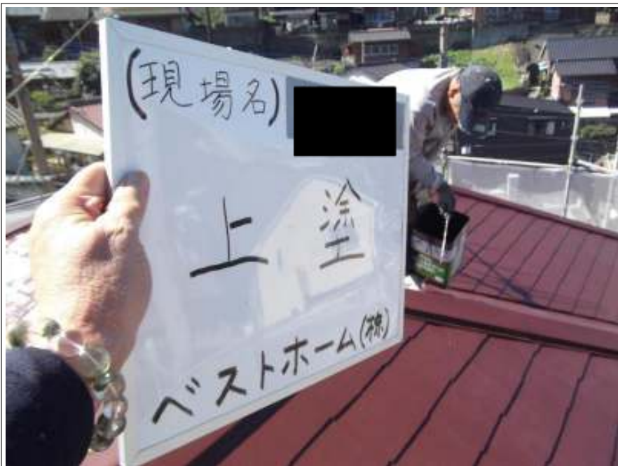
屋根 上塗り施工中
