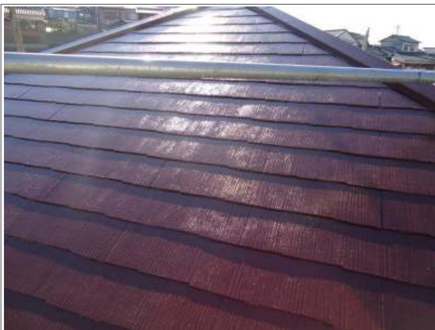
屋根 上塗り施工完了
