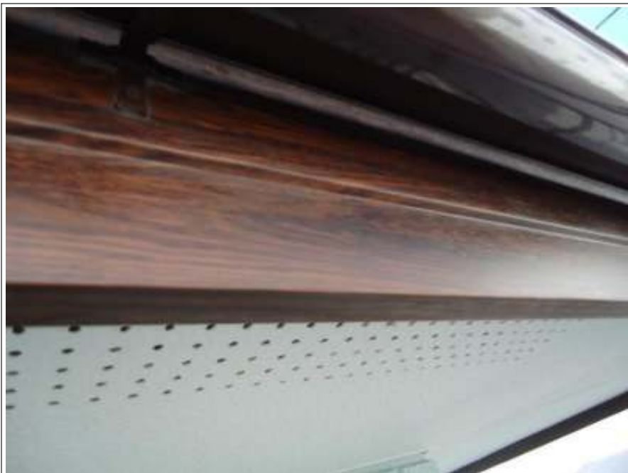
破風板 施工完了
