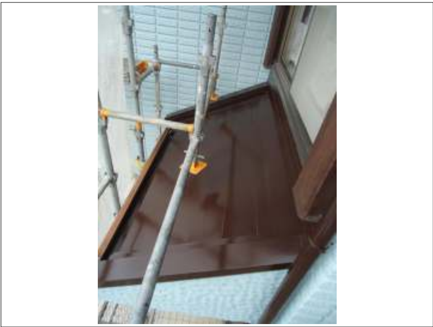
小庇 施工完了
