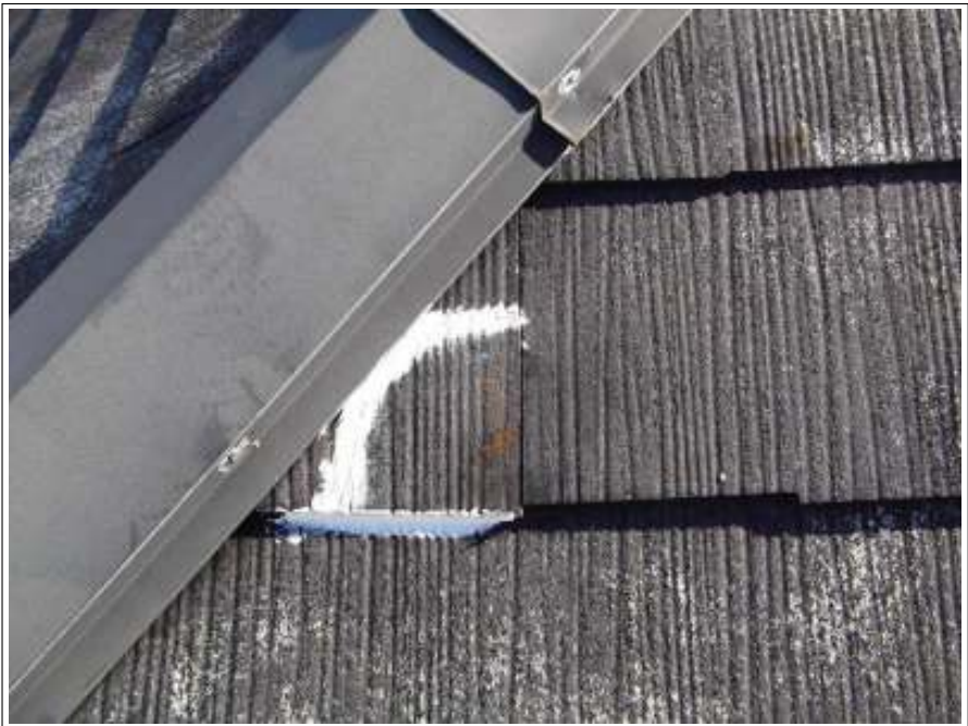
屋根 クラック補修 施工完了
