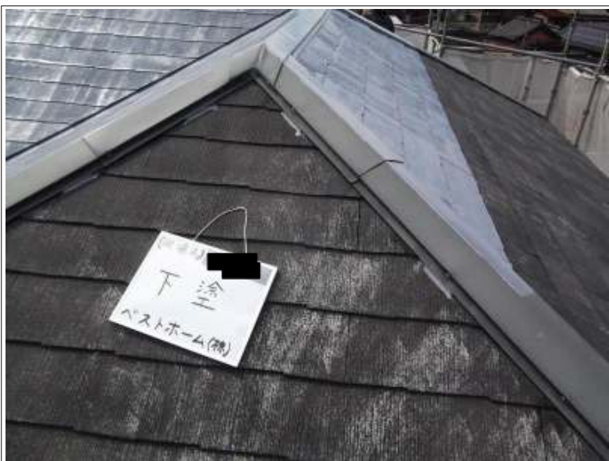
屋根 下塗り施工中
