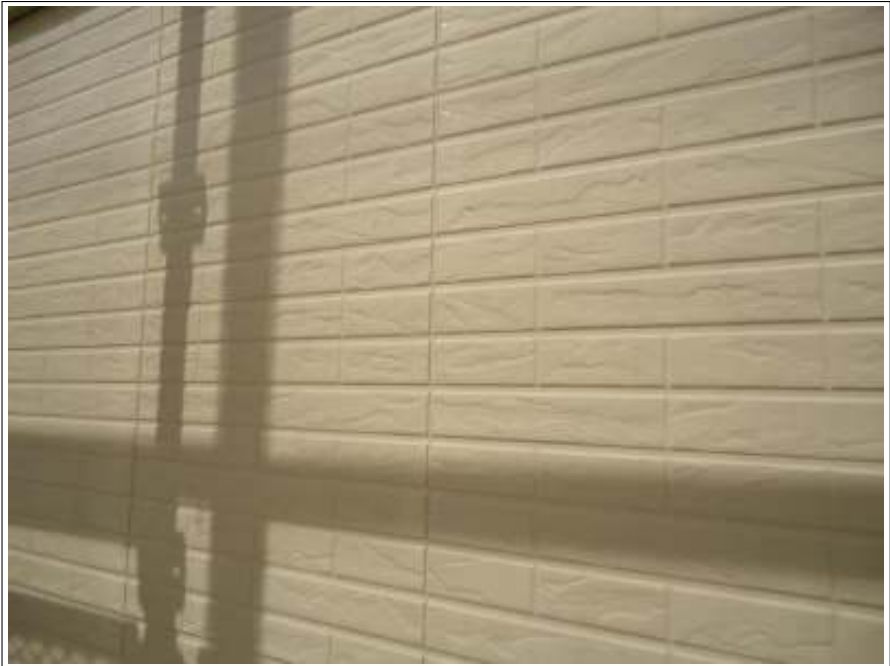
外壁（目地色）施工完了
