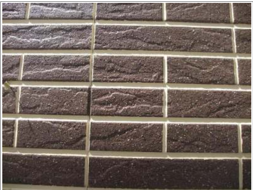
外壁上塗り施工完了
