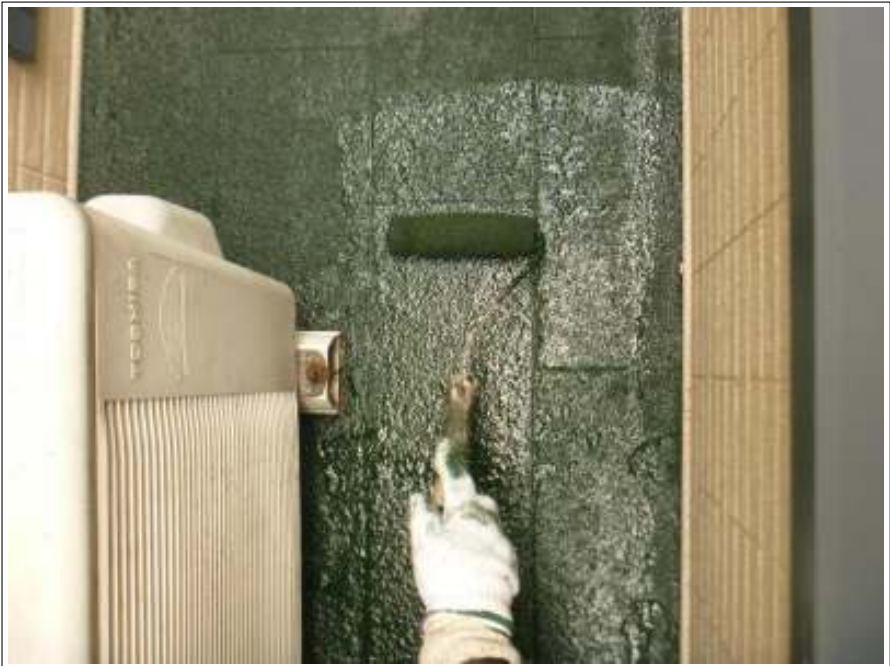
バルコニー上塗り2回目施工中
