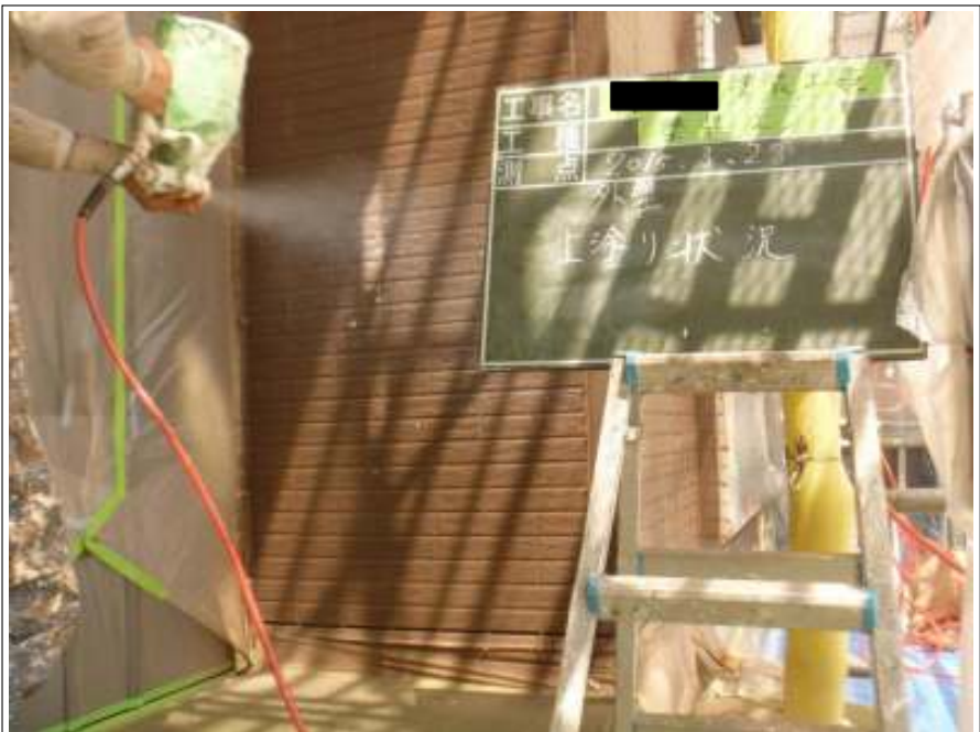
外壁上塗り施工中
