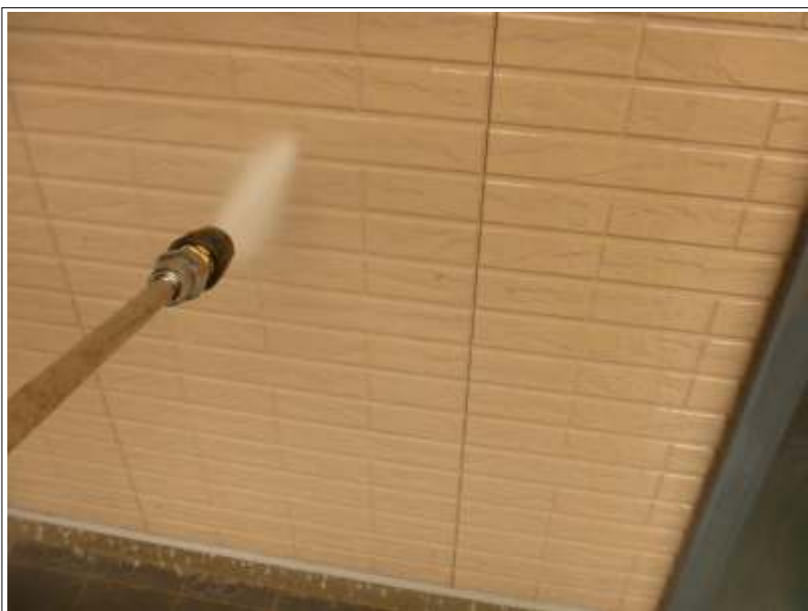
外壁高压洗浄中
