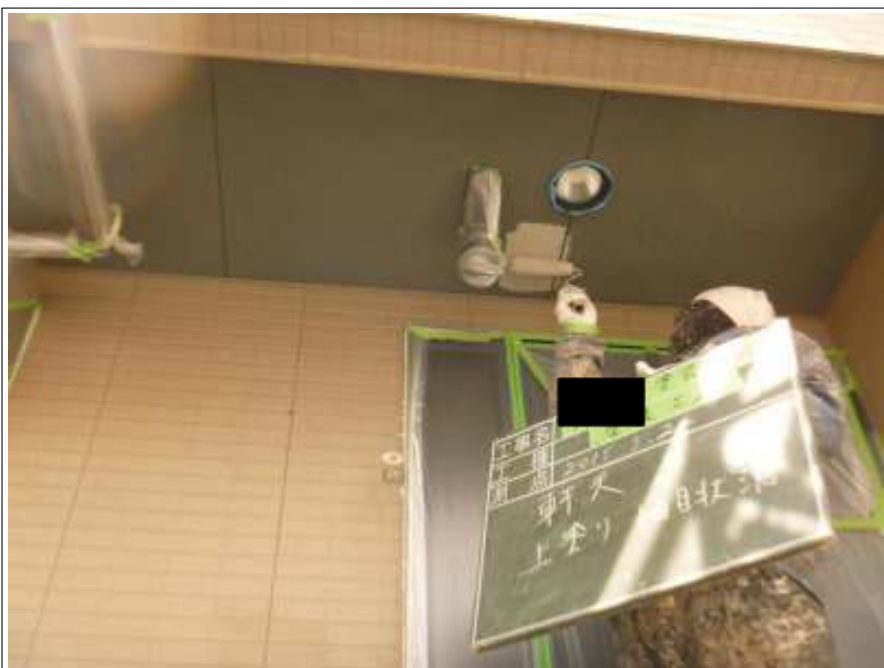
軒天上塗り施工中
