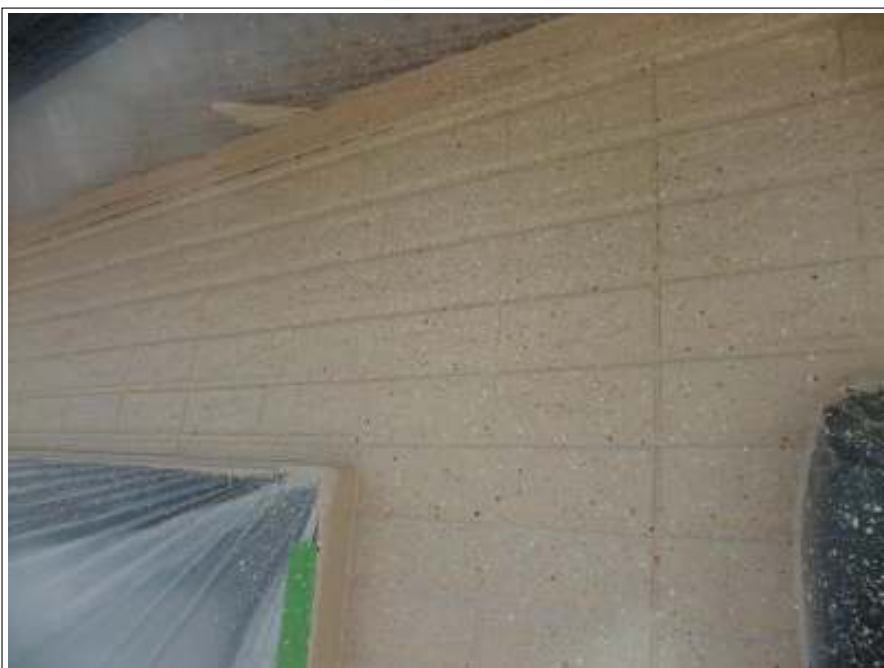
外壁上塗り施工完了
