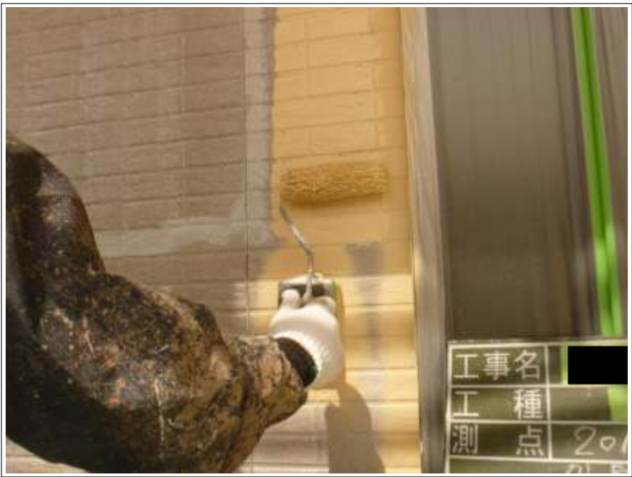
外壁（目地色）施工中
