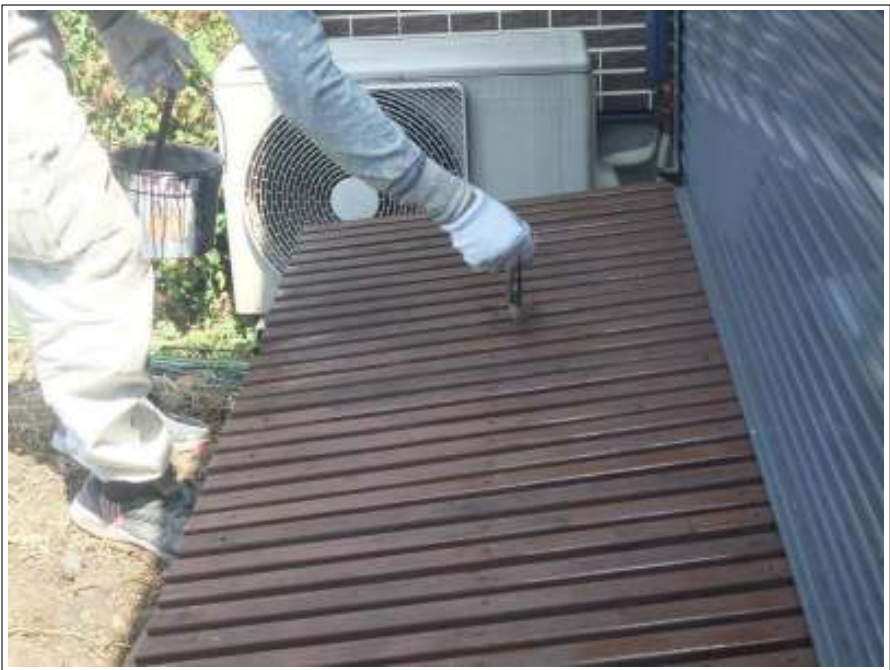
ウッドデッキ塗装施工中
