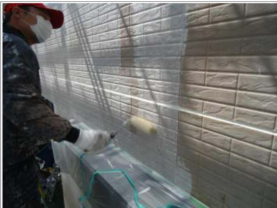
外壁下塗り施工中
