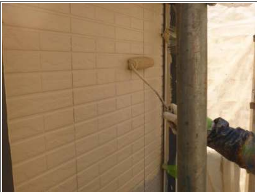
外壁（側面部）中塗り施工中
