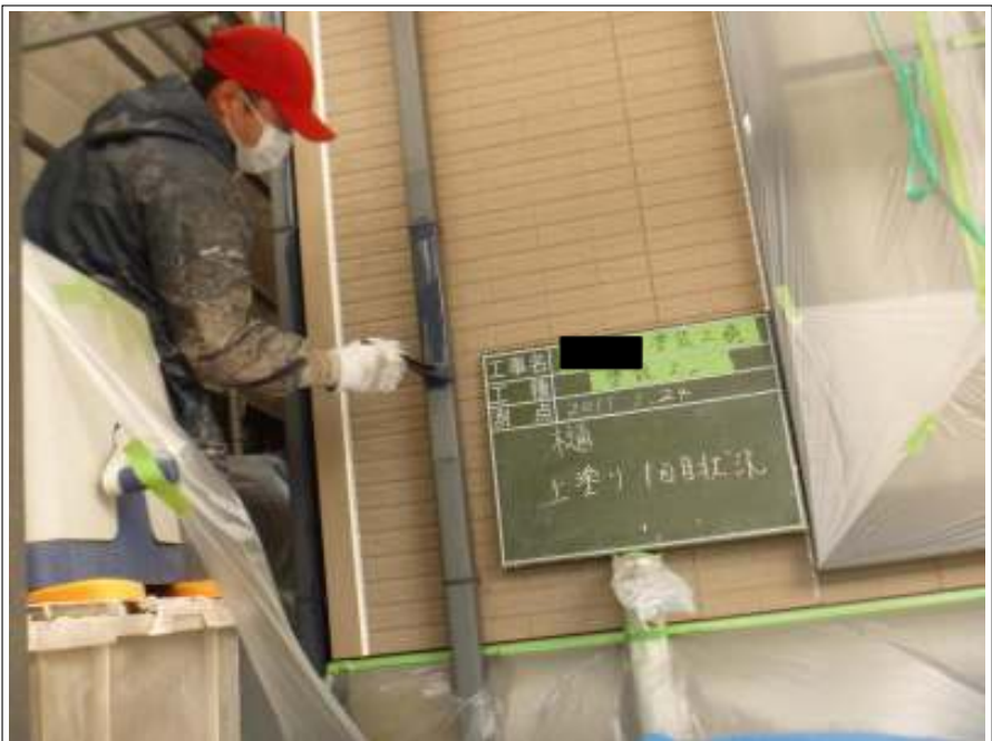
樋上塗り施工中
