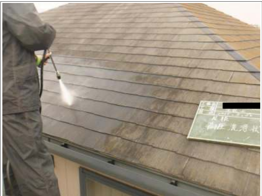
屋根高压洗浄中
