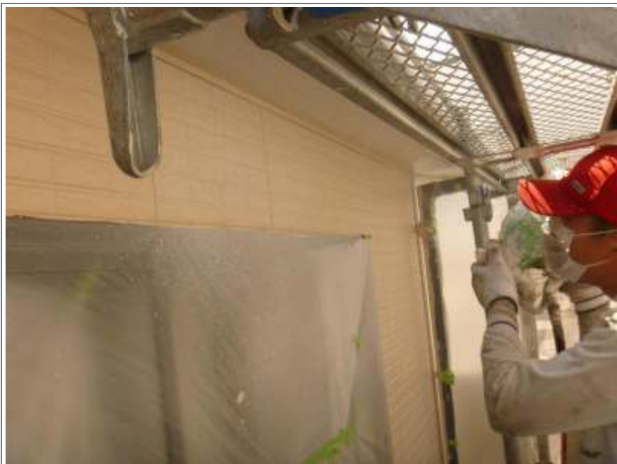
外壁上塗り施工中
