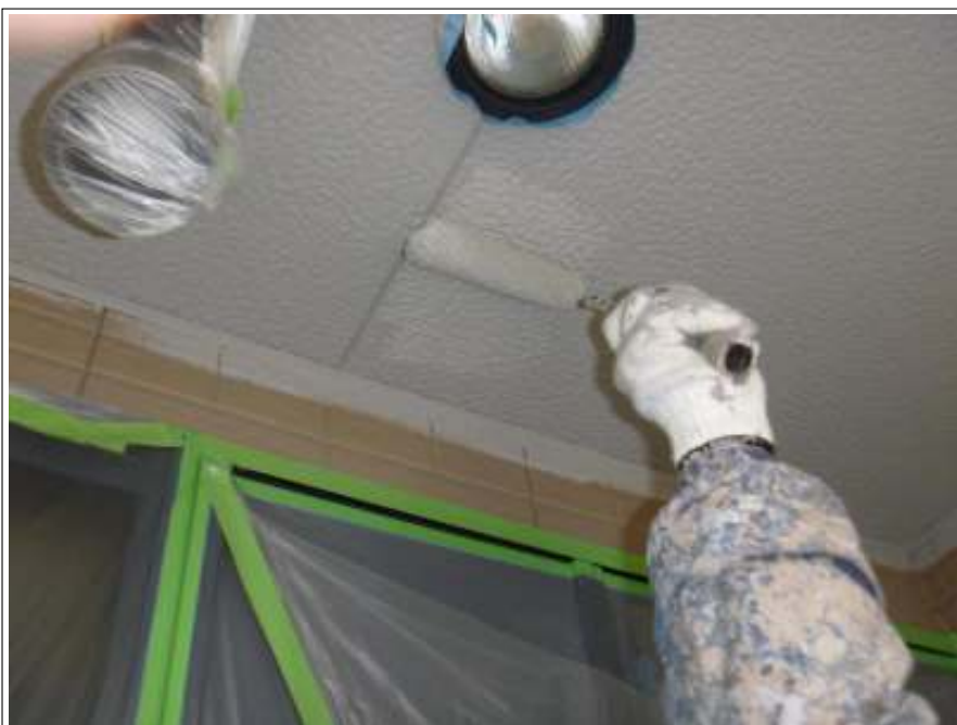
軒天上塗り2回目施工中
