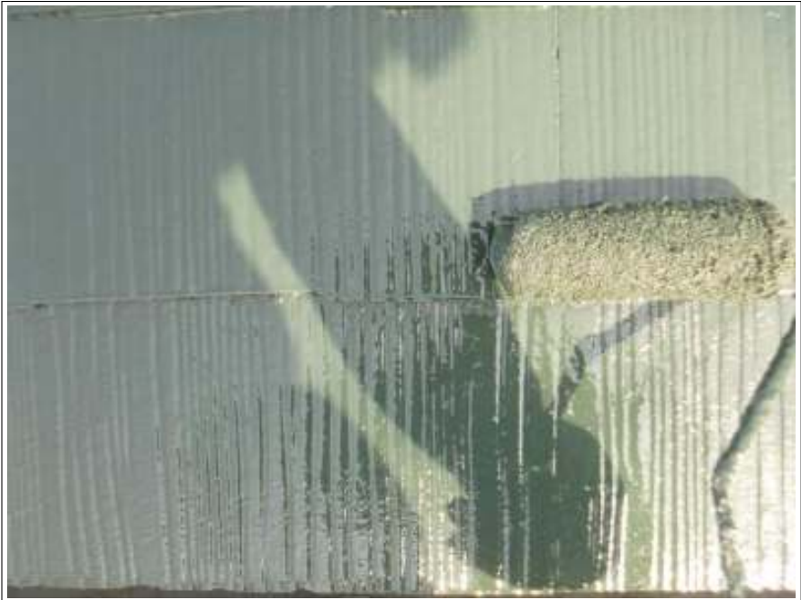
屋根上塗り施工中
