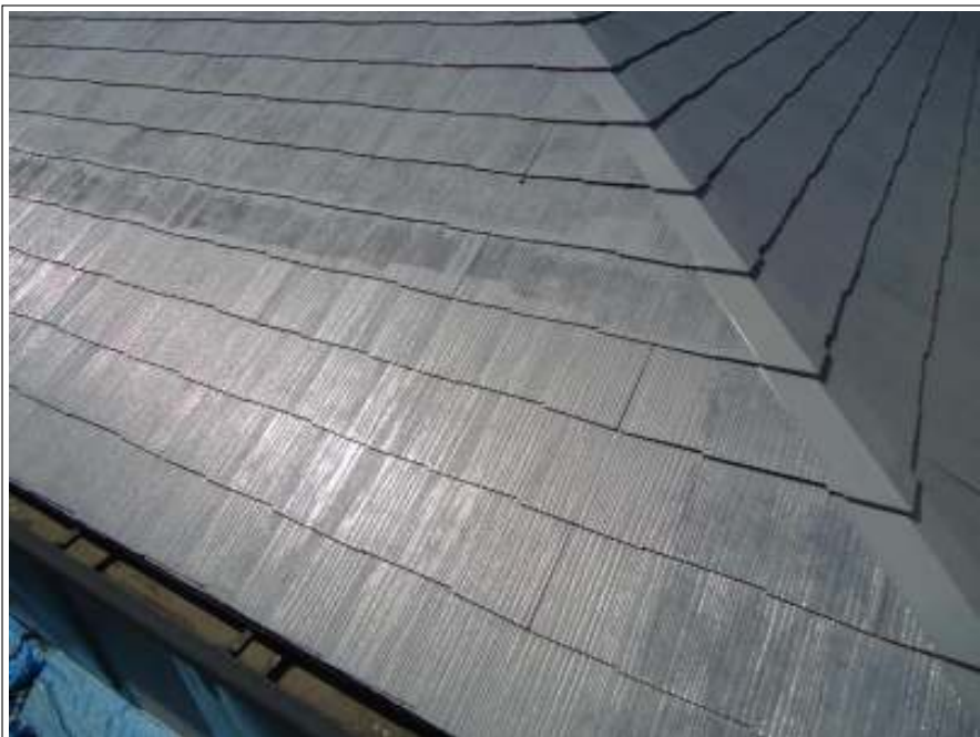
屋根下塗り施工完了
