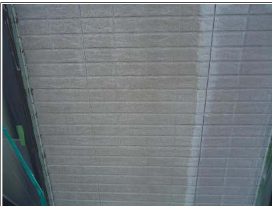
外壁下塗り施工完了
