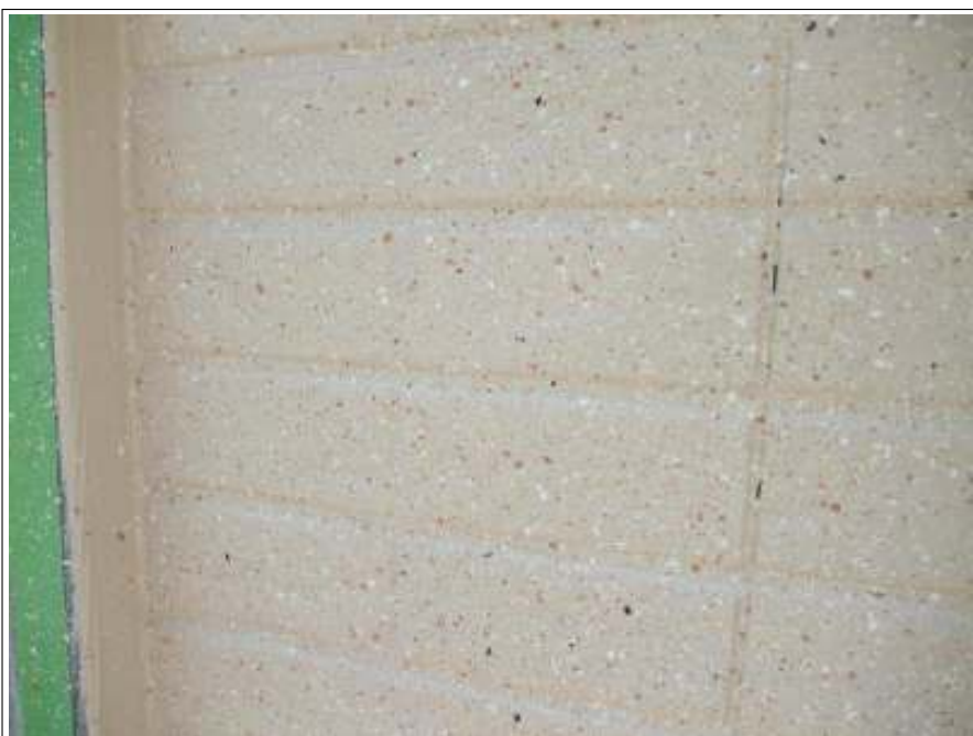
外壁上塗り施工完了
