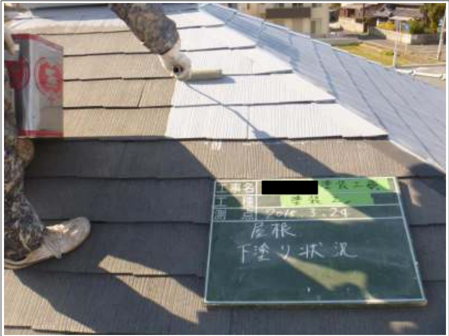
屋根下塗り施工中
