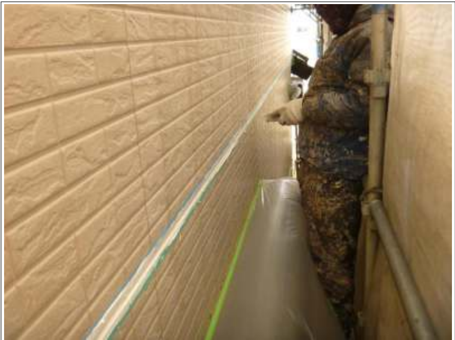
外壁シーリング打ち替え施工中
