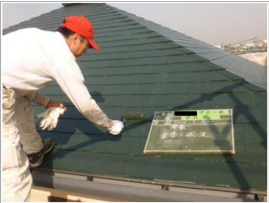
屋根上塗り施工中
