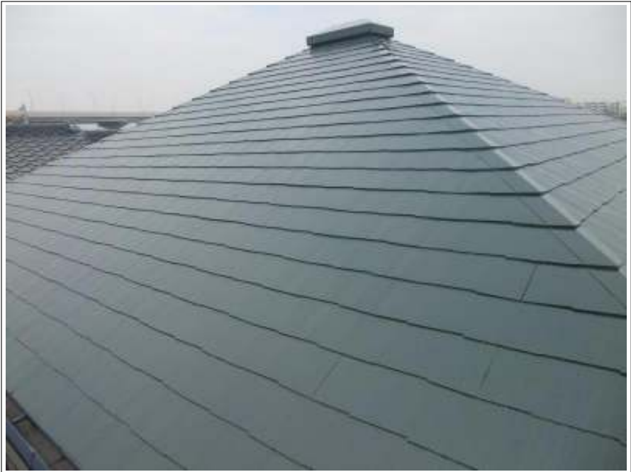
屋根上塗り施工完了
