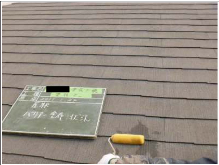
屋根バリアー施工中
