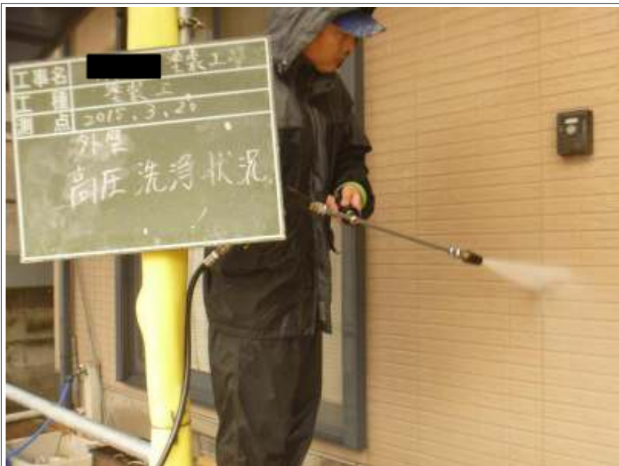
外壁高压洗浄中
