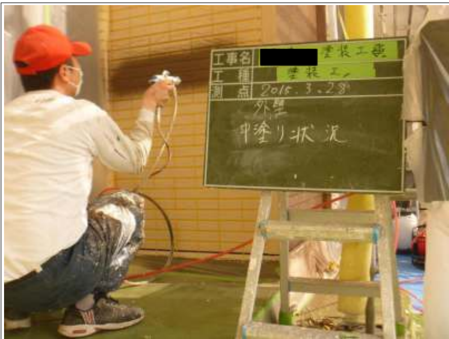
外壁中塗り施工中
