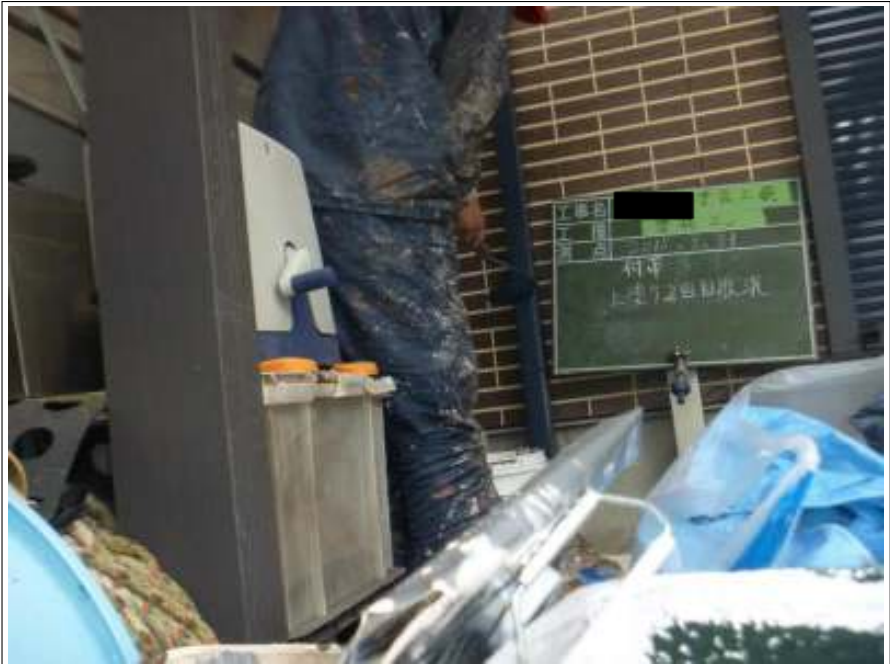
樋上塗り 2回目施工中
