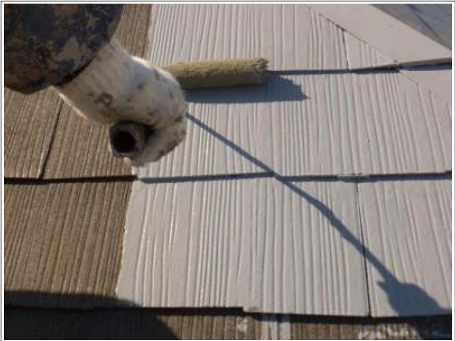
屋根下塗り施工中
