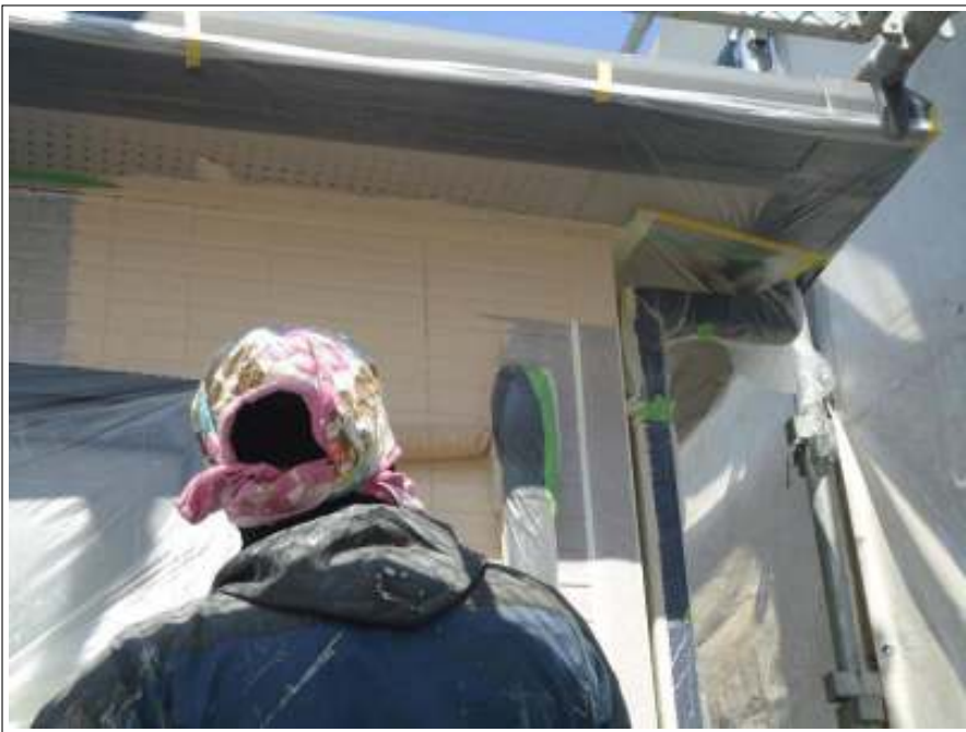
外壁中塗り施工中
