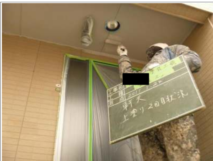
軒天上塗り2回目施工中
