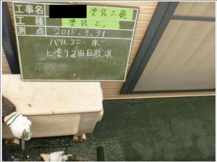
バルコニー上塗り2回目施工中
