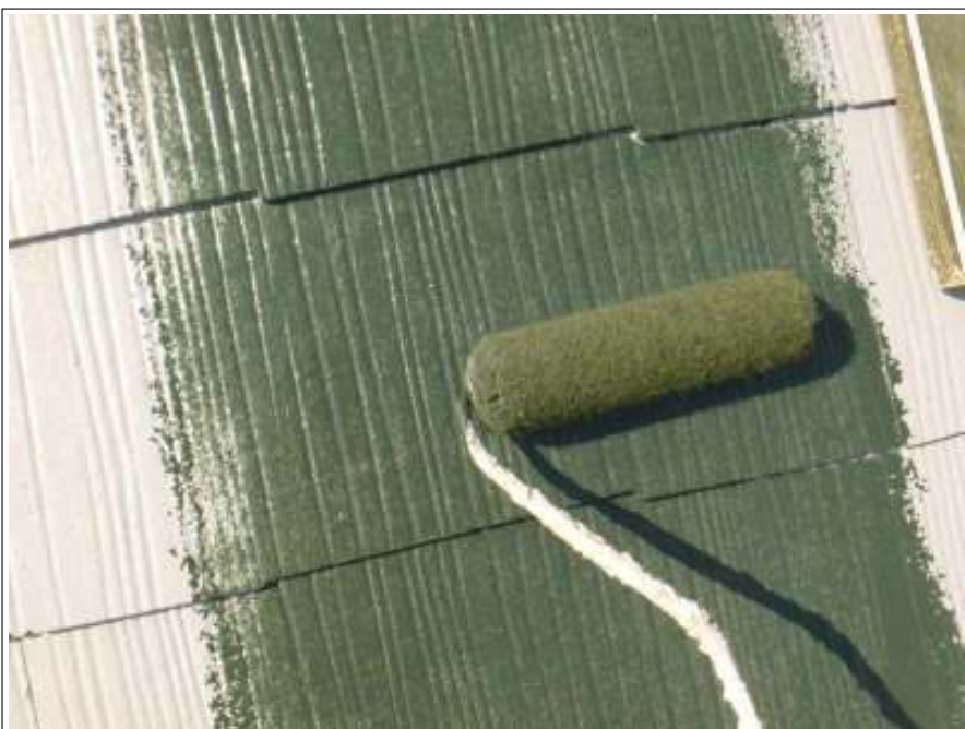
屋根中塗り施工中
