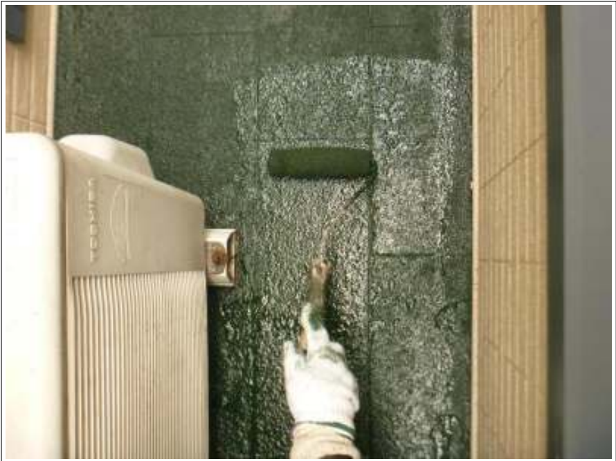
バルコニー上塗り施工中
