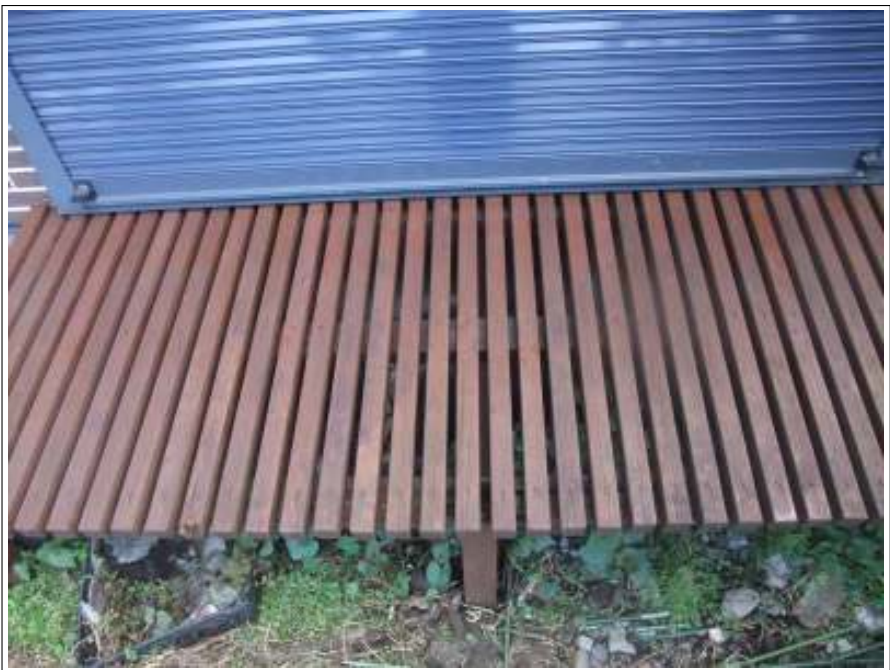
ウッドデッキ塗装施工完了
