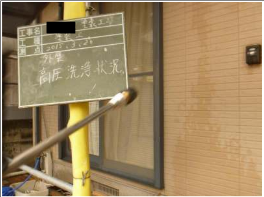
外壁高压洗浄中
