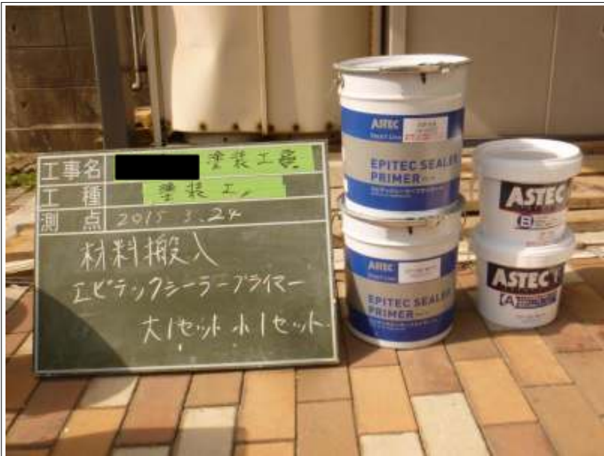
外壁下塗り使用塗料缶
