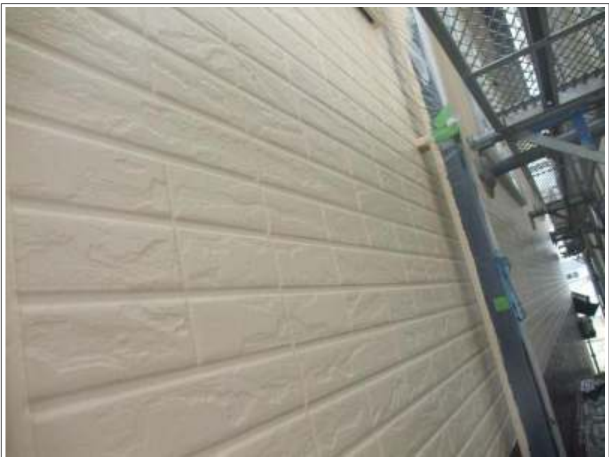
外壁上塗り施工完了
