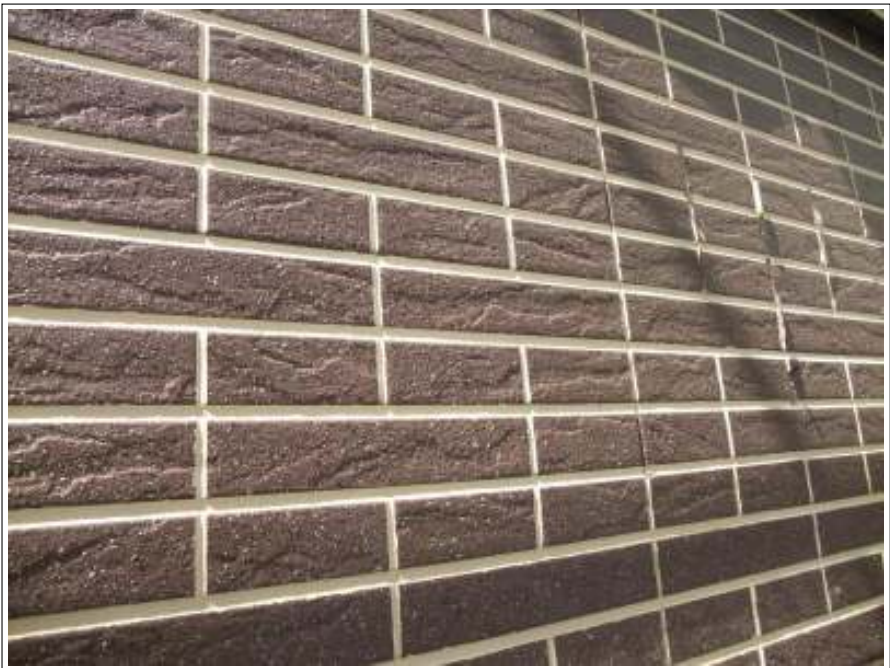
外壁上塗り施工完了
