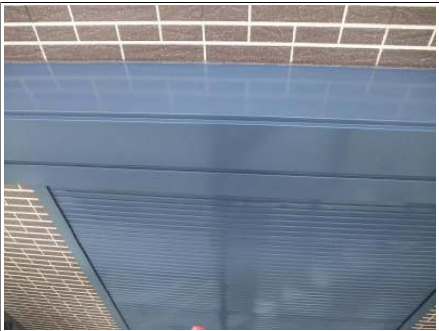
シャッター塗装施工完了
