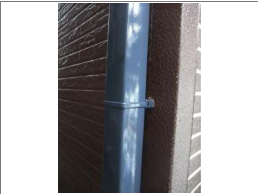
樋塗装施工完了
