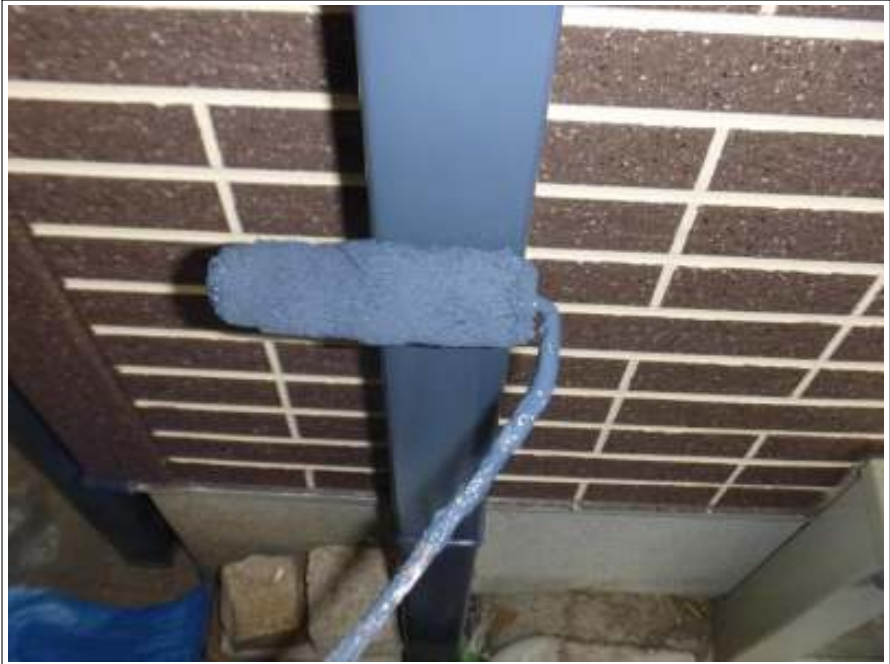
樋上塗り 2回目施工中
