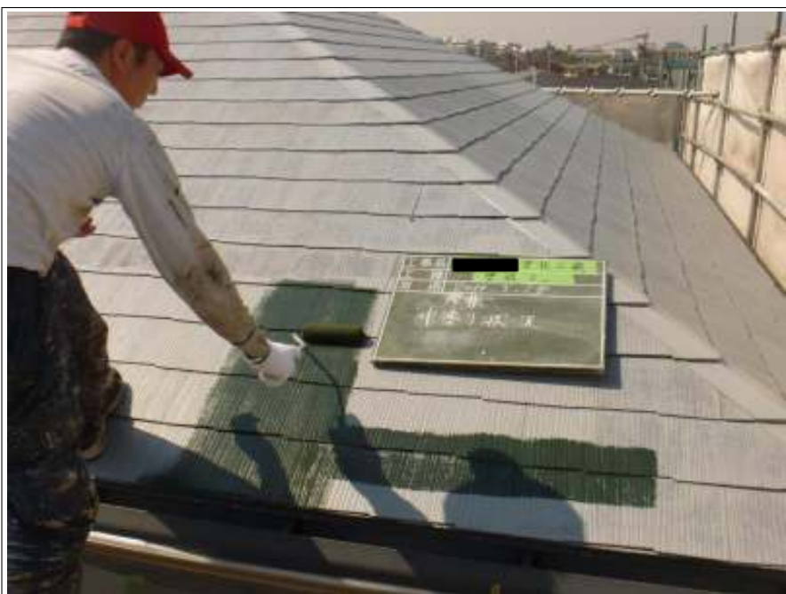
屋根中塗り施工中
