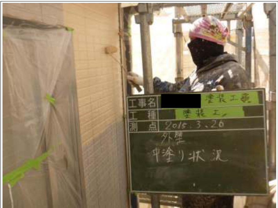
外壁（側面部）中塗り施工中
