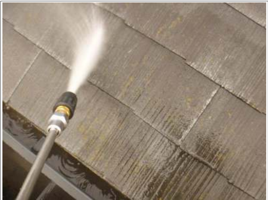
屋根高压洗浄中
