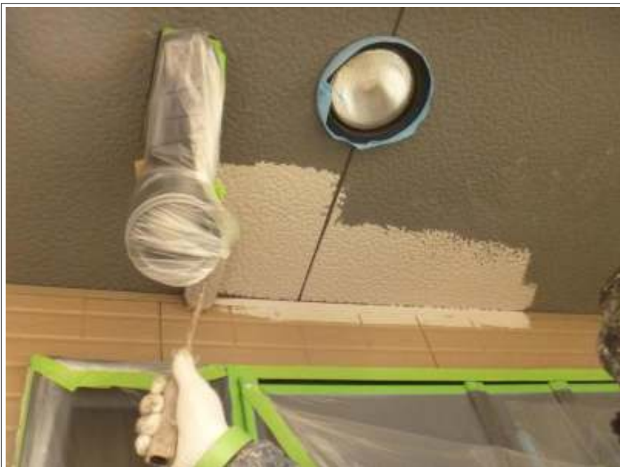
軒天上塗り施工中
