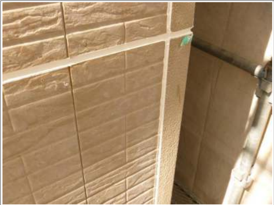
外壁シーリング打ち替え完了
