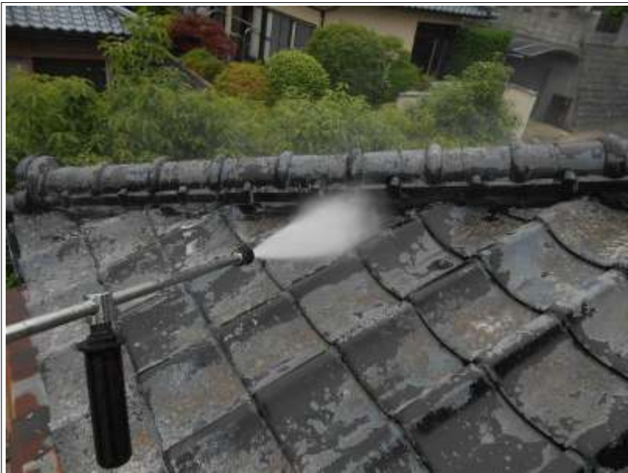
屋根 高圧洗浄中
