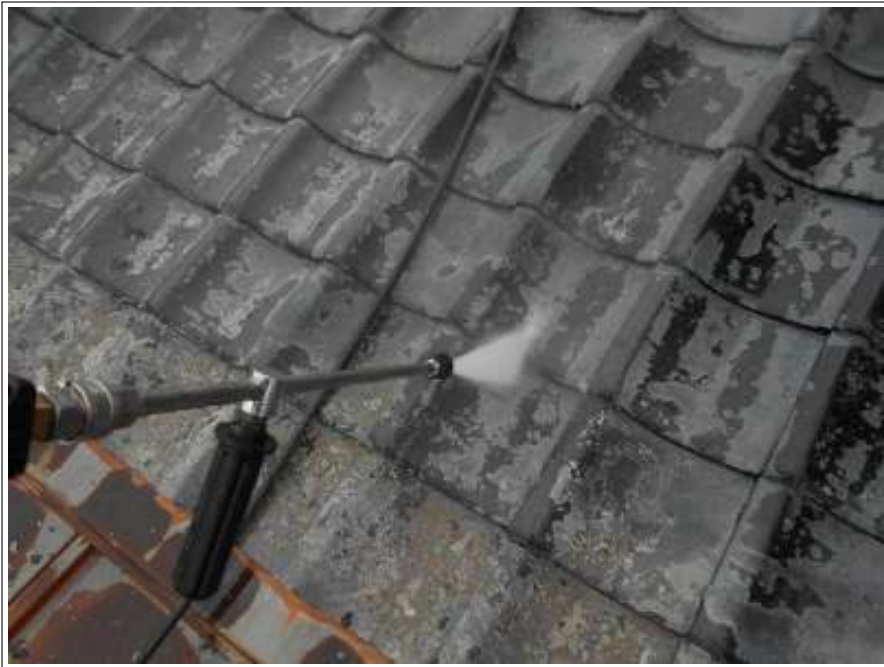
屋根 高圧洗浄中
