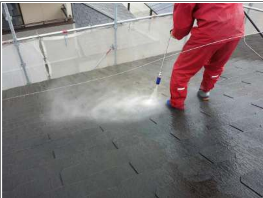
屋根 高圧洗浄中
