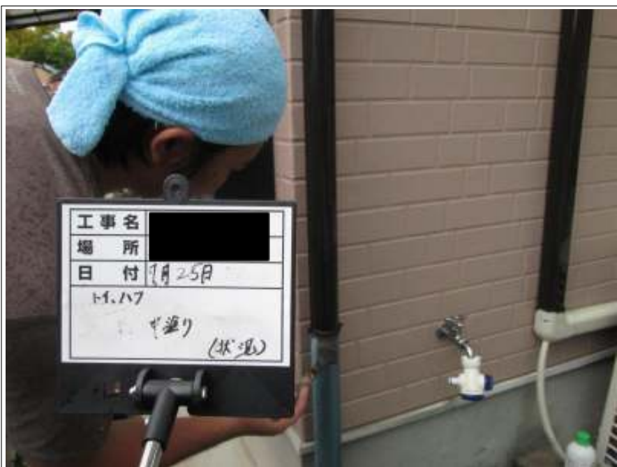
樋 中塗り施工中
