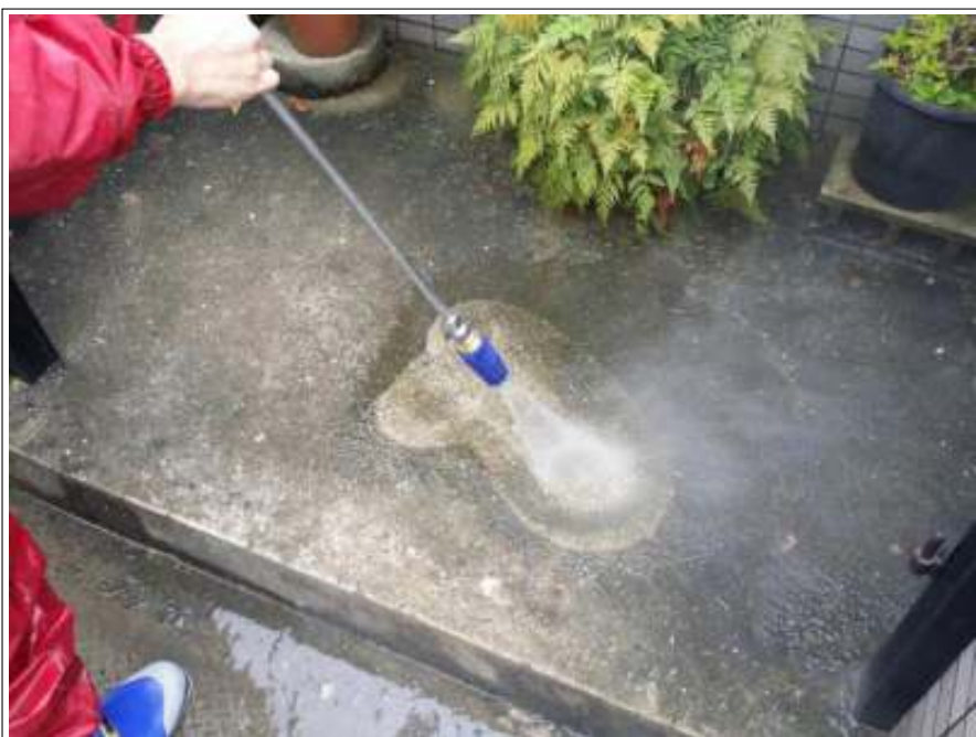
土間 高圧洗浄中
