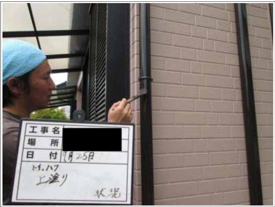
樋 上塗り施工中
