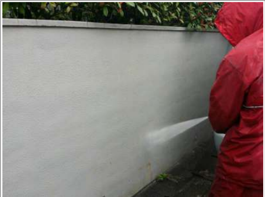
塀 高圧洗浄中
