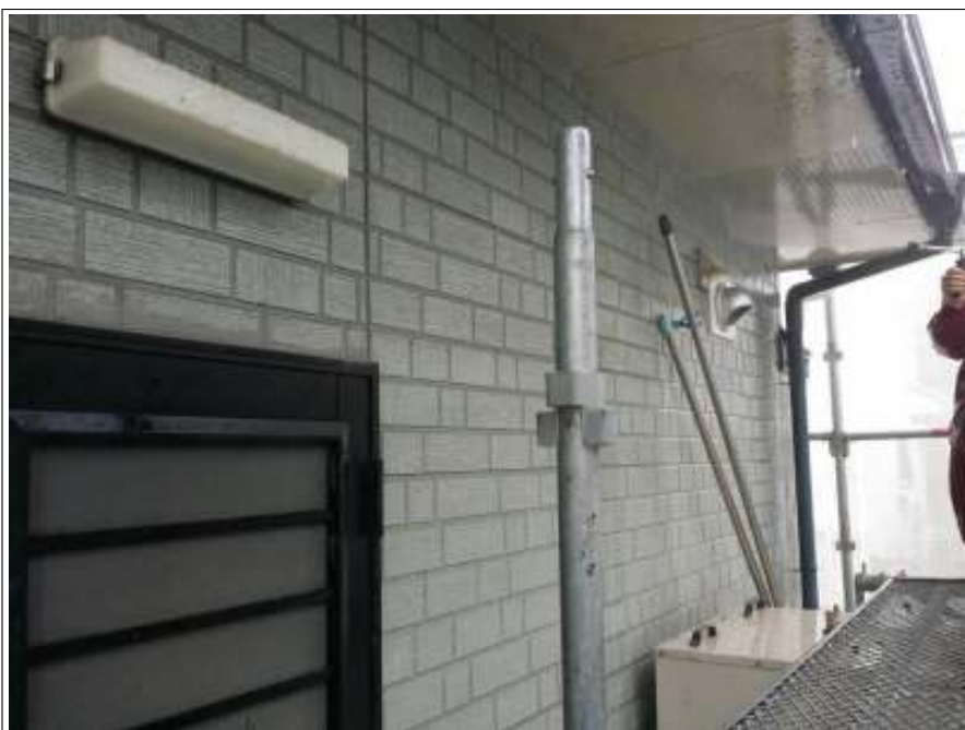
外壁 高圧洗浄中
