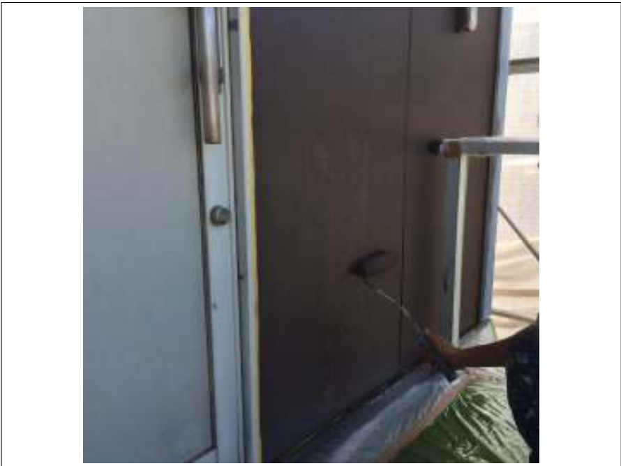
外壁 上塗り施工中
