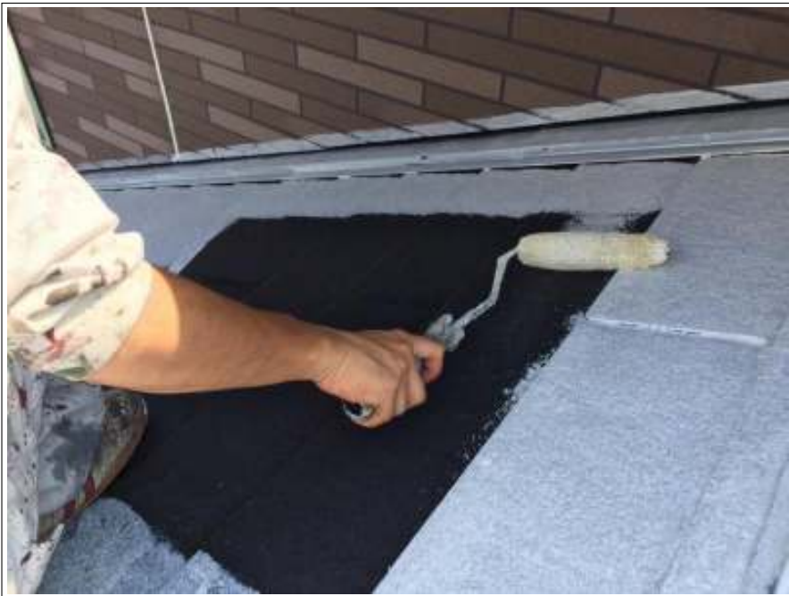
屋根 下塗り施工中
