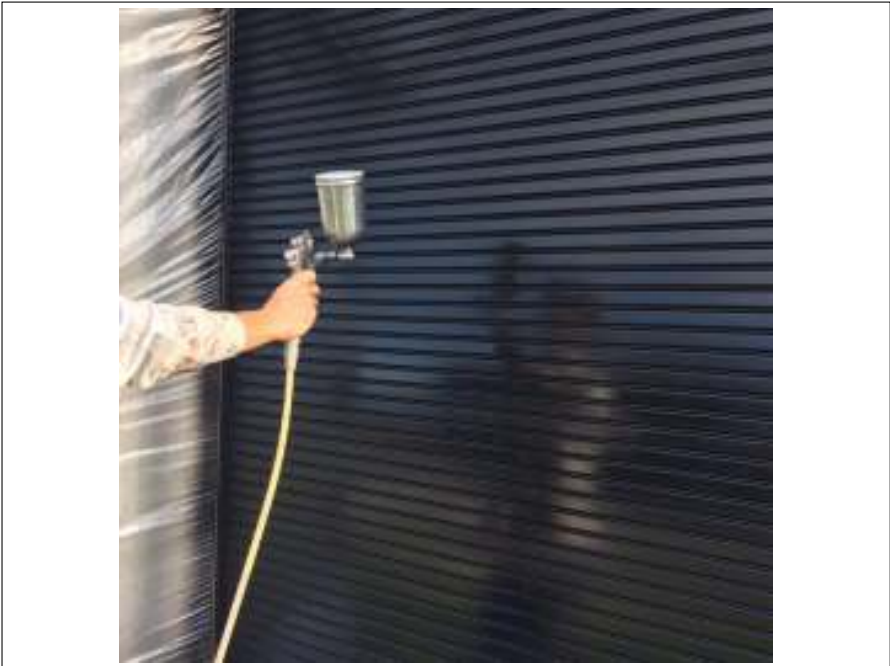
シャッター 上塗り施工中
