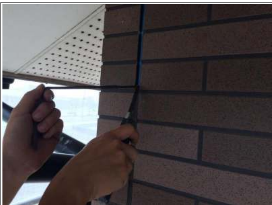
シーリング撤去 施工中
