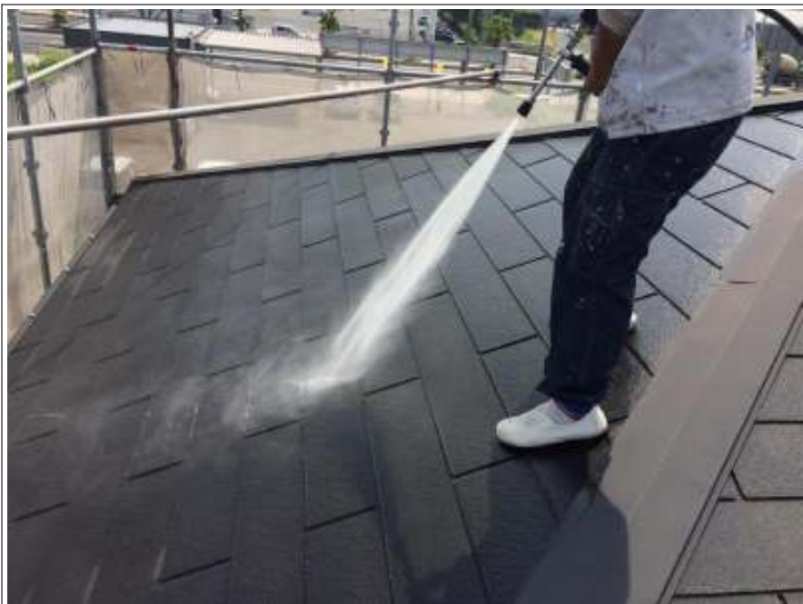
屋根 高圧洗浄中
