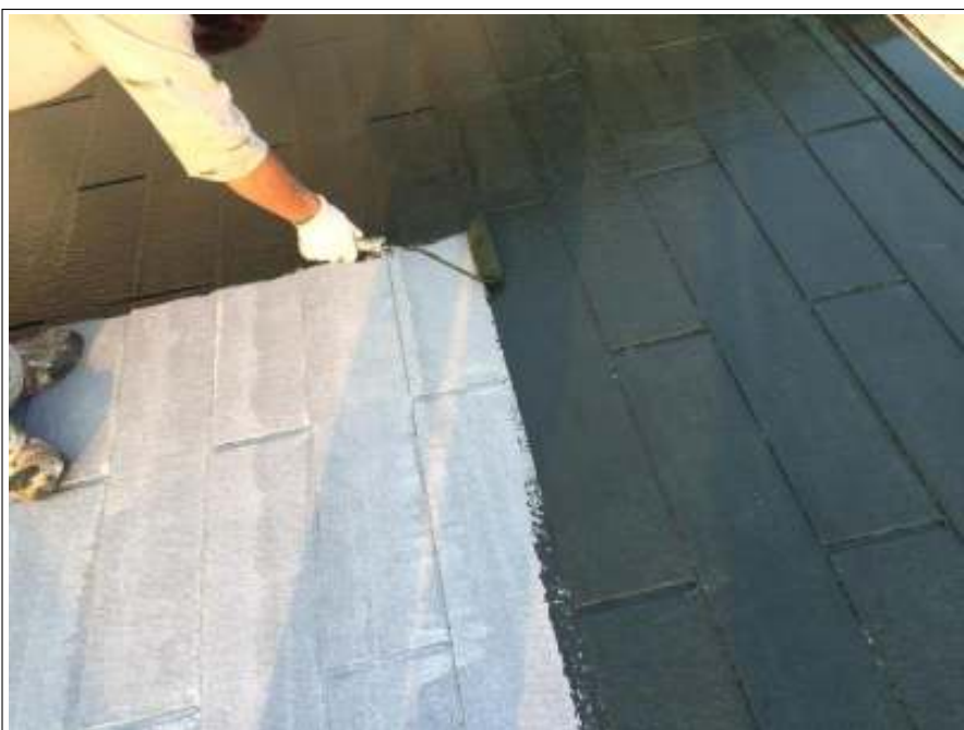
屋根 中塗り施工中
