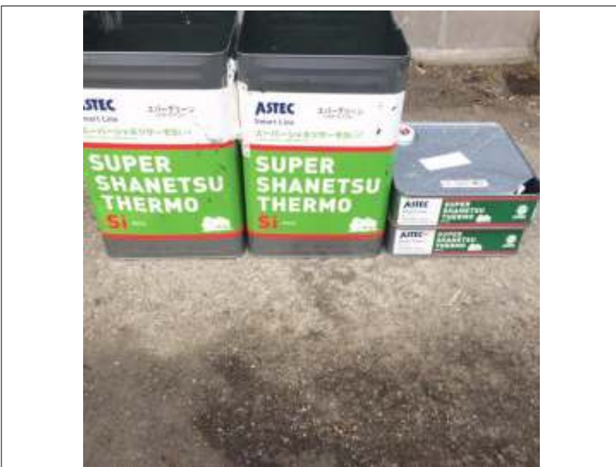
屋根 下塗り使用材料空缶
