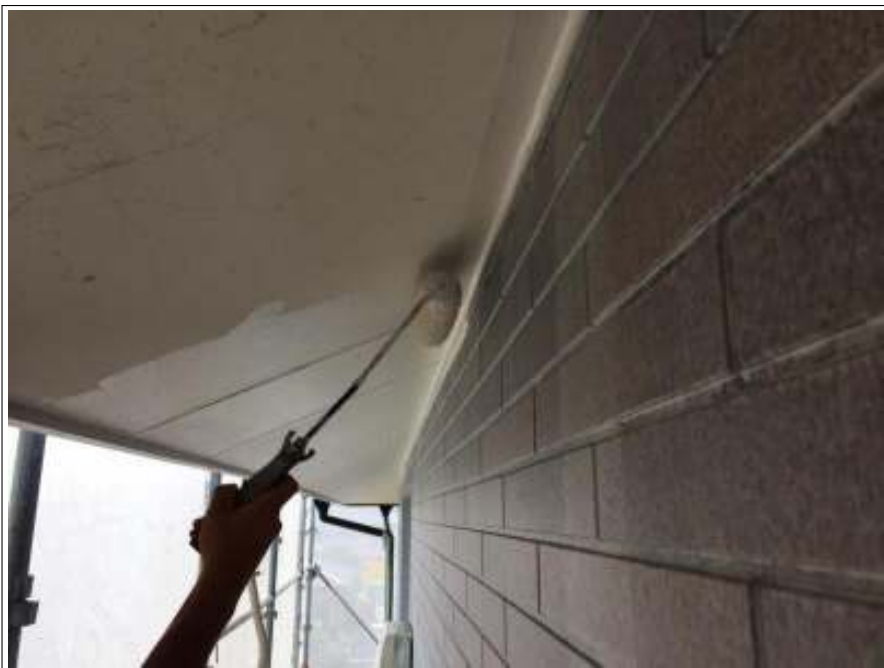
軒天 上塗り施工中
