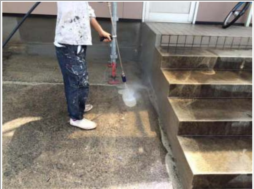
土間 高圧洗浄中
