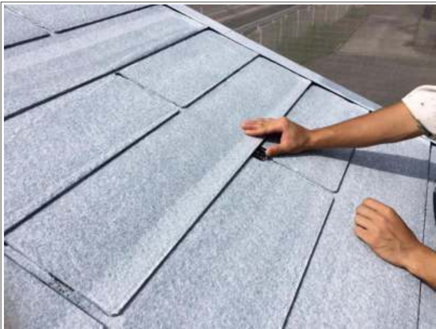
屋根 タスペーサー取付施工中
