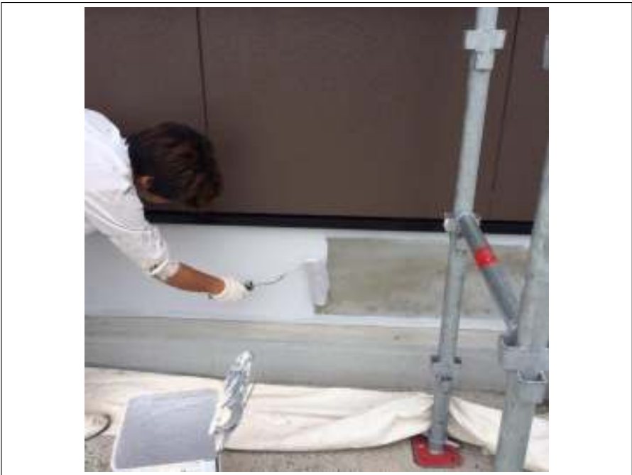
基礎塗り 施工中
