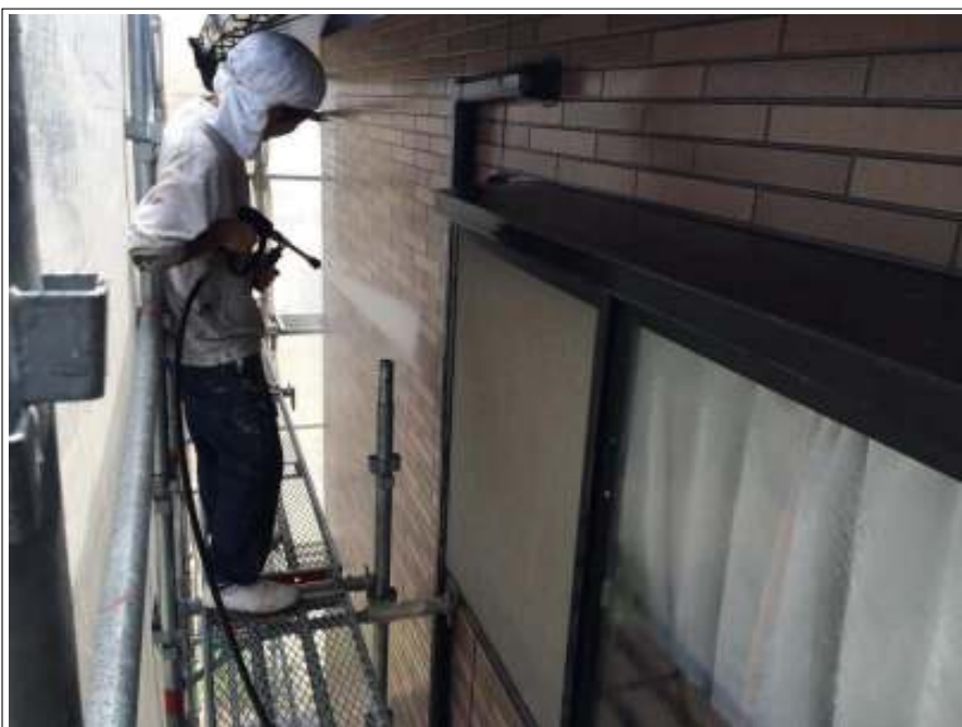
外壁 高圧洗浄中
