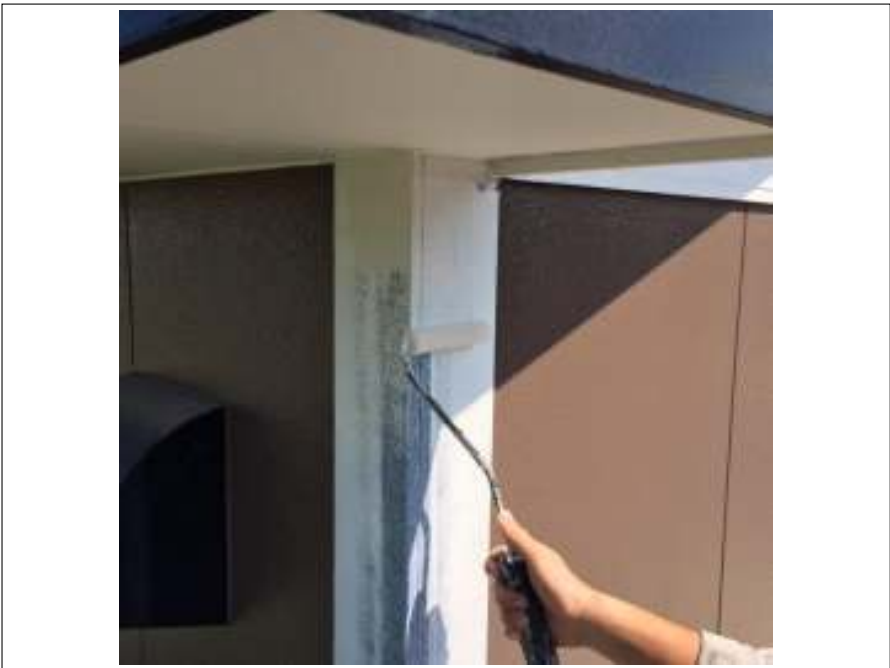
外壁アクセント部 上塗り施工中
