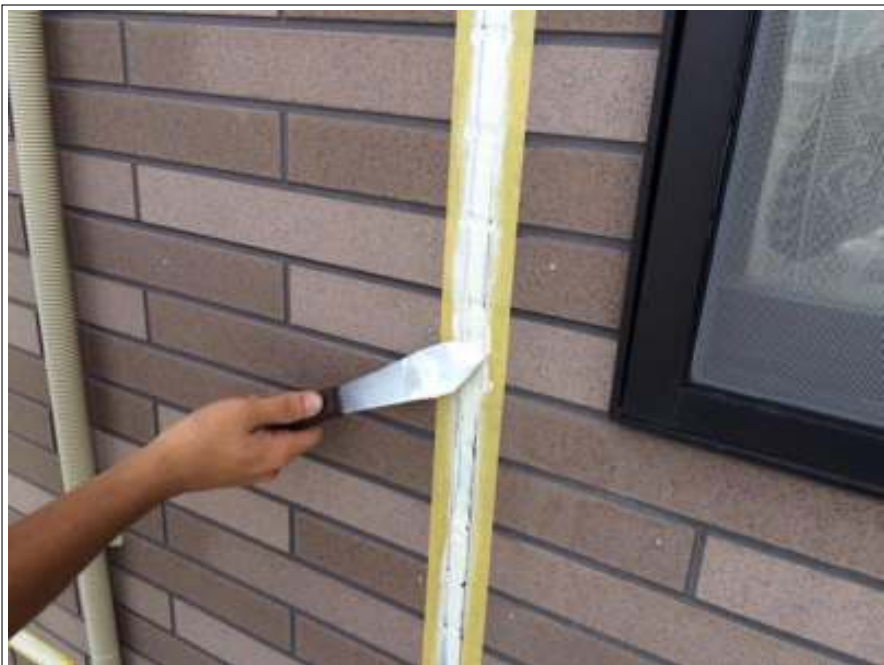
シーリング打ち替え 施工中
