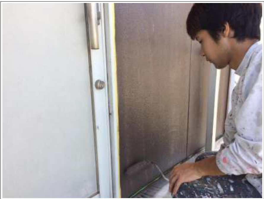
外壁 中塗り施工中
