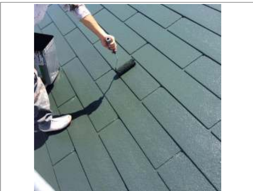
屋根 上塗り施工中
