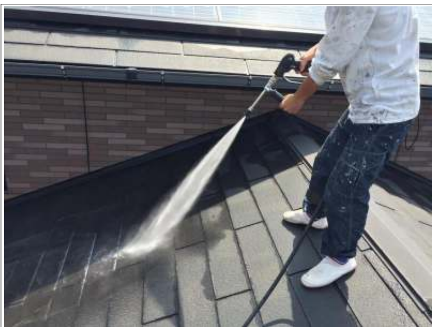
屋根 高圧洗浄中
