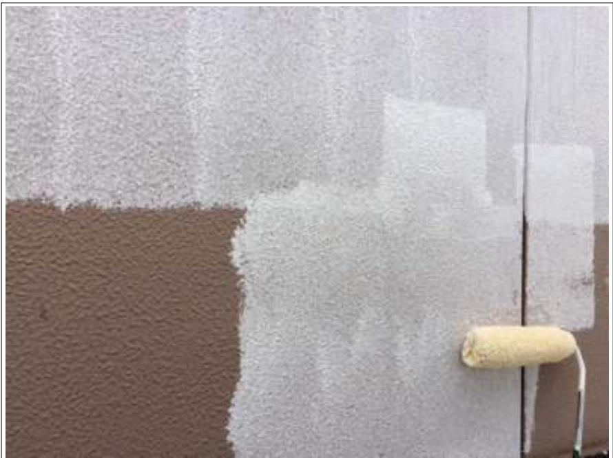
外壁 下塗り施工中
