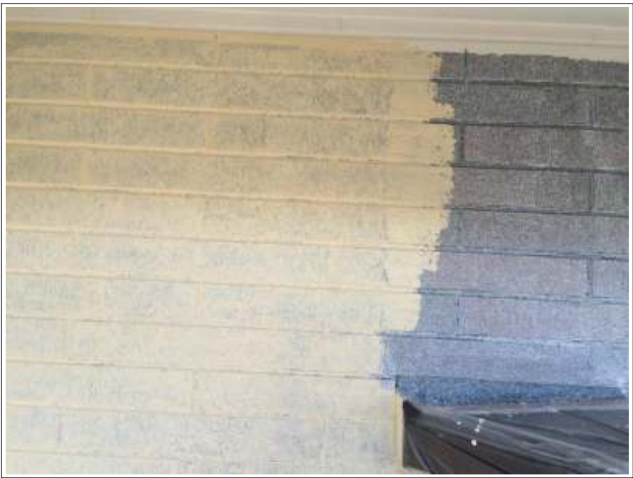
外壁 中塗り施工中
