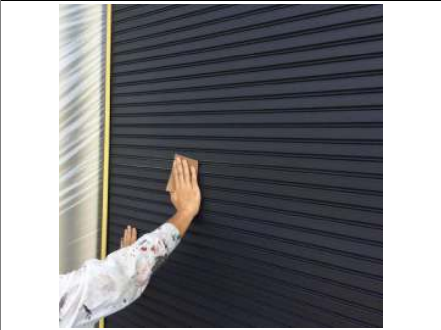
シャッター ケレン施工中
