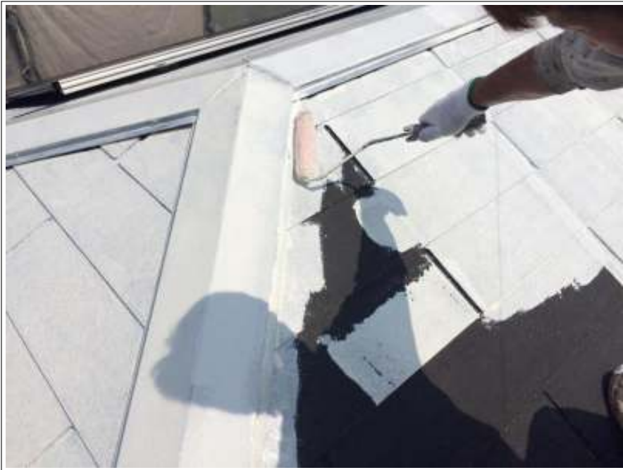
屋根 下塗り施工中
