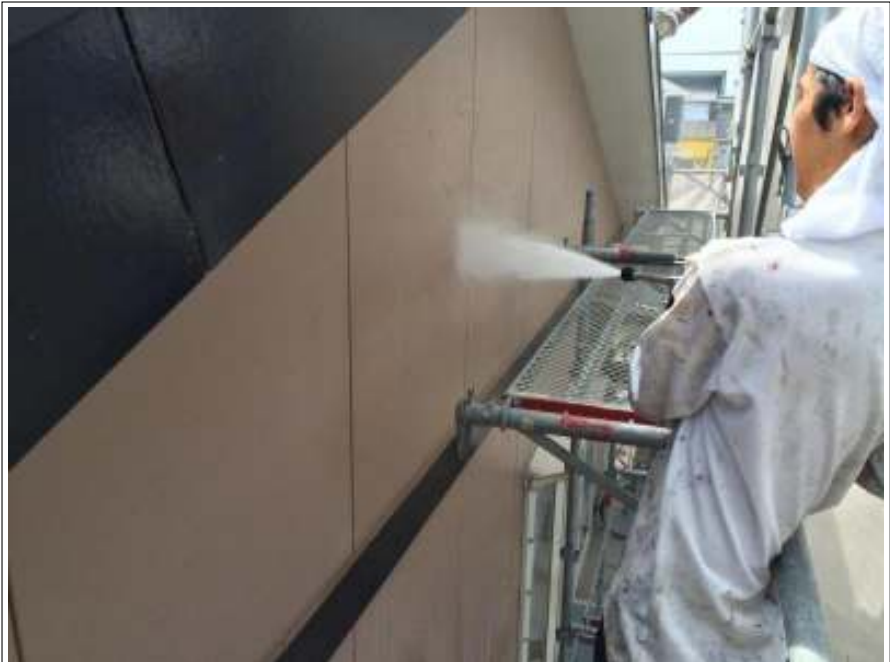
外壁 高圧洗浄中
