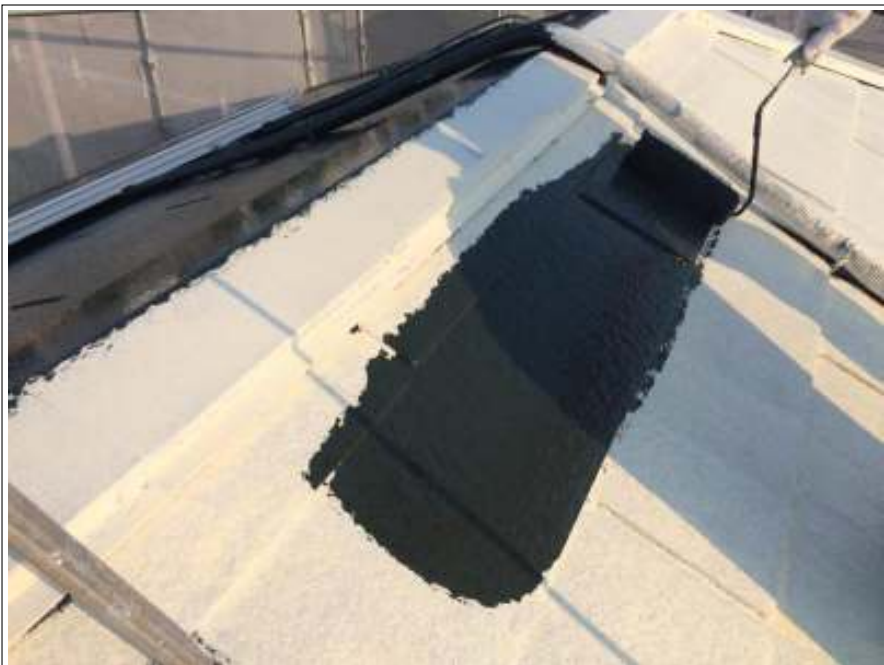
屋根 中塗り施工中
