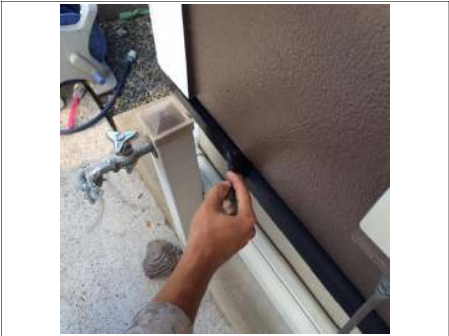
土台水切り 上塗り施工中
