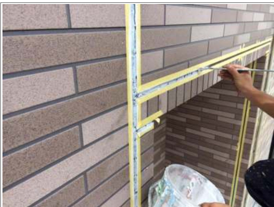
プライマー塗布 施工中
