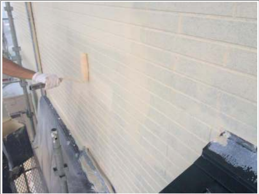
外壁 中塗り施工中
