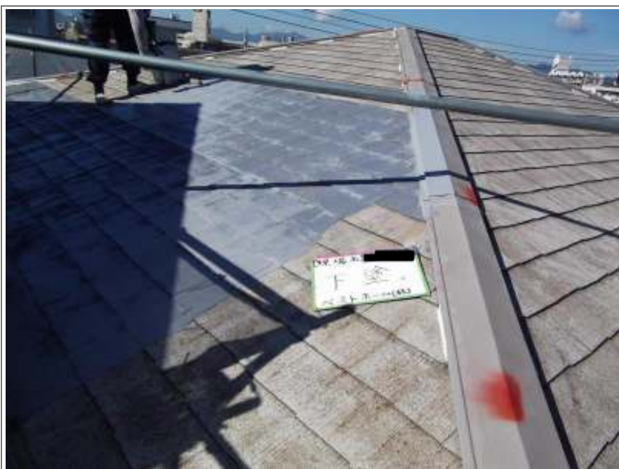
屋根 下塗り施工中
