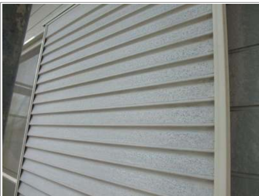
雨戸 ケレン施工完了
