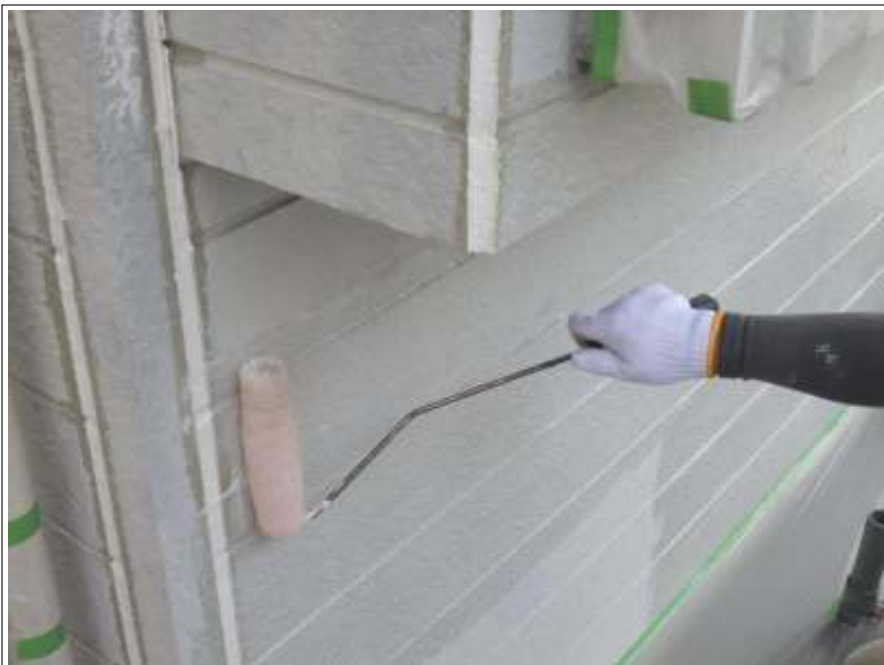
外壁 下塗り施工中
