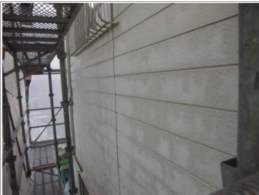
外壁 高圧洗浄中
