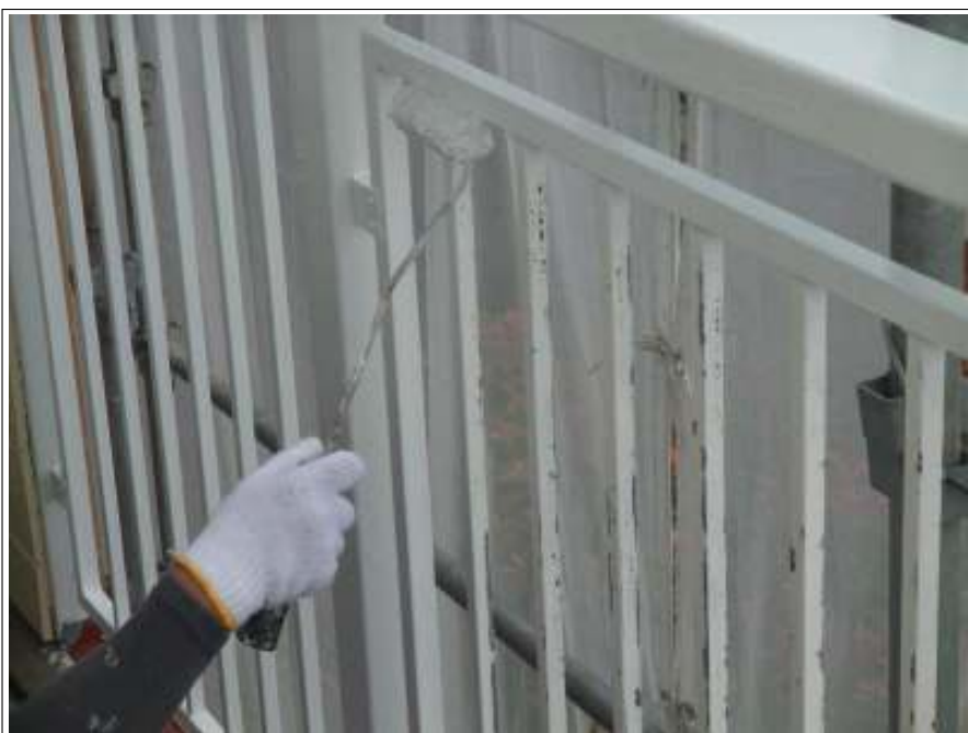
ベランダ鉄部 施工中
