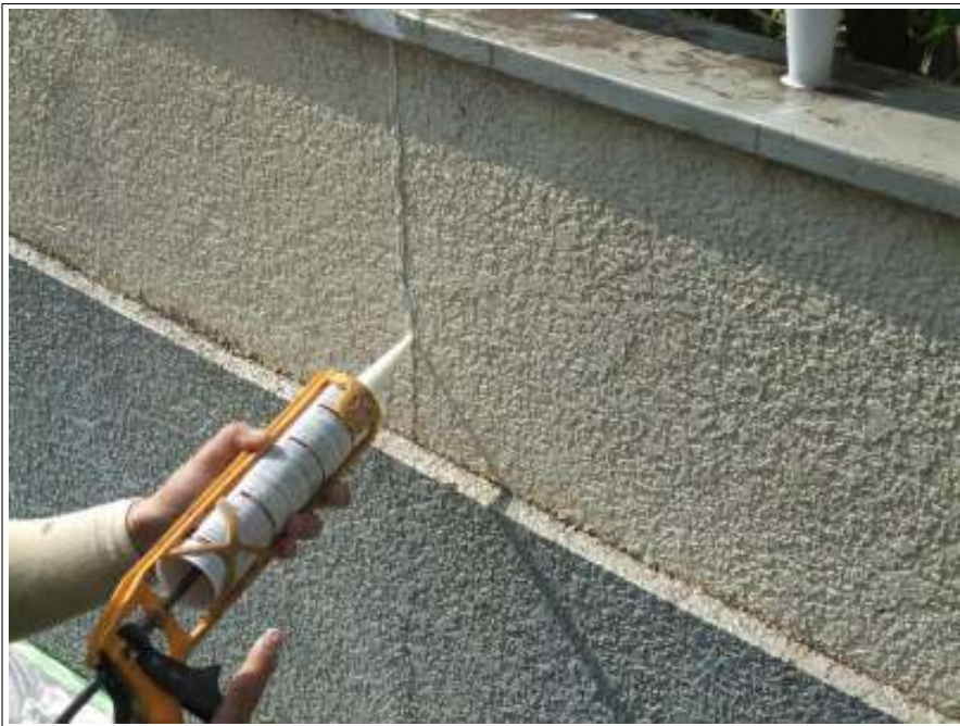
外塀 クラック補修施工中
