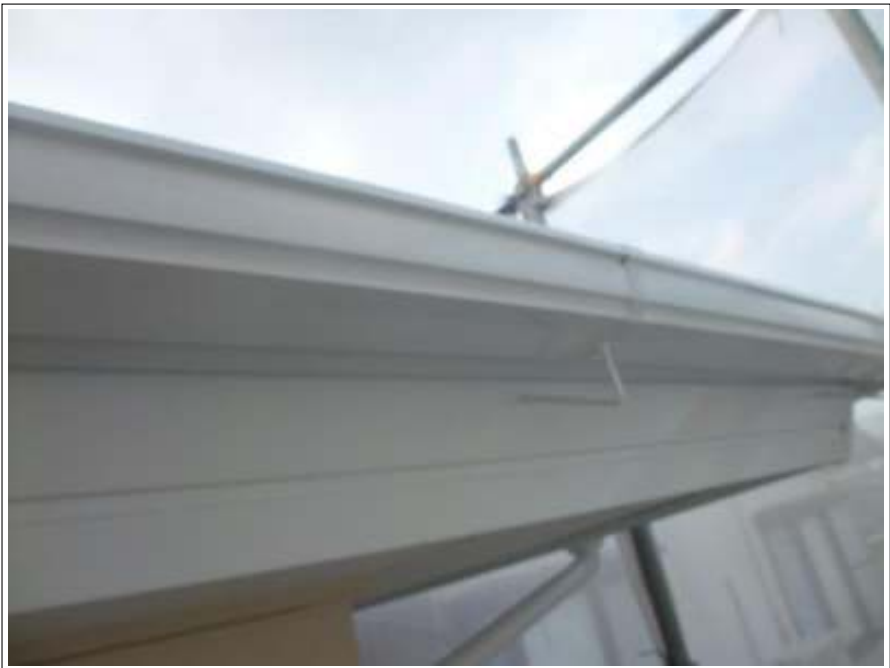
雨樋 施工完了
