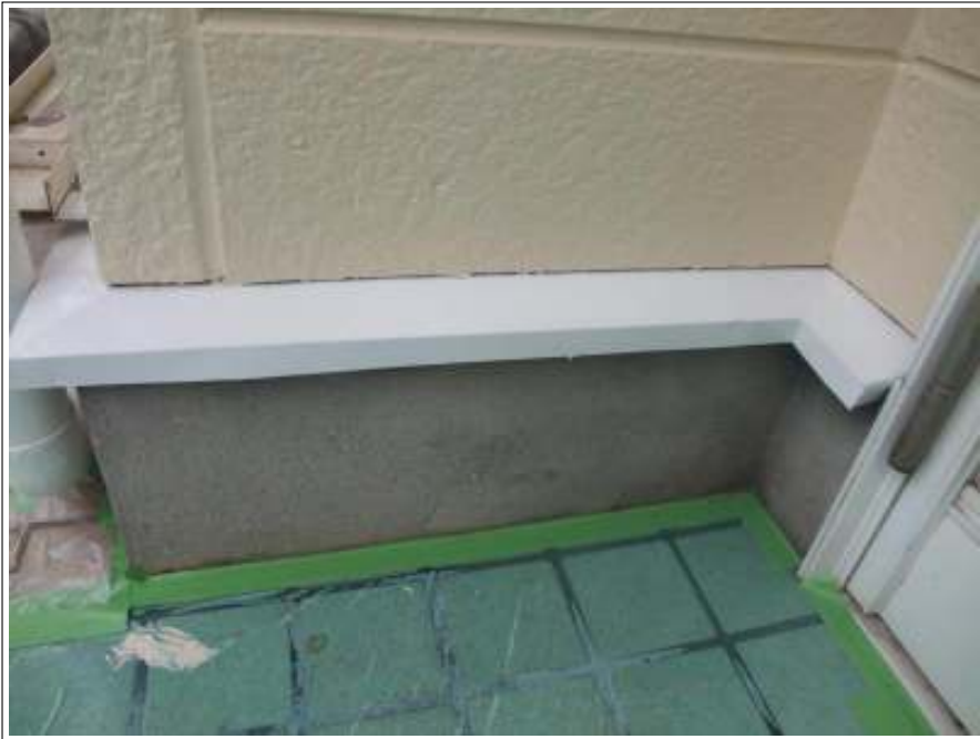
水切り塗装 施工完了
