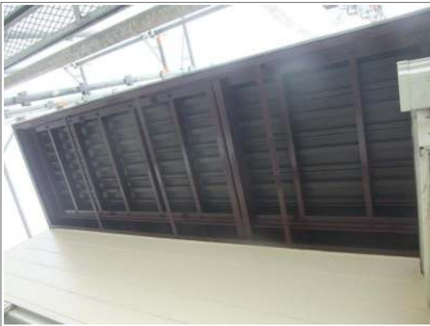
ベランダ鉄部 施工完了
