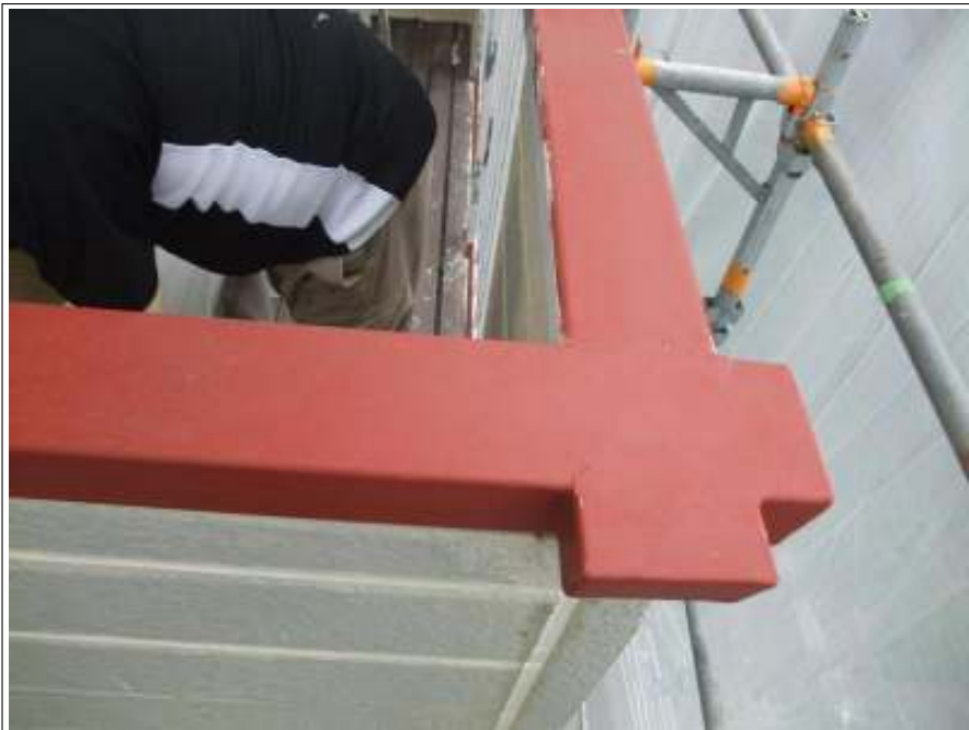
ベランダ鉄部 サビ止め施工完了
