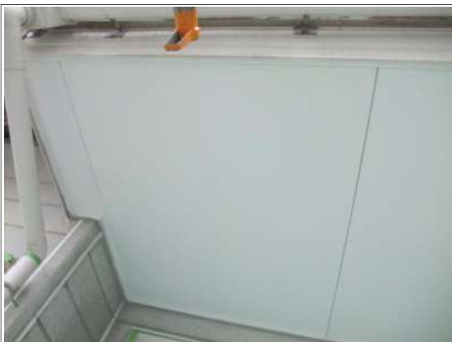
軒天 施工完了
