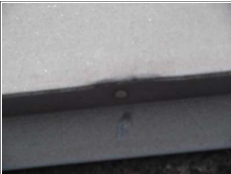
棟鉄板 補修後
