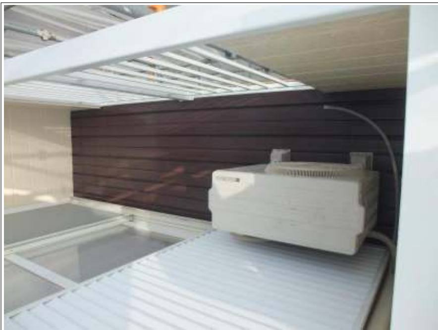
ベランダ床 施工完了
