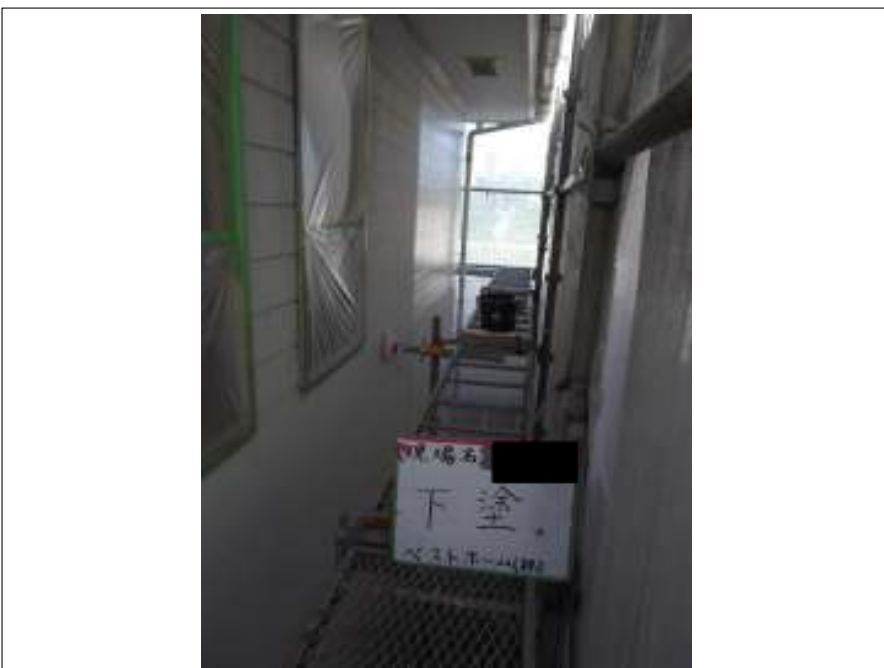
外壁 下塗り施工中
