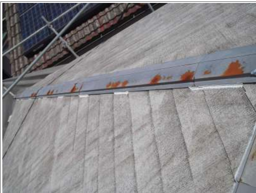
ラバー止め 施工完了
