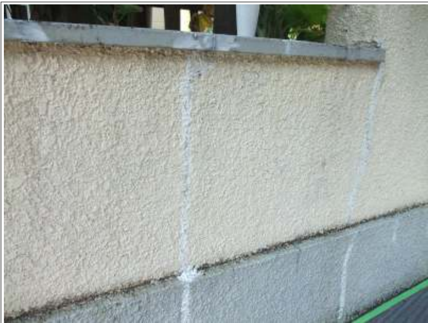
外塀 クラック補修施工後
