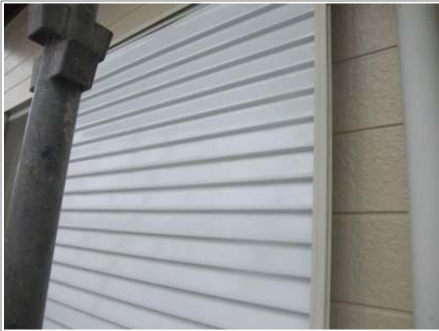
雨戸塗装 施工完了
