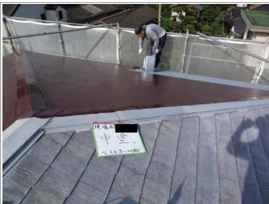
屋根 中塗り施工中
