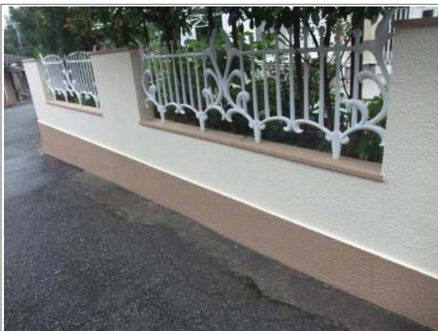
外塀 施工完了
