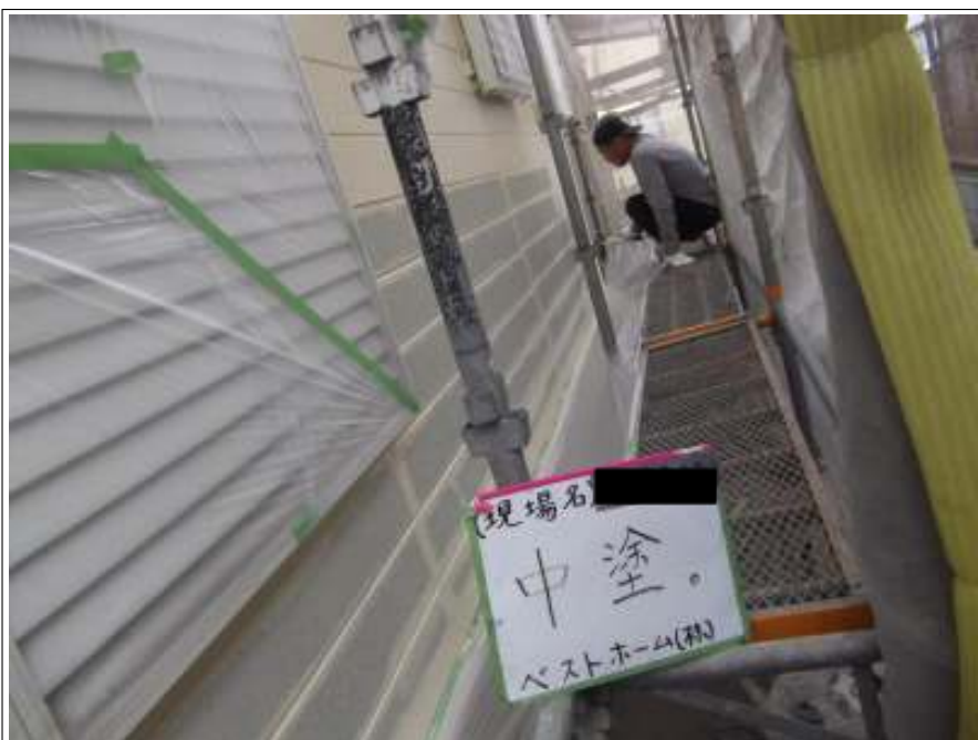
外壁 中塗り施工中
