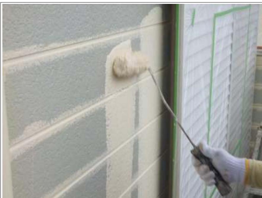
外壁 中塗り施工中
