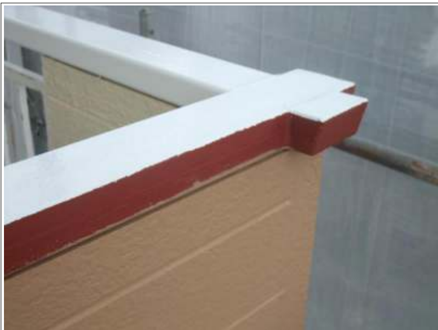
ベランダ鉄部 施工中
