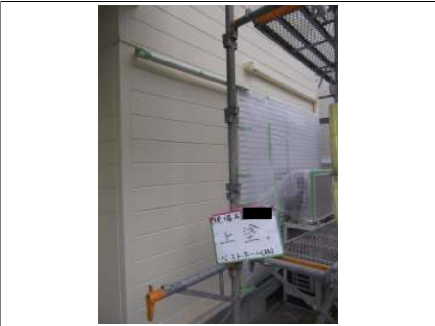
外壁 上塗り施工後
