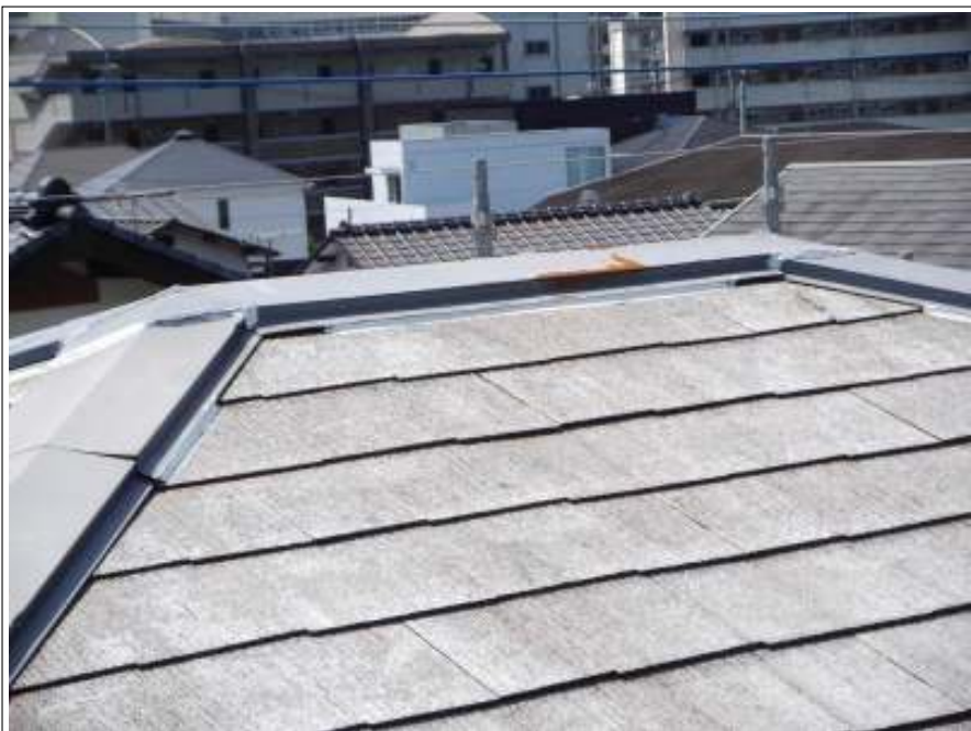
ラバー止め 施工完了
