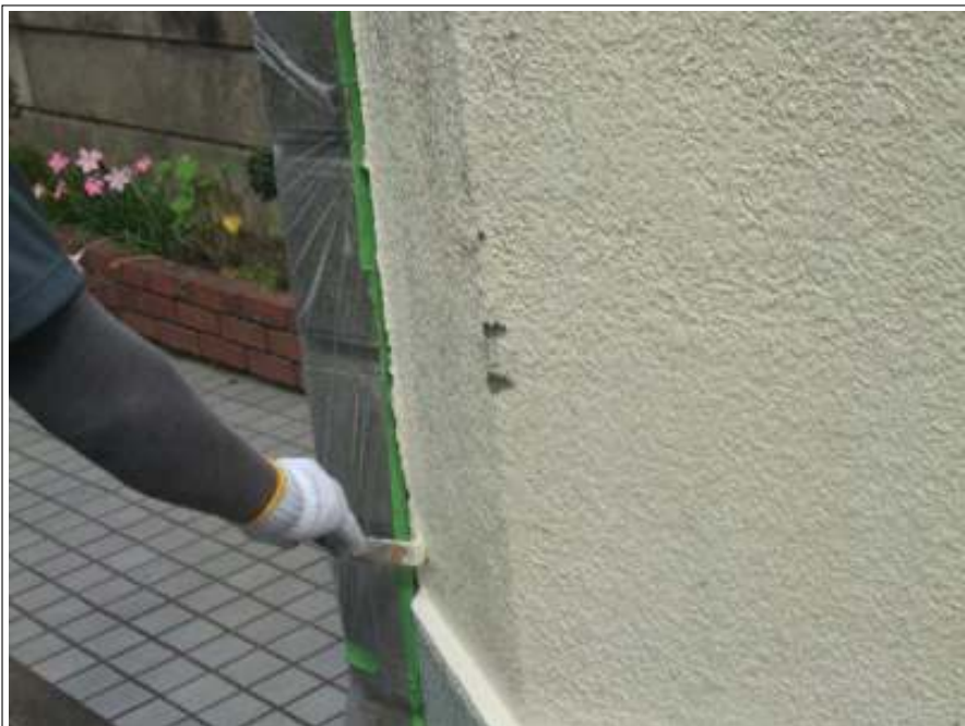
外塀 中塗り施工中
