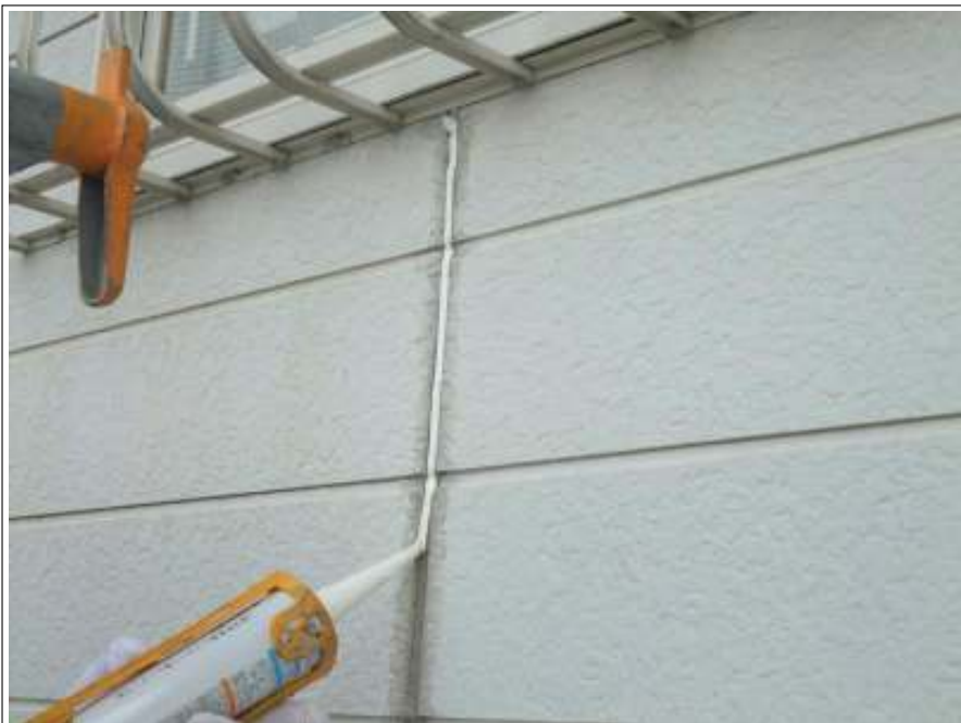
コーキング打替え 施工中
