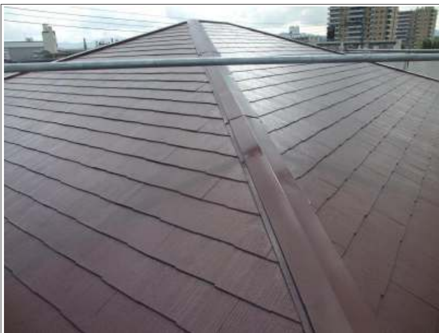
屋根 施工完了
