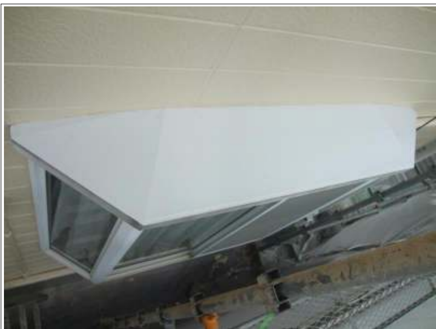
小庇 施工完了
