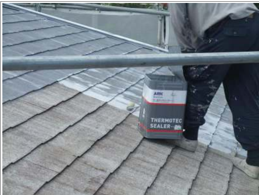
屋根 下塗り施工中
