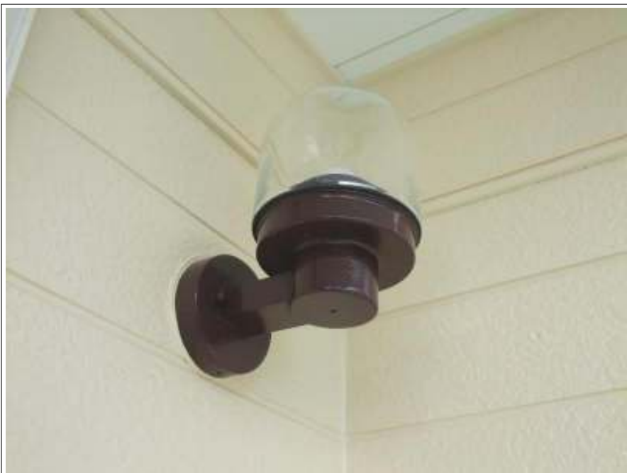
玄関ライト 施工完了
