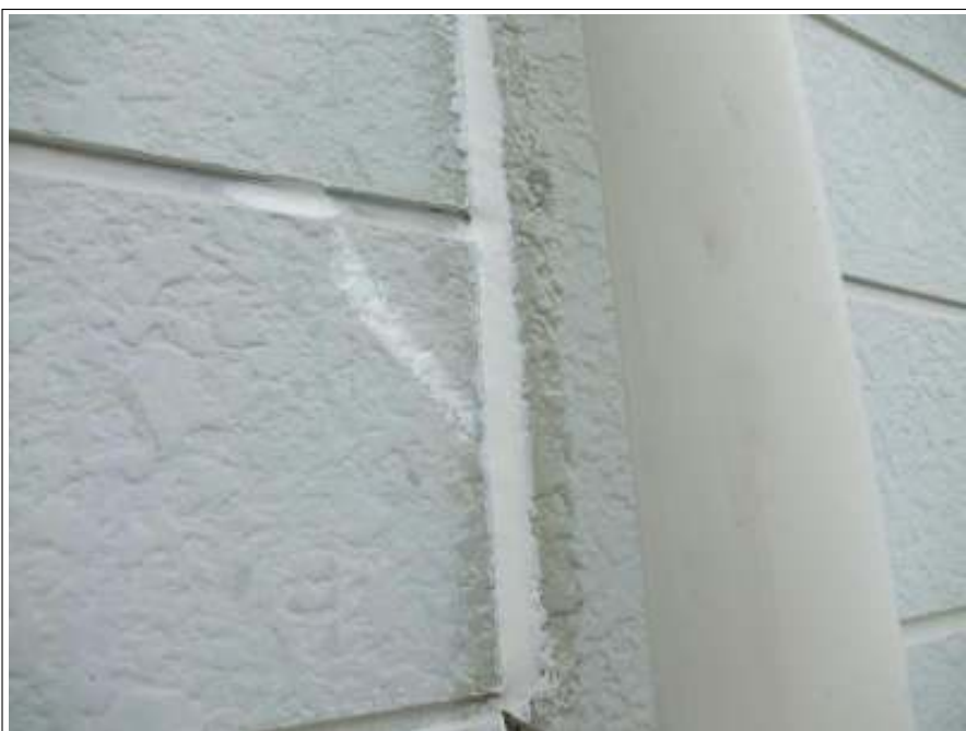
コーキング打替え 施工後
