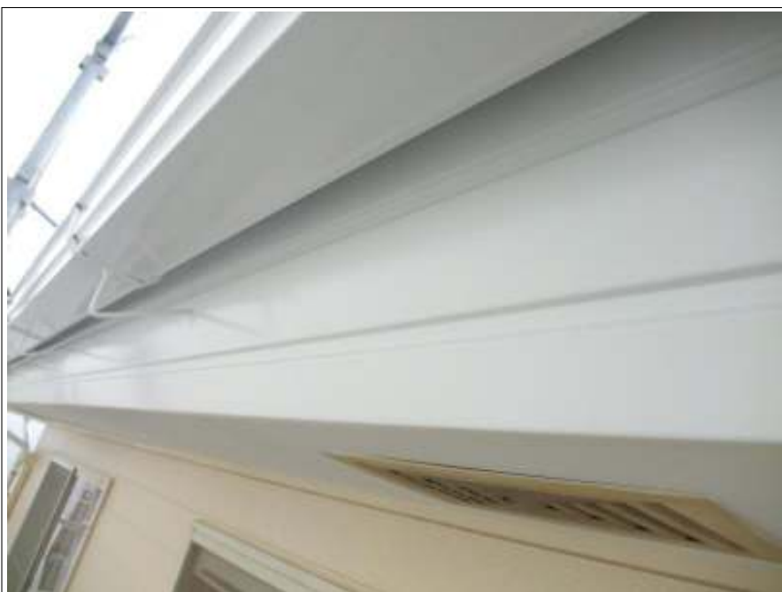
破風板 施工完了
