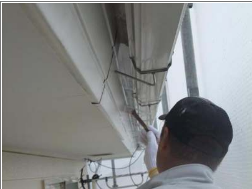
破風板 施工中
