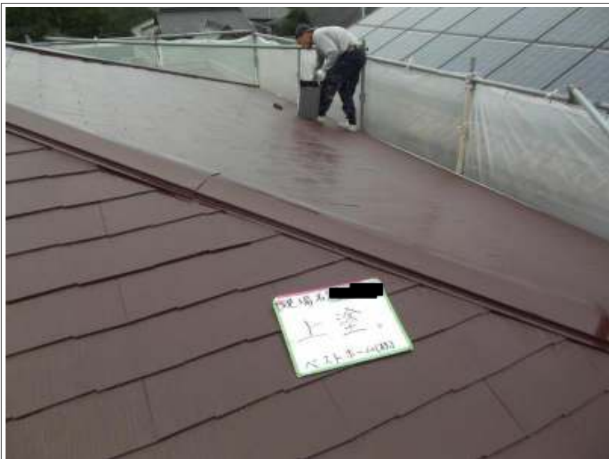
屋根 上塗り施工中
