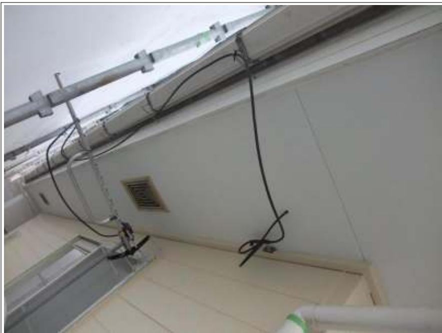
軒天 施工完了
