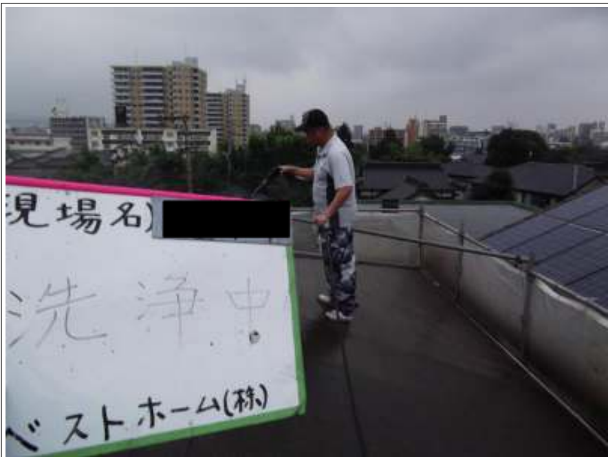
屋根 高圧洗浄中
