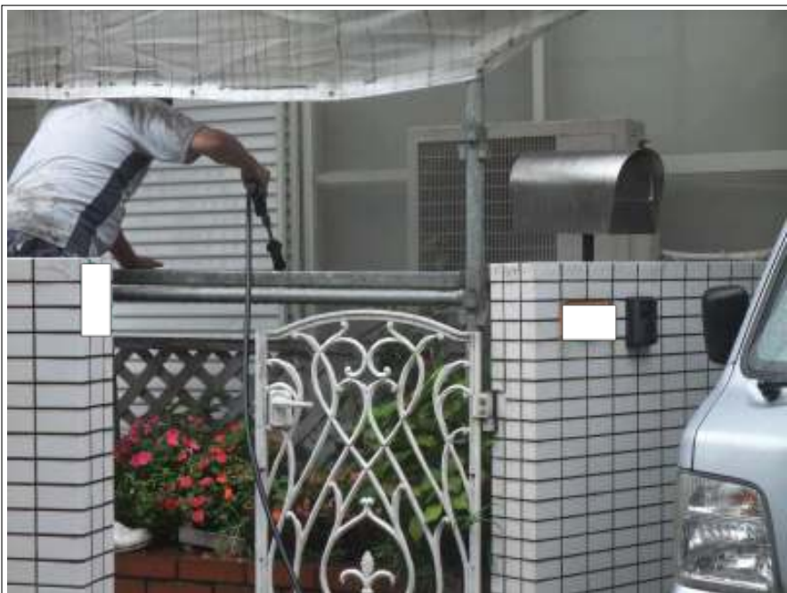
土間 高圧洗浄中
