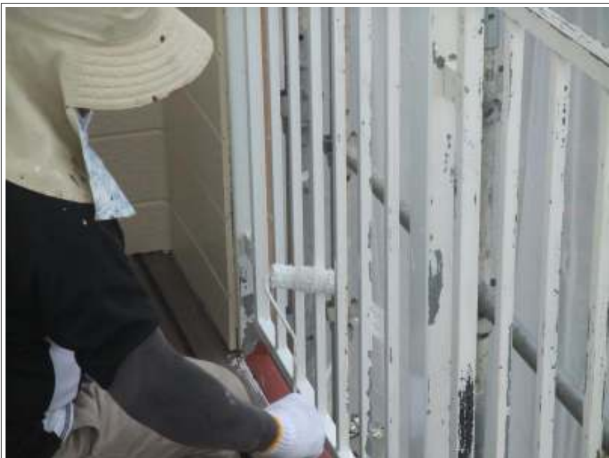
ベランダ鉄部 施工中
