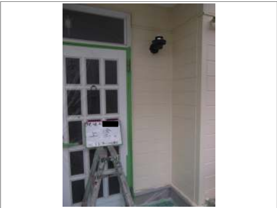
外壁 上塗り施工後
