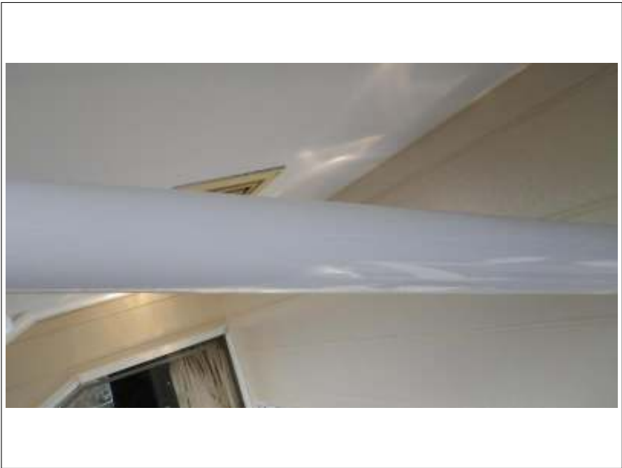
樋塗装下塗り施工完了
