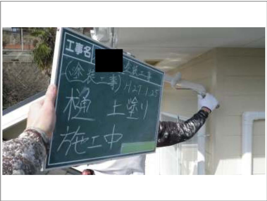
樋塗装上塗り施工中
