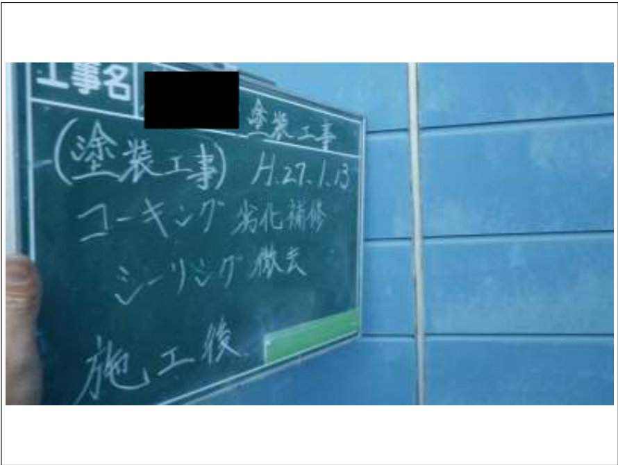
外壁シーリング撤去施工完了
