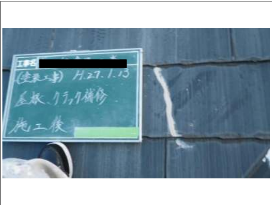
屋根クラック補修施工完了
