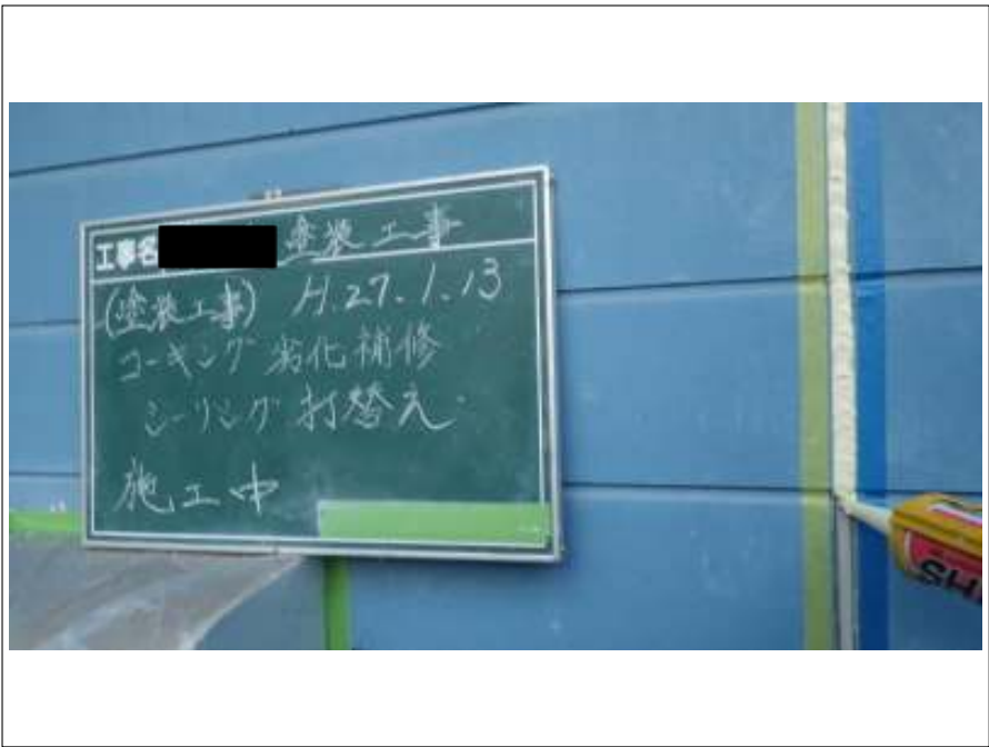
外壁シーリング打替え施工中
