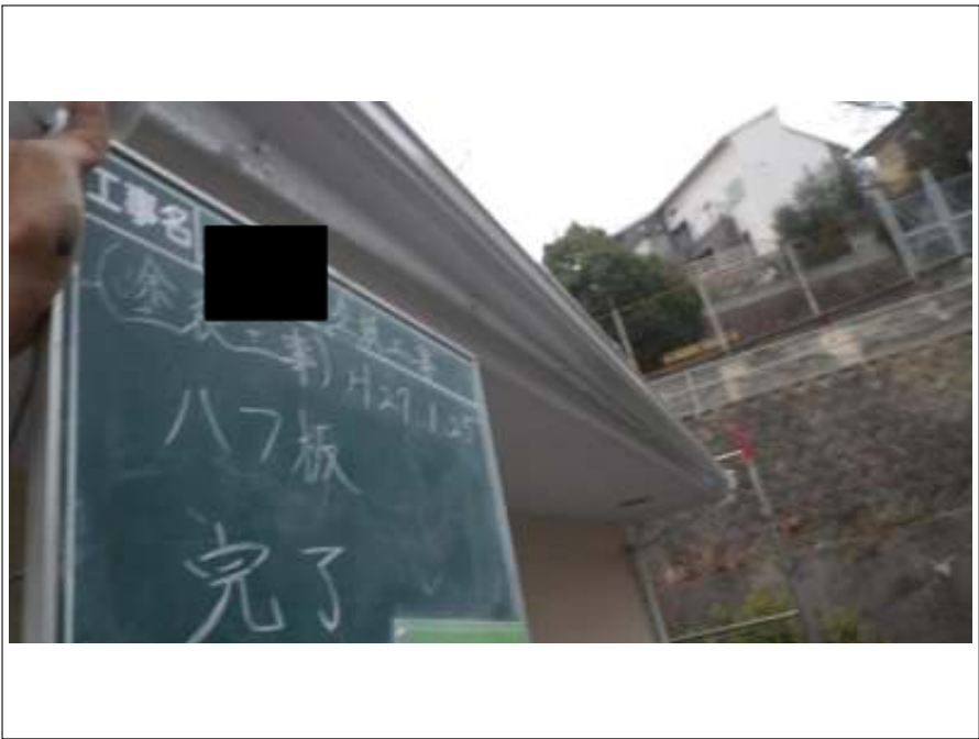
破風板塗装施工完了
