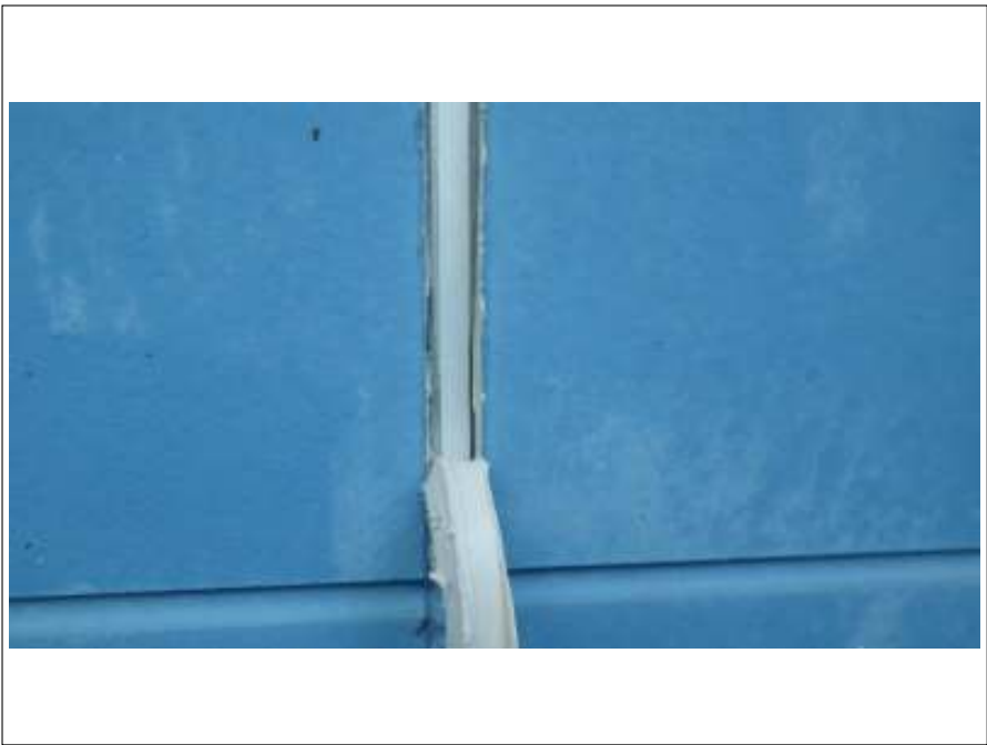
外壁シーリング撤去施工中
