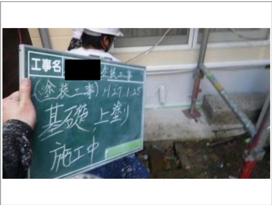
基礎塗装上塗り施工中
