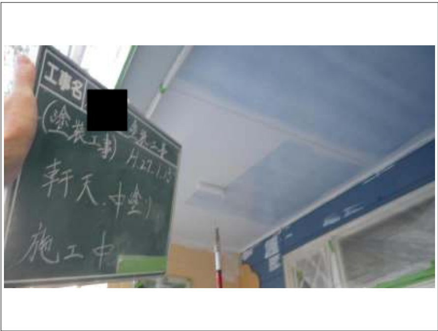
軒天塗装中塗り施工中
