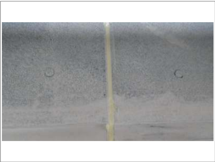
破風板シーリング補修施工完了
