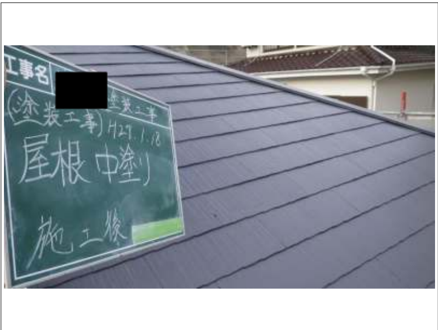
屋根塗装中塗り施工完了
