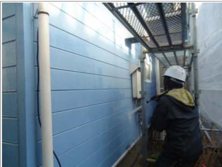
外壁高圧洗浄施工中
