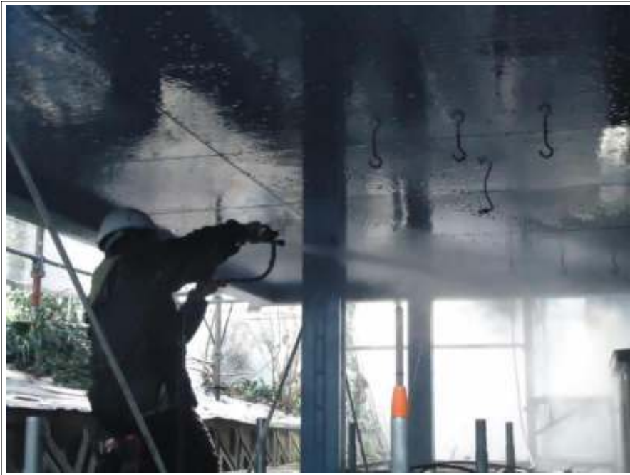
高压洗净施工中
