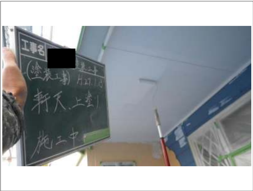
軒天塗装上塗り施工中
