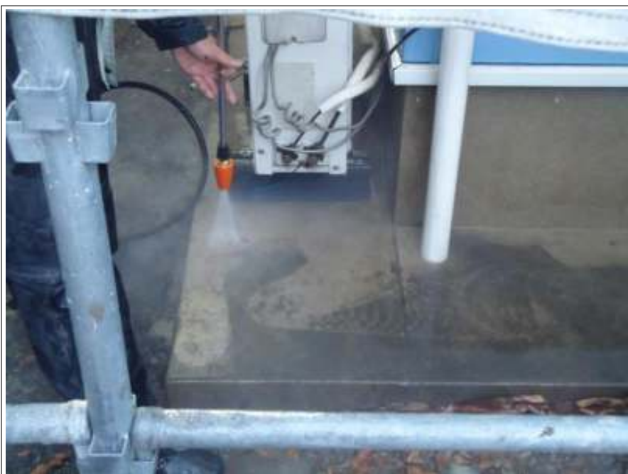
土間高圧洗浄施工中
