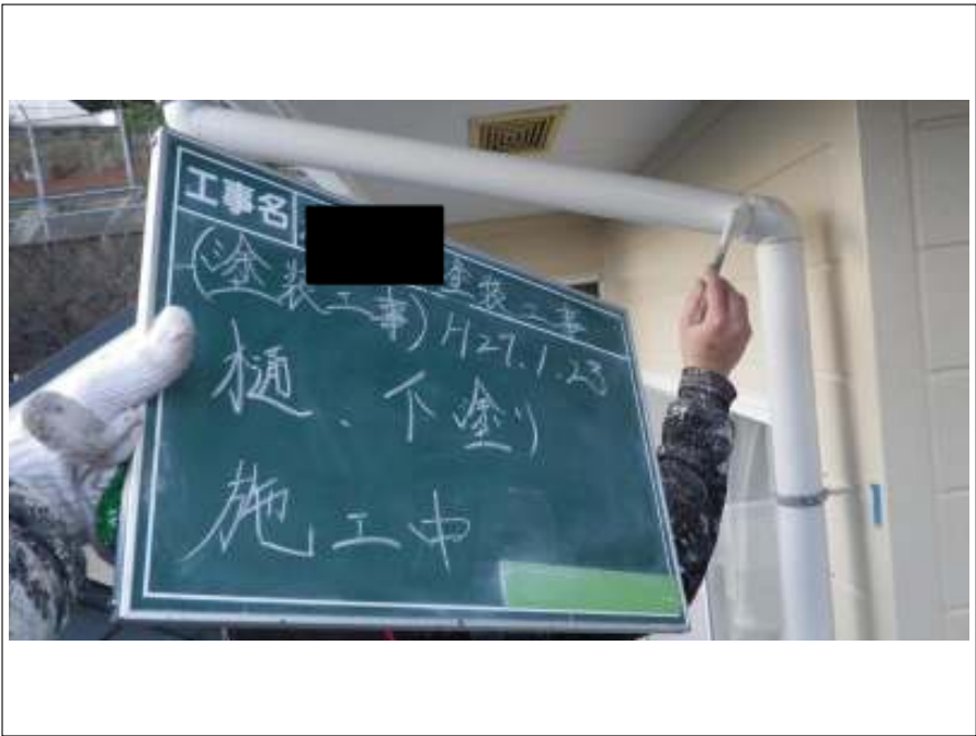
樋塗装下塗り施工中
