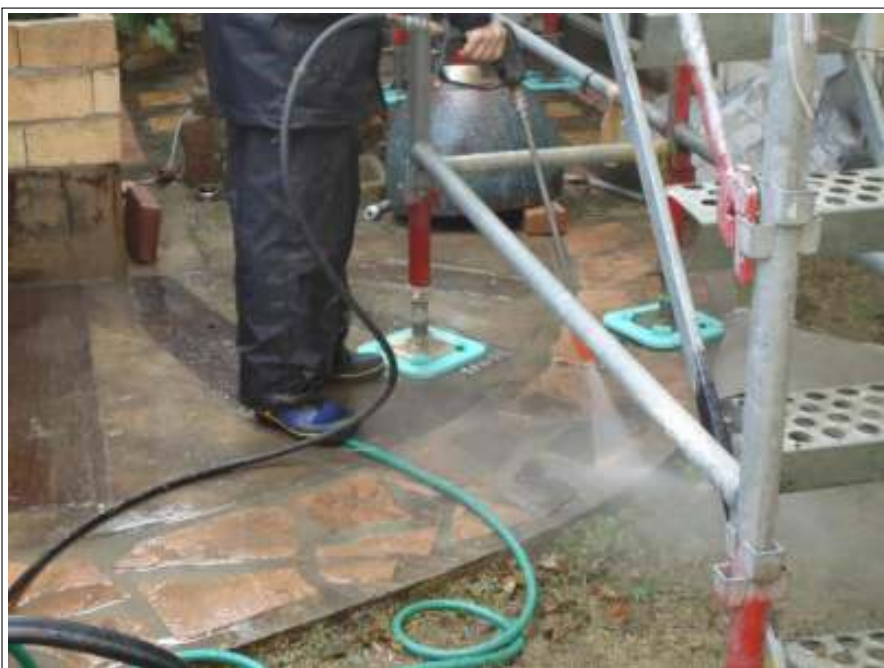
土間高圧洗淨施工中
