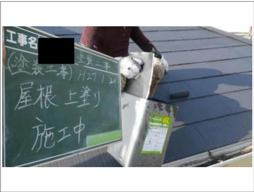
屋根塗装上塗り施工中
