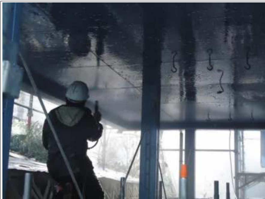
高压洗净施工中
