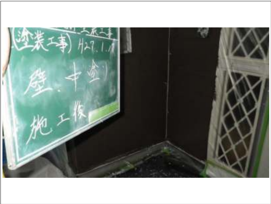
外壁塗装中塗り施工完了
