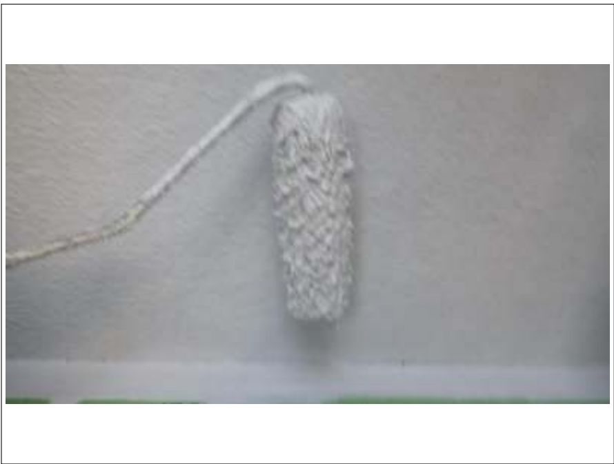
基礎塗装上塗り施工中
