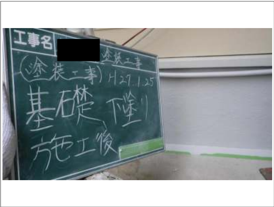
基礎塗装下塗り施工完了
