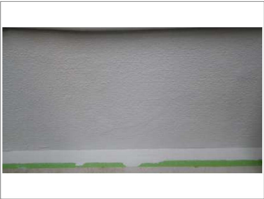
基礎塗装下塗り施工完了
