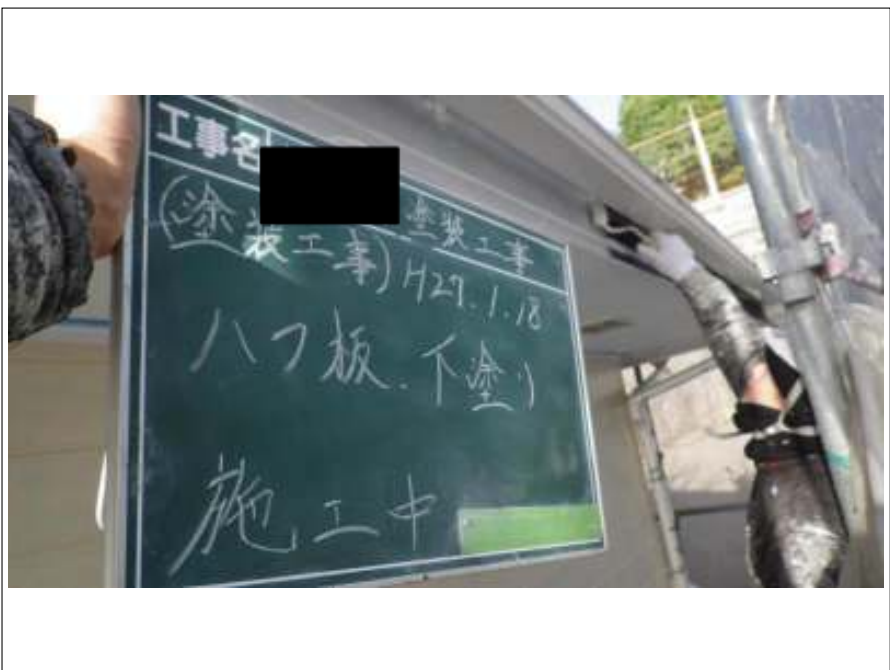
破風板塗装下塗り施工中
