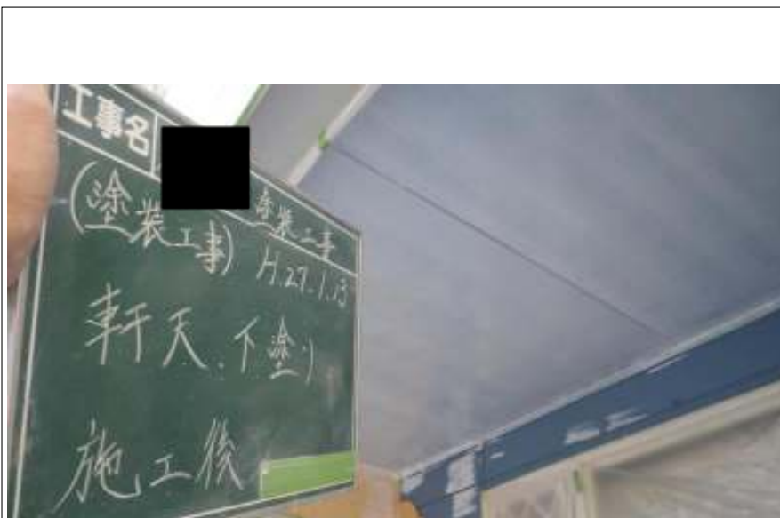
軒天塗装下塗り施工完了
