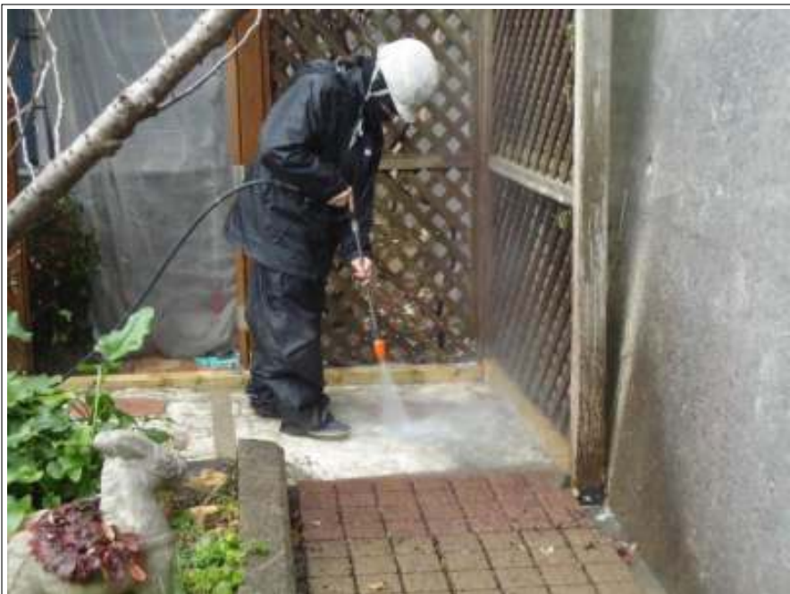
高压洗净施工中
