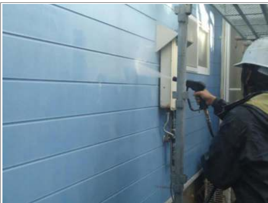
外壁高圧洗浄施工中
