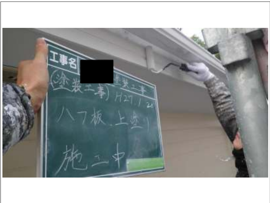
破風板塗装上塗り施工中
