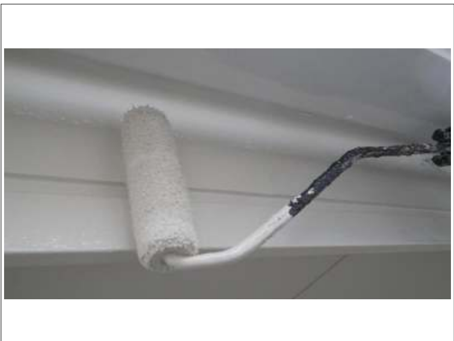
破風板塗装上塗り施工中
