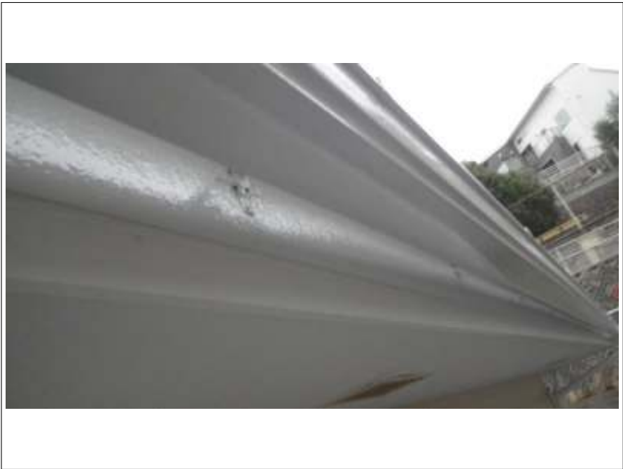
破風板塗装施工完了
