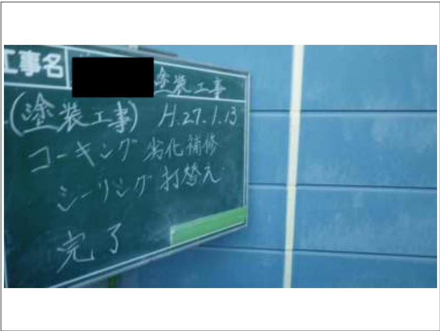
外壁シーリング打替え施工完了
