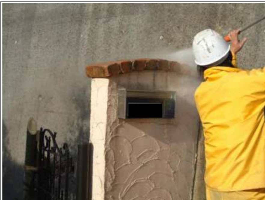
塀高圧洗浄施工中
