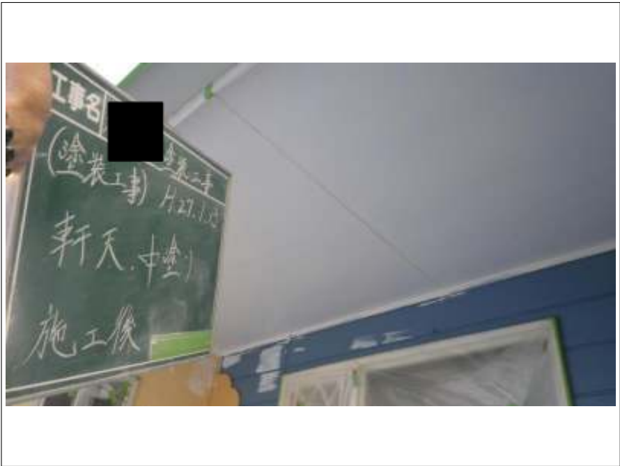
軒天塗装中塗り施工完了
