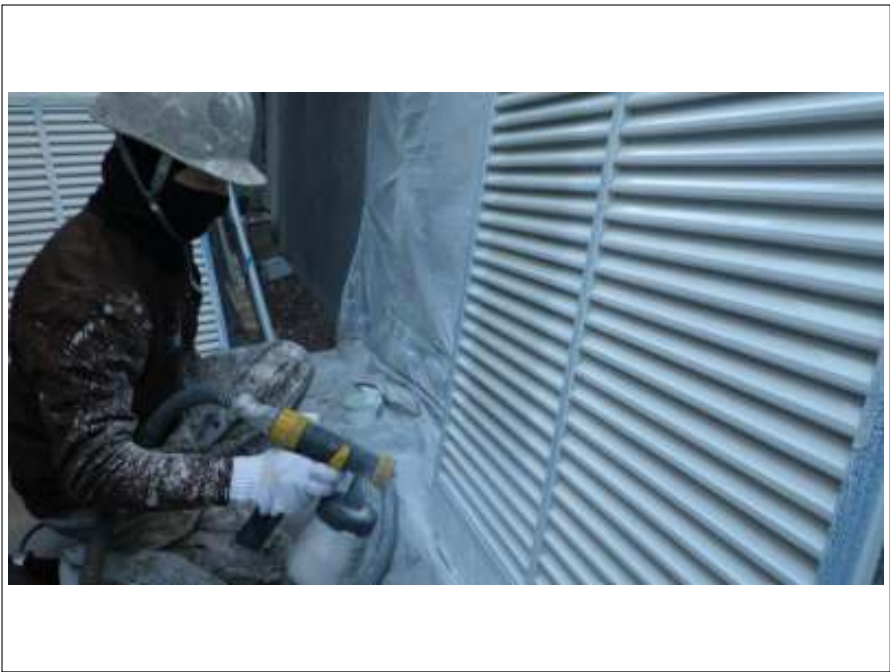
雨戸塗装下塗り施工中
