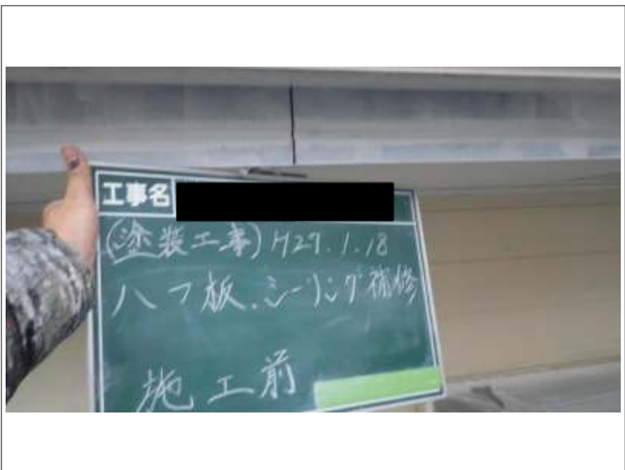
破風板シーリング補修施工前
