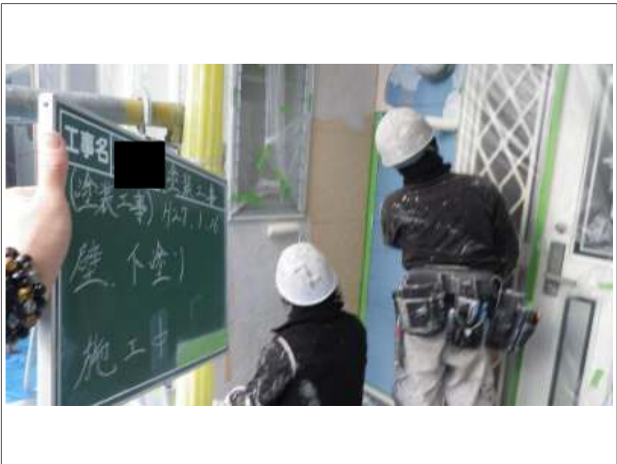
外壁塗装下塗り施工中
