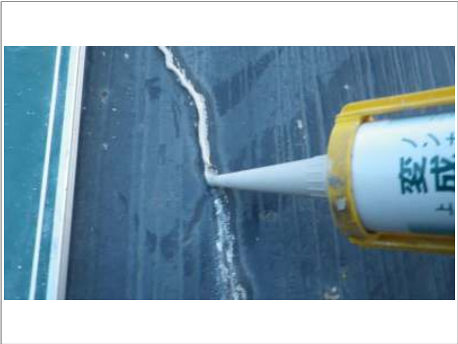
屋根クラック補修施工中
