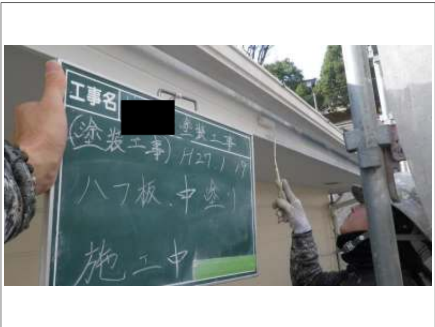
破風板塗装中塗り施工中
