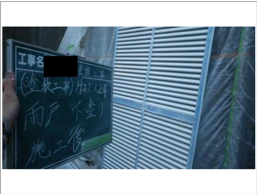
雨戸塗装下塗り施工完了
