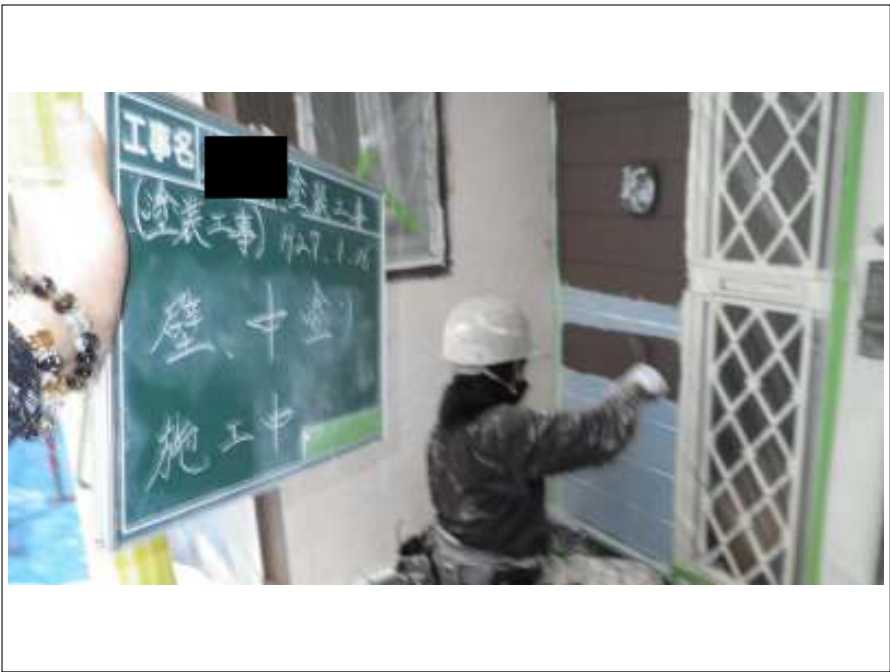
外壁塗装中塗り施工中
