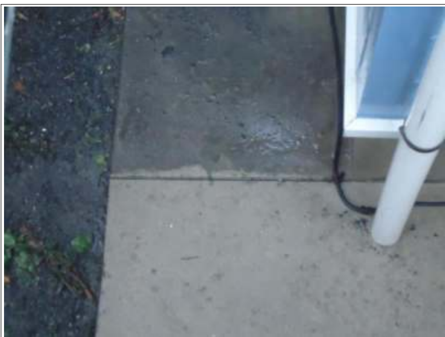
土間高圧洗淨施工中
