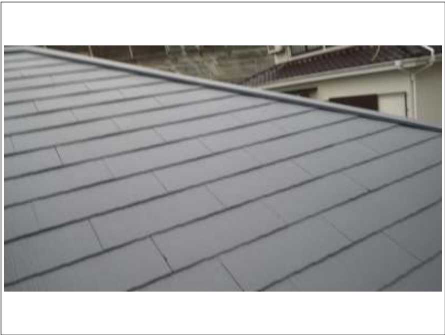
屋根塗装施工完了
