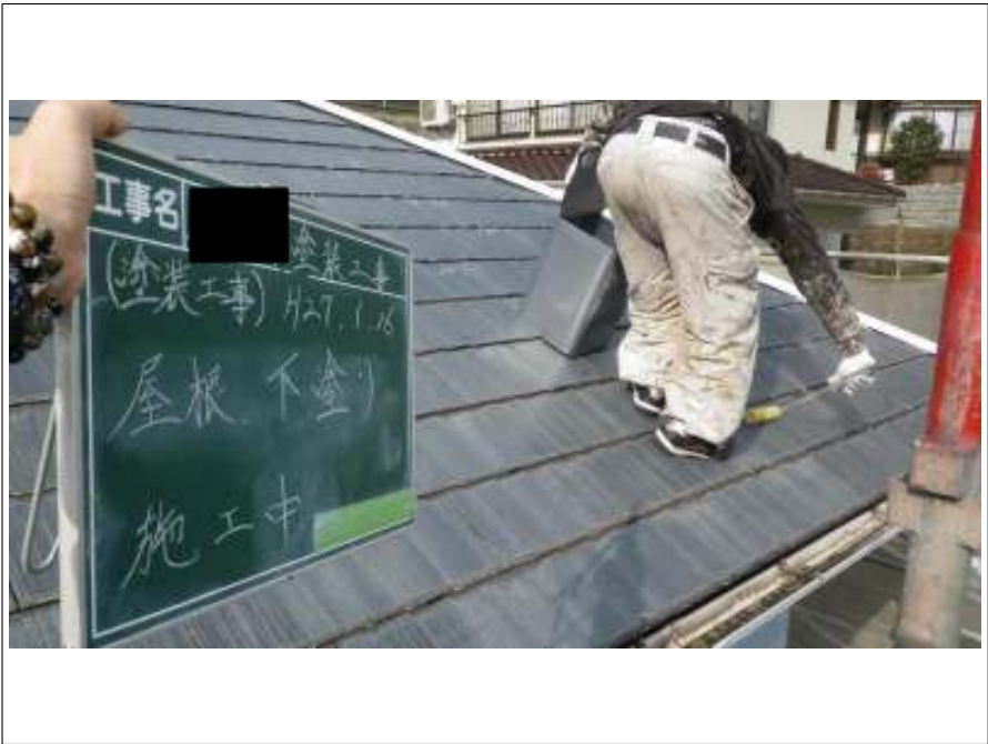
屋根塗装下塗り施工中
