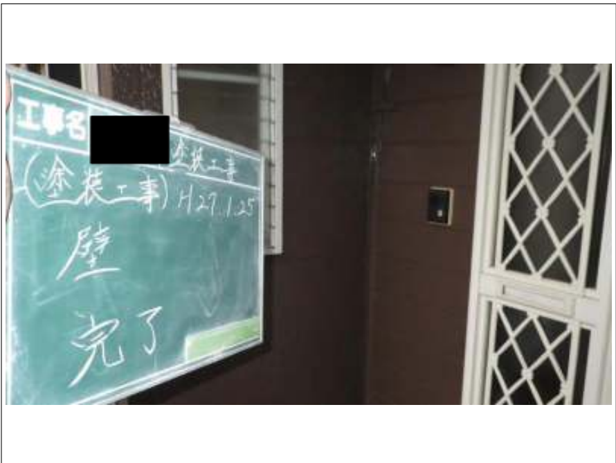
外壁塗装施工完了
