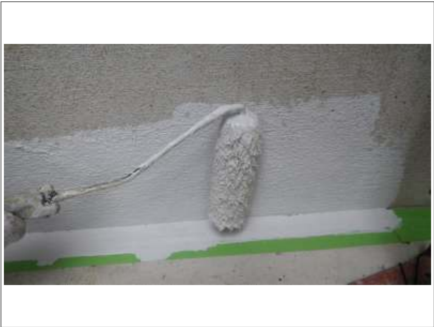
基礎塗装下塗り施工中
