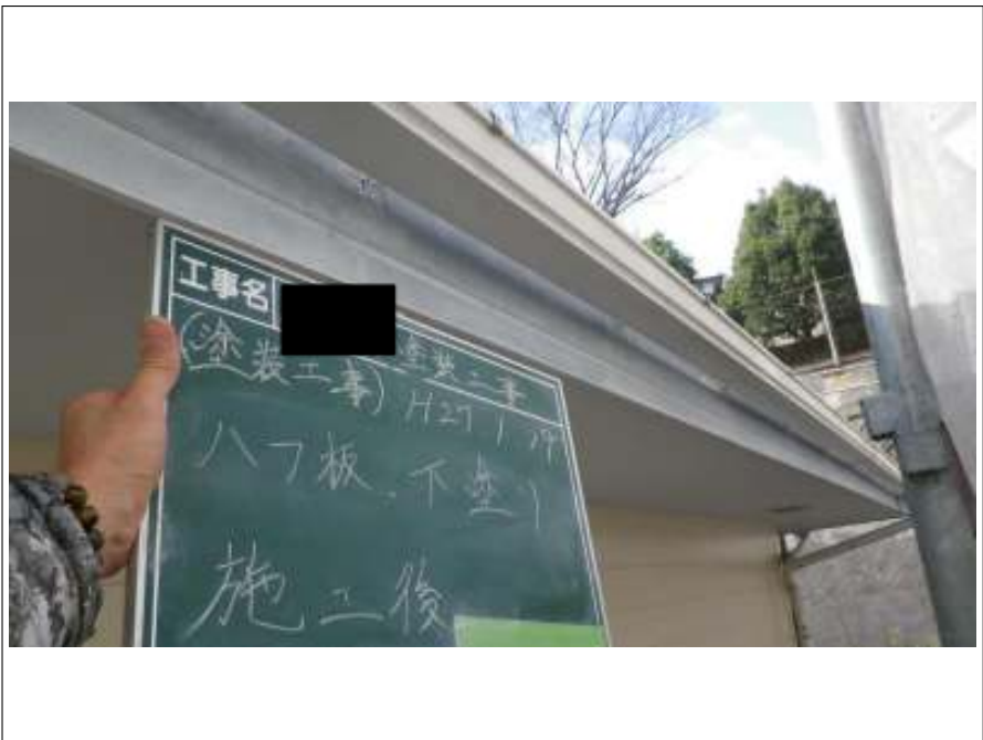
破風板塗装下塗り施工完了
