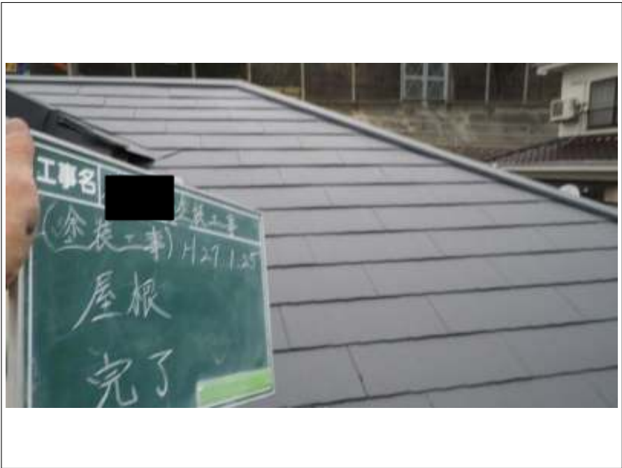
屋根塗装施工完了
