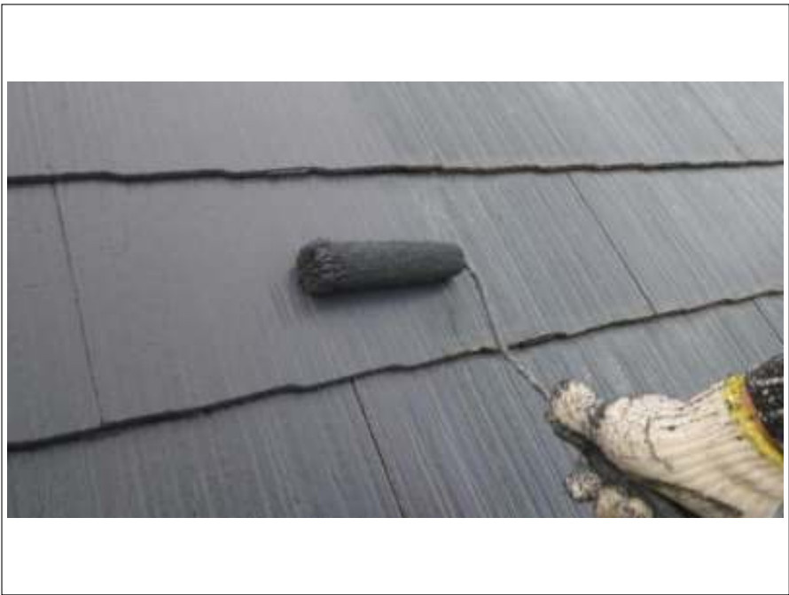
屋根塗装中塗り施工中
