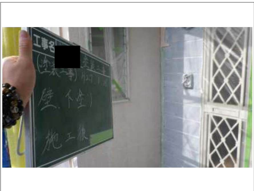
外壁塗装下塗り施工完了
