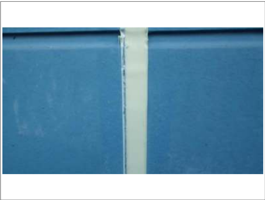
外壁シーリング打替え施工完了
