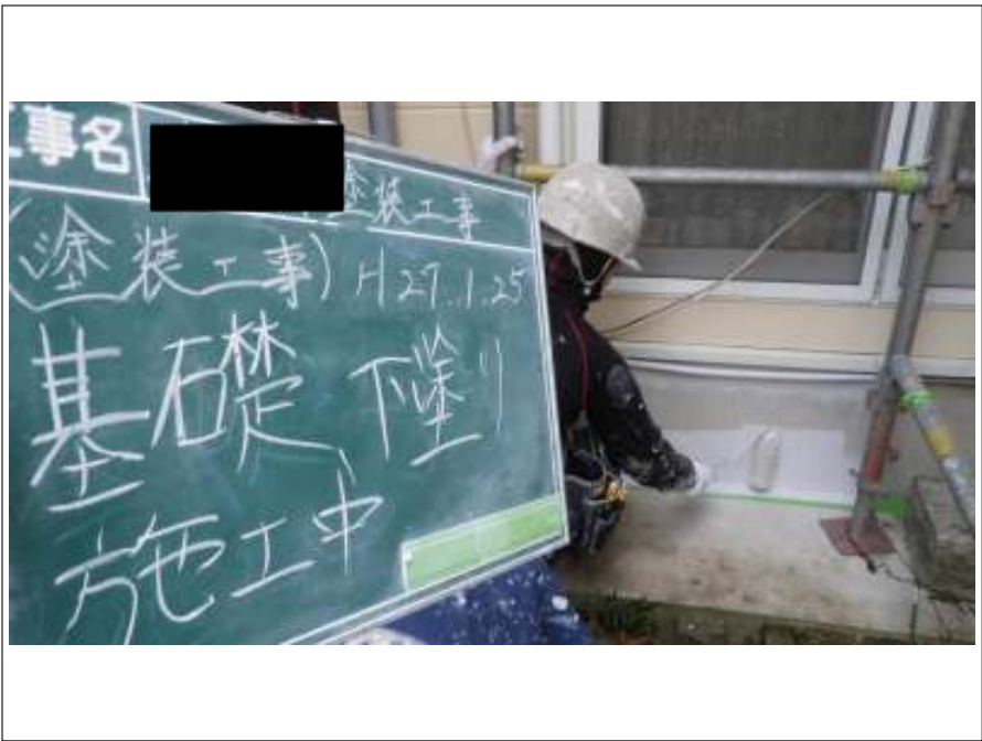
基礎塗装下塗り施工中
