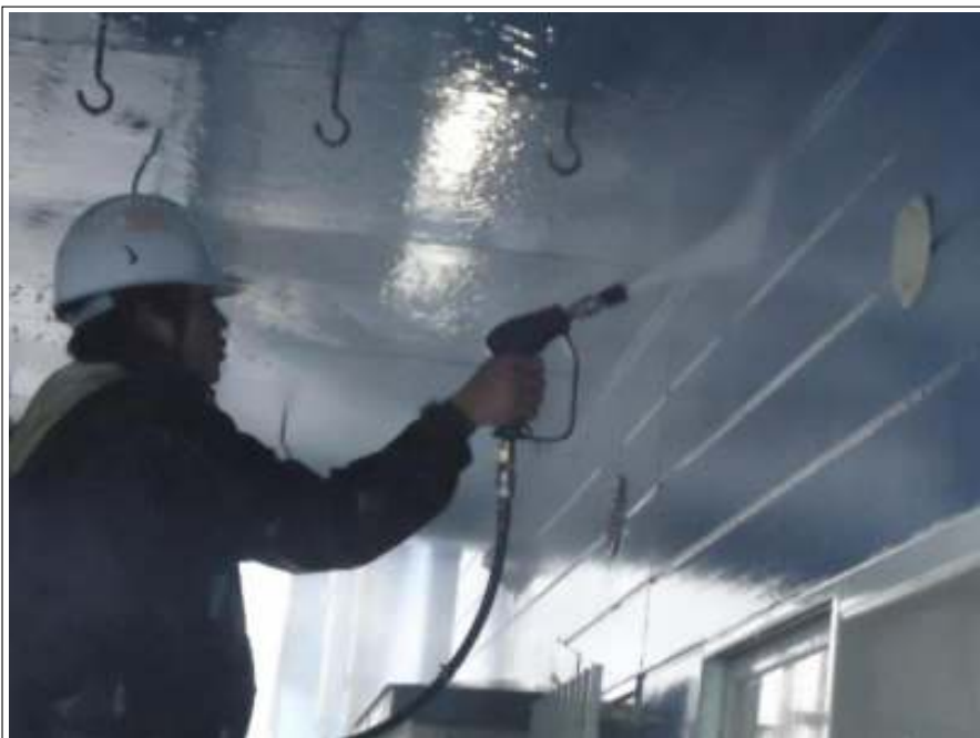
外壁高压洗净施工中
