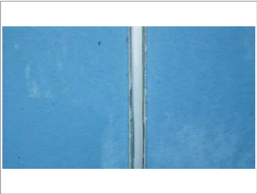
外壁シーリング撤去施工完了
