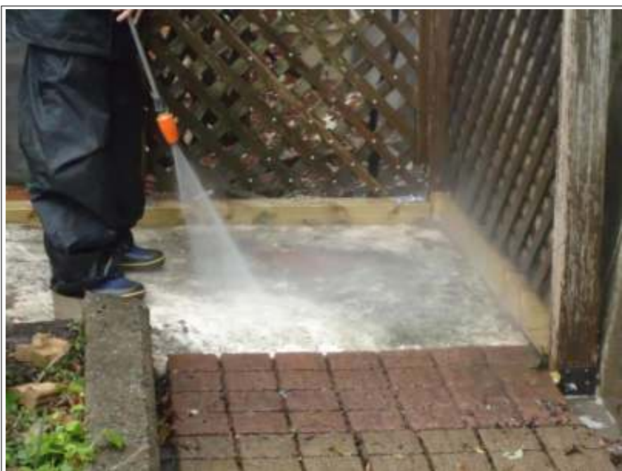
高压洗净施工中
