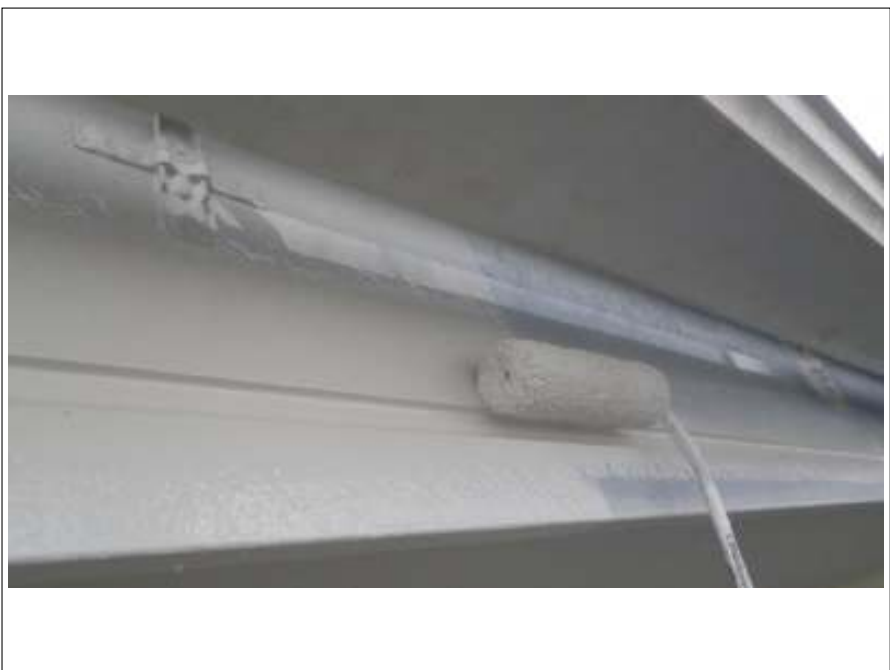
破風板塗装中塗り施工中
