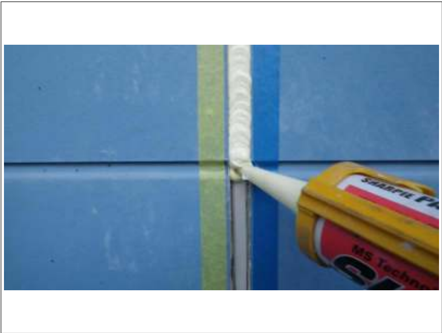
外壁シーリング打替え施工中
