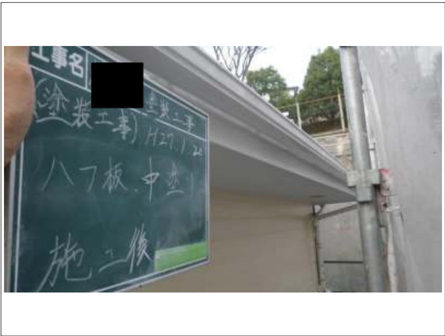
破風板塗装中塗り施工完了
