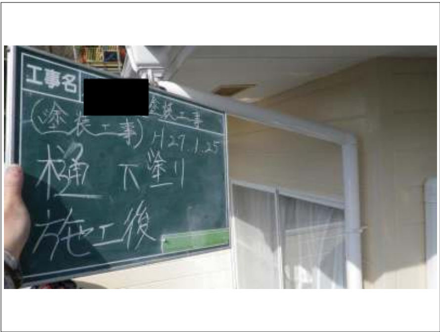
樋塗装下塗り施工完了
