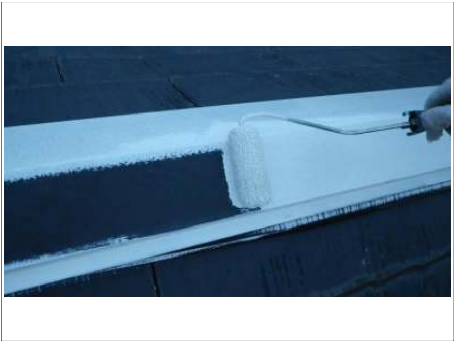
棟鉄板サビ止め施工中
