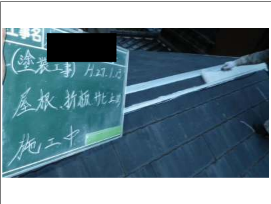
棟鉄板サビ止め施工中
