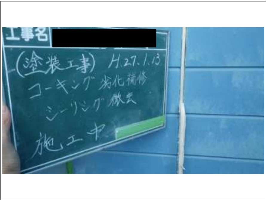
外壁シーリング撤去施工中
