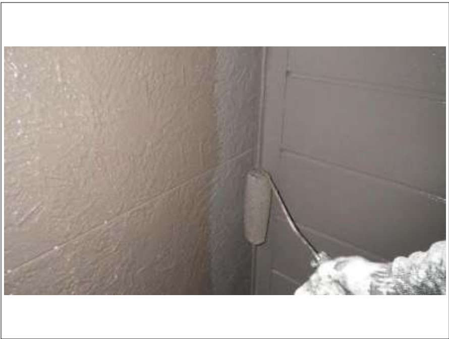
外壁塗装上塗り施工中
