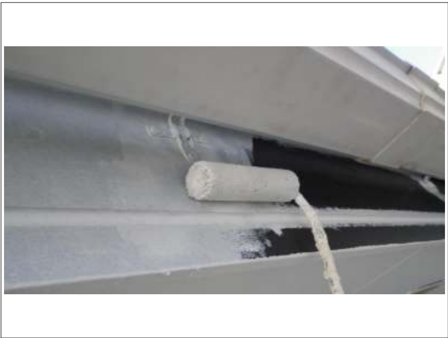
破風板塗装下塗り施工中
