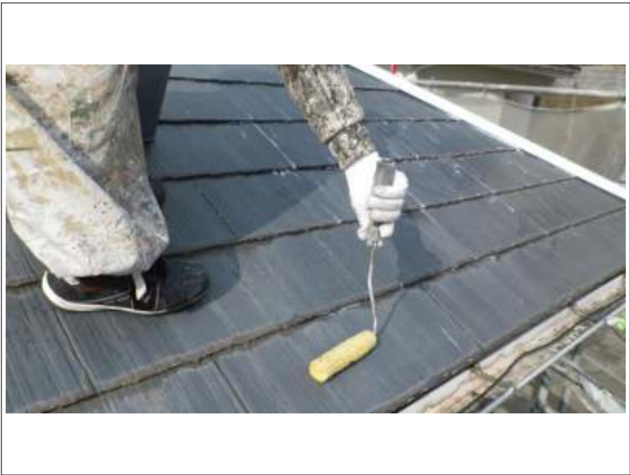
屋根塗装下塗り施工中
