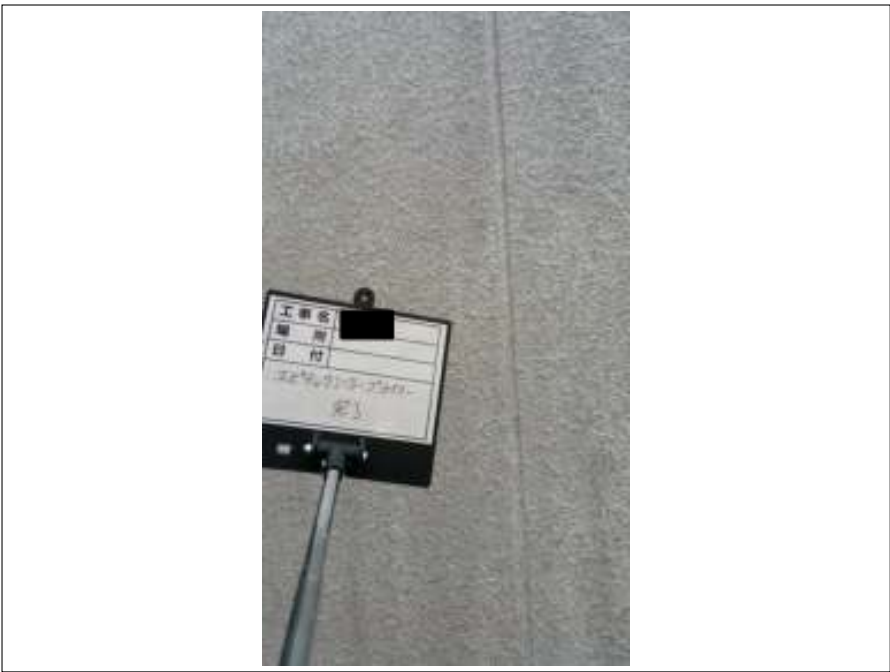
外壁 下塗り施工完了
