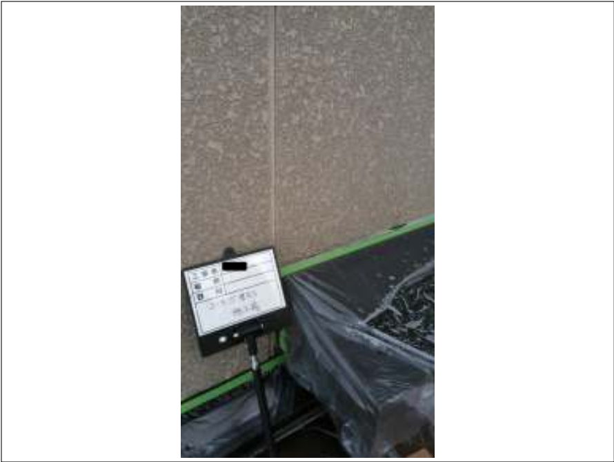
外壁 シーリング増し打ち施工前
