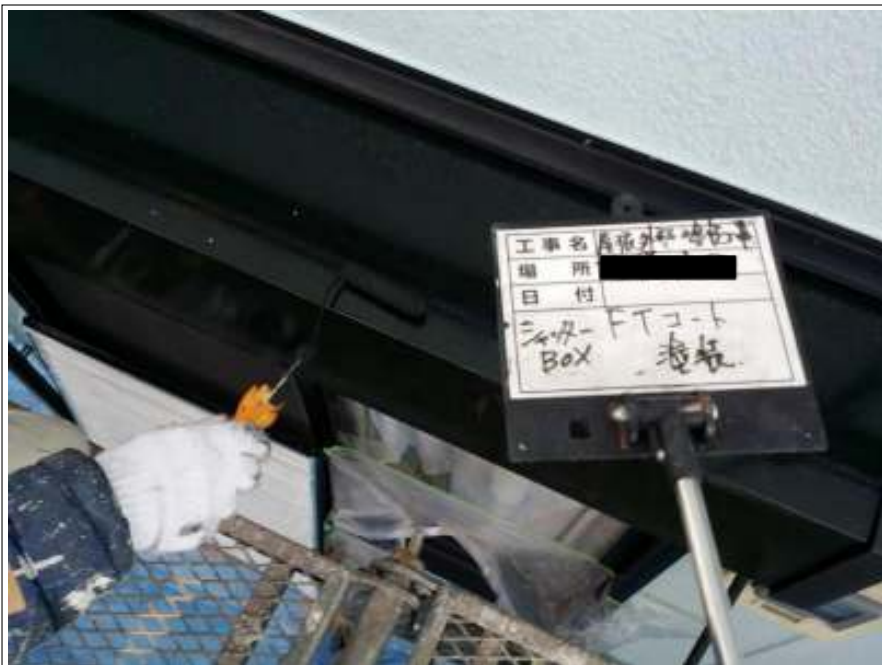
シャッターBOX 下塗り施工中
