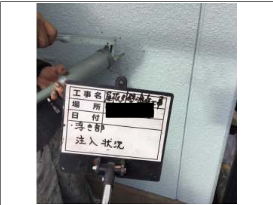
外壁 浮き部補修 施工中
