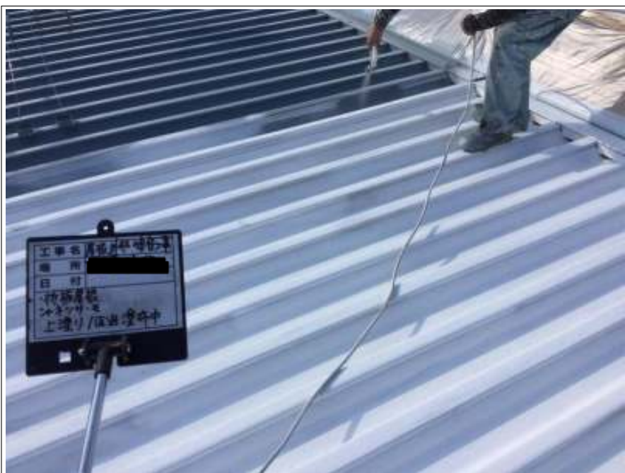
折半屋根 中塗り施工中
