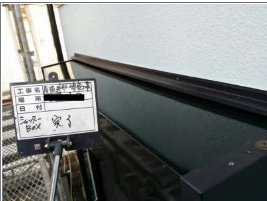
シャッターBOX 施工完了
