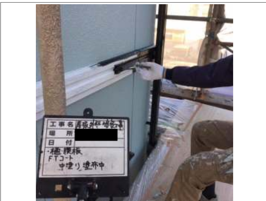
樋・帯 中塗り施工中
