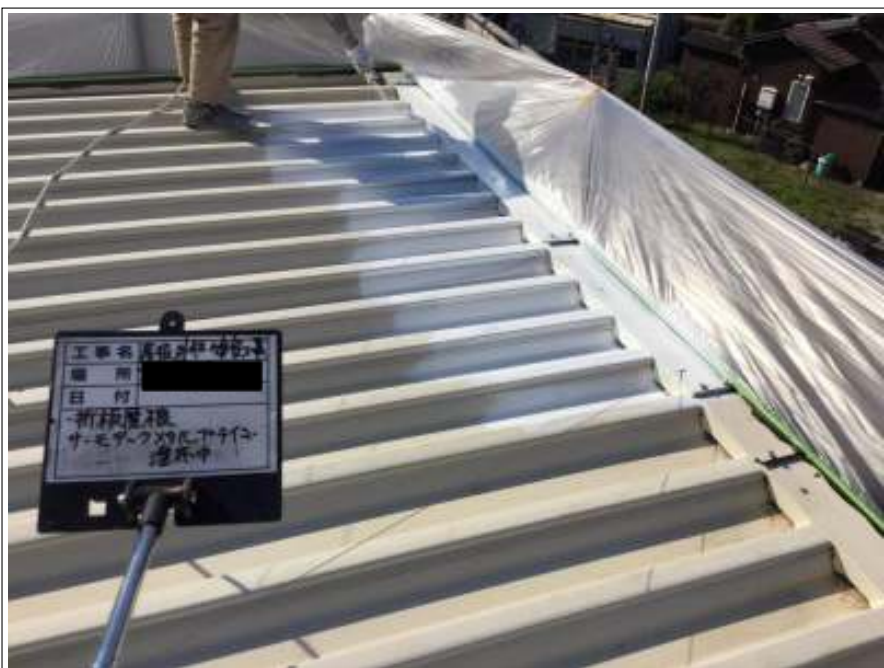
折半屋根 下塗り施工中
