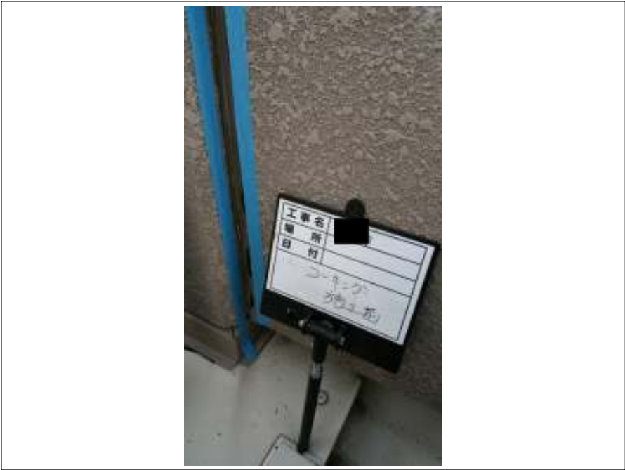
外壁 シーリング打ち替え施工前
