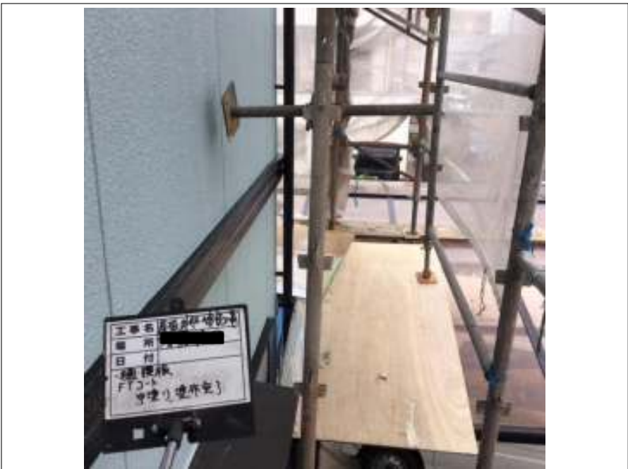
樋・帯 中塗り施工完了
