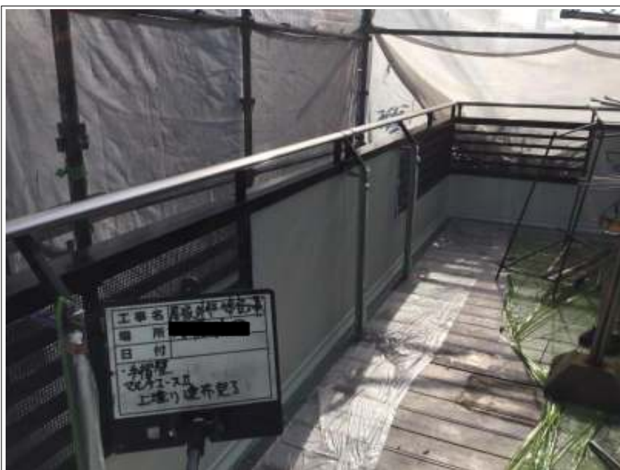
ベランダ内壁 施工完了
