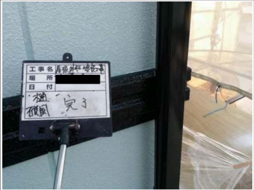
樋・帯 施工完了
