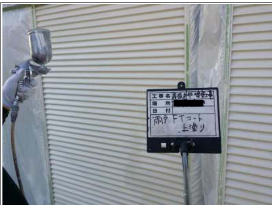
雨戸 上塗り施工中
