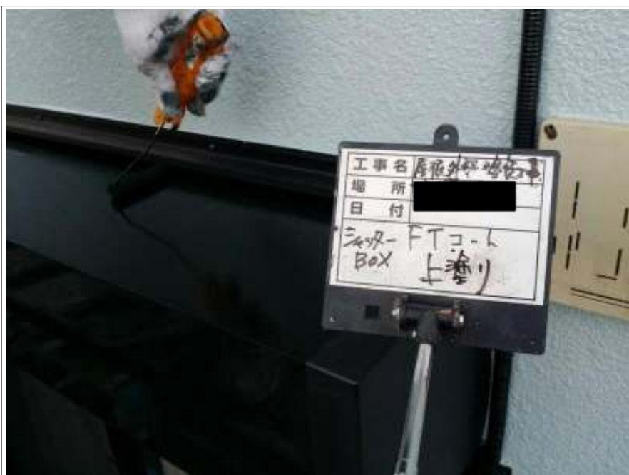
シャッターBOX 上塗り施工中
