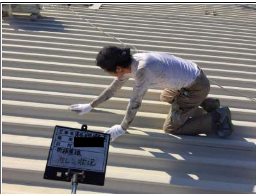
折半屋根 ケレン処理施工中
