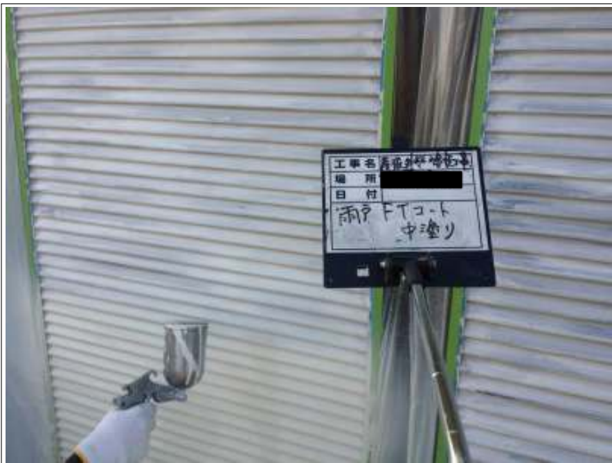
雨戸 中塗り施工中
