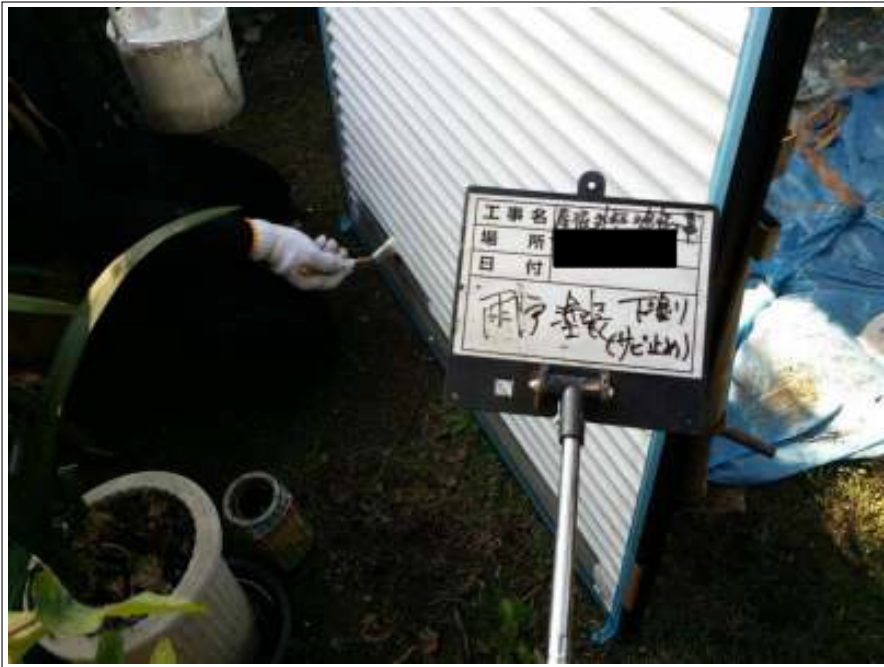
雨戸 下塗り施工中
