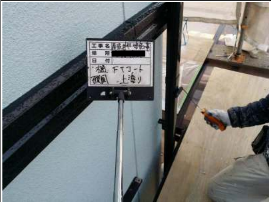
樋・帯 上塗り施工中
