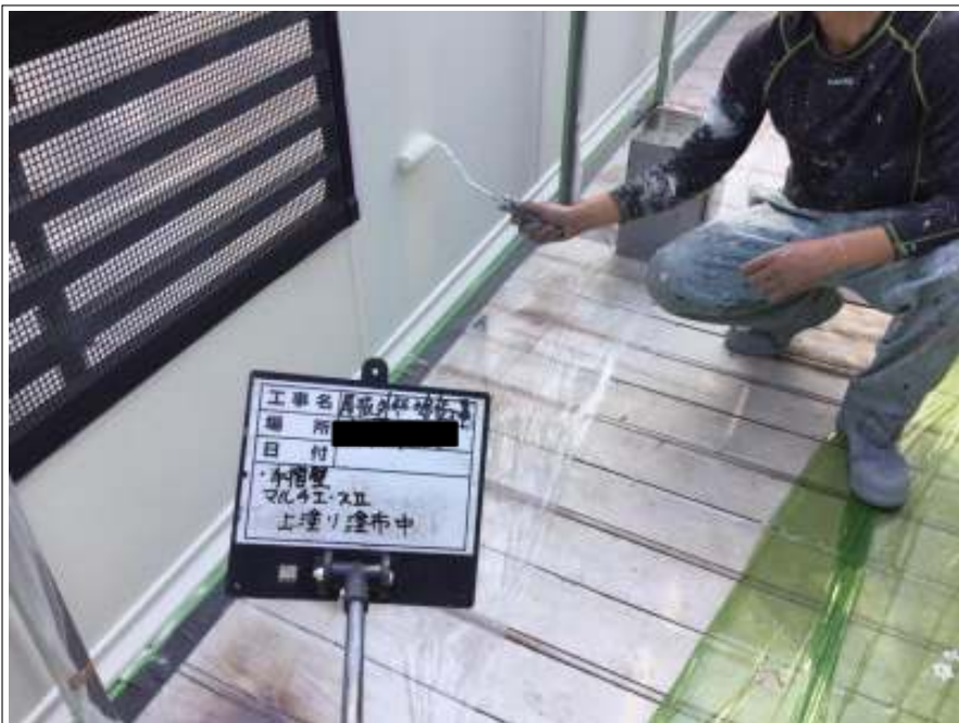
ベランダ内壁 上塗り施工中
