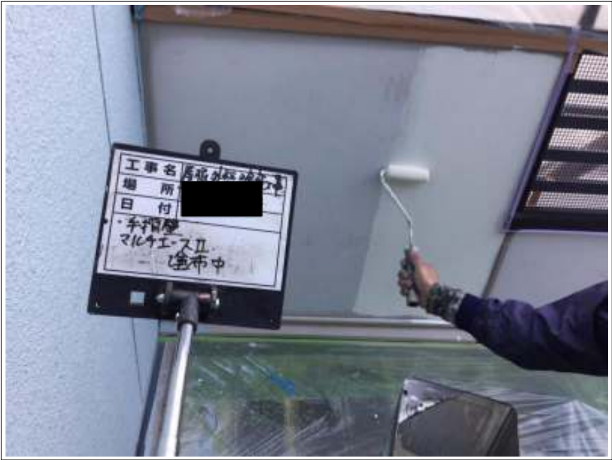
ベランダ内壁 下塗り施工中
