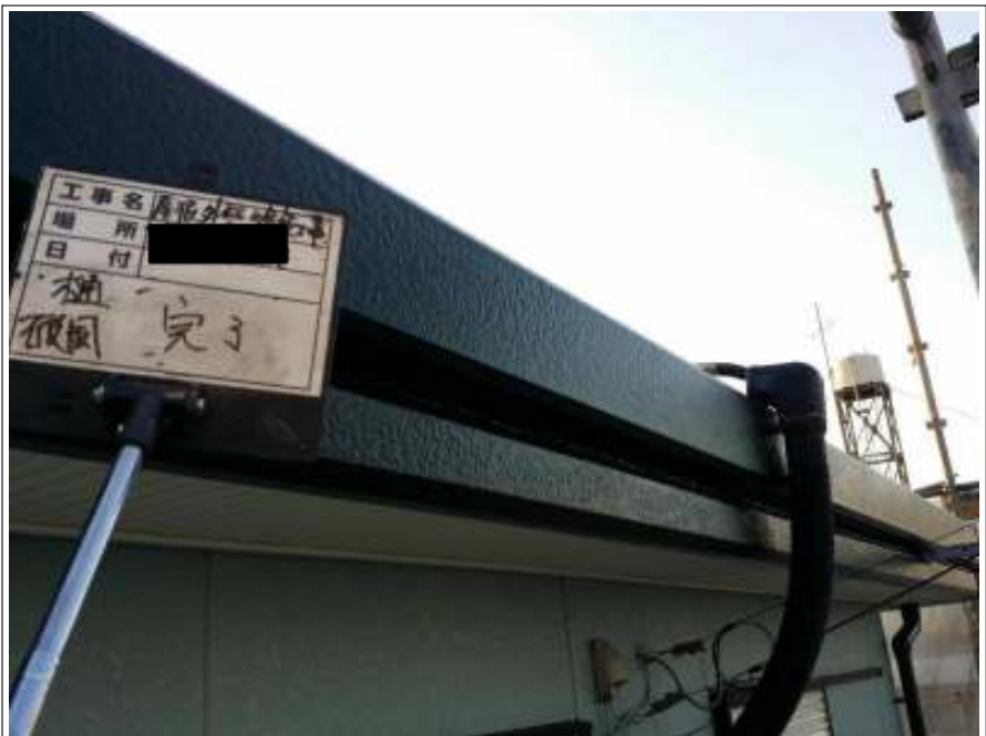
樋・破風板 施工完了
