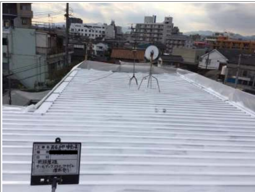
折半屋根 下塗り施工完了
