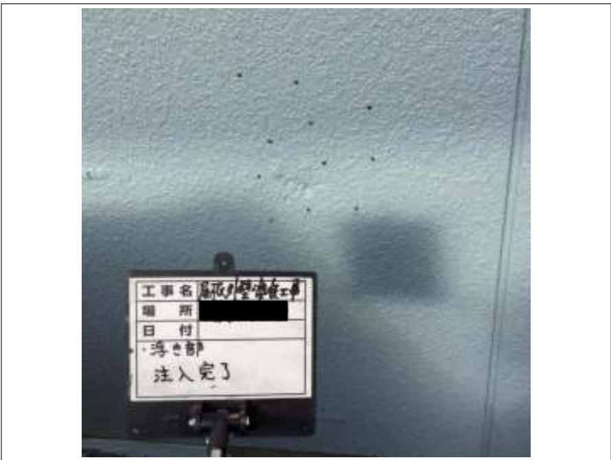
外壁 浮き部補修 施工完了
