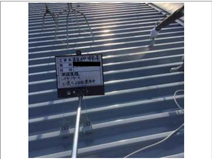
折半屋根 上塗り施工中
