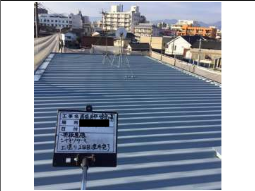
折半屋根 上塗り施工完了
