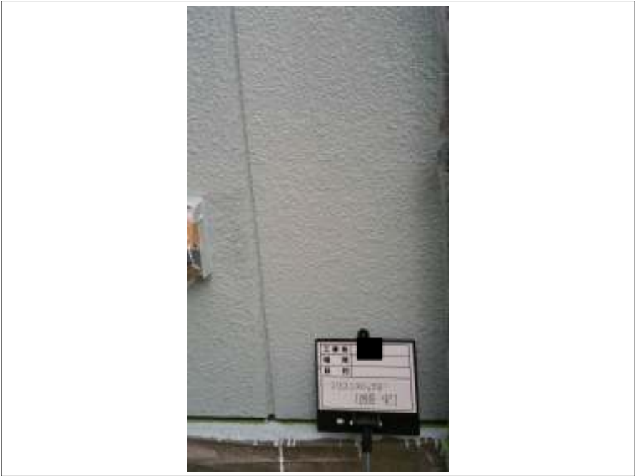
外壁 中塗り施工完了
