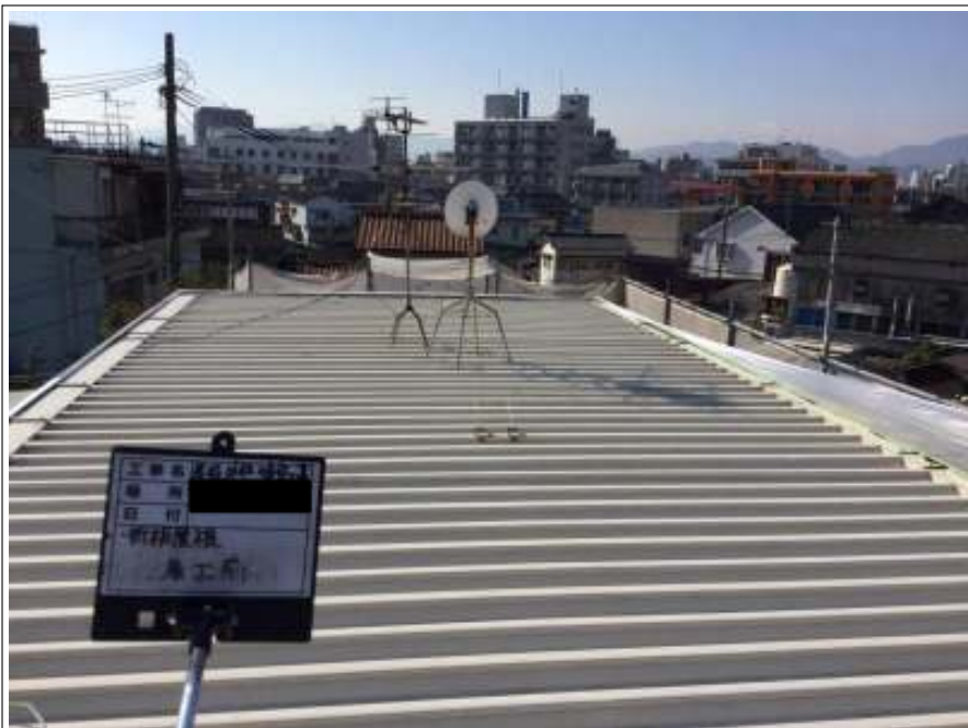
折半屋根 施工前
