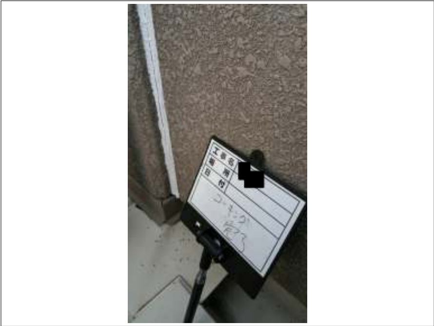
外壁 シーリング打ち替え施工完了
