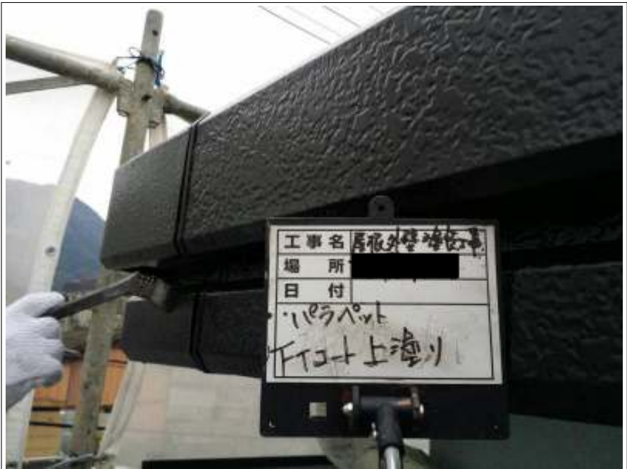
パラペット 施工完了
