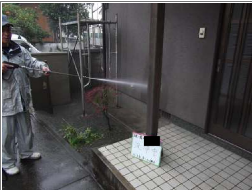
高圧洗浄施工中
