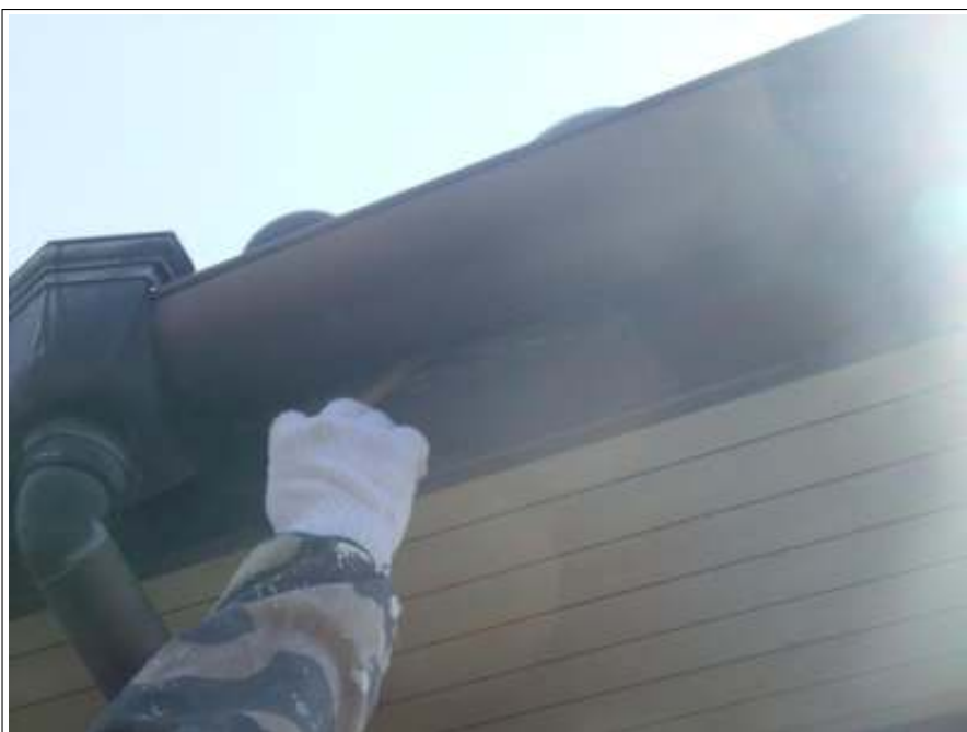
破風板 施工中
