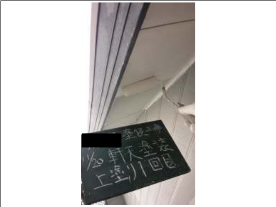
軒天 上塗り（1回目）施工中
