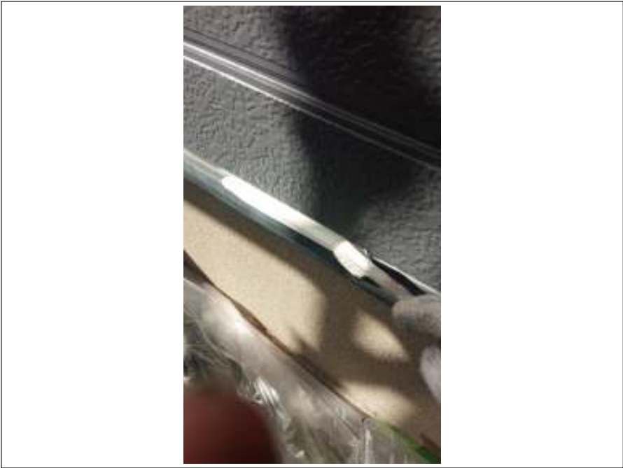
土台水切り 下塗り施工中
