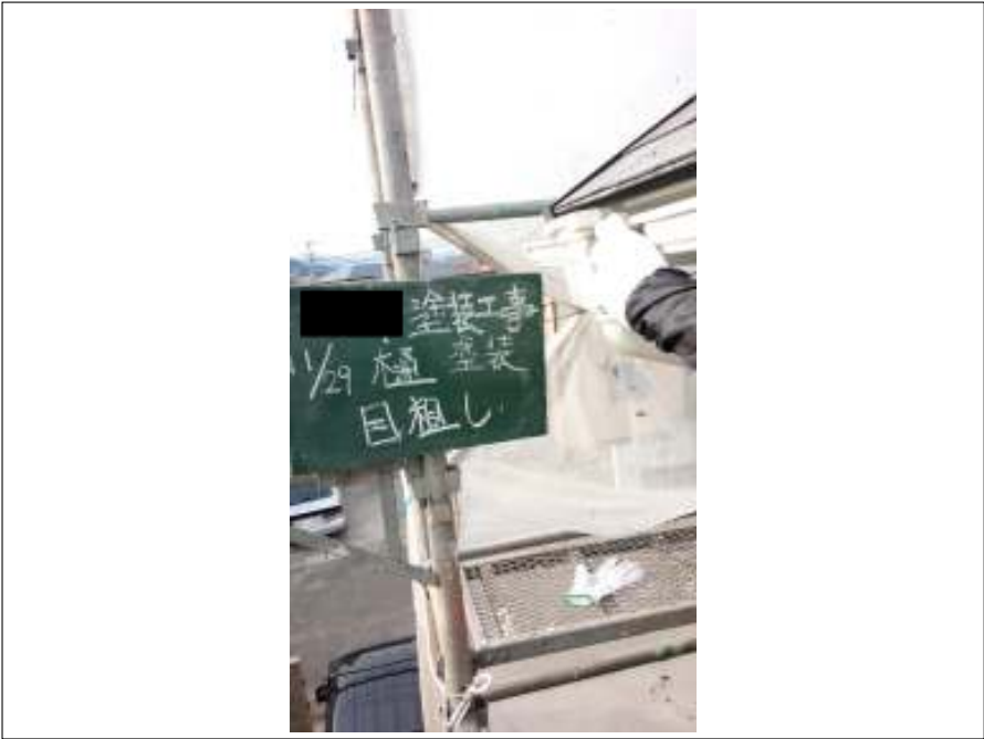
樋 下地処理施工中
