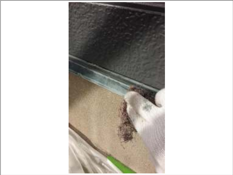
土台水切り ケレン処理施工中
