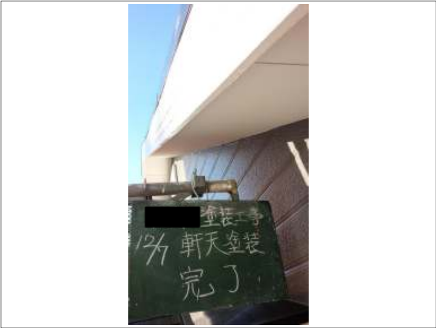
軒天 施工完了
