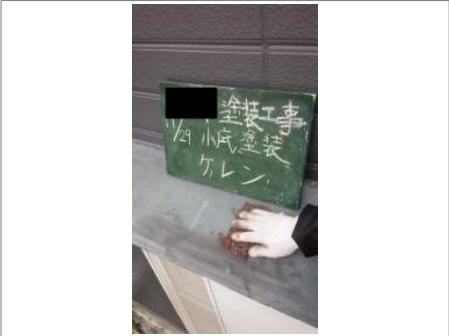
小庇 ケレン処理施工中
