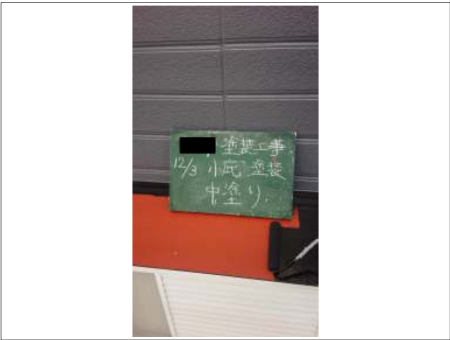
小庇 中塗り施工中
