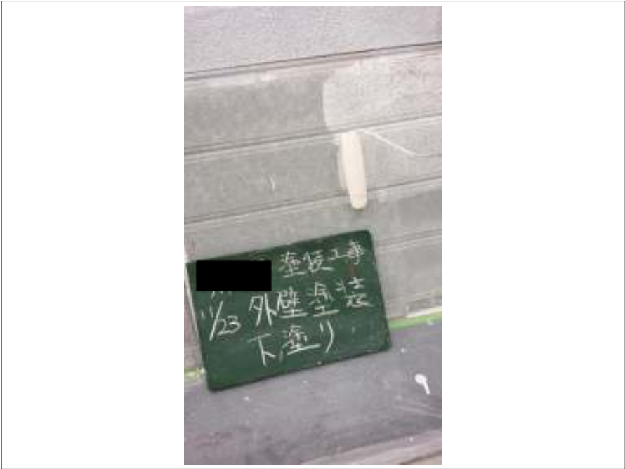
外壁 下塗り施工中
