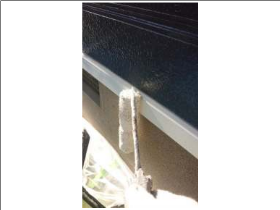
土台水切り 上塗り施工中
