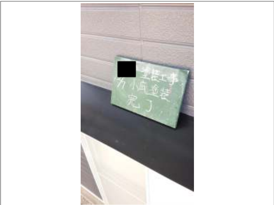
小庇 施工完了
