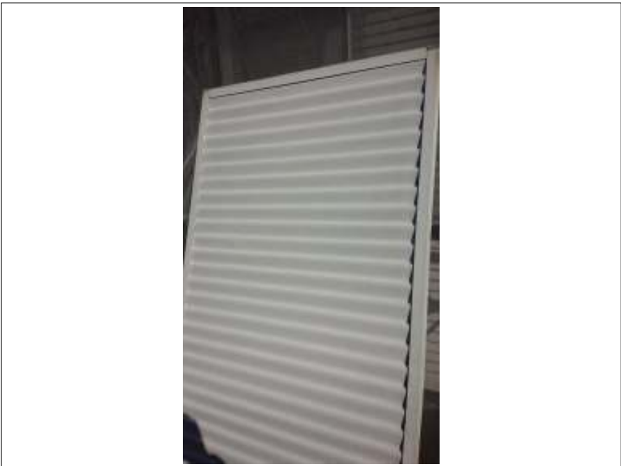
雨戸 施工完了
