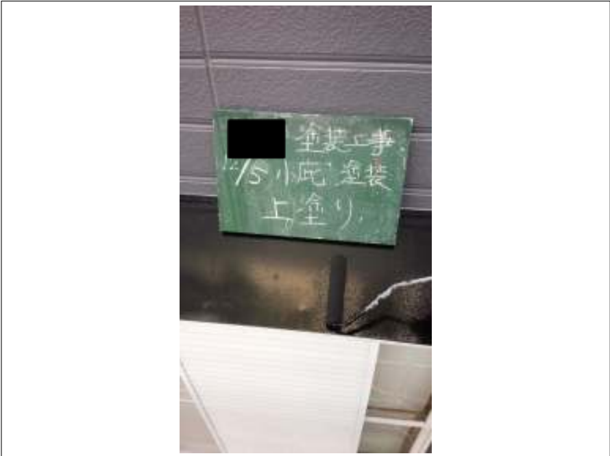
小庇 上塗り施工中
