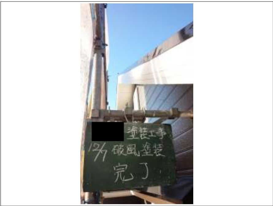
破風板 施工完了
