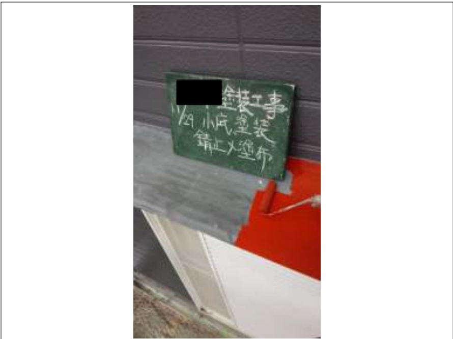
小庇 サビ止め塗布施工中
