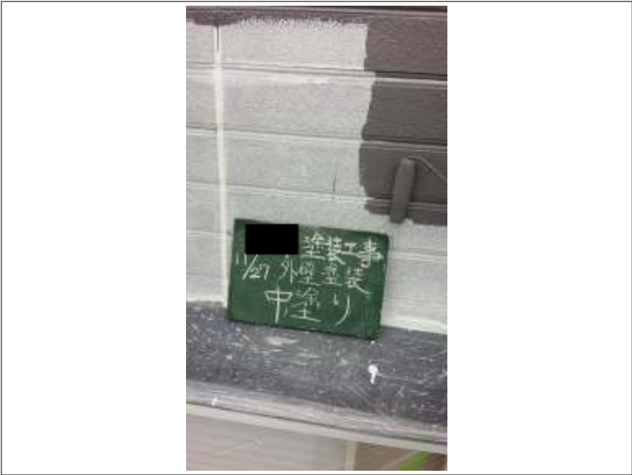
外壁 中塗り施工中
