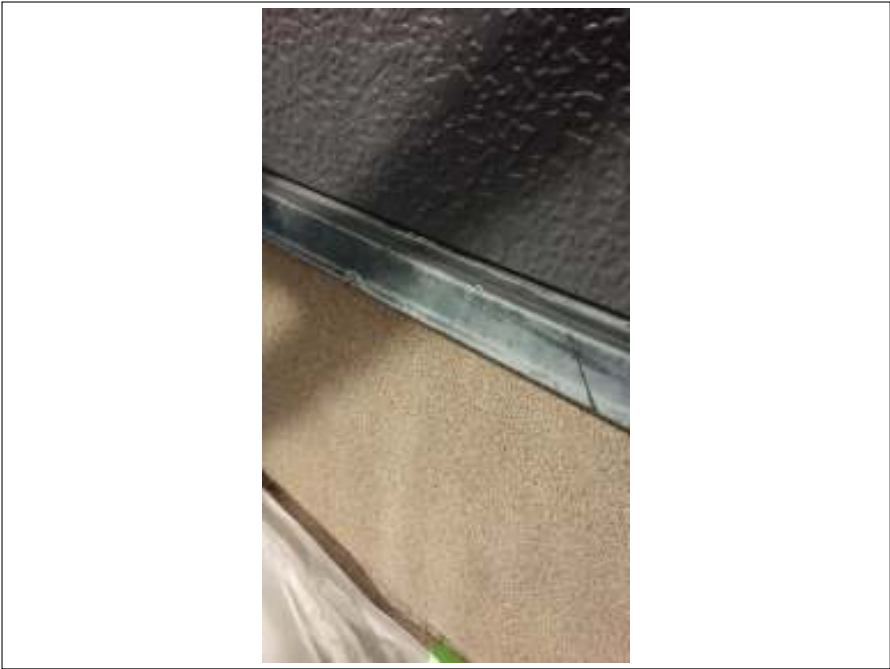
土台水切り 施工前
