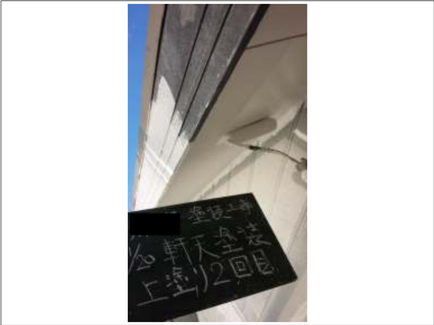
軒天 上塗り（2回目）施工中
