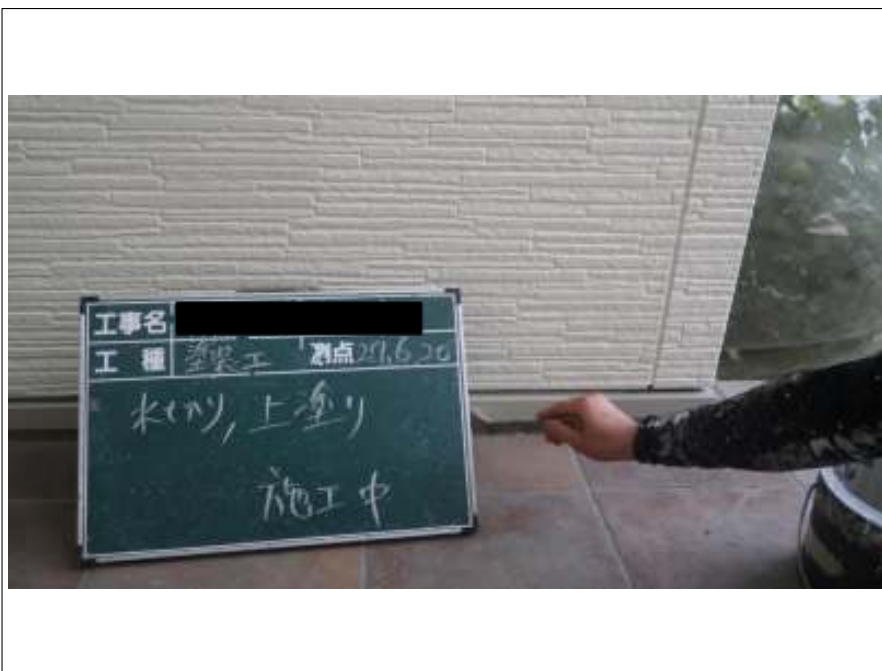
土台水切り 上塗り施工中
