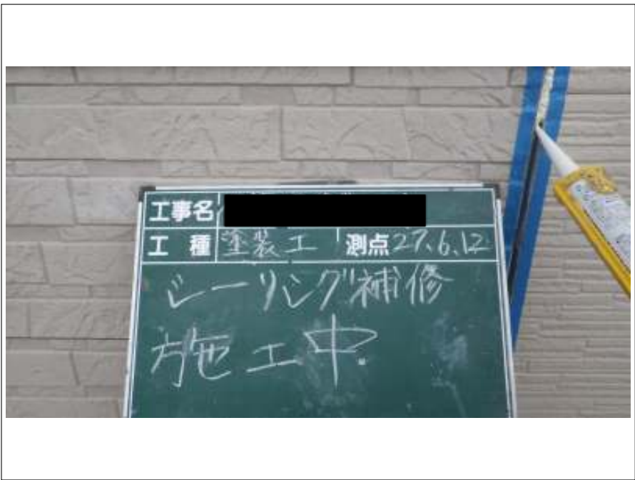
外壁 シーリング打ち替え施工中
