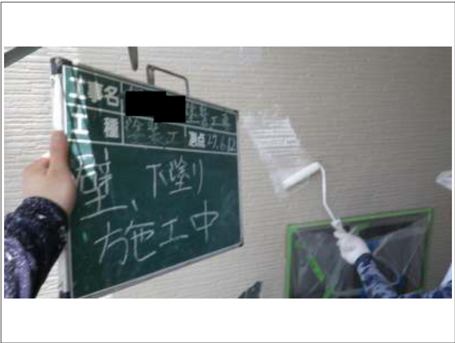
外壁 下塗り施工中
