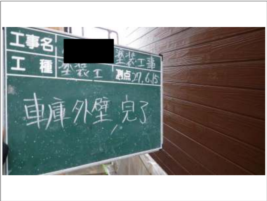
車庫外壁 施工完了
