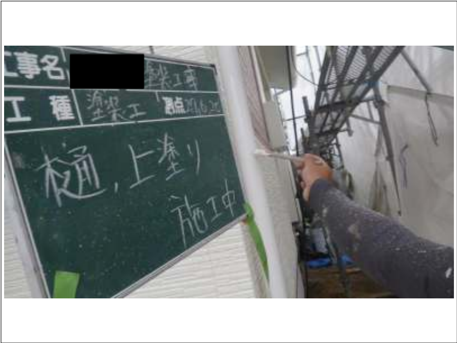
樋 上塗り施工中
