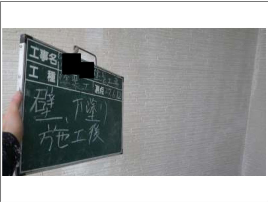
外壁 下塗り施工後
