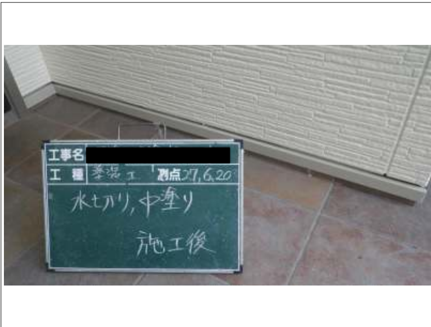
土台水切り 中塗り施工後
