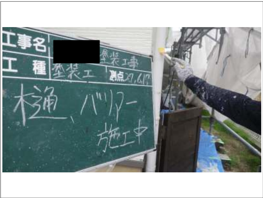
樋 バリアー施工中
