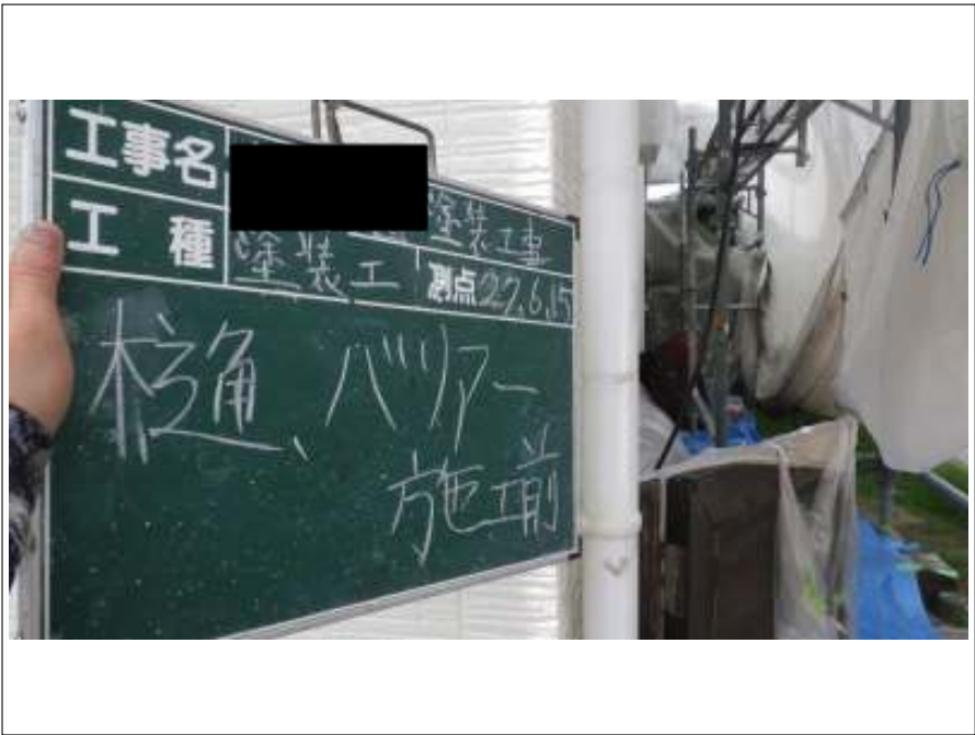
樋 バリアー施工前
