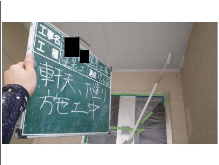
軒天 下塗り施工中
