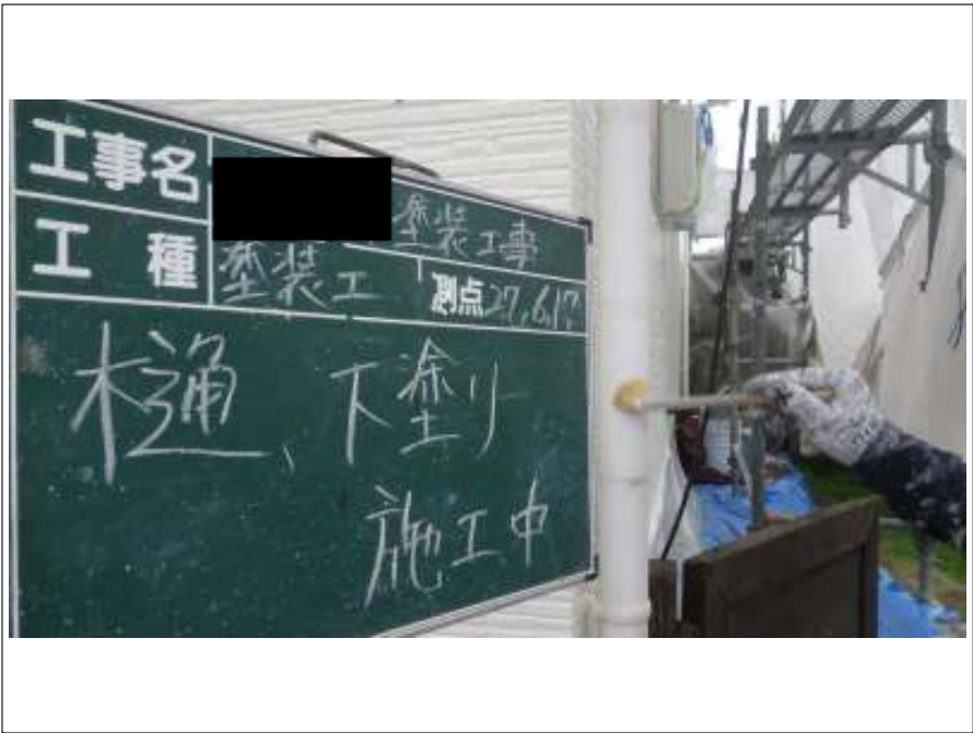
樋 下塗り施工中
