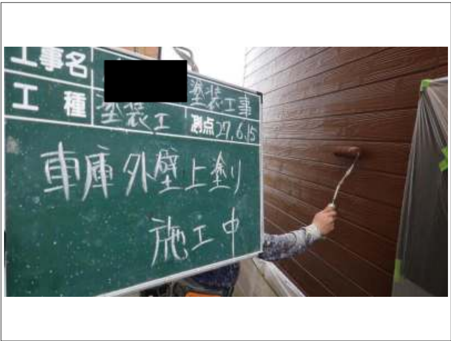
車庫外壁 上塗り施工中
