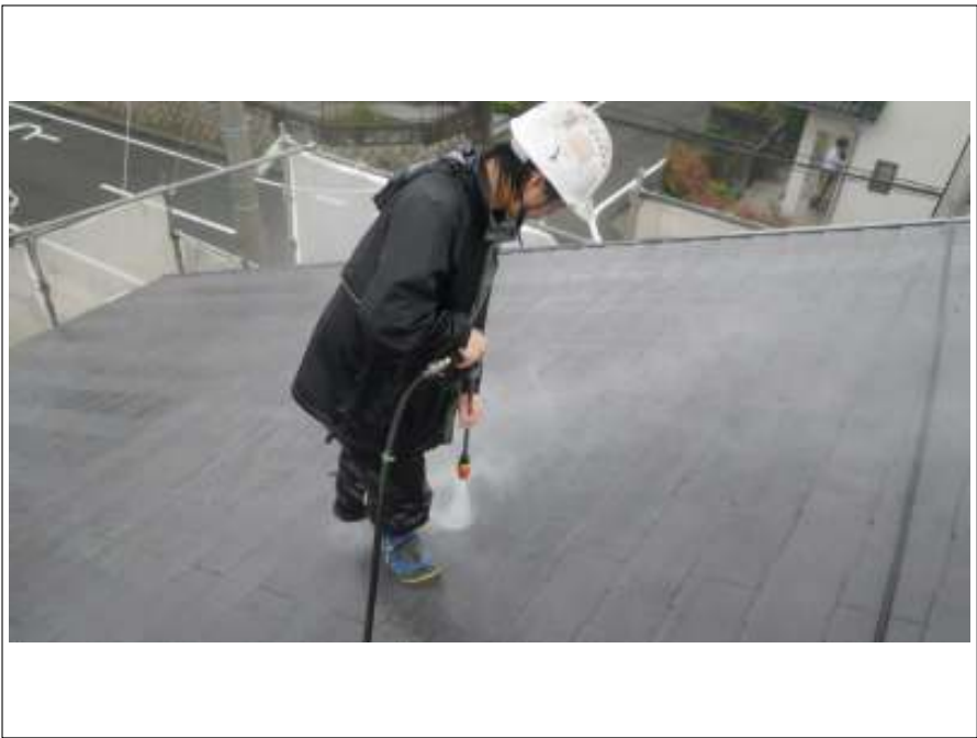
屋根 高圧洗浄中
