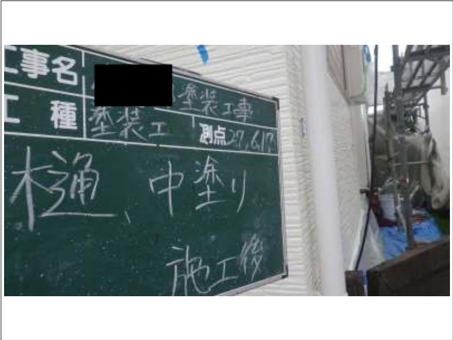
樋 中塗り施工後
