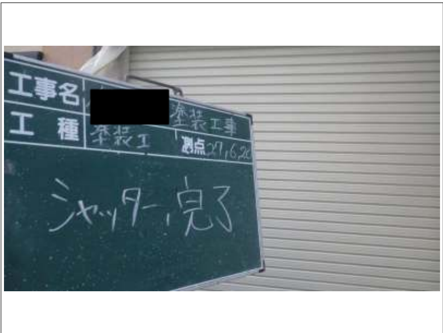
シャッター 施工完了
