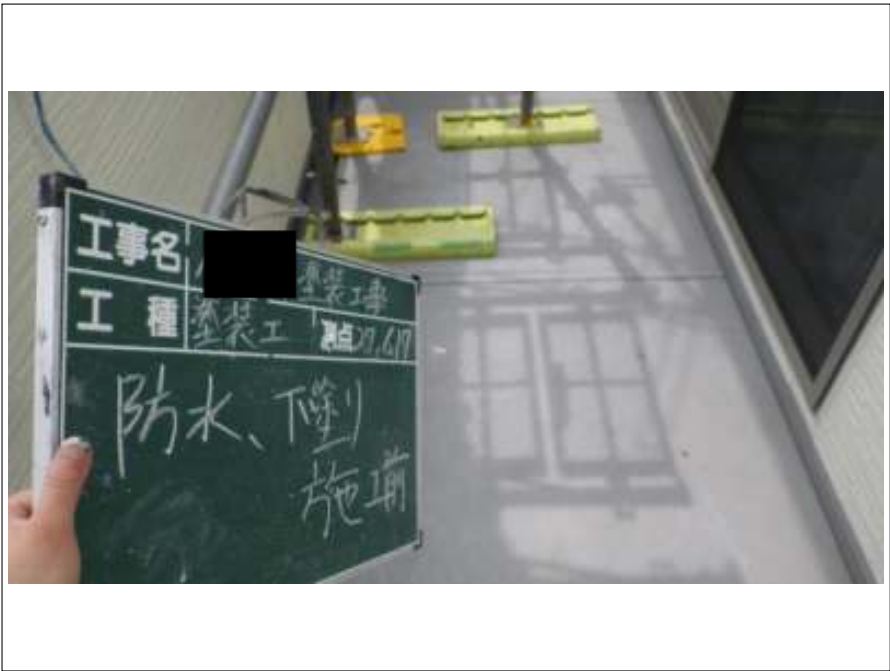
ベランダ防水 下塗り施工前
