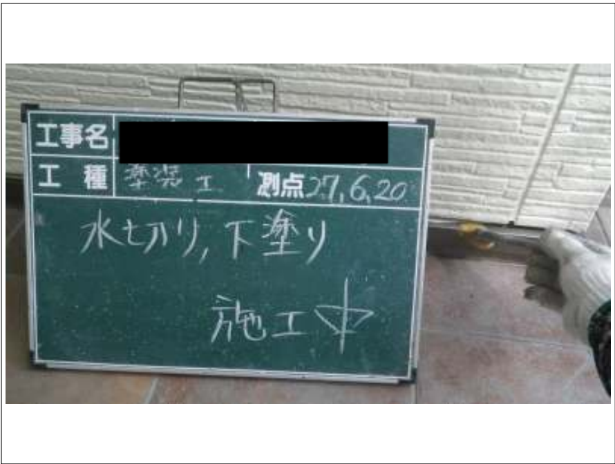
土台水切り 下塗り施工中
