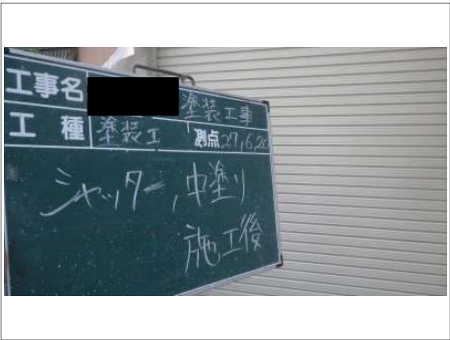
シャッター 中塗り施工後
