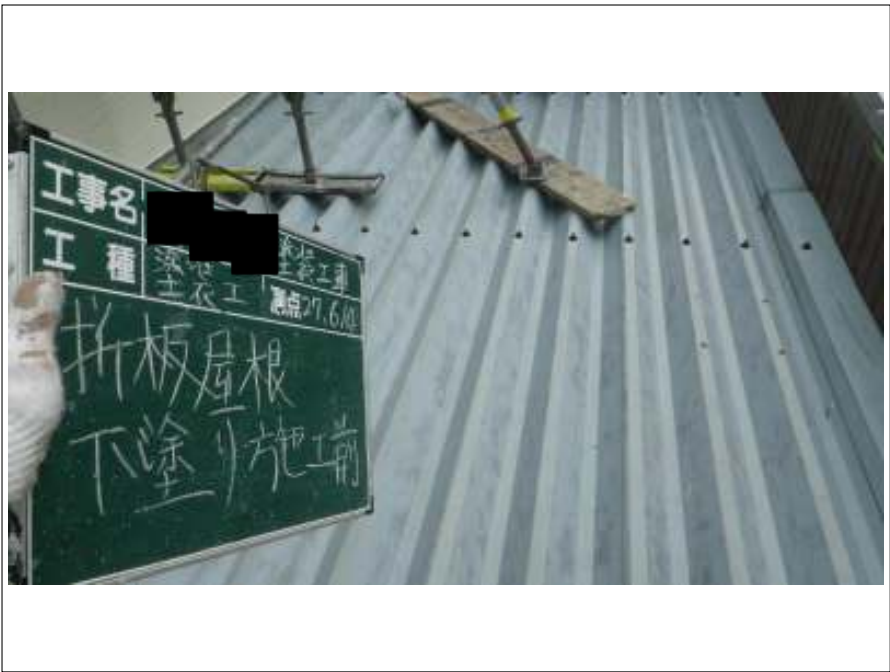
折板屋根 下塗り施工前
