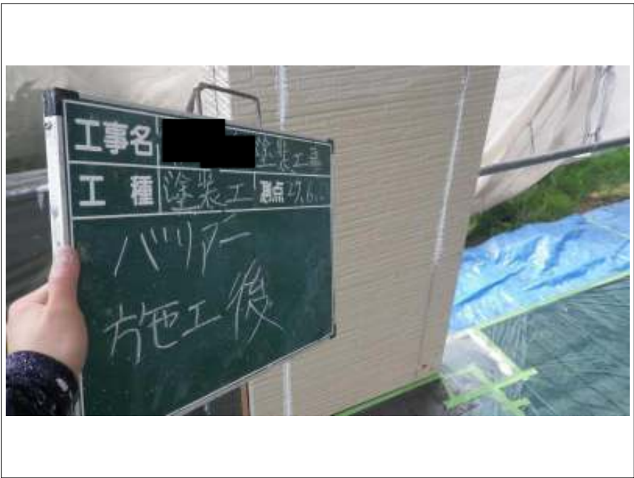
外壁 バリヤー施工後
