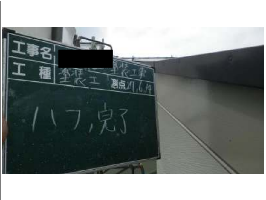
破風板 施工完了
