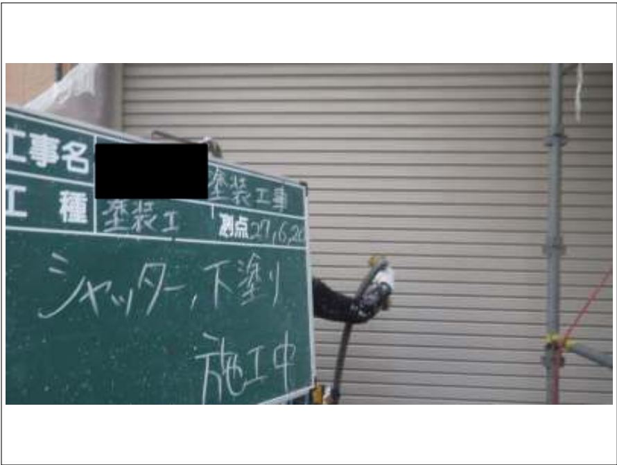
シャッター 下塗り施工中
