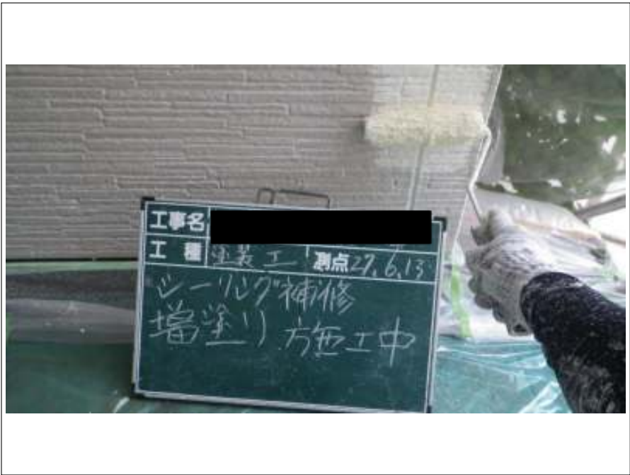
外壁 目地部増し塗り施工中
