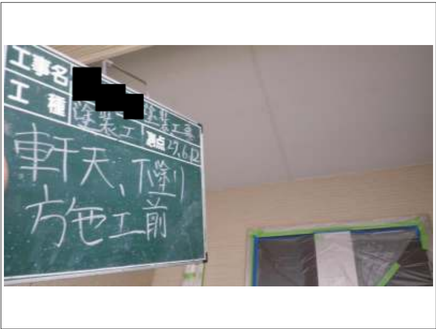
軒天 下塗り施工前
