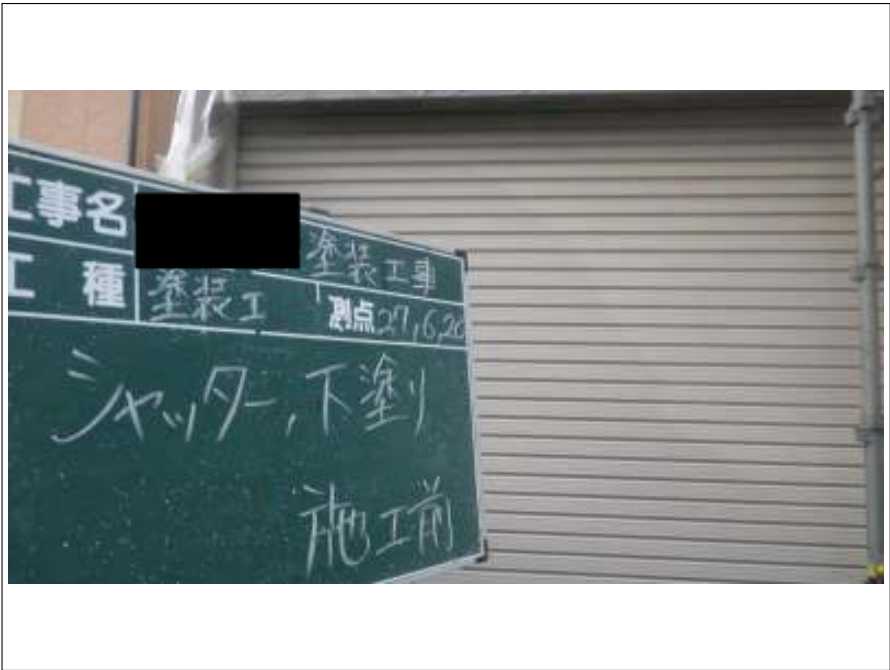
シャッター 下塗り施工前
