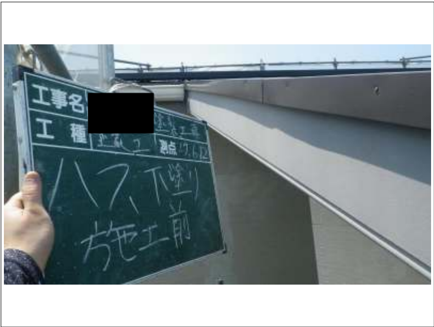
破風板 下塗り施工前
