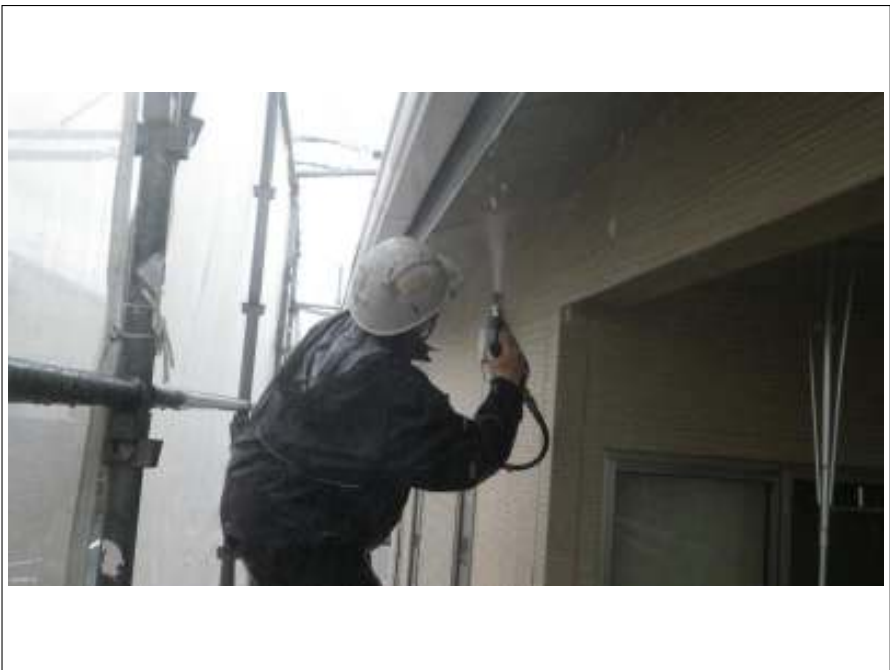
軒天 高圧洗浄中
