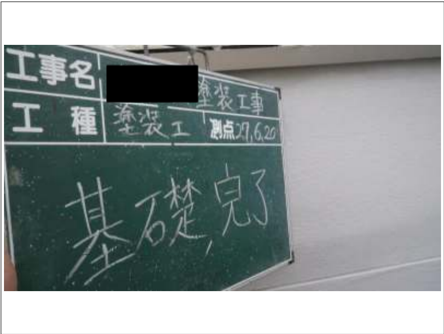
基礎 施工完了
