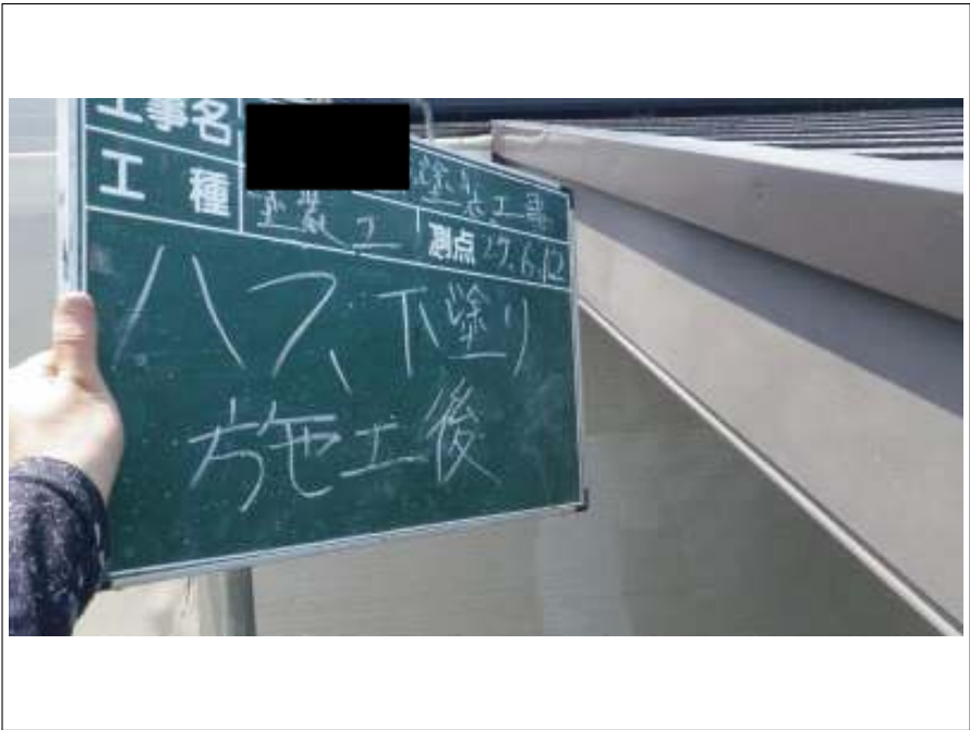
破風板 下塗り施工後
