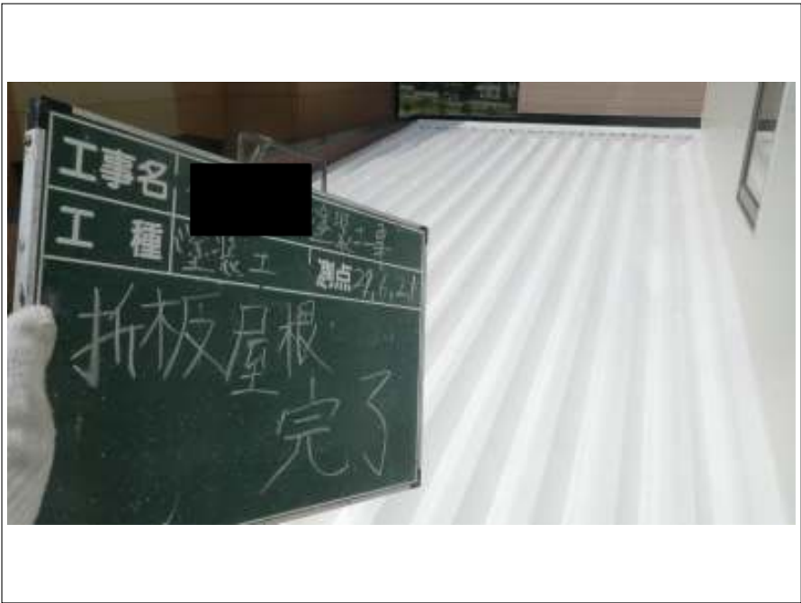
折板屋根 施工完了
