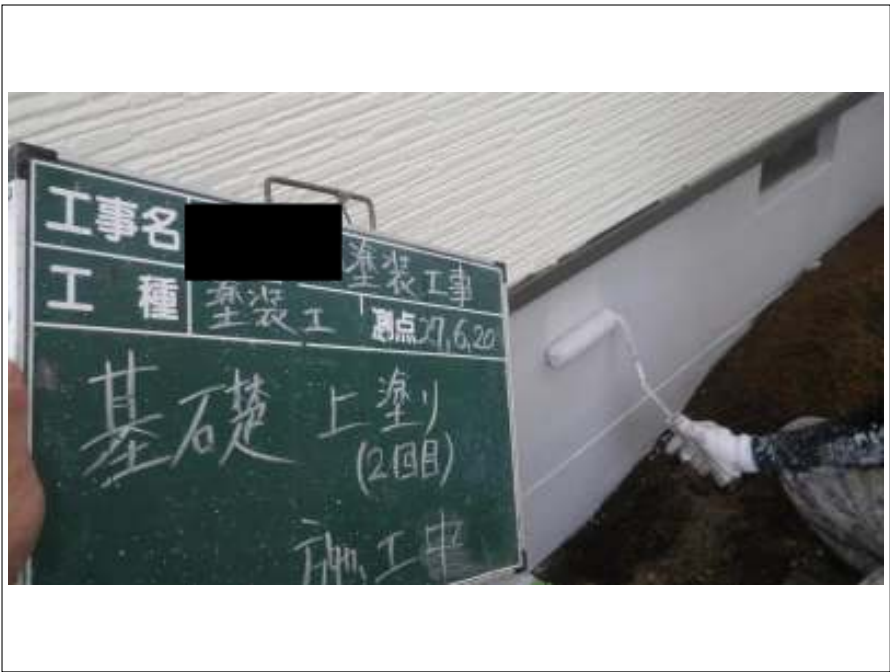
基礎 上塗り施工中(2回目)
