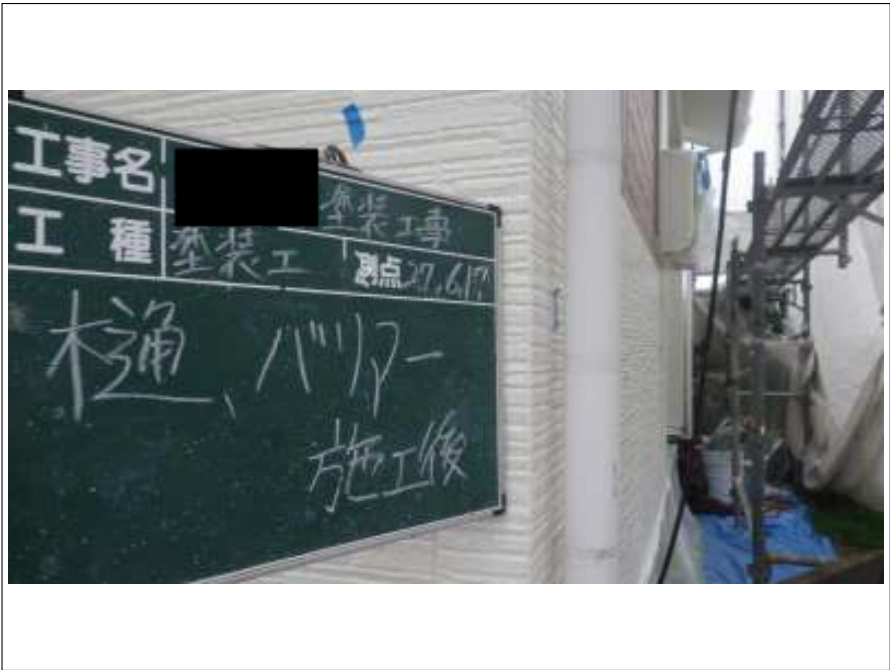
樋 バリアー施工後
