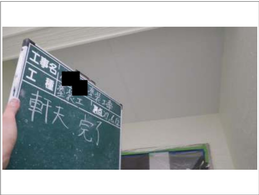
軒天 施工完了
