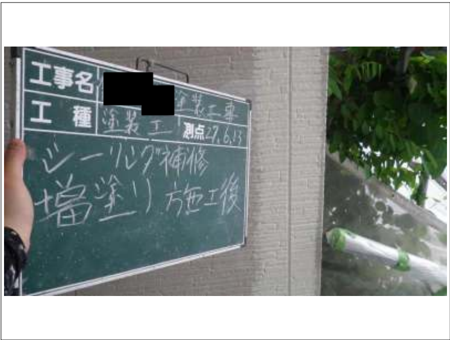
外壁 目地部増し塗り施工後
