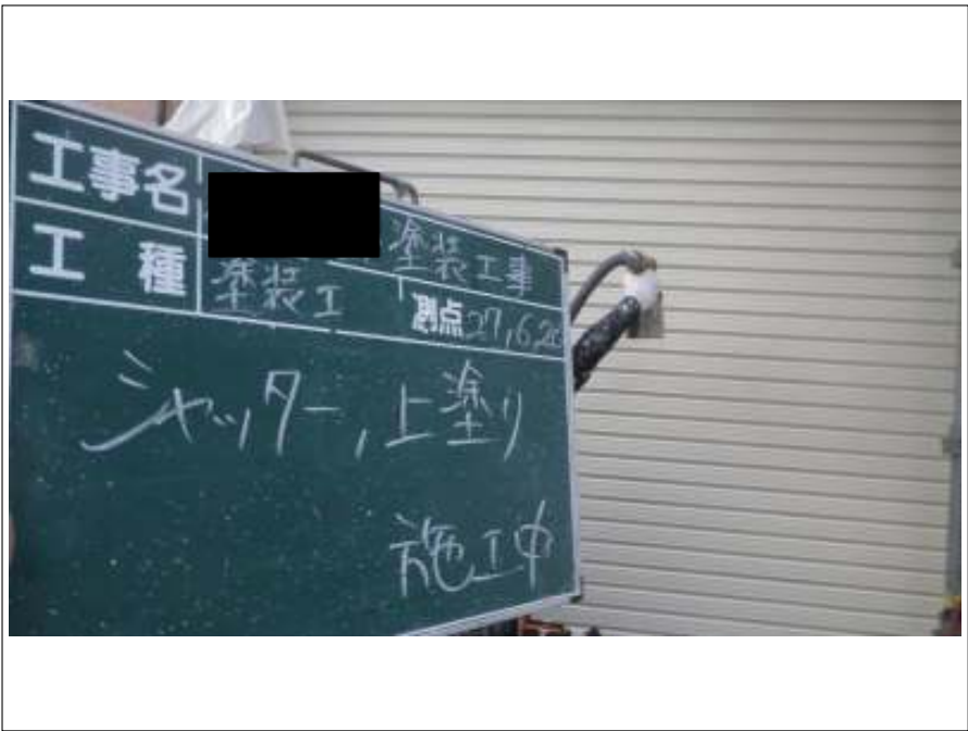
シャッター 上塗り施工中
