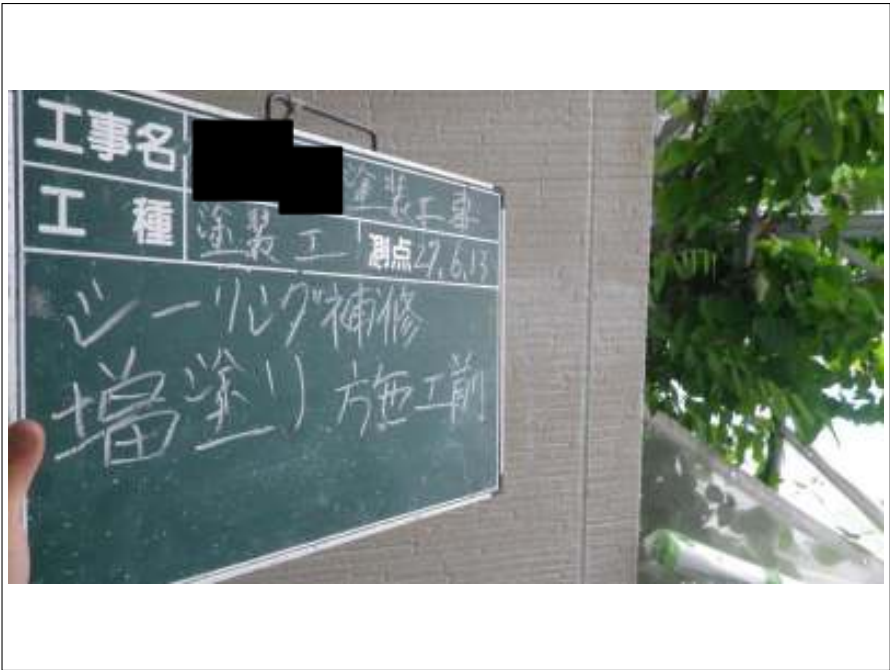
外壁 目地部増し塗り施工前
