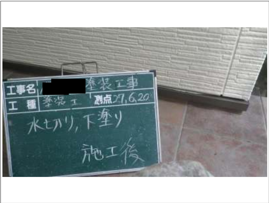
土台水切り 下塗り施工後
