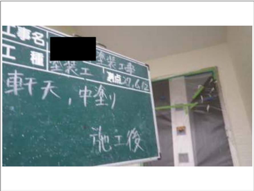
軒天 中塗り施工後
