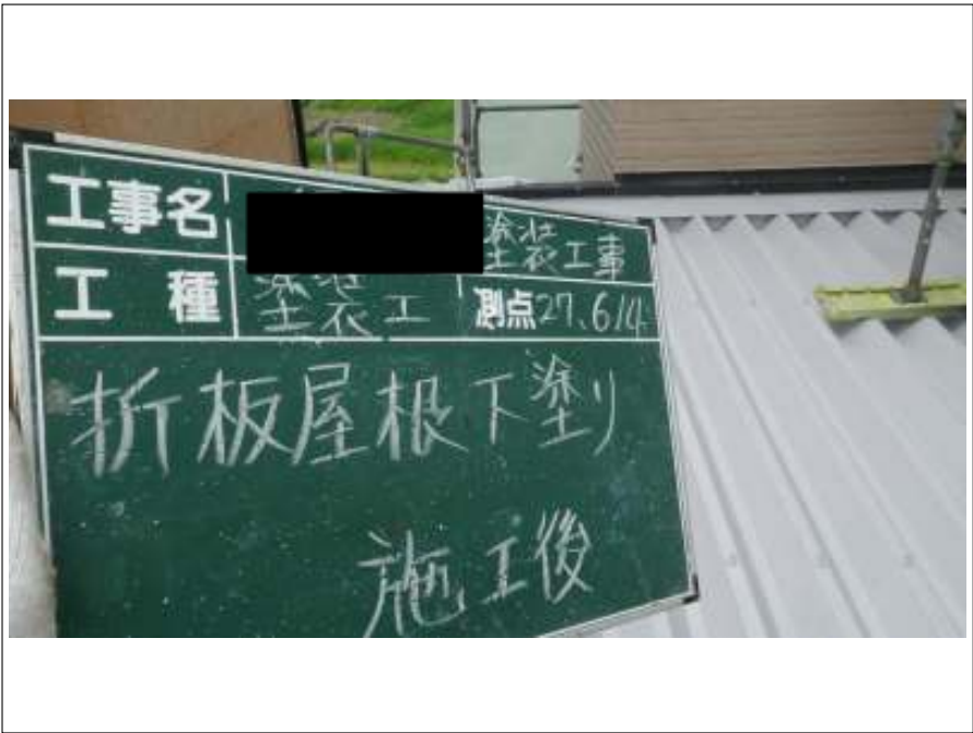
折板屋根 下塗り施工後
