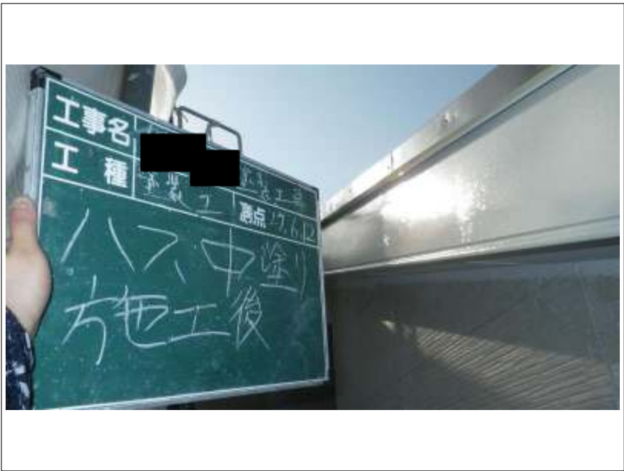
破風板 中塗り施工後
