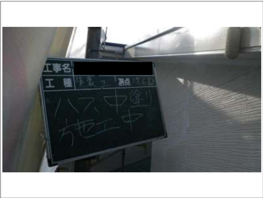
破風板 中塗り施工中
