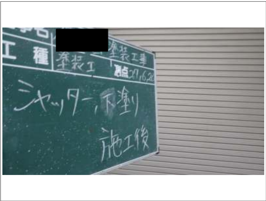
シャッター 下塗り施工後
