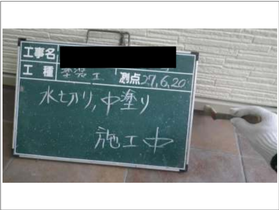
土台水切り 中塗り施工中
