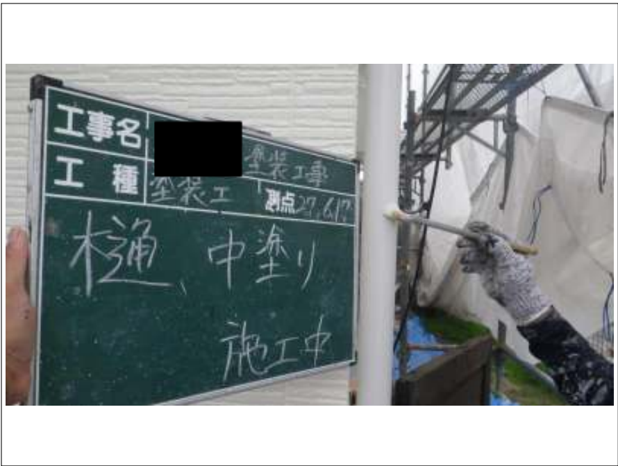
樋 中塗り施工中
