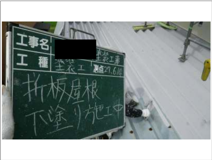
折板屋根 下塗り施工中
