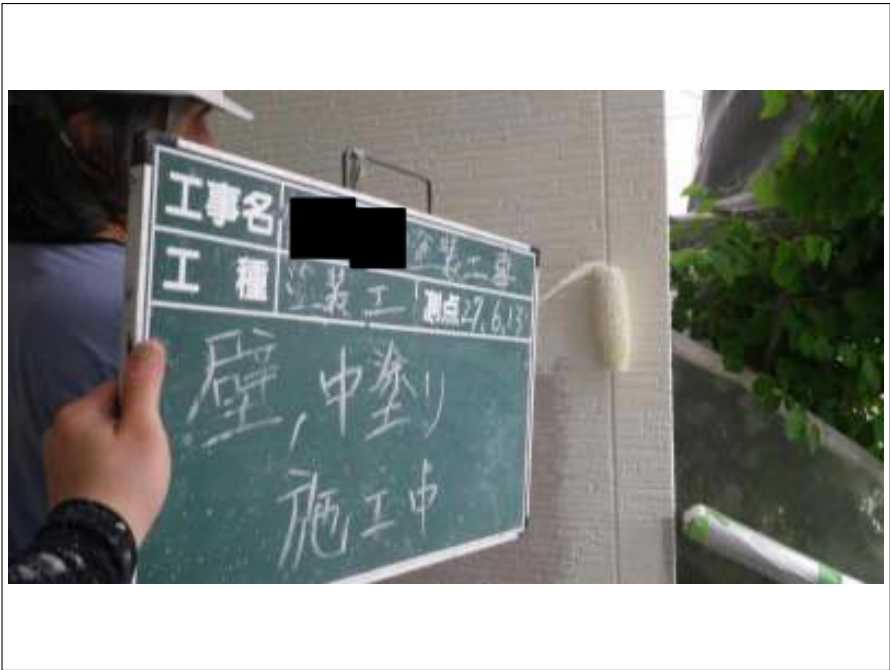
外壁 中塗り施工中
