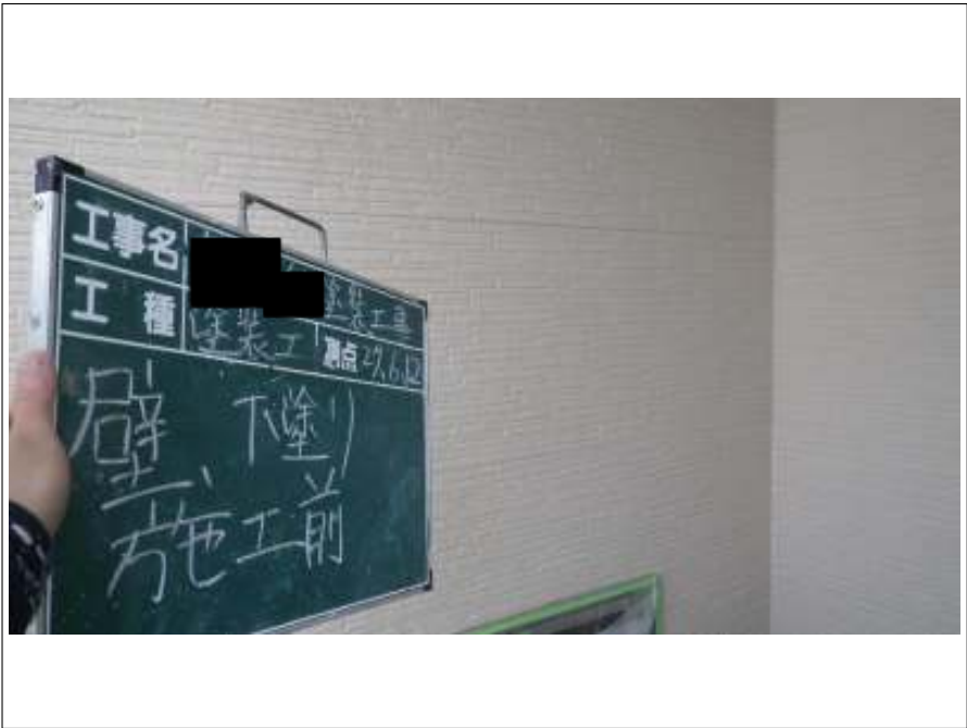
外壁 下塗り施工前
