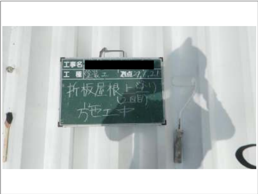
折板屋根 上塗り施工中(2回目)
