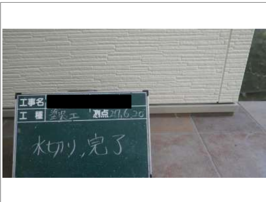
土台水切り 施工完了
