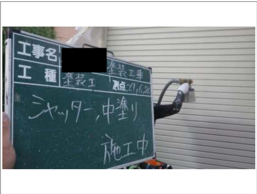
シャッター 中塗り施工中
