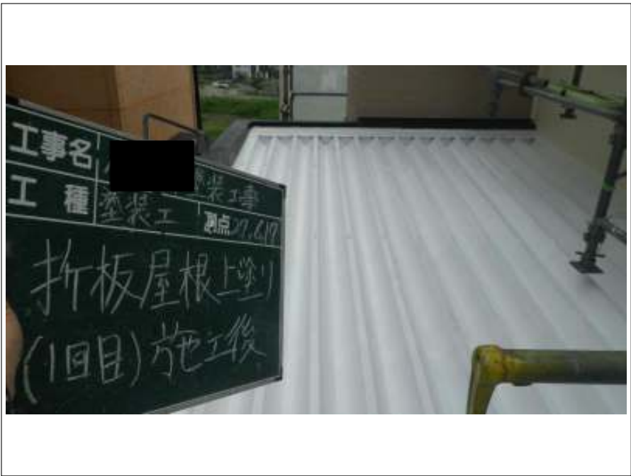
折板屋根 上塗り施工後(1回目)
