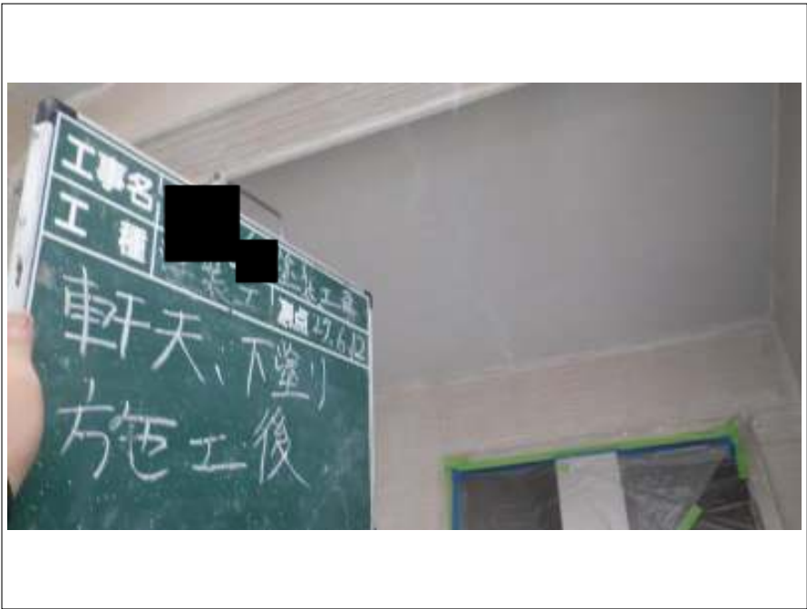
軒天 下塗り施工後
