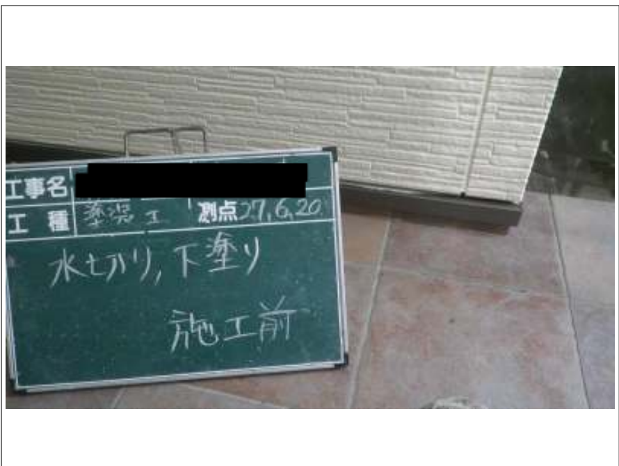
土台水切り 施工前
