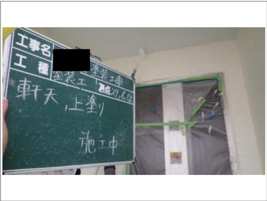
軒天 上塗り施工中
