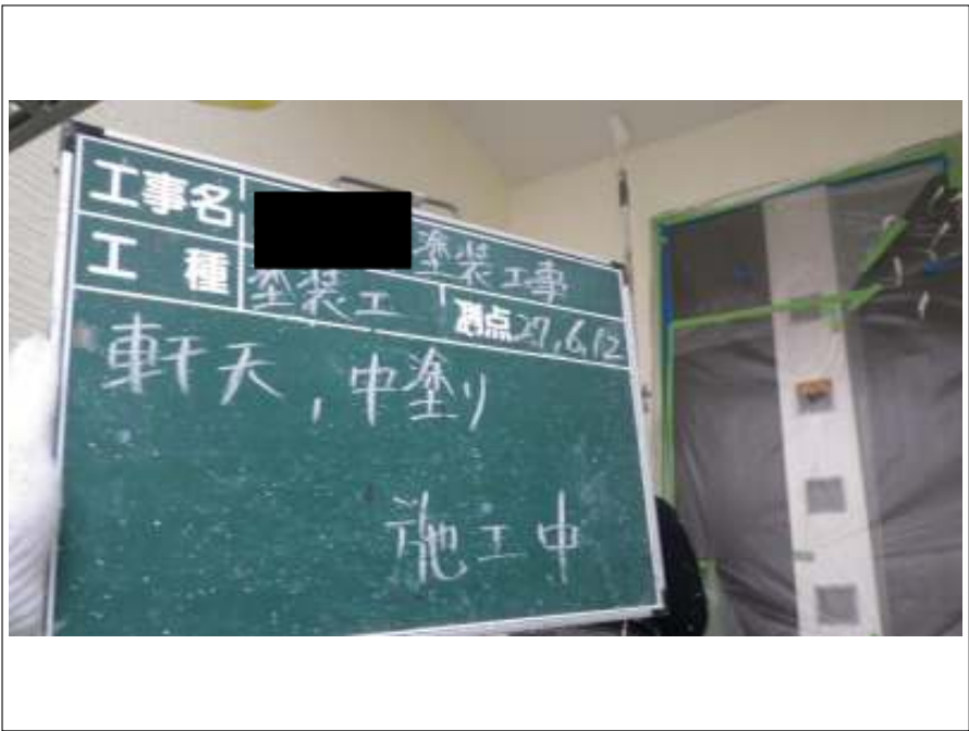
軒天 中塗り施工中
