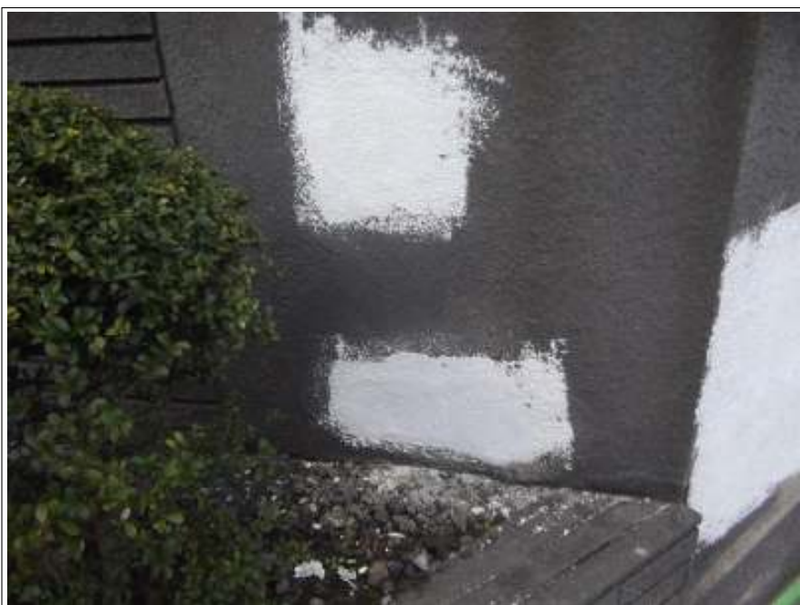
塀補修施工完了
