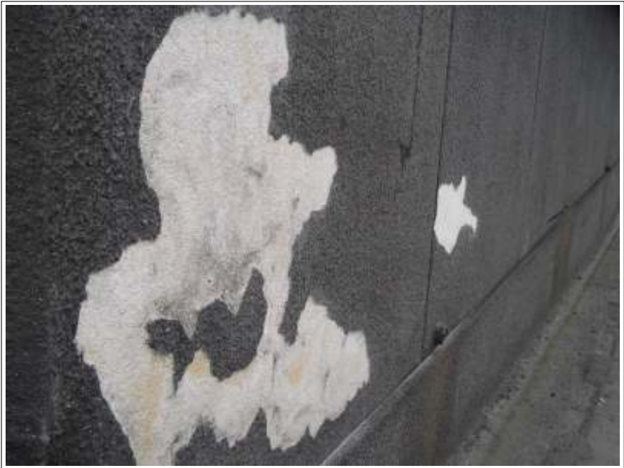
塀補修施工完了
