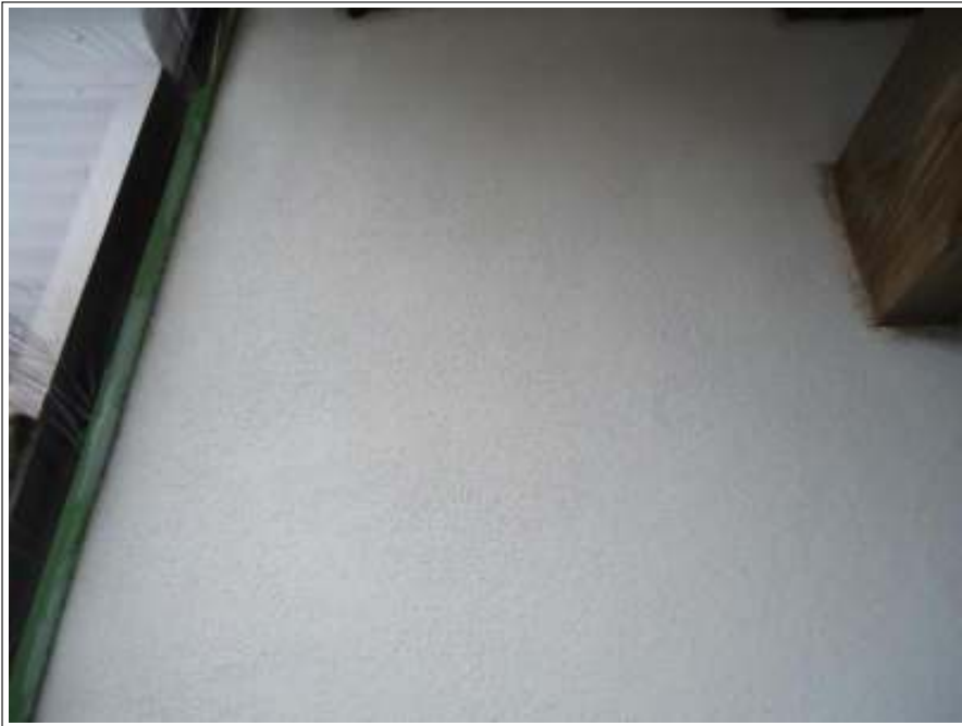
外壁塗装下塗り施工完了
