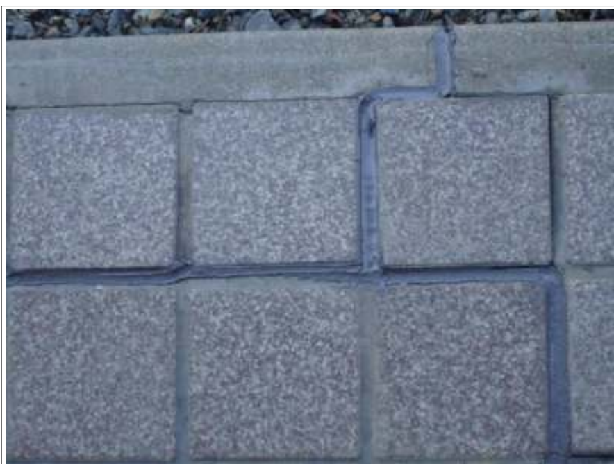
土間補修施工完了
