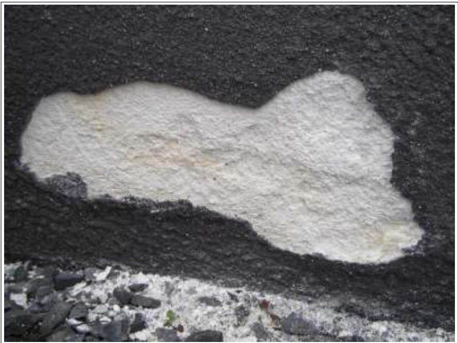
塀補修施工完了
