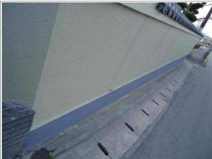
塀塗装施工完了
