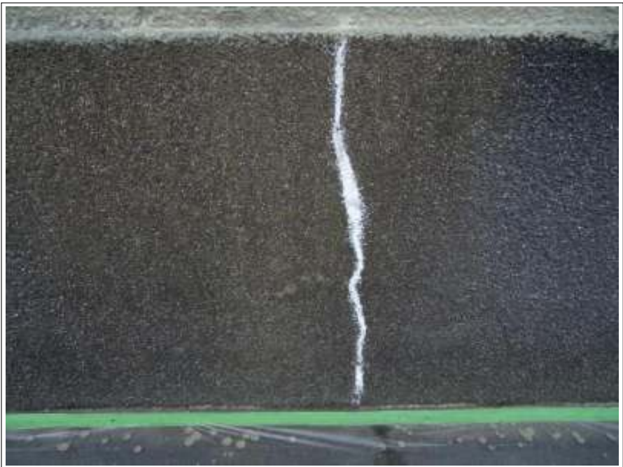
塀クラック補修施工完了
