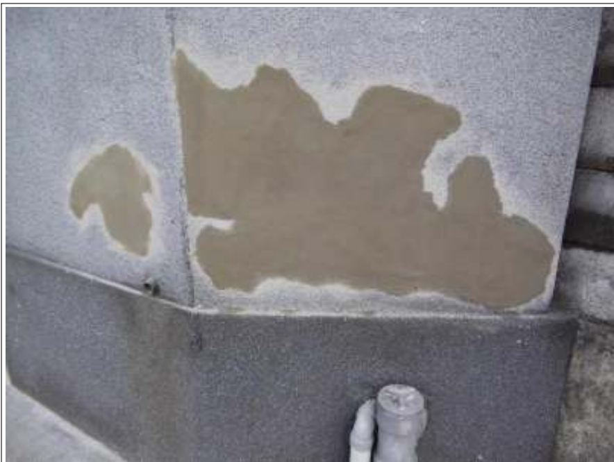
塀補修施工完了
