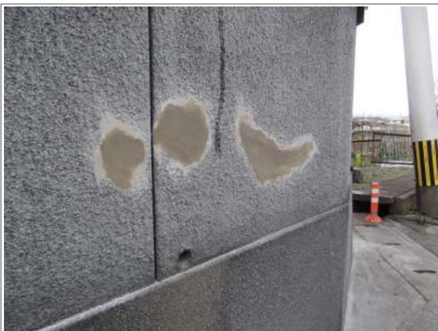
塀補修施工完了
