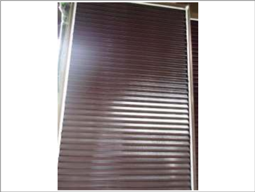
シャッター塗装施工完了
