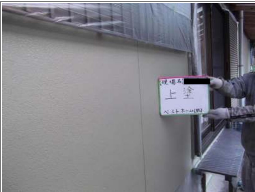
外壁塗装上塗り施工中
