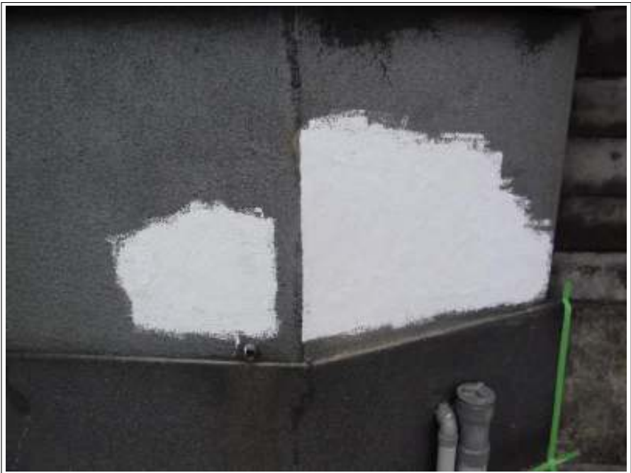
塀補修施工完了
