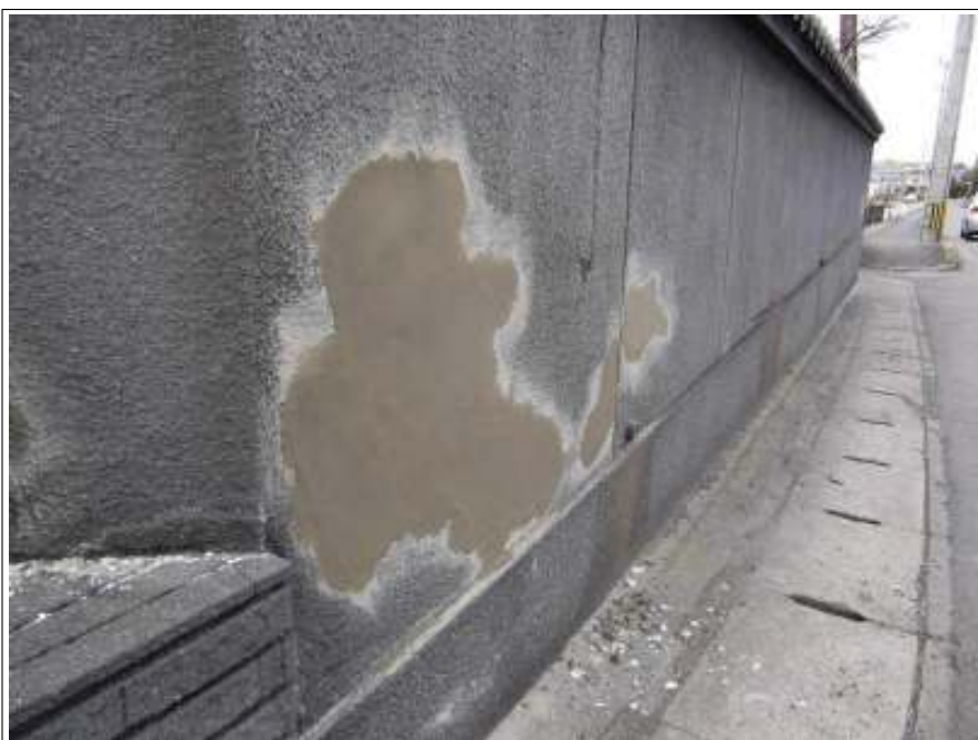
塀補修施工完了
