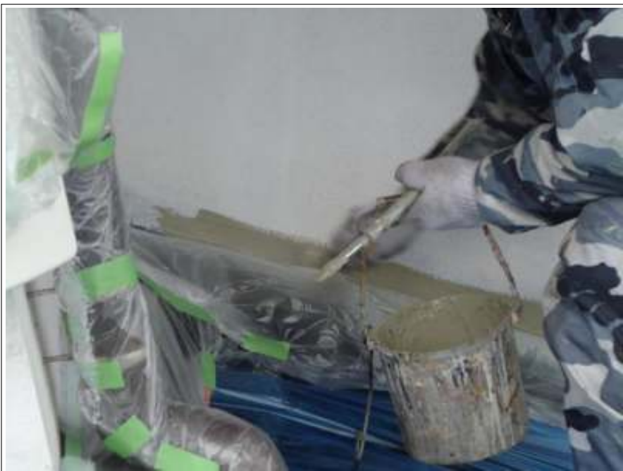
外壁塗装中塗り施工中
