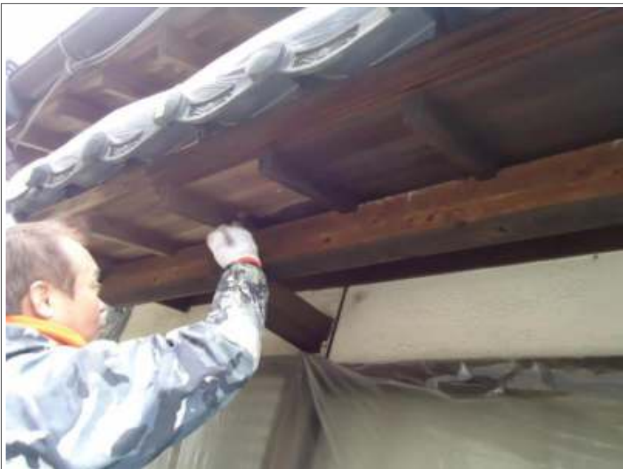
軒天塗装施工中
