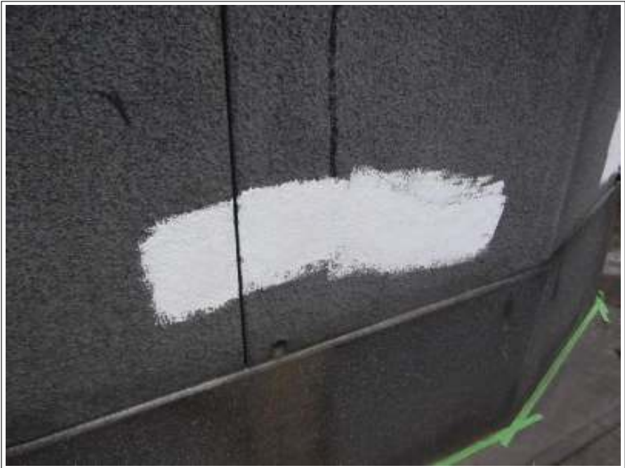
塀補修施工完了
