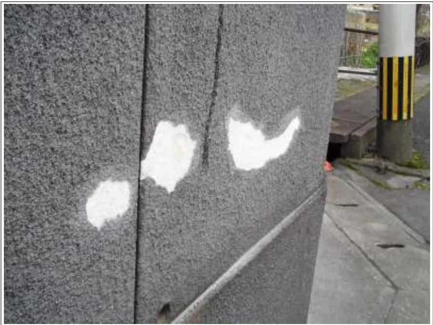
塀補修施工完了
