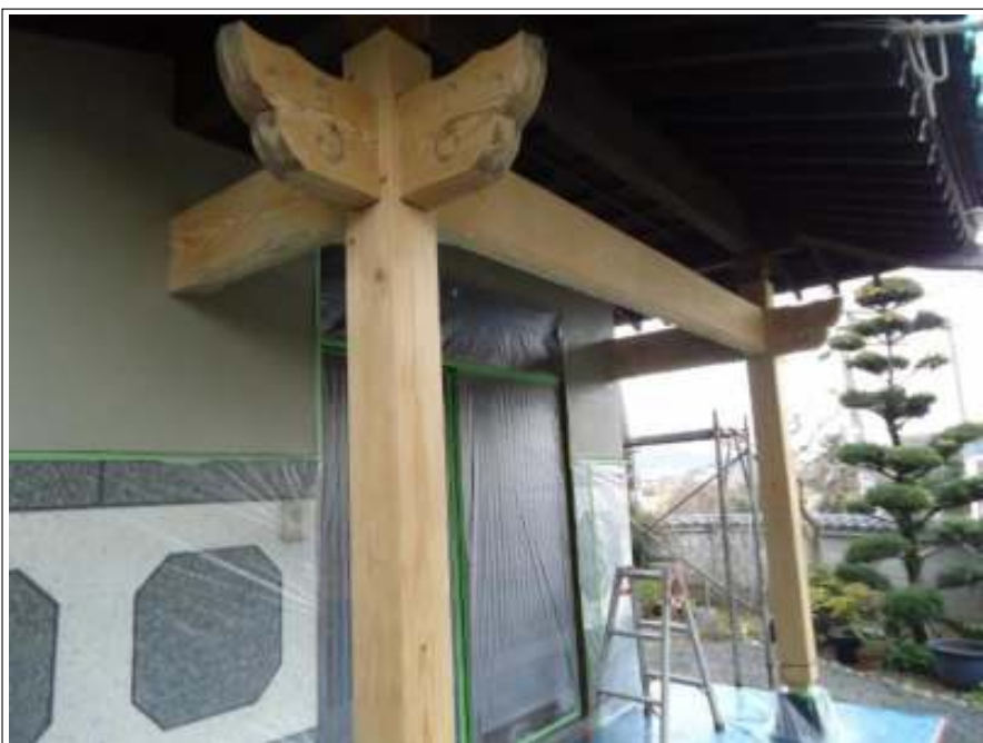
玄関木柱シミ抜き施工完了
