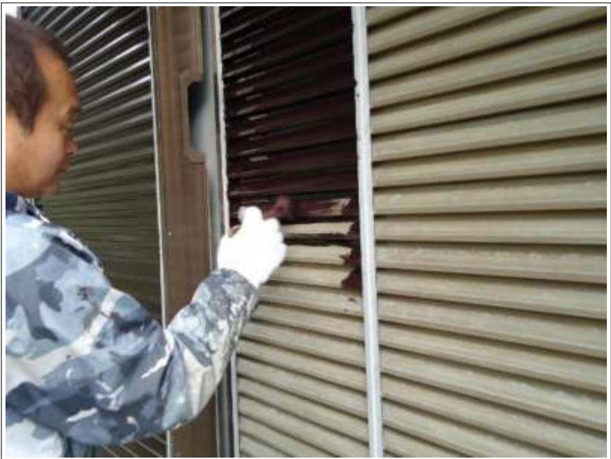
シャッター塗装施工中
