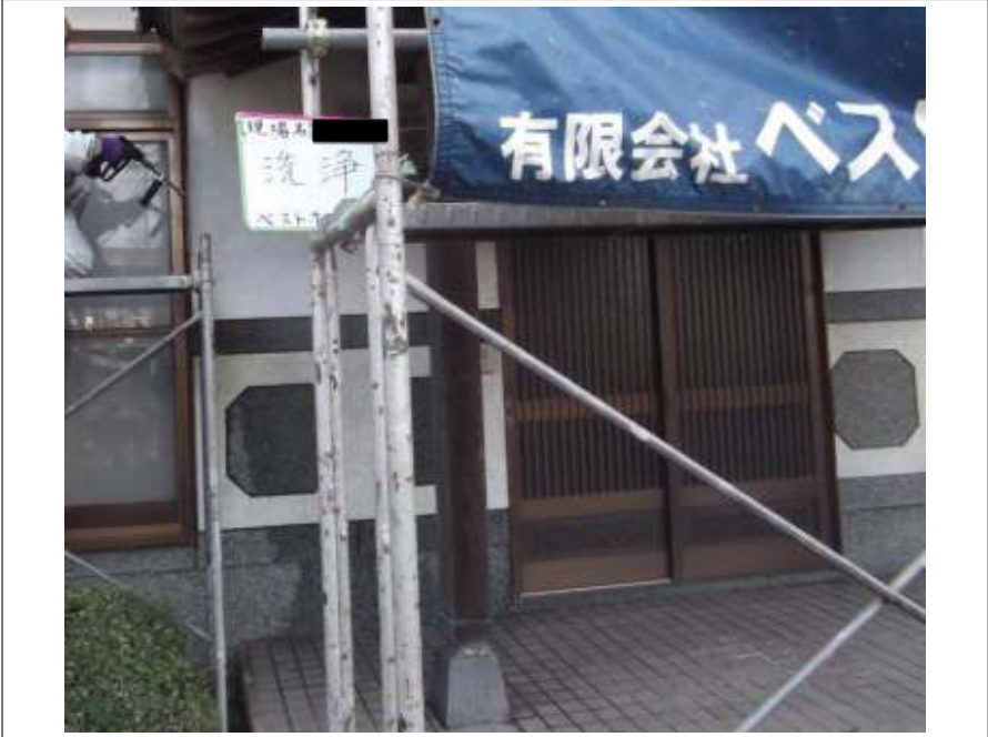
高圧洗淨施工中
