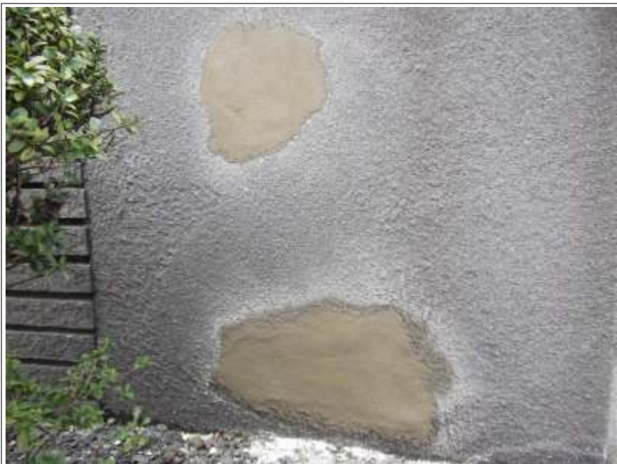
塀補修施工完了
