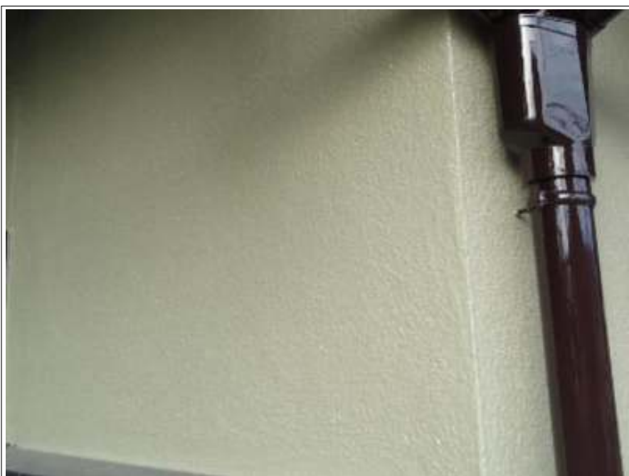
外壁塗装上塗り施工完了
