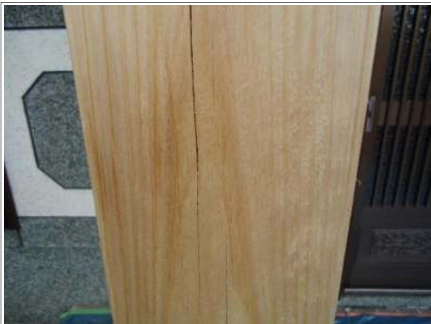
玄関木柱シミ抜き施工完了
