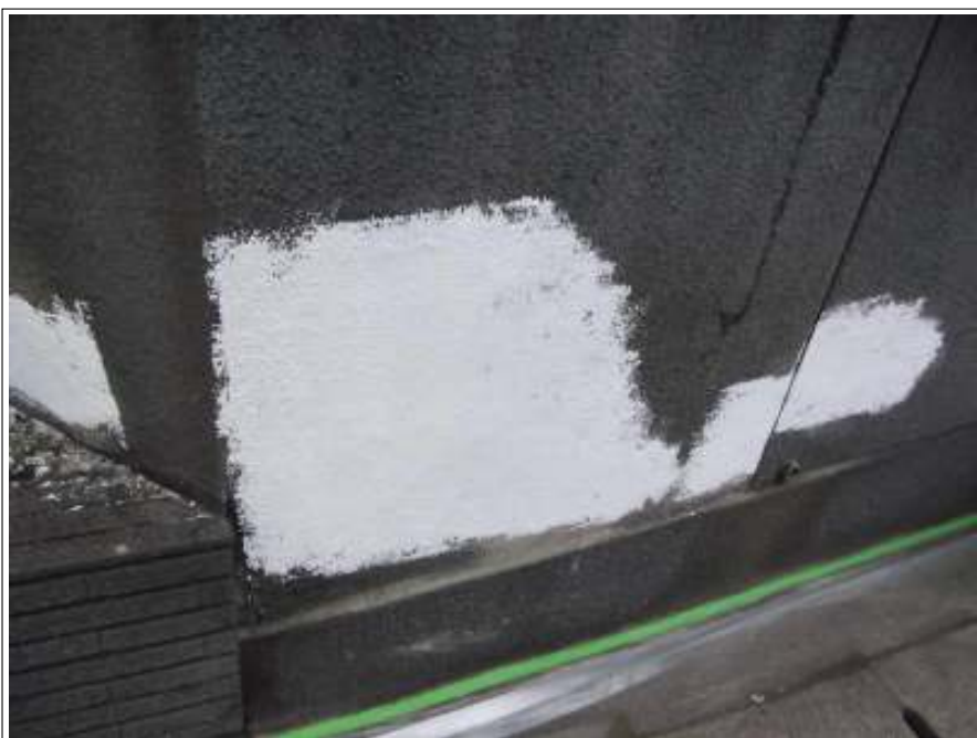
塀補修施工完了
