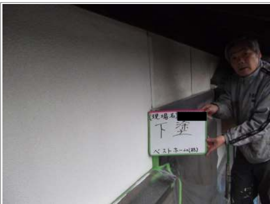
外壁塗装下塗り施工中
