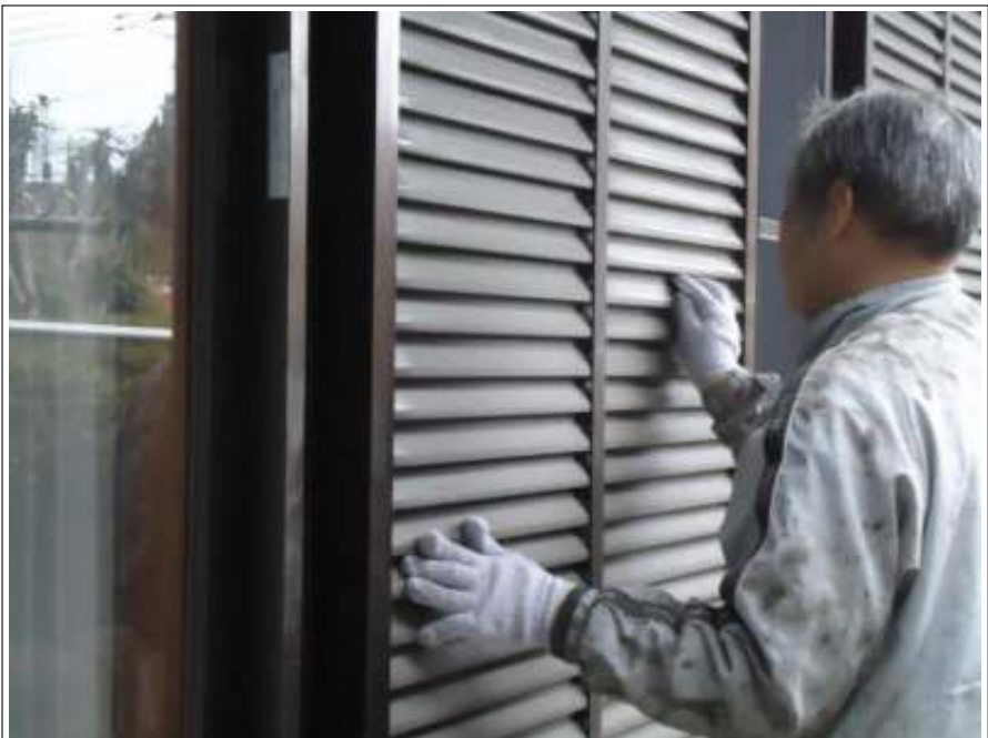
シャッターケレン施工中
