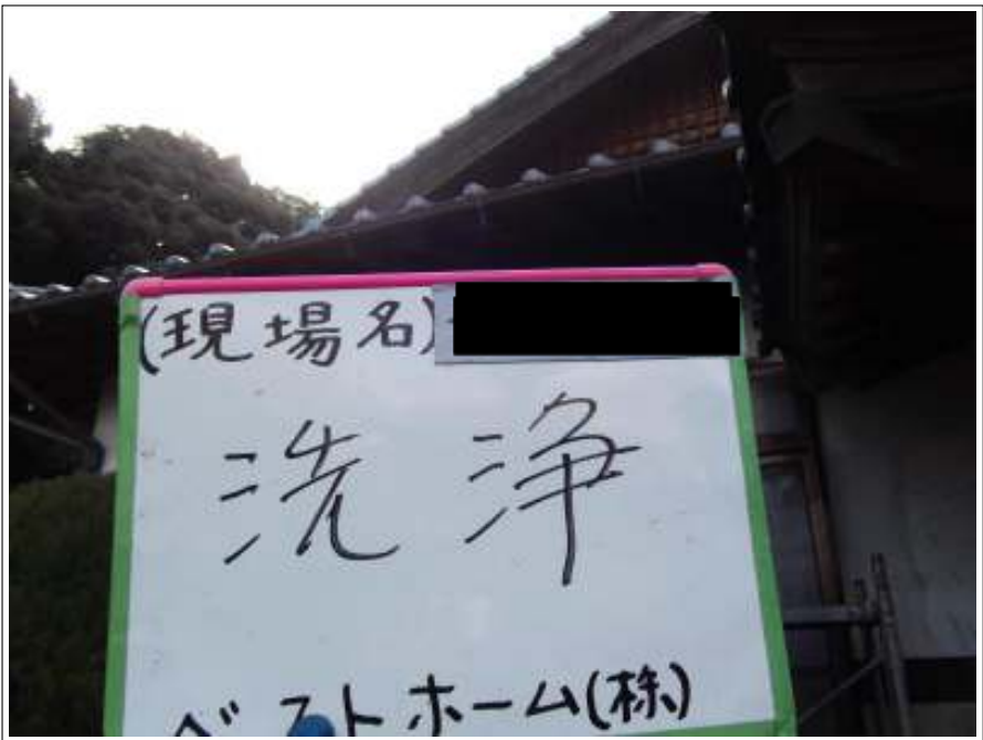
高圧洗淨施工中
