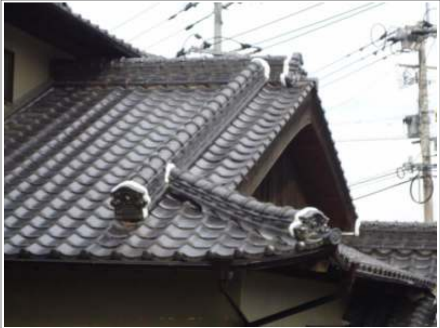
しっくい塗装施工完了
