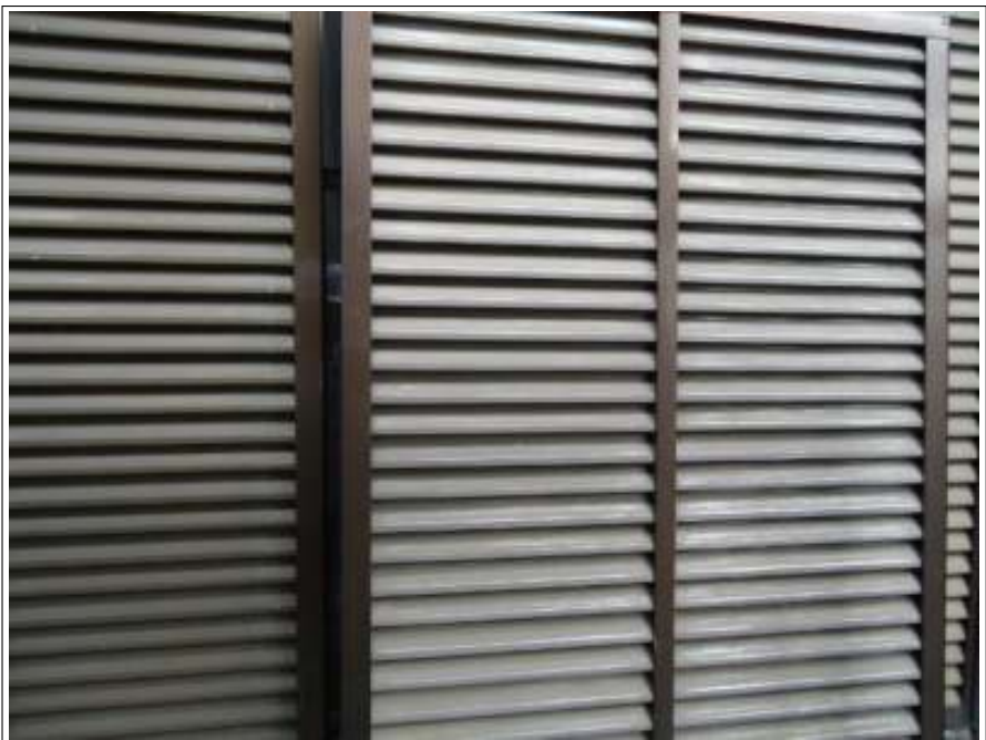
シャッターケレン施工完了
