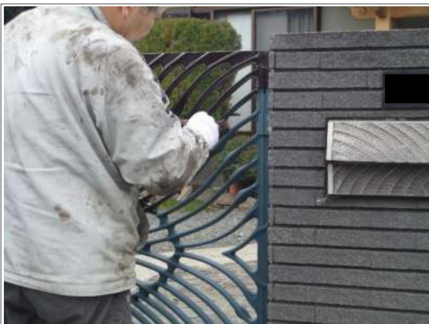
門扉塗装施工中
