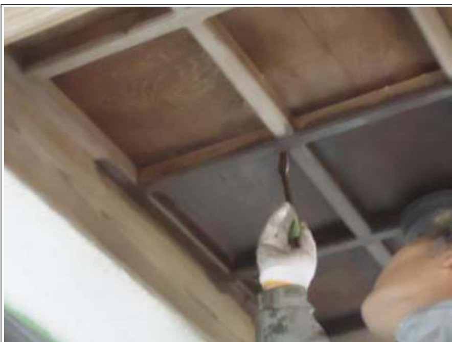
軒天塗装施工中
