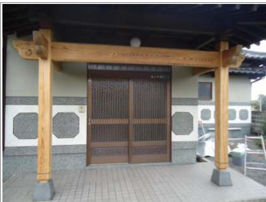
玄関木柱塗装施工完了
