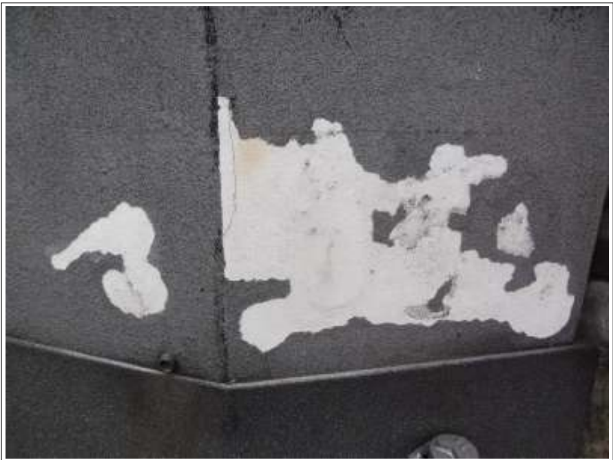
塀補修施工完了
