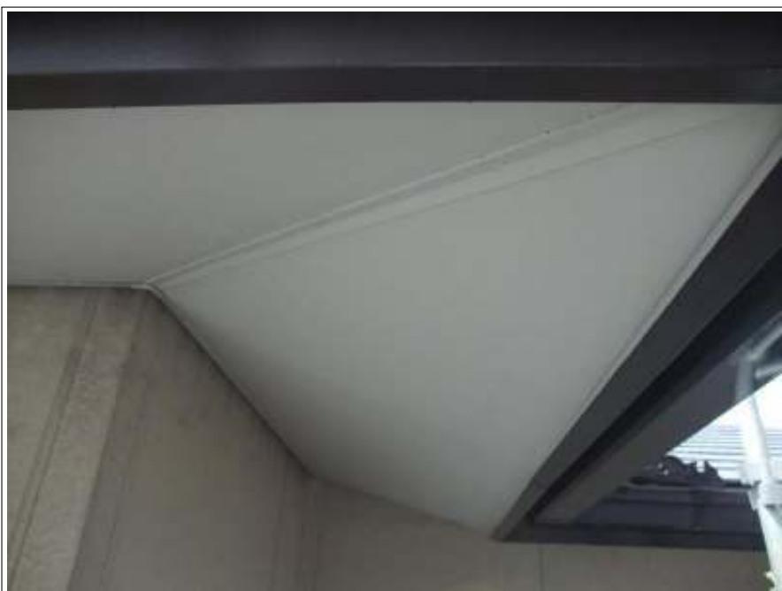
軒天塗装 施工後
