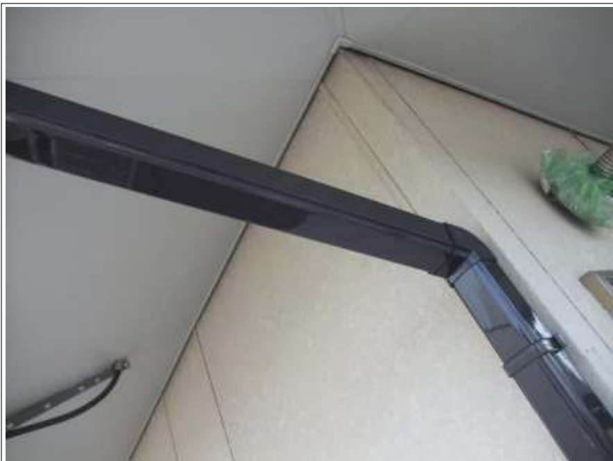
雨樋塗装 施工後
