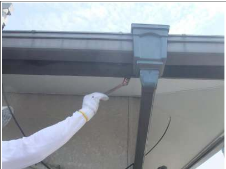
破風板塗装 施工中
