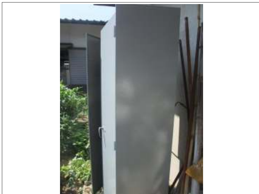
倉庫 施工完了
