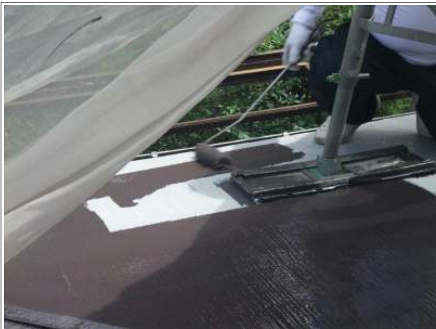
屋根 中塗り施工中
