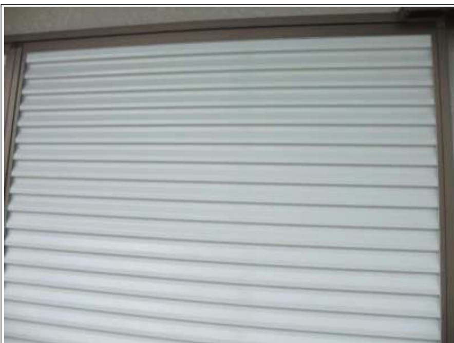
雨戸塗装 施工後
