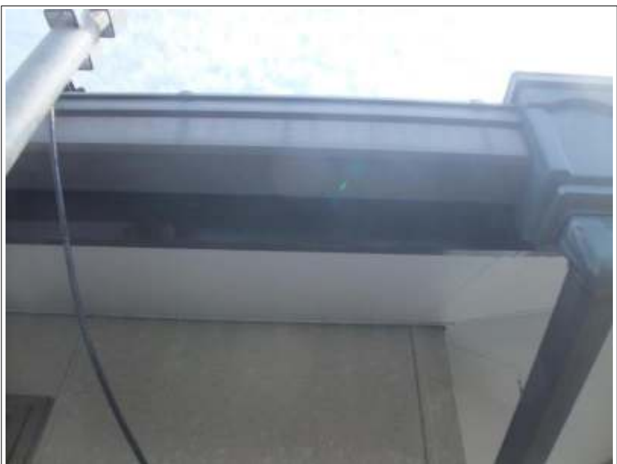
破風板塗装 施工後
