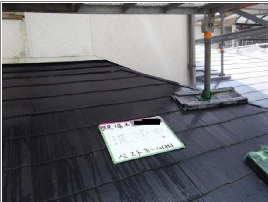
屋根 高圧洗浄中
