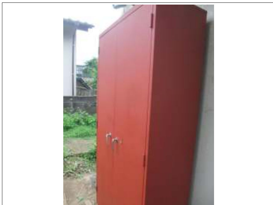
倉庫 サビ止め施工後
