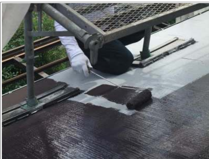
屋根 中塗り施工中
