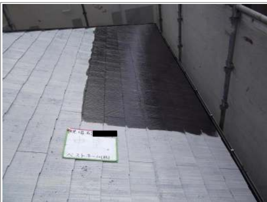
屋根 中塗り施工中
