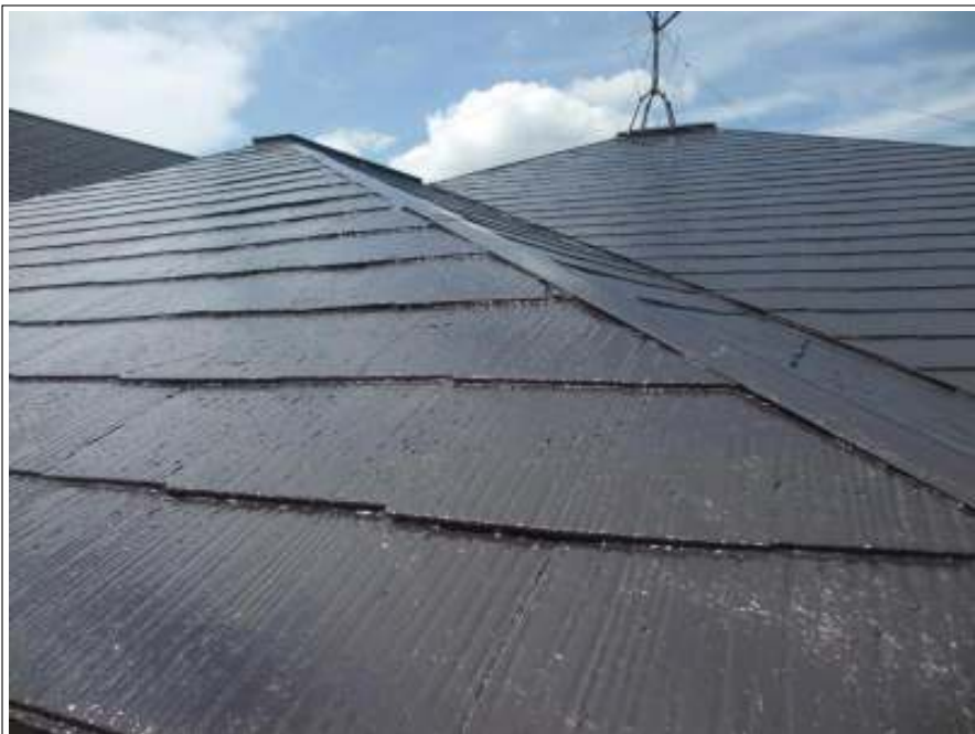
屋根 上塗り施工後
