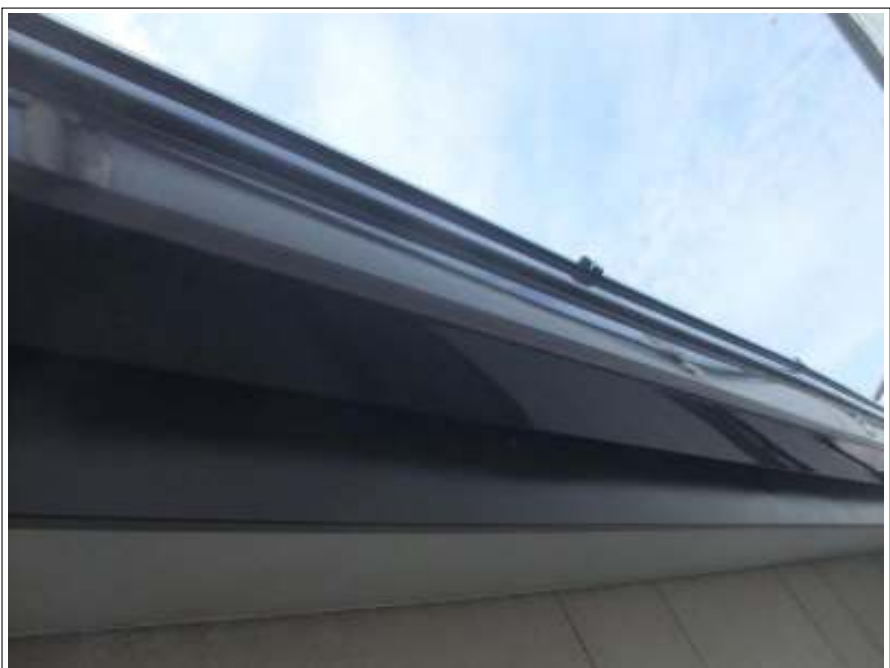
雨樋塗装 施工後
