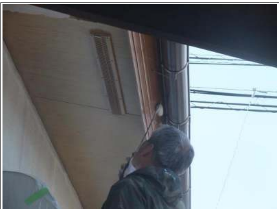
破風板塗装施工中
