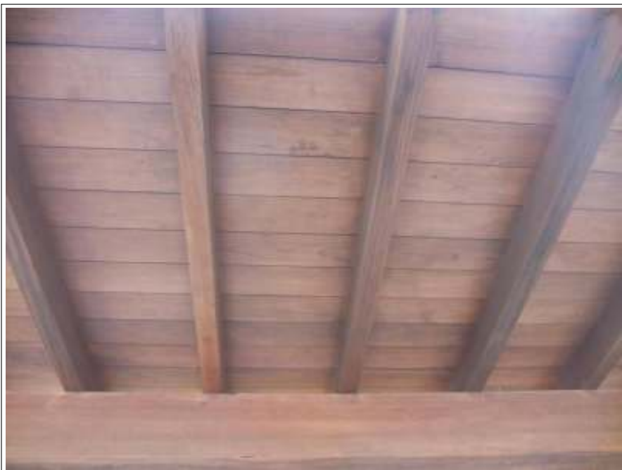
木部塗装施工完了
