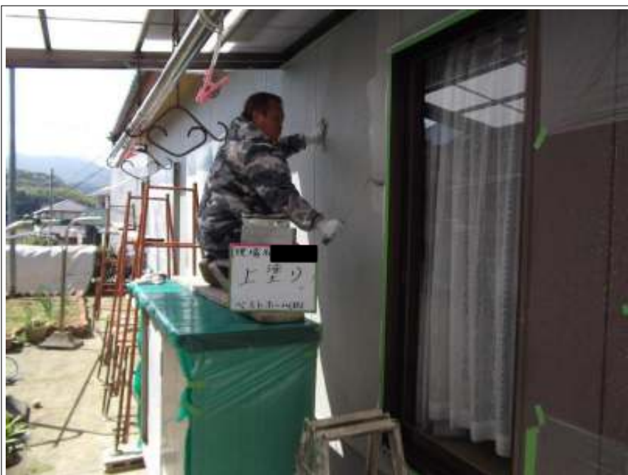
外壁上塗り施工中
