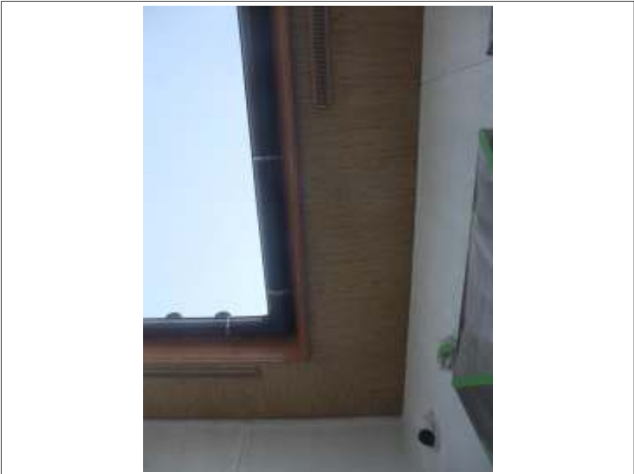
軒天塗装施工完了
