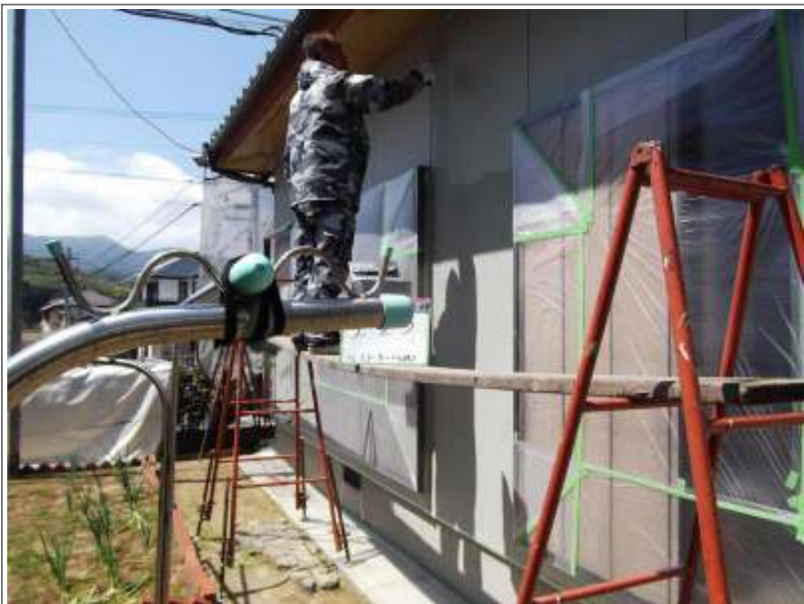
外壁上塗り施工中
