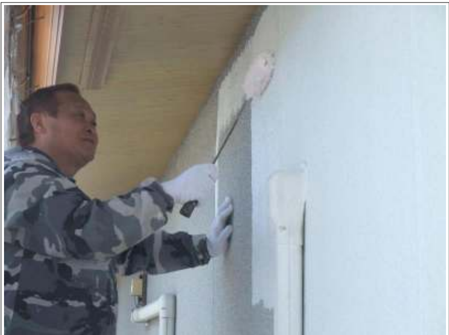
外壁下塗り施工中
