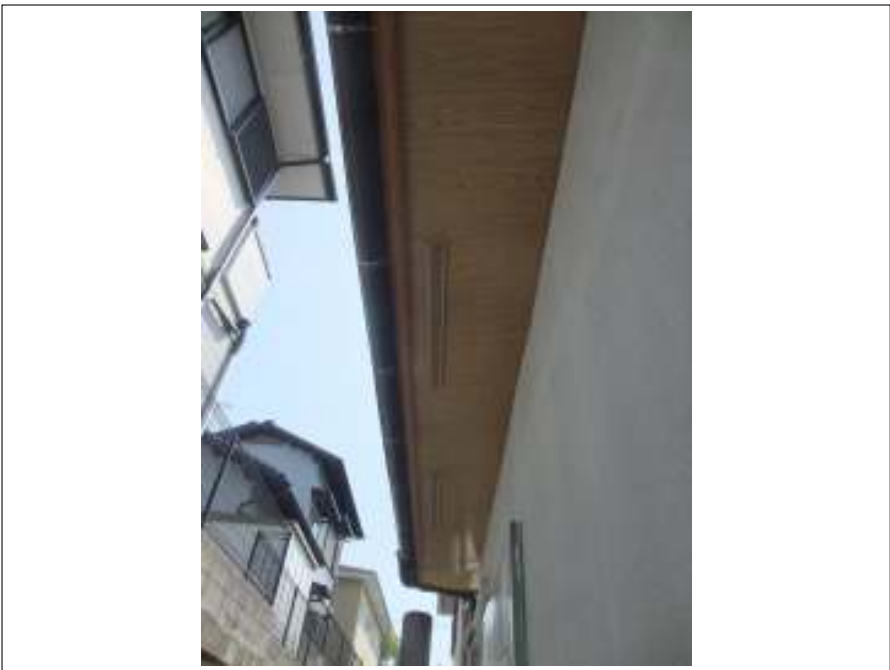
軒天塗装施工完了
