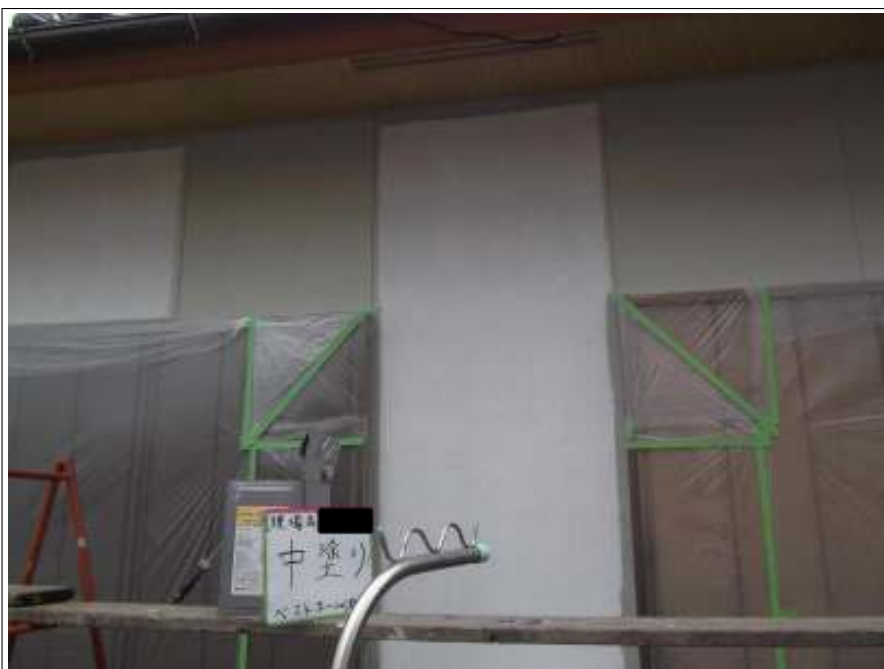
外壁中塗り施工中
