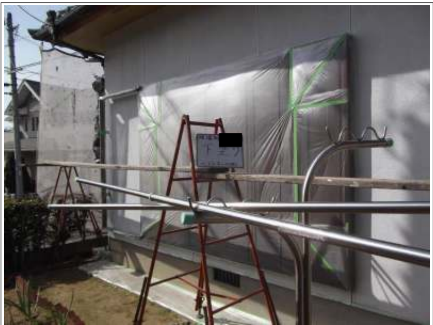
外壁下塗り施工完了
