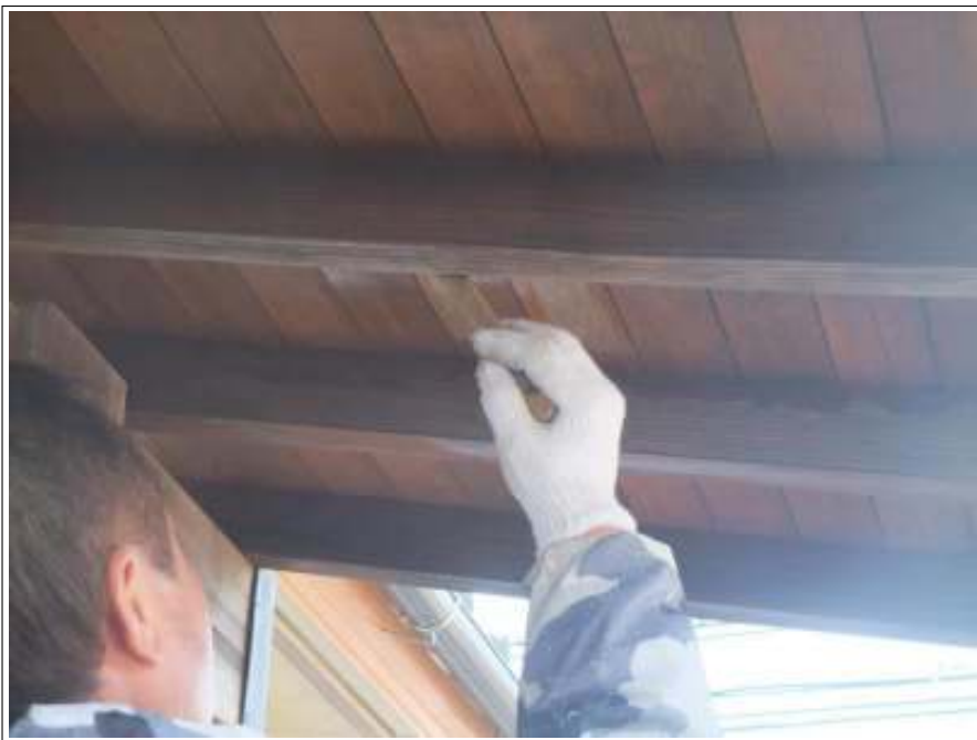
木部塗装施工中
