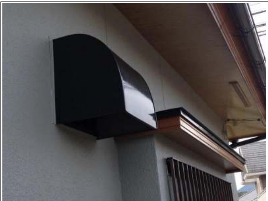
換気フード塗装施工完了
