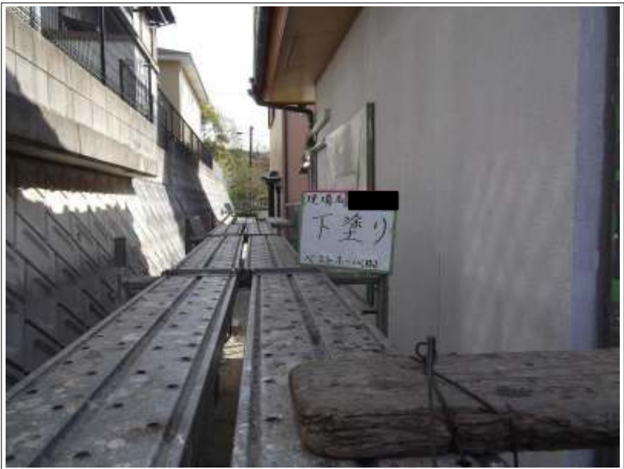
外壁下塗り施工完了
