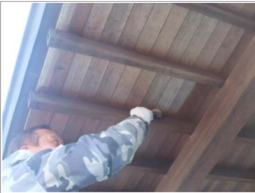
木部塗装施工中
