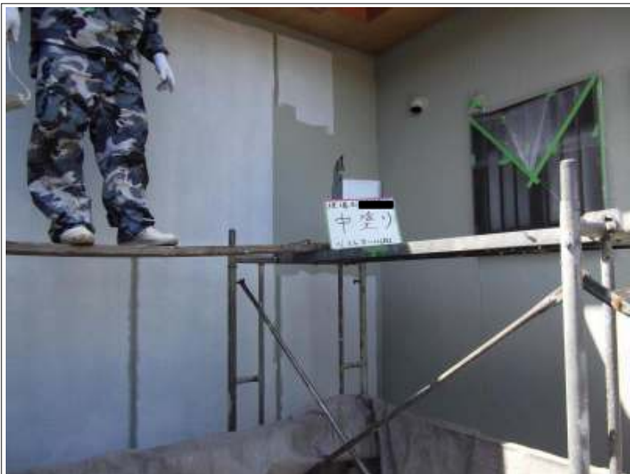
外壁中塗り施工中
