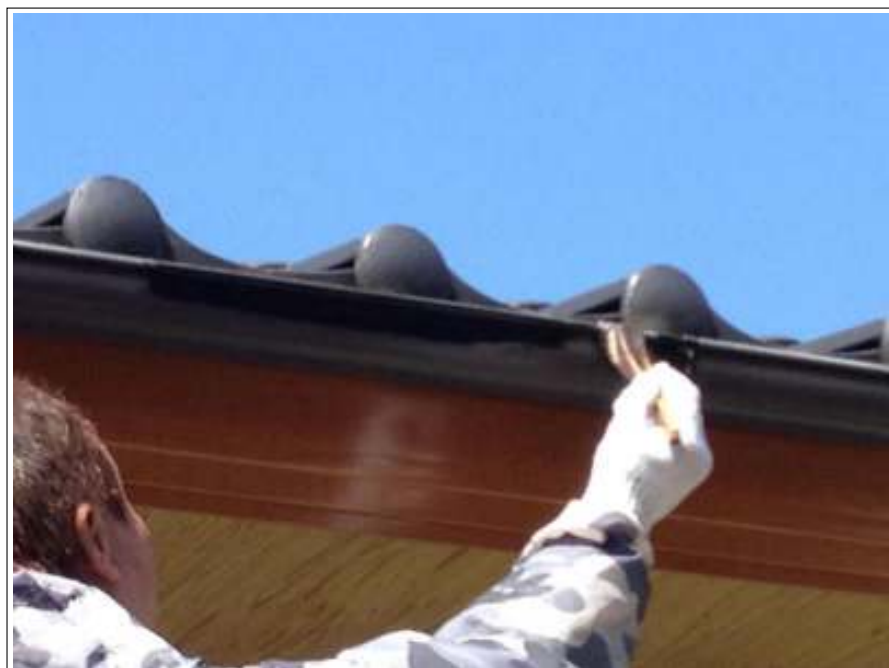
雨樋塗装施工中
