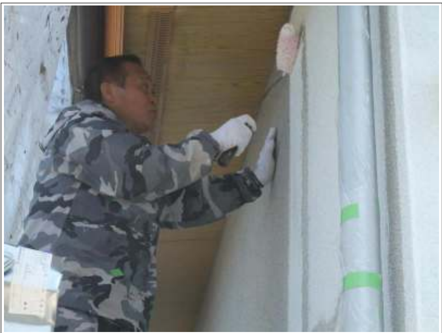
外壁下塗り施工中
