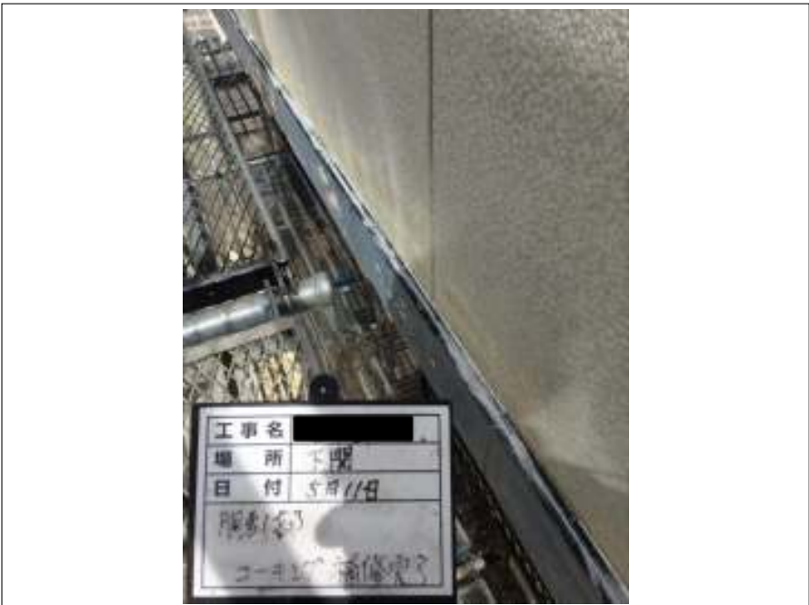
洞差し コーキング補修施工完了
