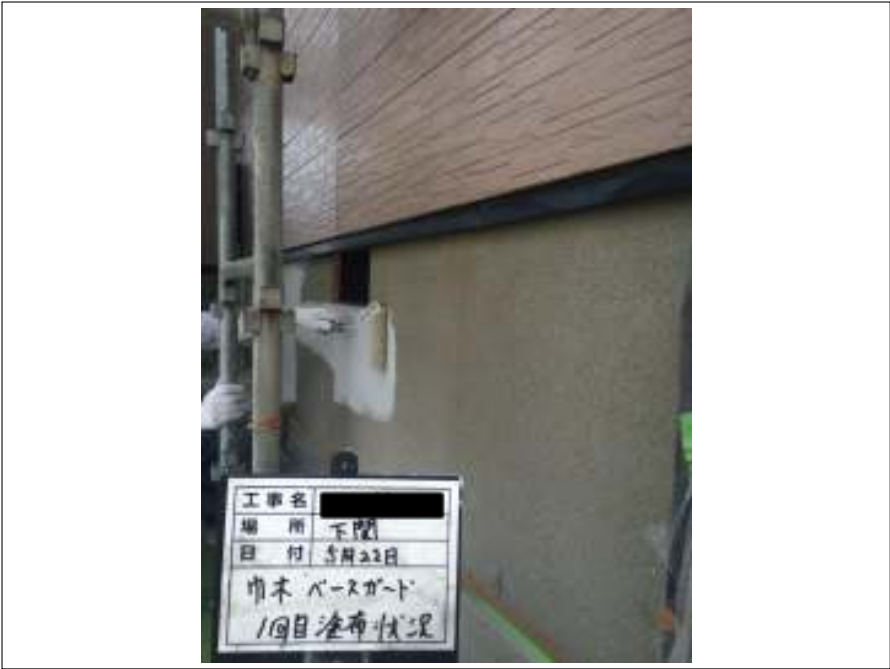
基礎 上塗り（1回目）施工中
