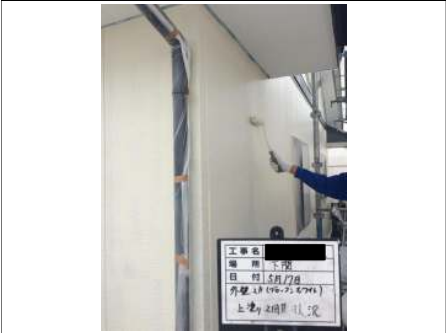
外壁 上塗り施工中
