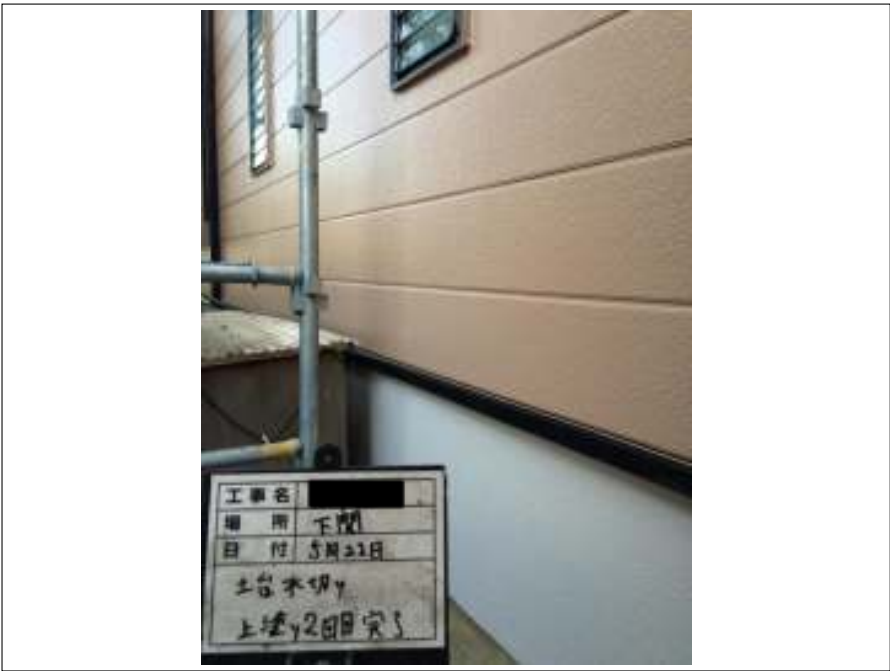
土台水切り 上塗り（2回目）施工完了
