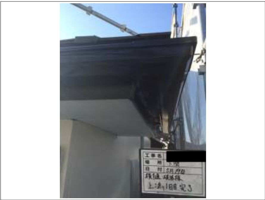
横樋・破風 上塗り（1回目）施工完了
