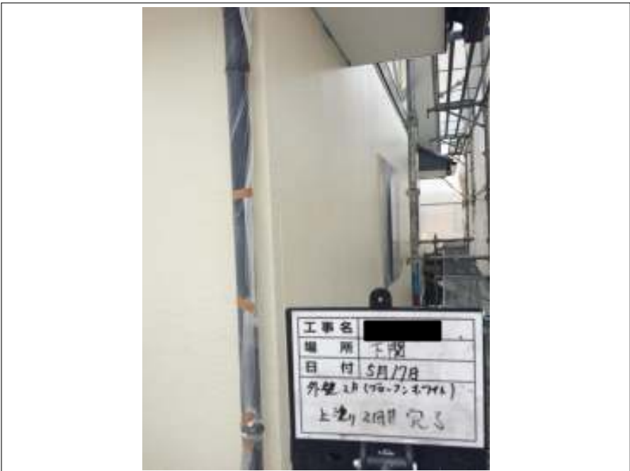
外壁 上塗り施工完了
