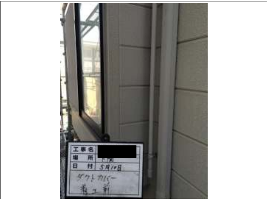
ダクトカバー 施工前
