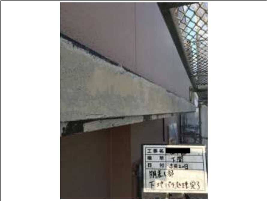
胴差し 下地パテ処理施工完了
