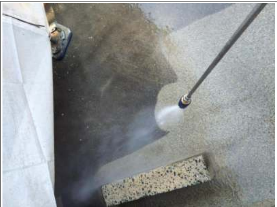
土間高圧洗浄中
