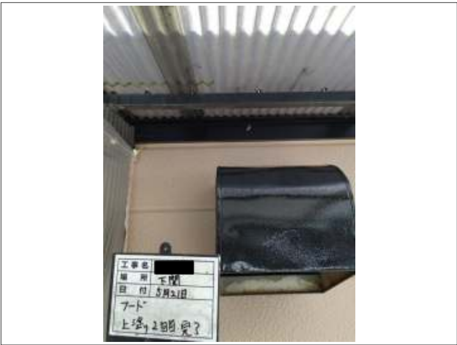
換気フード 上塗り（2回目）施工完了
