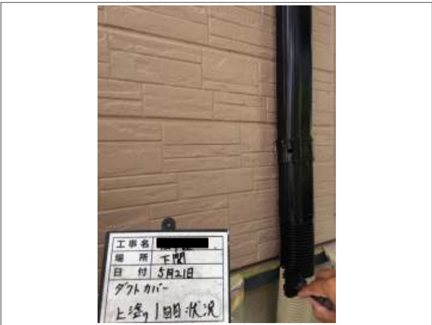
ダクトカバー 上塗り（1回目）施工中
