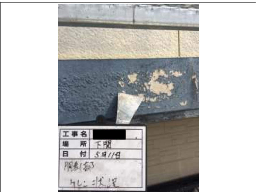
洞差し ケレン施工中
