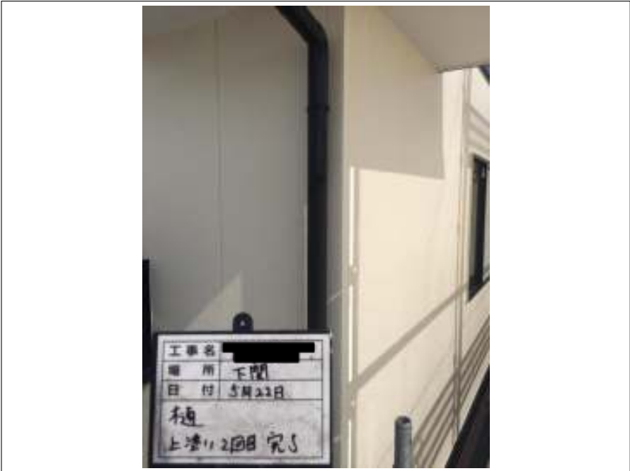
樋 上塗り（2回目）施工完了
