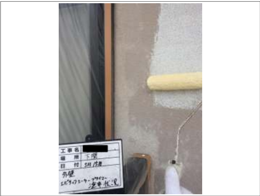
外壁 下塗り施工中
