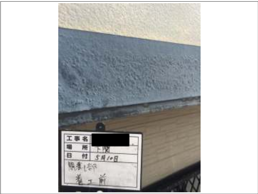
洞差し 施工前
