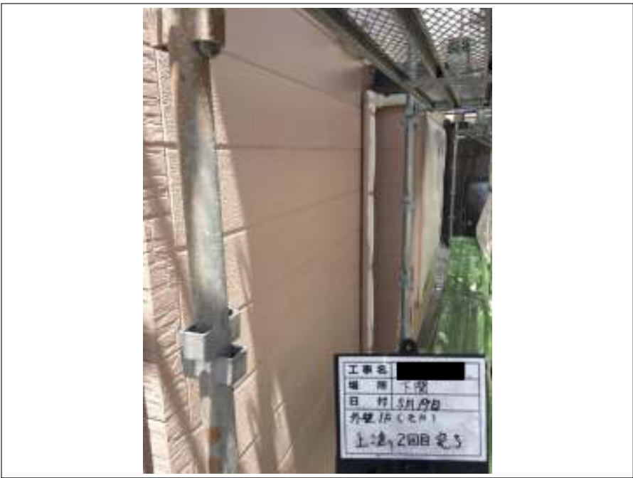
外壁 上塗り施工完了
