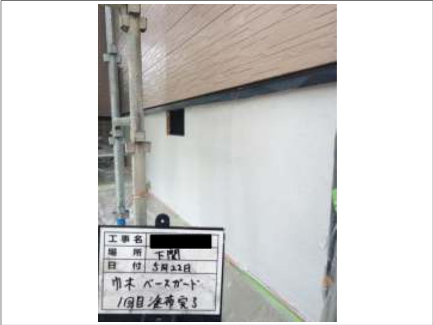
基礎 上塗り（1回目）施工完了
