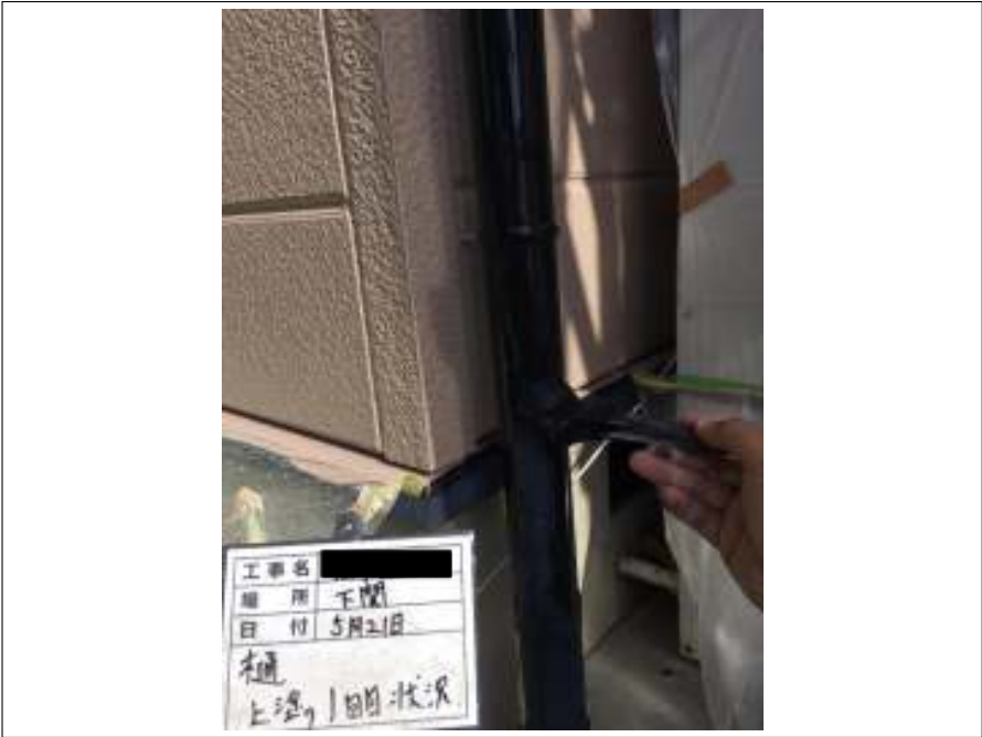
樋 上塗り（1回目）施工中
