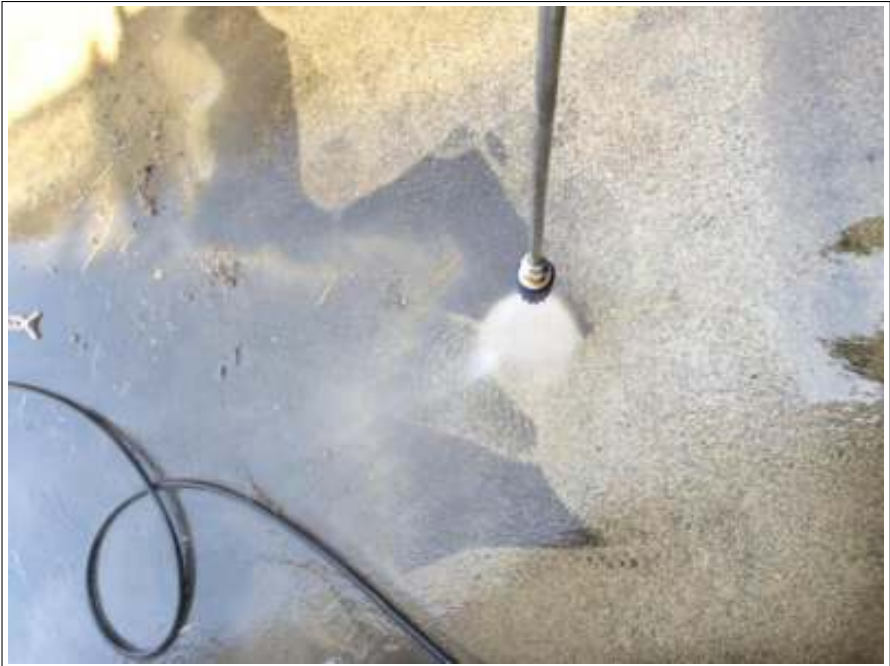
土間高圧洗浄中
