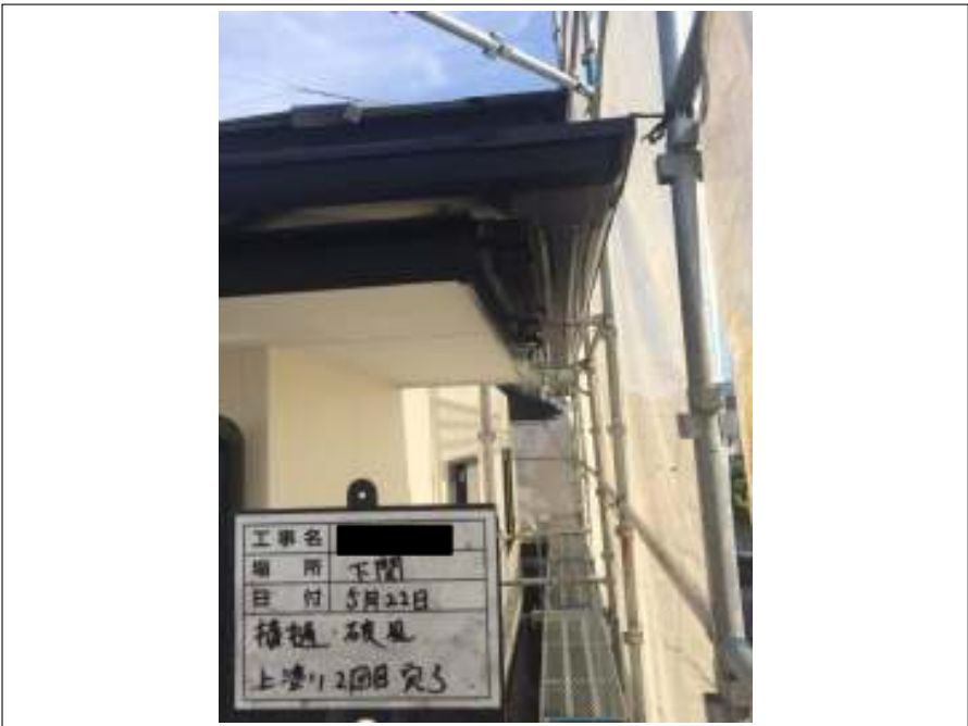
横樋・破風 上塗り（2回目）施工完了
