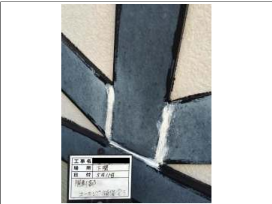
洞差し コーキング補修施工完了
