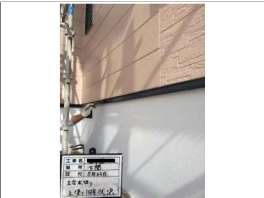
土台水切り 上塗り（1回目）施工中
