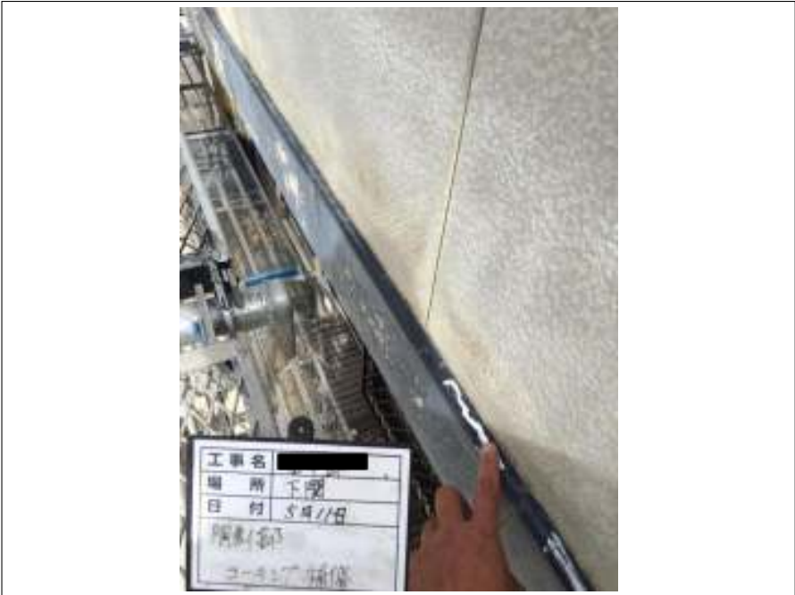
洞差し コーキング補修施工前
