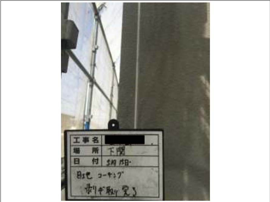
外壁 コーキング打替え撤去中
