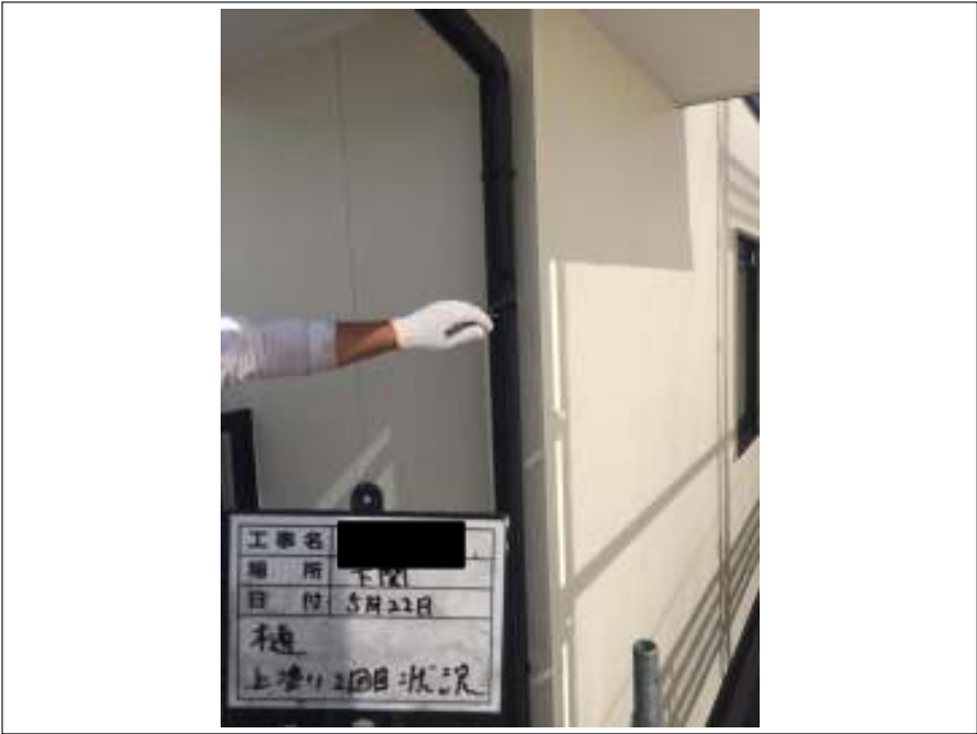
樋 上塗り（2回目）施工中
