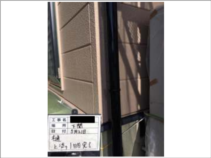
樋 上塗り（1回目）施工完了
