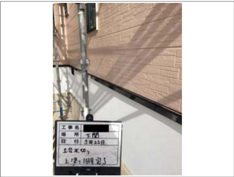
土台水切り 上塗り（1回目）施工完了
