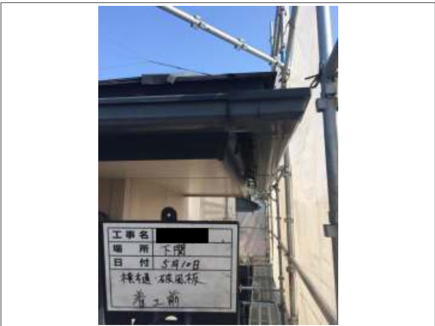
横樋・破風 施工前
