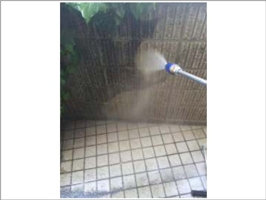
外壁高圧洗浄中
