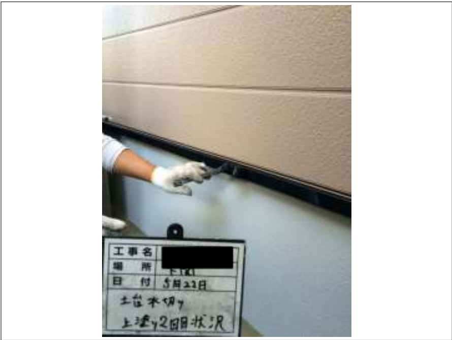
土台水切り 上塗り（2回目）施工中
