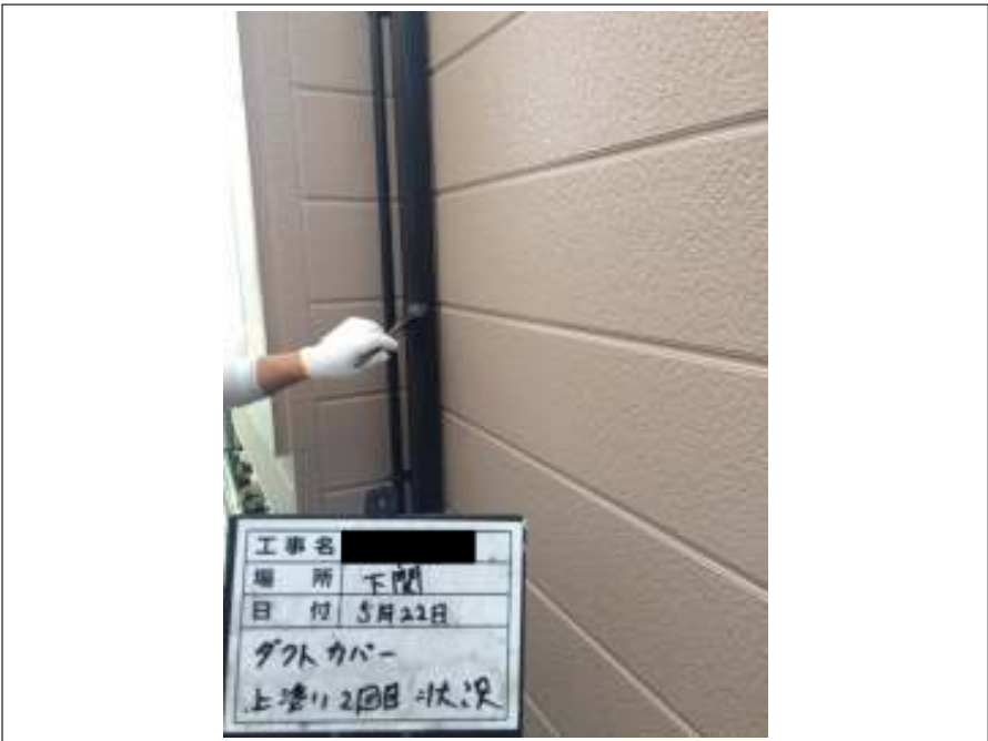
ダクトカバー 上塗り（2回目）施工中
