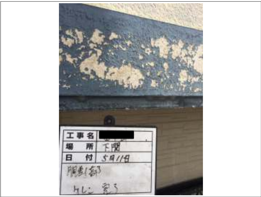
胴差し ケレン施工完了
