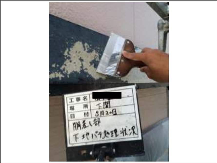
胴差し 下地パテ処理施工中
