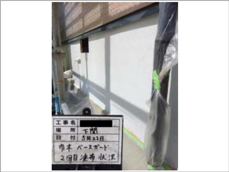
基礎 上塗り（2回目）施工中
