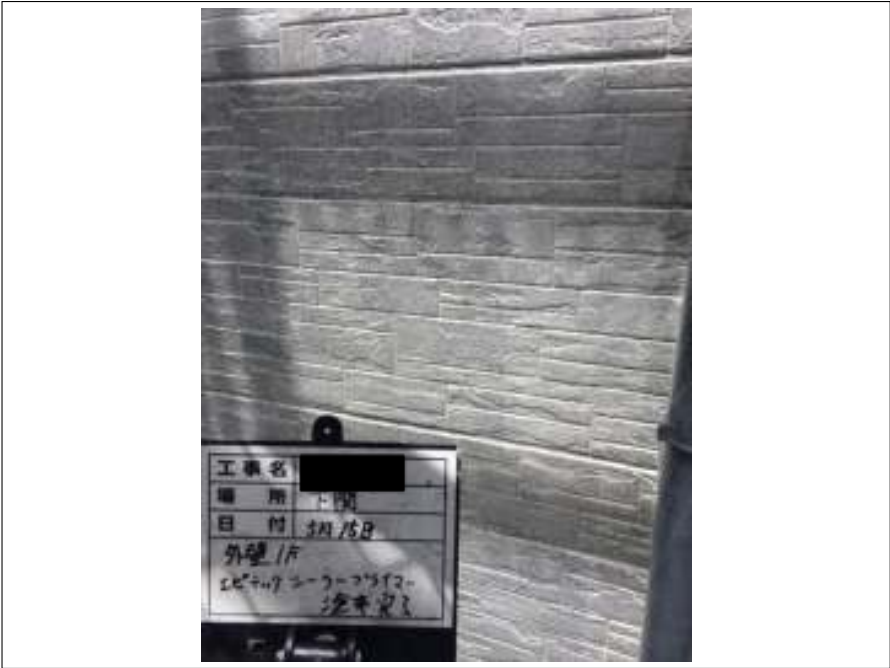
外壁 下塗り施工完了
