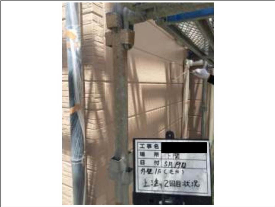
外壁 上塗り施工中
