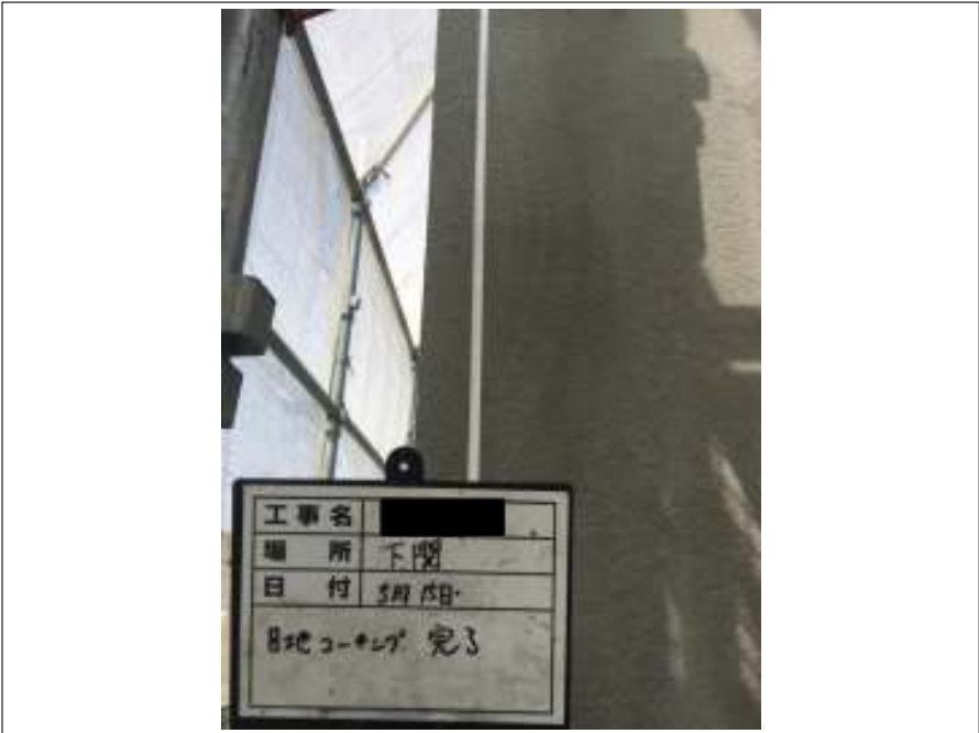
外壁 コーキング打替え施工完了
