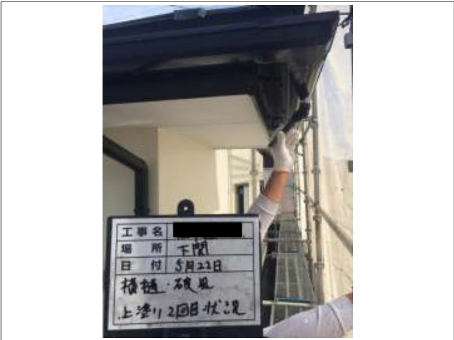
横樋・破風 上塗り（2回目）施工中
