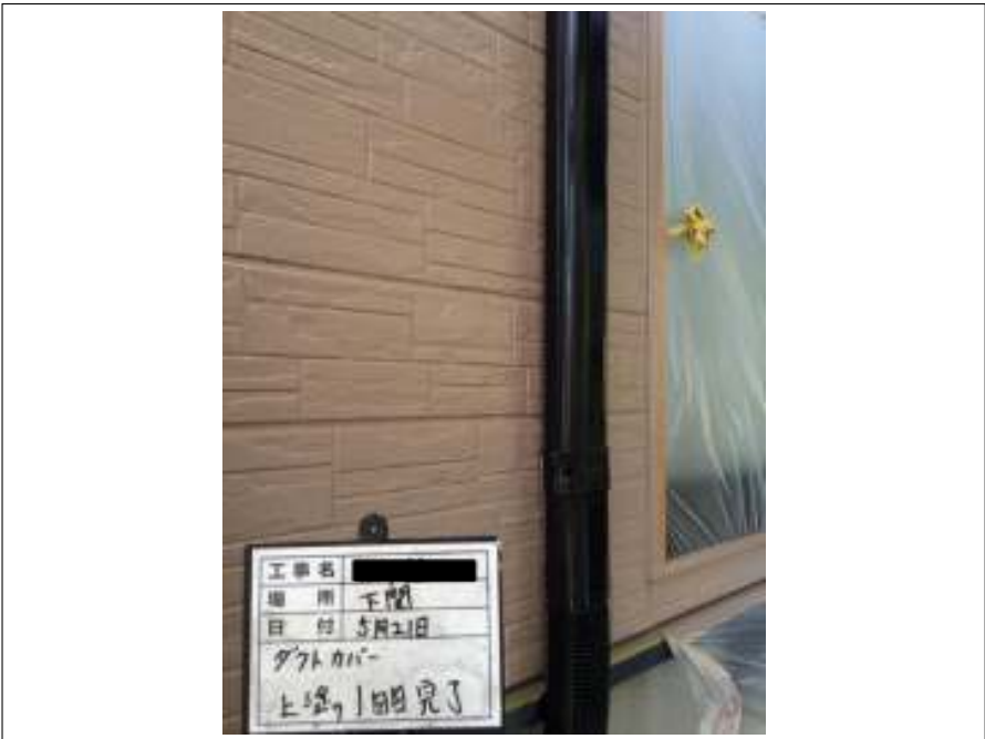
ダクトカバー 上塗り（1回目）施工完了
