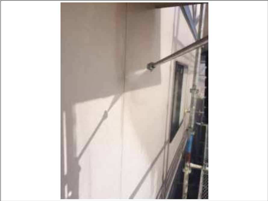
外壁高压洗净中
