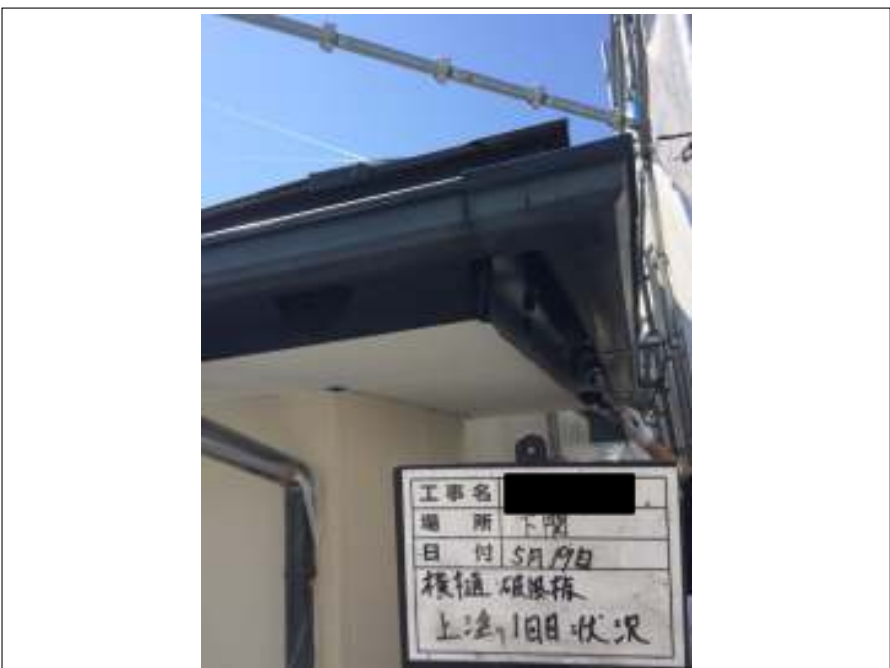
横樋・破風 上塗り (1回目) 施工中
