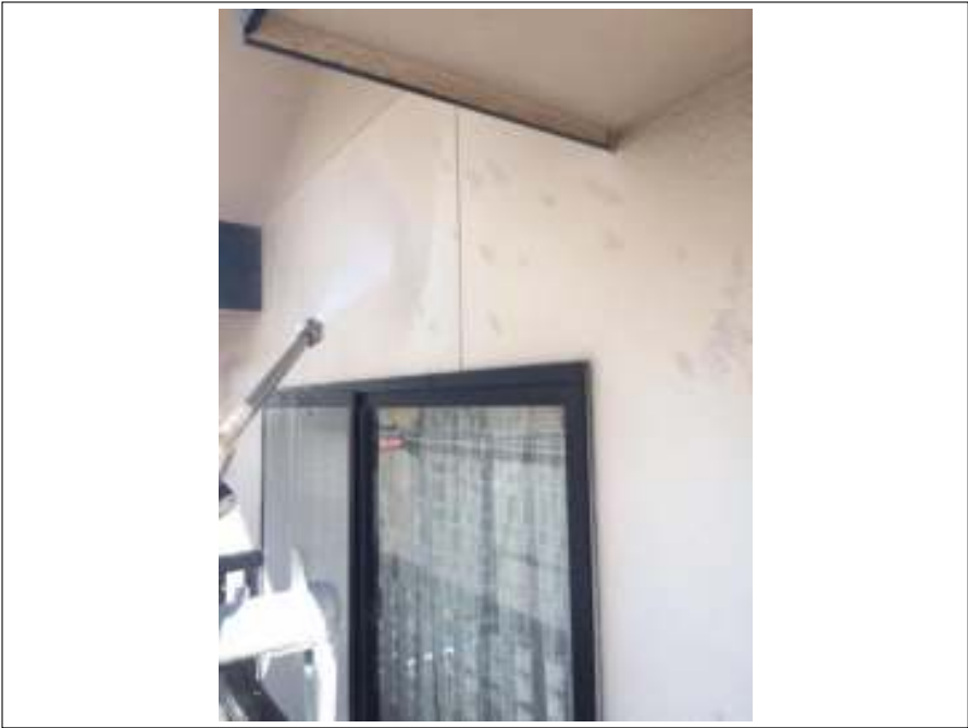
外壁高压洗净中
