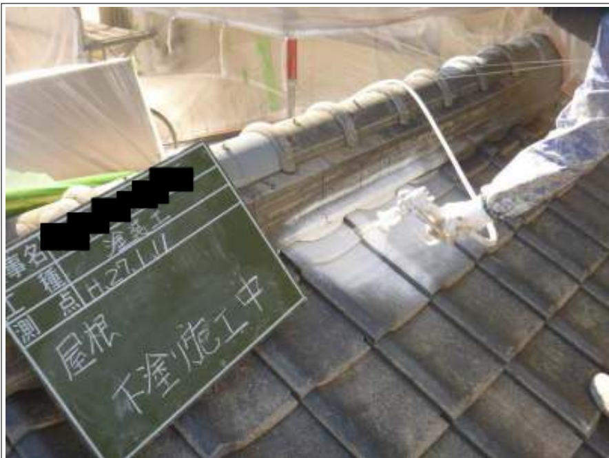
屋根塗装下塗り施工中
