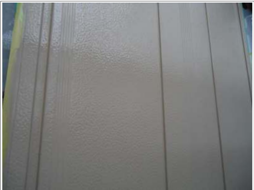
雨戸塗装施工完了
