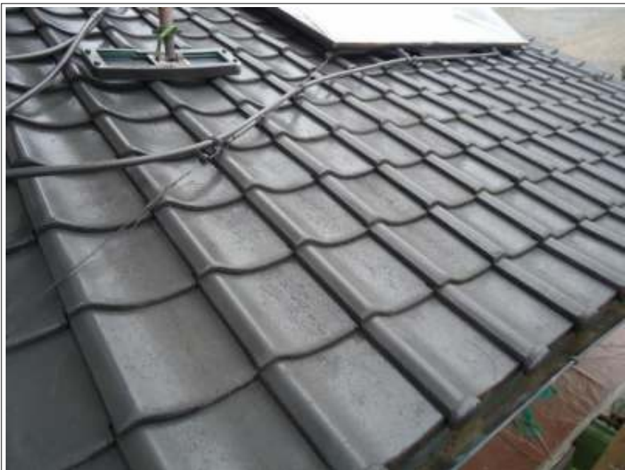
屋根塗装中塗り施工完了
