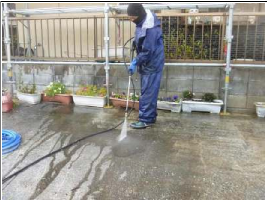
土間高圧洗浄施工中
