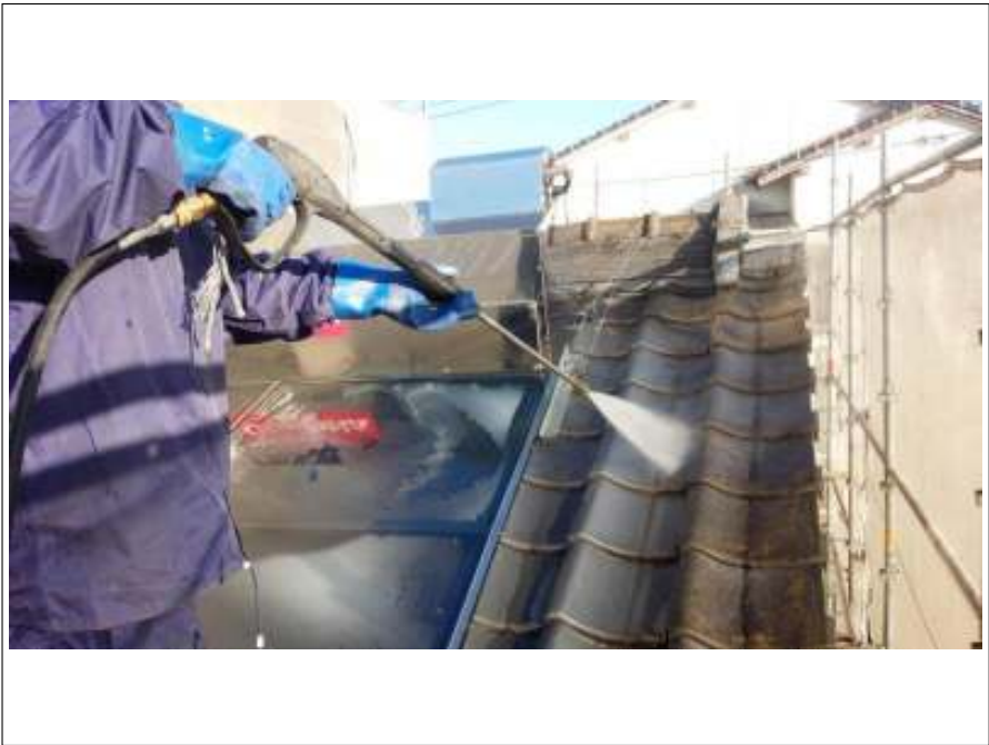
屋根高压洗净施工中
