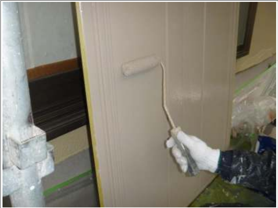
雨戸塗装上塗り施工中
