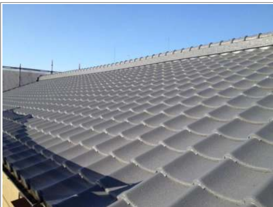
屋根塗装上塗り施工完了
