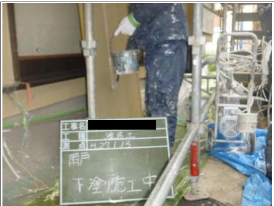
雨戸塗装下塗り施工中
