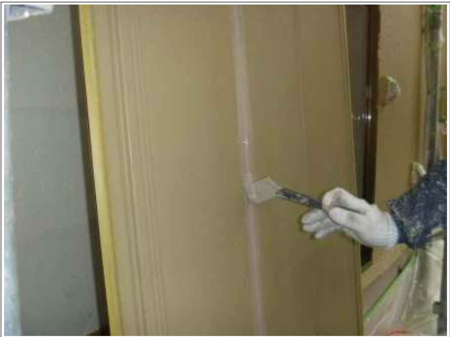
雨戸塗装下塗り施工中
