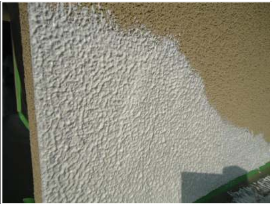
外壁クラック補修施工中
