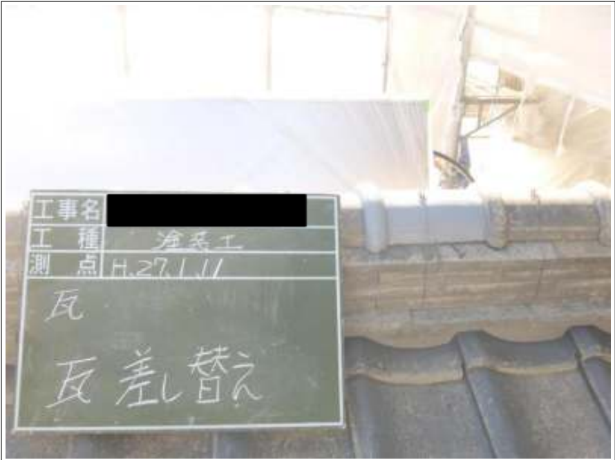
瓦差し替え施工完了
