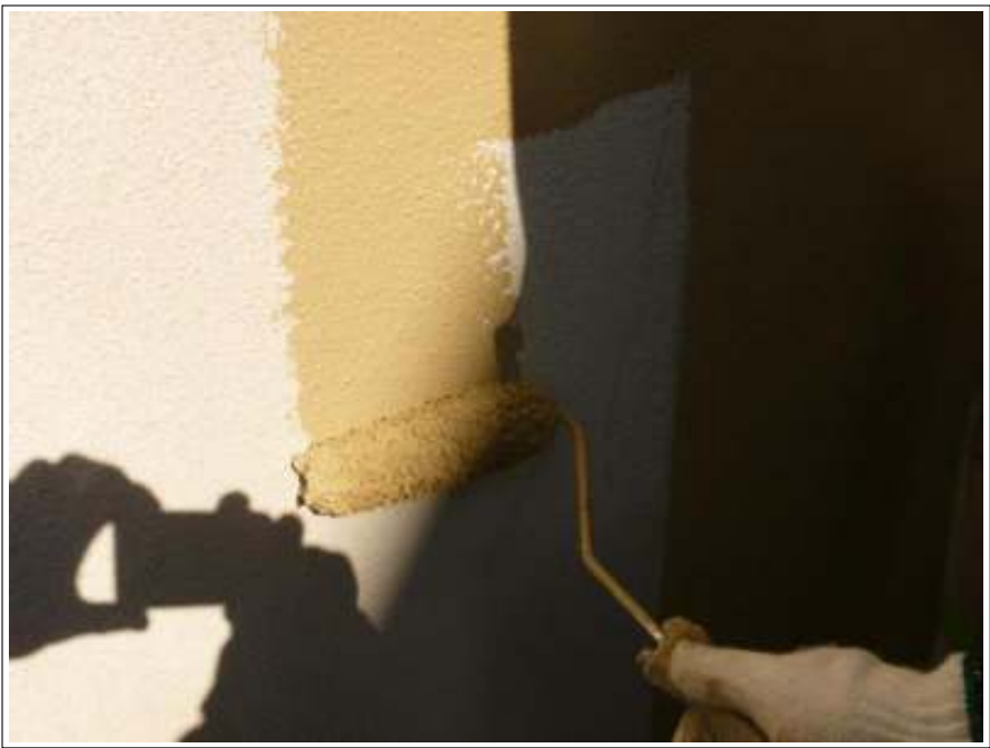
外壁塗装中塗り施工中
