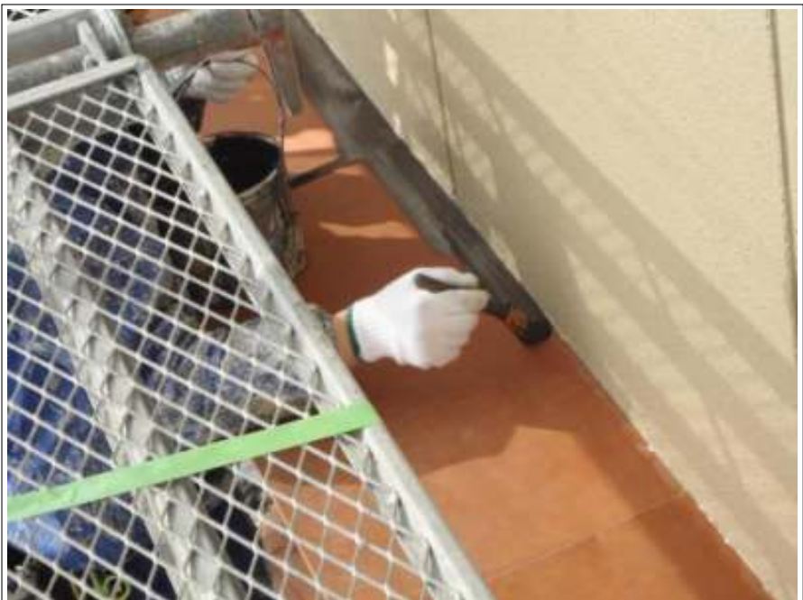
小庇塗装施工中
