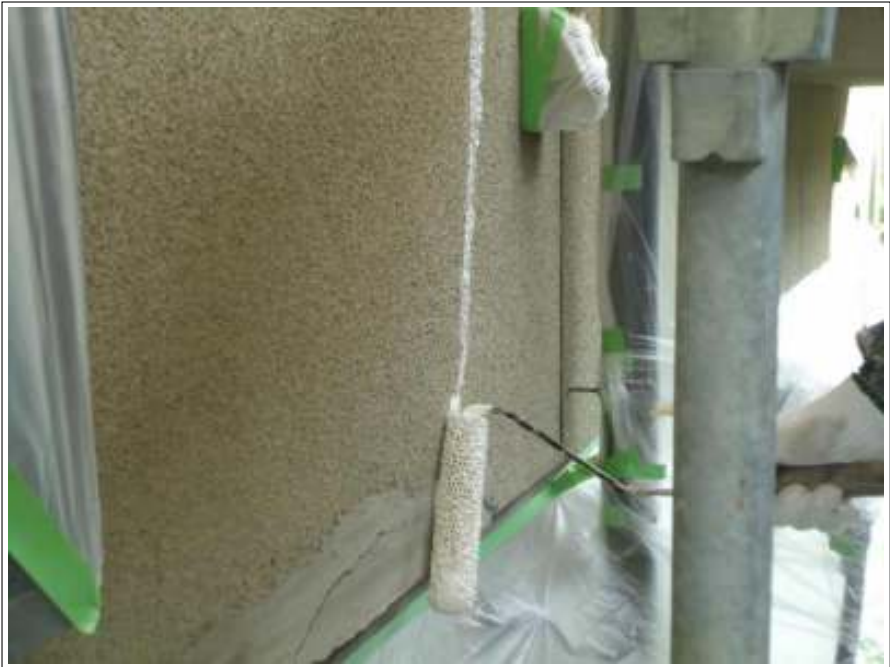
外壁クラック補修施工中
