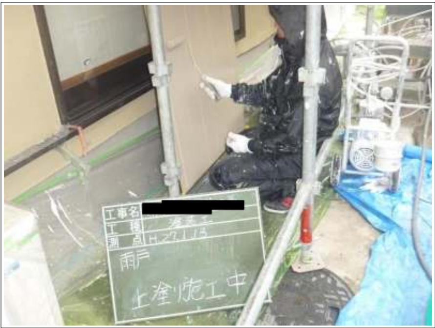
雨戸塗装上塗り施工中
