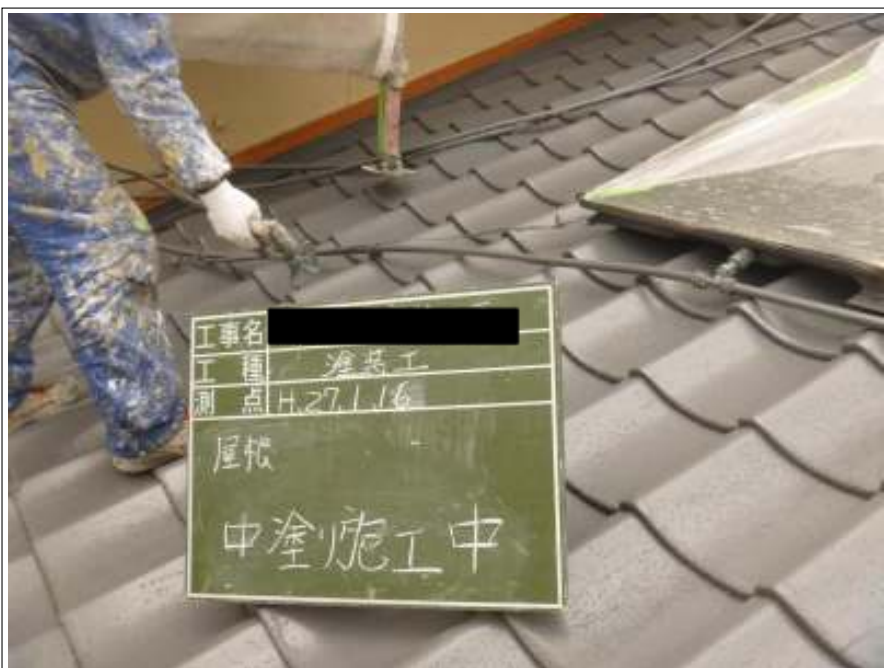
屋根塗装中塗り施工中
