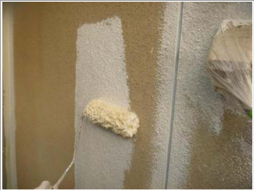
外壁塗装下塗り施工中
