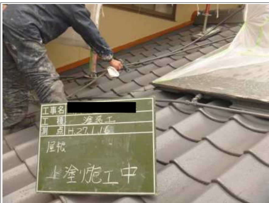
屋根塗装上塗り施工中
