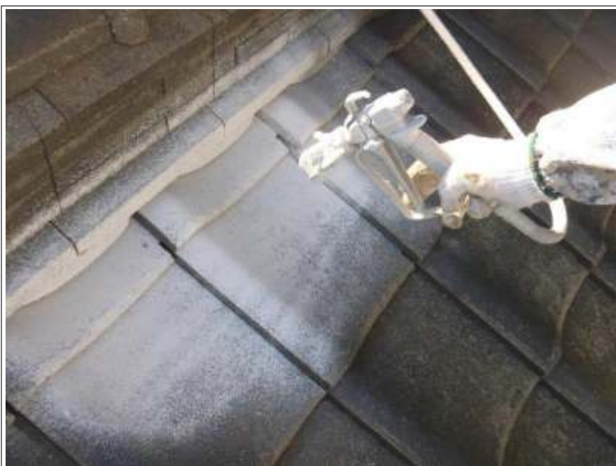
屋根塗装下塗り施工中
