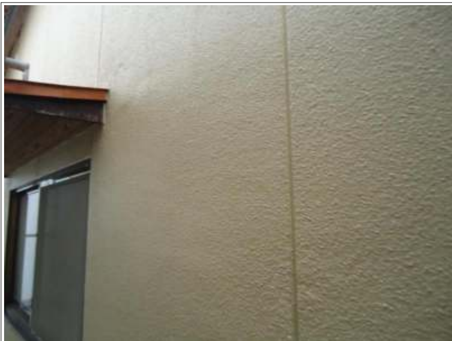
外壁塗装上塗り施工完了
