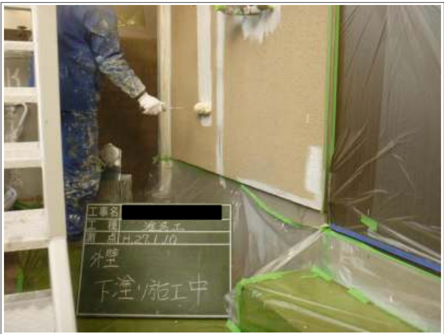
外壁塗装下塗り施工中
