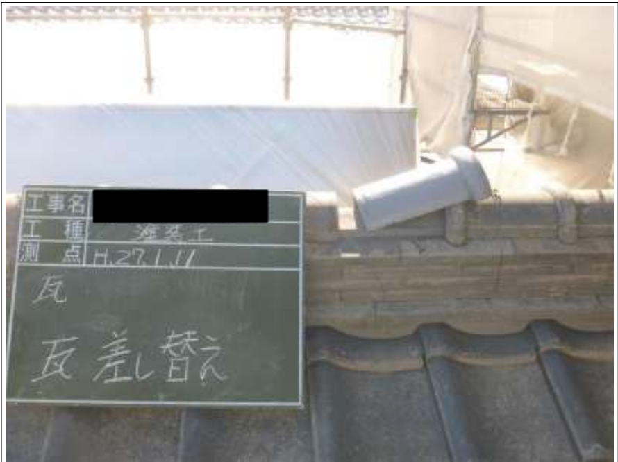
瓦差し替え施工中
