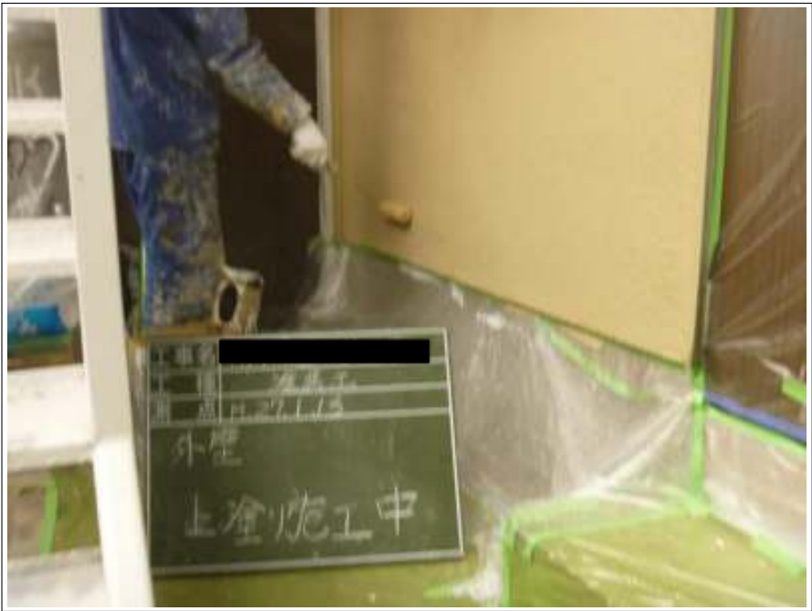
外壁塗装上塗り施工中
