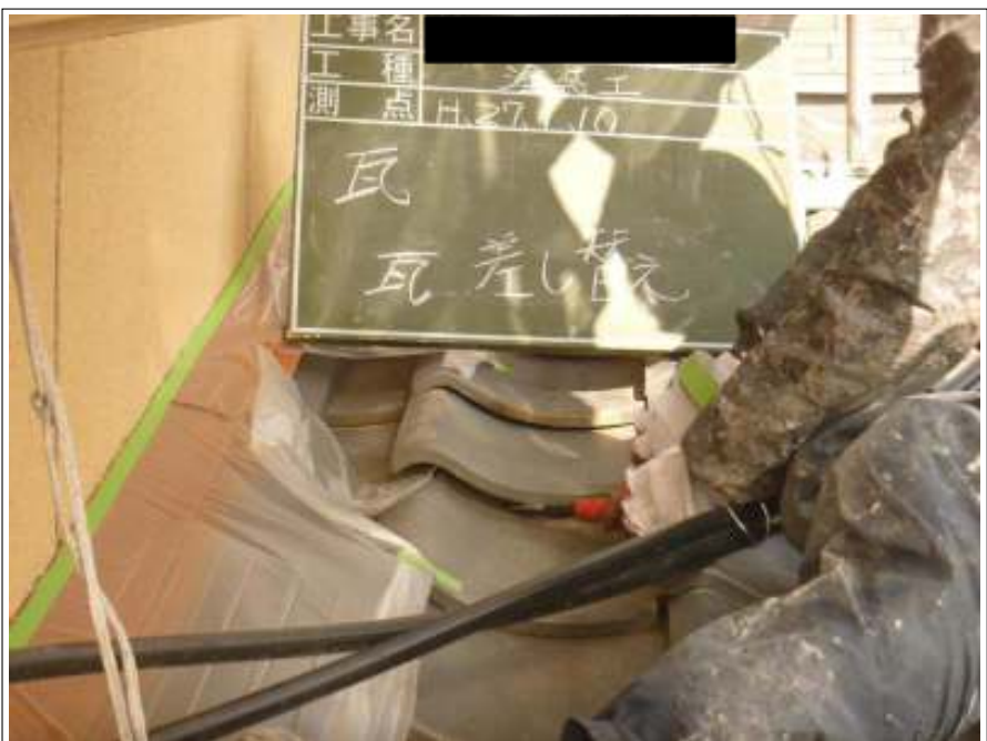
瓦差し替え施工中
