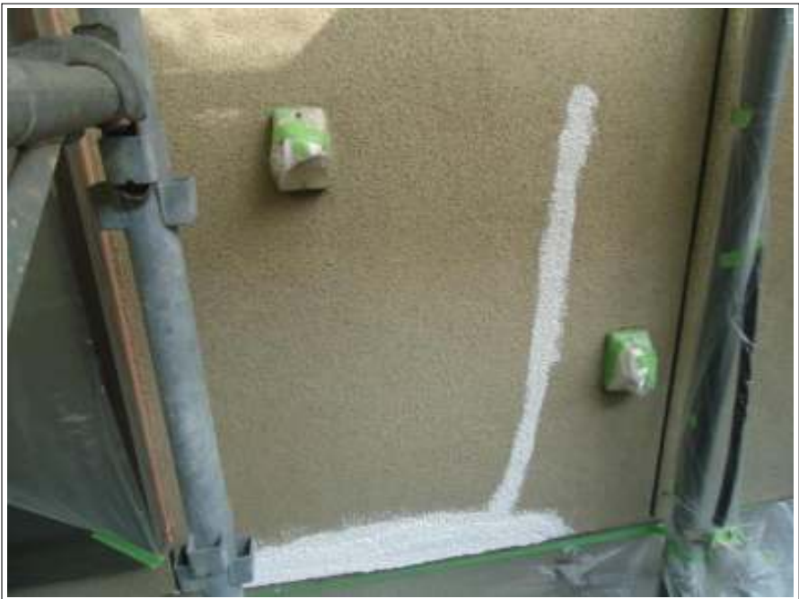
外壁クラック補修施工中
