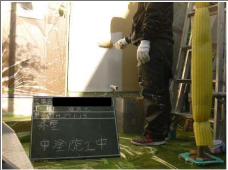
外壁塗装中塗り施工中
