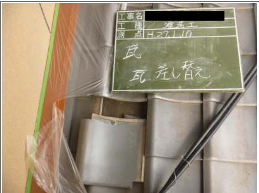
瓦差し替え施工中
