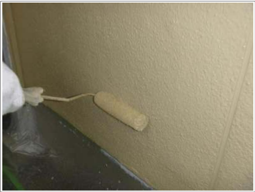
外壁塗装上塗り施工中
