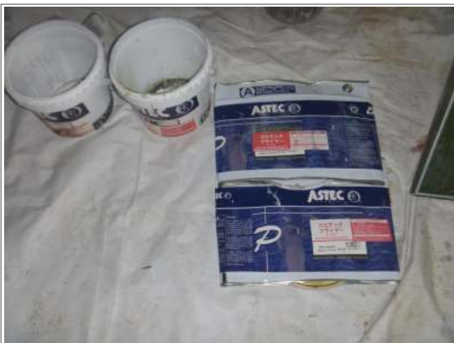
屋根下塗り使用材料空缶
