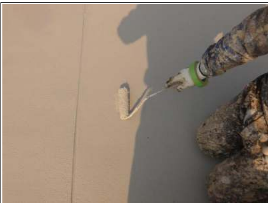
屋上防水中塗り施工中
