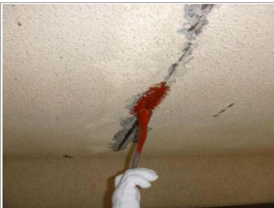
爆裂部 サビ止め施工中
