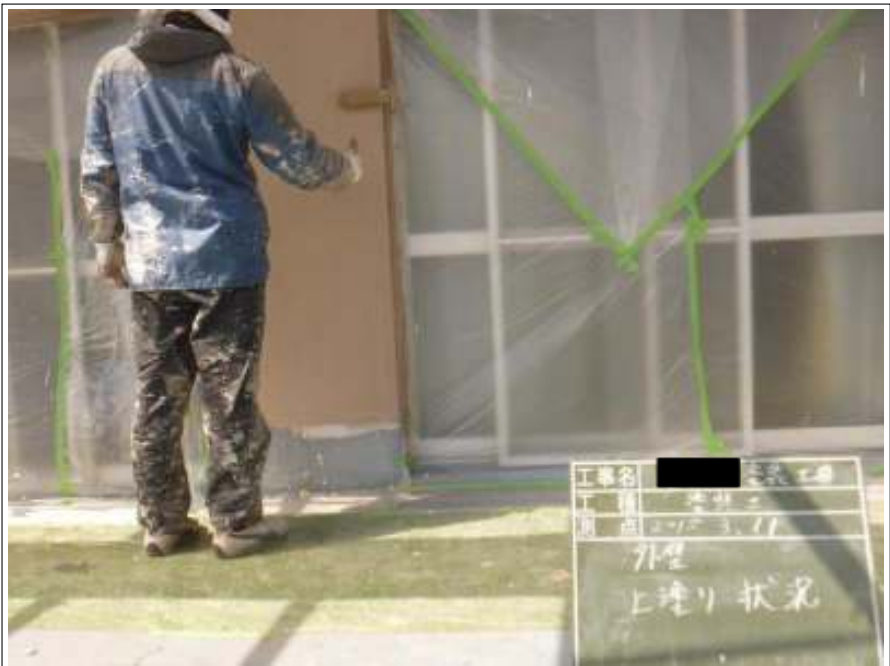
外壁塗装上塗り施工中
