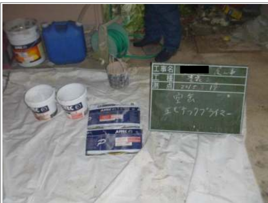
屋根下塗り使用材料空缶
