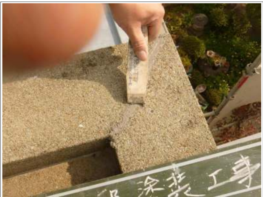
クラック補修施工中
