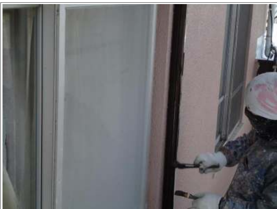
雨樋塗装施工中
