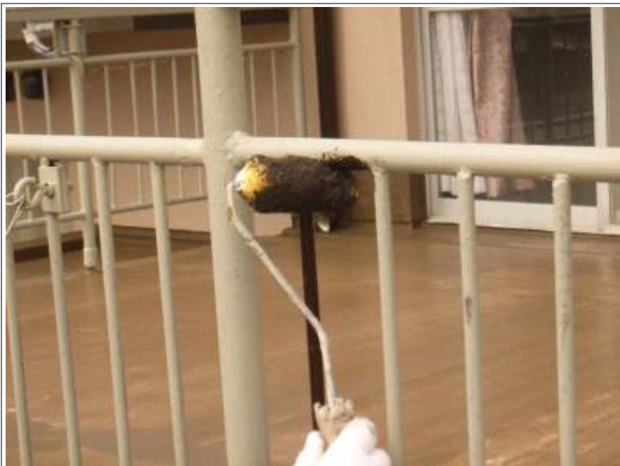
手摺塗装上塗り施工中
