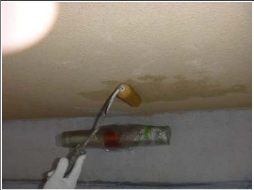
軒天塗装下塗り施工中
