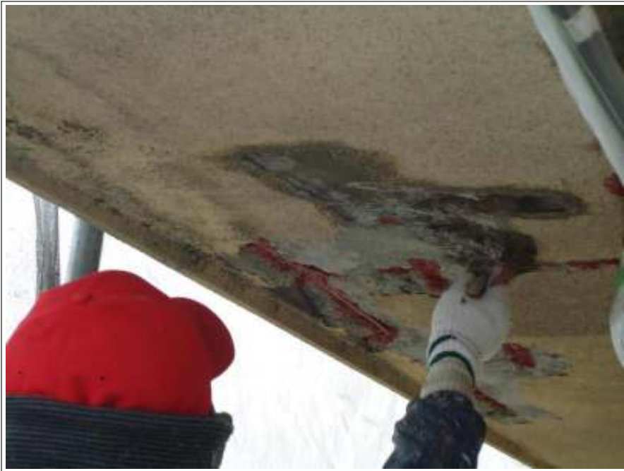
爆裂部 モルタル補修施工中
