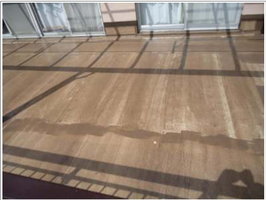
ベランダ部中塗り施工後
