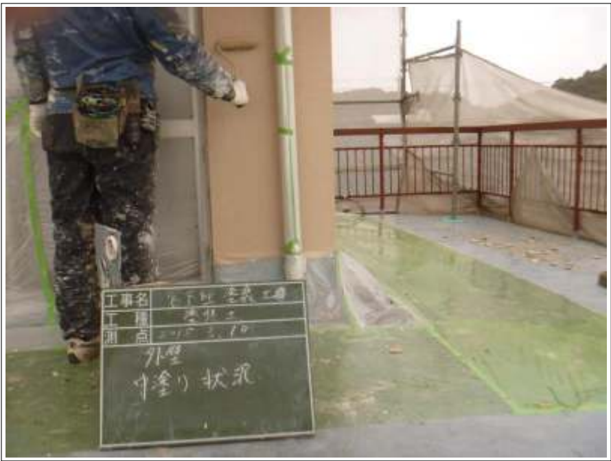
外壁塗装中塗り施工中
