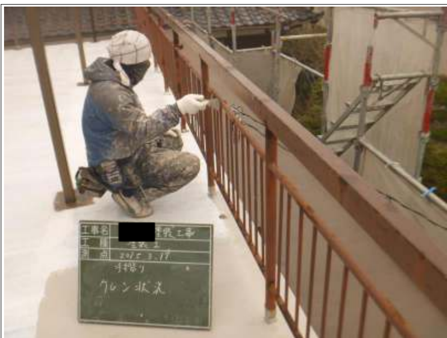
手摺ケレン施工中
