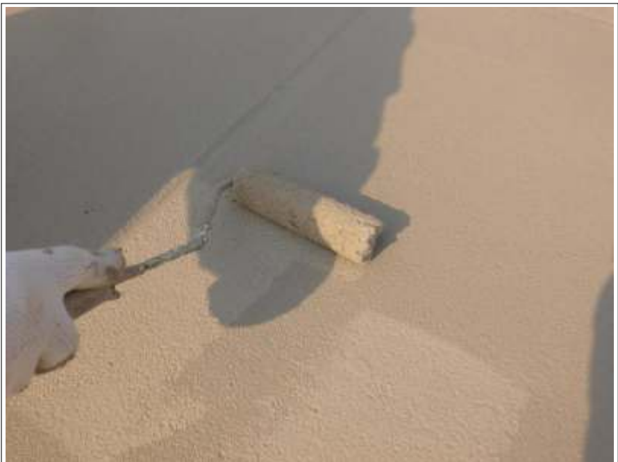
屋上防水上塗り施工中
