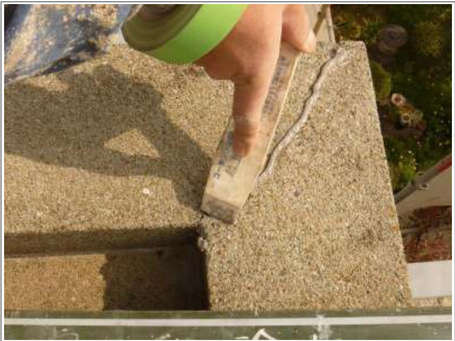
クラック補修施工中
