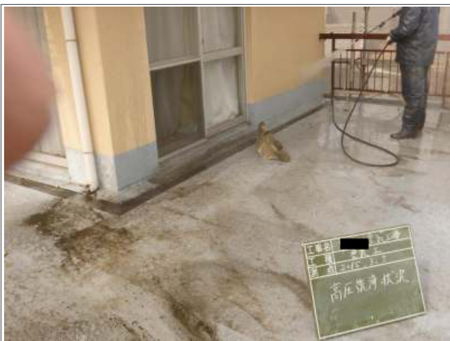
屋上高压洗浄施工中
