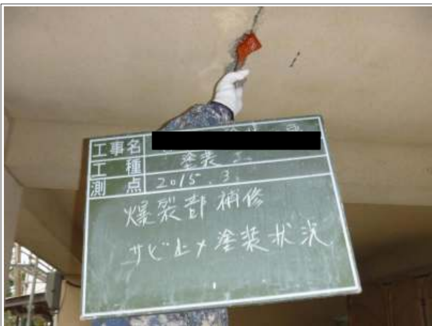
爆裂部 サビ止め施工中
