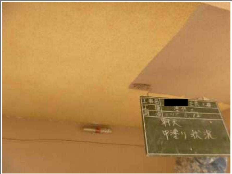
軒天塗装中塗り施工中
