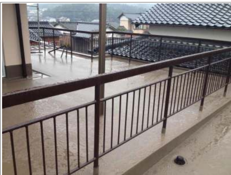
手摺塗装上塗り施工後
