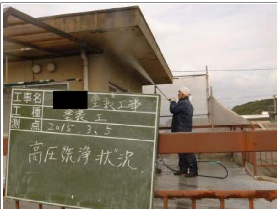
外壁高压洗浄施工中
