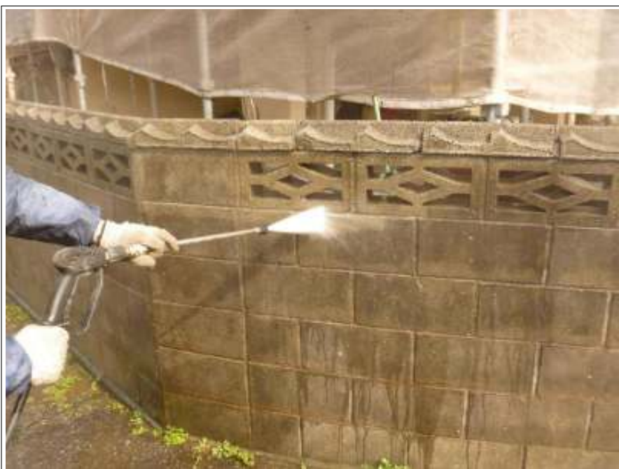
塀高圧洗浄施工中
