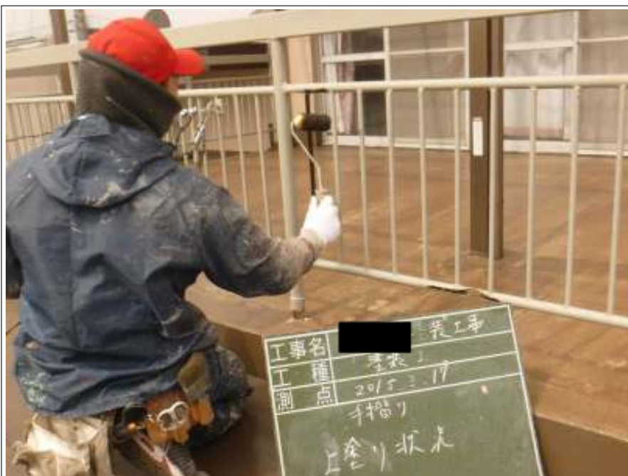
手摺塗装上塗り施工中
