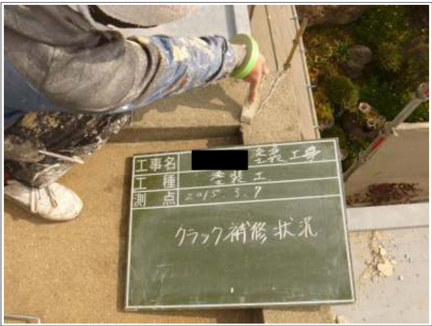
クラック補修施工中
