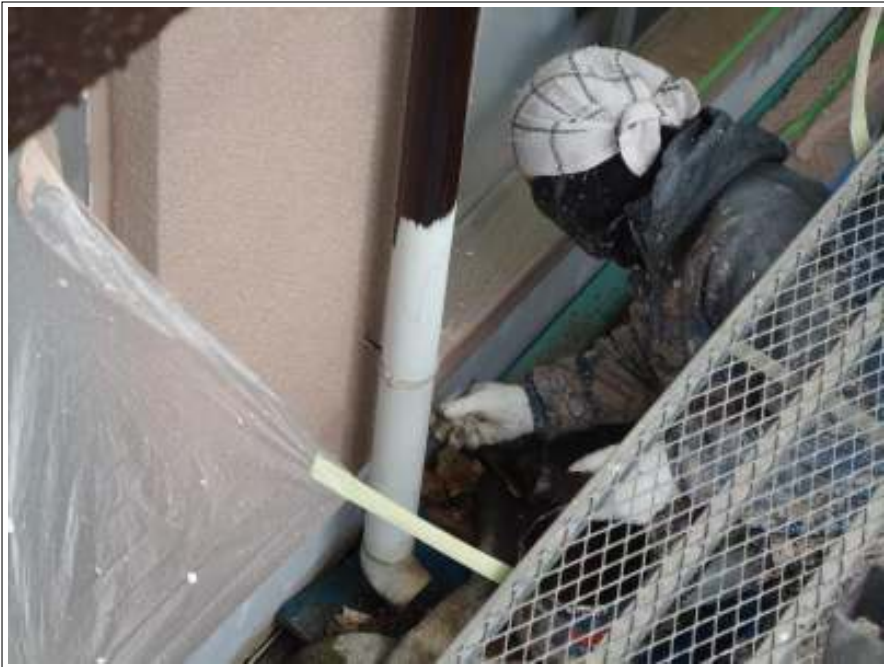
雨樋塗装施工中
