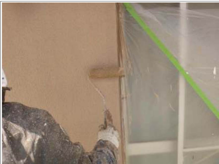
外壁塗装上塗り施工中
