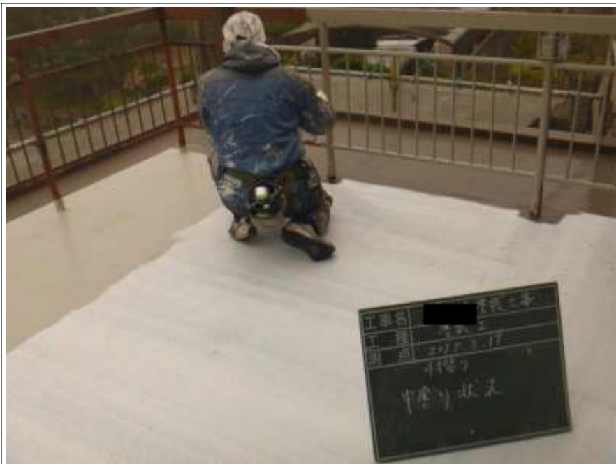
手摺塗装サビ止め施工中
