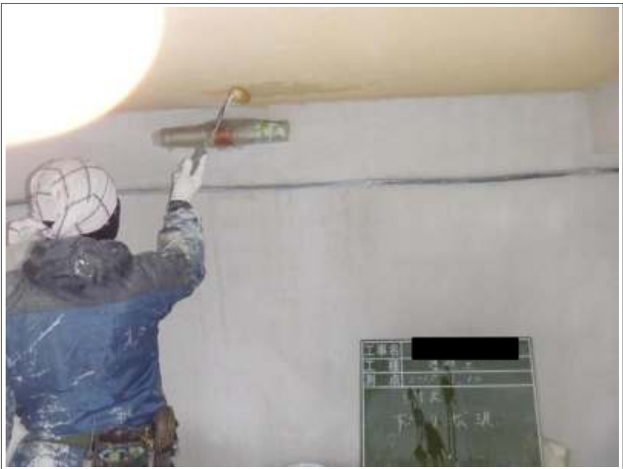
軒天塗装下塗り施工中
