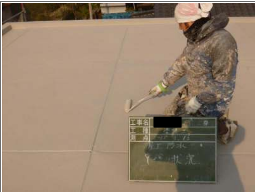
屋上防水中塗り施工中
