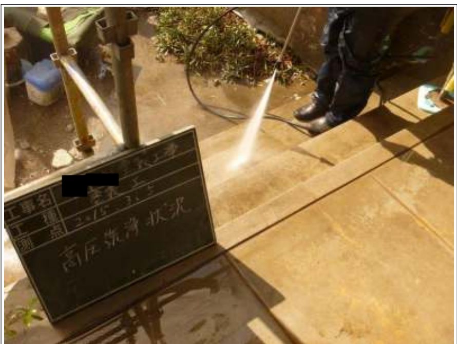
土間高压洗淨施工中
