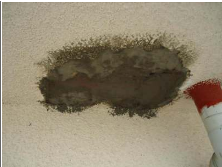
爆裂部 モルタル補修施工後
