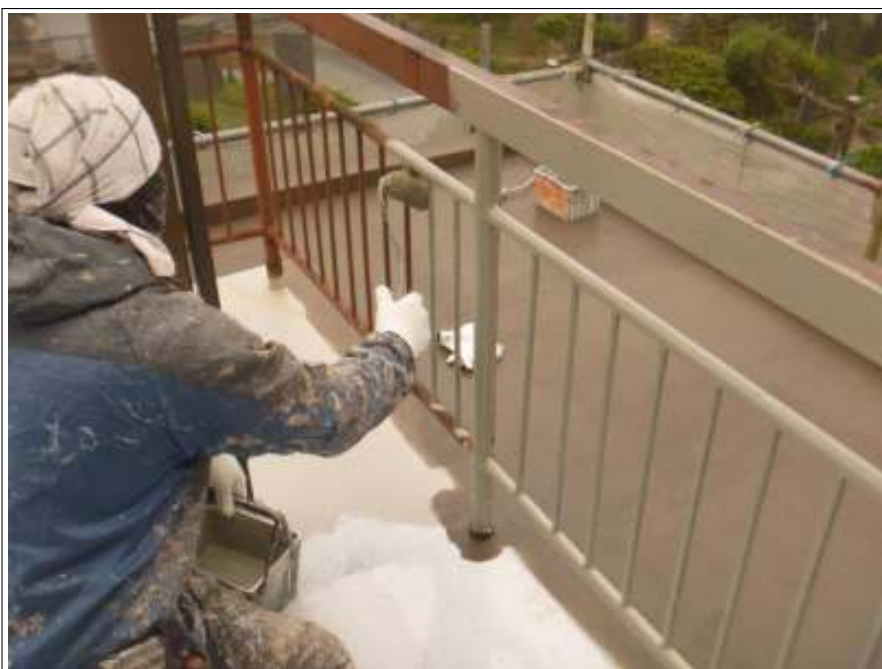
手摺塗装サビ止め施工中
