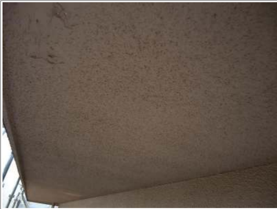
軒天塗装上塗り施工後
