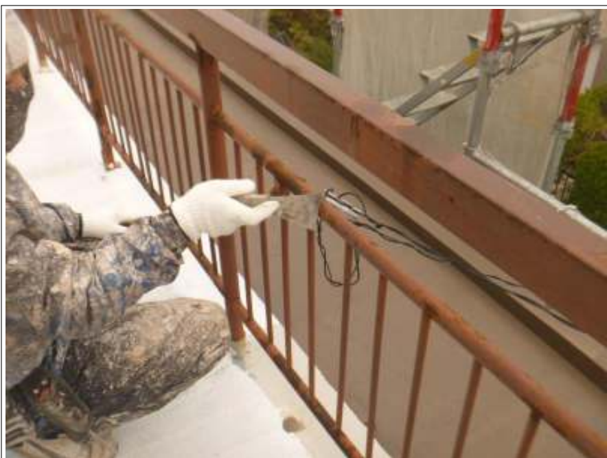
手摺ケレン施工中
