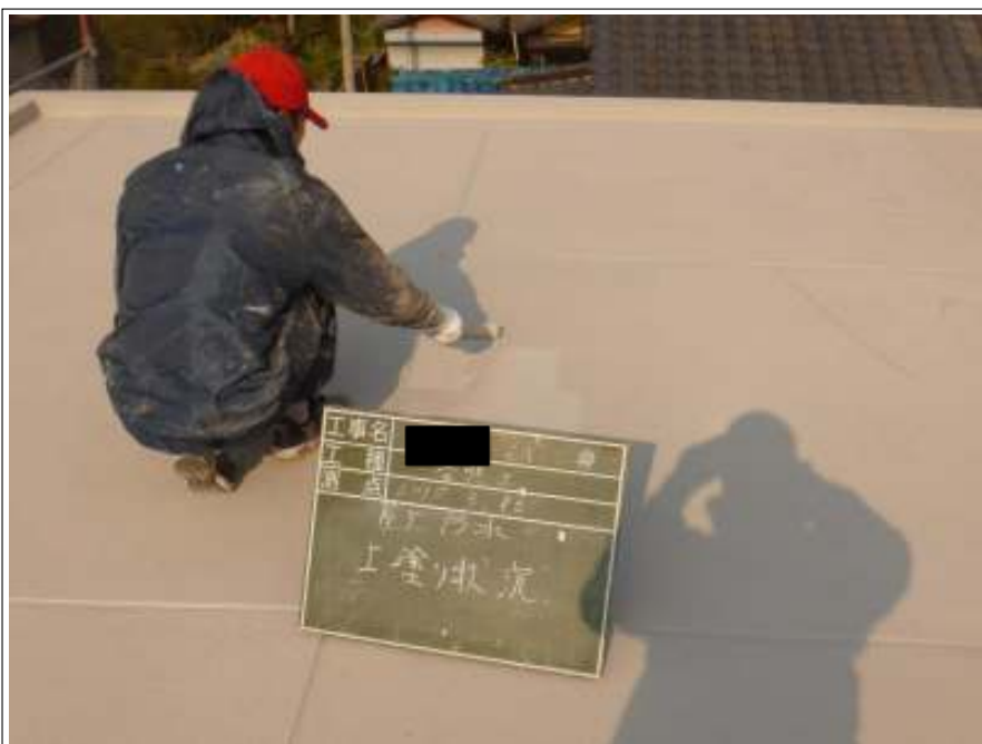
屋上防水上塗り施工中
