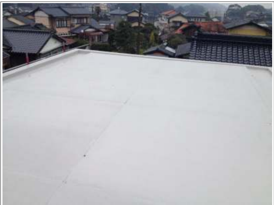
屋上防水上塗り施工後
