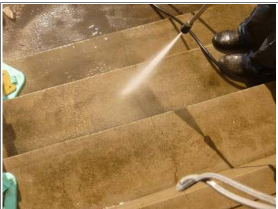
土間高压洗淨施工中
