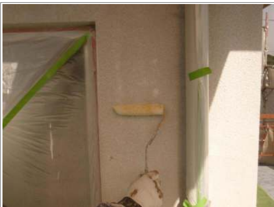
外壁塗装下塗り施工中
