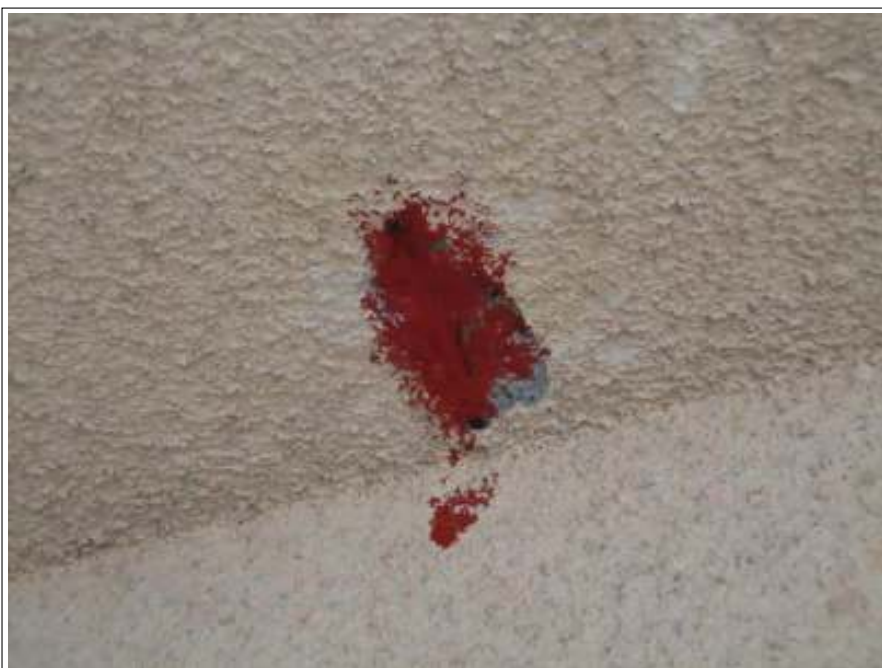
爆裂部 サビ止め施工後
