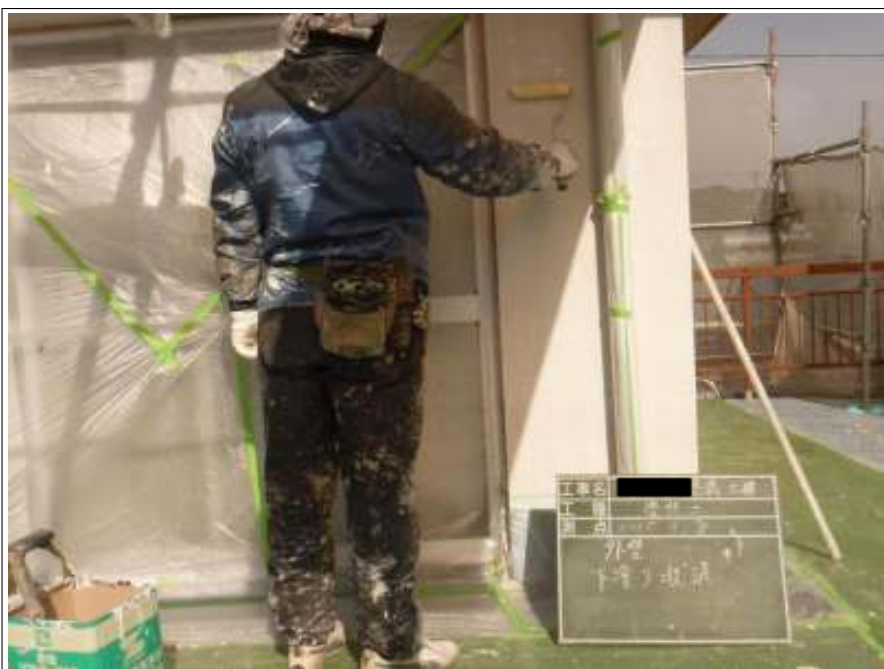
外壁塗装下塗り施工中
