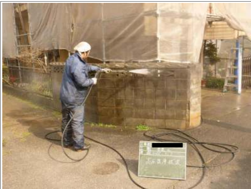
塀高圧洗浄施工中
