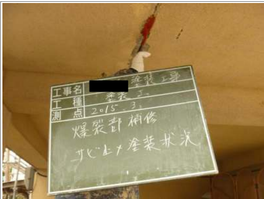
爆裂部 サビ止め施工中
