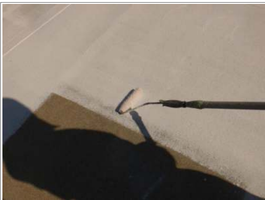
屋上防水下塗り施工中
