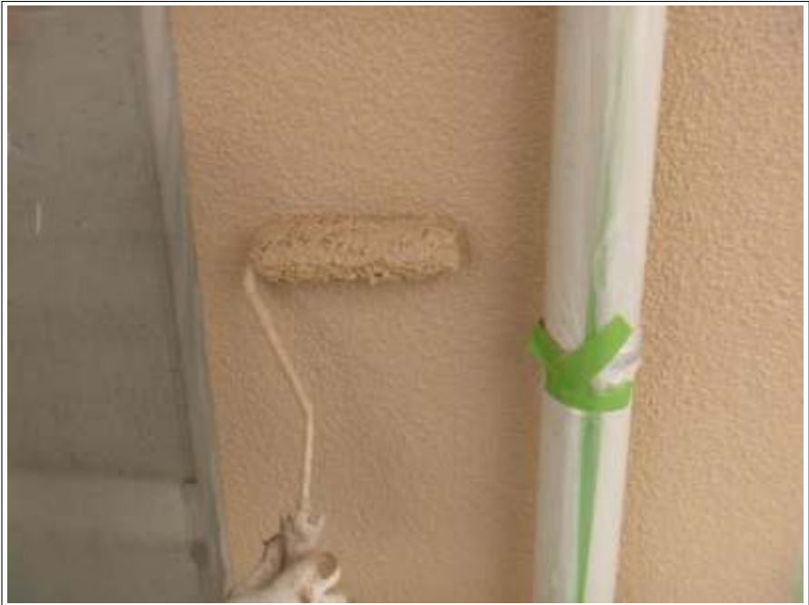
外壁塗装中塗り施工中
