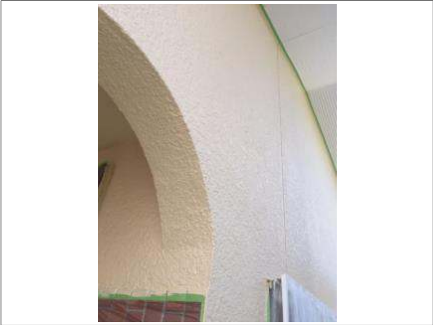
外壁 中塗り施工後
