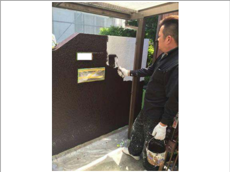
塀 上塗り施工中
