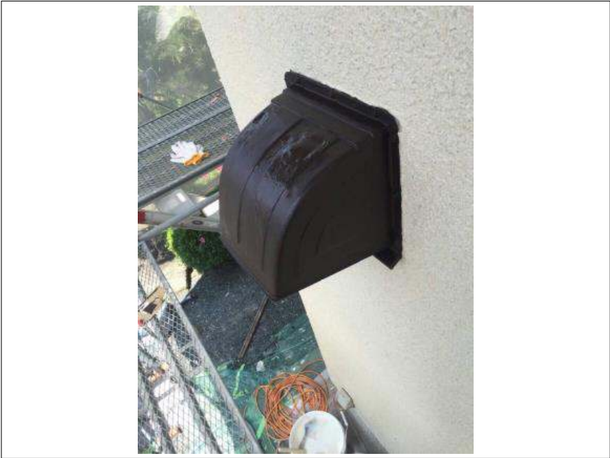
換気フード 施工後
