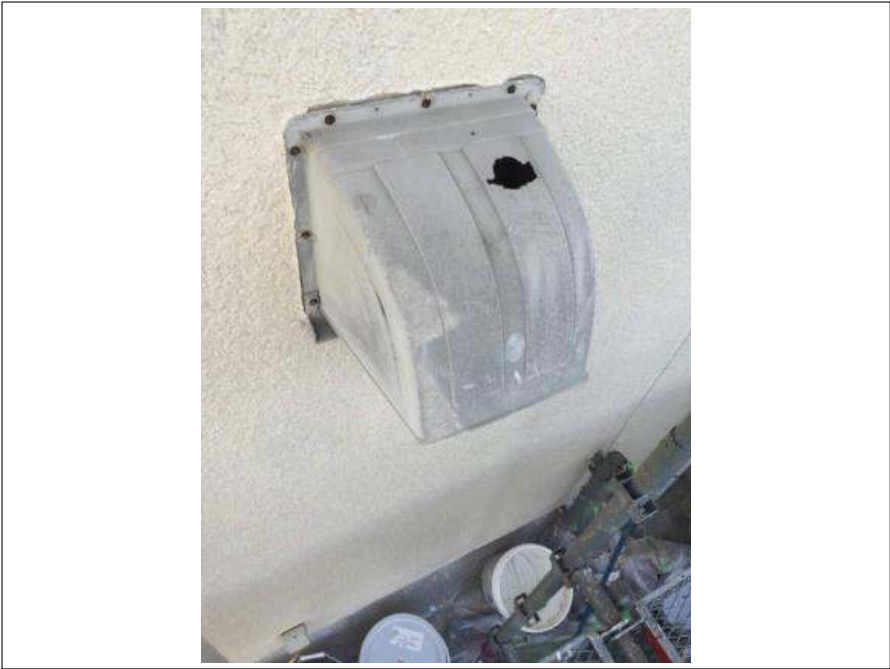
換気フード 施工前
