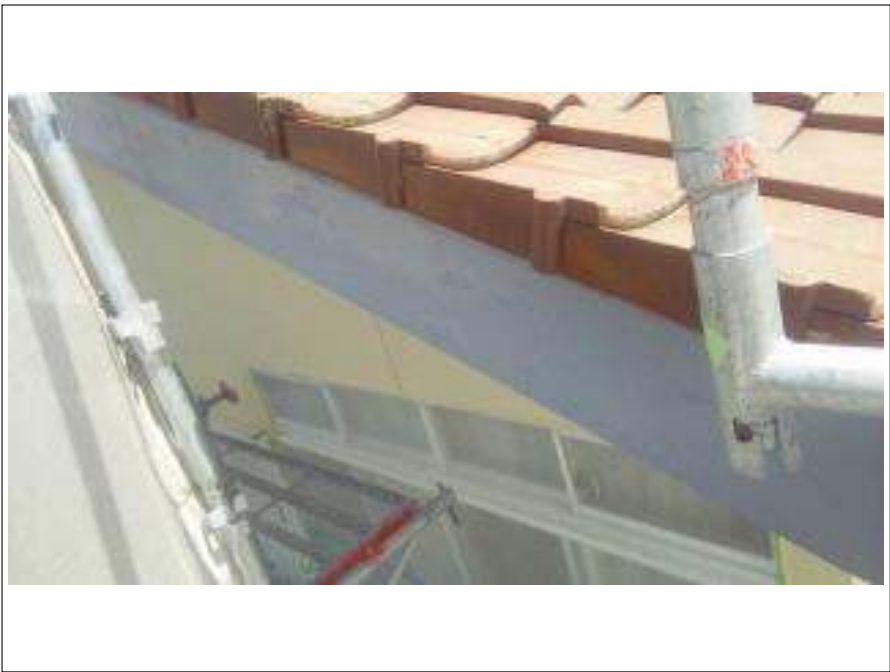
破風板 下塗 施工後
