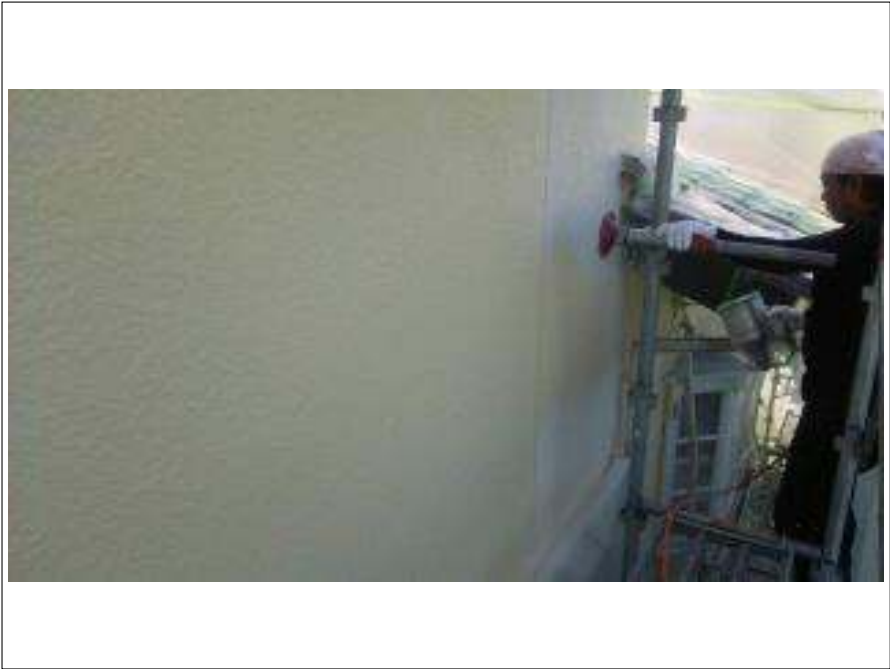
外壁 上塗り施工中
