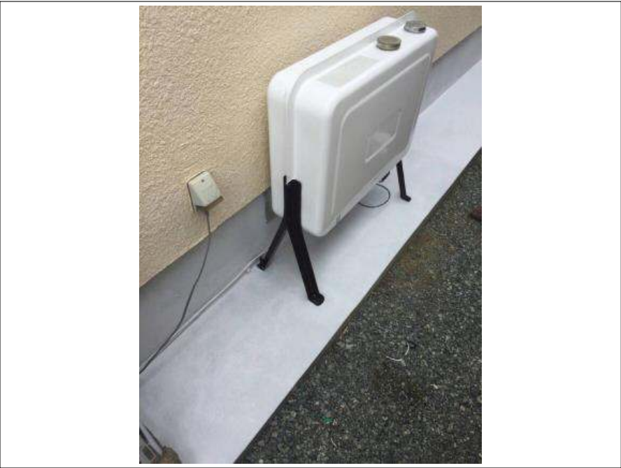
基礎・犬走り 施工後
