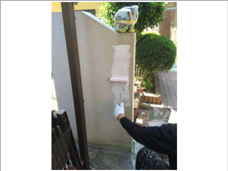
塀 下塗り施工中
