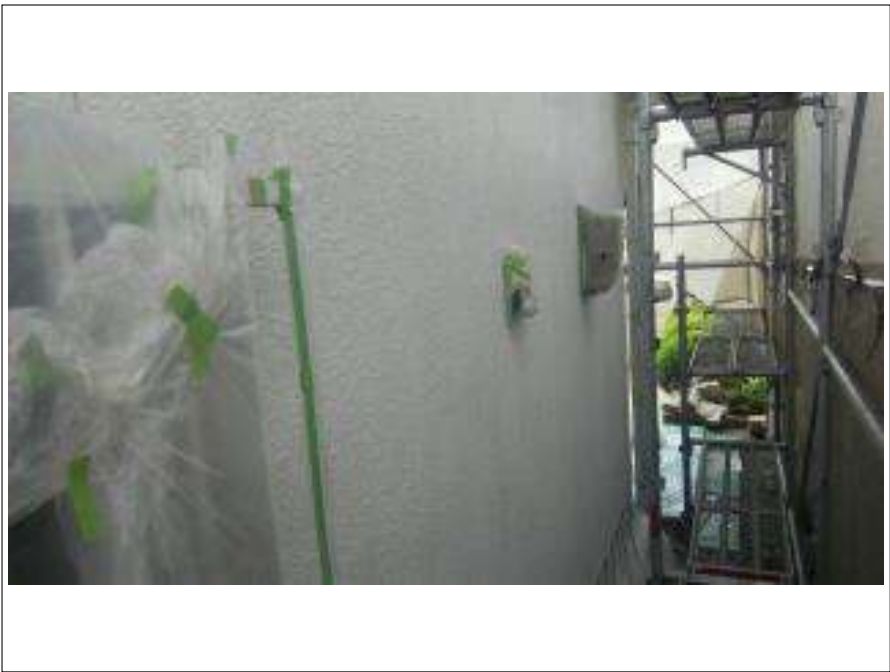
外壁 下塗り施工中
