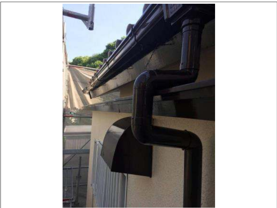
樋 上塗り施工後
