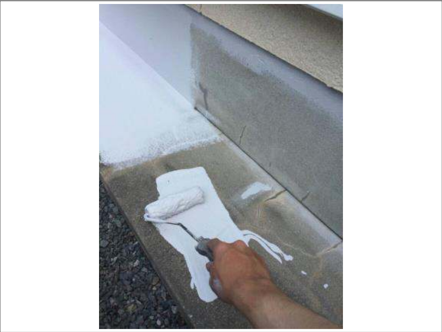
基礎・犬走り 施工中
