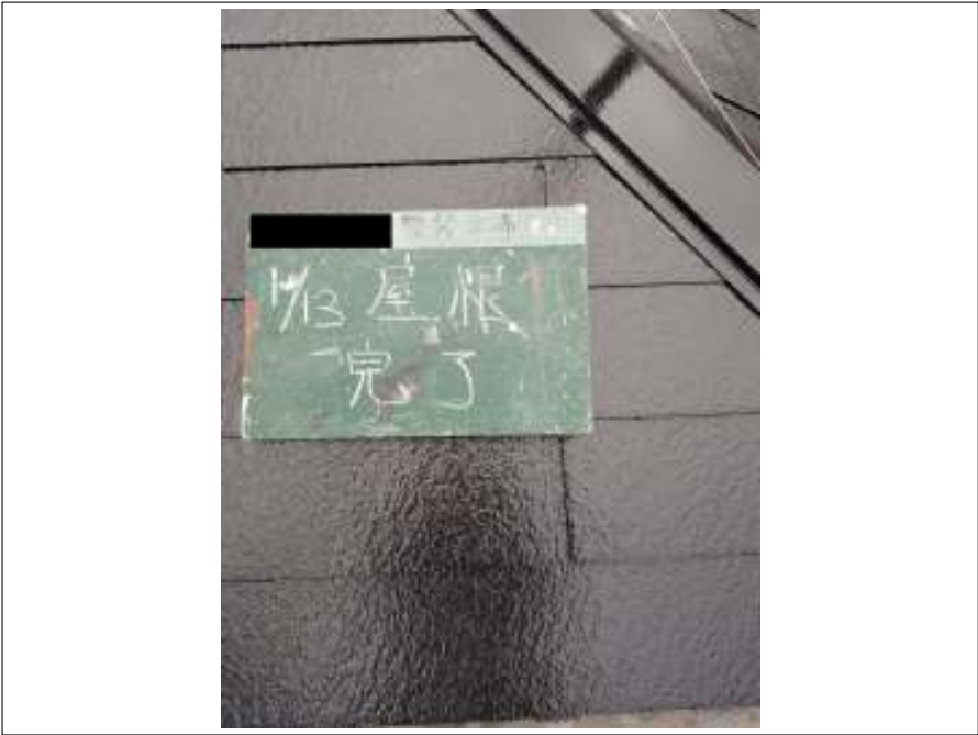
屋根 施工完了
