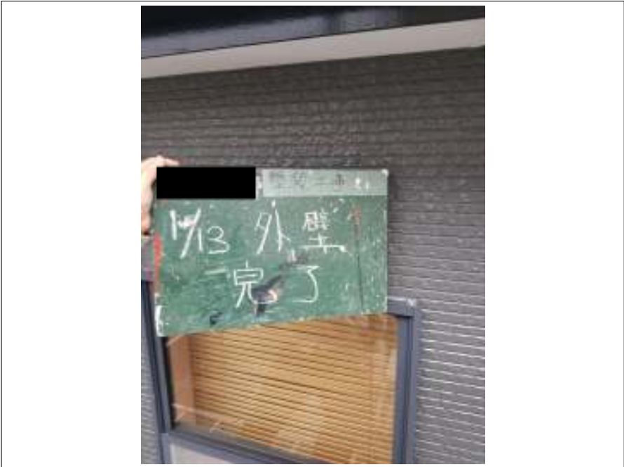
外壁 施工完了
