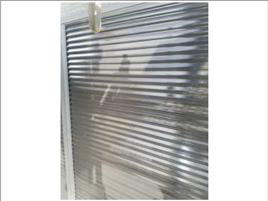
雨戸 施工完了
