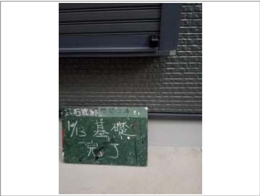
基礎 施工完了
