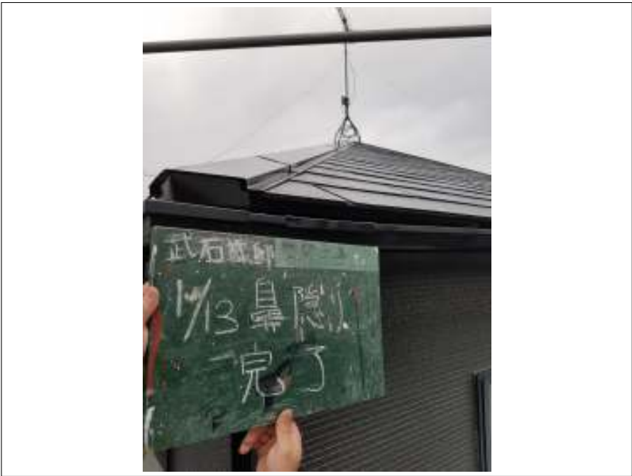
鼻隠し 施工完了
