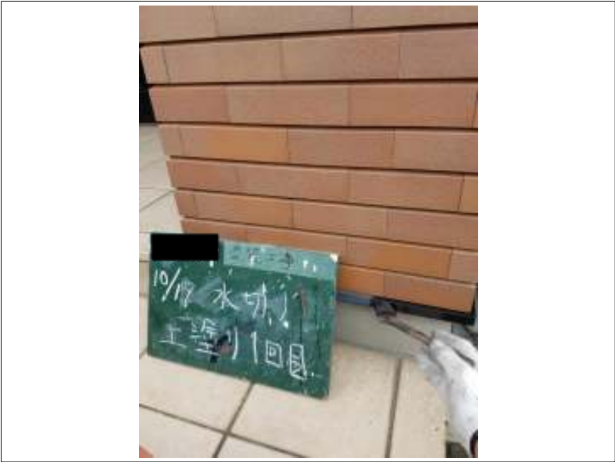
土台水切り 上塗り(1回目)施工中
