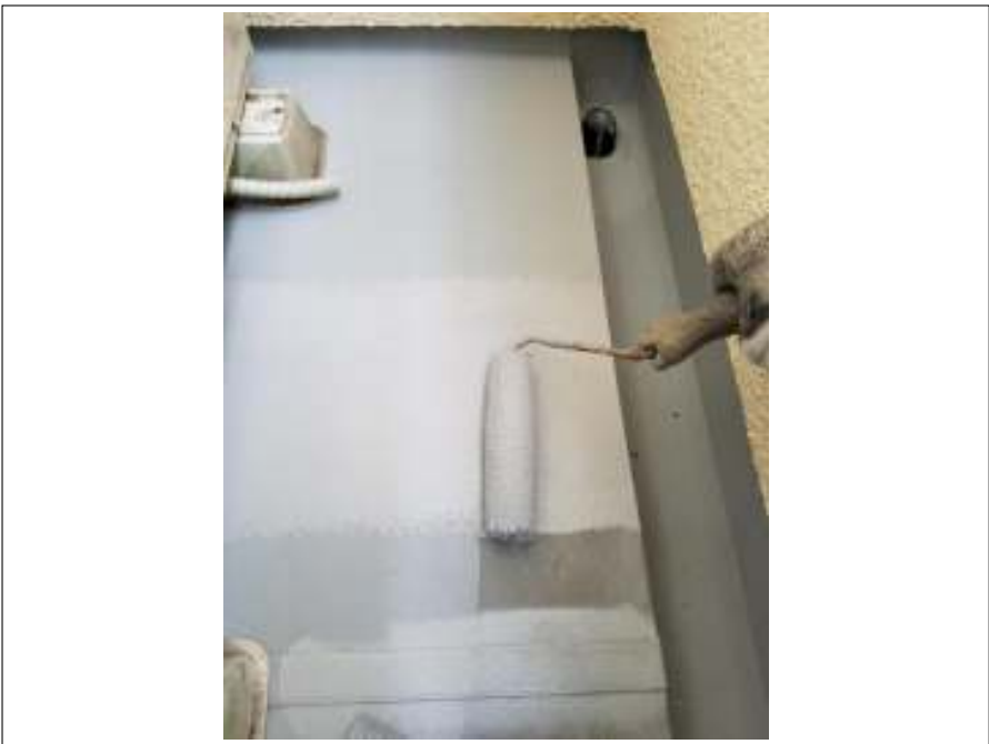
ベランダ 上塗り施工中
