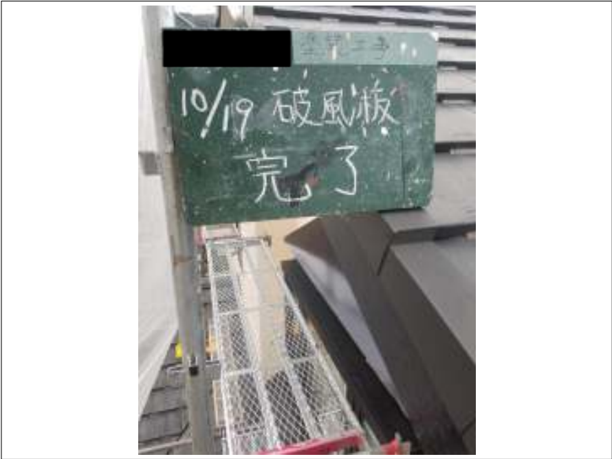
破風板 施工完了
