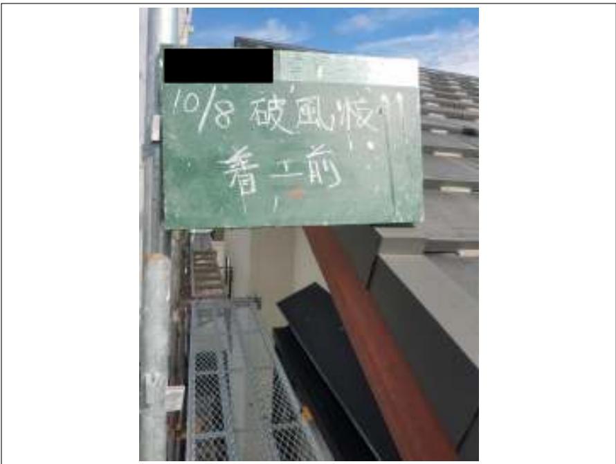
破風板 施工前
