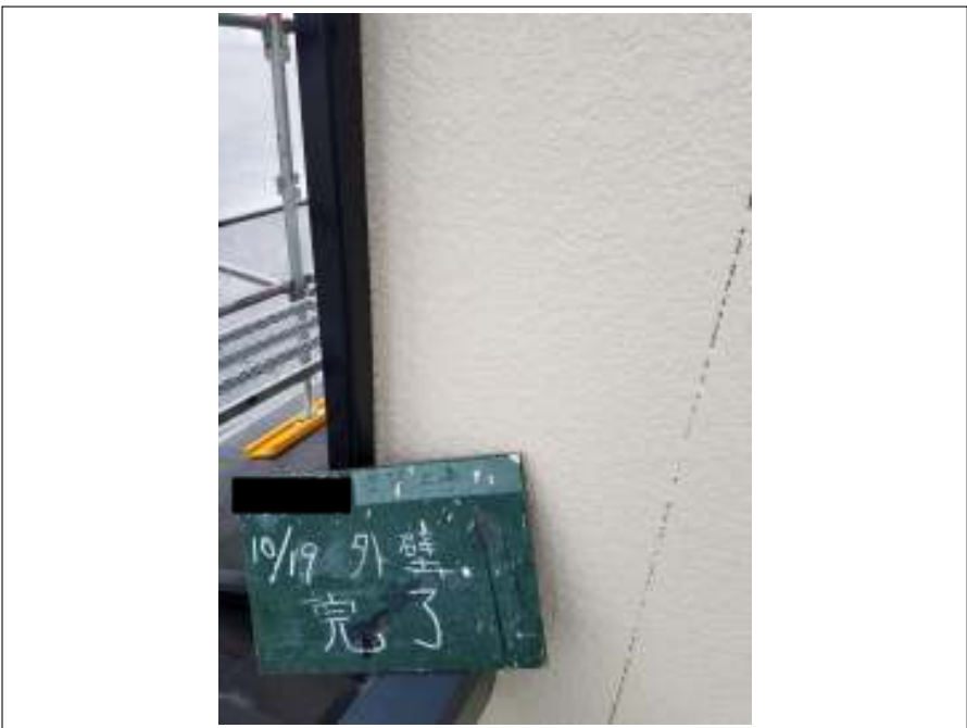
外壁 施工完了
