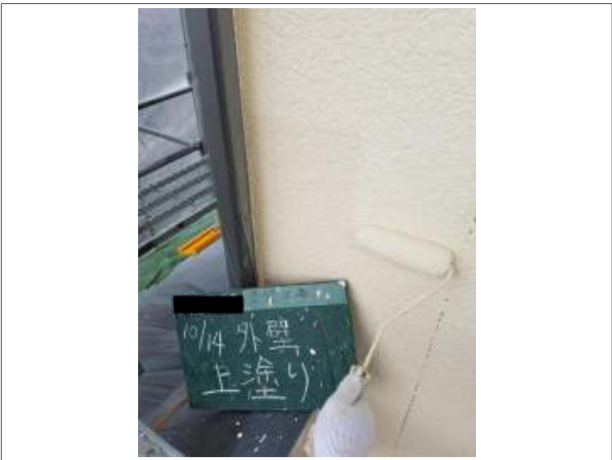
外壁 上塗り施工中
