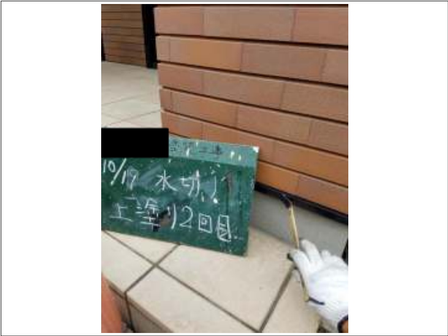
土台水切り 上塗り(2回目)施工中
