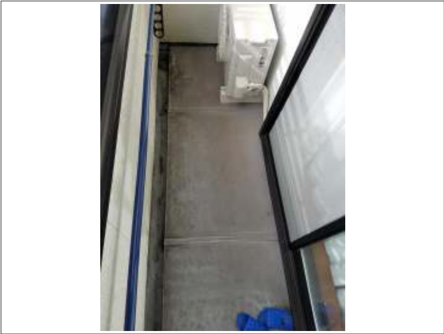
ベランダ 施工前
