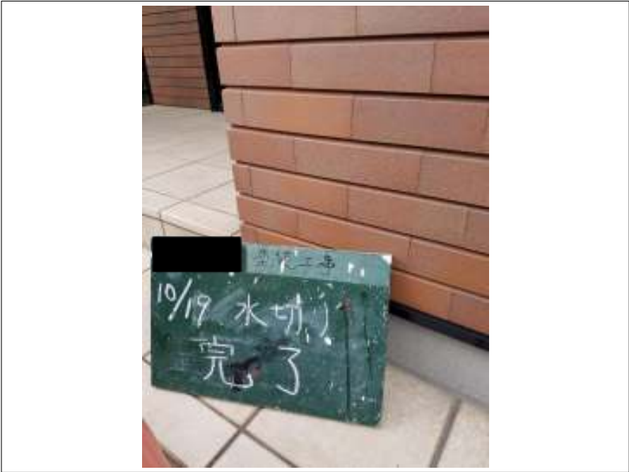
土台水切り 施工完了
