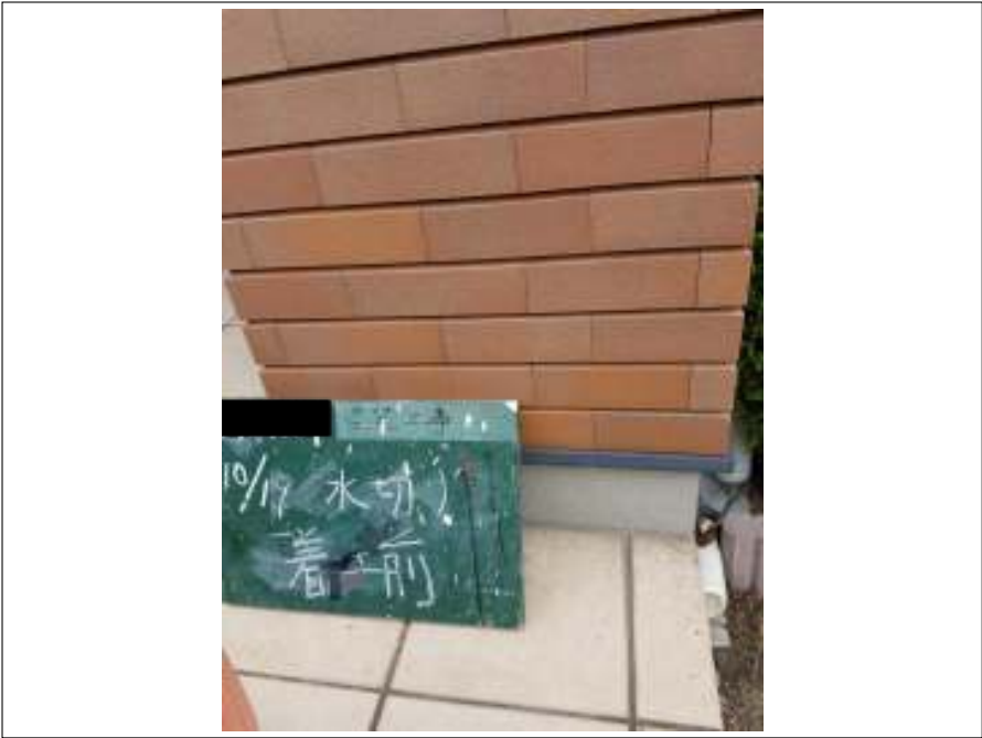
土台水切り 施工前
