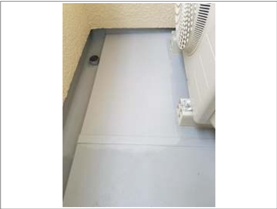
ベランダ 上塗り施工中
