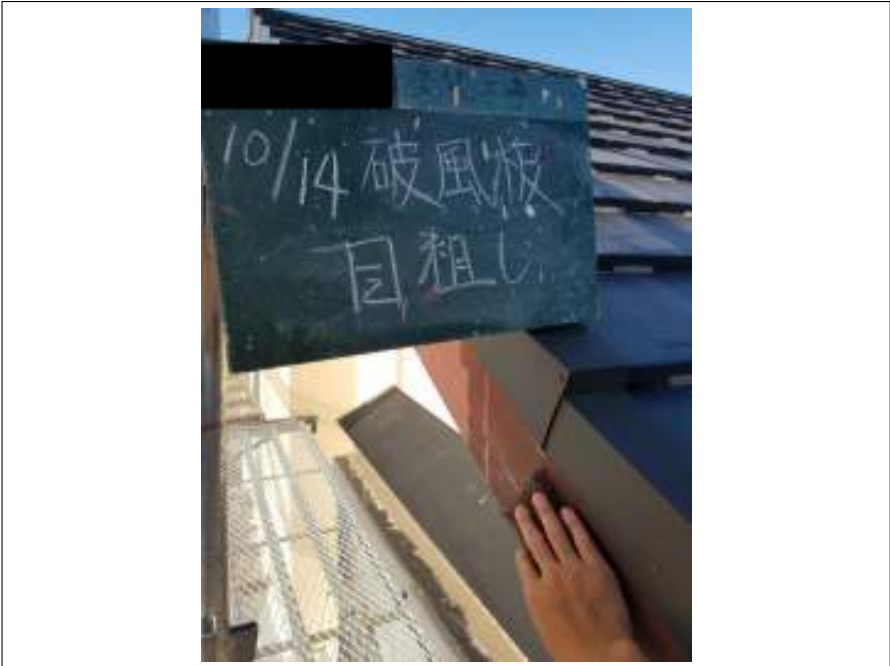
破風板 目粗し施工中
