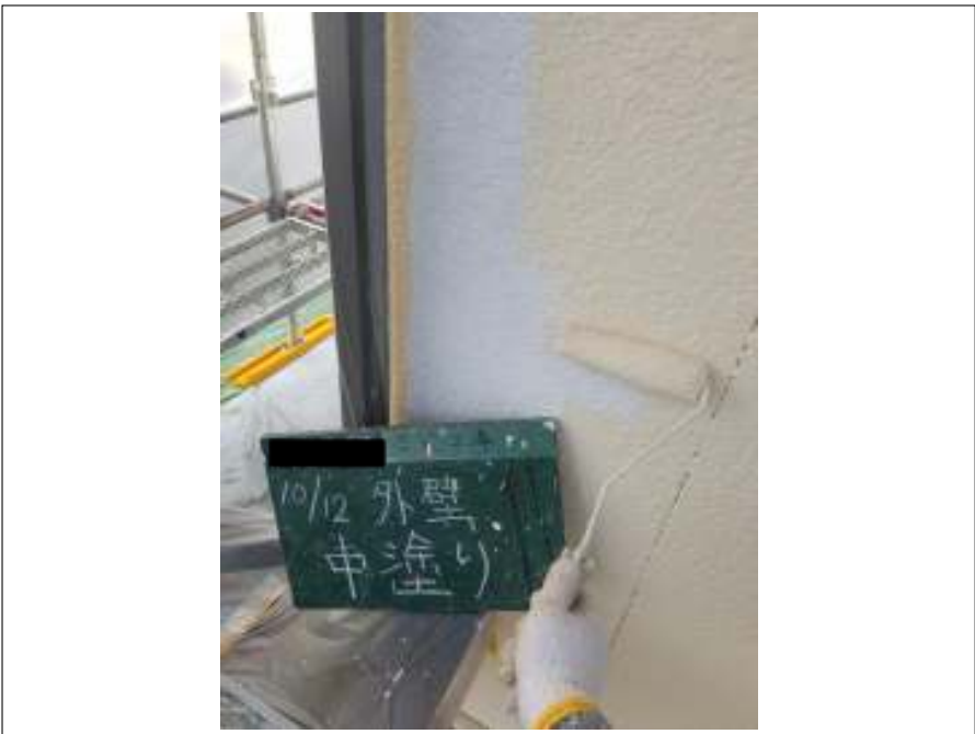
外壁 中塗り施工中
