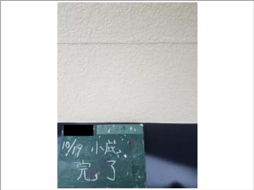
小庇 施工完了
