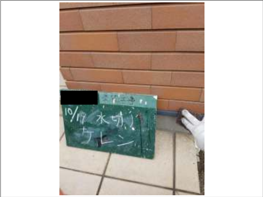
土台水切り ケレン処理施工中
