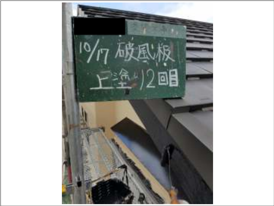
破風板 上塗り（2回目）施工中
