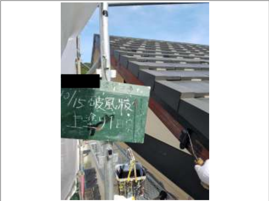
破風板 上塗り（1回目）施工中
