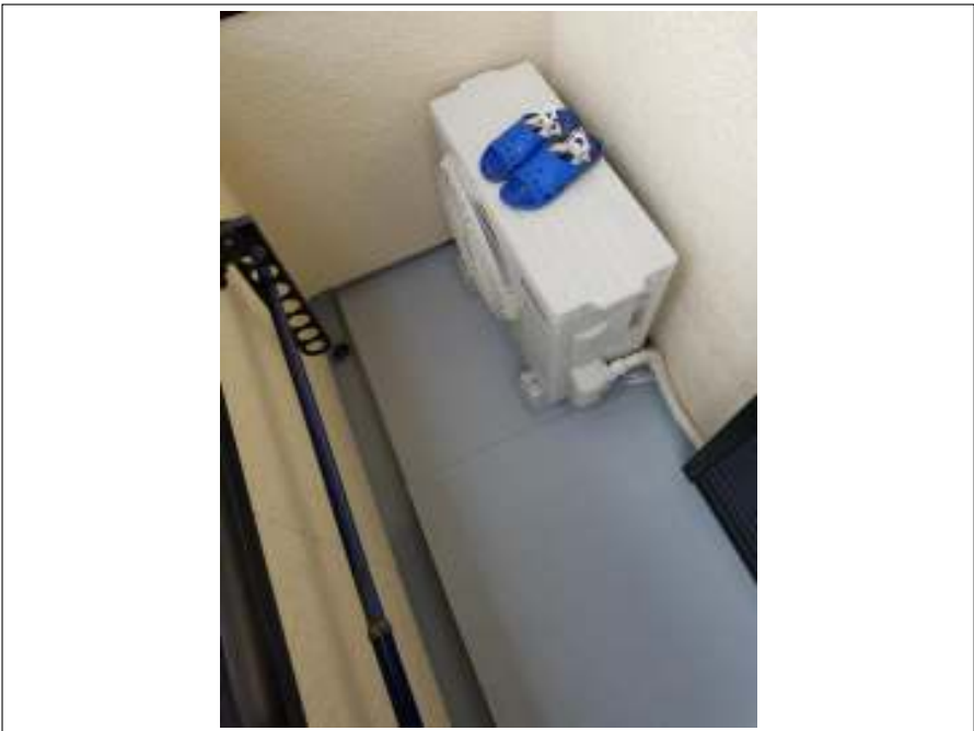
ベランダ 施工完了
