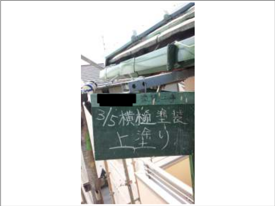
横樋 上塗り施工中
