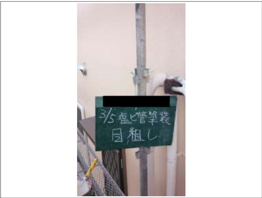
配管 ケレン施工中
