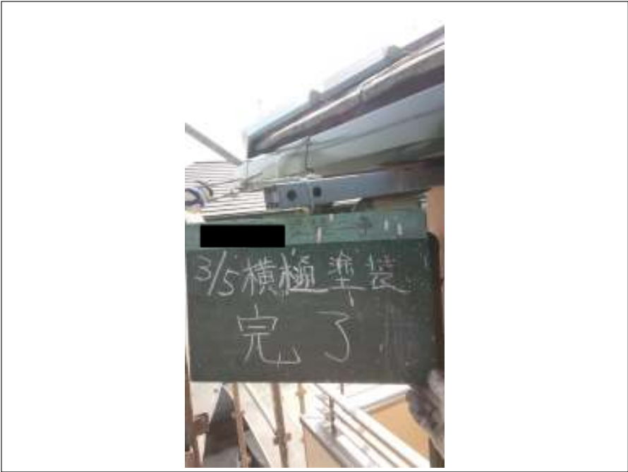
横樋 施工完了
