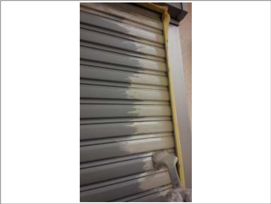
シャッター 施工中
