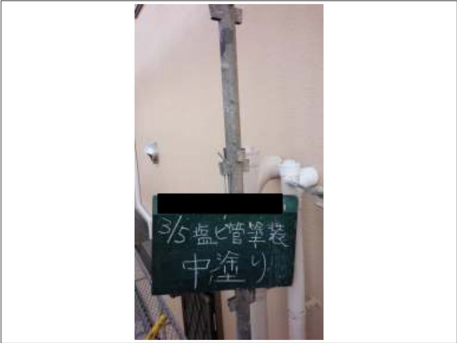
配管 中塗り施工中
