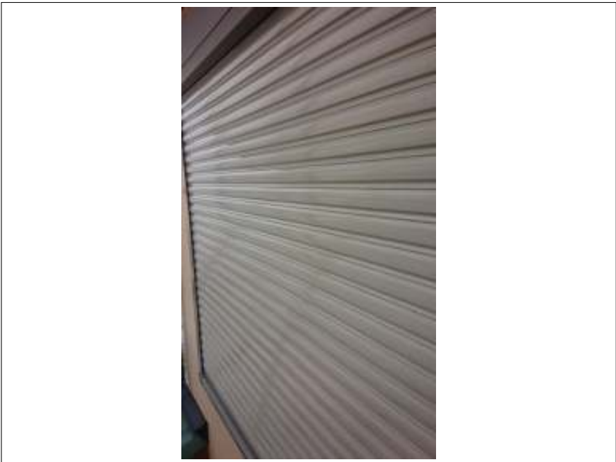
シャッター 施工完了
