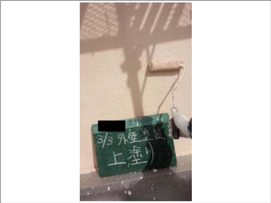
外壁 上塗り施工中
