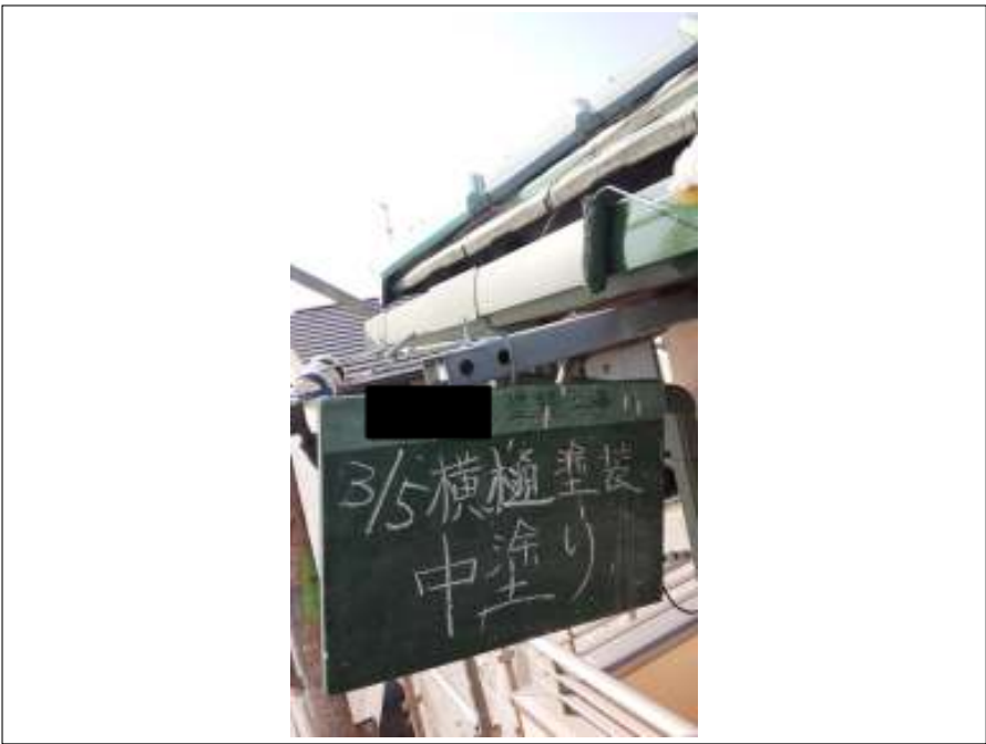
横樋 中塗り施工中
