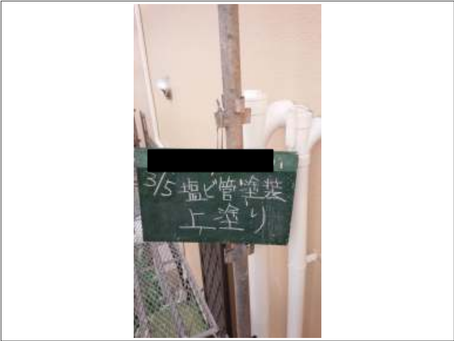
配管 上塗り施工中
