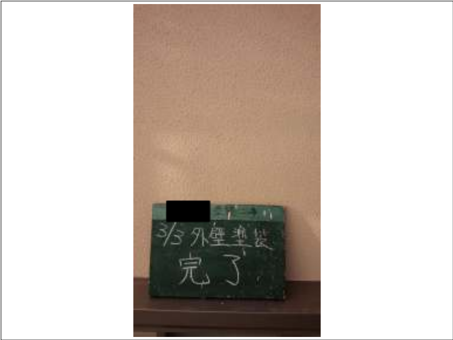
外壁 施工完了
