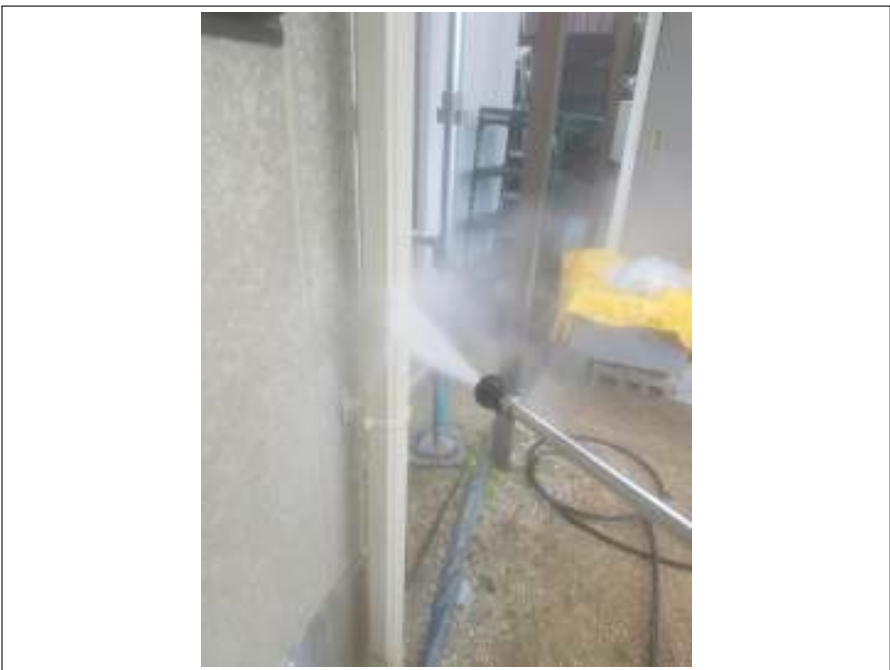
樋 高圧洗浄中
