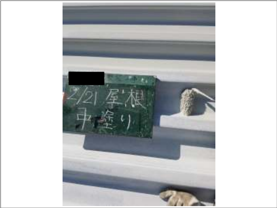
屋根 中塗り施工中
