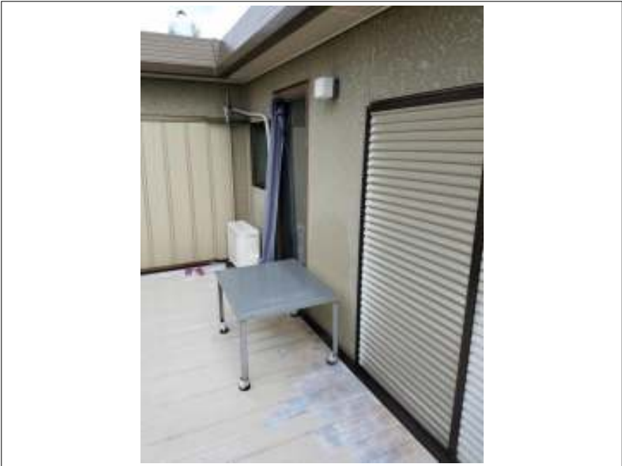
ベランダ 施工前
