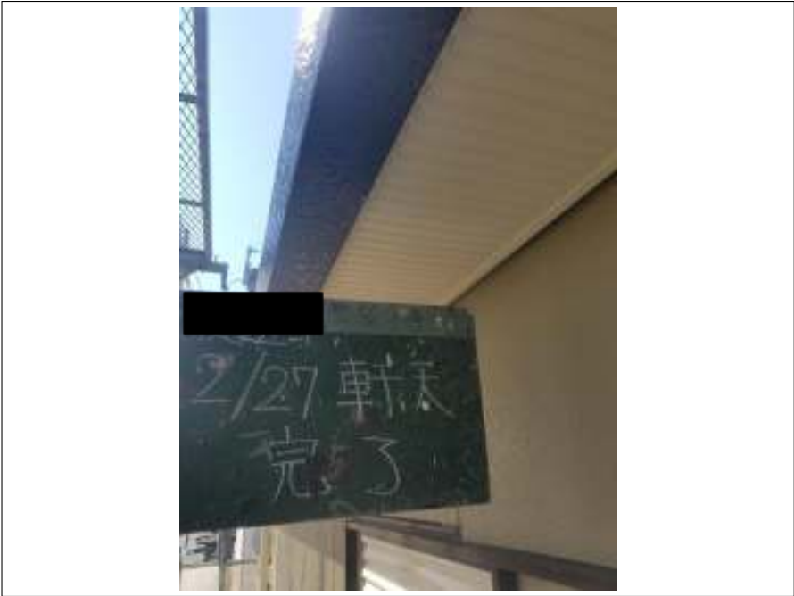
軒天 施工完了
