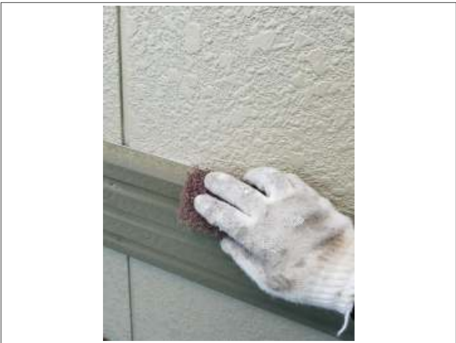
帯 ケレン処理施工中
