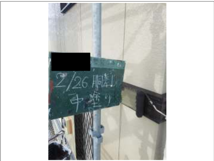
帯 上塗り（1回目）施工中
