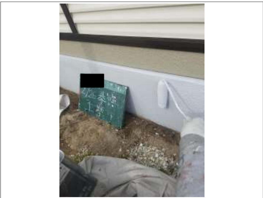
基礎 上塗り（2回目）施工中
