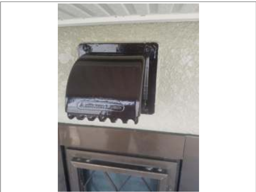
換気フード 施工完了
