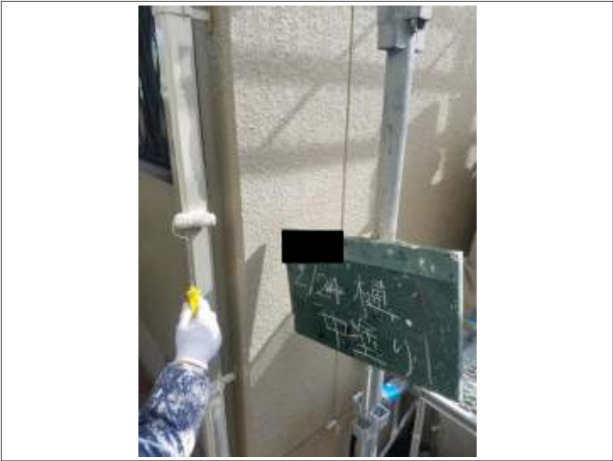
樋 上塗り（1回目）施工中
