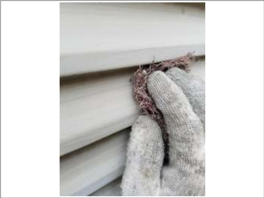
シャッター ケレン処理施工中
