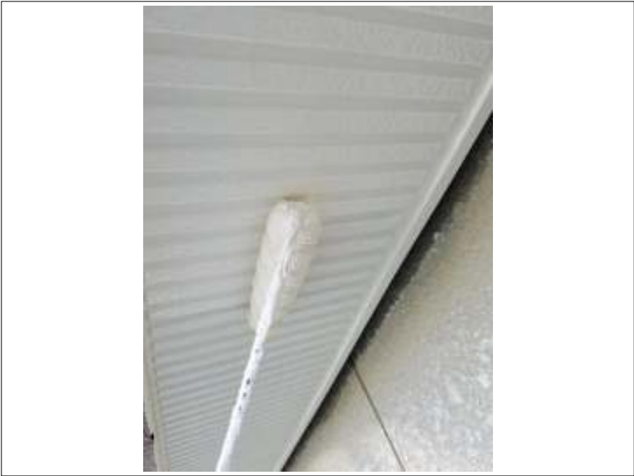
軒天 上塗り（2回目）施工中
