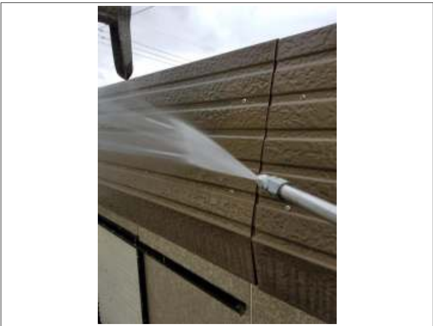
パラペット 高圧洗浄中
