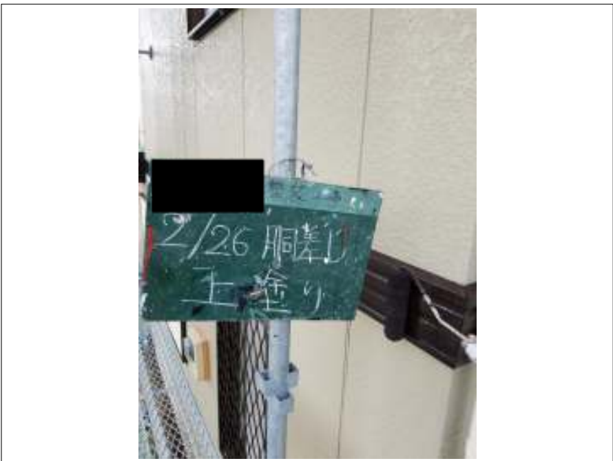
帯 上塗り（2回目）施工中
