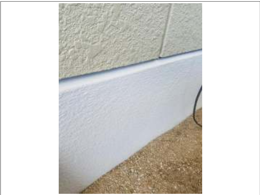
基礎 施工完了
