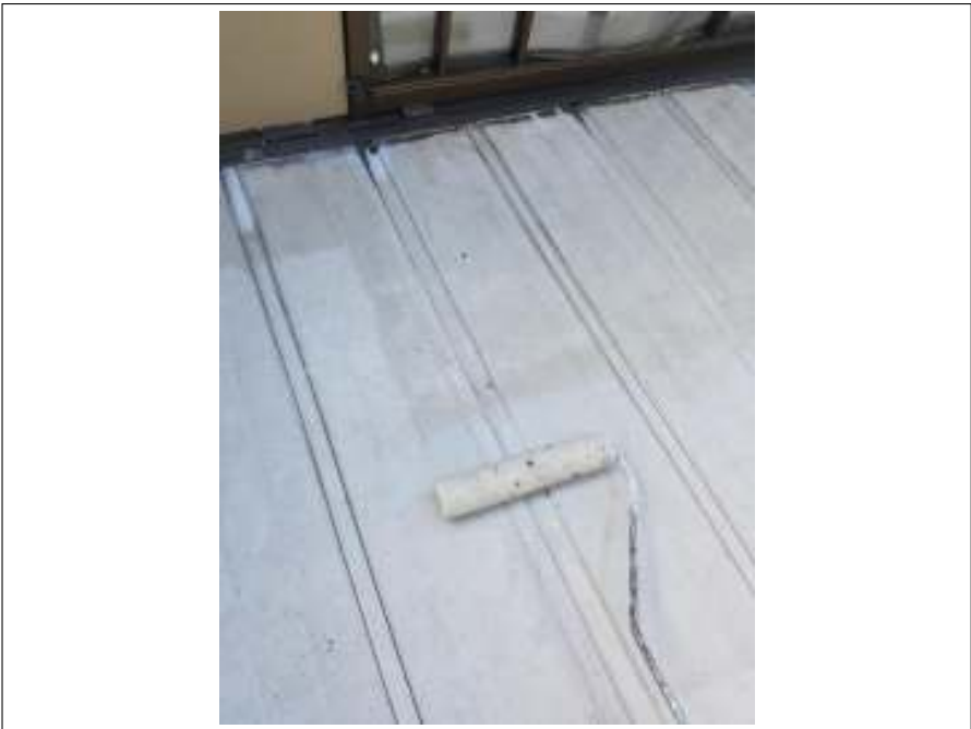
ベランダ 下塗り施工中
