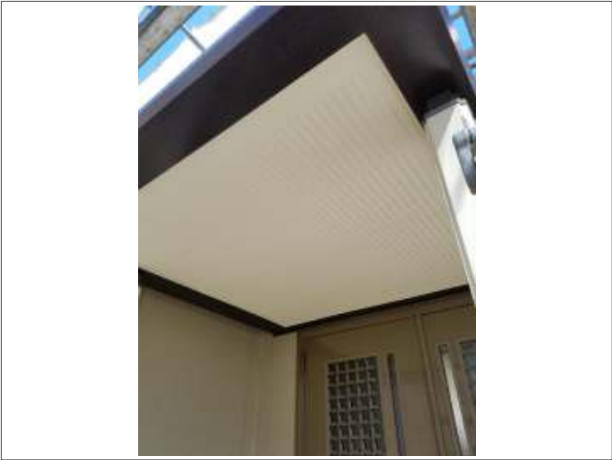
軒天 施工完了
