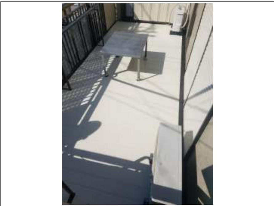
ベランダ 施工完了
