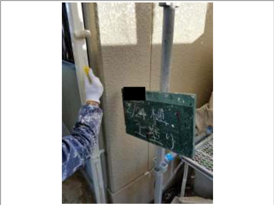
樋 上塗り (2回目) 施工中
