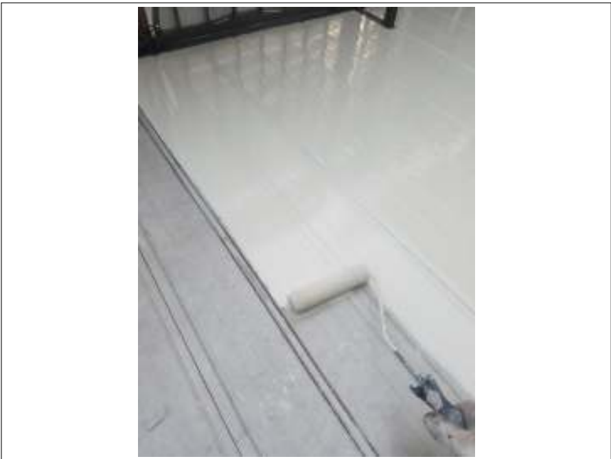
ベランダ 上塗り施工中
