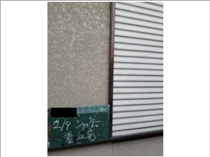
シャッター 施工前
