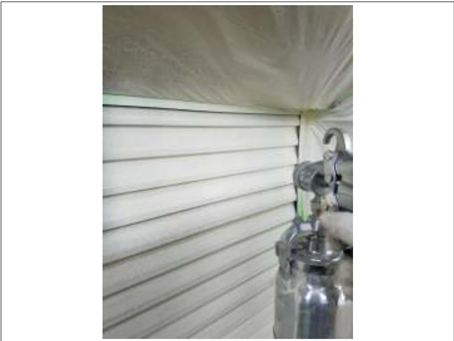
シャッター 上塗り(1回目) 施工中
