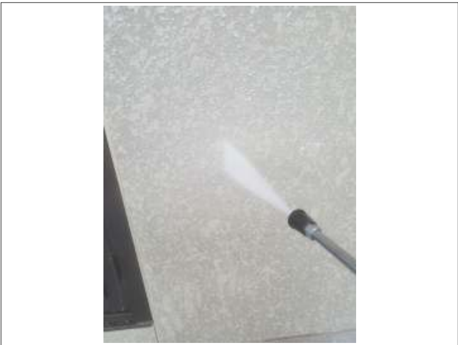
外壁 高圧洗浄中
