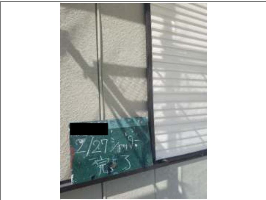
シャッター 施工完了
