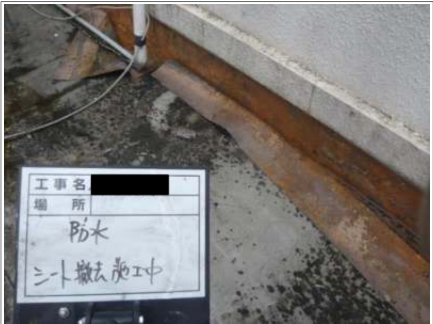
防水部 シート撤去施工中
