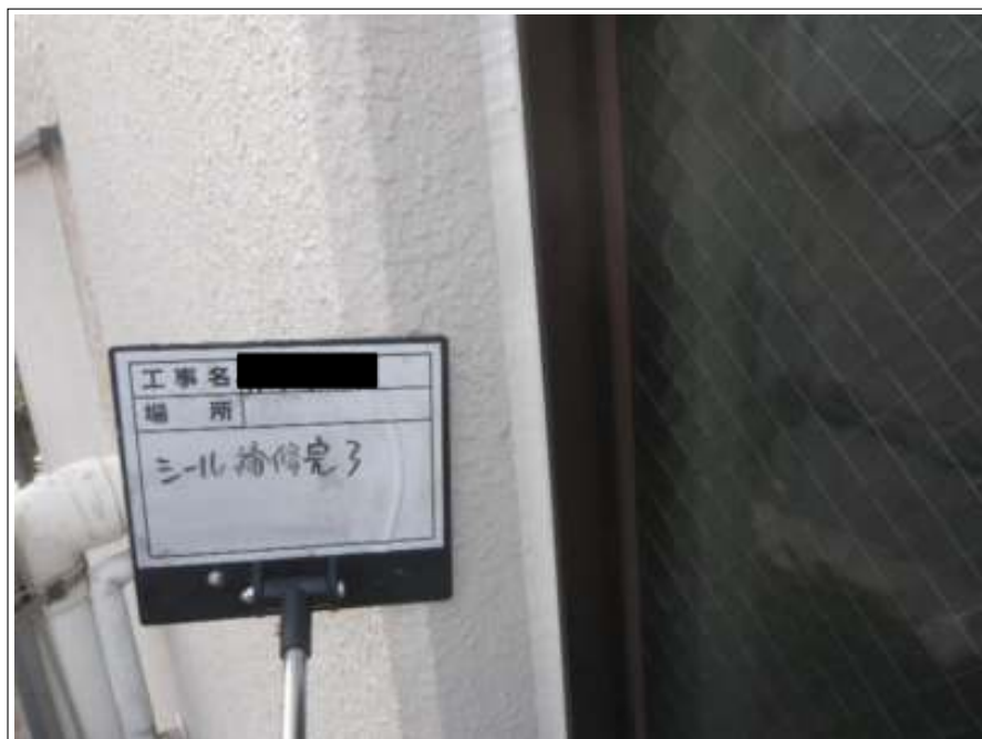
シーリング打ち替え施工後
