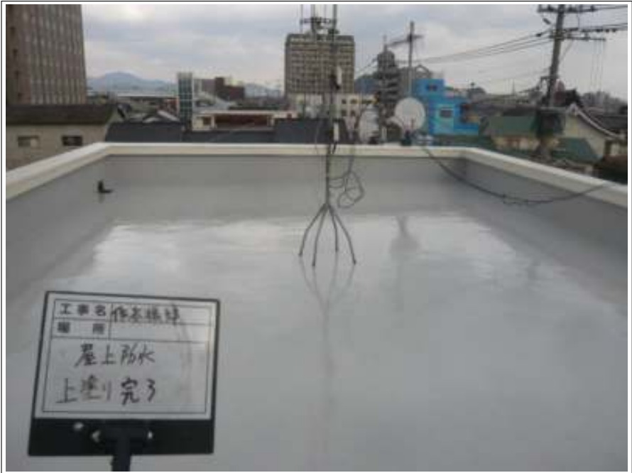
屋上防水 上塗り施工後
