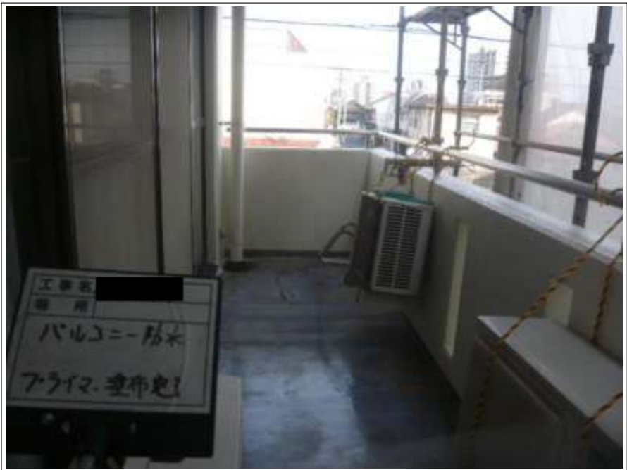
バルコニー防水 下塗り施工後
