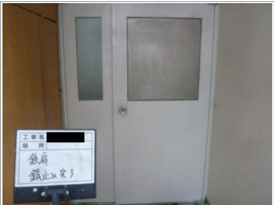
鉄扉 錆止め塗布施工後
