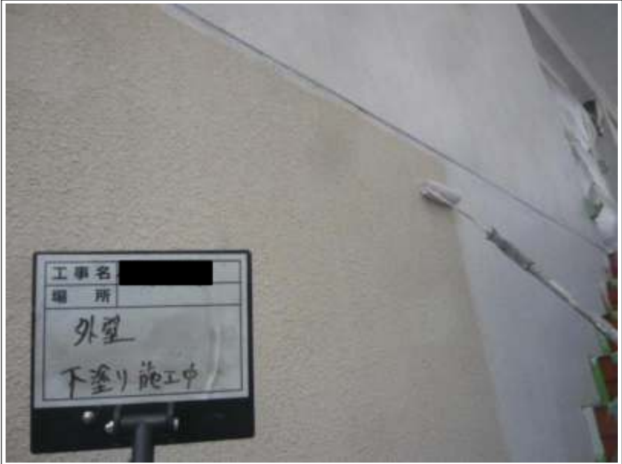
外壁 下塗り施工中
