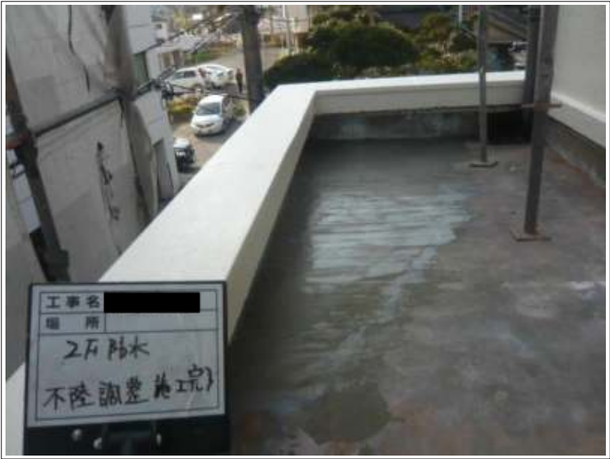
防水部 不陸調整施工後
