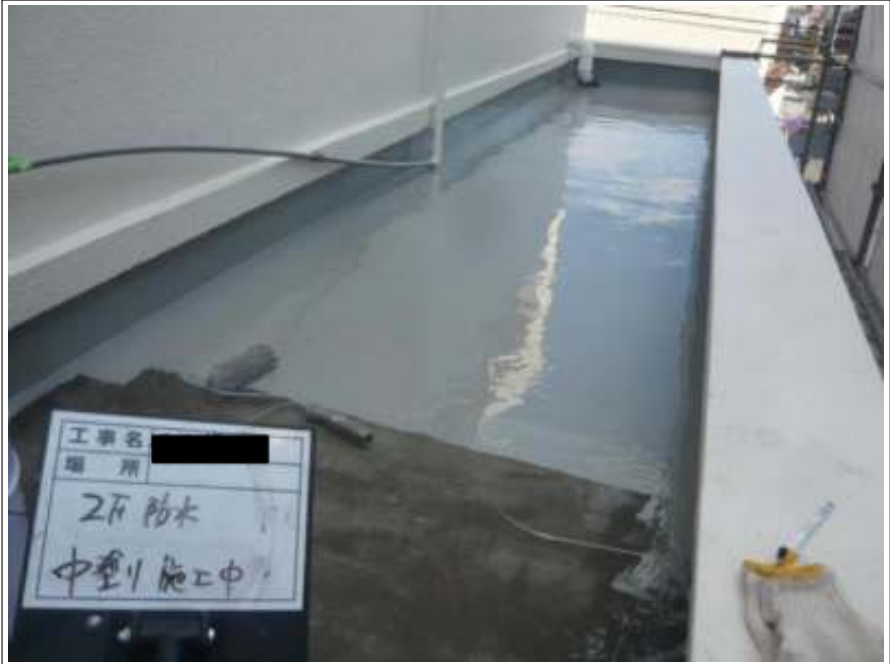
防水部 中塗り施工中
