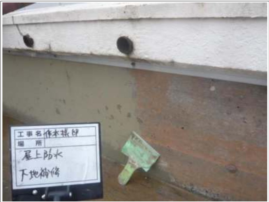
屋上防水 下地補修施工中
