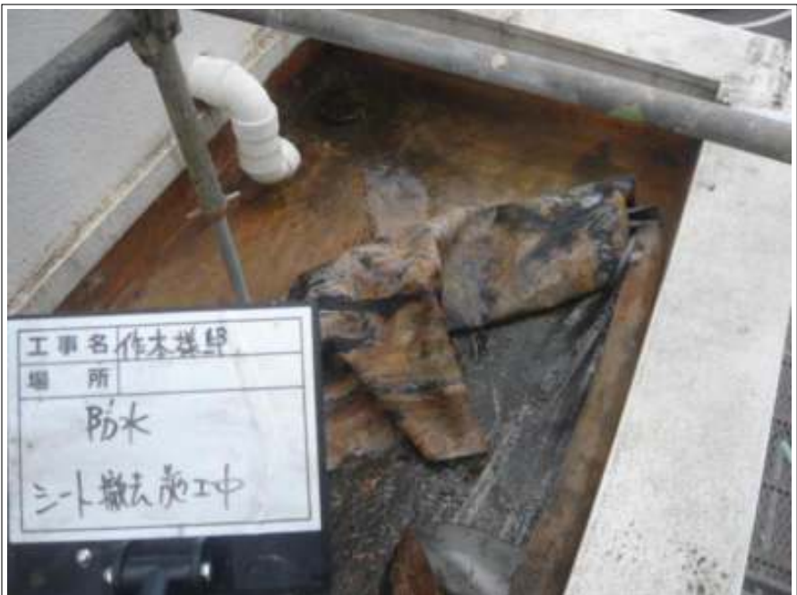
防水部 シート撤去施工中
