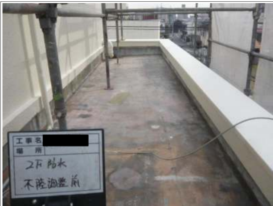
防水部 不陸調整施工前
