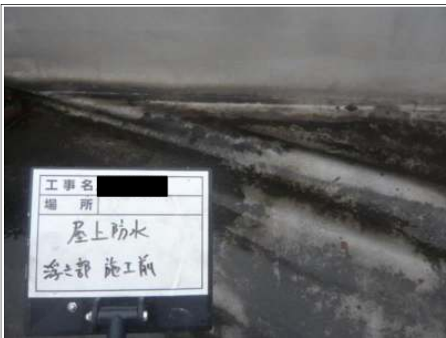
屋上防水 浮き部 施工前
