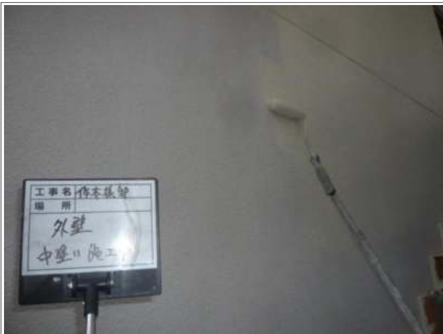
外壁 中塗り施工中
