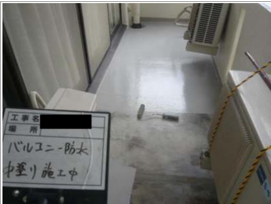
バルコニー防水 中塗り施工中
