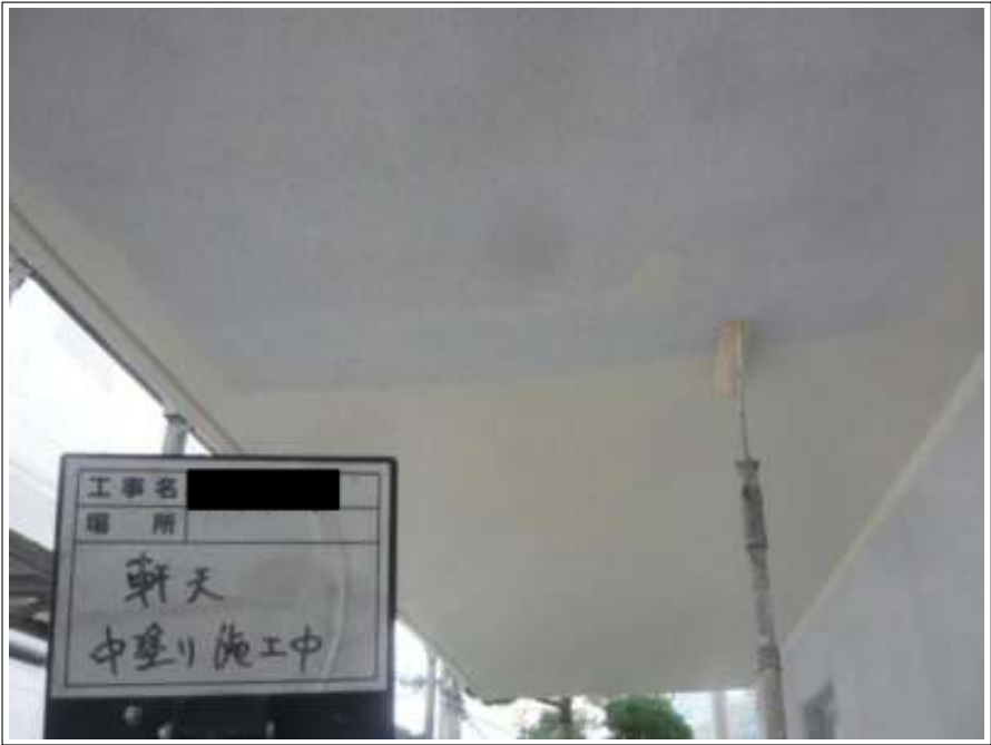
軒天 中塗り施工中
