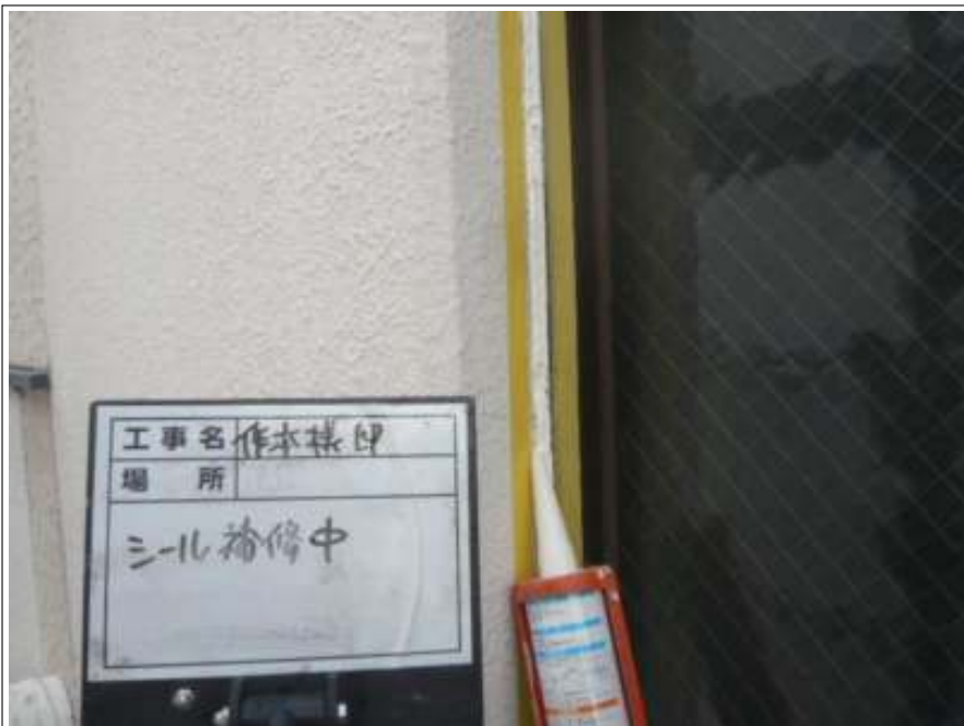
シーリング打ち替え施工中
