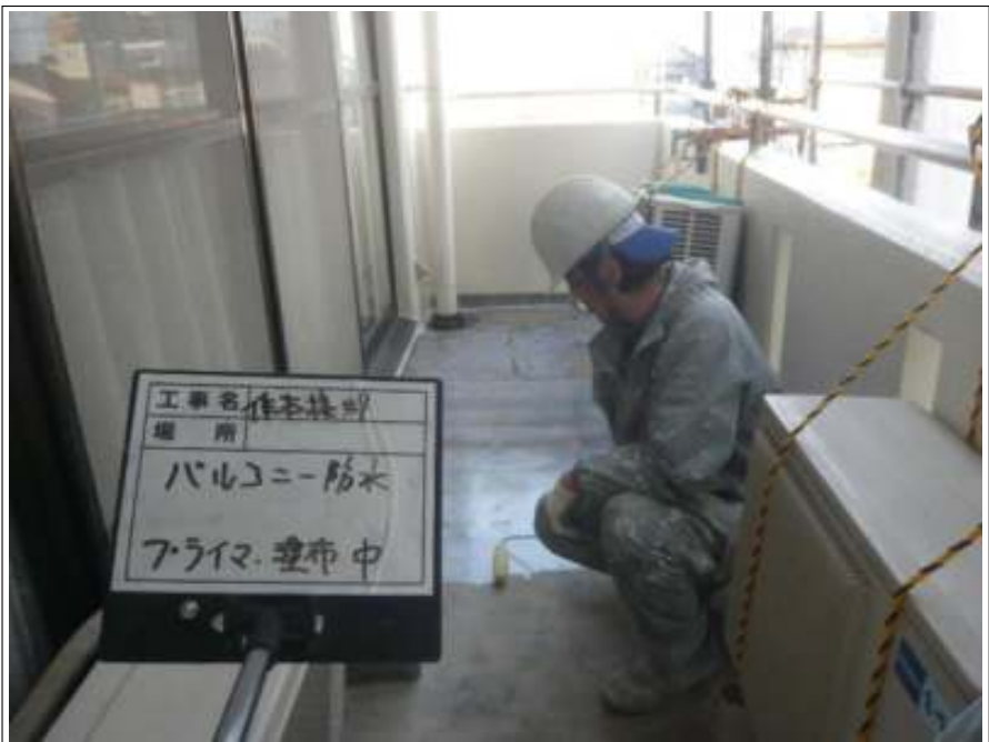
バルコニー防水 下塗り施工中
