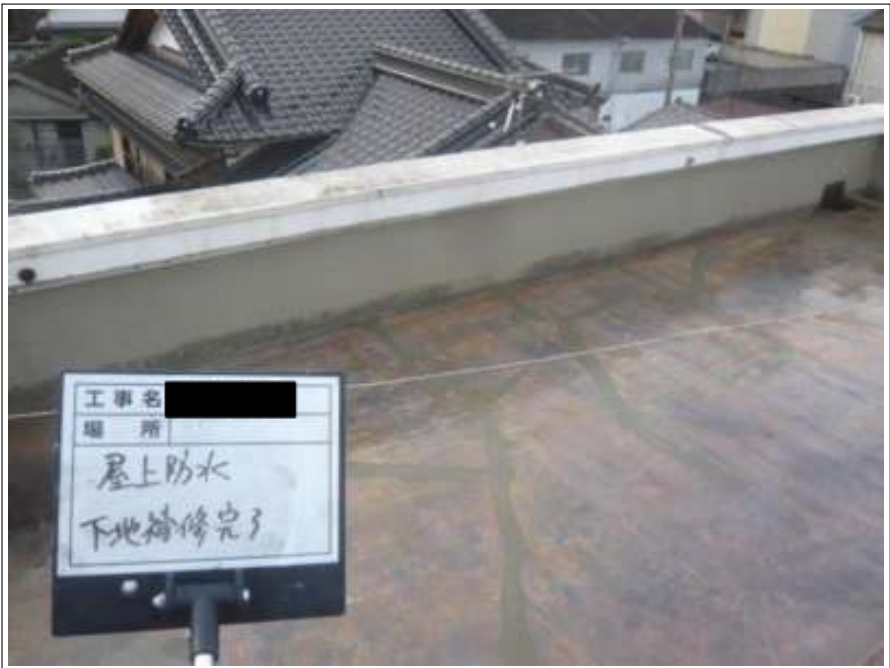
屋上防水 下地補修施工後
