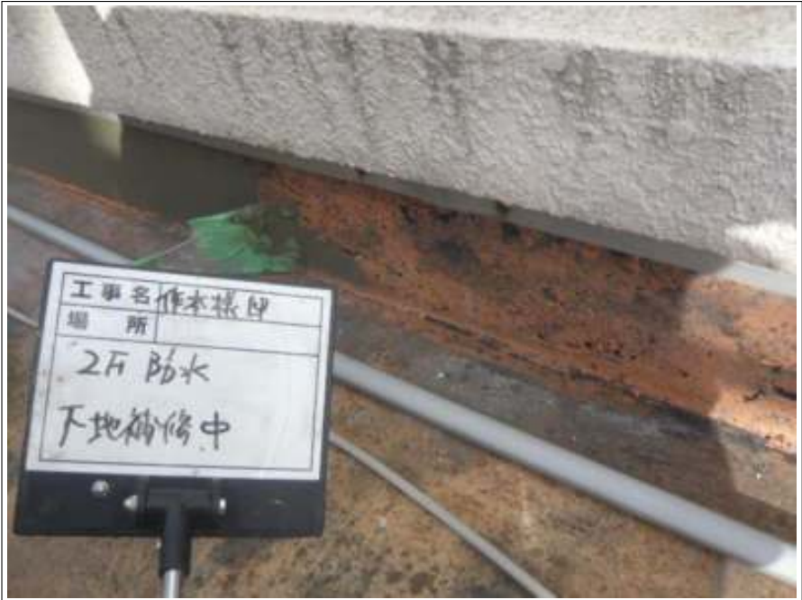
防水部 下地補修施工中
