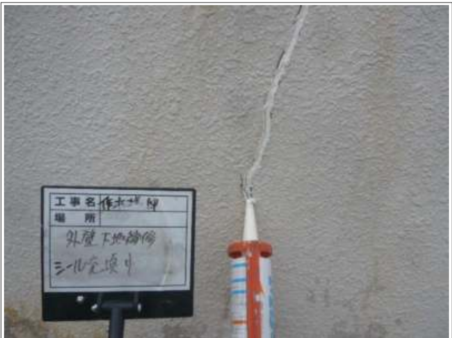
外壁 クラック補修施工中
