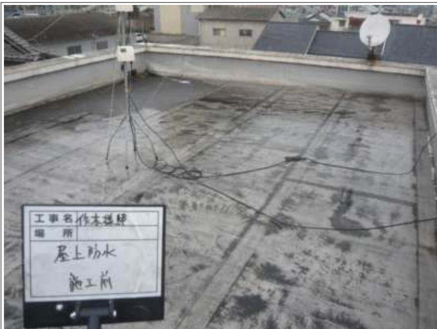
屋上防水 施工前
