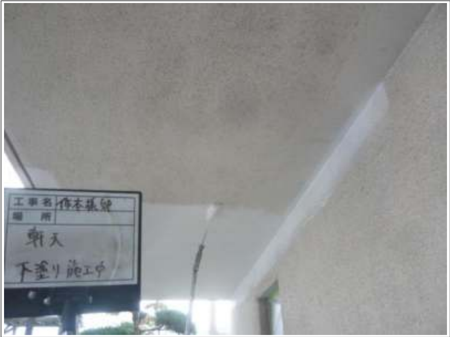
軒天 下塗り施工中
