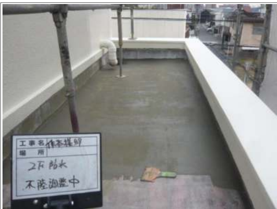
防水部 不陸調整施工中
