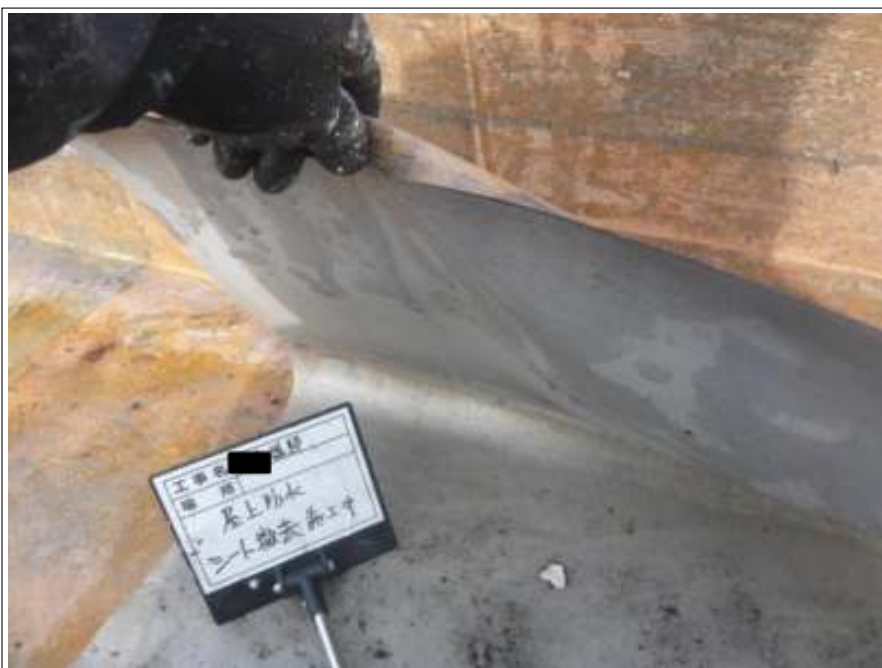
屋上防水 シート撤去施工中
