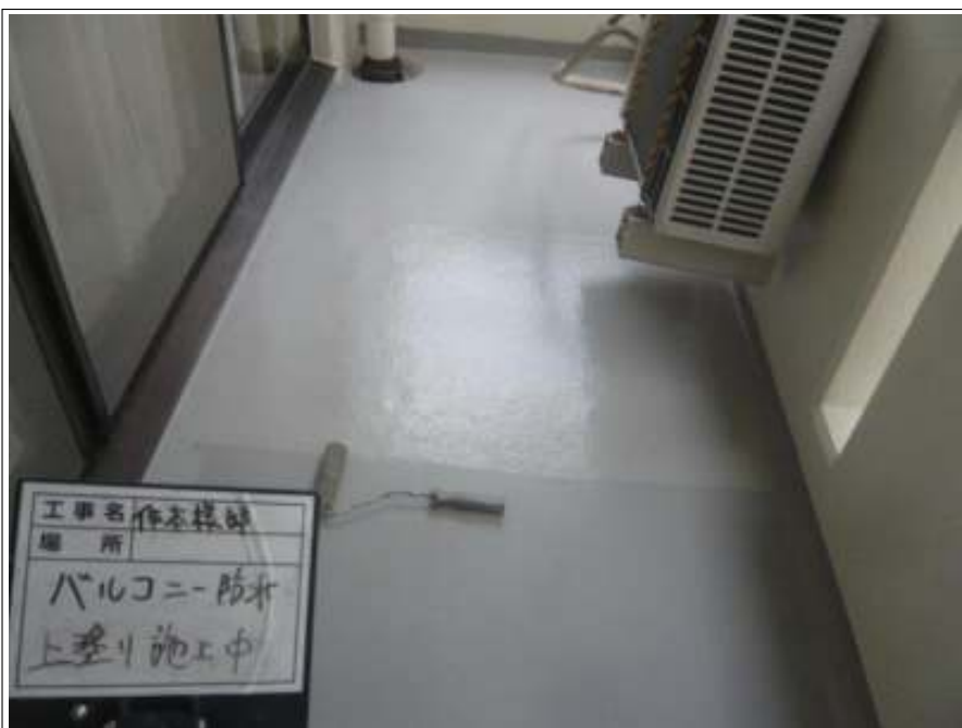
バルコニー防水 上塗り施工中
