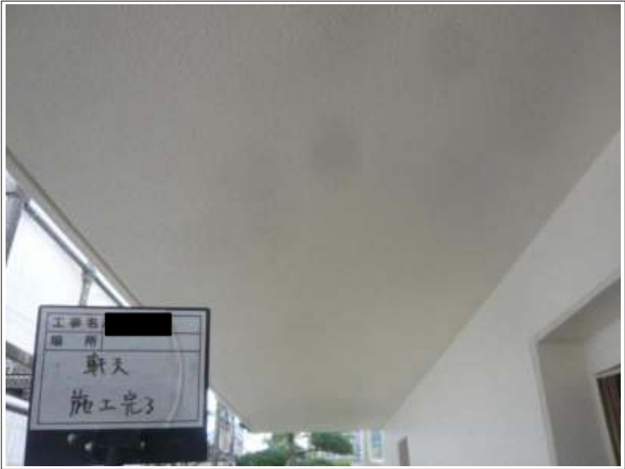
軒天 施工完了
