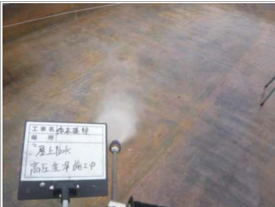
屋上防水 高圧洗浄中
