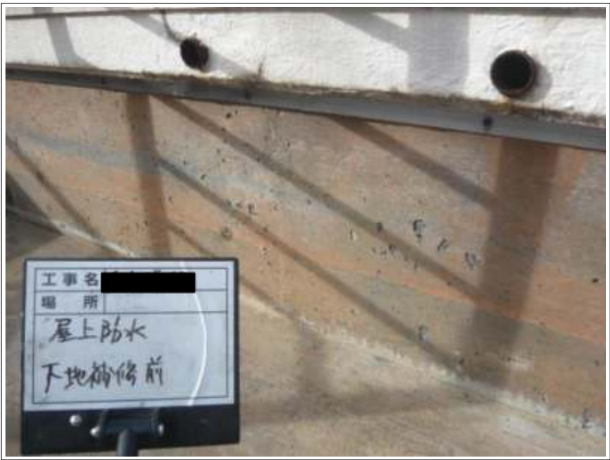
屋上防水 下地補修施工前
