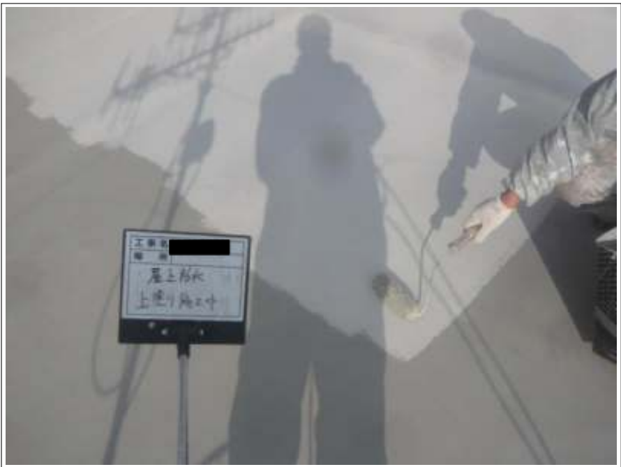
屋上防水 上塗り施工中
