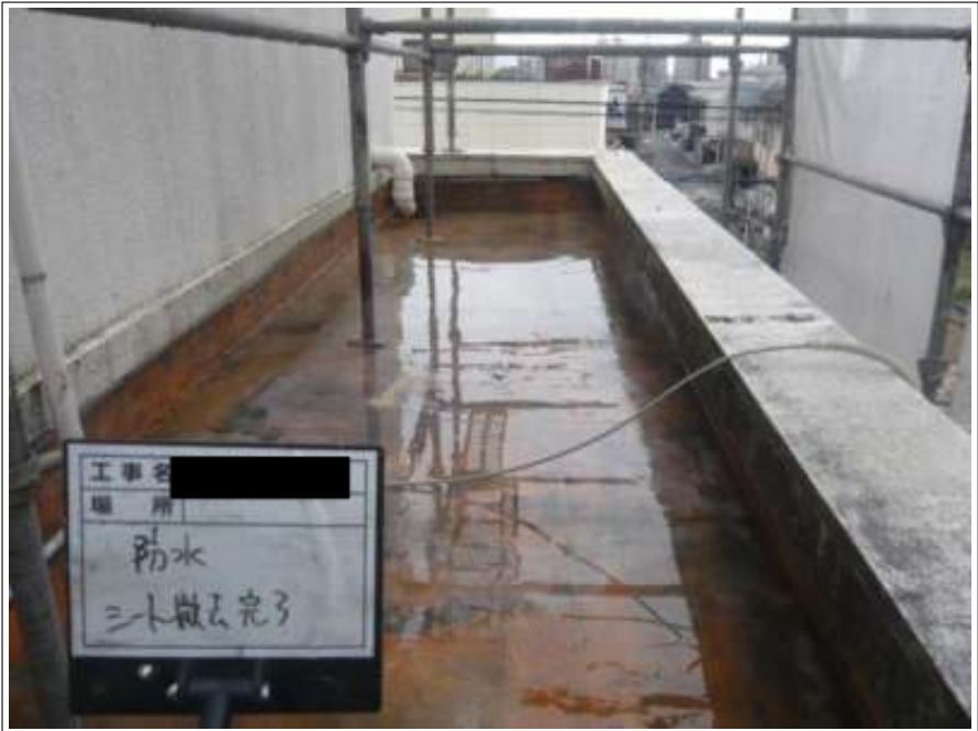
防水部 シート撤去施工後
