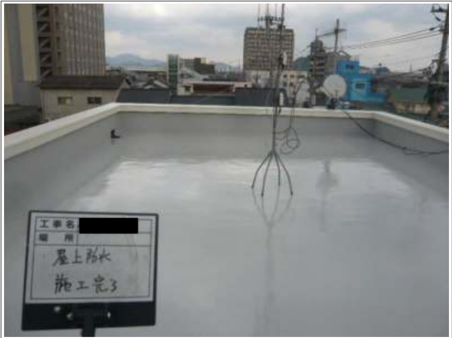
屋上防水 施工完了
