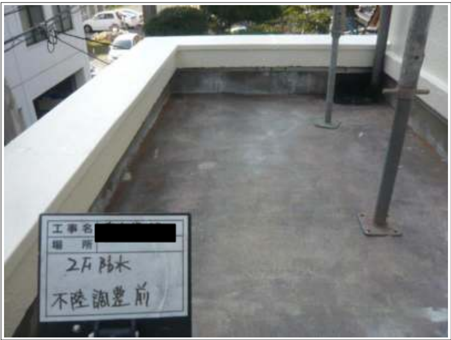
防水部 不陸調整施工前
