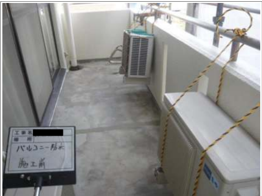
バルコニー防水 施工前
