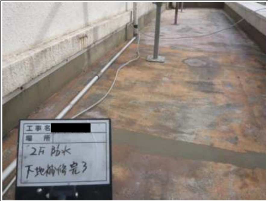
防水部 下地補修施工後
