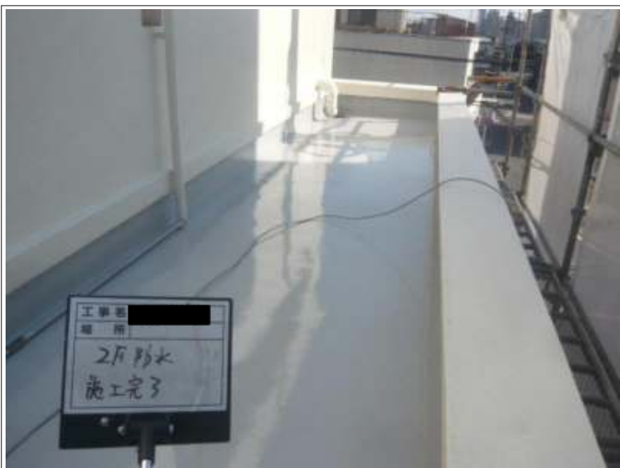
防水部 施工完了
