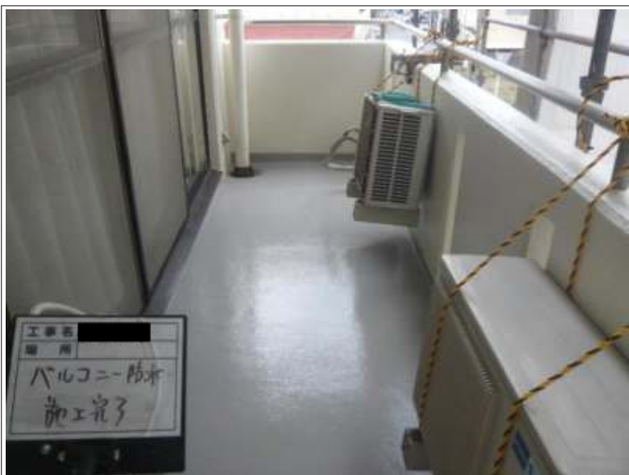
バルコニー防水 施工完了
