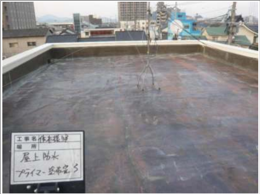
屋上防水 下塗り施工後
