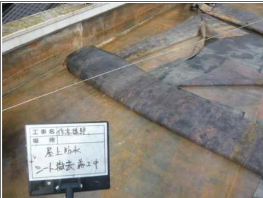
屋上防水 シート撤去施工中
