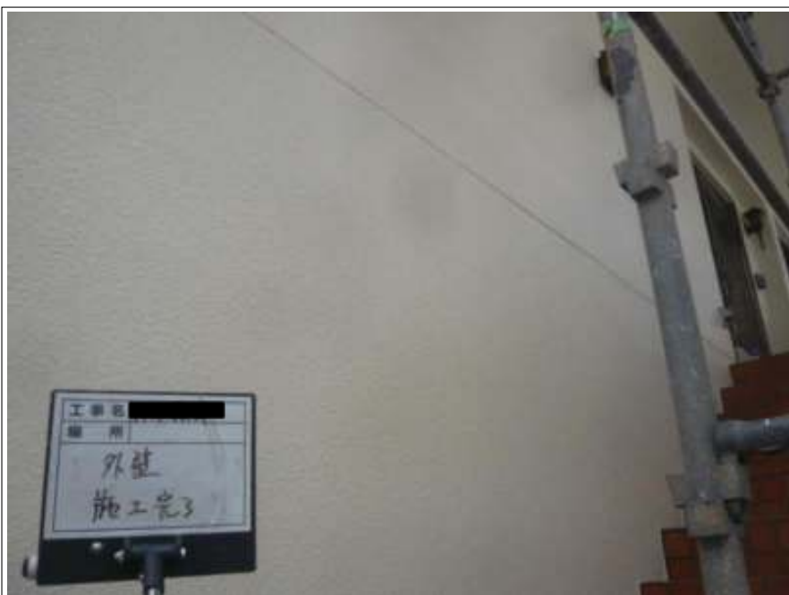
外壁 施工完了
