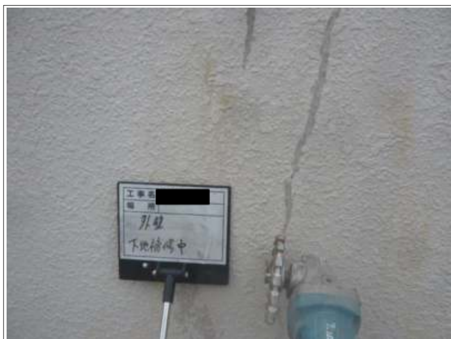
外壁 クラック補修施工中
