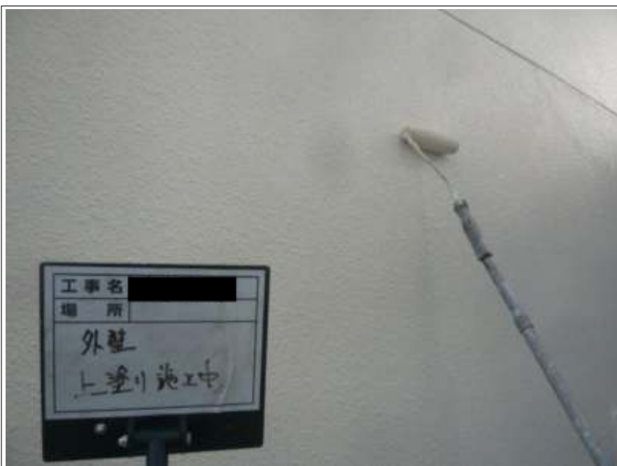
外壁 上塗り施工中
