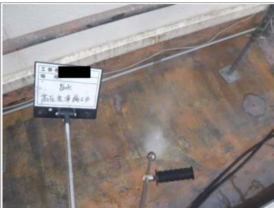
防水部 高圧洗浄中
