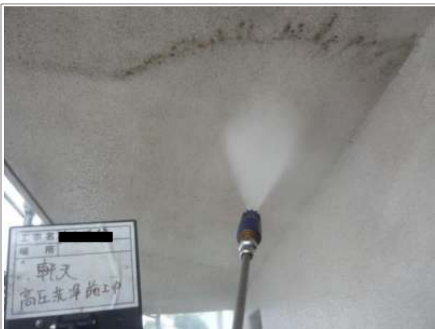
軒天 高圧洗浄中
