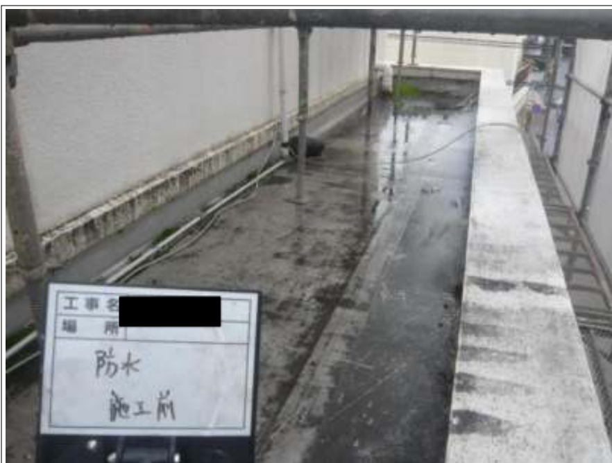
防水部 施工前
