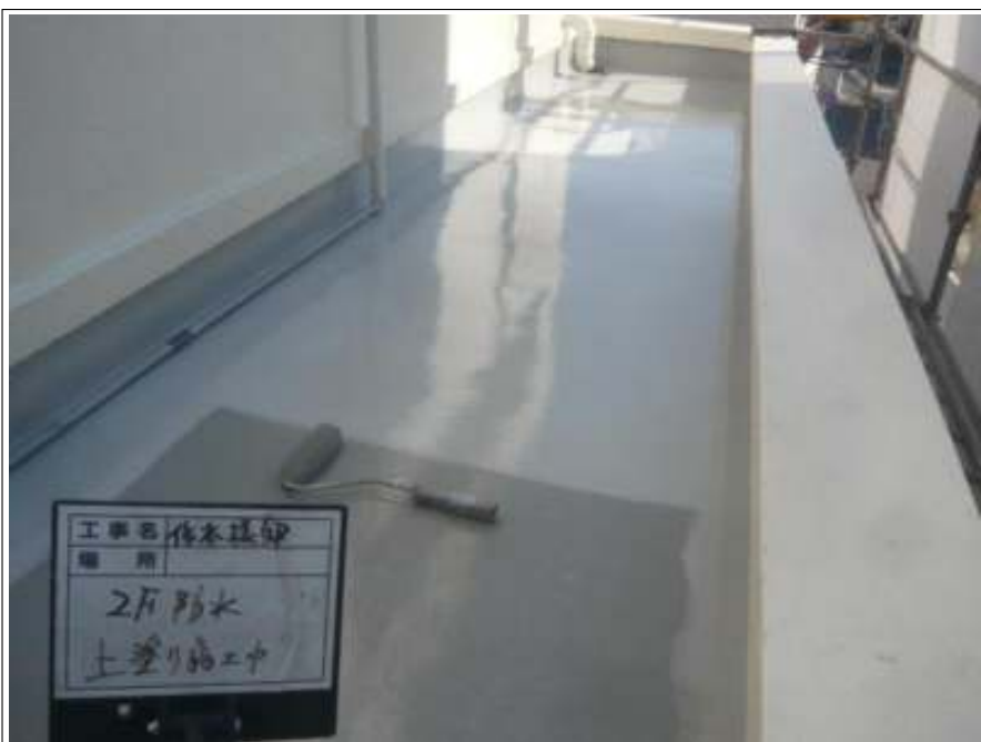
防水部 上塗り施工中
