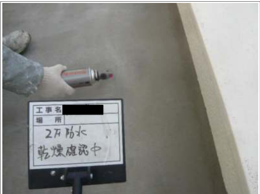
防水部 乾燥確認中
