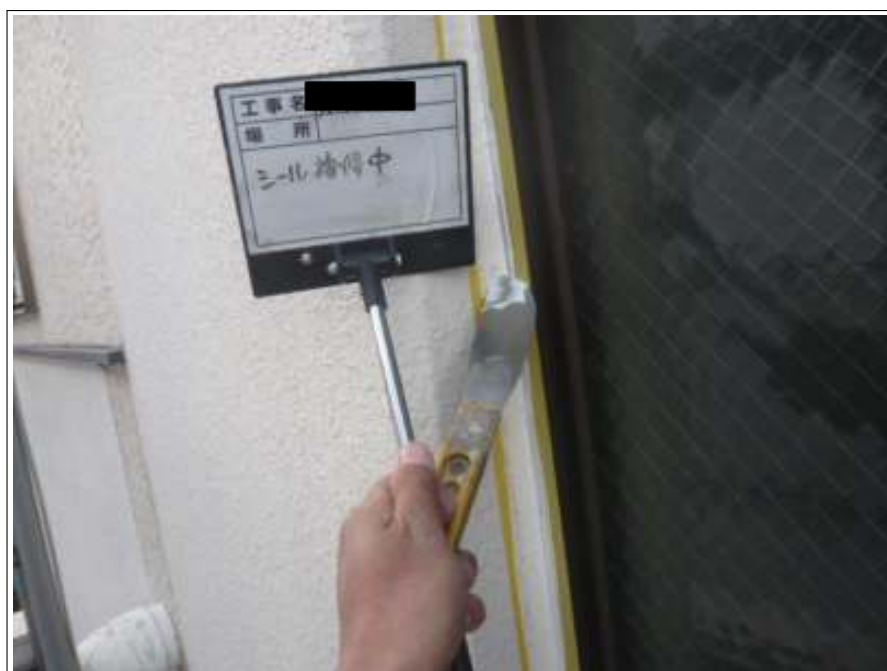
シーリング打ち替え施工中
