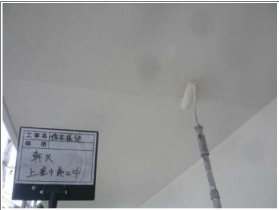
軒天 上塗り施工中
