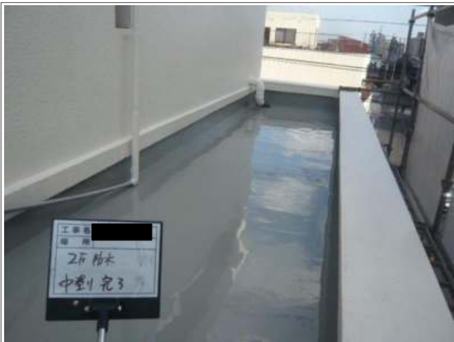
防水部 中塗り施工後
