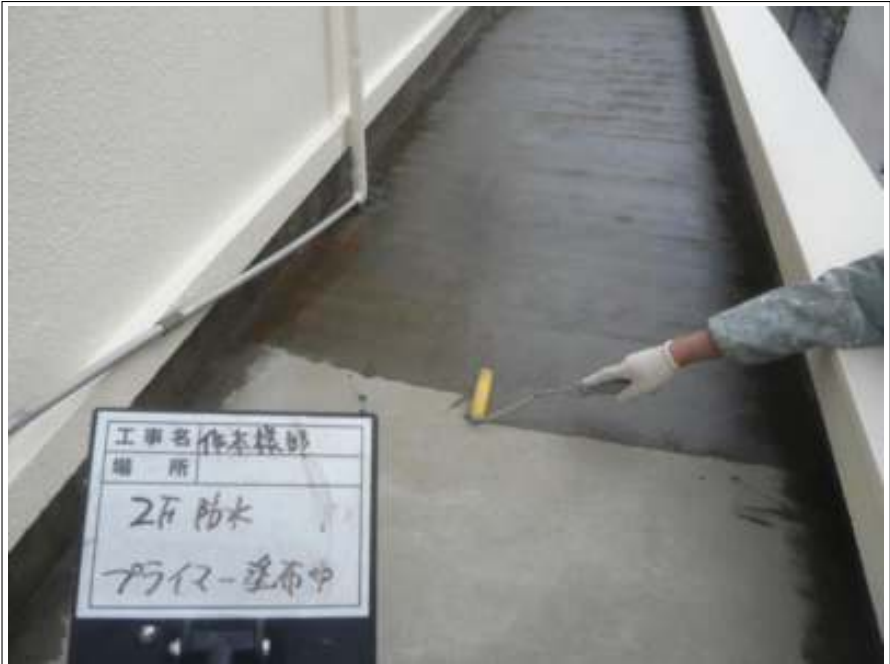
防水部 下塗り施工中
