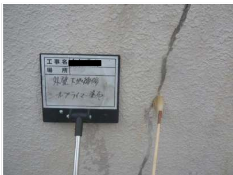
外壁 クラック補修施工中
