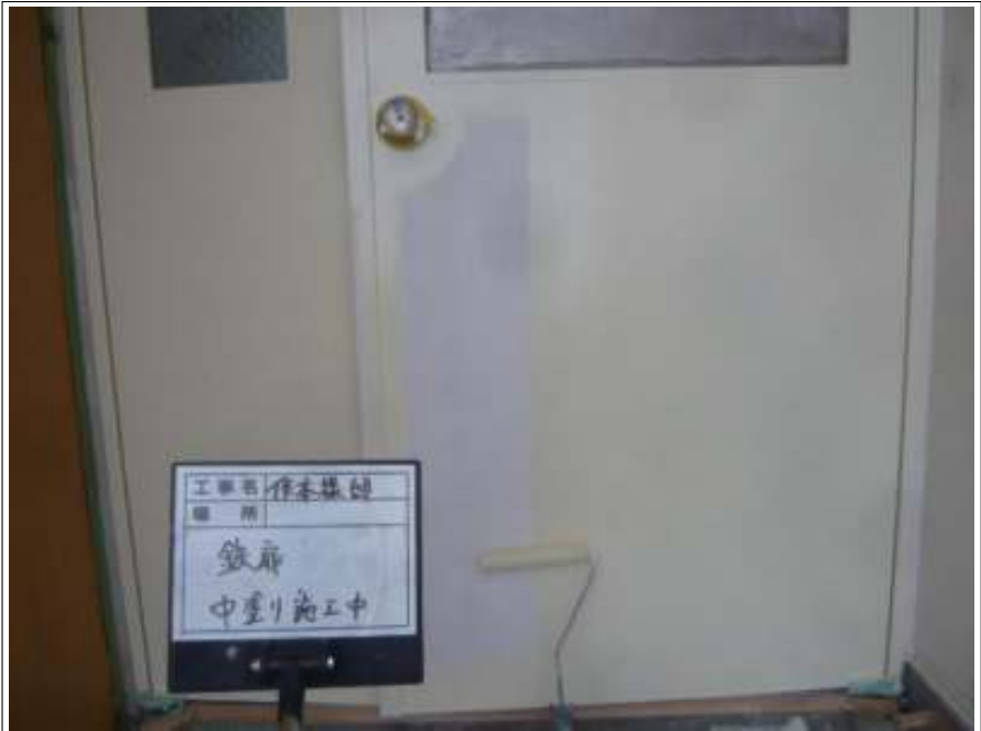
鉄扉 中塗り施工中
