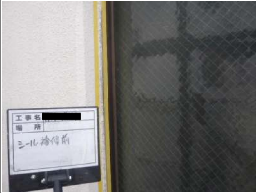
シーリング打ち替え施工前
