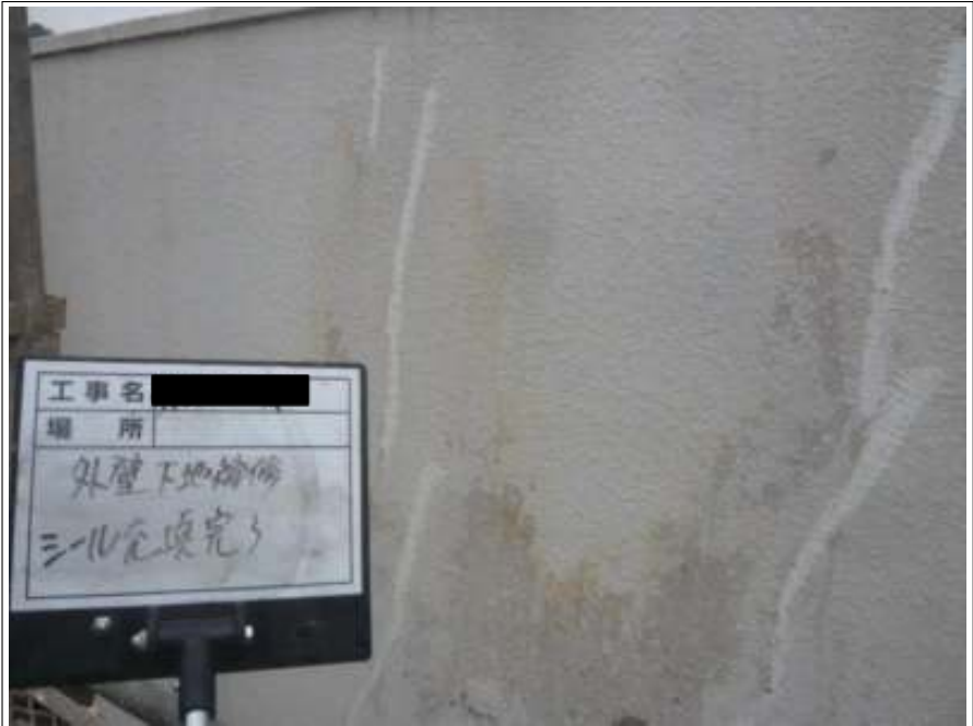
外壁 クラック補修施工後
