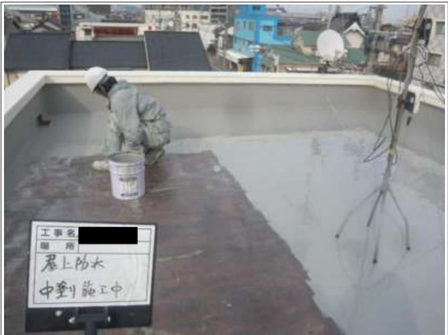
屋上防水 中塗り施工中
