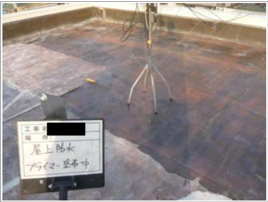
屋上防水 下塗り施工中
