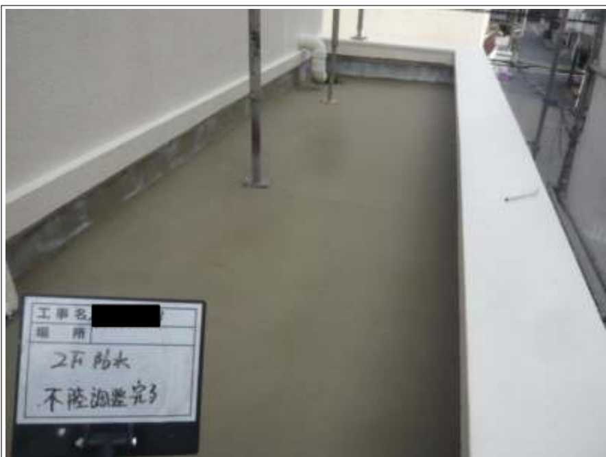
防水部 不陸調整施工後
