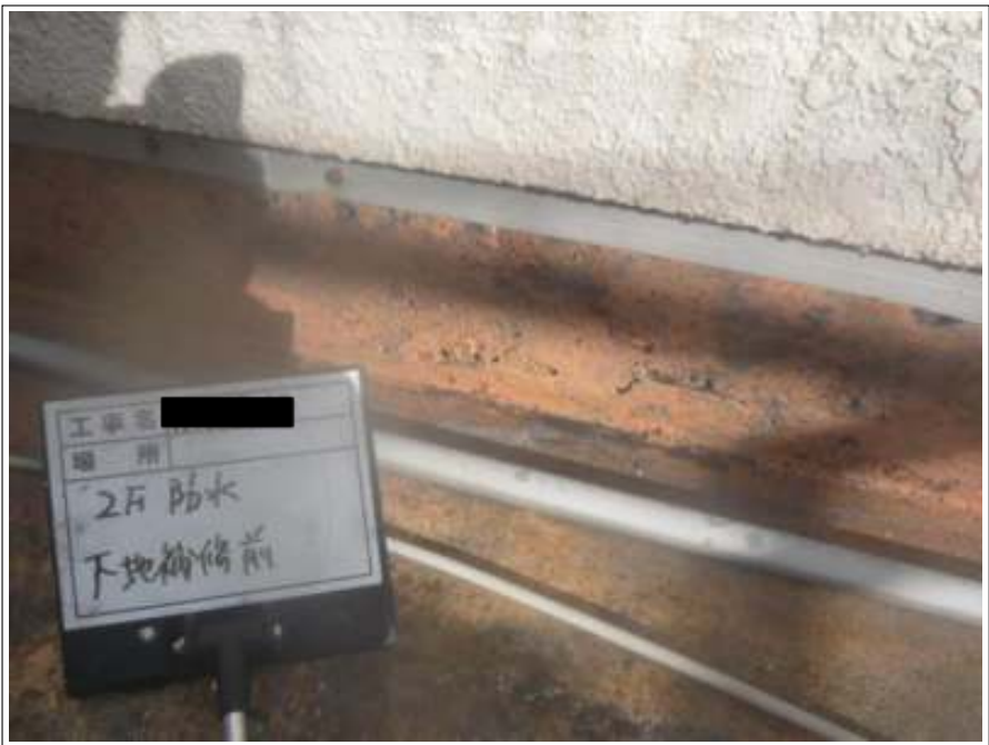
防水部 下地補修施工前
