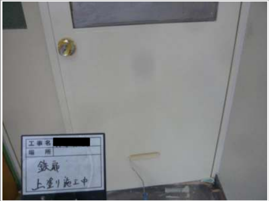
鉄扉 上塗り施工中
