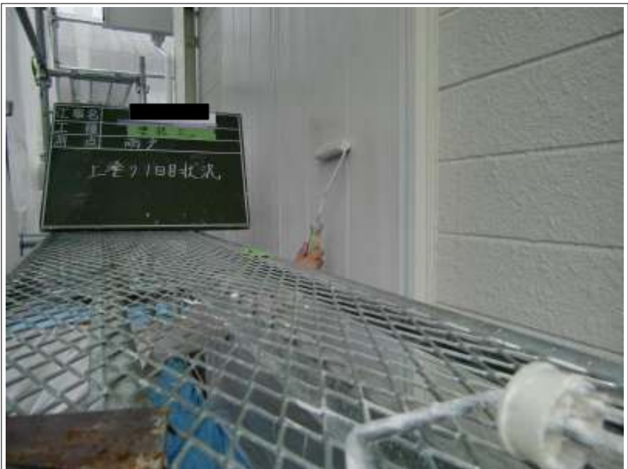
雨戸 上塗り（1回目）施工中
