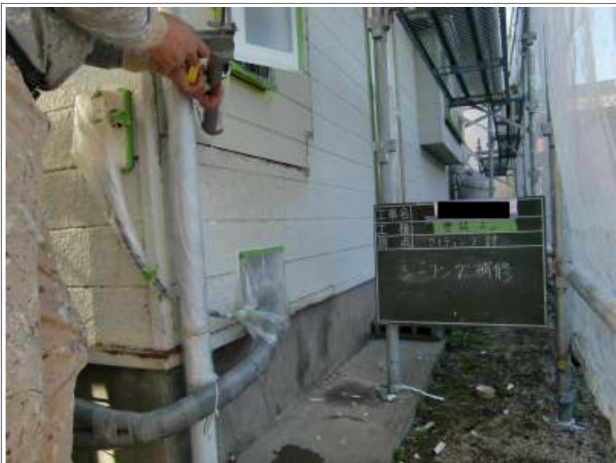
外壁 シーリング補修施工中
