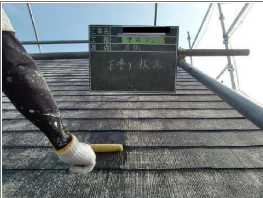
屋根 下塗り施工中
