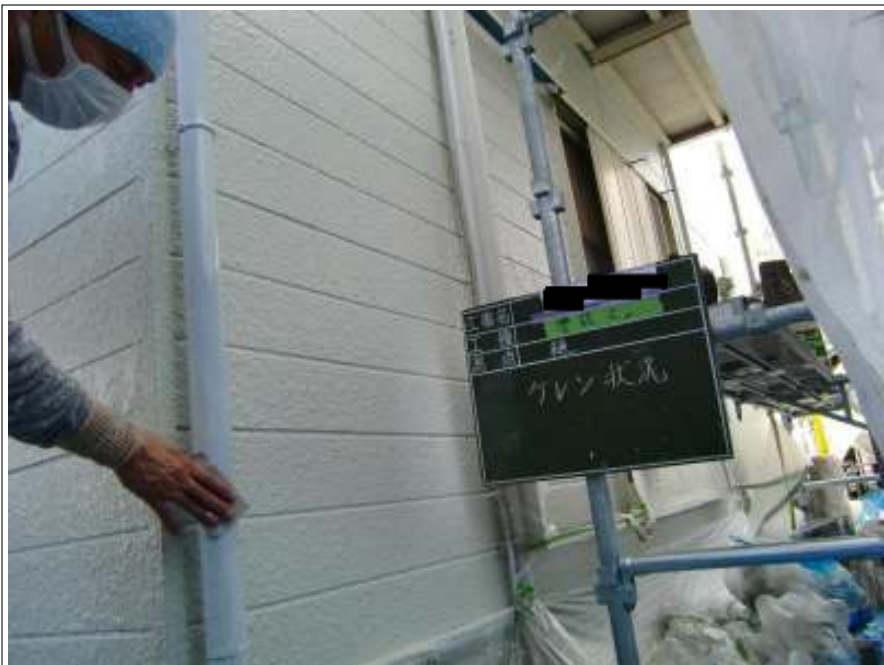
樋 ケレン処理施工中
