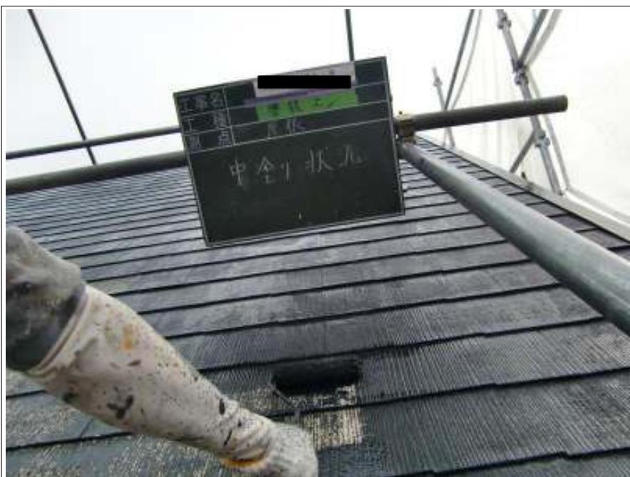
屋根 中塗り施工中
