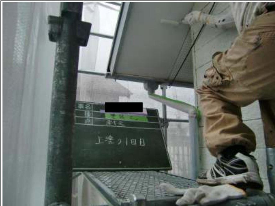
軒天 上塗り（1回目）施工中
