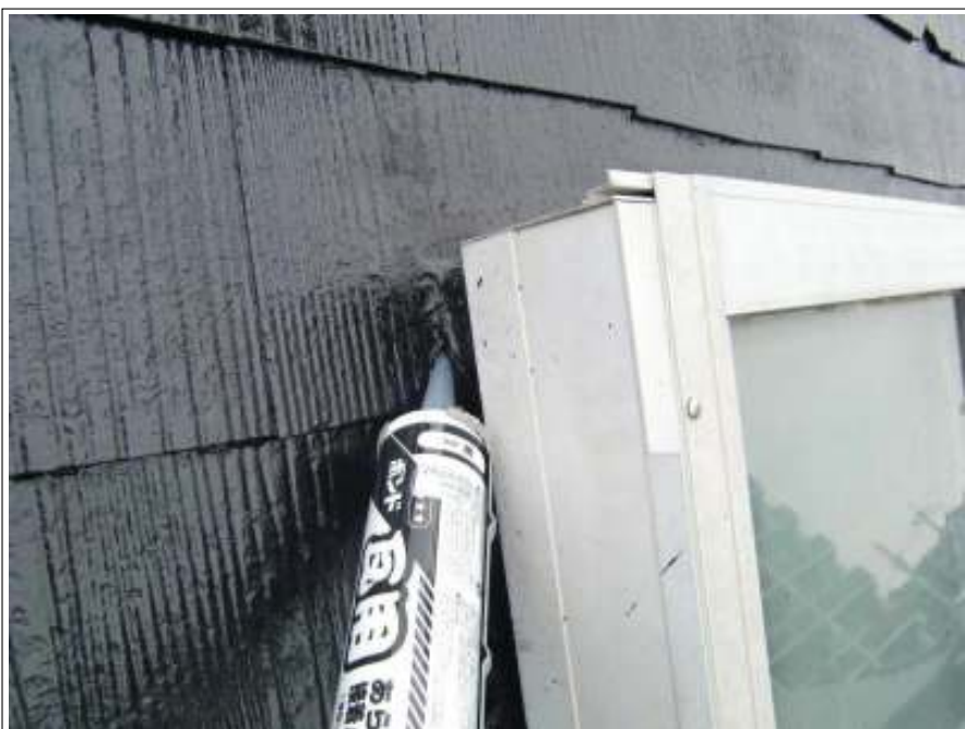
屋根 シーリング補修施工中
