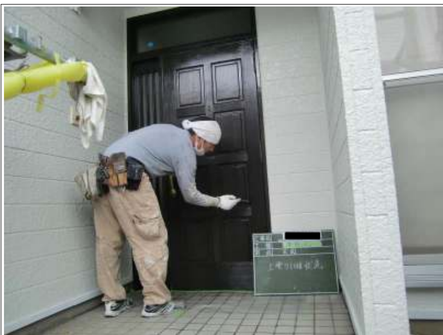
玄関ドア 上塗り（1回目）施工中
