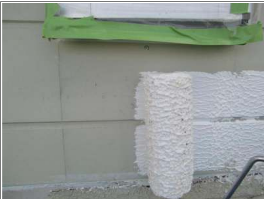
外壁 補修塗り施工中
