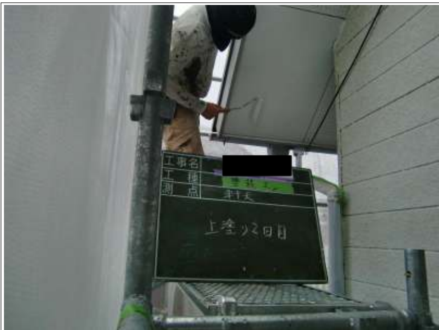
軒天 上塗り（2回目）施工中
