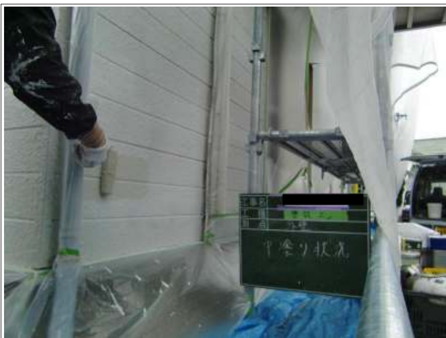
外壁 中塗り施工中
