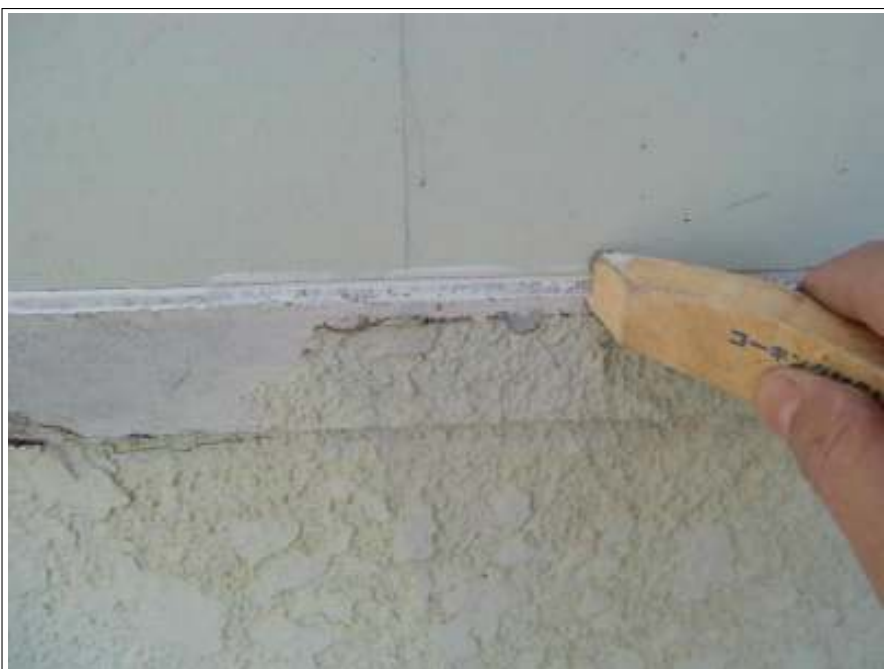
外壁 シーリング補修施工中
