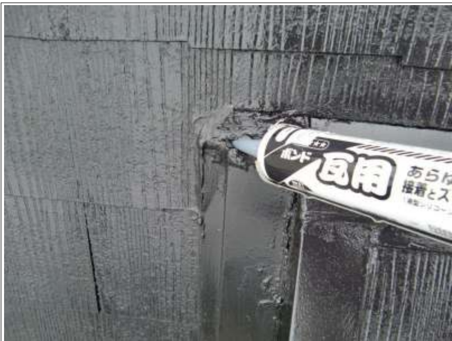
屋根 クラック補修施工中
