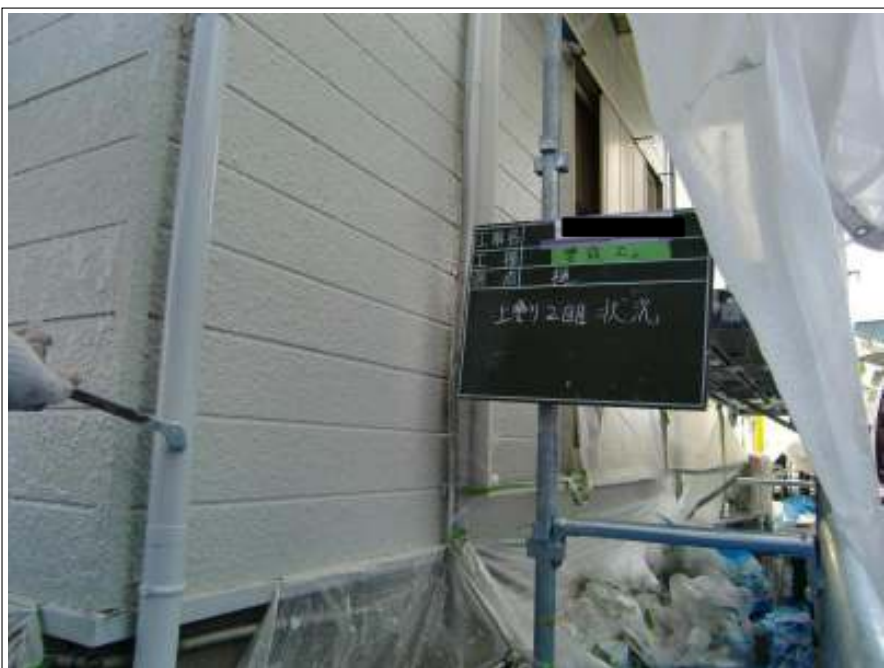
樋 上塗り（2回目）施工中
