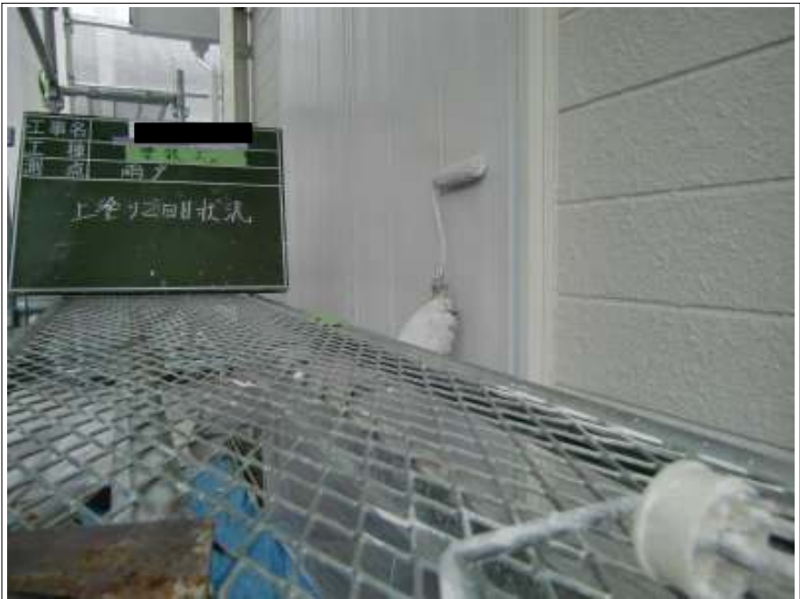
雨戸 上塗り（2回目）施工中
