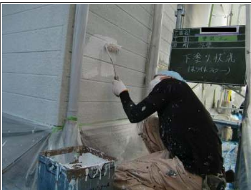
外壁 下塗り施工中
