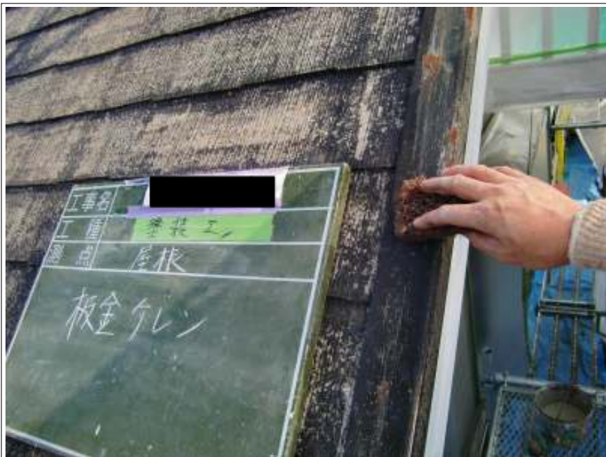
屋根板金 ケレン処理施工中
