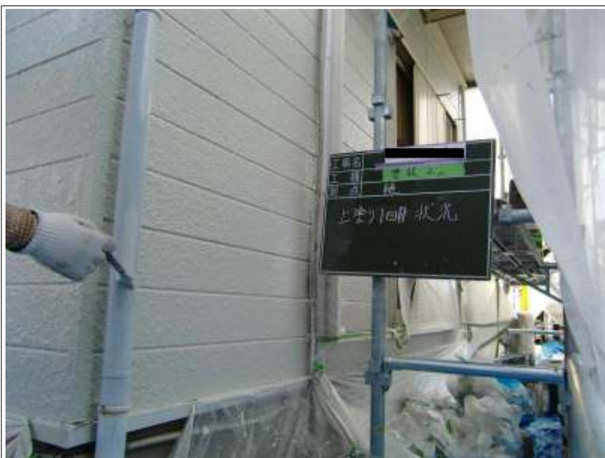
樋 上塗り（1回目）施工中
