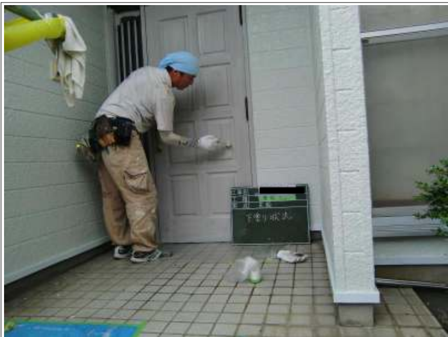
玄関ドア 下塗り施工中
