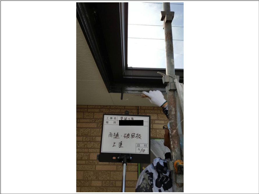
破風板・樋 上塗り施工中
