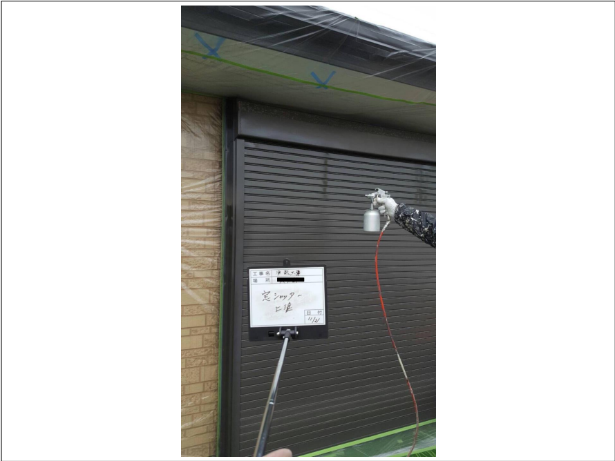
シャッター 上塗り施工中
