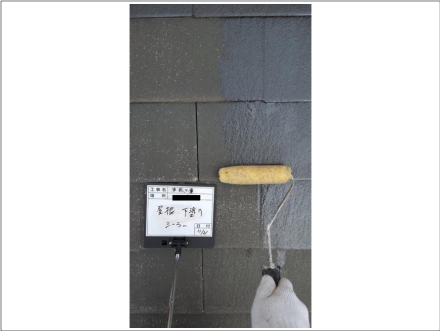
屋根 下塗り施工中
