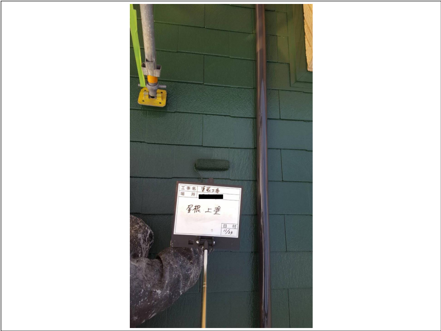
屋根 上塗り施工中
