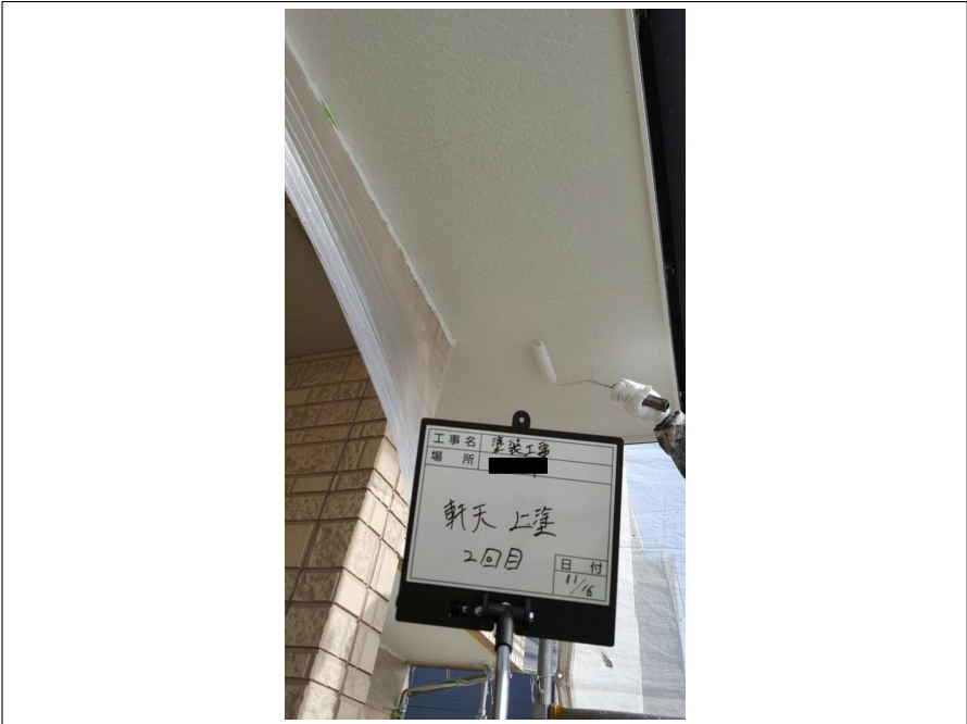
軒天 上塗り（2回目）施工中
