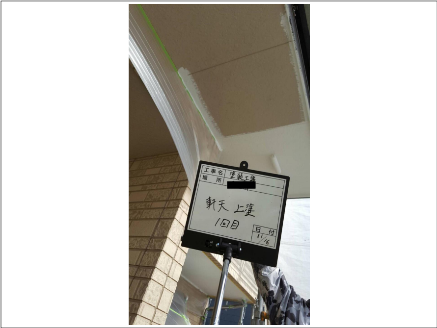
軒天 上塗り（1回目）施工中
