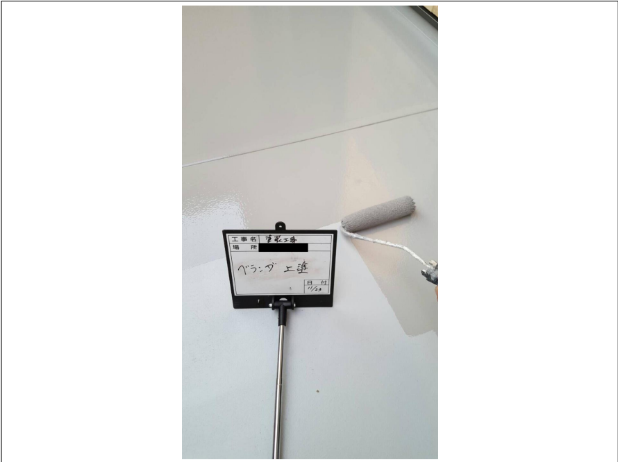
ベランダ 上塗り (2回目) 施工中
