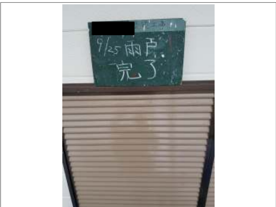
雨戸 施工完了
