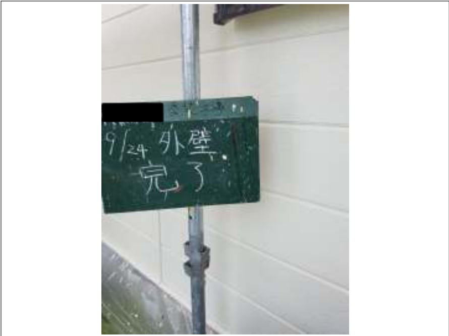
外壁 施工完了
