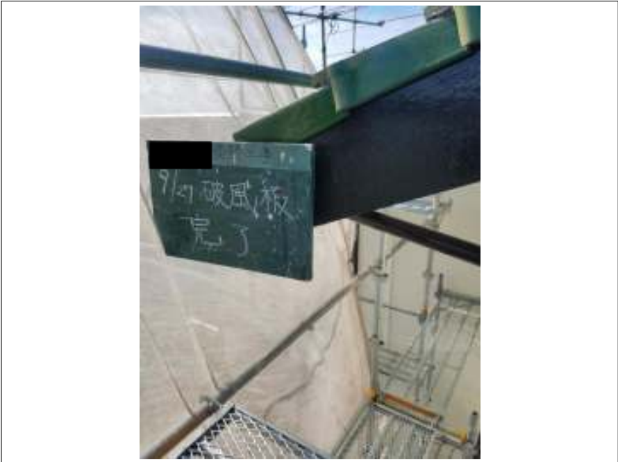
破風板 施工完了
