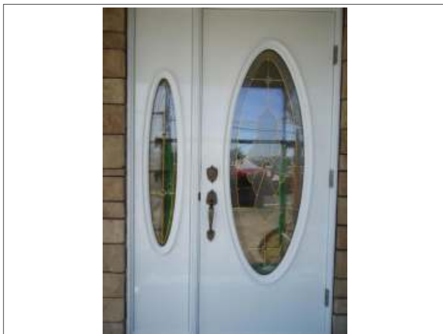
玄関ドア 施工後
