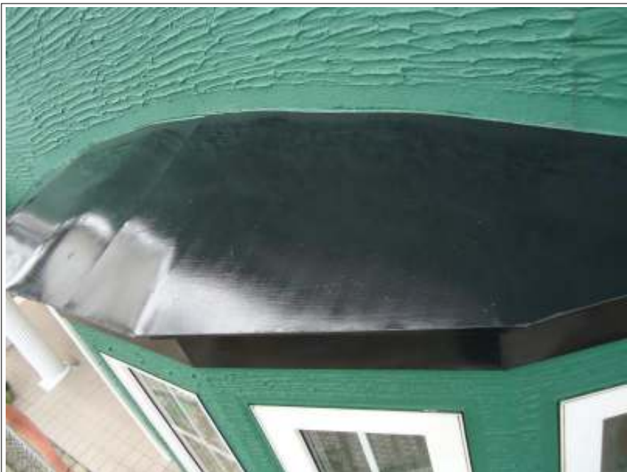
出窓天板 施工後
