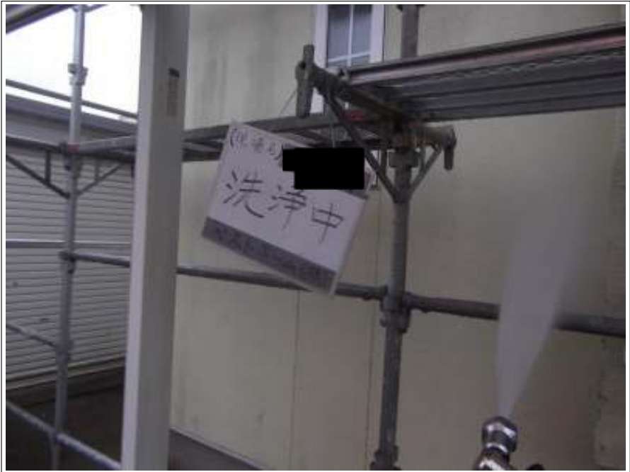
外壁 高圧洗浄中
