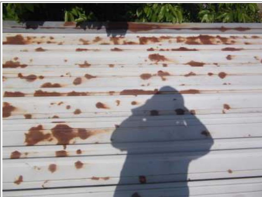
折板屋根 施工前
