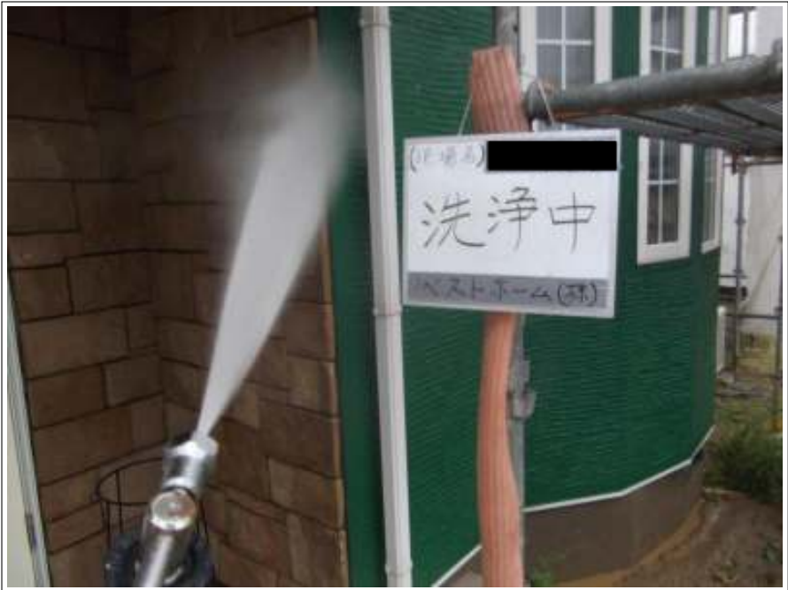
外壁 高圧洗浄中
