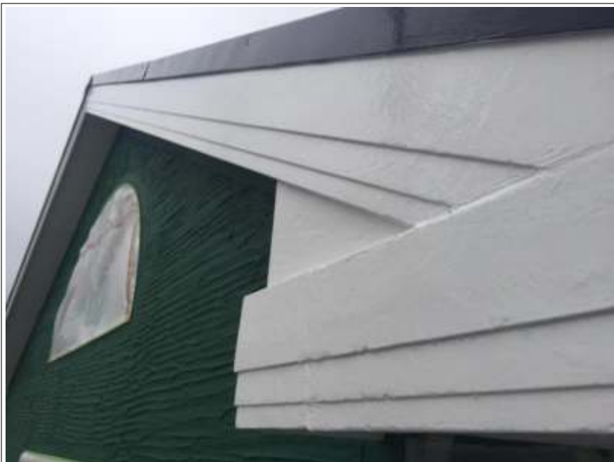
破風板 施工後
