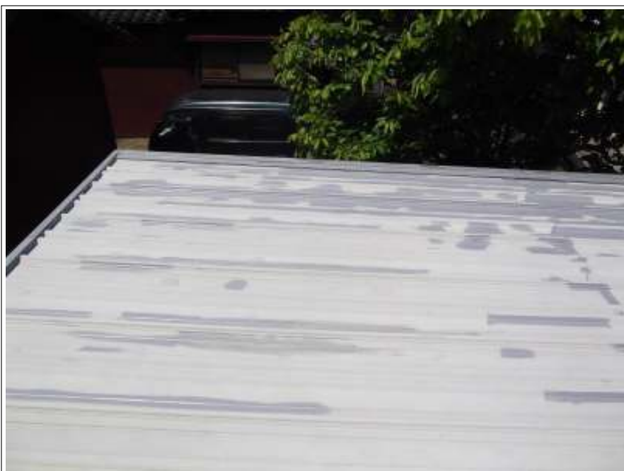
折板屋根 施工中
