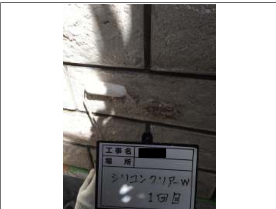
外壁 玄関部 (1回目) 施工中
