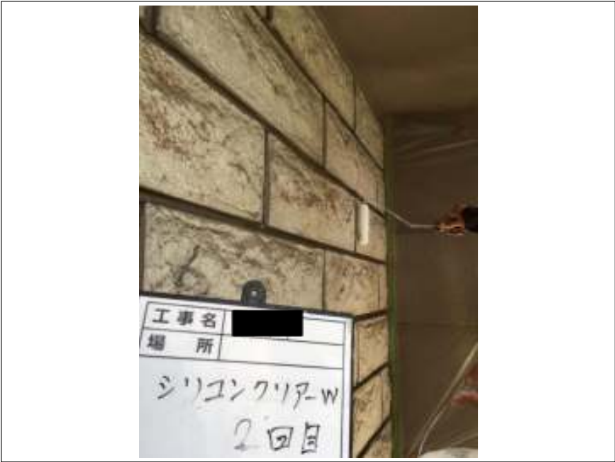
外壁 玄関部 (2回目) 施工中
