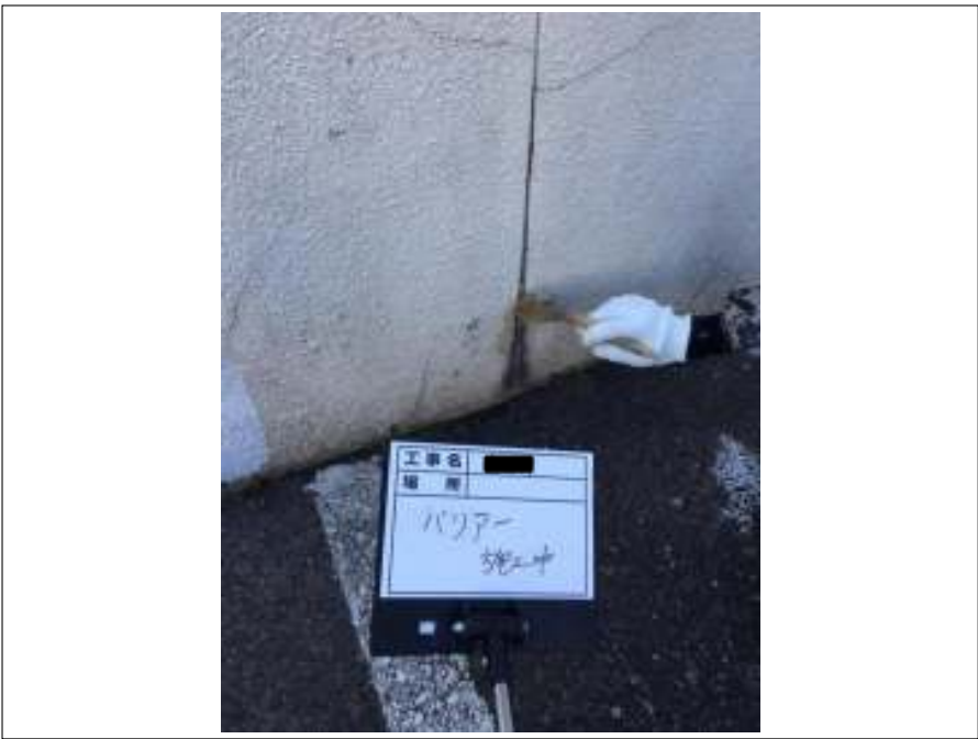
塀 バリアー 施工中
