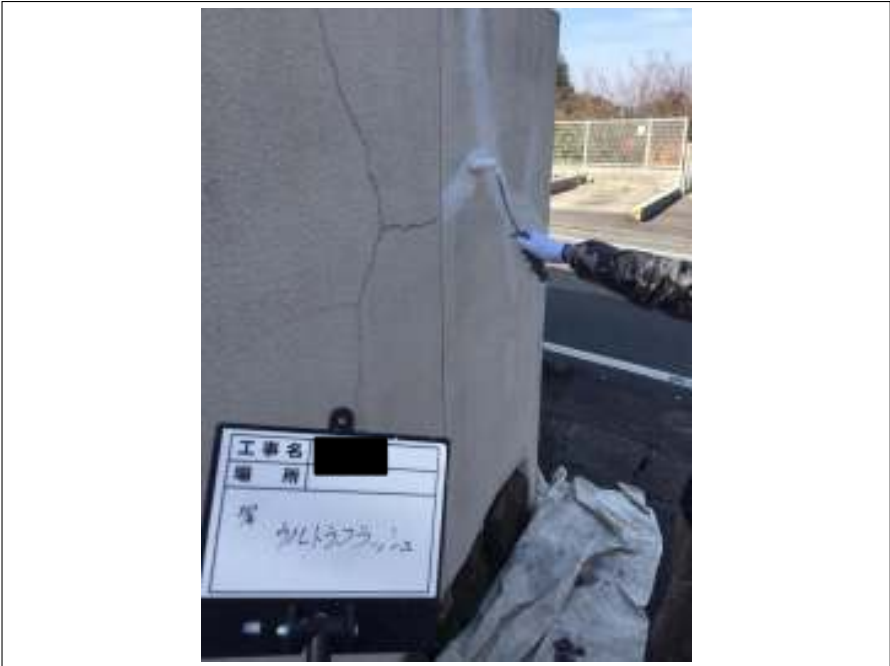
塀 クラック補修 施工中
