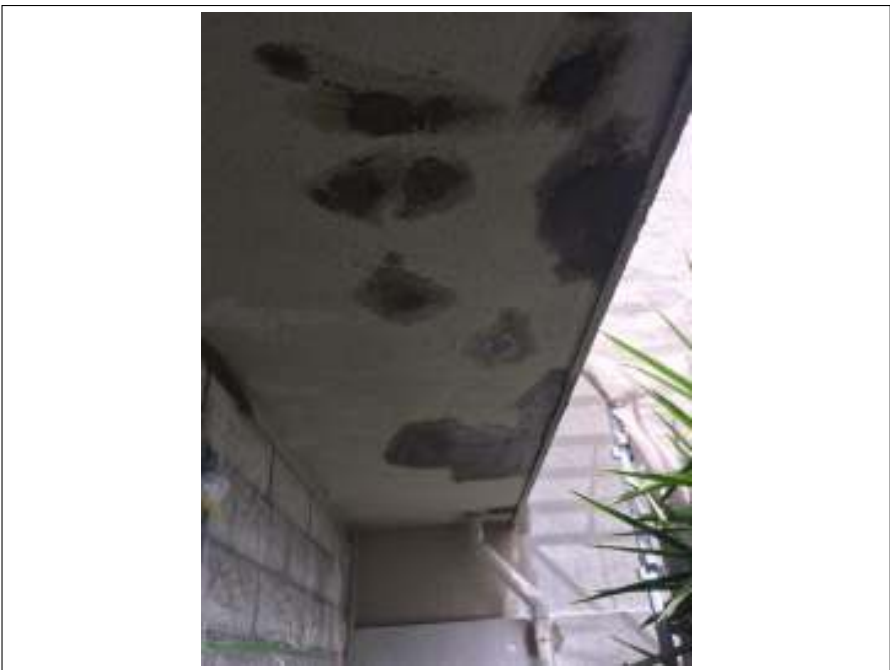
軒天 爆裂部 補修完了
