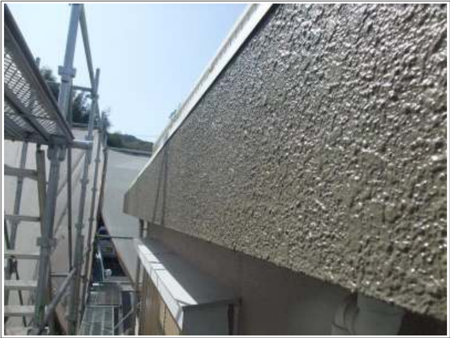
パラペット 施工完了
