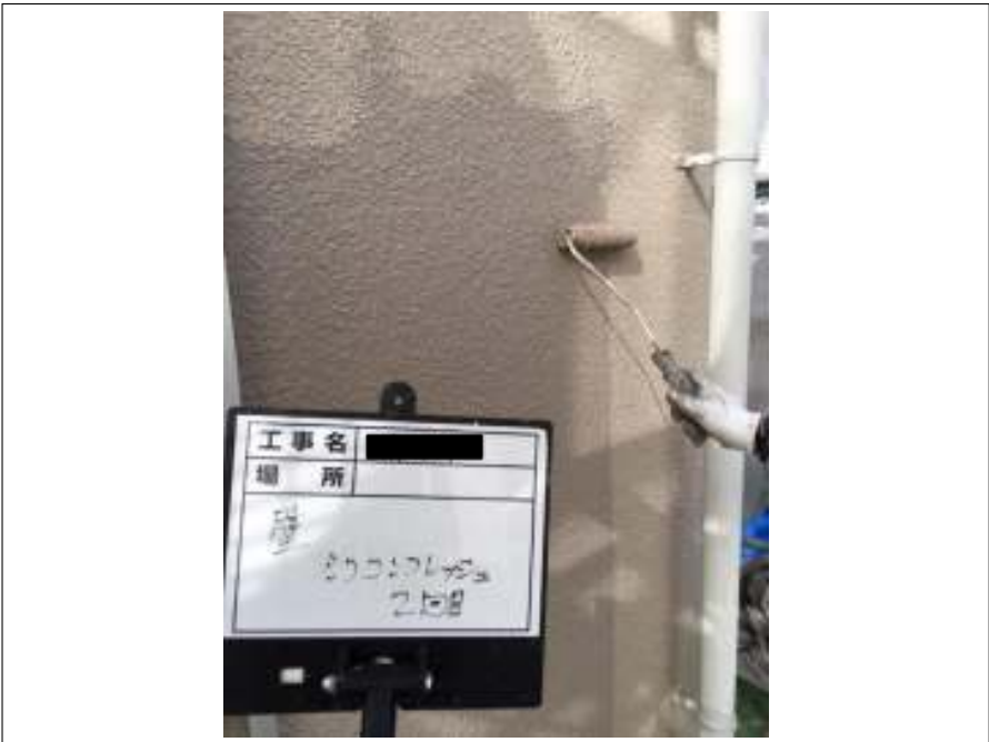
外壁 上塗り 施工中
