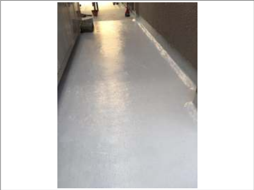
ベランダ床 施工完了
