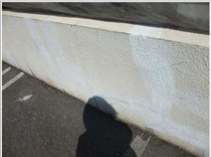
塀 クラック補修 施工完了
