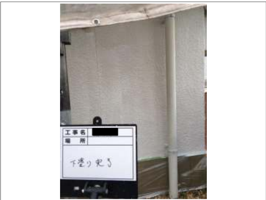
外壁 下塗り 施工完了
