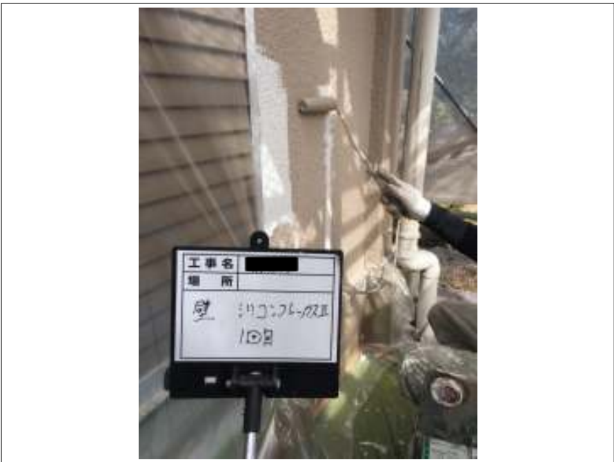
外壁 中塗り 施工中
