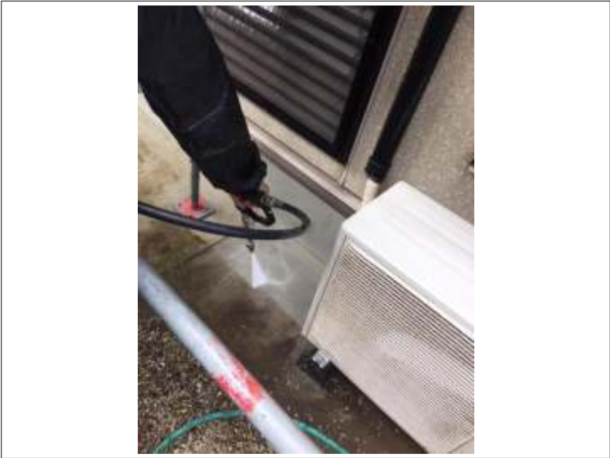
土間 高圧洗浄中
