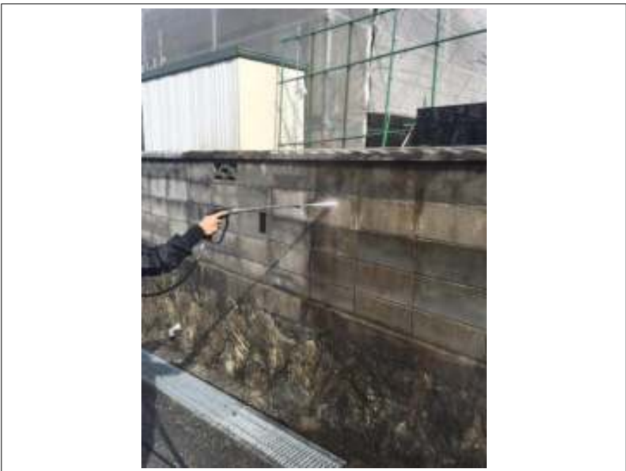
塀 高圧洗浄中
