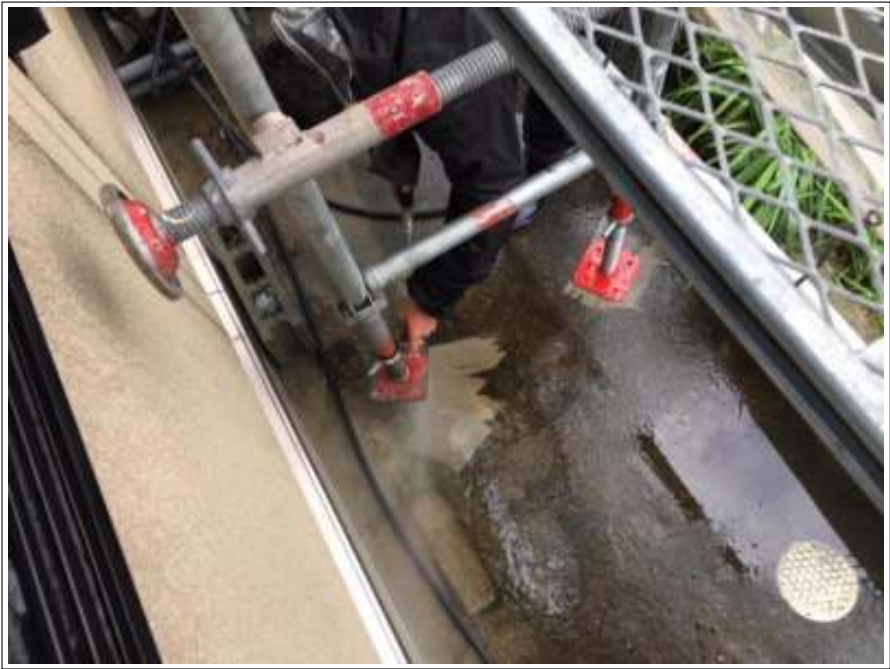
土間 高圧洗浄中
