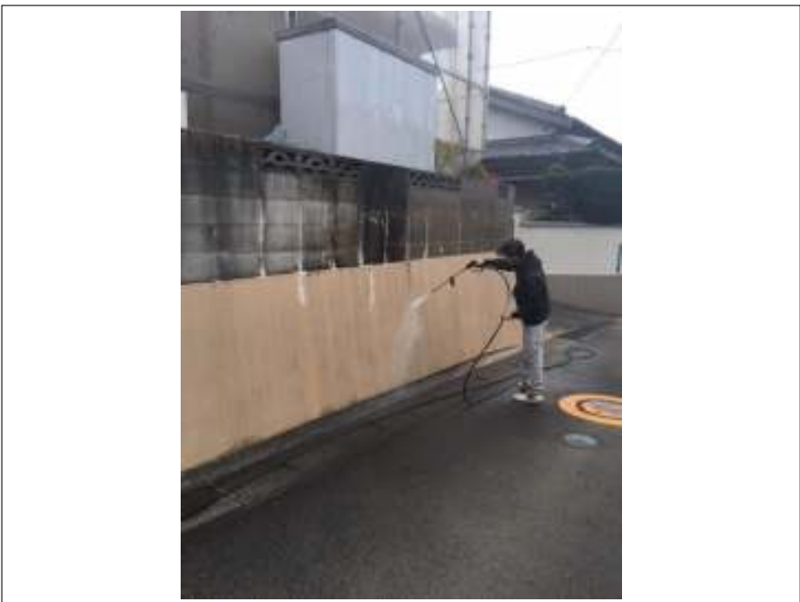
塀 高圧洗浄中
