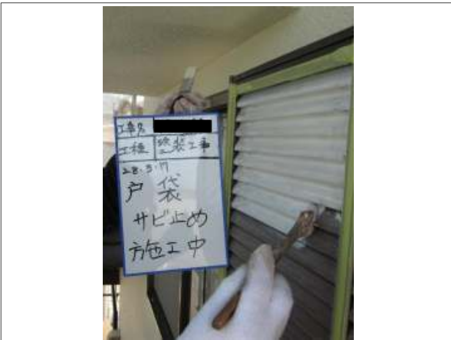
戸袋 サビ止め施工中
