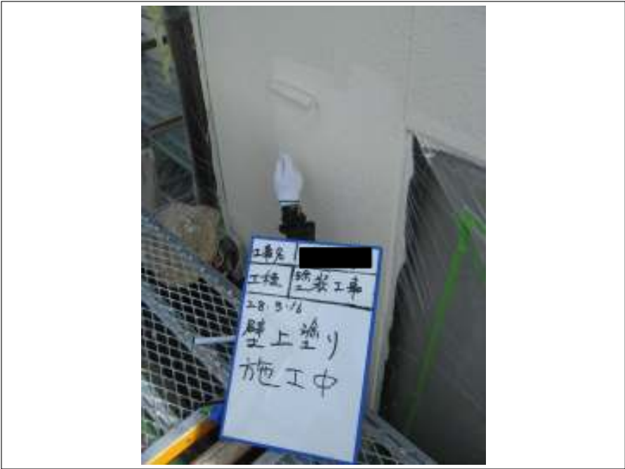
外壁 上塗り施工中
