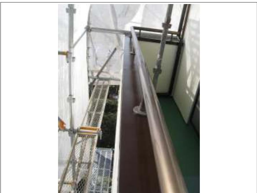
ベランダ天板 下塗り施工完了
