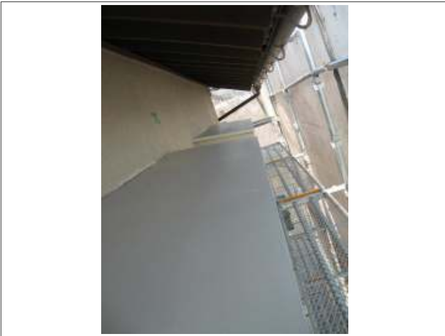
鉄部 錆止め塗布施工後
