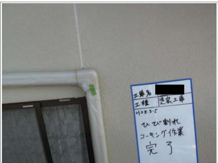
外壁 クラック補修施工後
