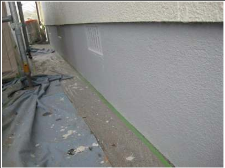
基礎 上塗り施工完了
