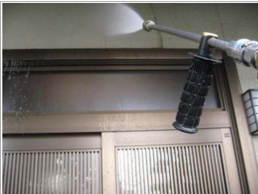
外壁 高压洗净中
