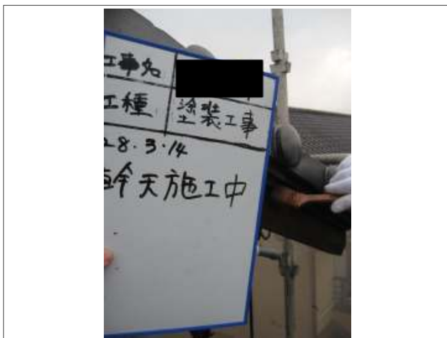
軒天 上塗り施工中 (1回目)
