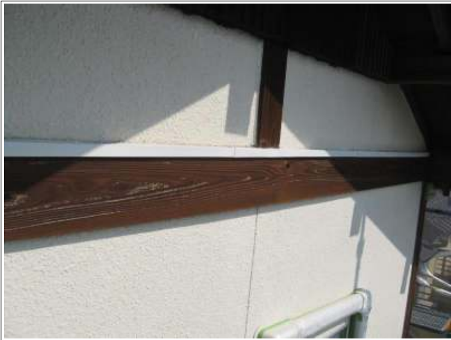
鉄部 錆止め塗布施工後
