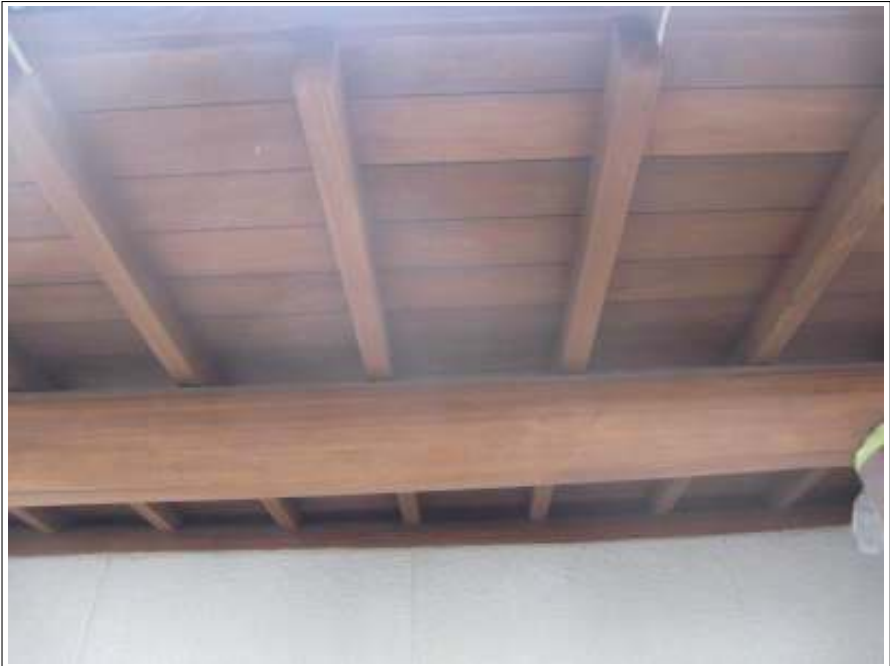
軒天 施工完了
