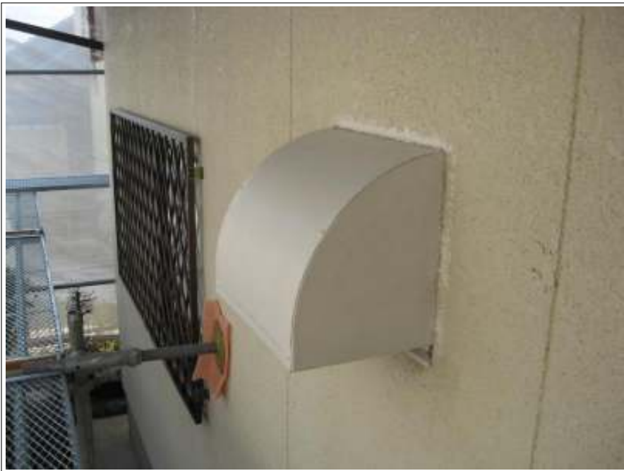
鉄部 錆止め塗布施工後
