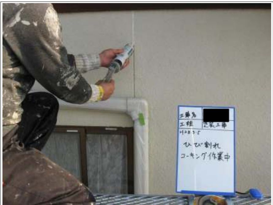
外壁 クラック補修施工中
