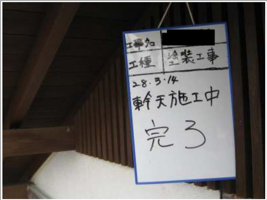
軒天 施工完了
