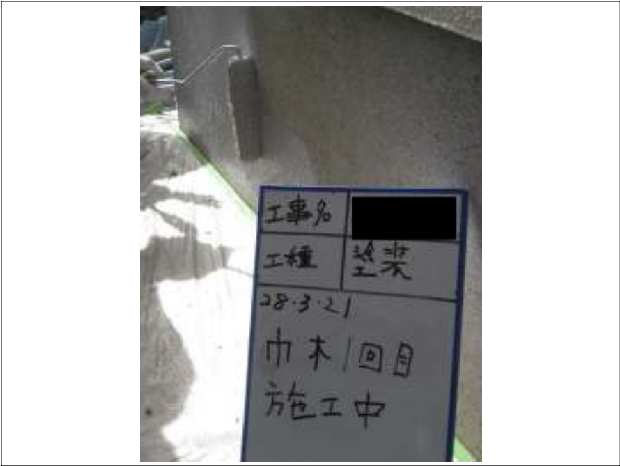
基礎 上塗り施工中
