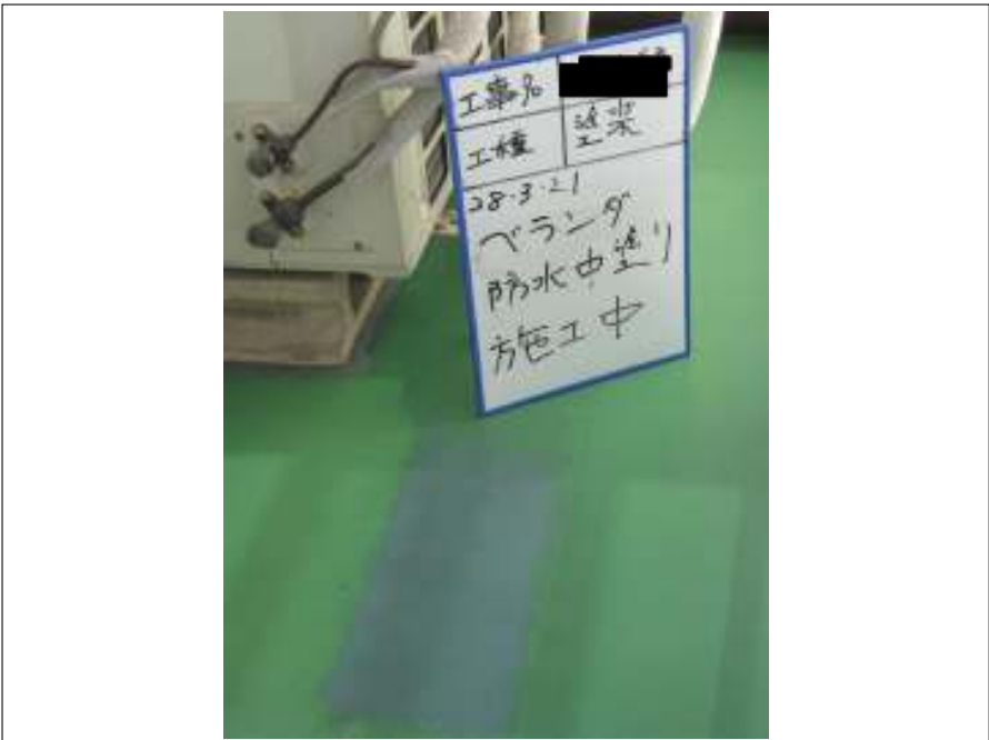
ベランダ床 中塗り施工中
