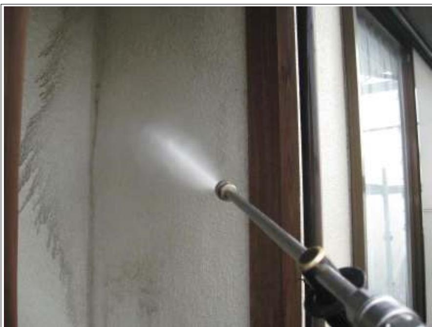
外壁 高压洗净中
