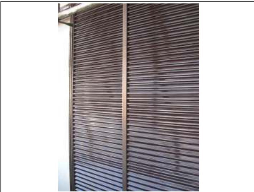
戸袋 上塗り施工完了
