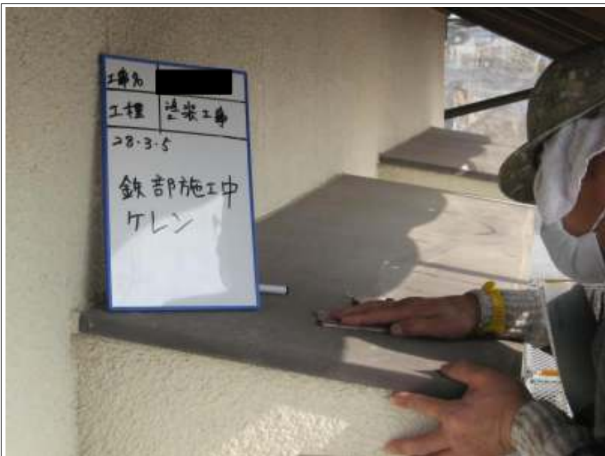
鉄部 ケレン処理施工中
