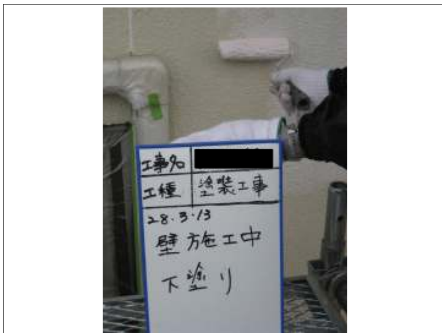
外壁 下塗り施工中
