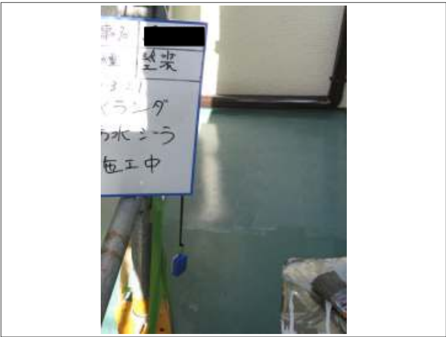
ベランダ床 下塗り施工中
