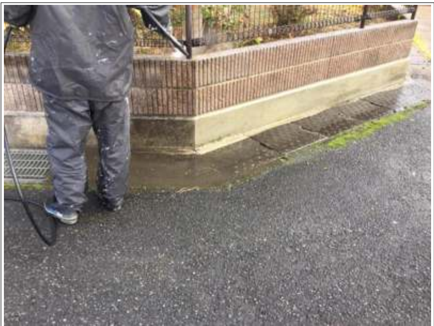
外塀高圧洗浄中
