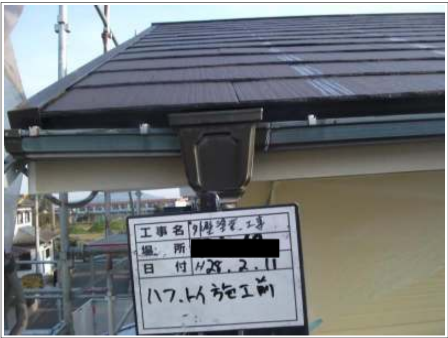
破風・樋 施工前
