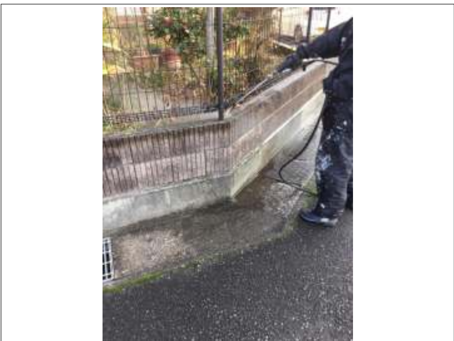
外塀高圧洗浄中
