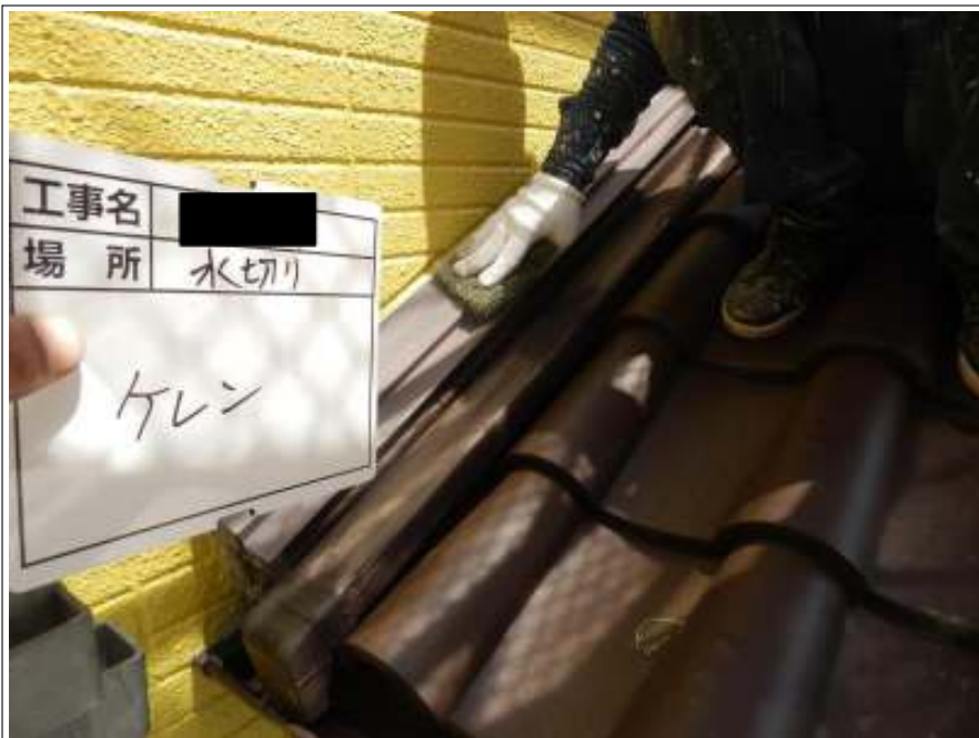
水切り ケレン処理施工中
