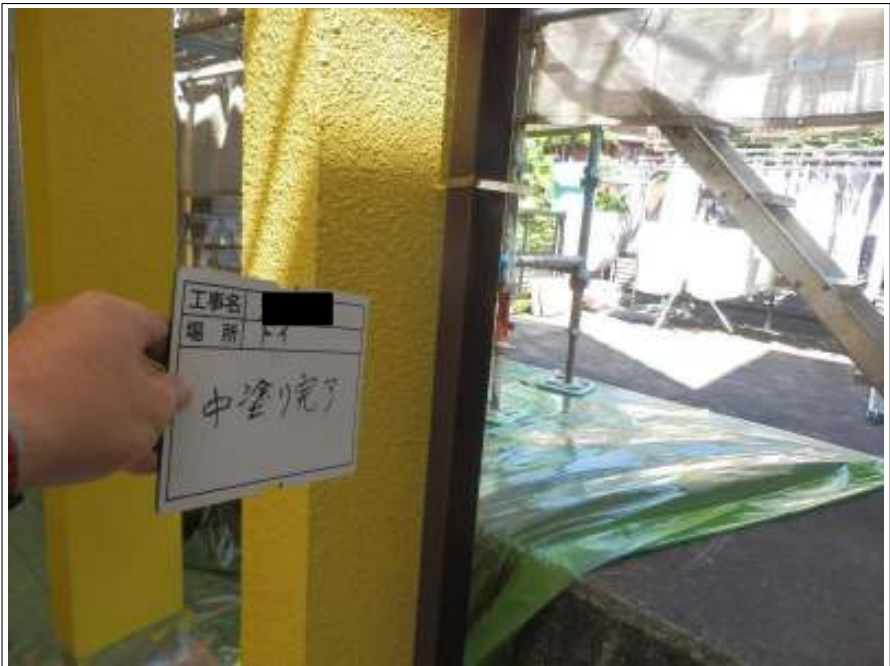
樋 上塗り (1回目) 施工後
