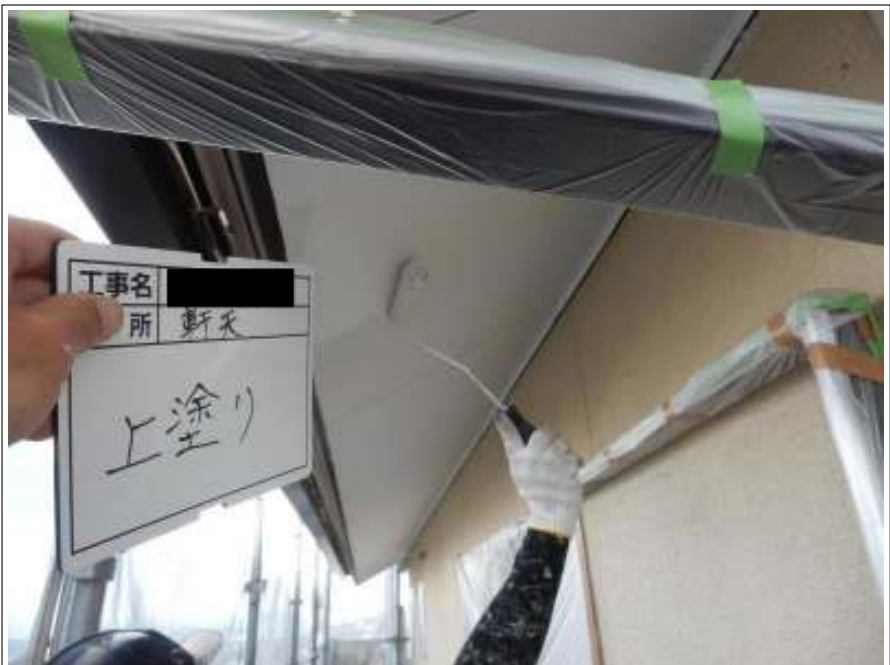
軒天 上塗り（2回目）施工中
