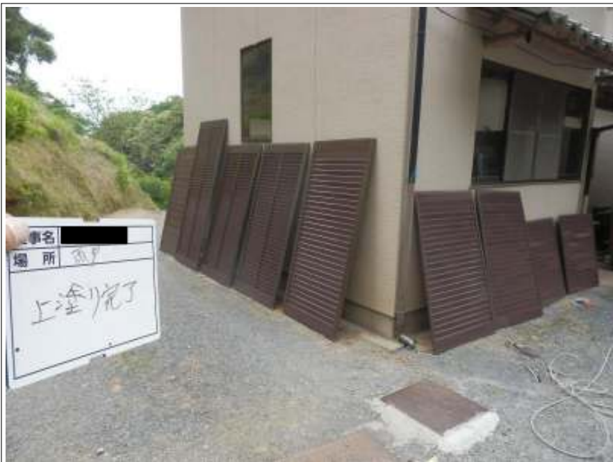
雨戸 上塗り（2回目）施工後
