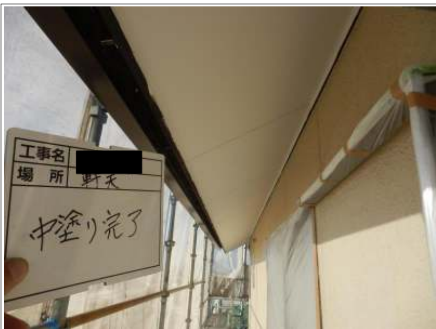
軒天 上塗り（1回目）施工後
