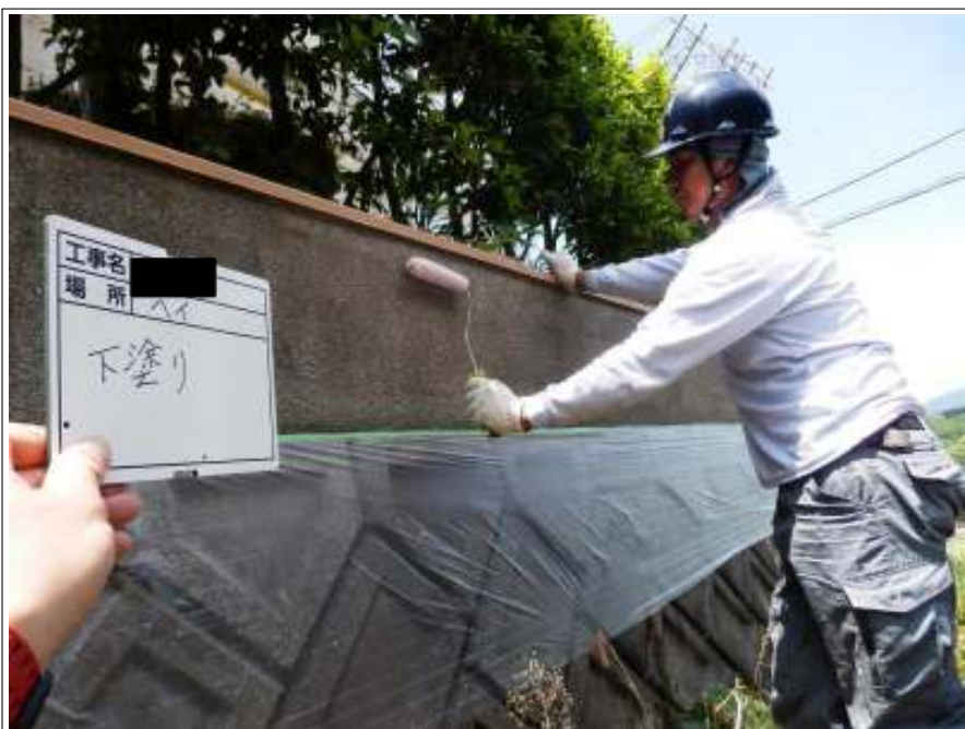
塀 下塗り施工中
