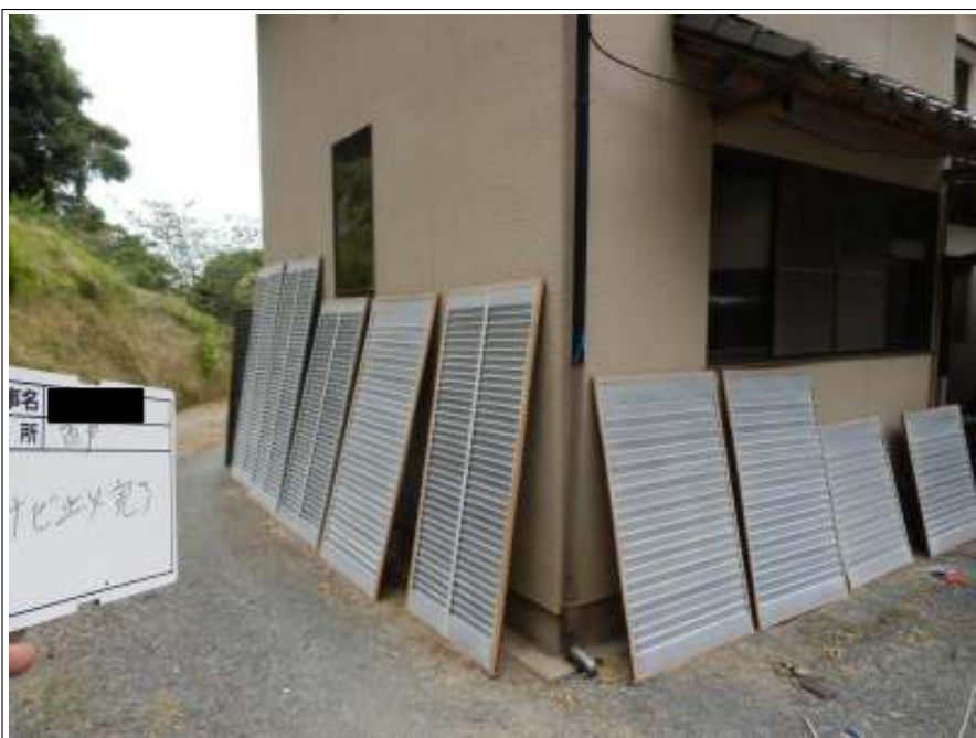
雨戸 サビ止め塗布施工後
