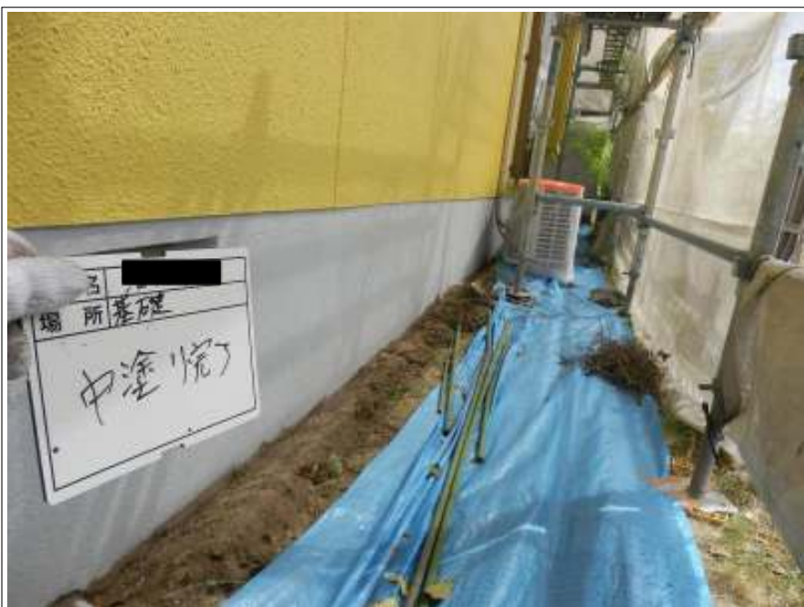
基礎 中塗り施工後
