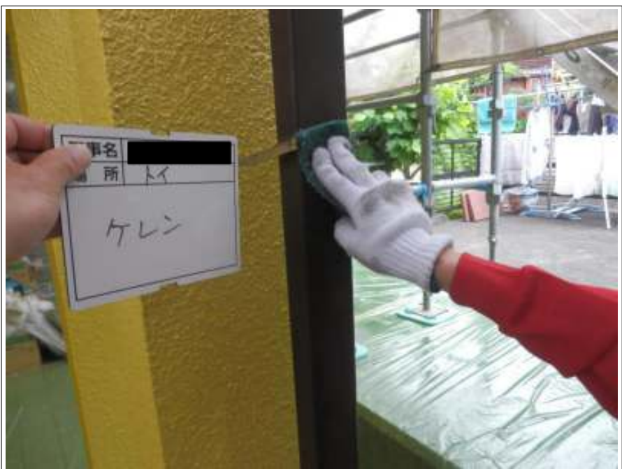
樋 ケレン処理施工中
