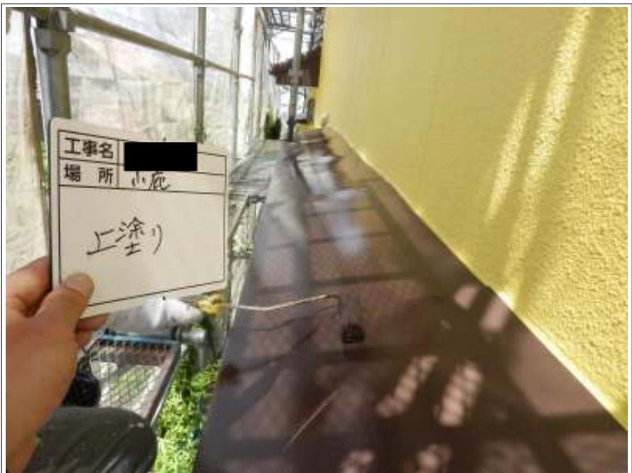
小庇 上塗り施工中
