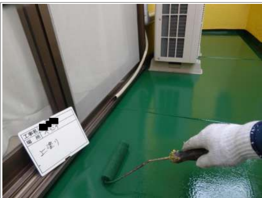
ベランダ 上塗り施工中
