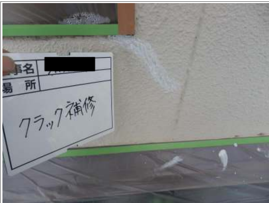
外壁 クラック補修施工後
