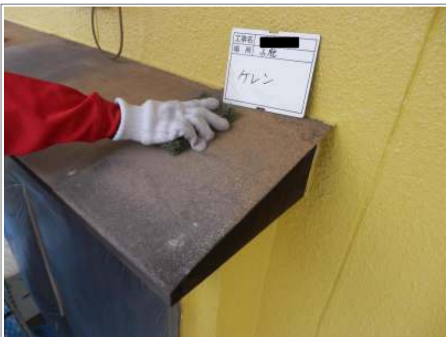
小庇 ケレン処理施工中
