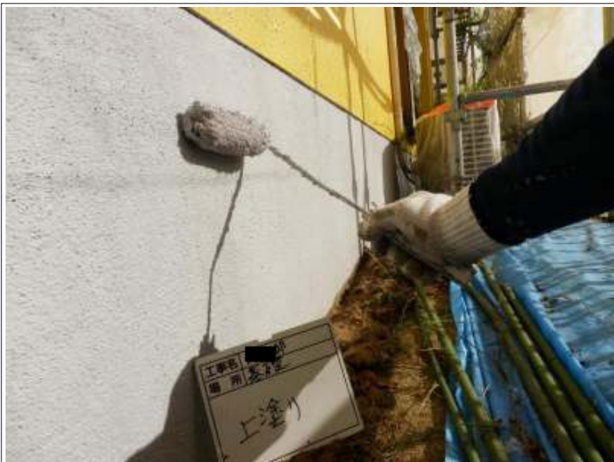
基礎 上塗り施工中
