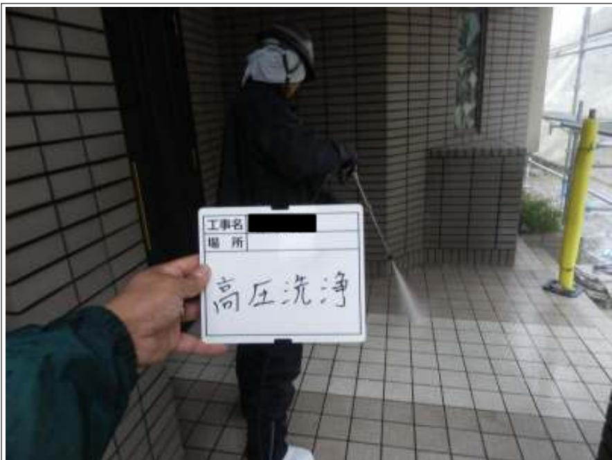
玄関部 高圧洗浄中
