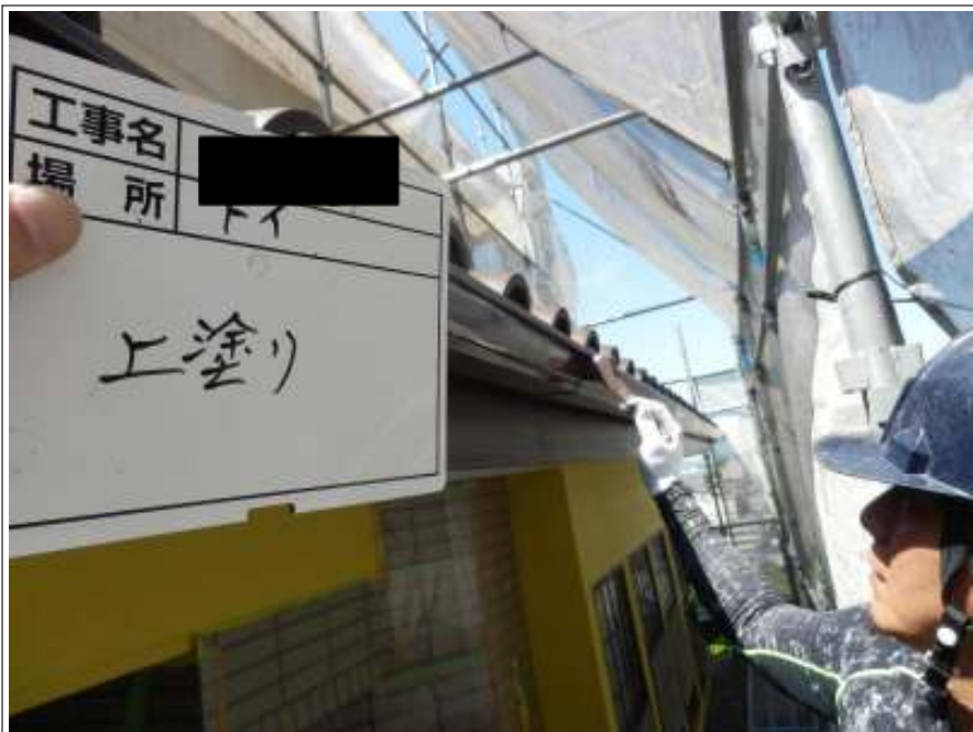
樋 上塗り（2回目）施工中
