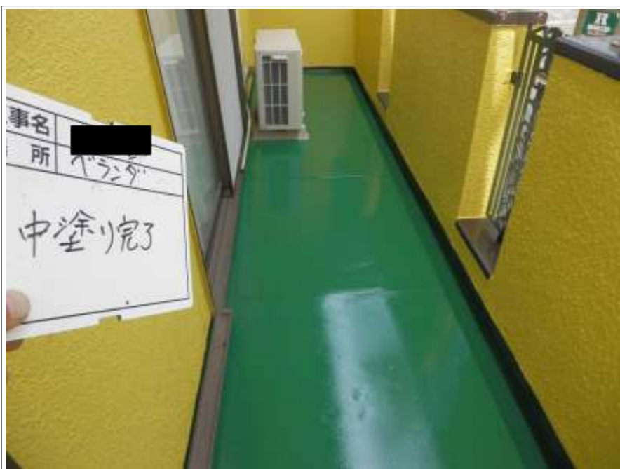
ベランダ 中塗り施工後
