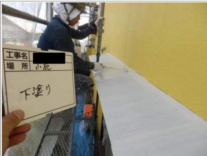
小庇 下塗り施工中
