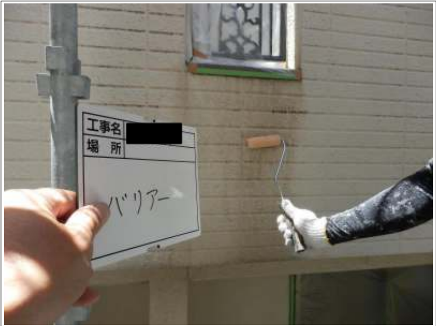
外壁 バリアー塗布
