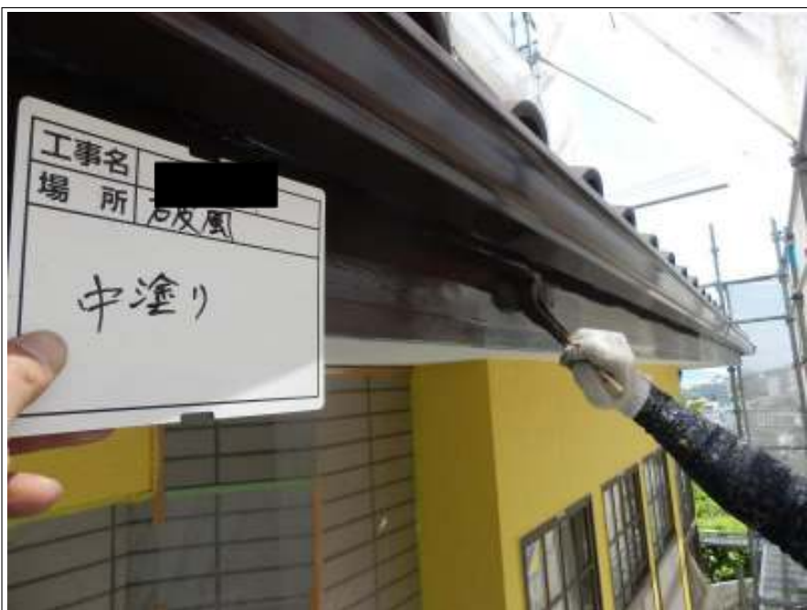
破風板 中塗り施工中
