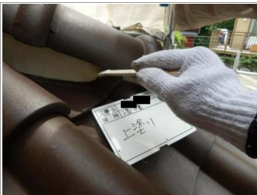
漆喰 上塗り施工中
