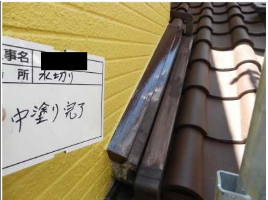
水切り 中塗り施工後
