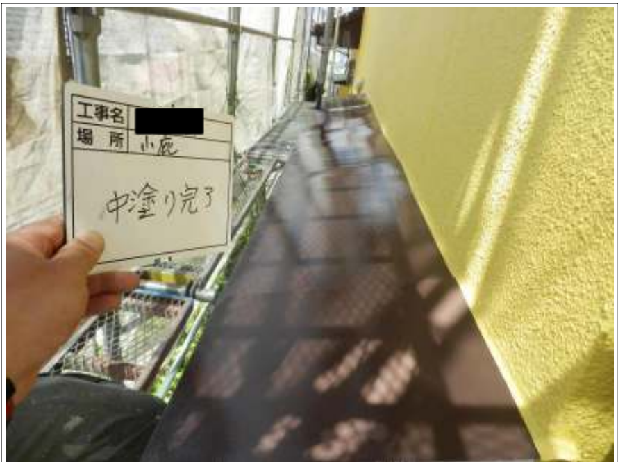
小庇 中塗り施工後
