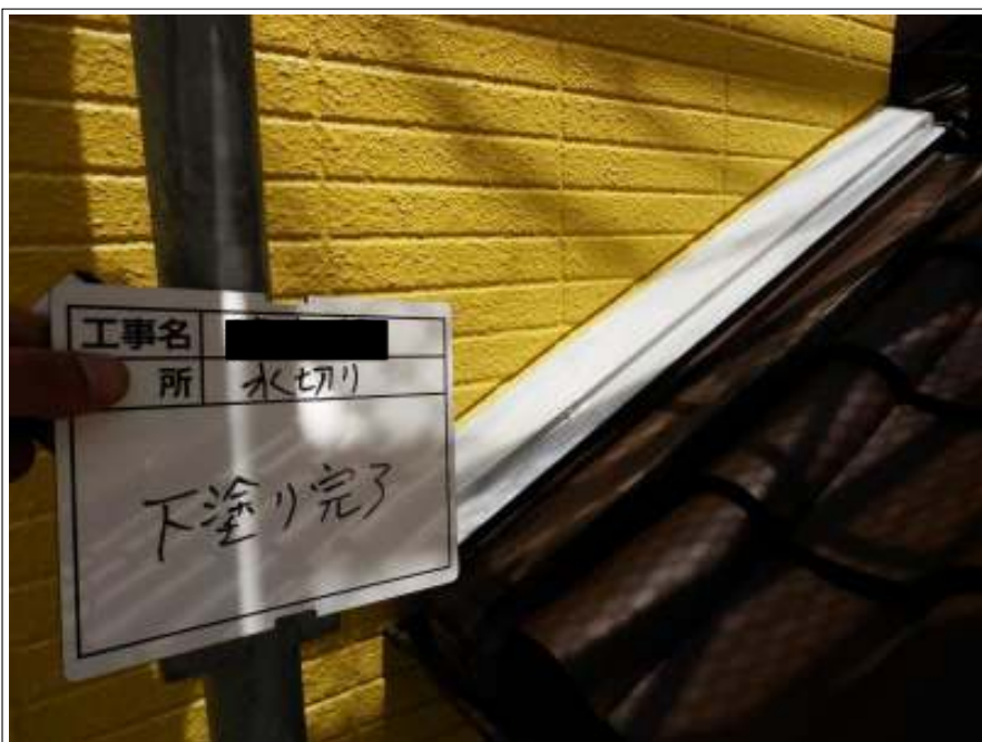
水切り 下塗り施工後
