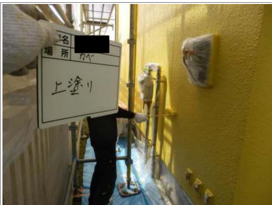
外壁（1F） 上塗り施工中
