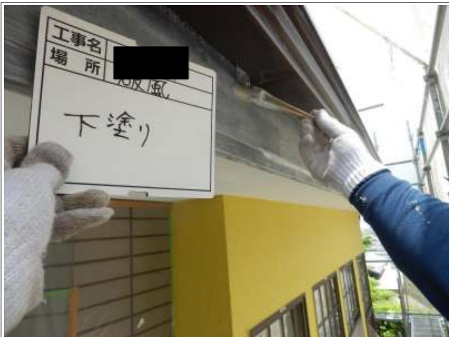
破風板 下塗り施工中
