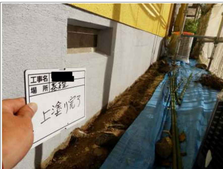
基礎 上塗り施工後
