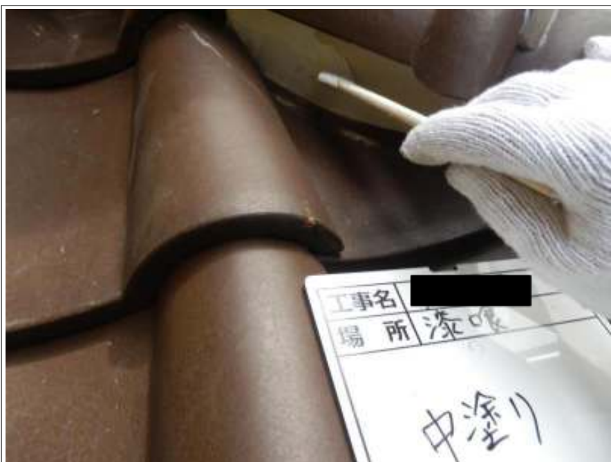
漆喰 中塗り施工中
