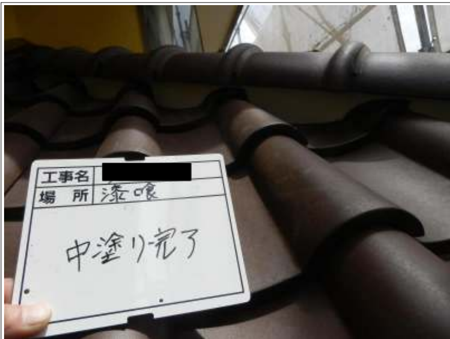
漆喰 中塗り施工後
