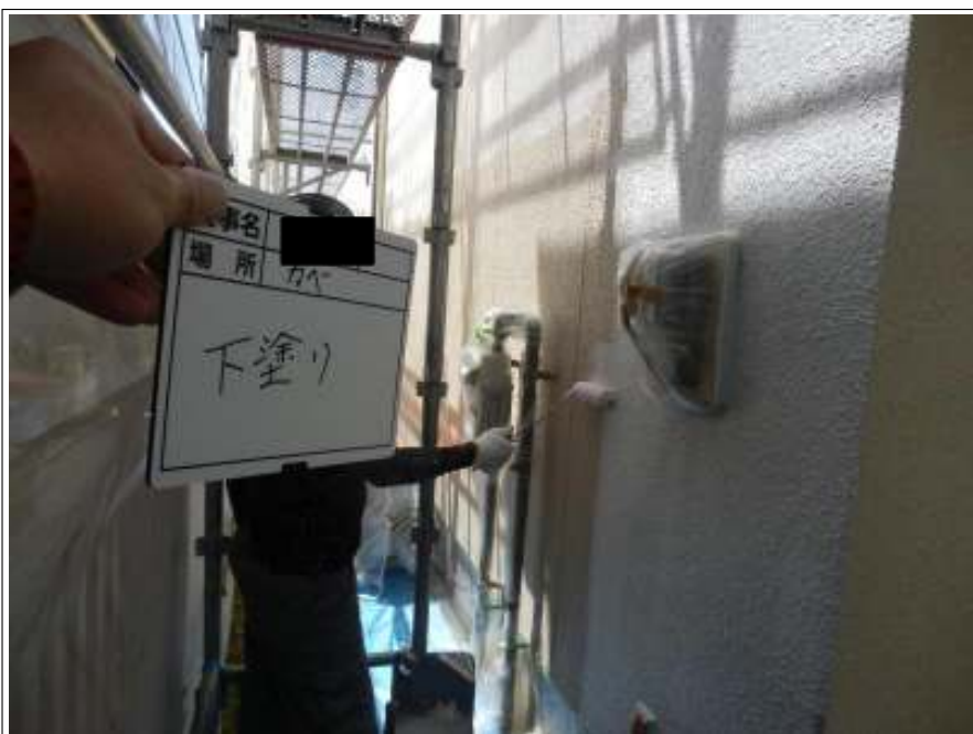
外壁（1F） 下塗り施工中
