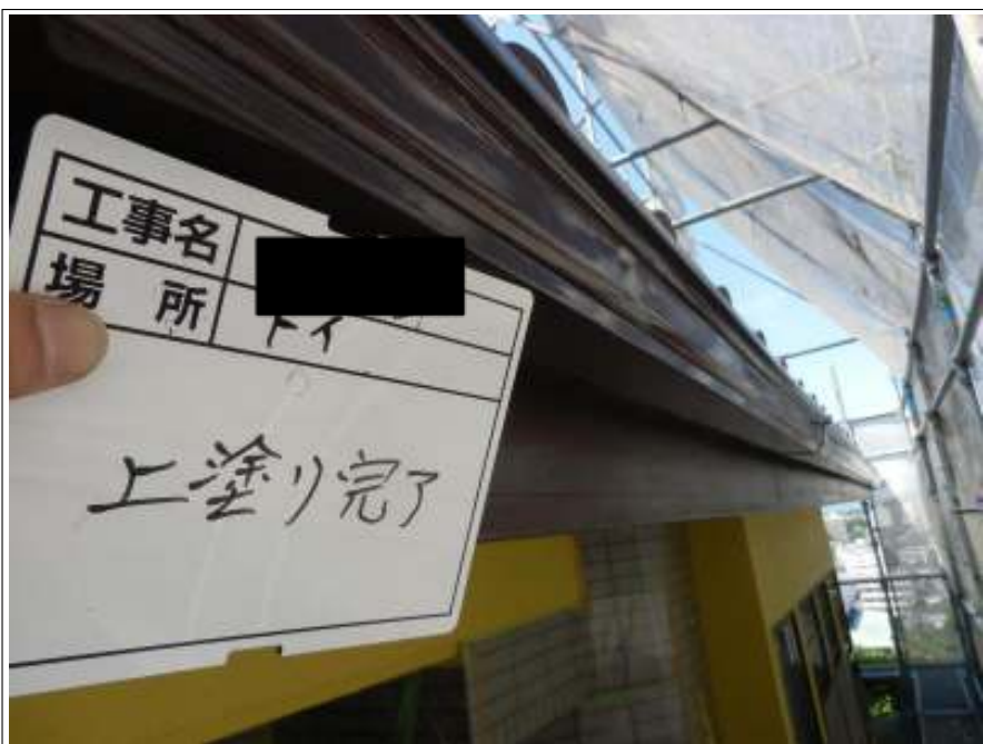
樋 上塗り（2回目）施工後
