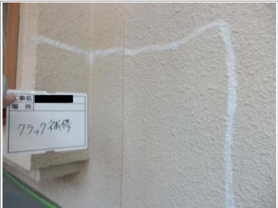
外壁 クラック補修施工後
