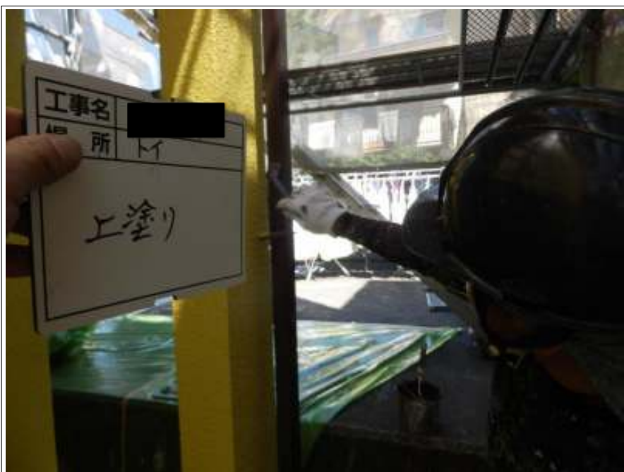
樋 上塗り（2回目）施工中
