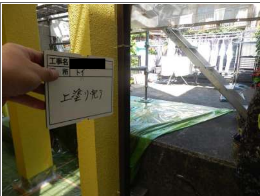
樋 上塗り（2回目）施工後
