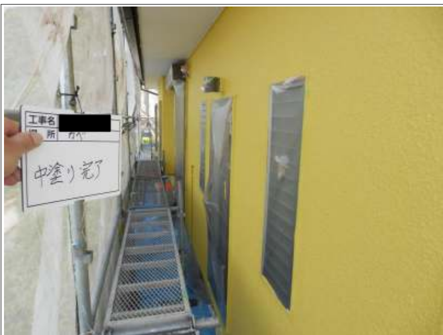
外壁（2F） 中塗り施工後
