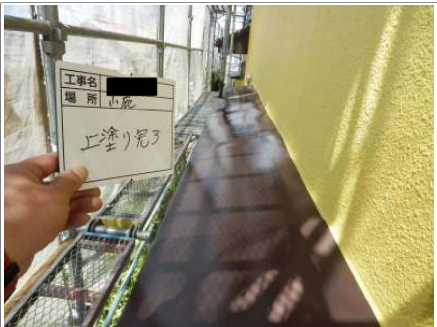
小庇 上塗り施工後
