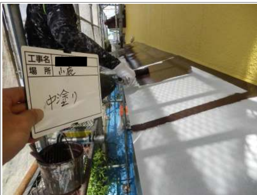
小庇 中塗り施工中
