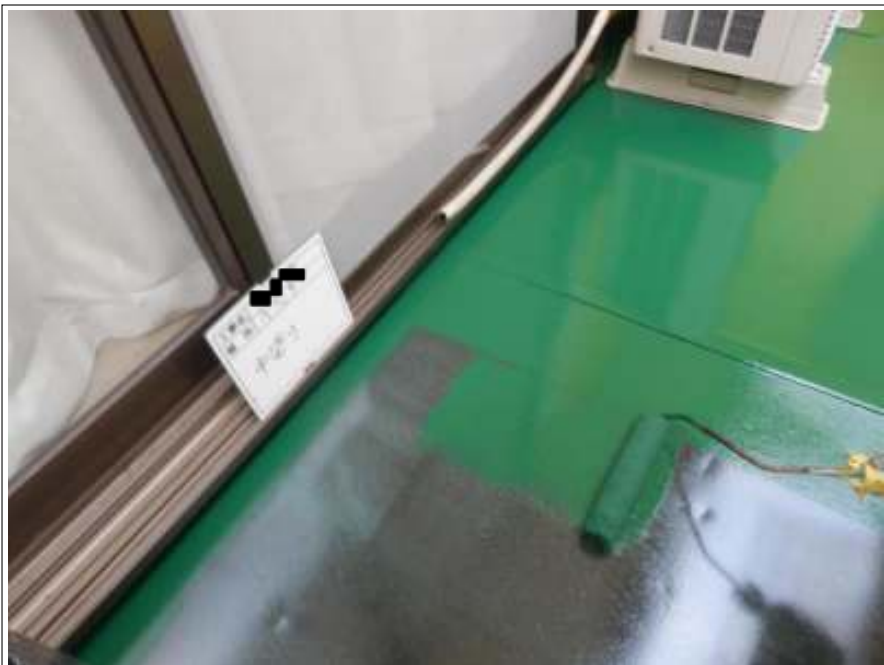
ベランダ 中塗り施工中
