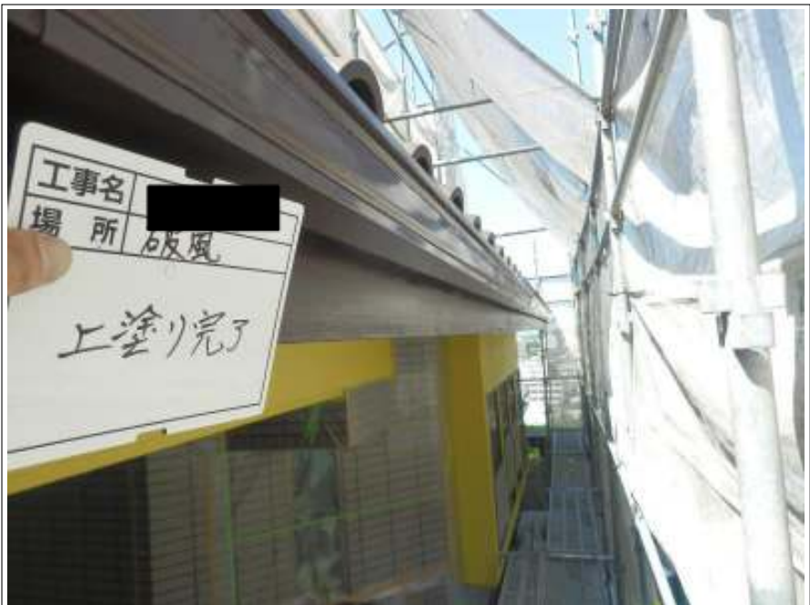
破風板 上塗り施工後
