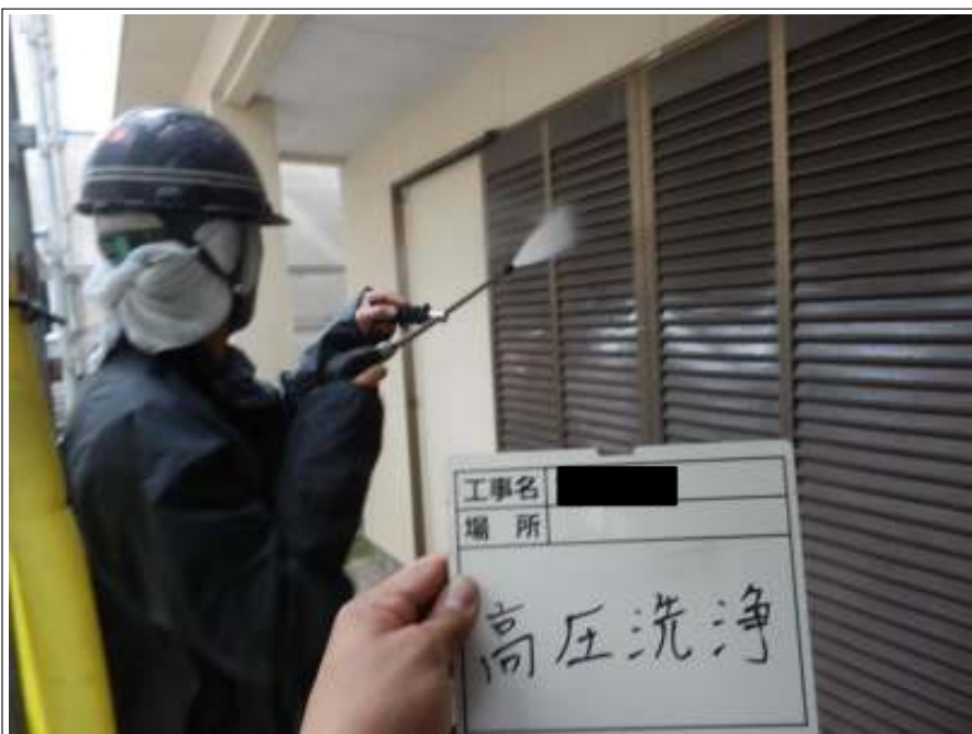
雨戸 高压洗浄中
