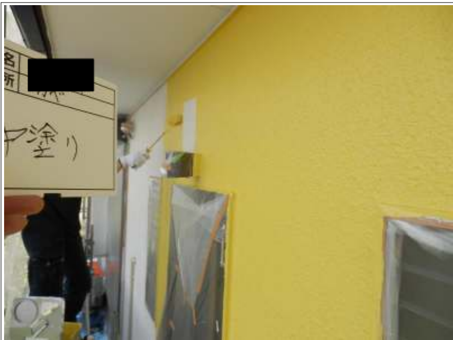
外壁（2F） 中塗り施工中
