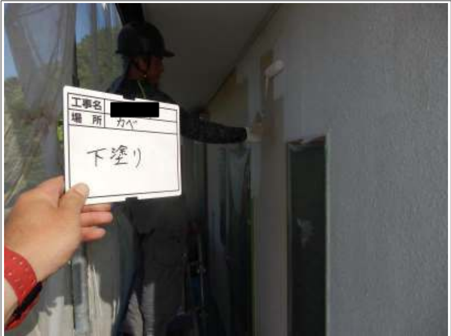
外壁（2F） 下塗り施工中
