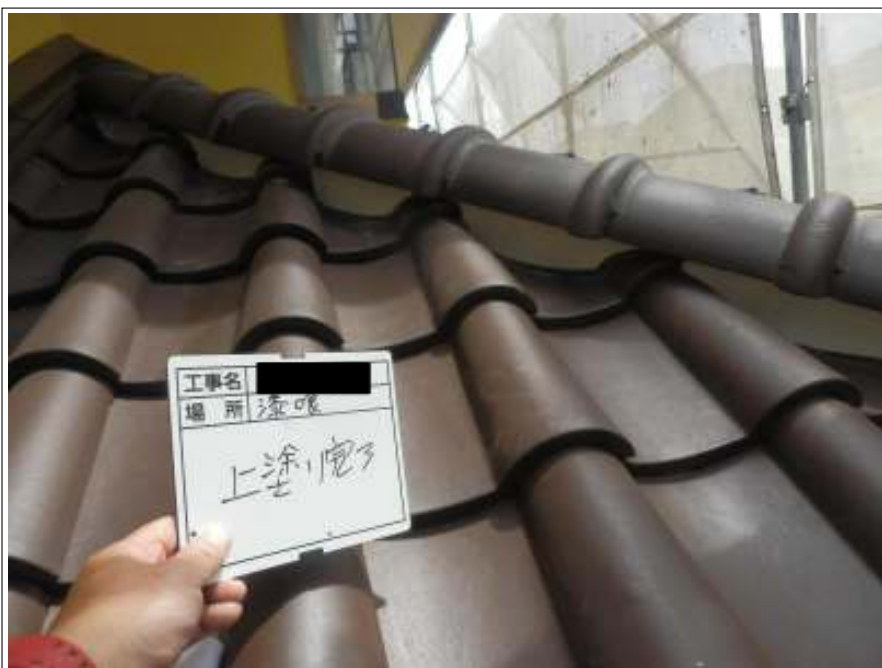
漆喰 上塗り施工後
