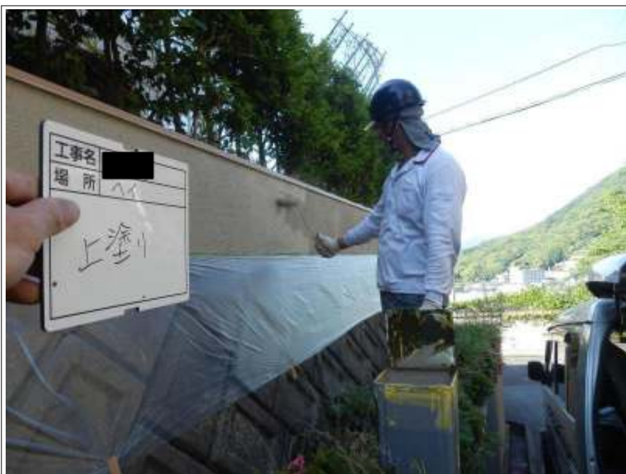
塀 上塗り施工中
