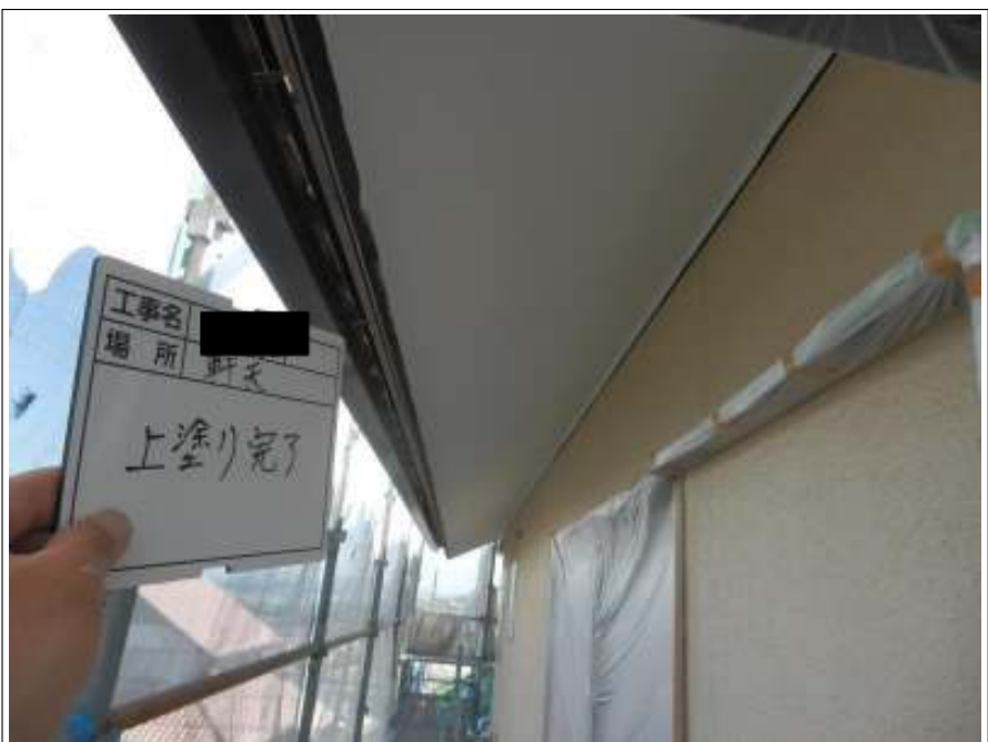
軒天 上塗り（2回目）施工後
