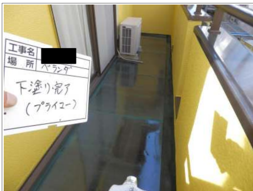
ベランダ 下塗り施工後
