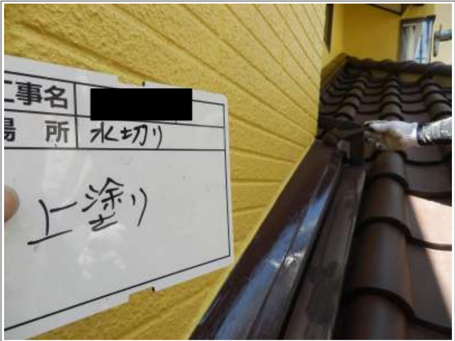
水切り 上塗り施工中
