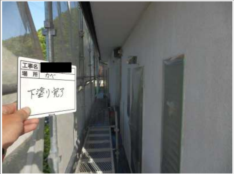
外壁（2F） 下塗り施工後
