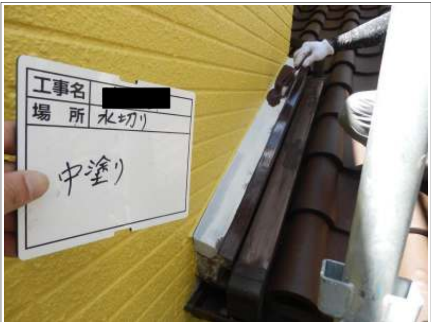
水切り 中塗り施工中
