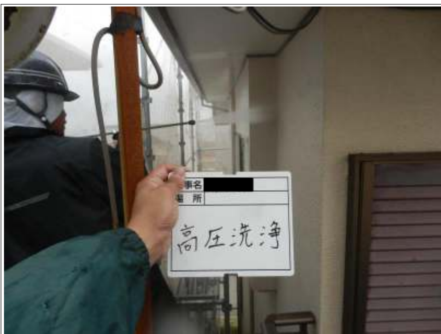
外壁 高压洗浄中
