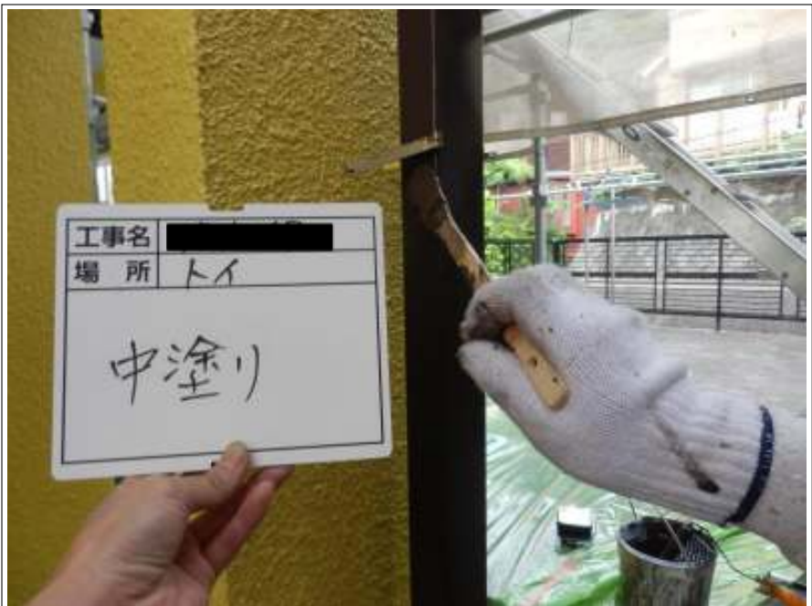
樋 上塗り (1回目) 施工中
