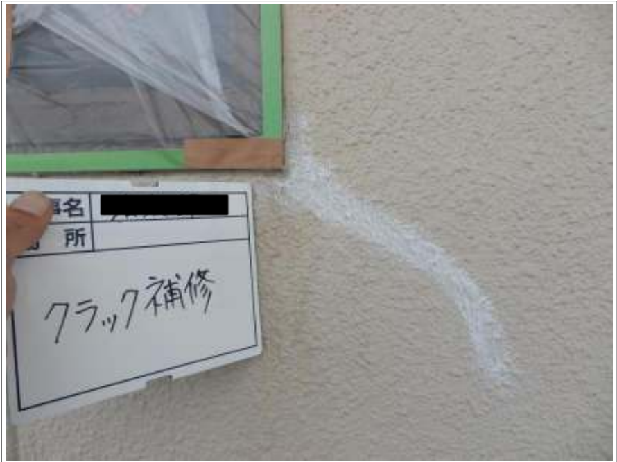
外壁 クラック補修施工後
