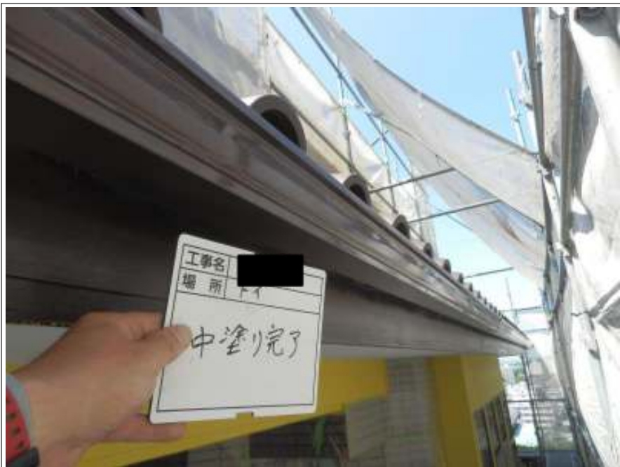
樋 上塗り（1回目）施工後
