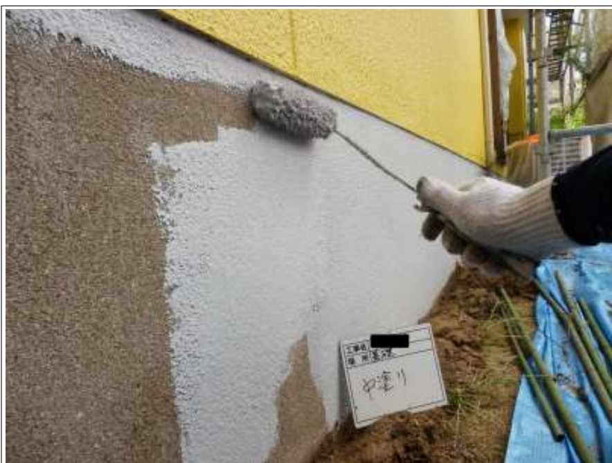
基礎 中塗り施工中
