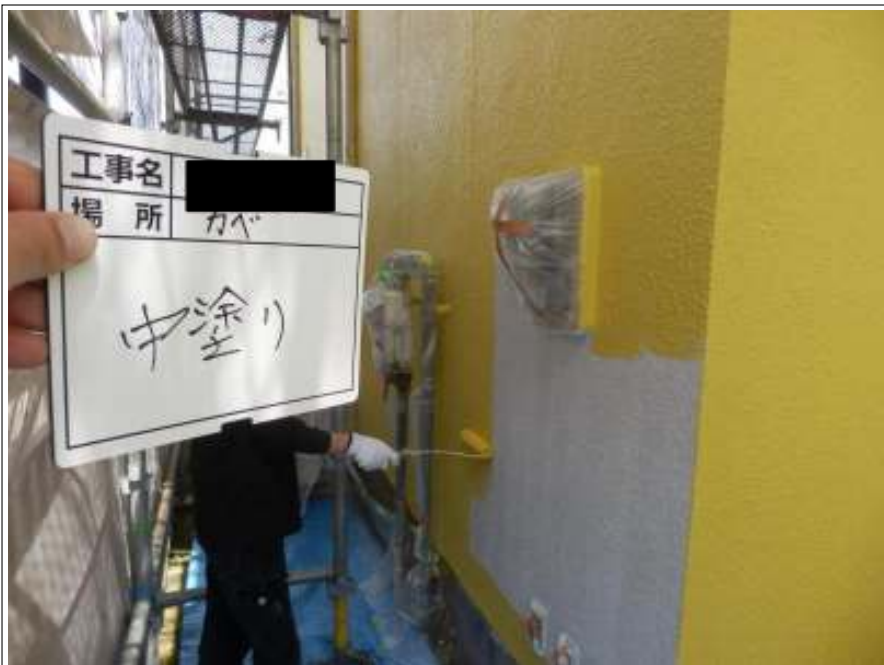
外壁（1F） 中塗り施工中
