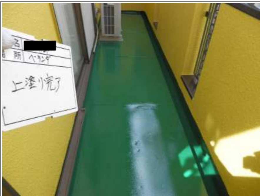
ベランダ 上塗り施工後
