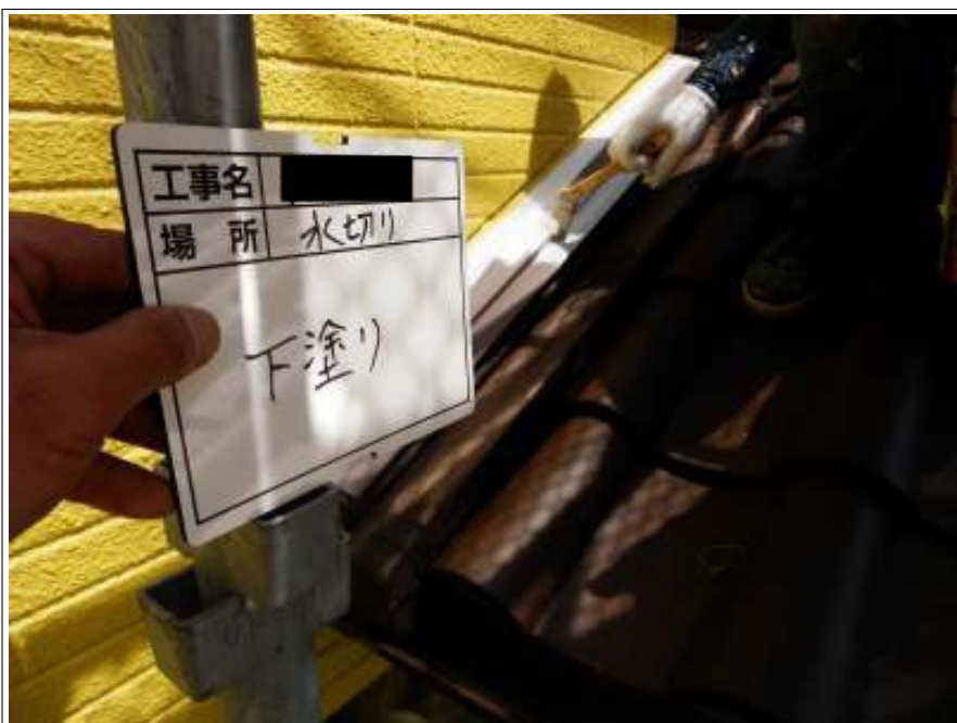
水切り 下塗り施工中
