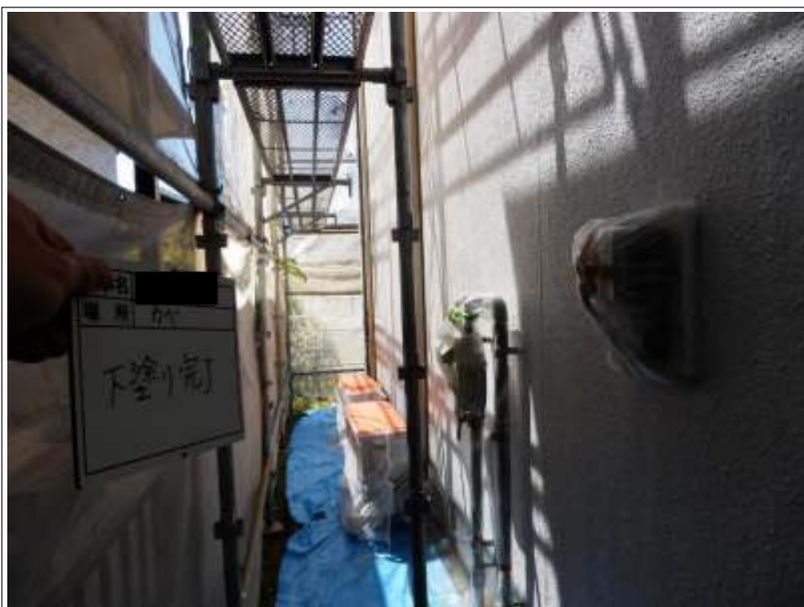
外壁（1F） 下塗り施工後
