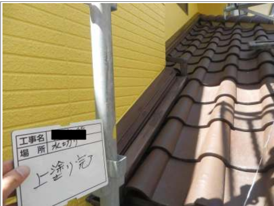
水切り 上塗り施工後
