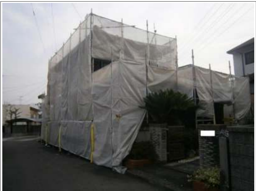
仮設足場組立
