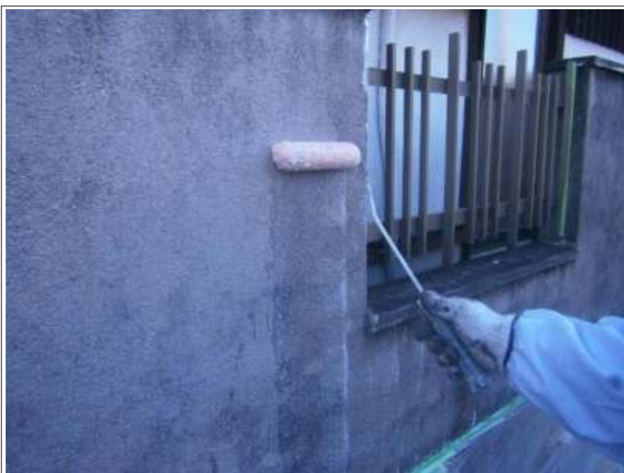
塀 下塗り施工中
