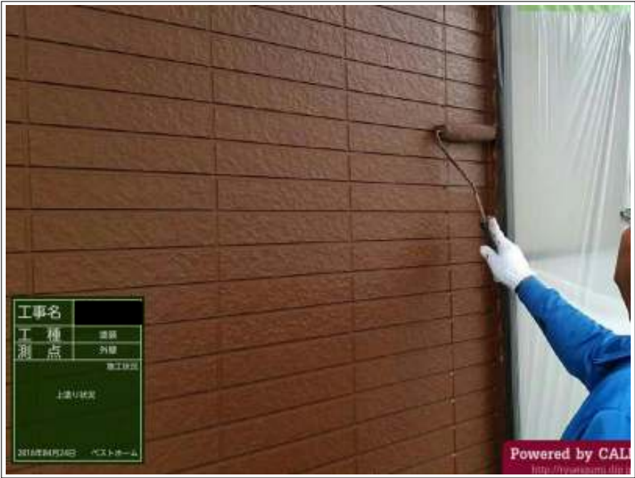
外壁 上塗り施工中
