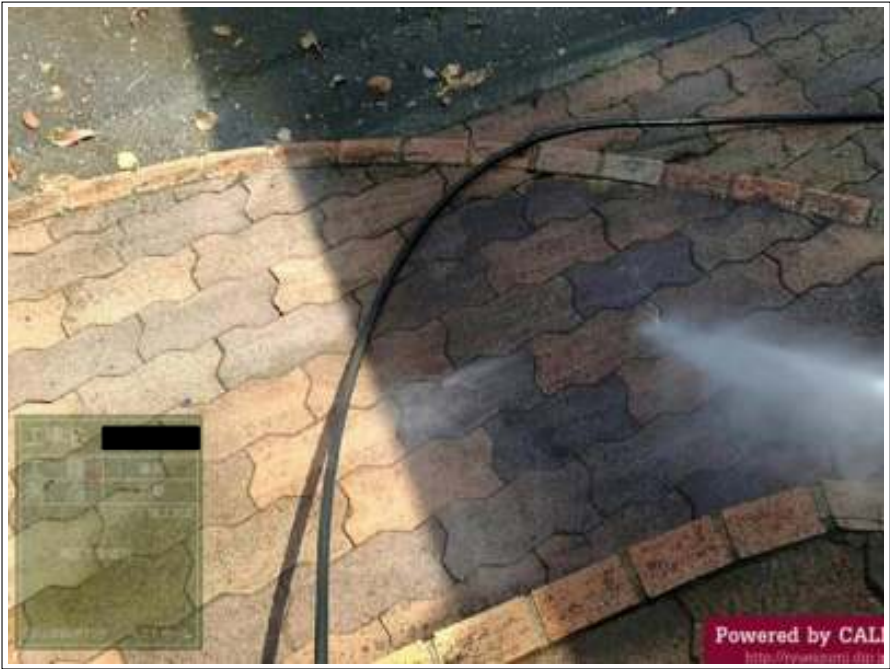
土間 高圧洗浄中
