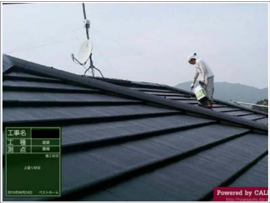
屋根 上塗り施工中
