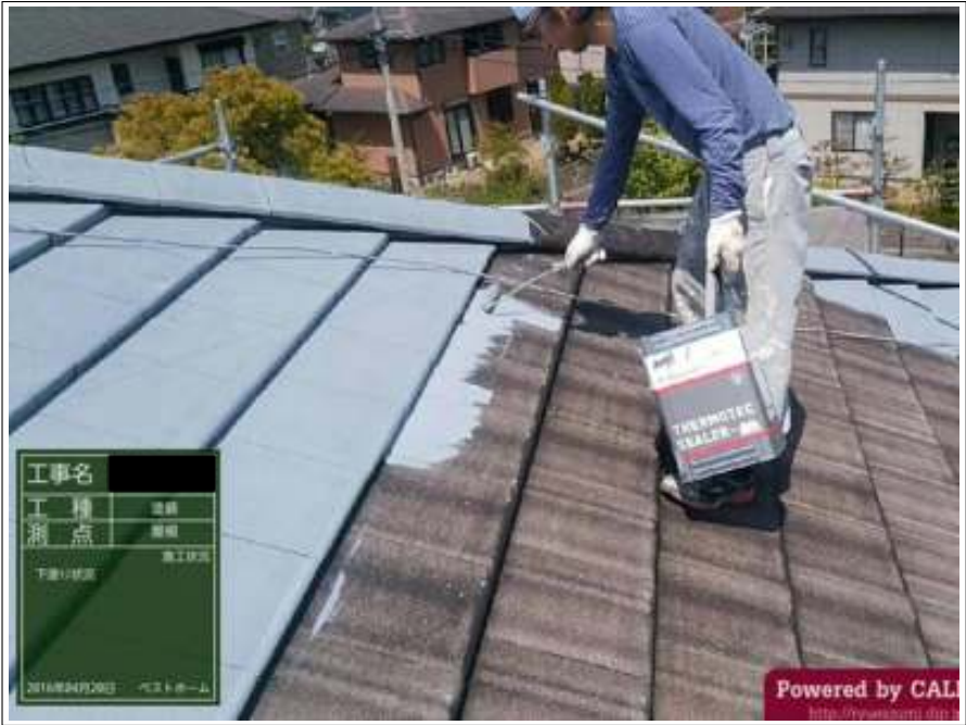
屋根 下塗り施工中
