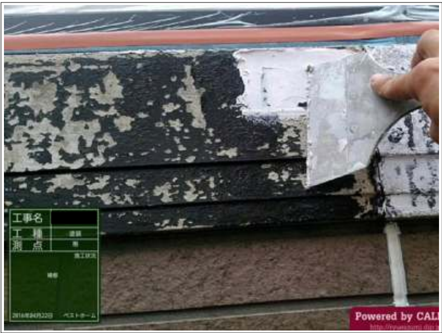
帯 パテ補修施工中
