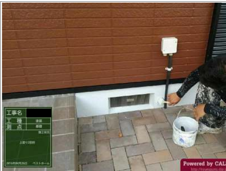
基礎塗り施工中
