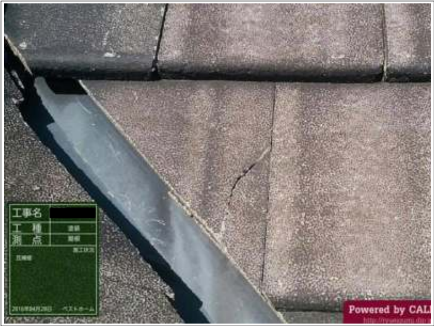
屋根 クラック補修施工前
