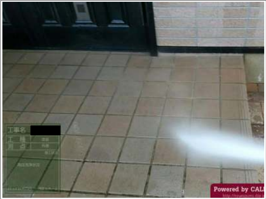
玄関床 高圧洗浄中
