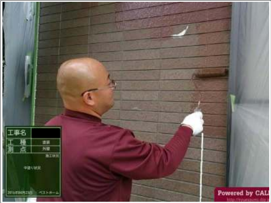
外壁 中塗り施工中
