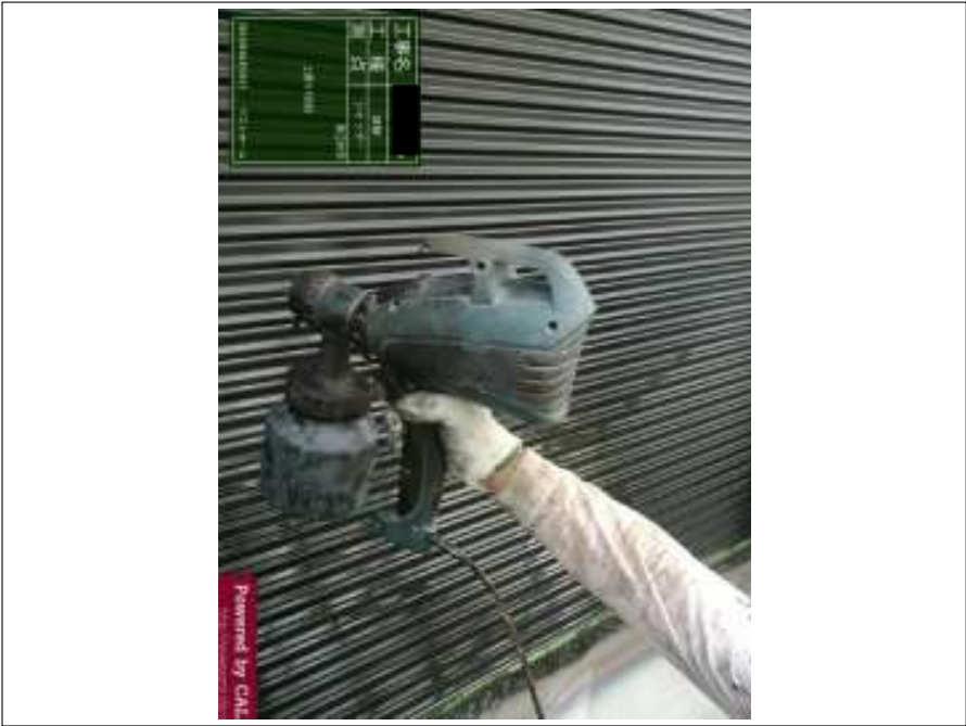
シャッター 上塗り (1回目) 施工中
