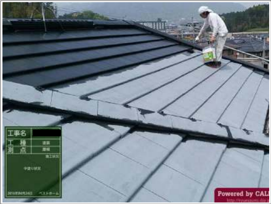
屋根 中塗り施工中
