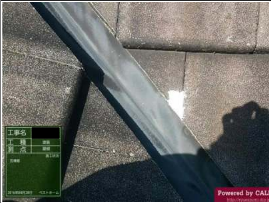
屋根 クラック補修施工後
