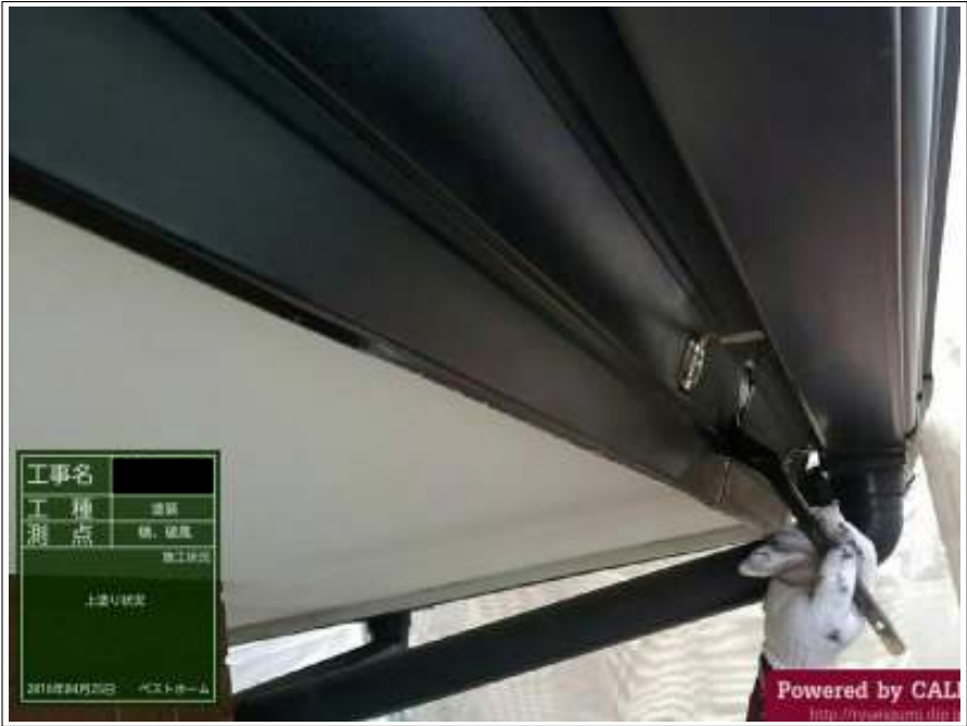
鼻かくし 上塗り 施工中
