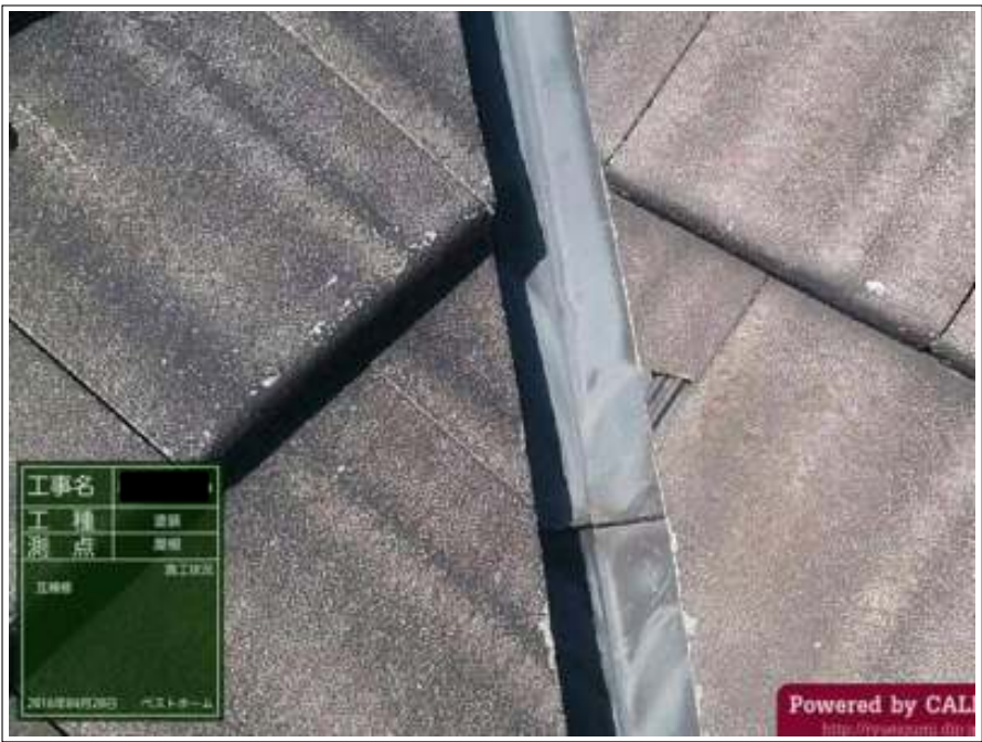
屋根 クラック補修施工前
