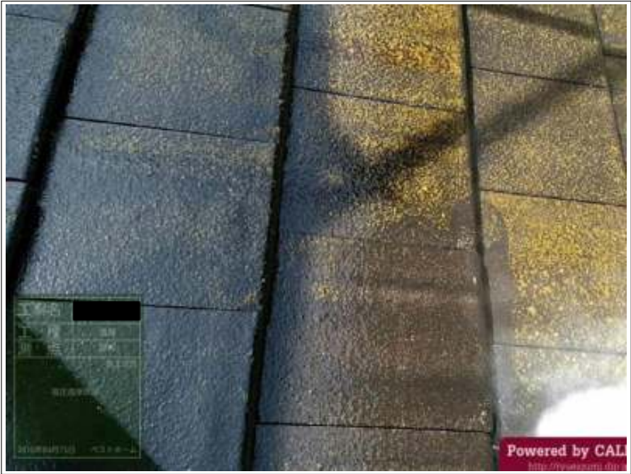
屋根 高圧洗浄中
