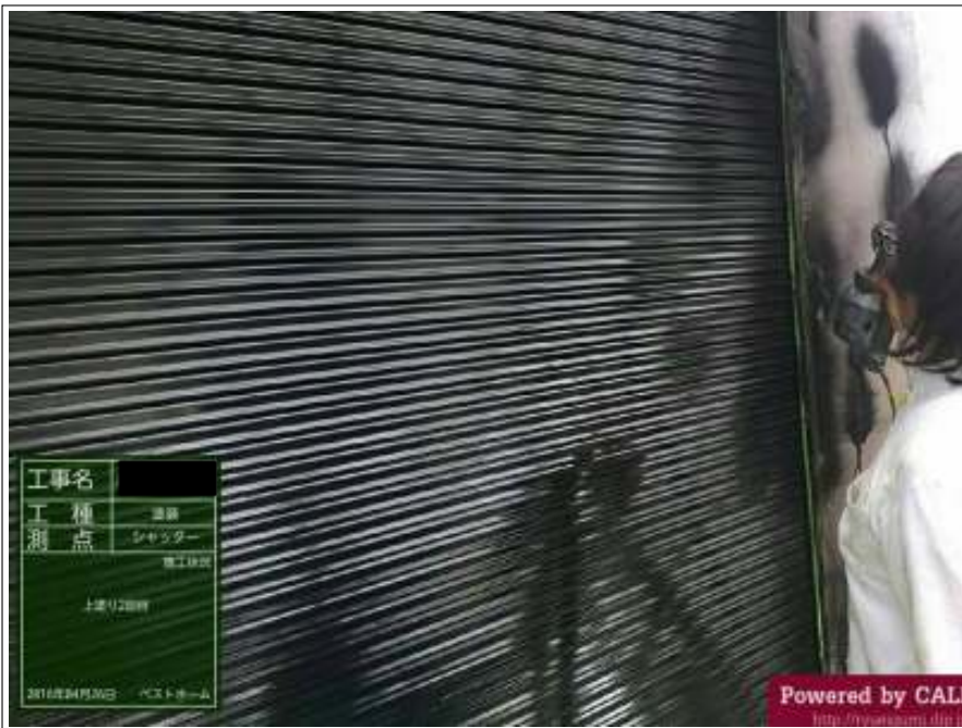
シャッター 上塗り (2回目) 施工中
