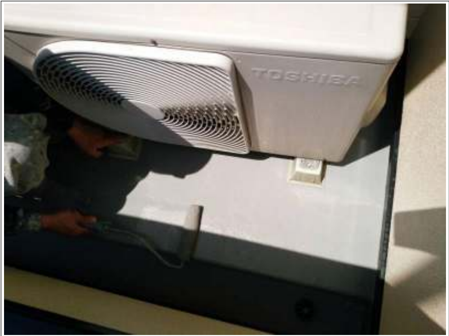
ベランダ床 施工中
