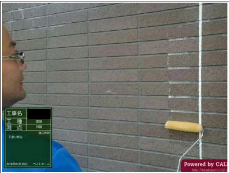
外壁 下塗り施工中
