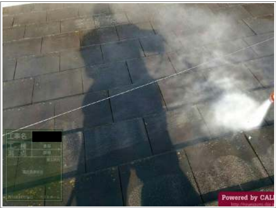
屋根 高圧洗浄中
