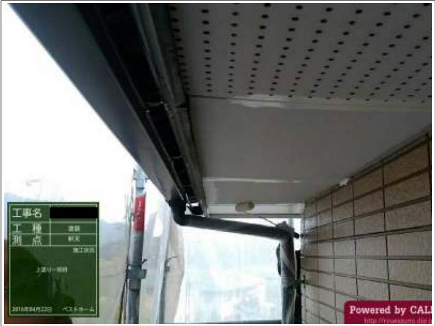
軒天 上塗り（1回目）施工中
