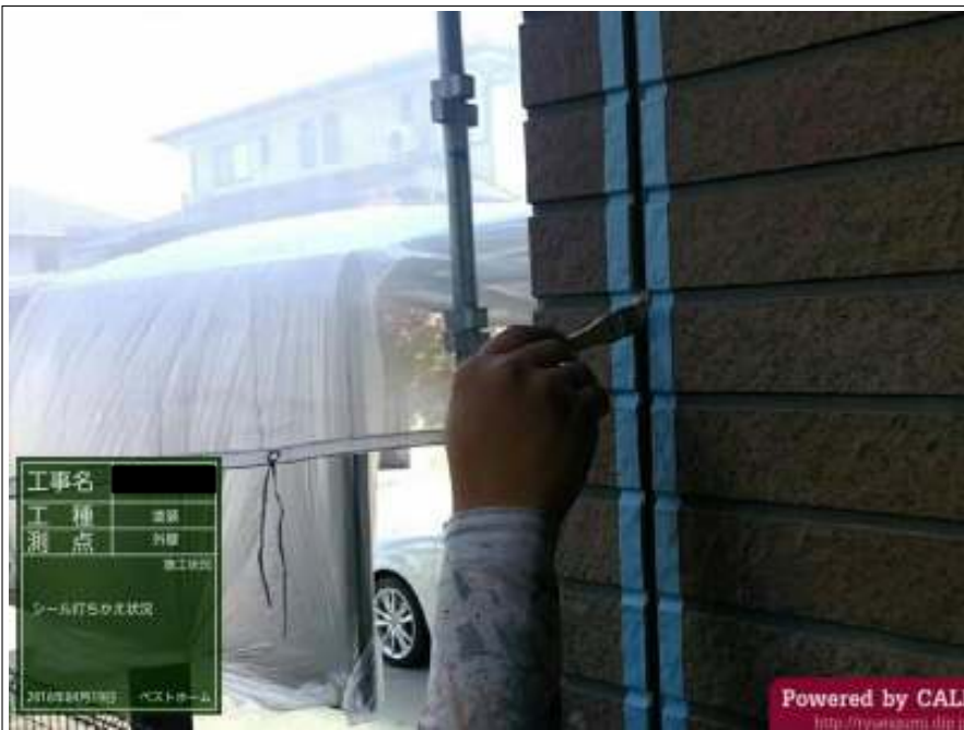
プライマー塗布施工中
