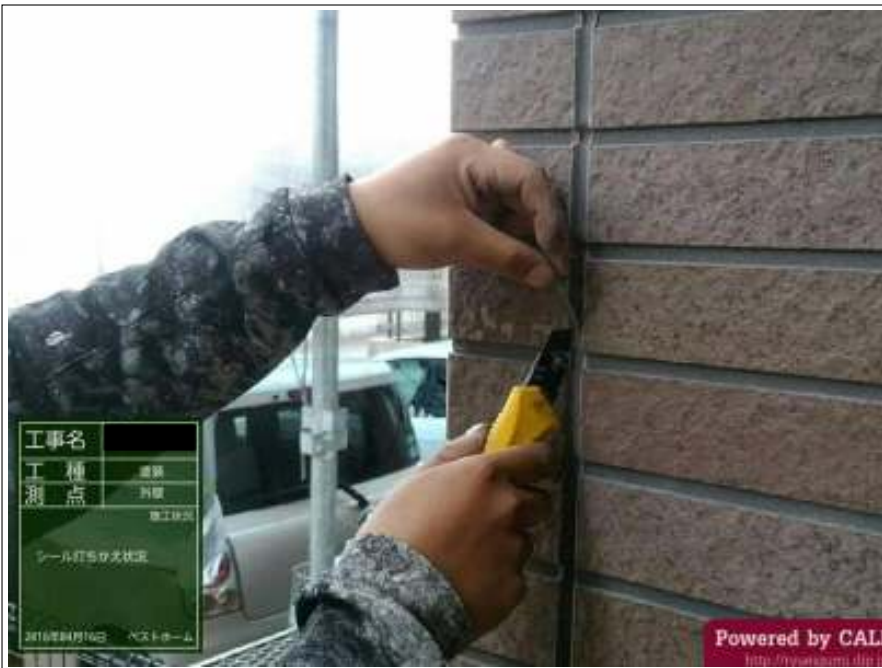
シーリング撤去施工中
