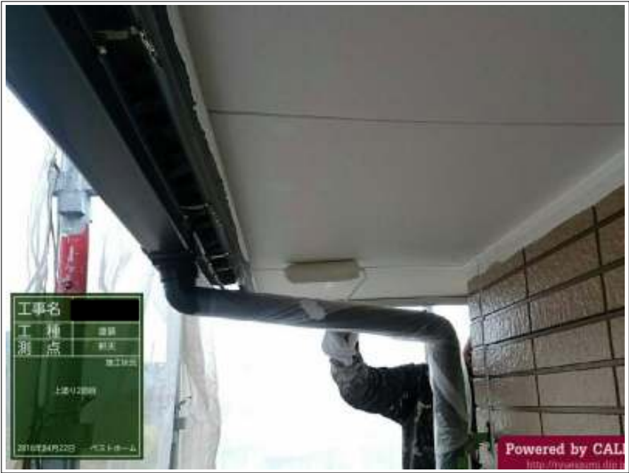
軒天 上塗り（2回目）施工中
