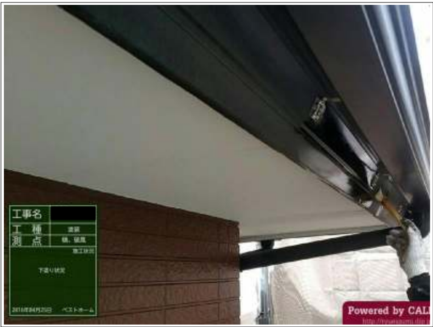
鼻かくし 下塗り 施工中
