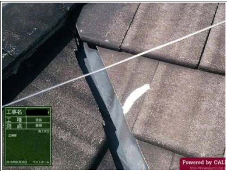
屋根 クラック補修施工後
