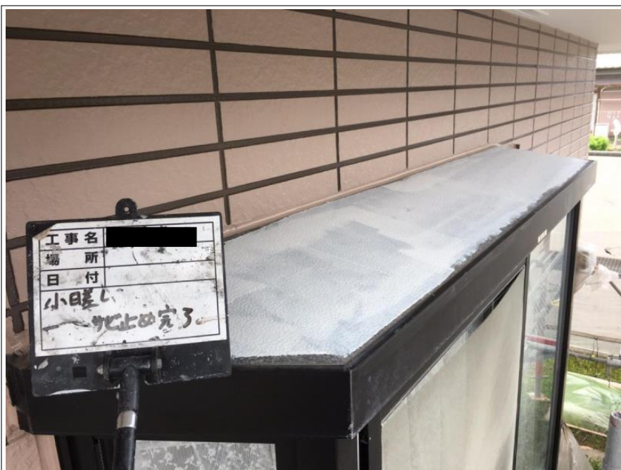
小庇 サビ止め塗布施工後
