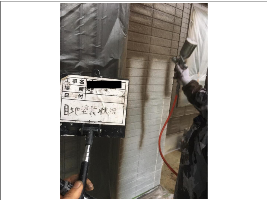
外壁 目地色施工中
