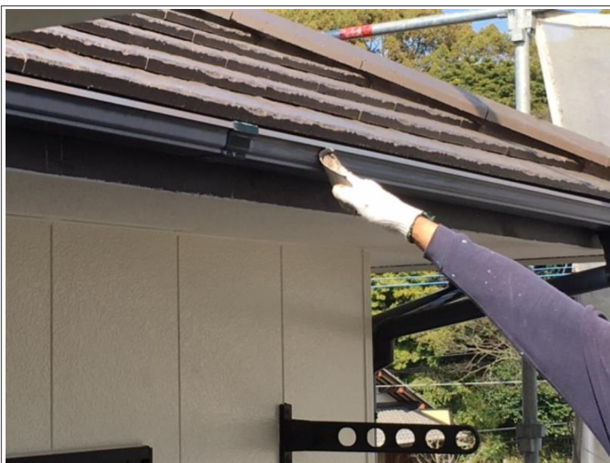
樋 ケレン処理施工中
