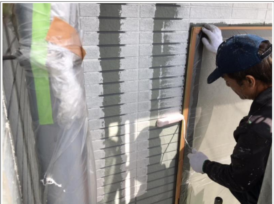
外壁 下塗り施工中
