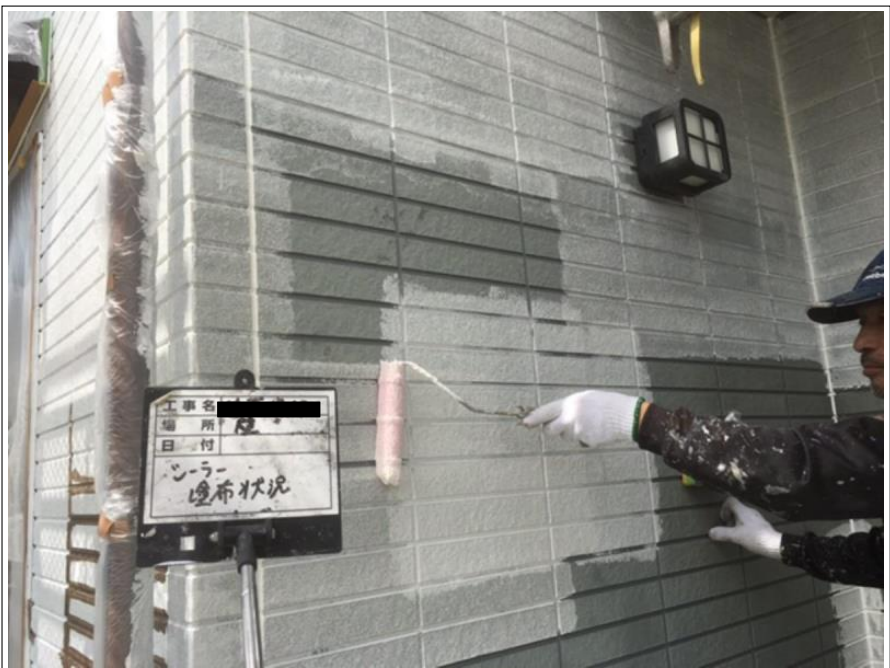
外壁 下塗り施工中
