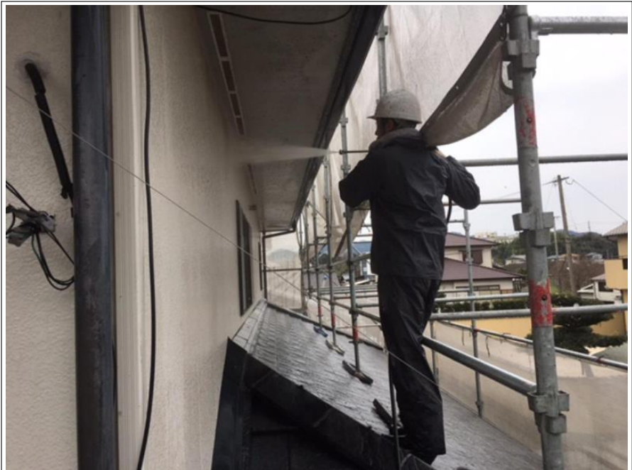
外壁 高圧洗浄中
