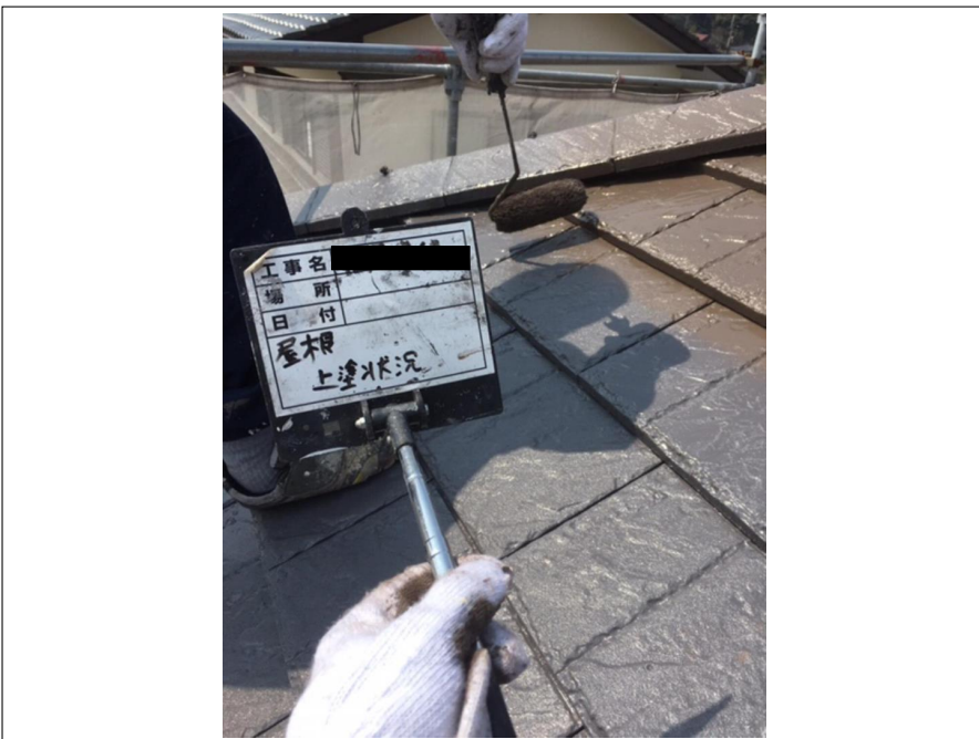
屋根 上塗り施工中
