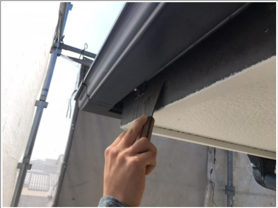
鼻隠し ケレン処理施工中
