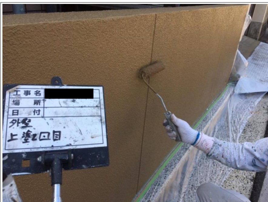
塀 上塗り（2回目）施工中
