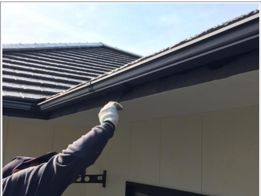
鼻隠し 上塗り施工中
