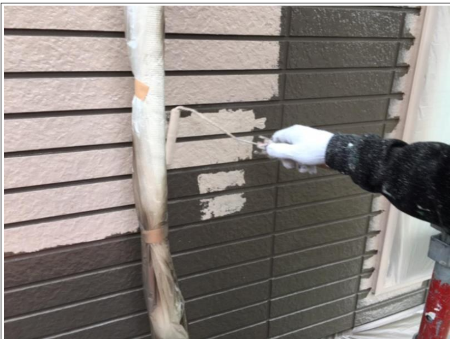
外壁 上塗り（1回目）施工中
