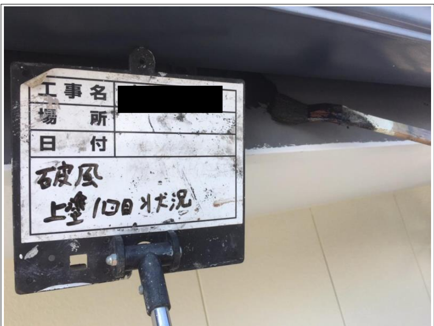
破風板 上塗り（1回目）施工中
