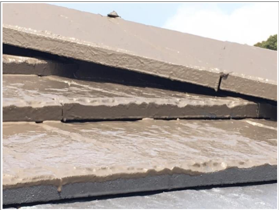
屋根 上塗り施工中
