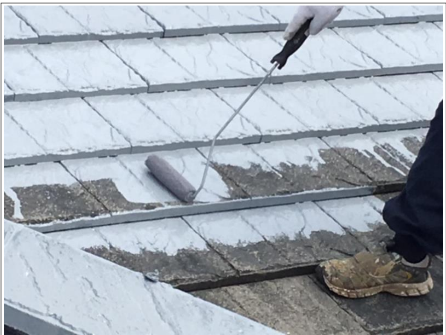
屋根 下塗り施工中
