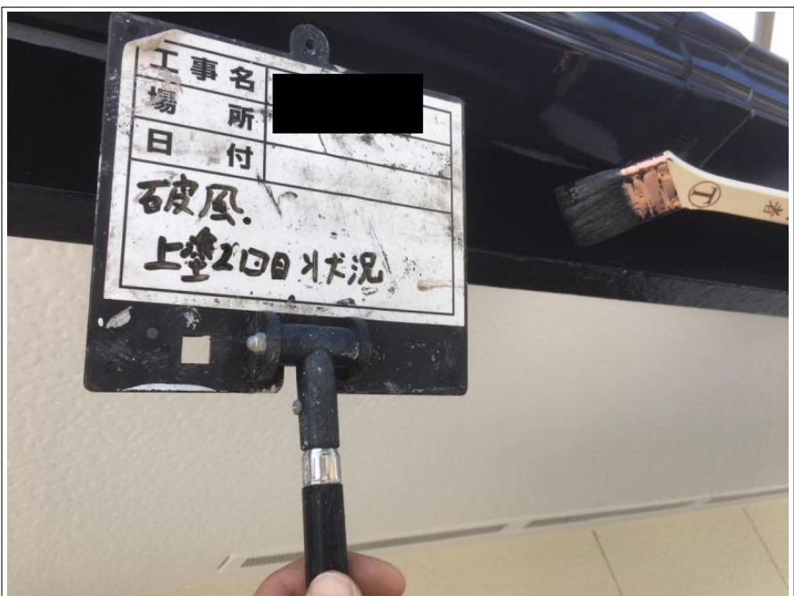
破風板 上塗り（2回目）施工中
