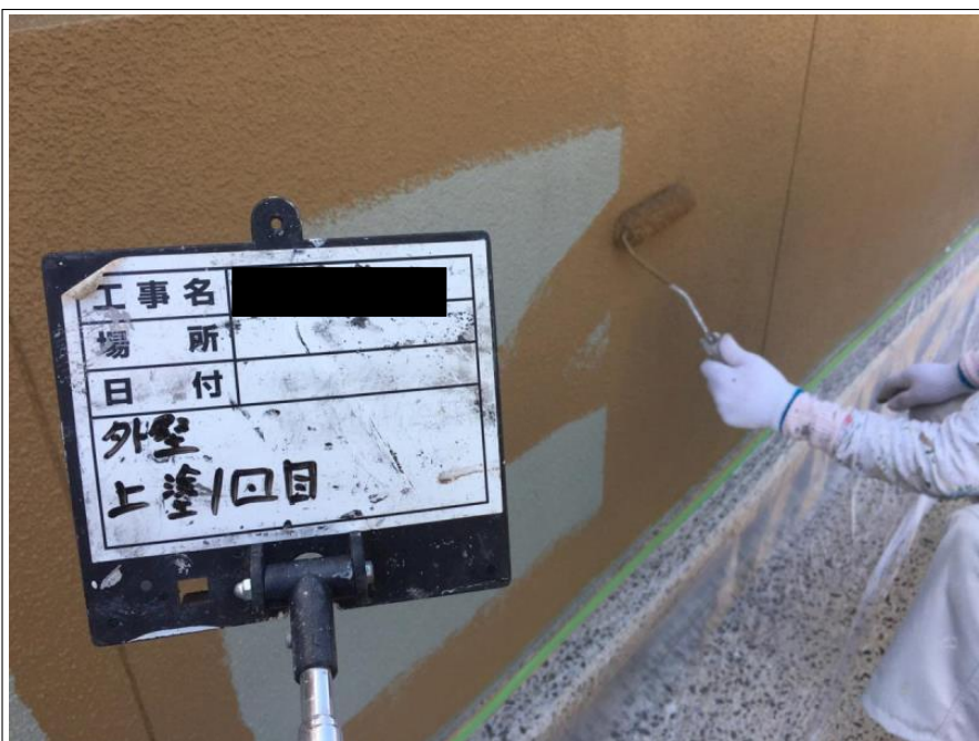
塀 上塗り（1回目）施工中
