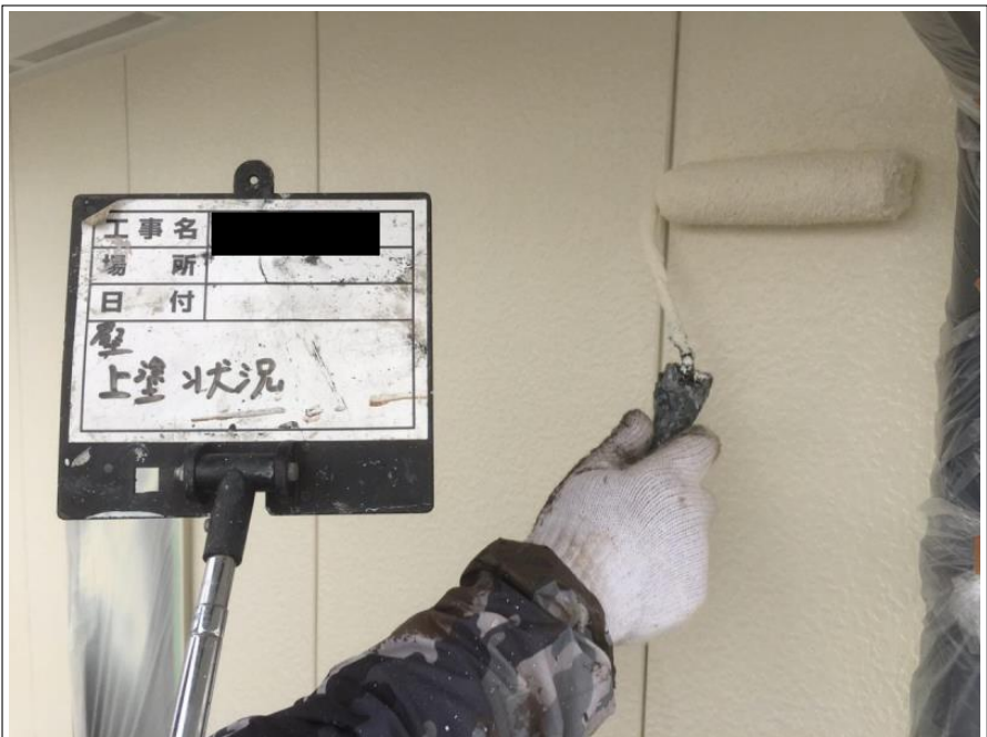
外壁 上塗り施工中
