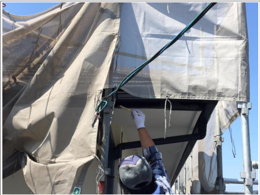
鼻隠し 上塗り施工中
