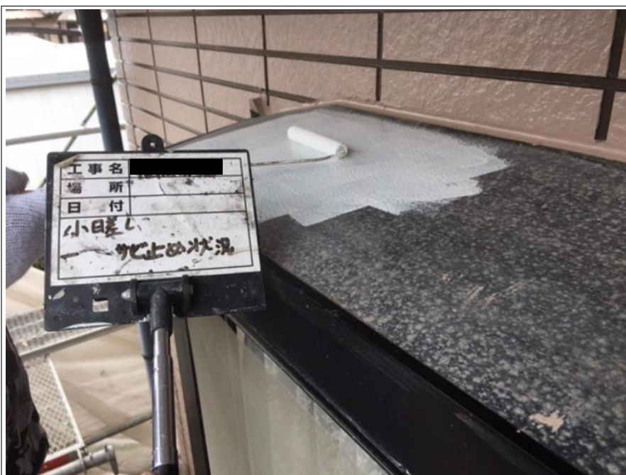
小庇 サビ止め塗布施工中
