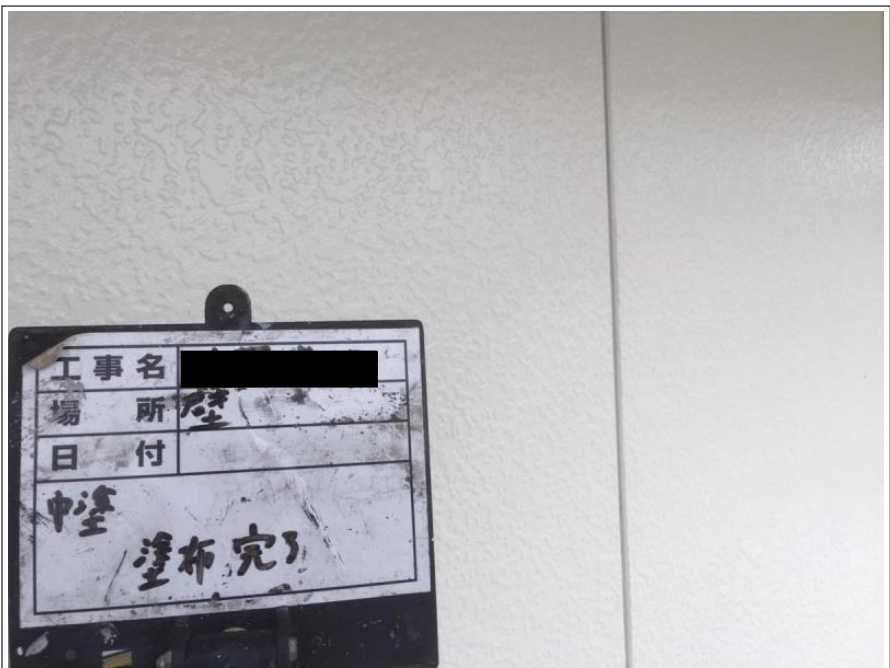
外壁 中塗り施工後
