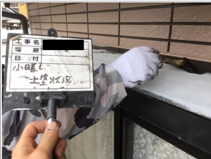
小庇 上塗り施工中
