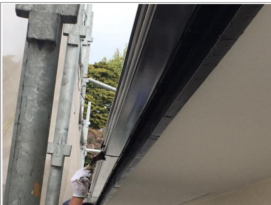
樋 上塗り施工中
