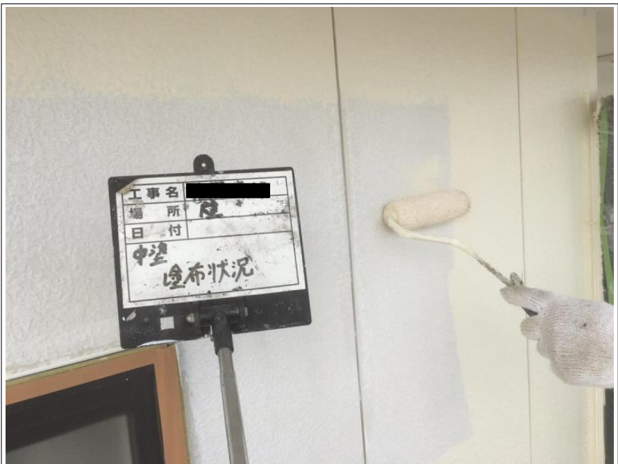
外壁 中塗り施工中
