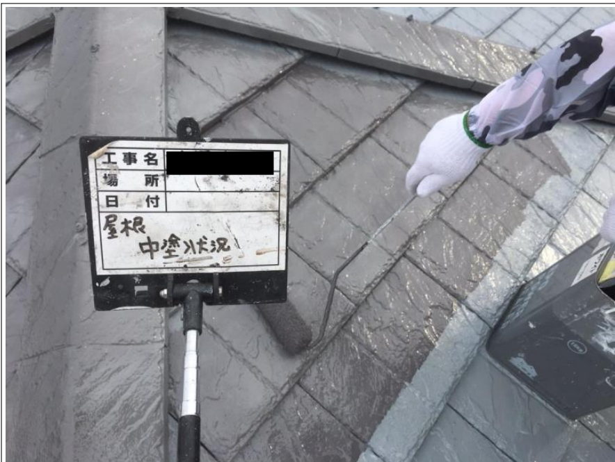
屋根 中塗り施工中
