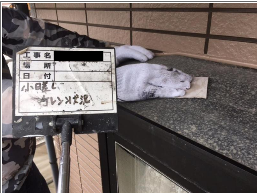
小庇 ケレン処理施工中
