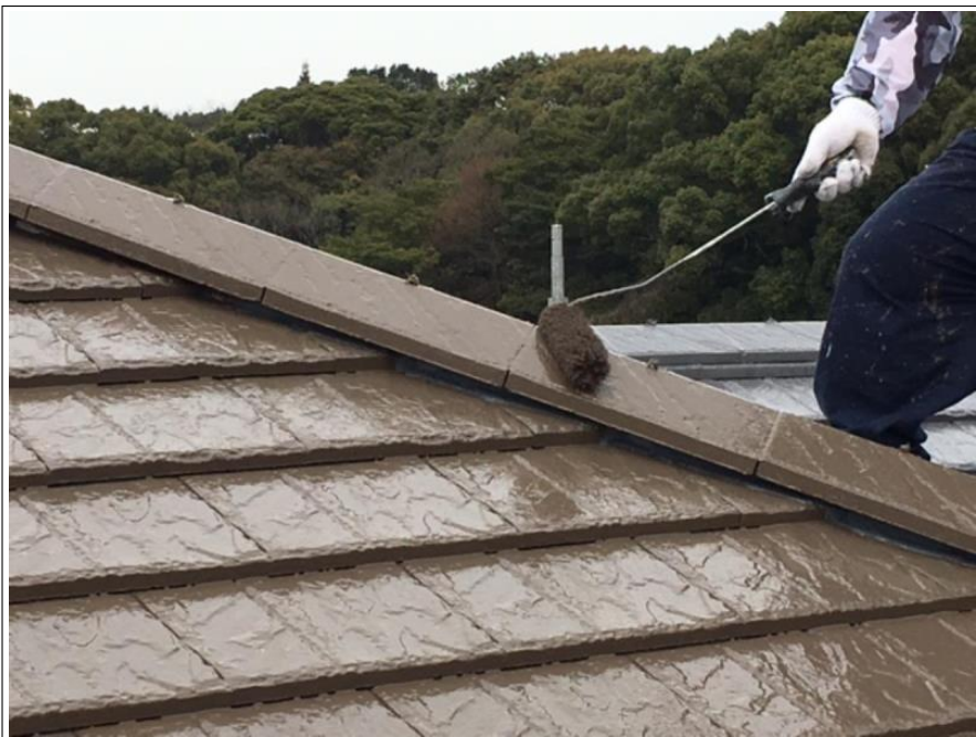
屋根板金部 中塗り施工中
