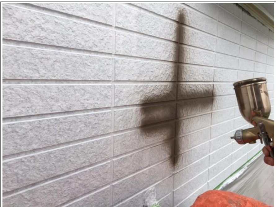
外壁 目地色施工中
