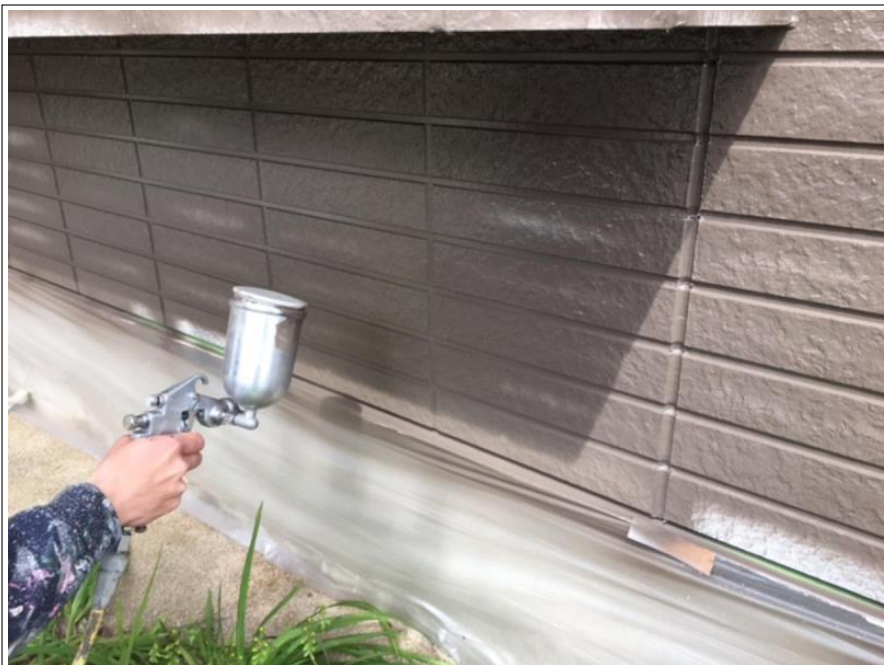
外壁 目地色施工中
