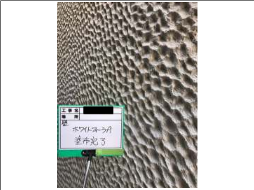
外壁 下塗り施工後
