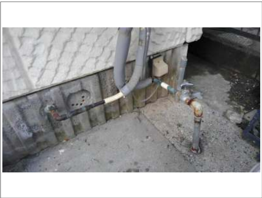
保温カバー巻き直し 施工中
