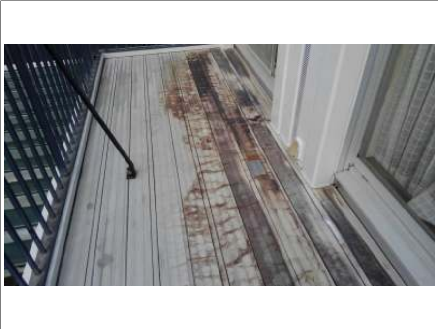
ベランダ 施工前
