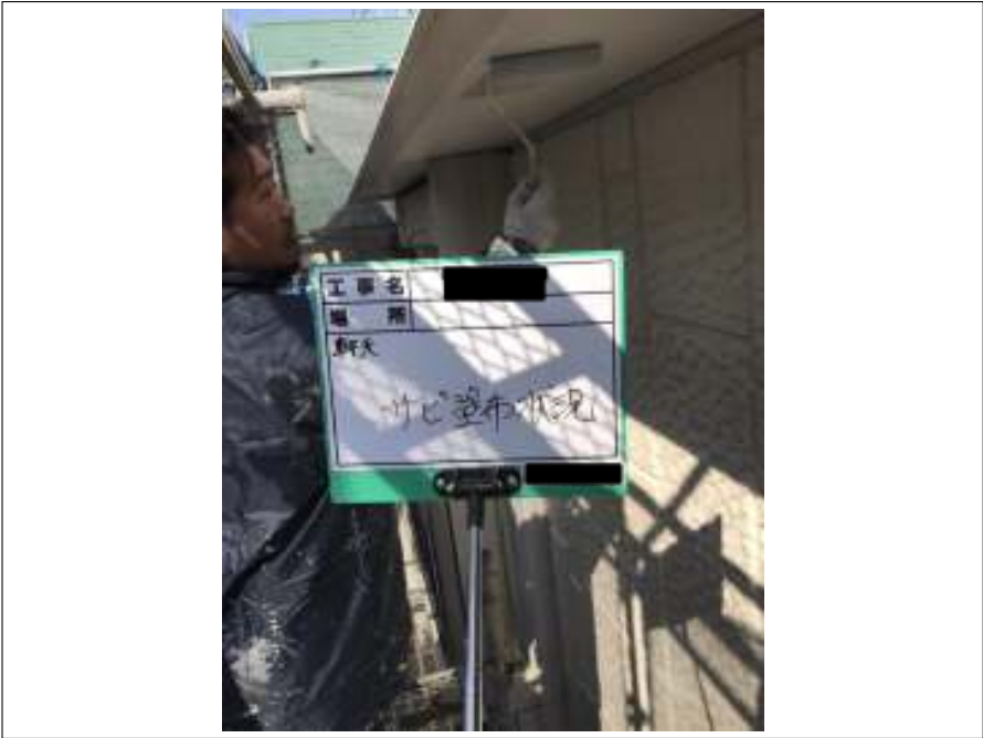
軒天 サビ止め塗布施工中
