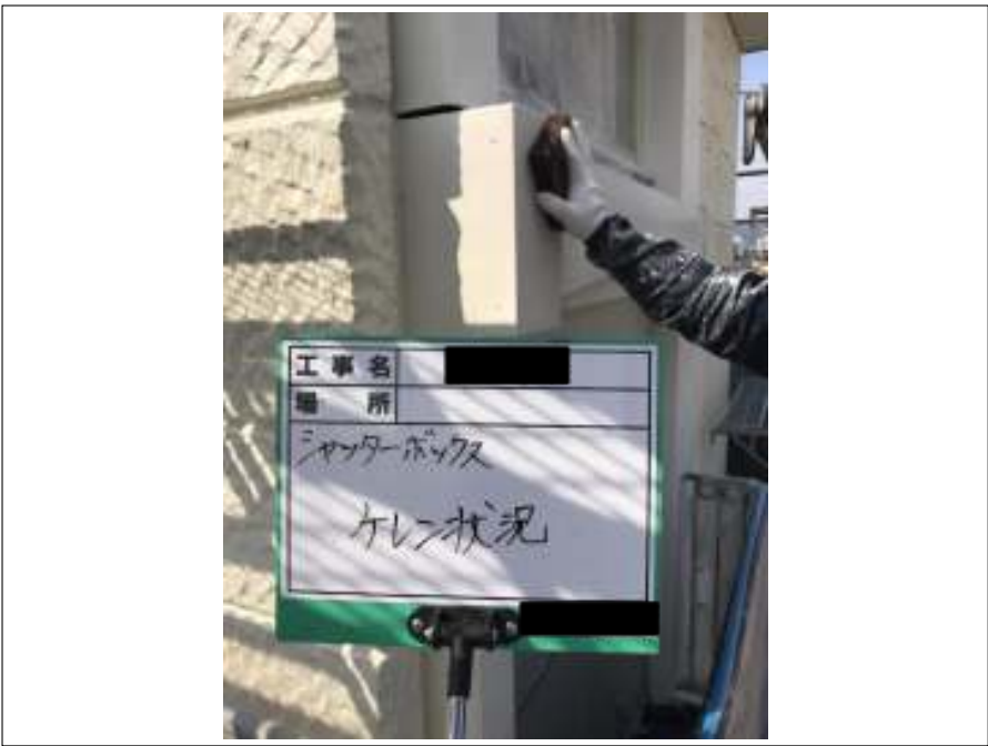
シャッター・シャッターBOX ケレン処理施工中
