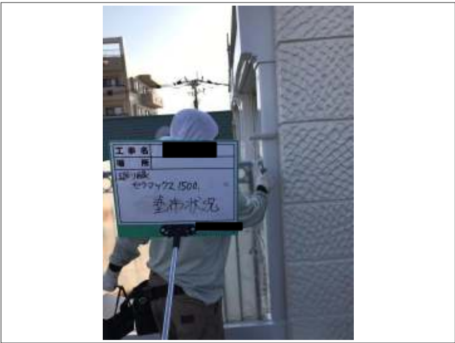
廻り縁 上塗り施工中
