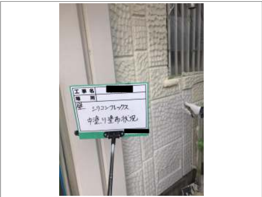
外壁 中塗り施工中
