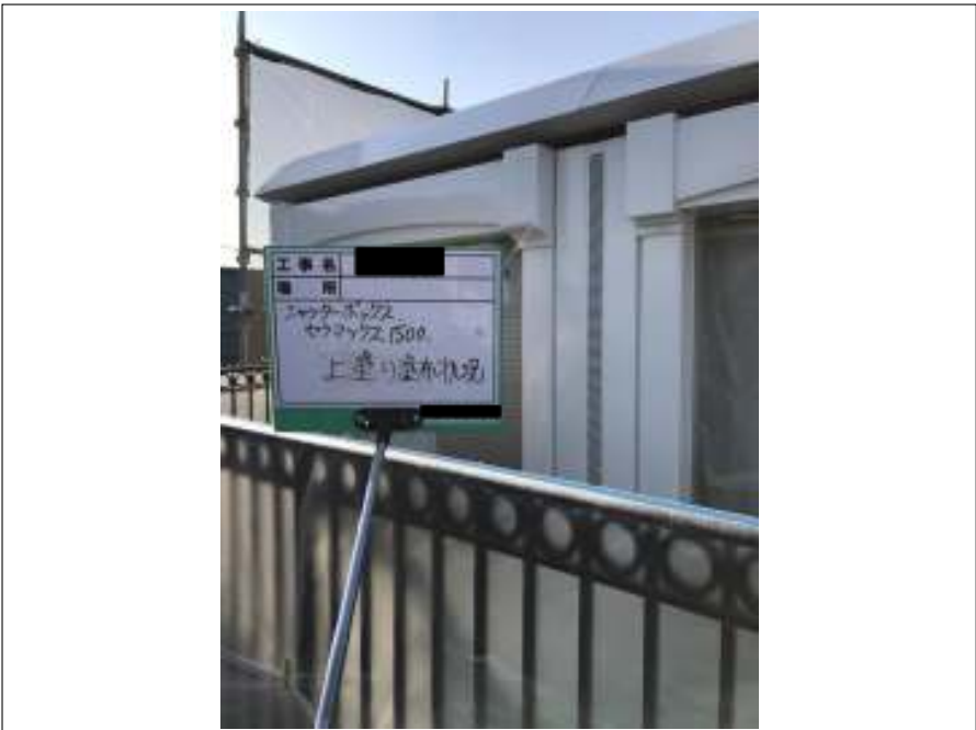
シャッター・シャッターBOX 上塗り施工中
