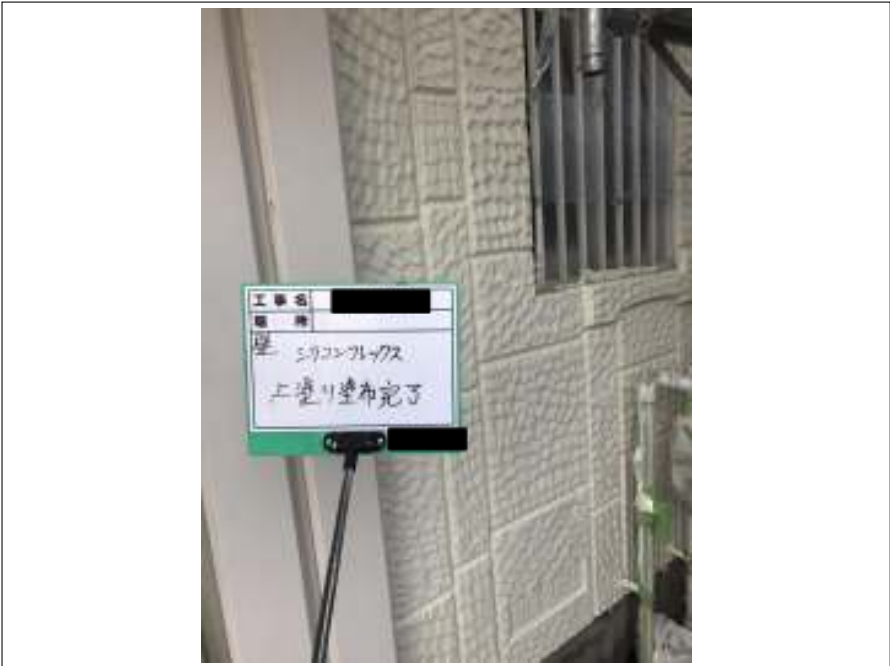
外壁 上塗り施工後
