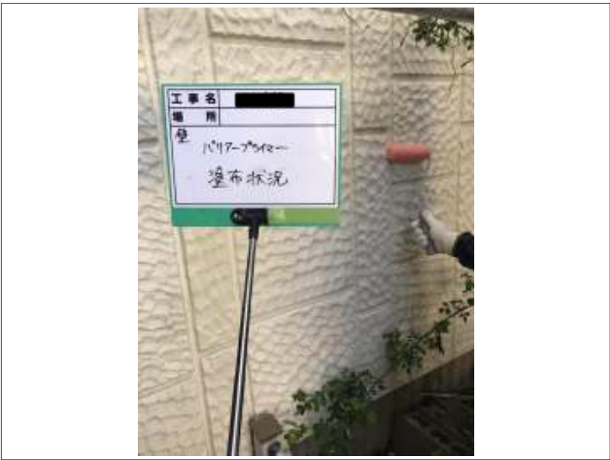
外壁 バリアー塗布施工中
