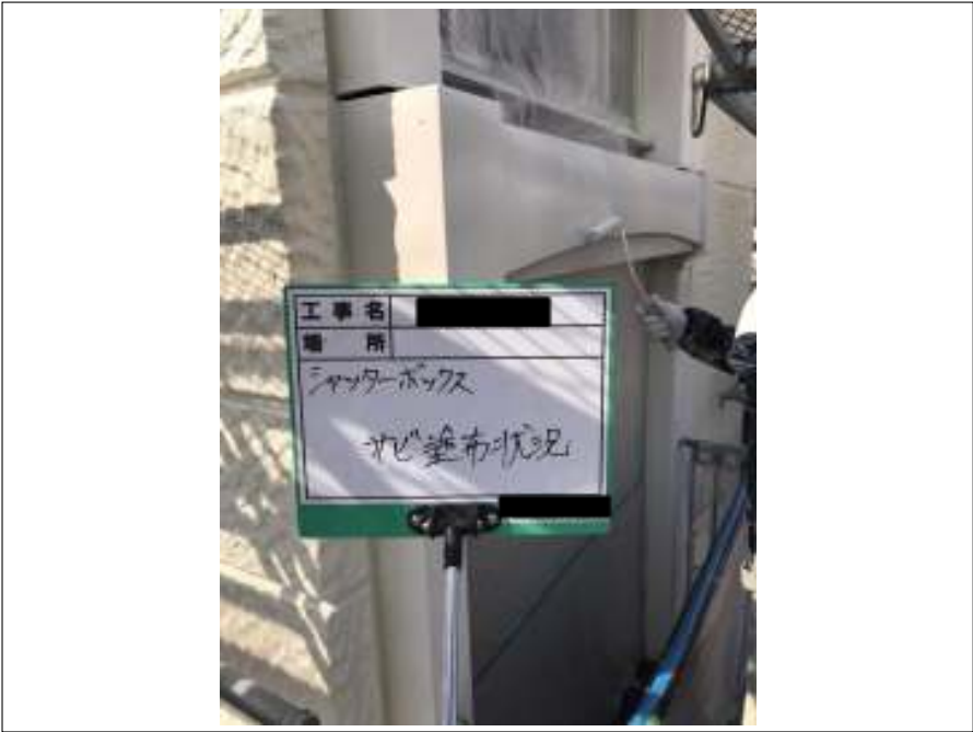
シャッター・シャッターBOX サビ止め塗布施工中
