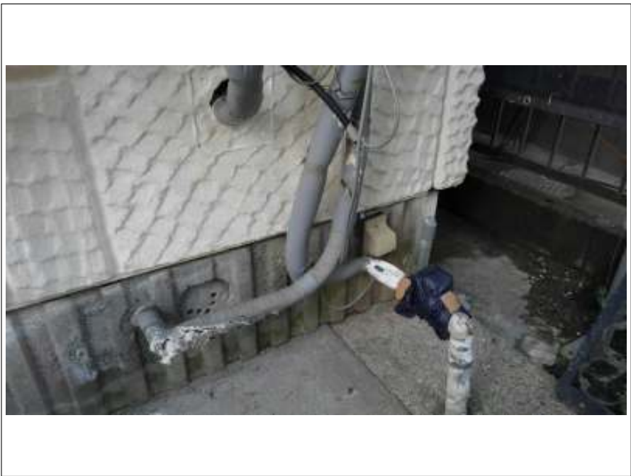
保温カバー巻き直し 施工前
