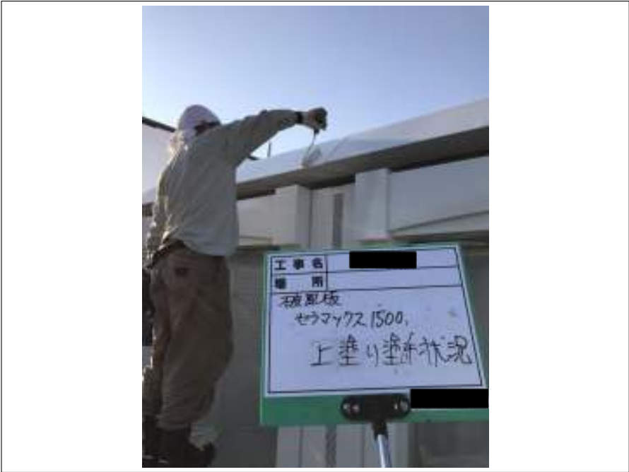
破風板 上塗り施工中
