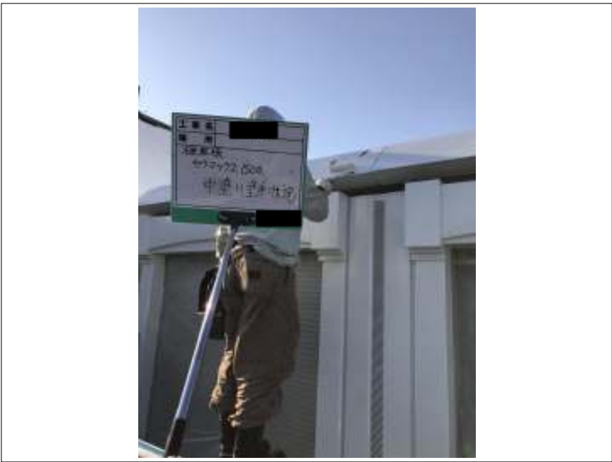
破風板 中塗り施工中
