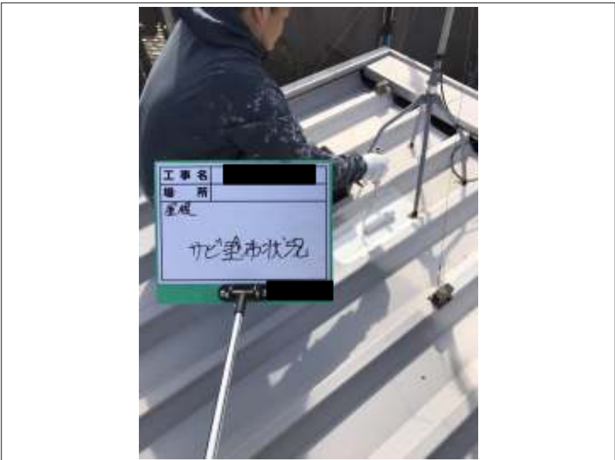
屋根 サビ止め塗布施工中
