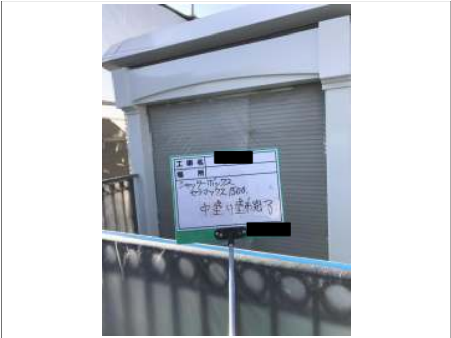
シャッター・シャッターBOX 中塗り施工後
