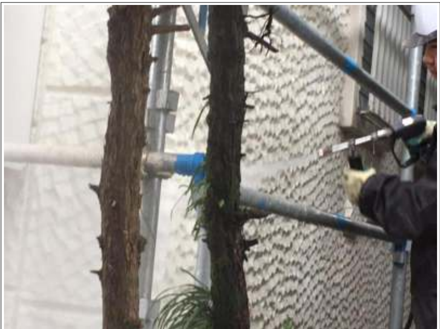
外壁 高圧洗浄中
