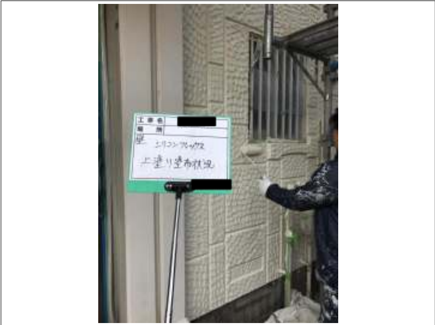
外壁 上塗り施工中
