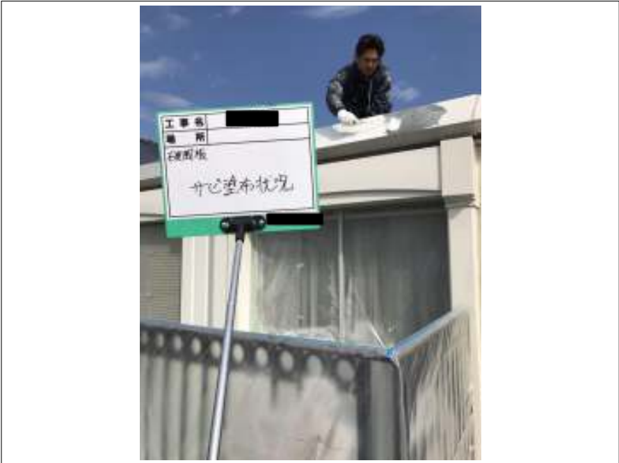
破風板 サビ止め塗布施工中
