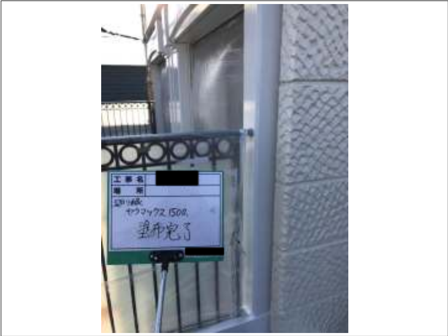
廻り縁 上塗り施工後
