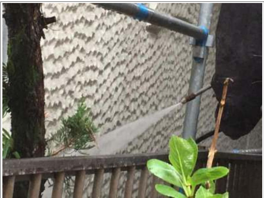
外壁 高圧洗浄中
