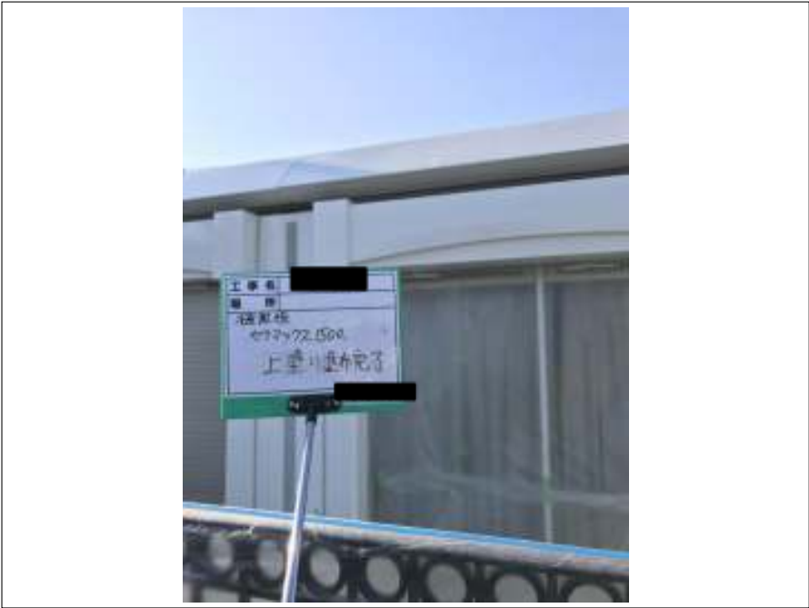
破風板 上塗り施工後
