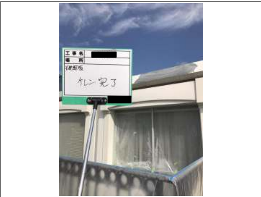
破風板 ケレン処理施工後
