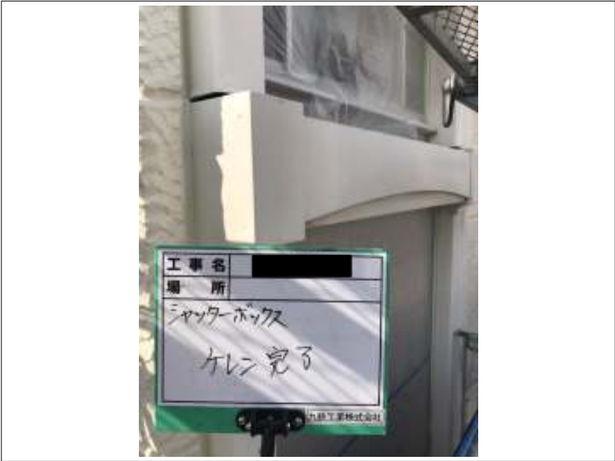
シャッター・シャッターBOX ケレン処理施工後
