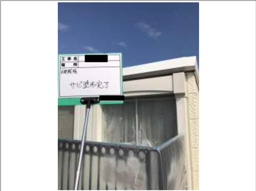
破風板 サビ止め塗布施工後
