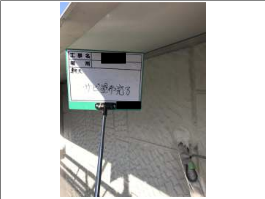
軒天 サビ止め塗布施工後
