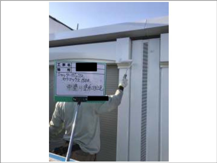
シャッター・シャッターBOX 中塗り施工中
