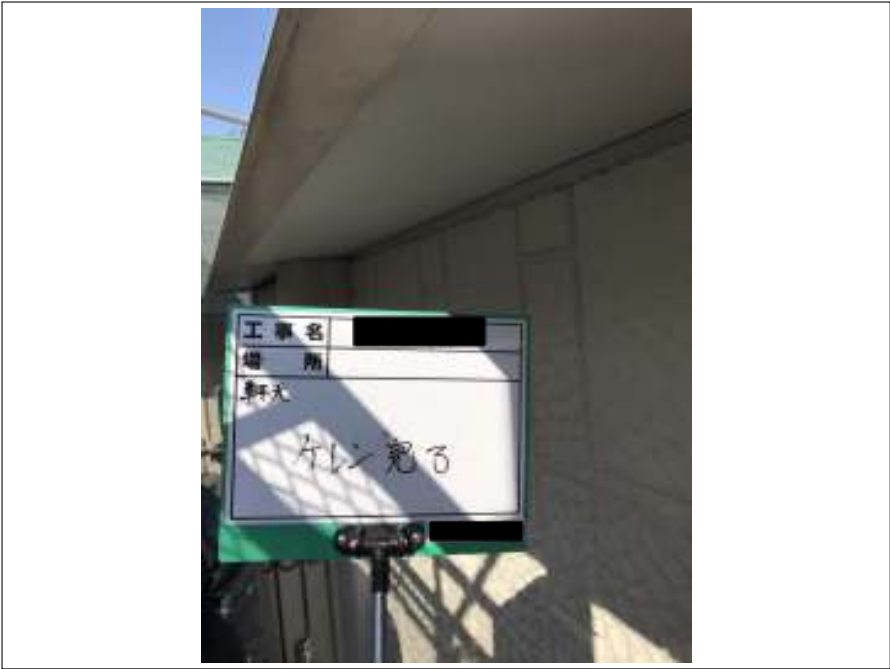
軒天 ケレン処理施工後
