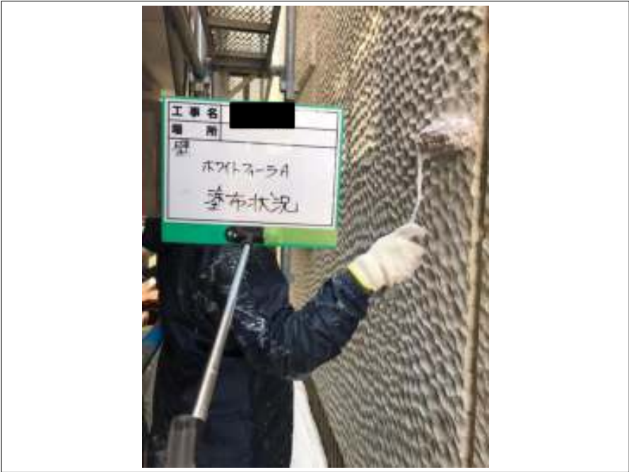
外壁 下塗り施工中
