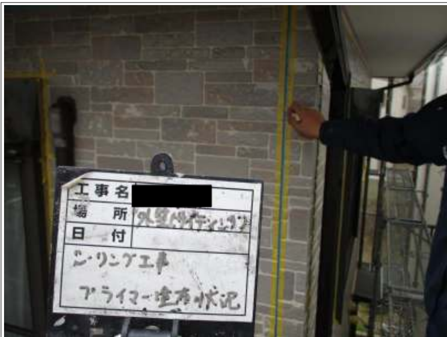
プライマー塗布
