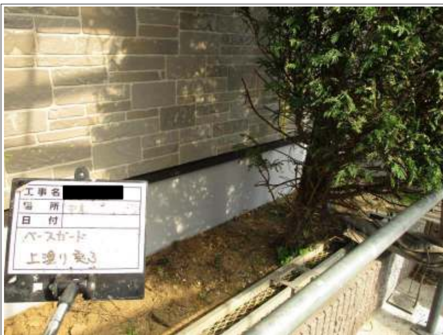
基礎 上塗り施工後
