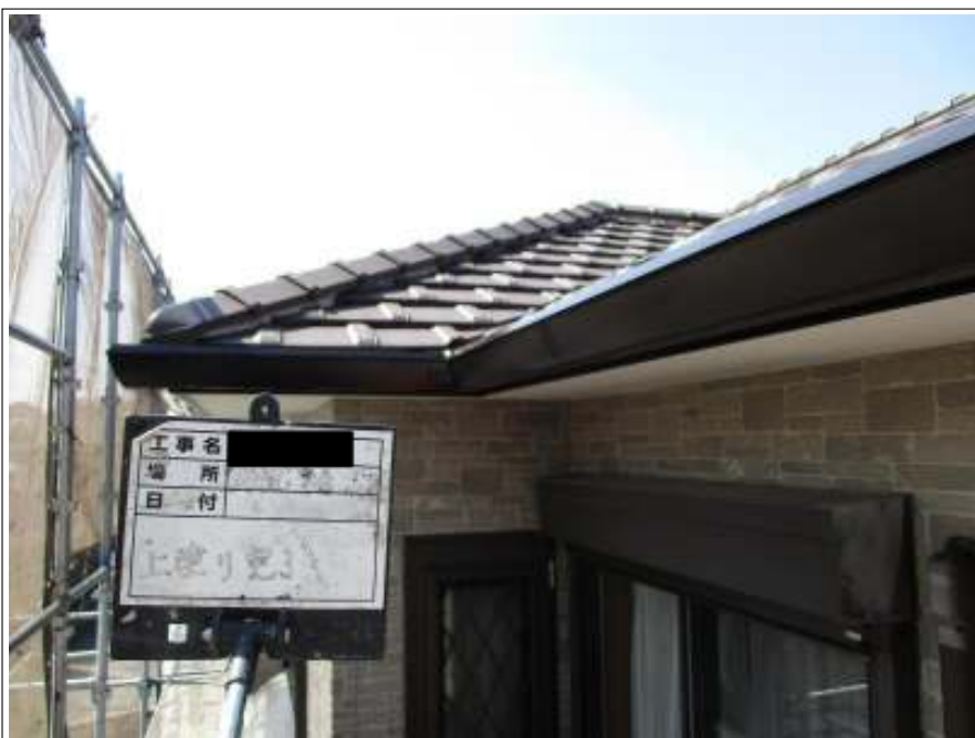
破風板・樋 上塗り施工後
