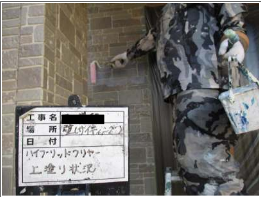
外壁 上塗り施工中
