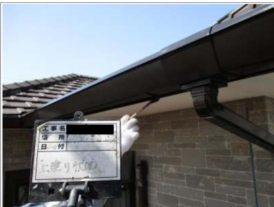
破風板・樋 上塗り施工中
