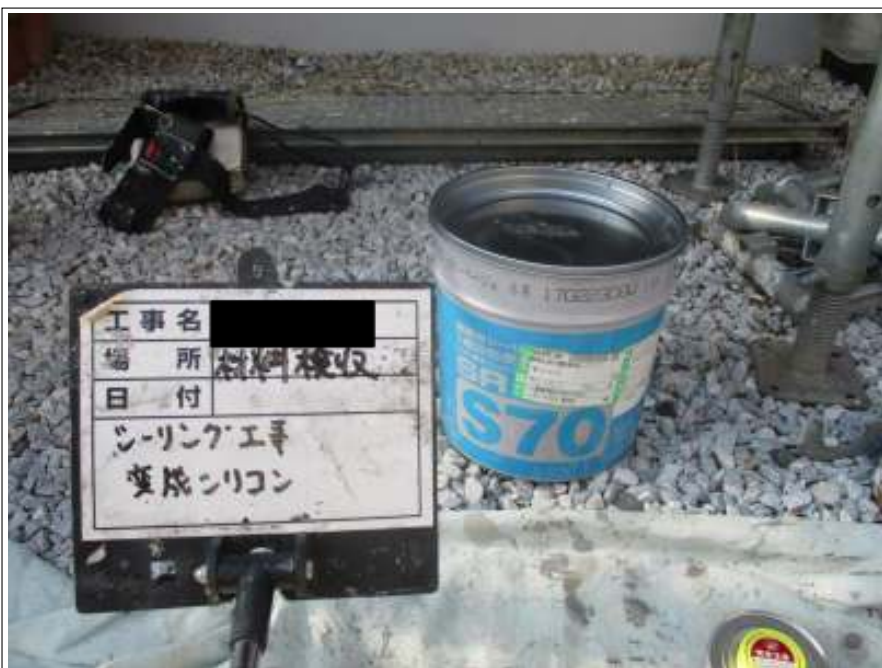
シーリング打ち替え 使用材料
