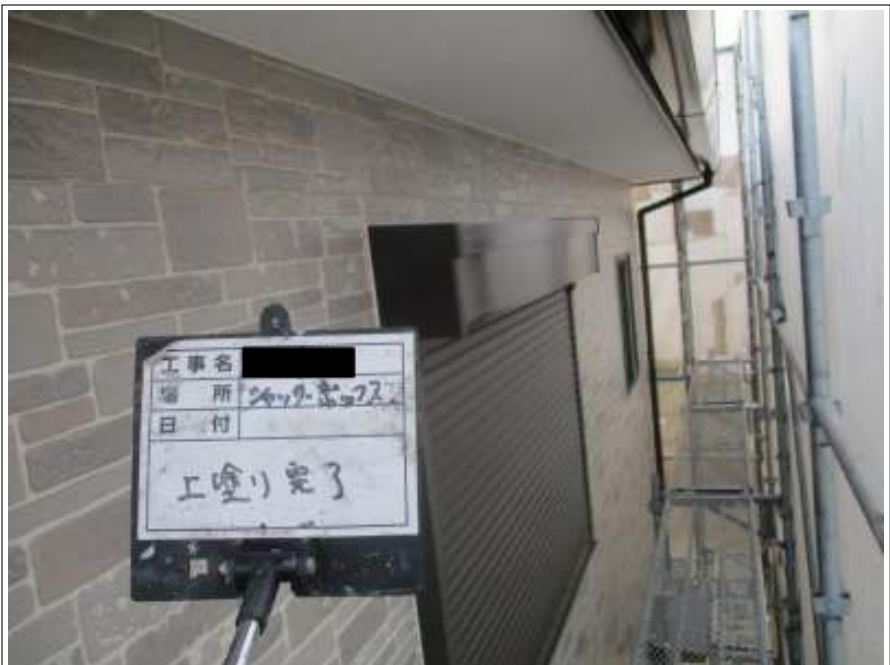
シャッター 上塗り施工後
