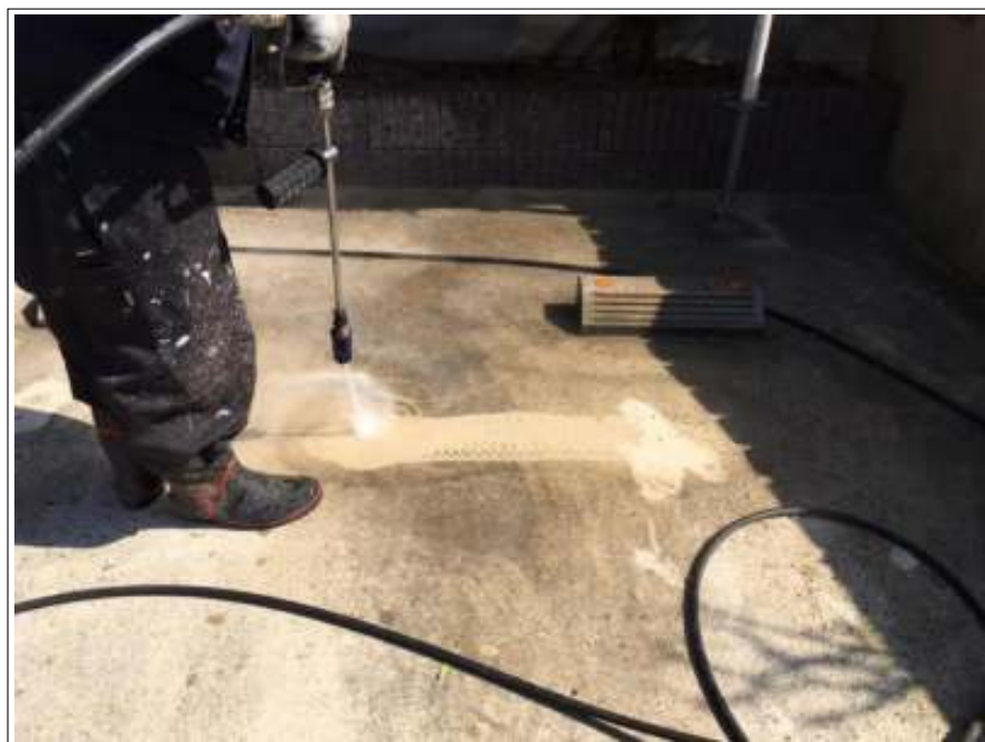
土間 高圧洗浄中
