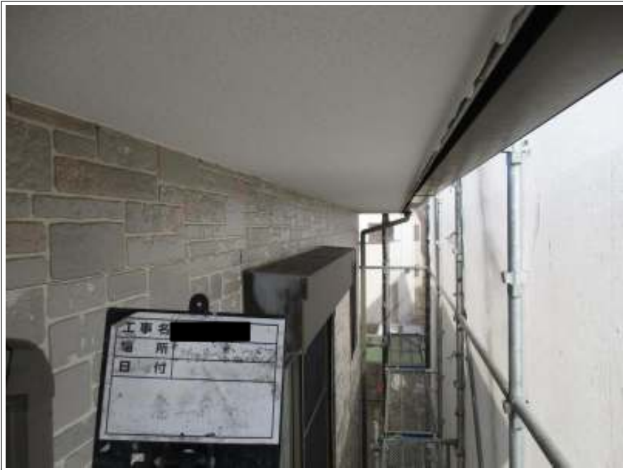
シャッター 施工前
