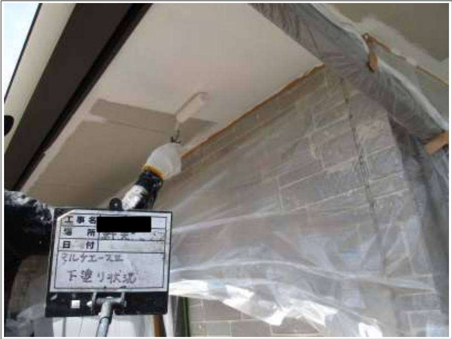
軒天 下塗り施工中
