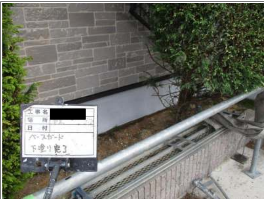
基礎 下塗り施工後
