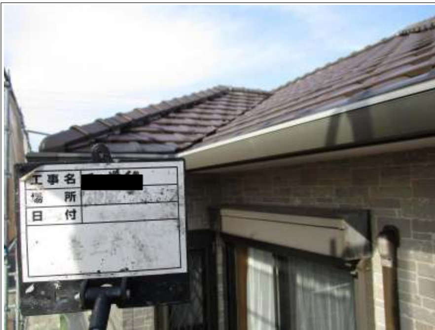
破風板・樋 施工前
