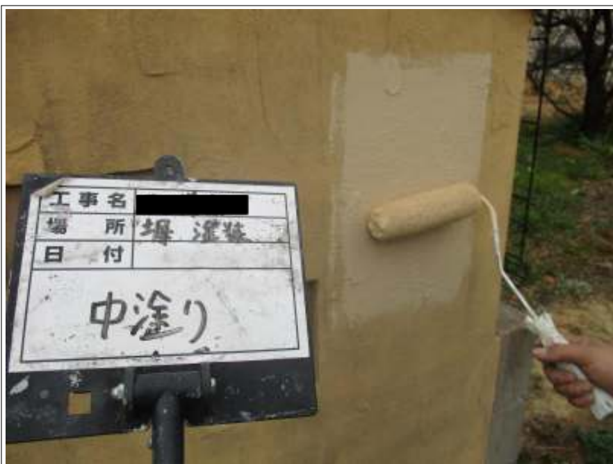
塀 中塗り施工中
