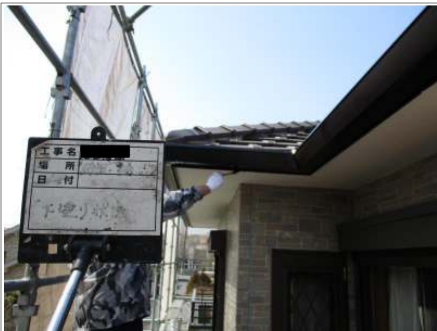
破風板・樋 下塗り施工中
