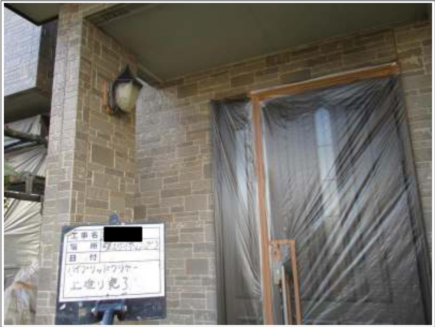
外壁 上塗り施工後
