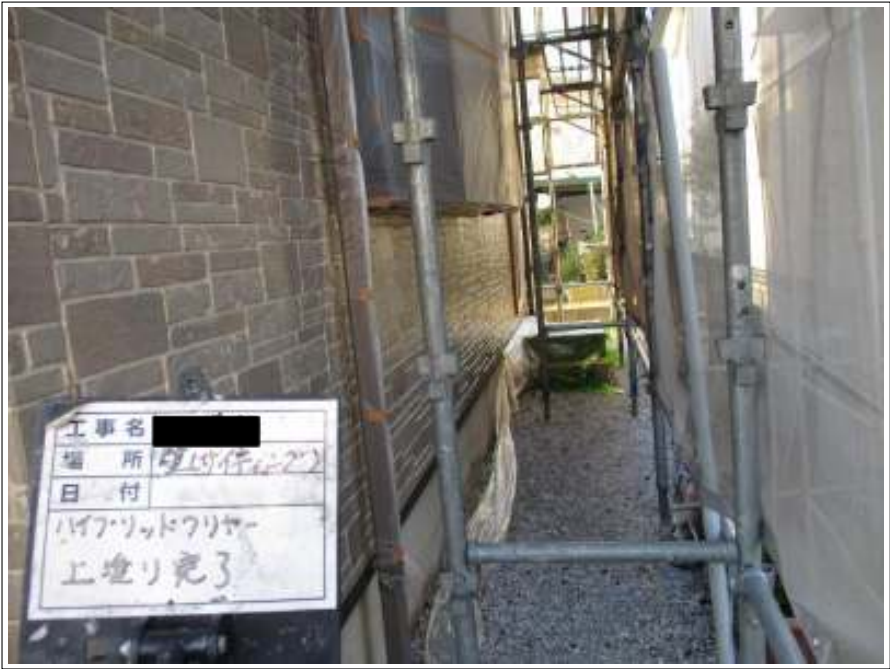
外壁 上塗り施工後
