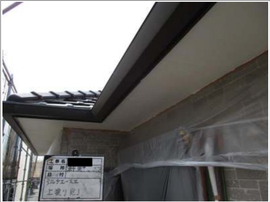
軒天 上塗り施工後
