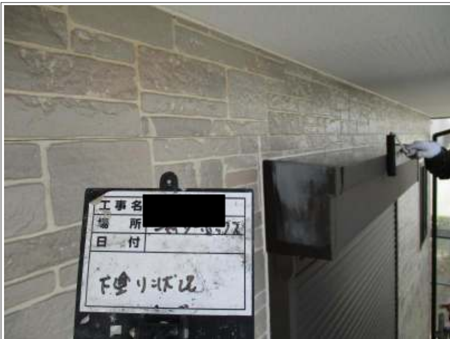
シャッター 下塗り施工中
