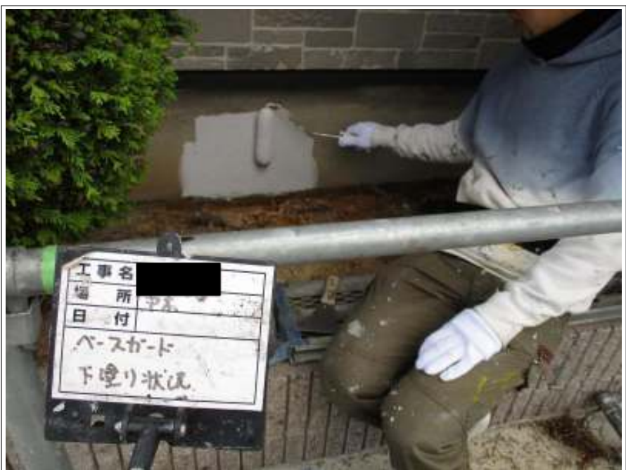
基礎 下塗り施工中
