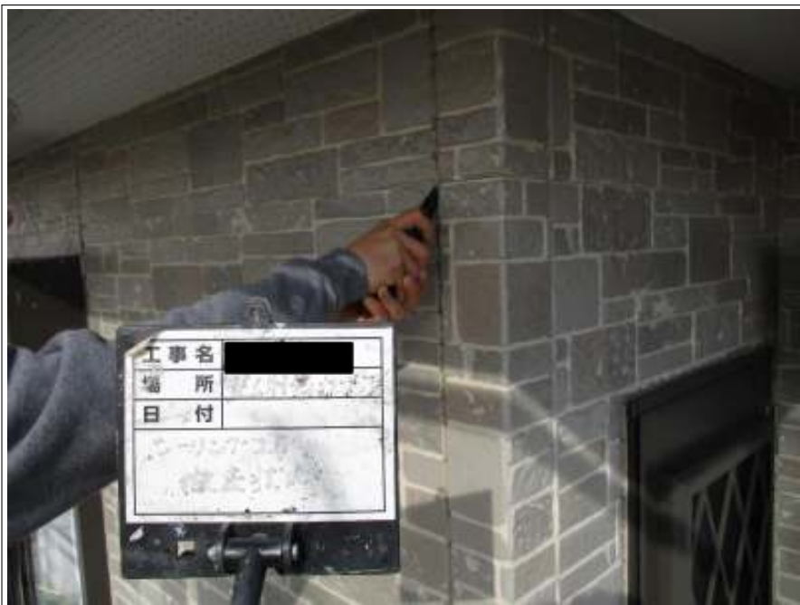
既存シーリング撤去
