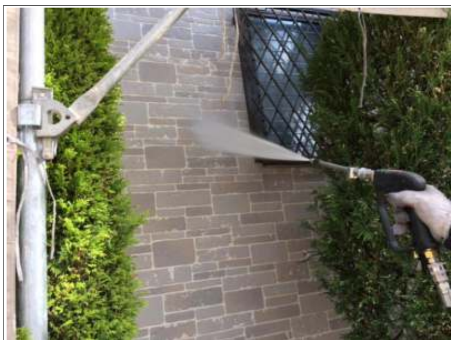
外壁 高圧洗浄中
