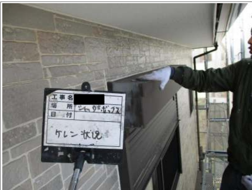
シャッター ケレン処理
