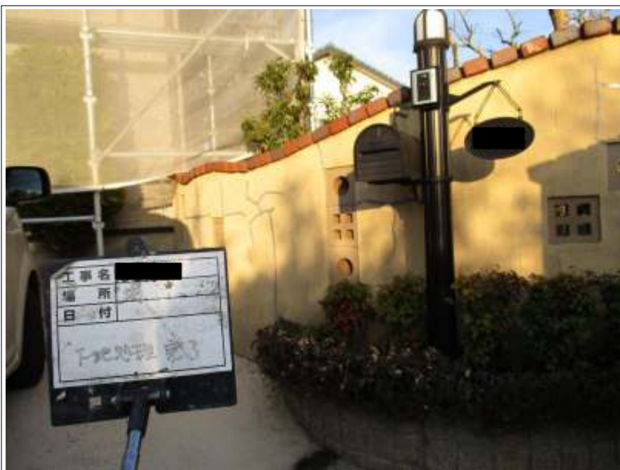
塀 クラック補修施工後
