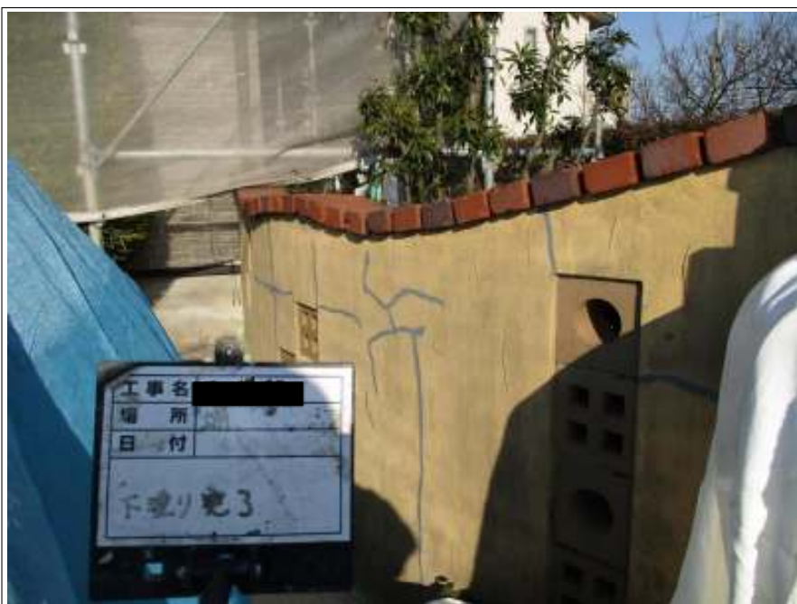
塀 下塗り施工後
