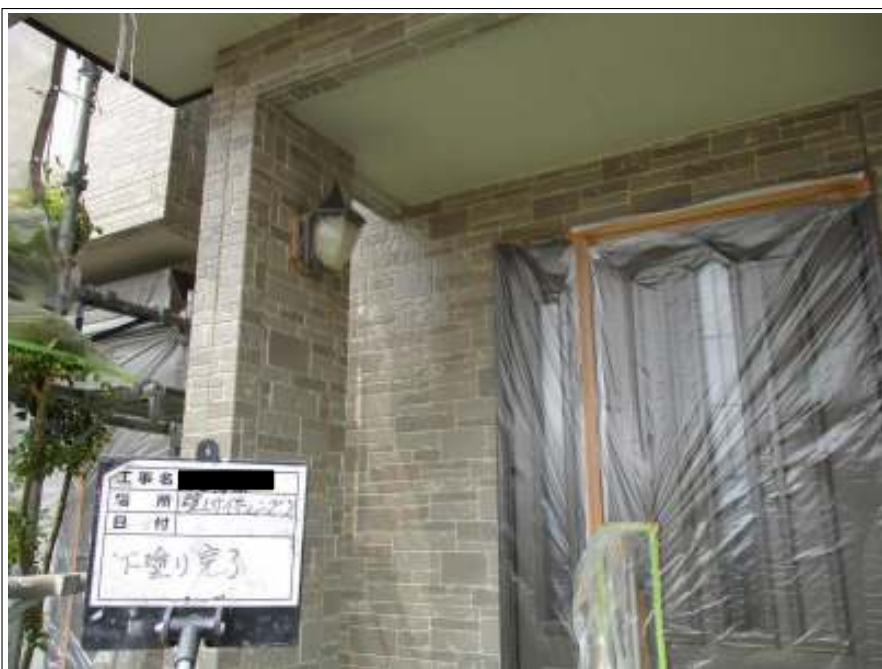
外壁 下塗り施工後
