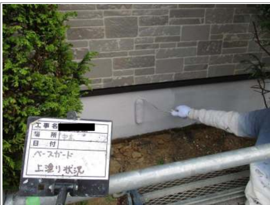
基礎 上塗り施工中
