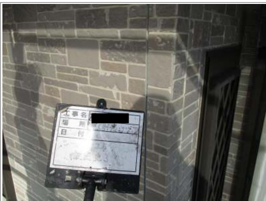
既存シーリング撤去後
