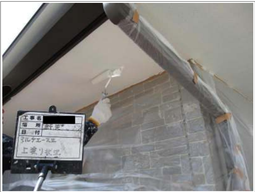
軒天 上塗り施工中
