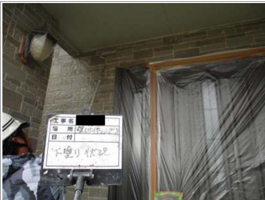
外壁 下塗り施工中
