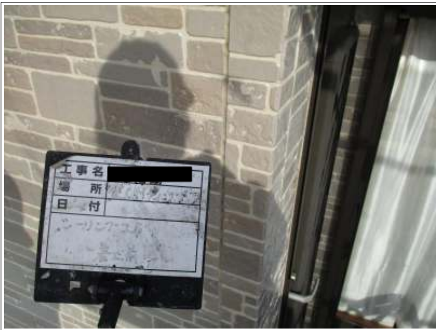
シーリング打ち替え施工前
