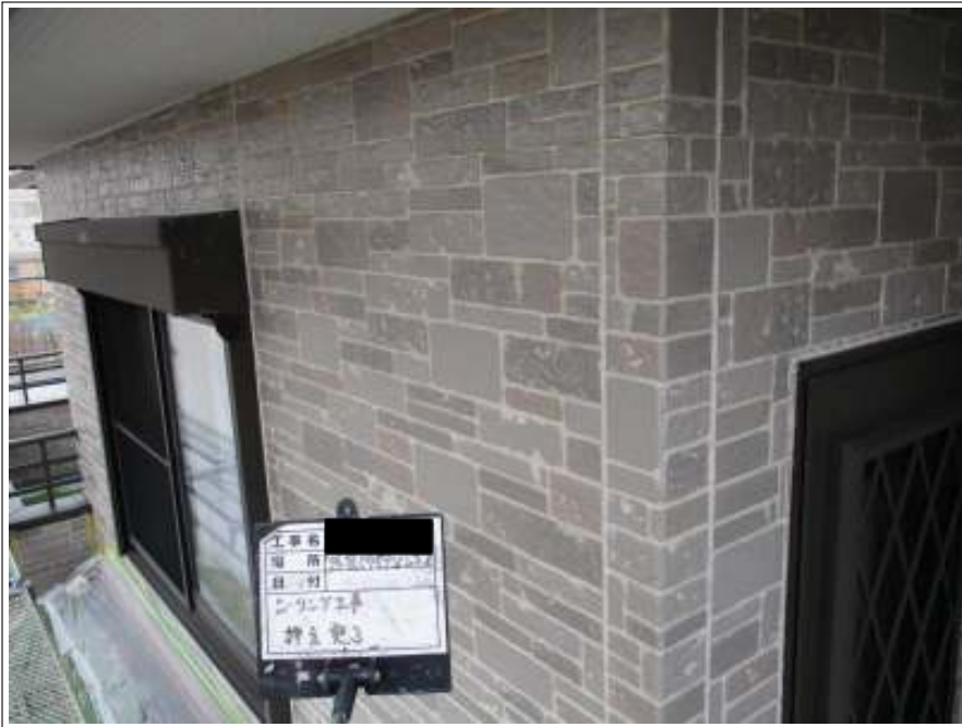
シーリング打ち替え施工後
