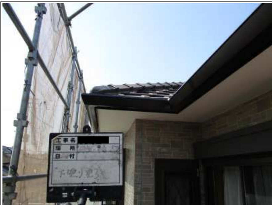
破風板・樋 下塗り施工後
