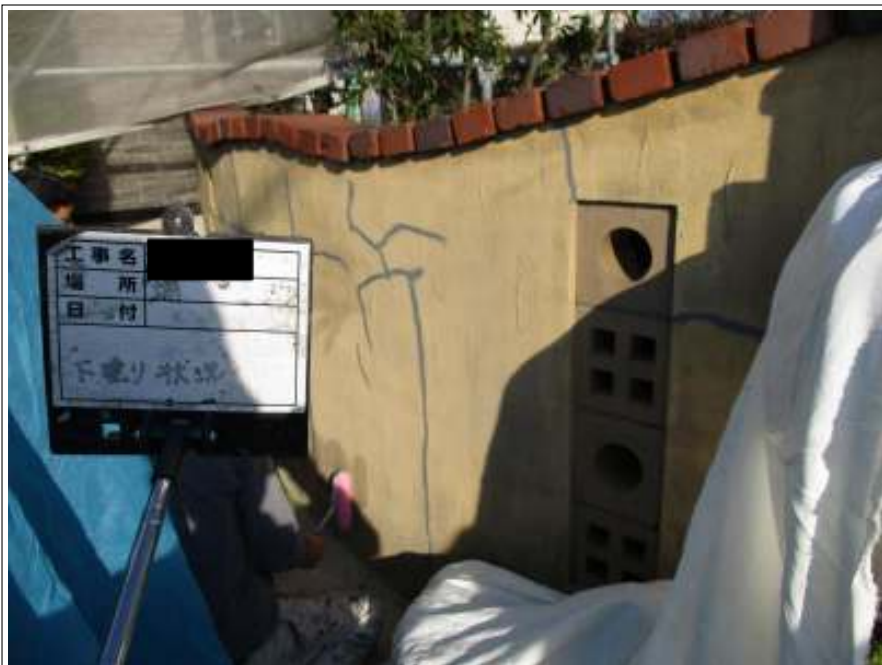
塀 下塗り施工中
