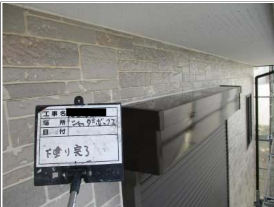
シャッター 下塗り施工後
