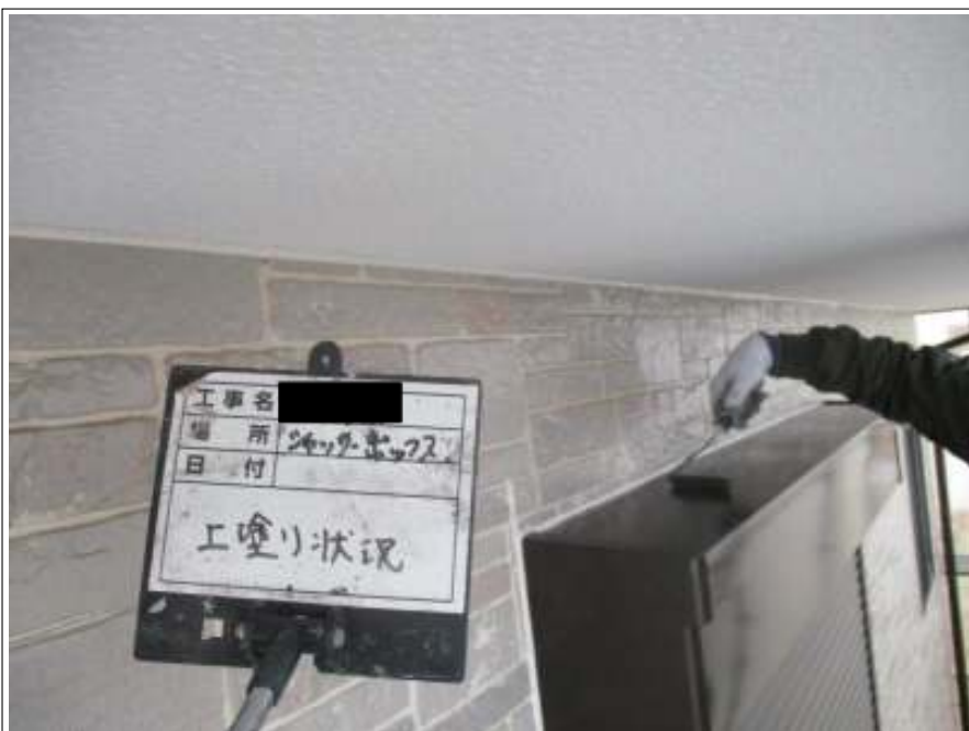
シャッター 上塗り施工中
