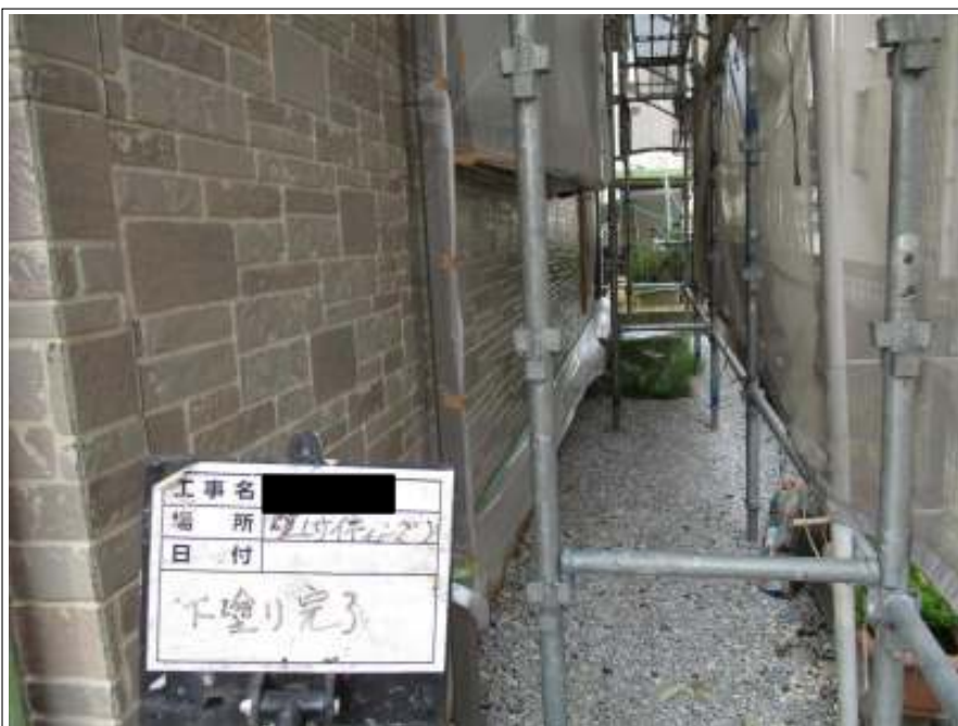
外壁 下塗り施工後
