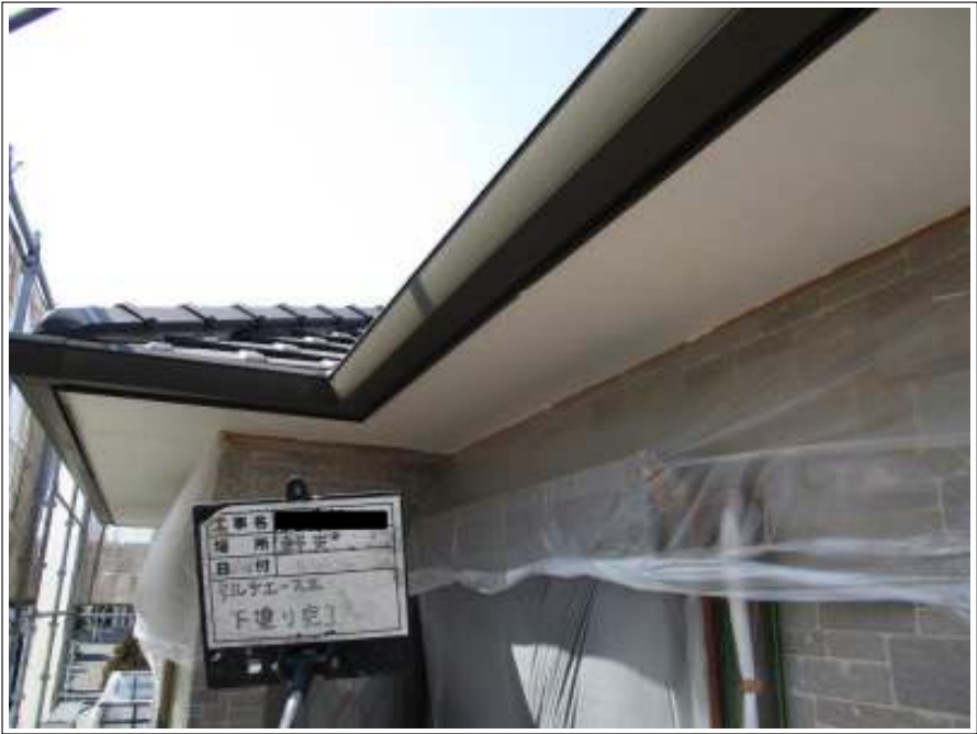
軒天 下塗り施工後
