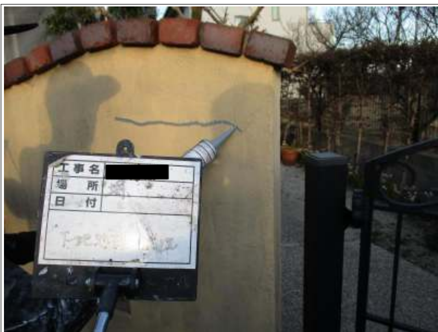
塀 クラック補修
