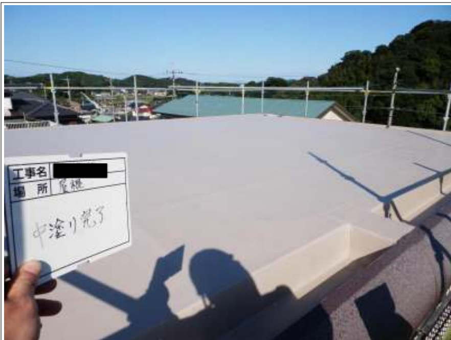
屋上 中塗り施工後
