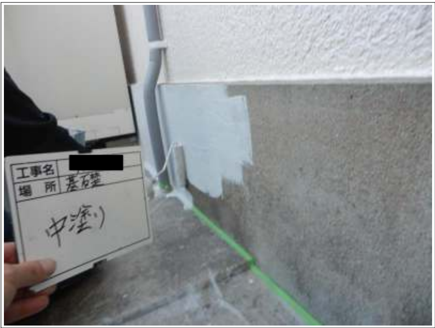
基礎 上塗り（1回目）施工中
