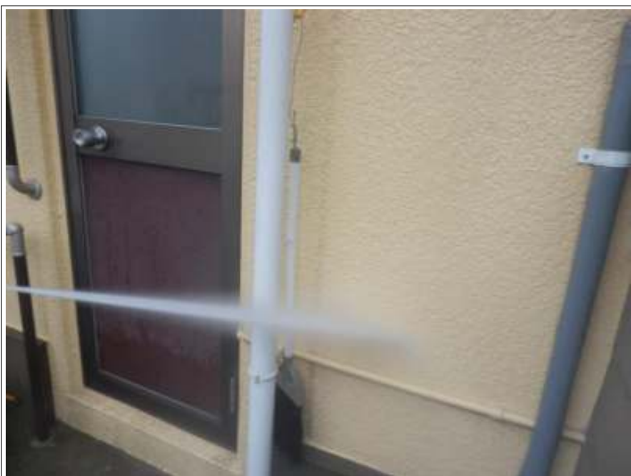
外壁 高圧洗浄中
