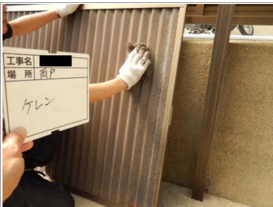
雨戸 ケレン処理施工中
