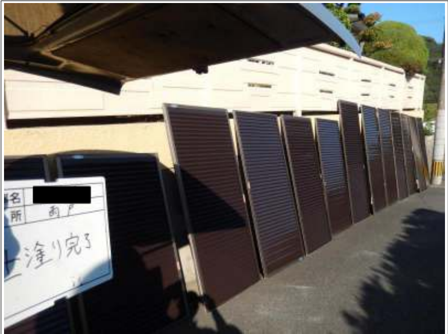
雨戸 上塗り施工後
