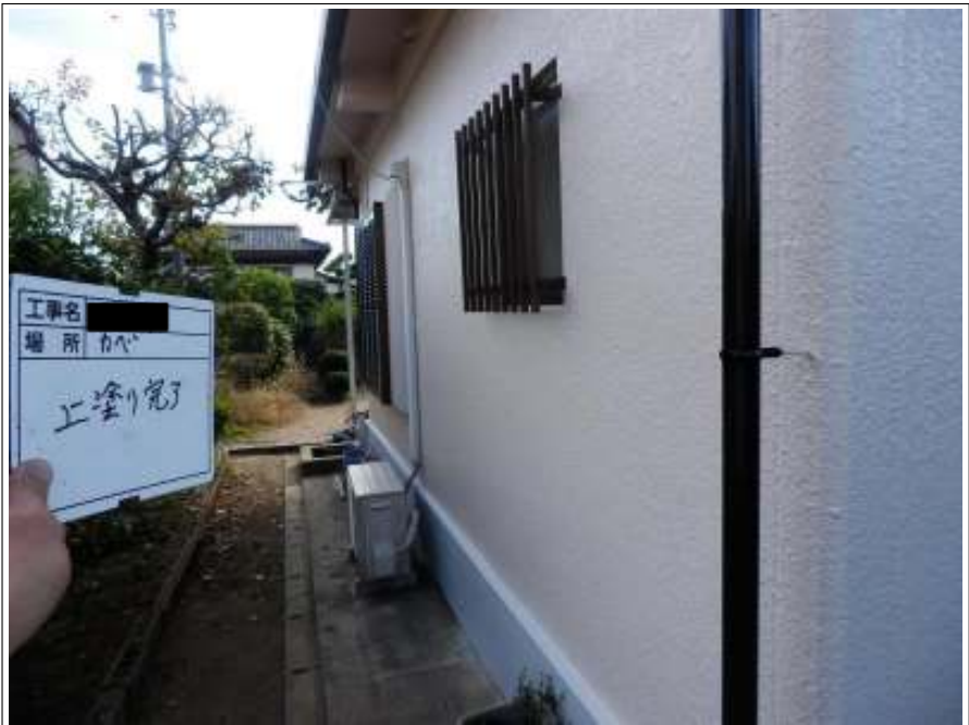
外壁 上塗り施工後
