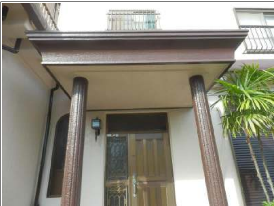
玄関庇 施工後
