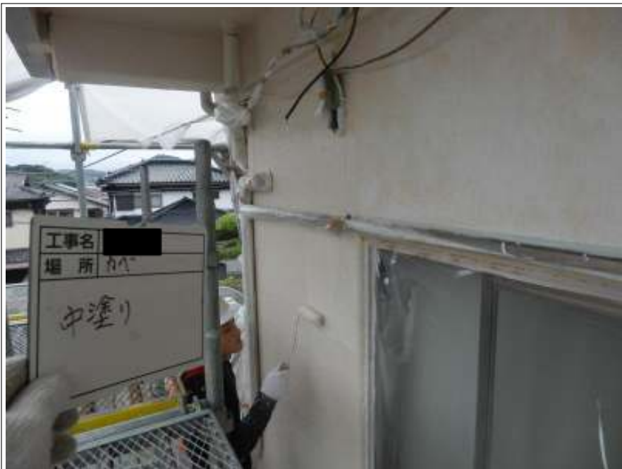
外壁 中塗り施工中
