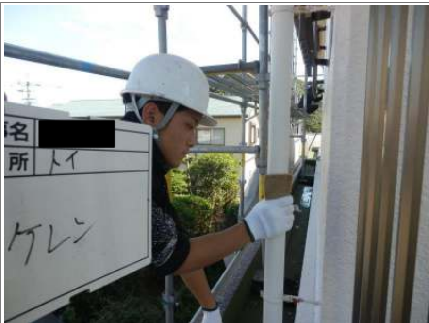
樋 ケレン処理施工中
