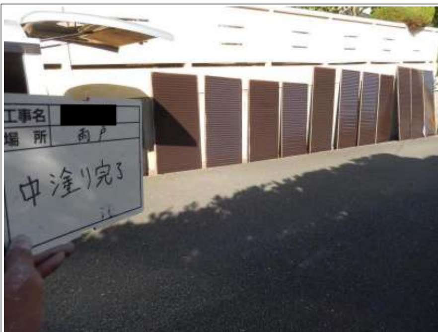
雨戸 中塗り施工後
