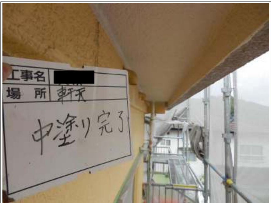
軒天 上塗り（1回目）施工後
