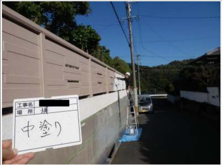
塀 中塗り施工中
