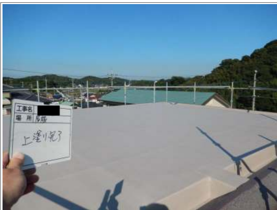
屋上 上塗り施工後
