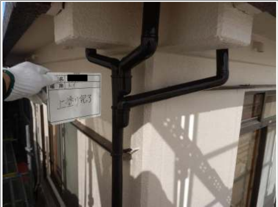
樋 上塗り（2回目）施工後
