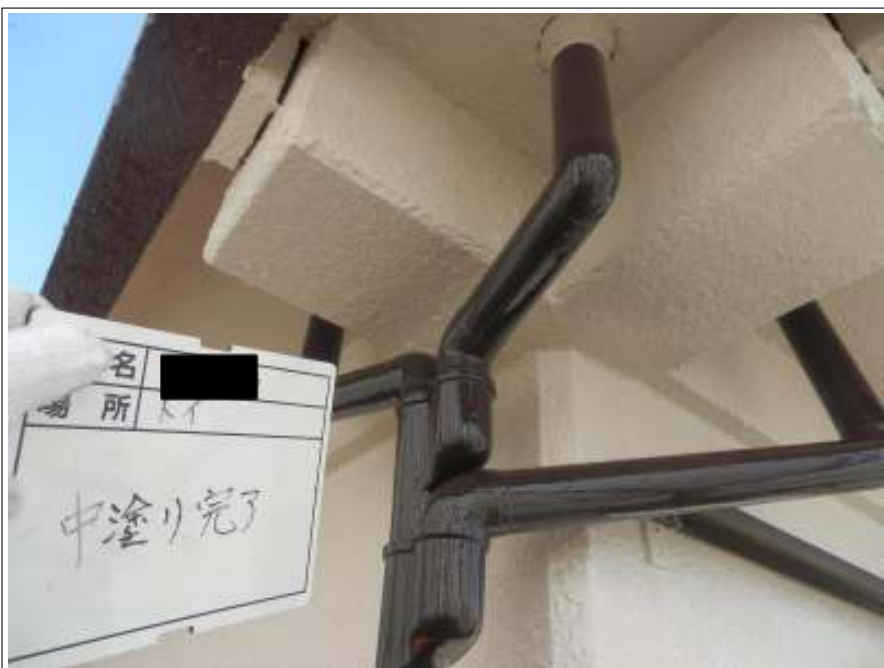
樋 上塗り（1回目）施工後
