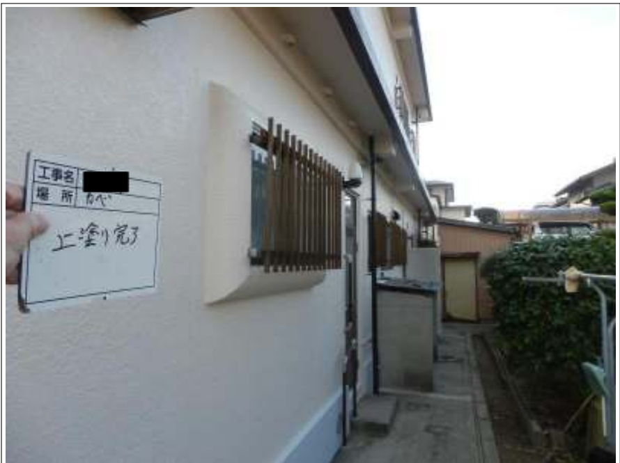
外壁 上塗り施工後
