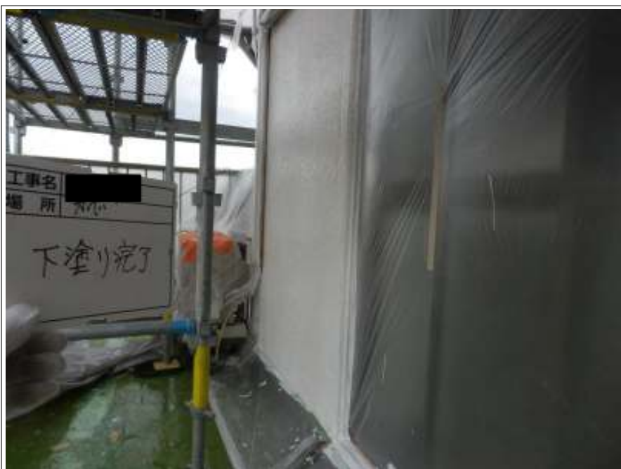
外壁 下塗り施工後
