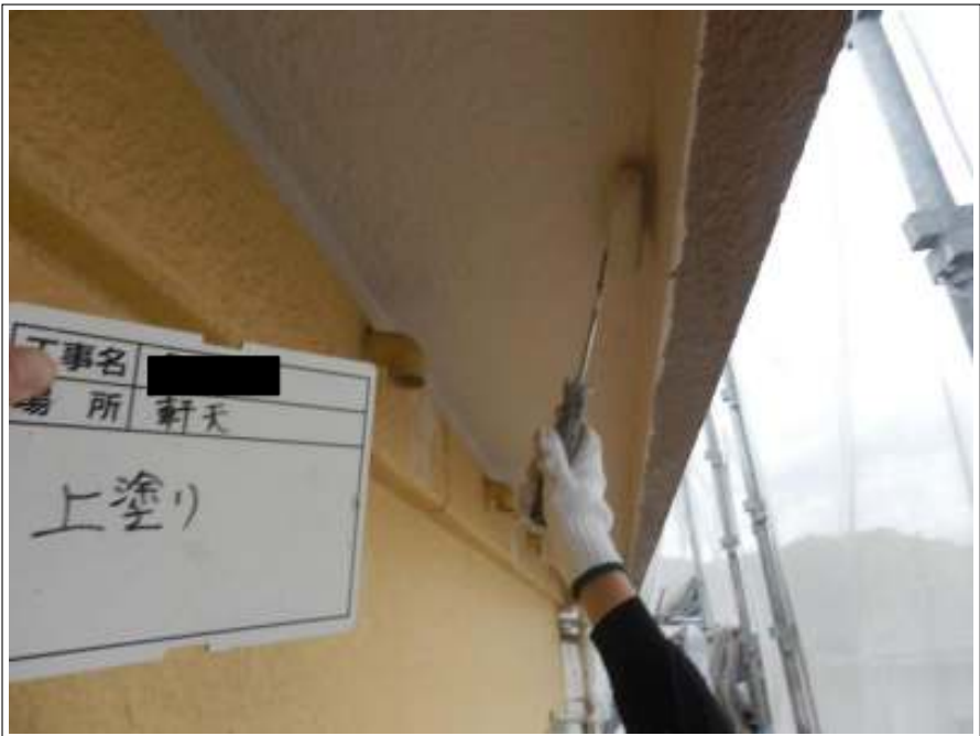
軒天 上塗り（2回目）施工中
