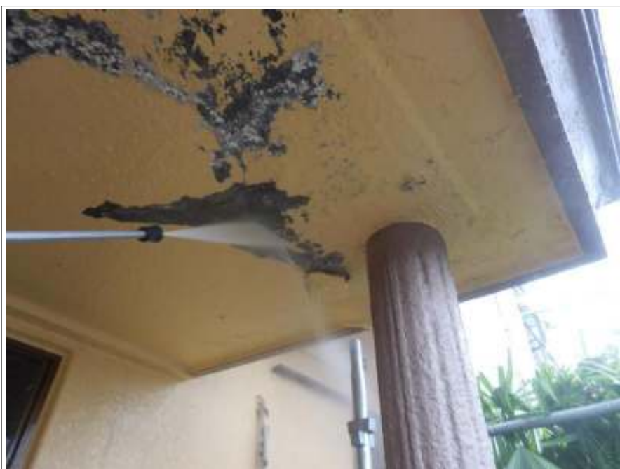
軒天 高圧洗浄中
