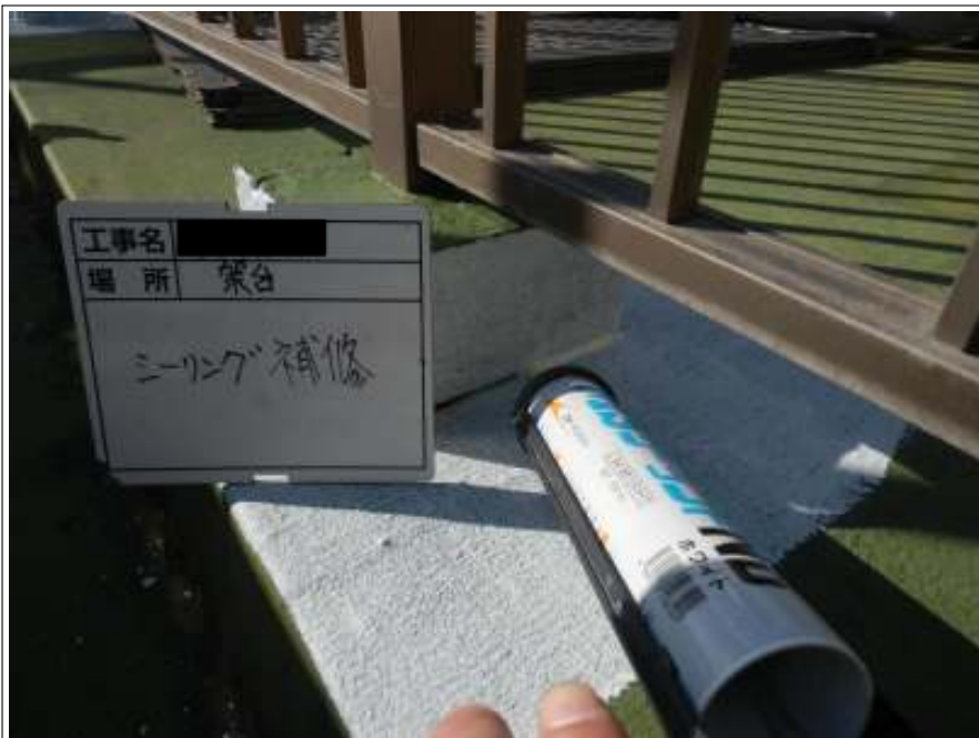
桟台 シーリング補修
