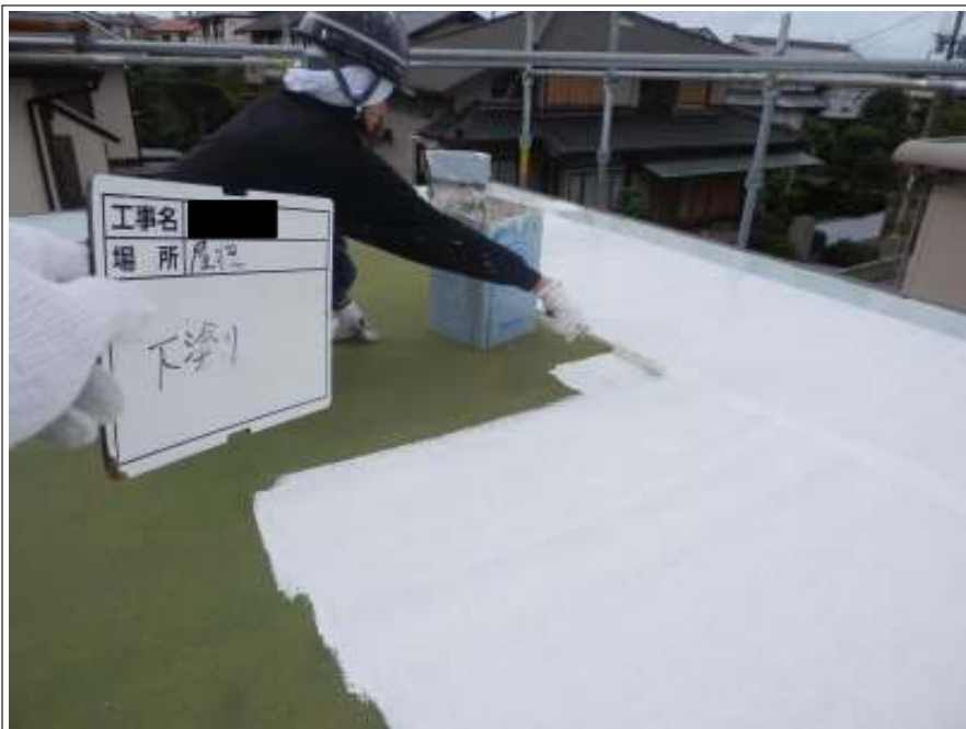
屋上 下塗り施工中
