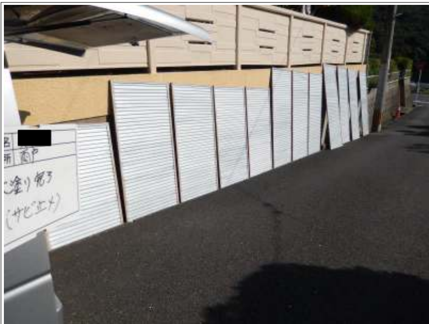
雨戸 錆止め塗布 施工後
