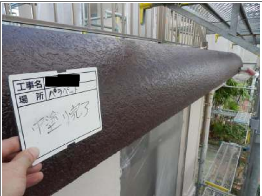
パラペット 上塗り(1回目)施工後
