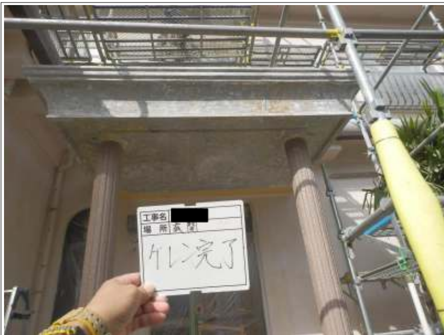
玄関庇 ケレン処理施工後
