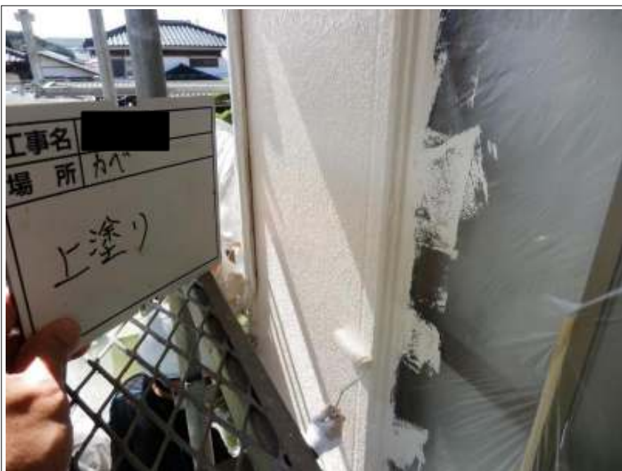
外壁 上塗り施工中
