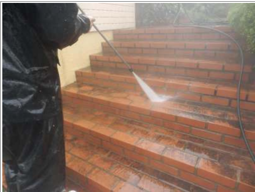
階段 高圧洗浄中
