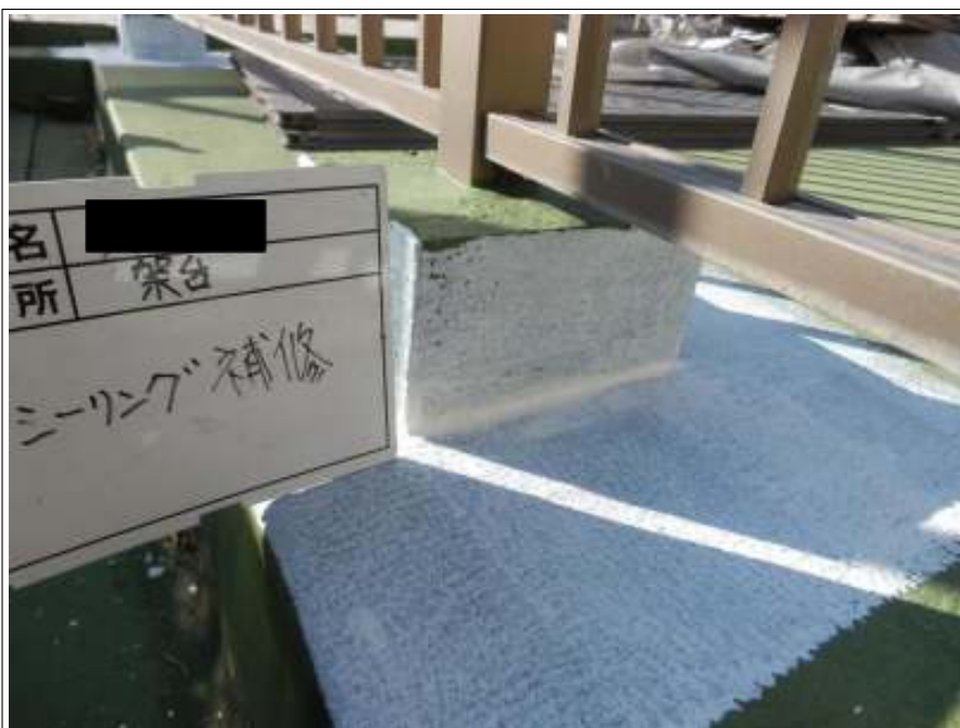
桟台 シーリング補修後
