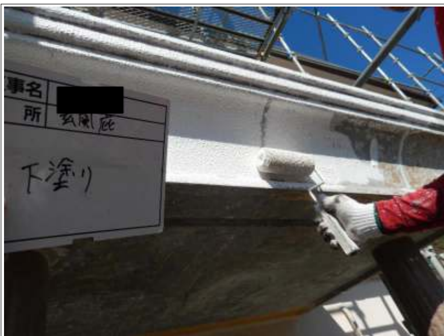
玄関庇 下塗り施工中
