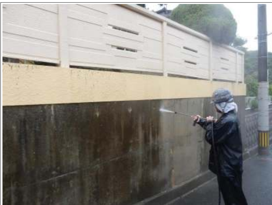
塀 高圧洗浄中
