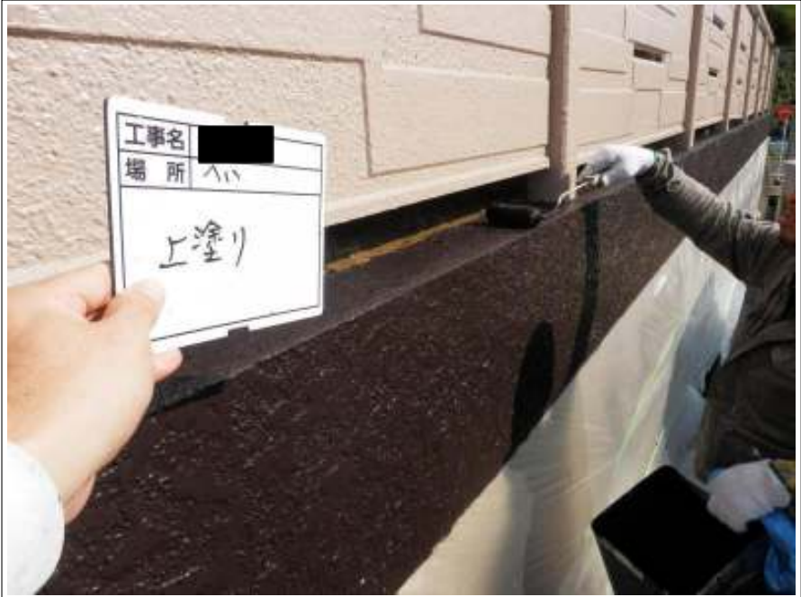
塀 上塗り施工中
