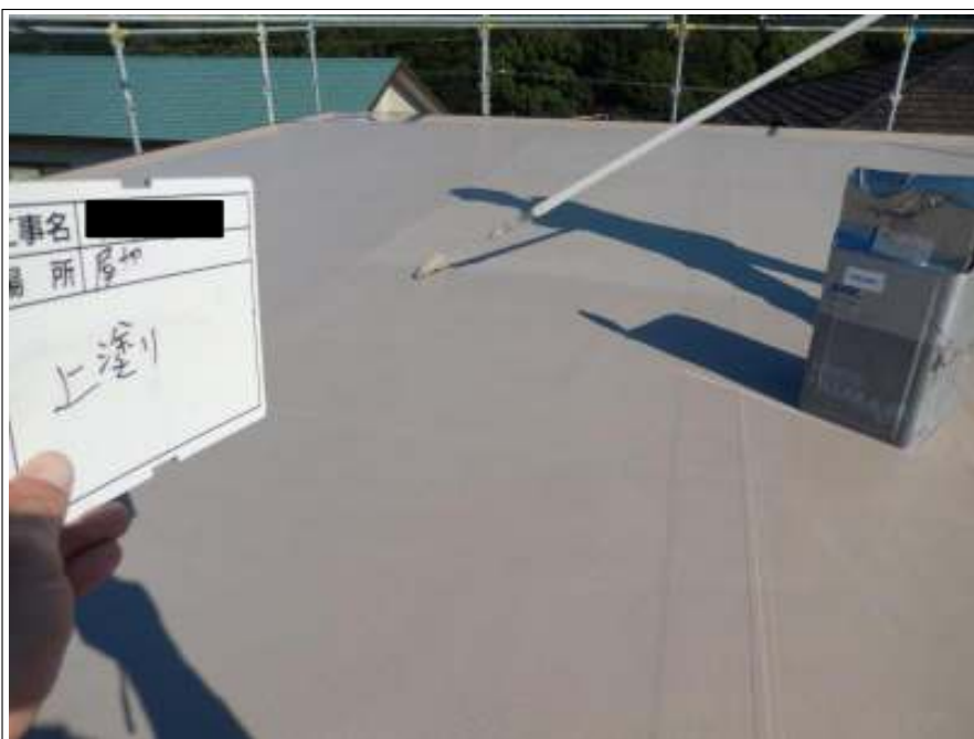
屋上 上塗り施工中
