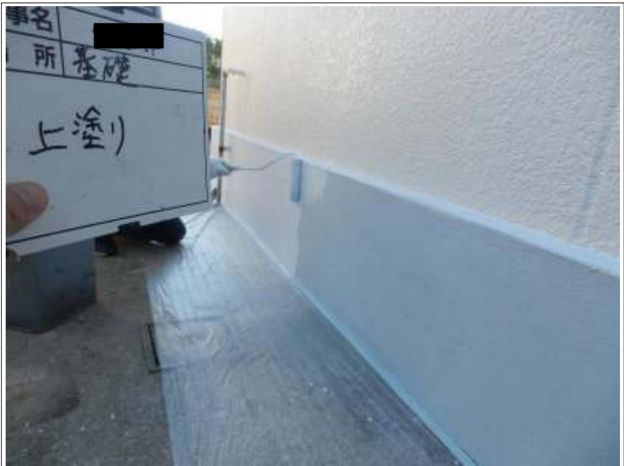
基礎 上塗り（2回目）施工中
