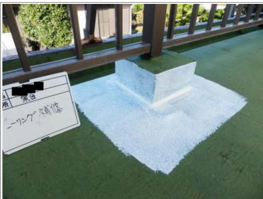
桟台 シーリング補修後
