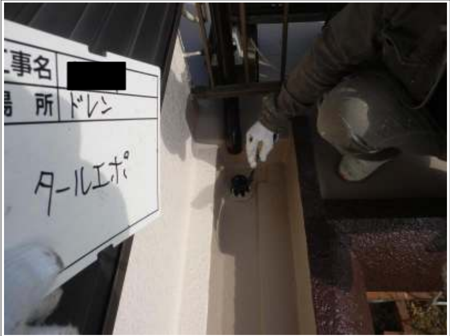
ドレン 上塗り施工中
