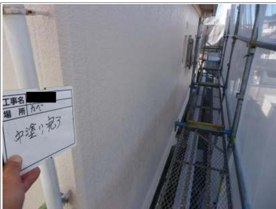
外壁 中塗り施工後
