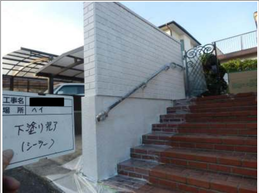
塀 下塗り施工後
