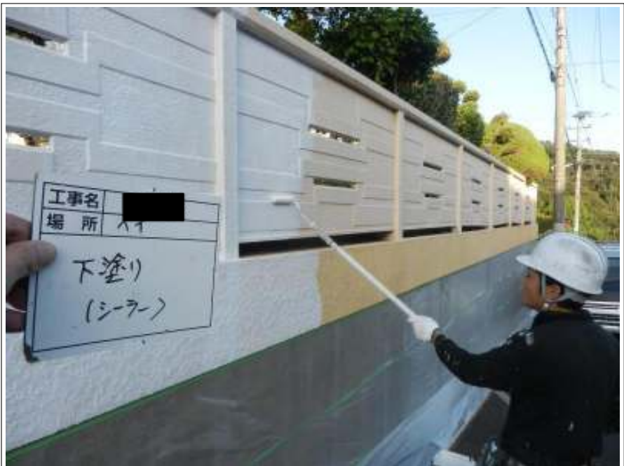
塀 下塗り施工中
