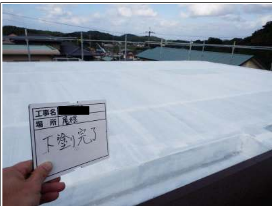
屋上 下塗り施工後
