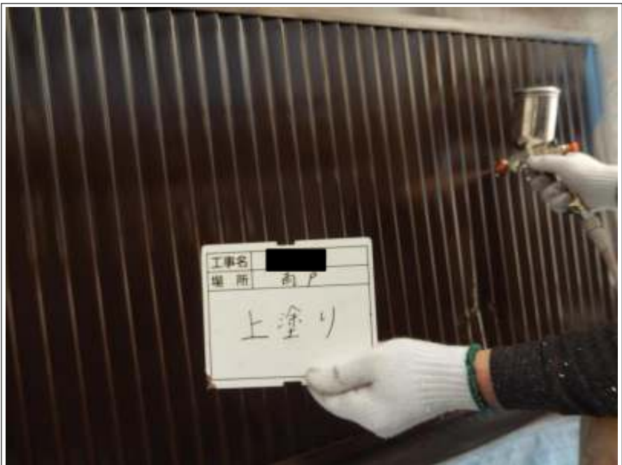
雨戸 上塗り施工中
