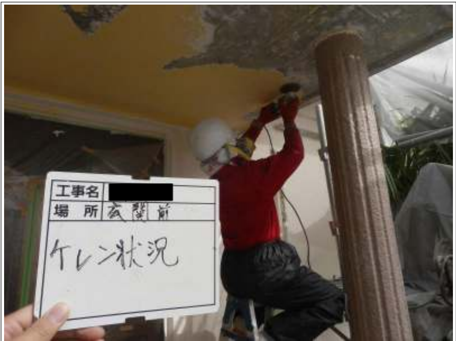
玄関庇 ケレン処理施工中
