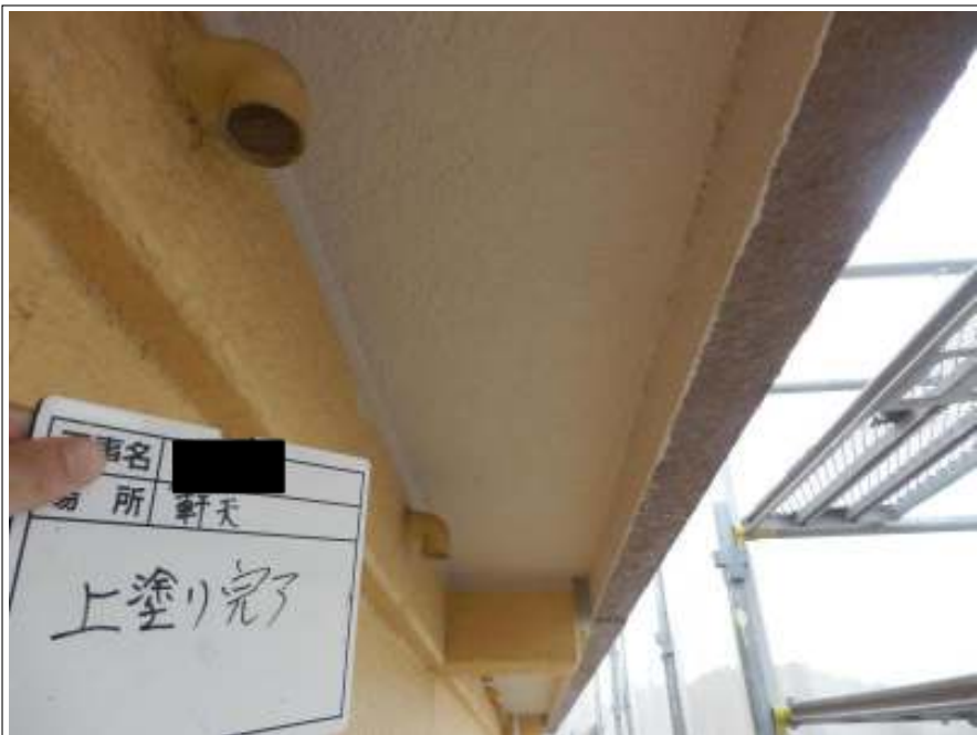
軒天 上塗り（2回目）施工後
