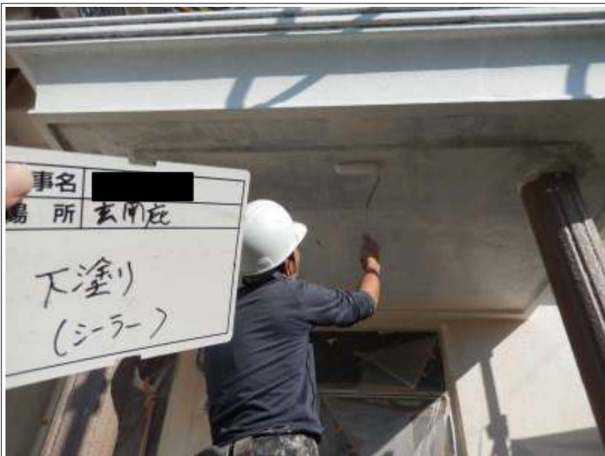
玄関庇 下塗り施工中
