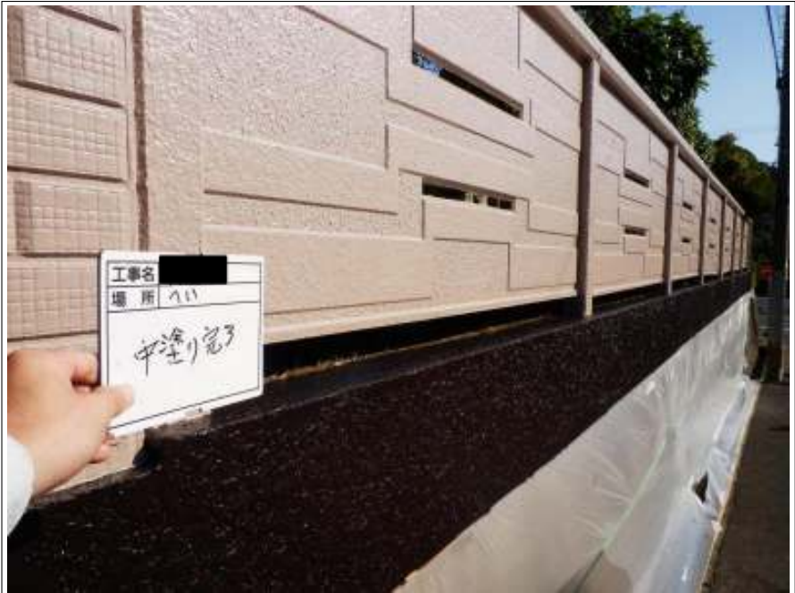
塀 中塗り施工後
