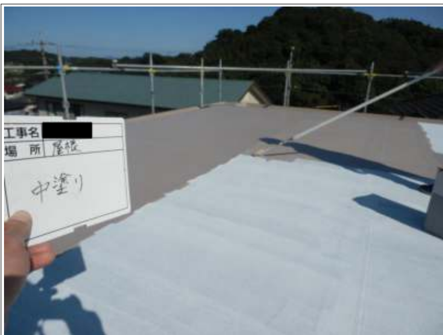
屋上 中塗り施工中
