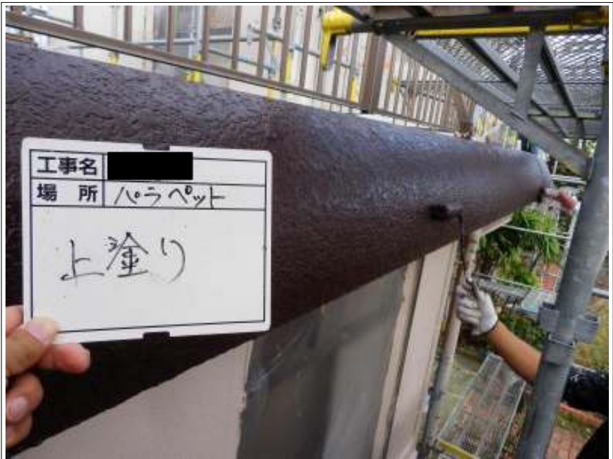
パラペット 上塗り(2回目)施工中
