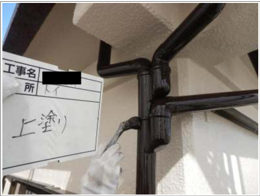
樋 上塗り（2回目）施工中
