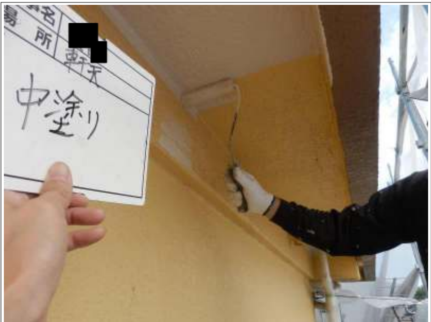
軒天 上塗り（1回目）施工中
