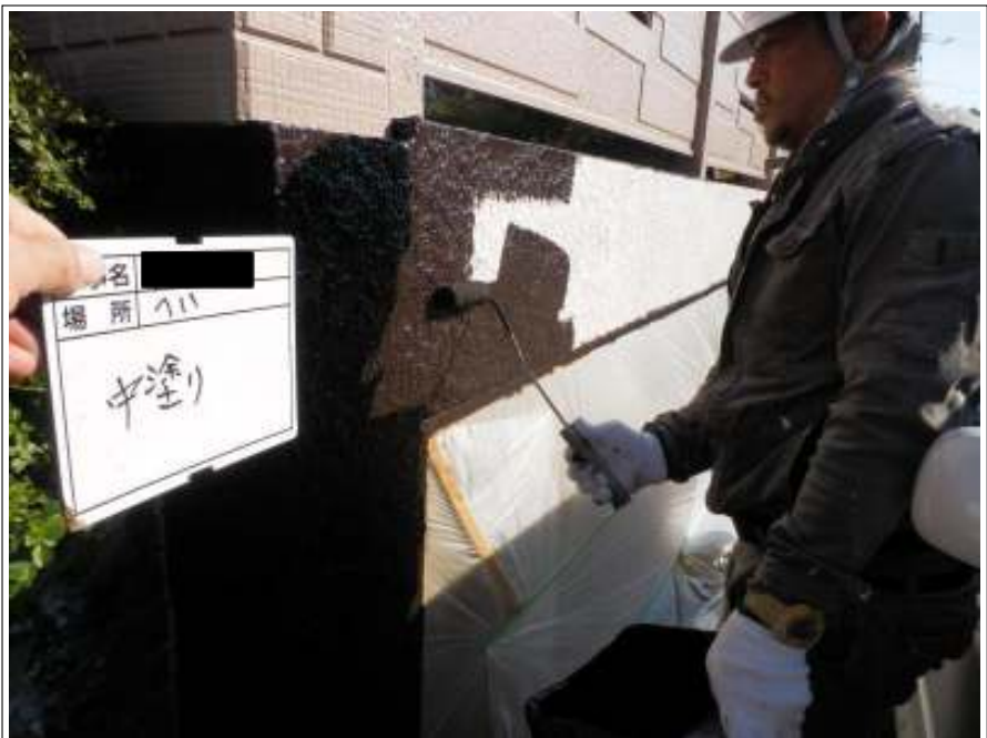
塀 中塗り施工中
