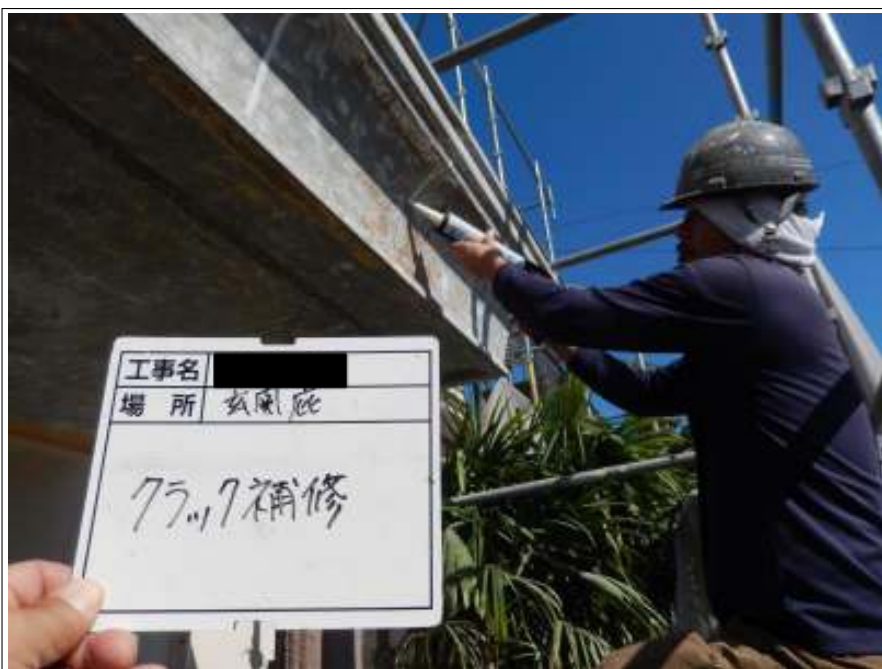
玄関庇 クラック補修
