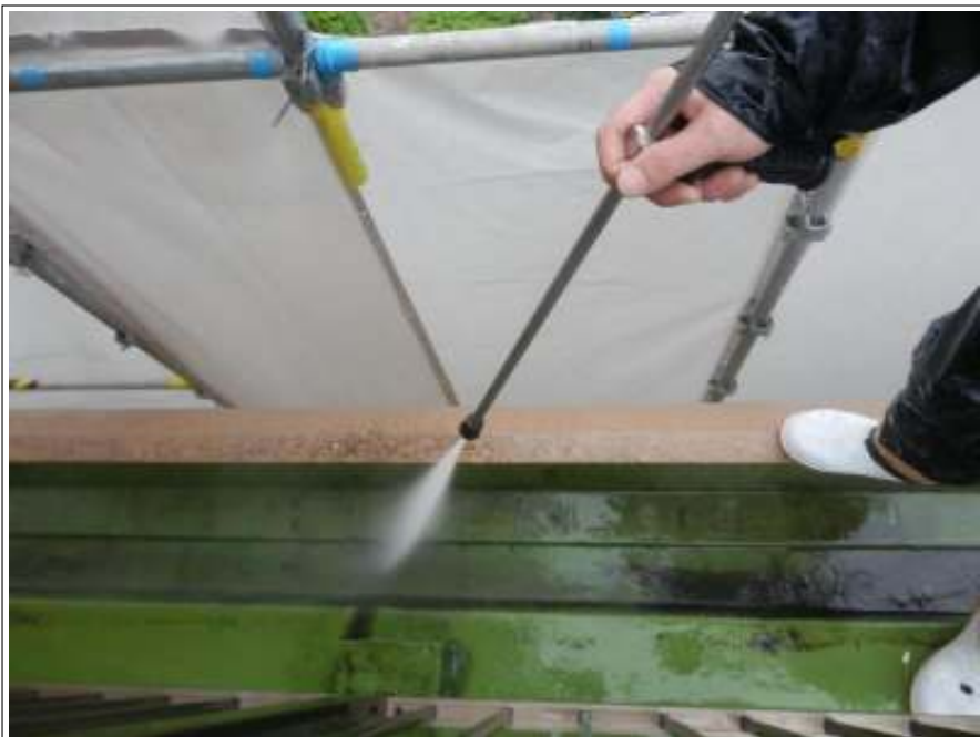
屋上 高圧洗浄中
