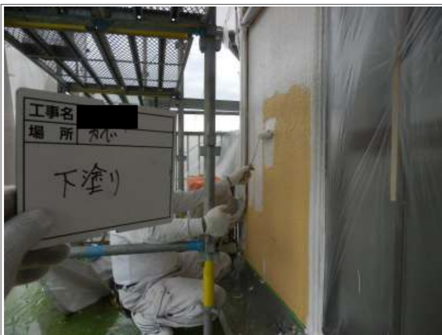
外壁 下塗り施工中
