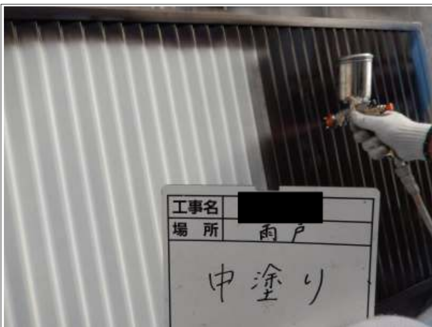
雨戸 中塗り施工中
