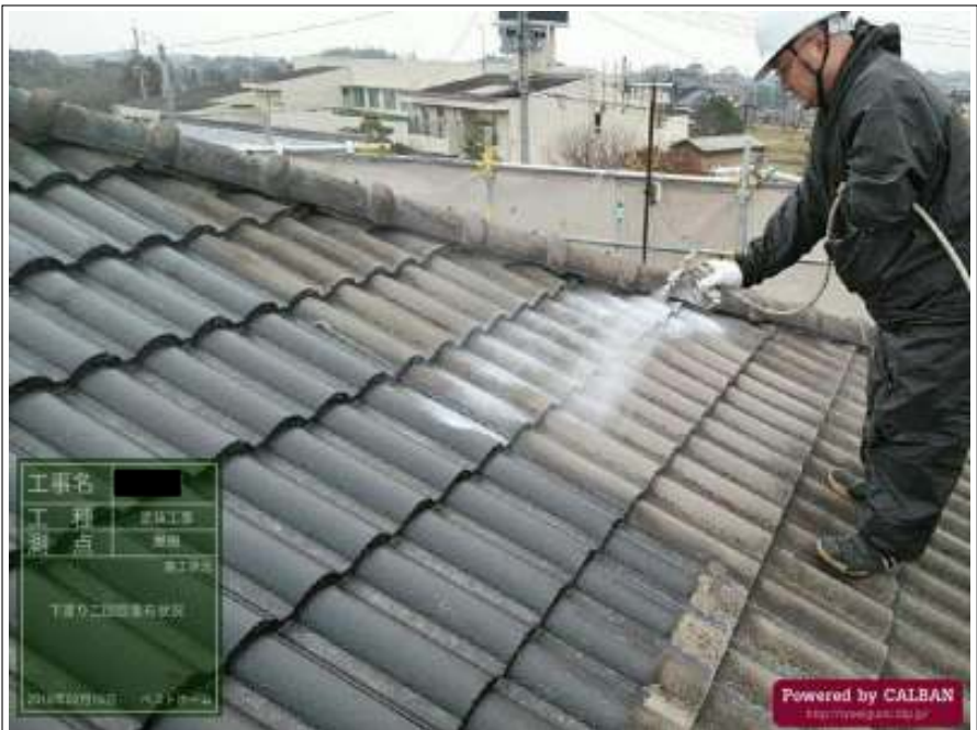
屋根 下塗り（1回目）施工中
