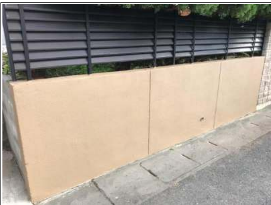
塀 上塗り施工後
