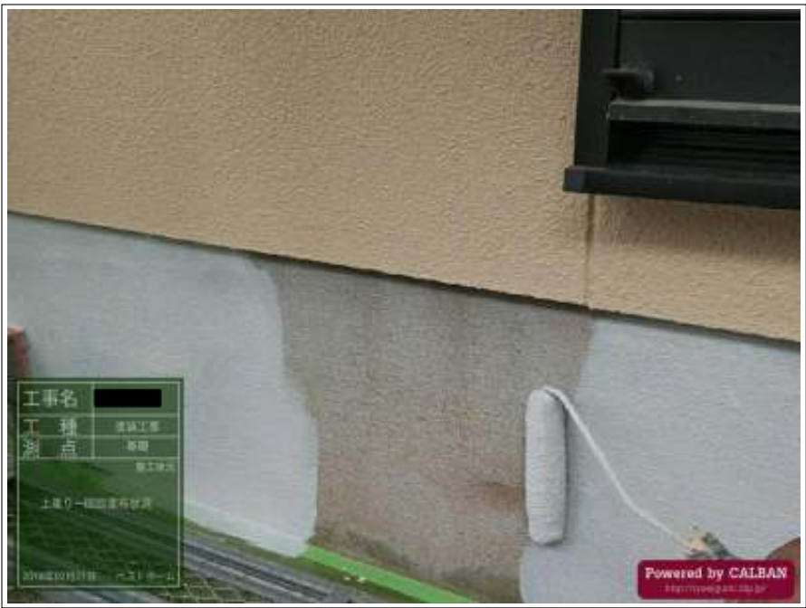
基礎 上塗り（1回目）施工中
