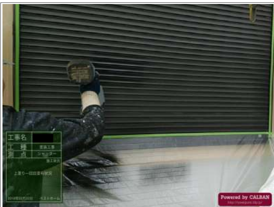
シャッター 上塗り(1回目)施工中
