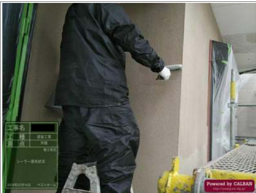
外壁 下塗り施工中
