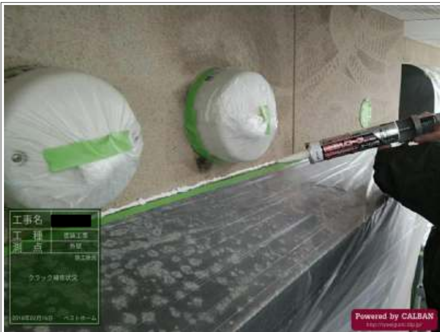
クラック補修 施工中
