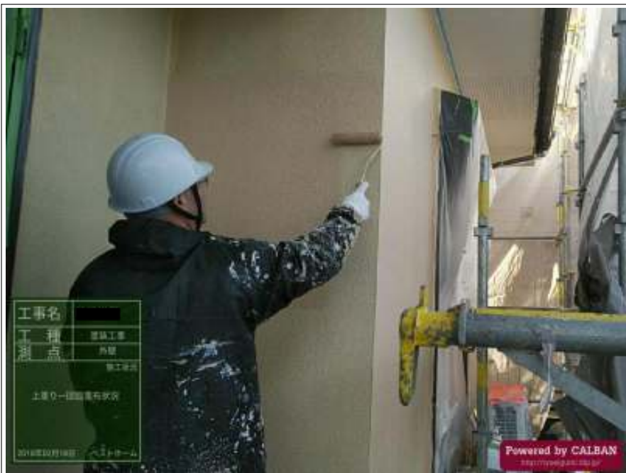
外壁 中塗り施工中
