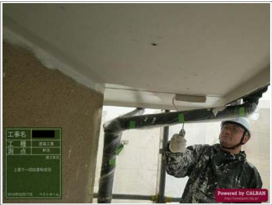
軒天（1回目） 施工中
