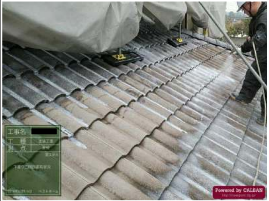
屋根 下塗り（2回目）施工中
