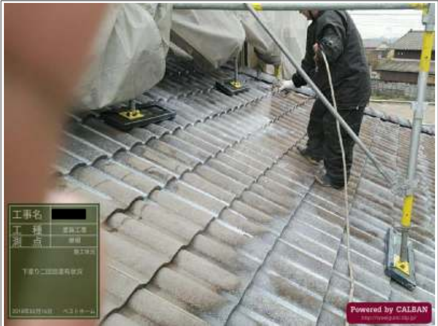
屋根 下塗り（2回目）施工中
