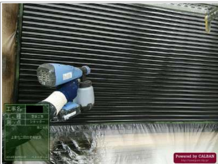
シャッター 上塗り(1回目)施工中
