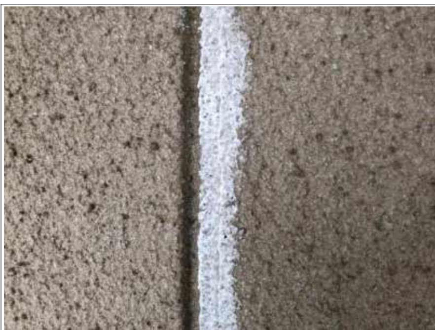
クラック補修 施工完了
