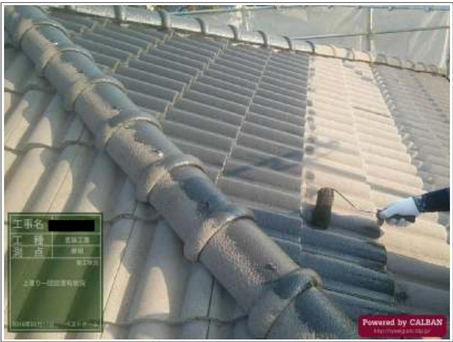
屋根 中塗り施工中
