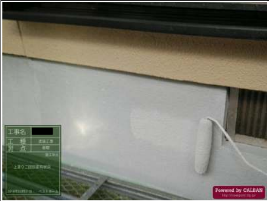
基礎 上塗り（2回目）施工中
