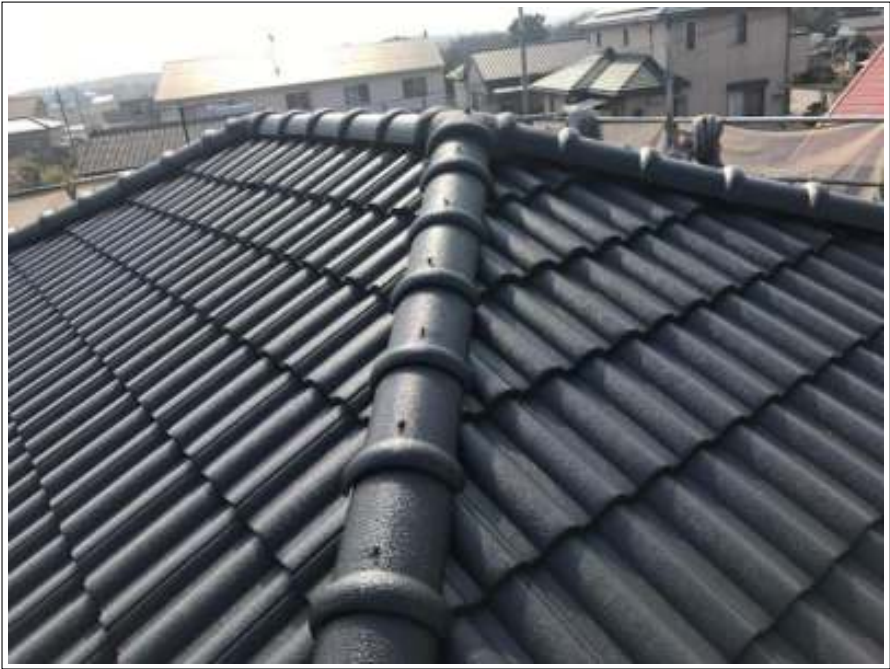
屋根 施工完了
