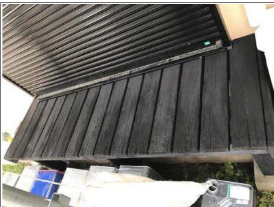
濡れ縁 上塗り施工後
