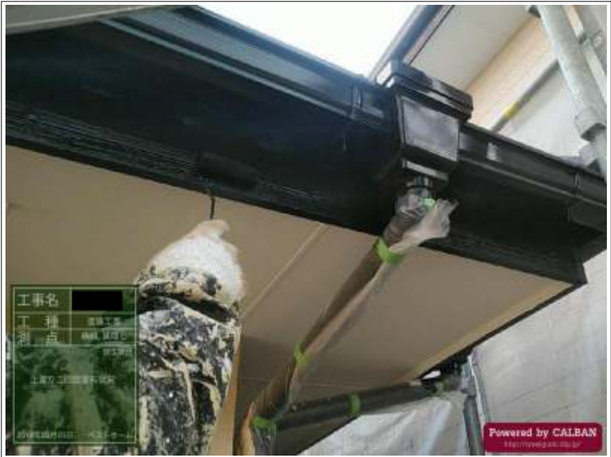
破風板 上塗り（2回目）施工中
