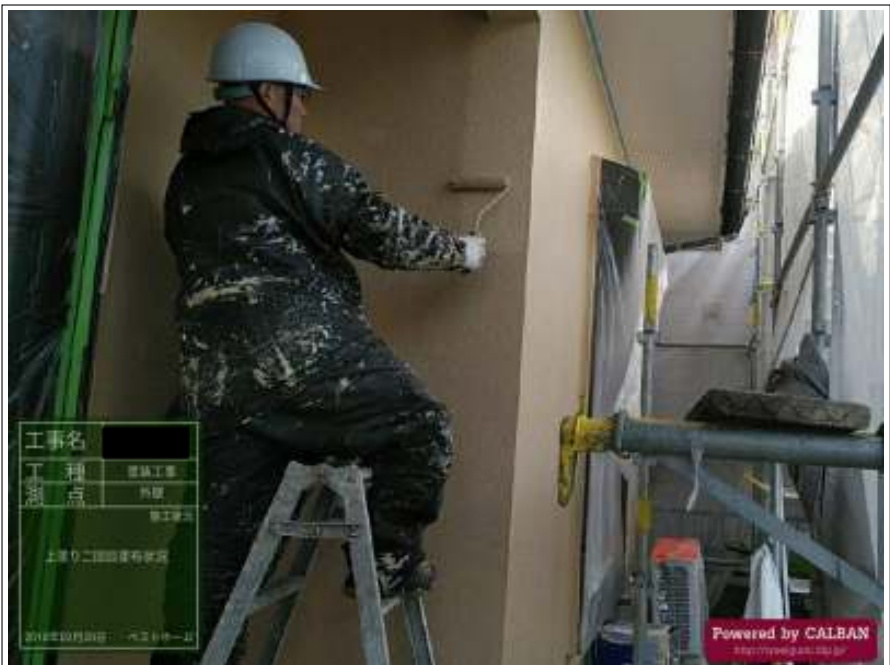
外壁 上塗り施工中
