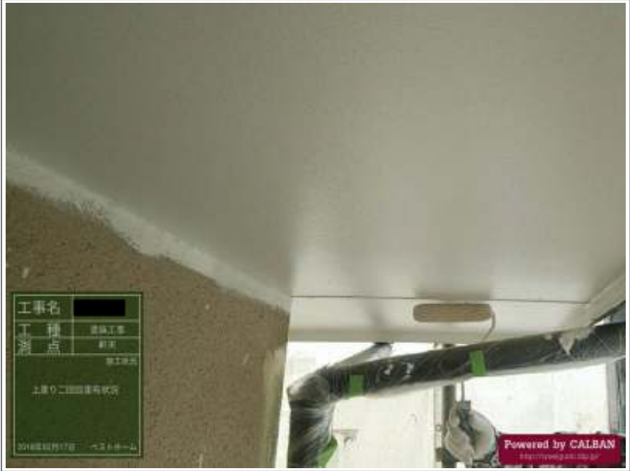
軒天（2回目） 施工中
