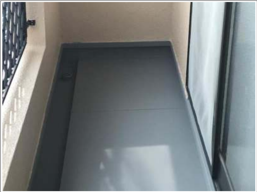
ベランダ床 上塗り施工後
