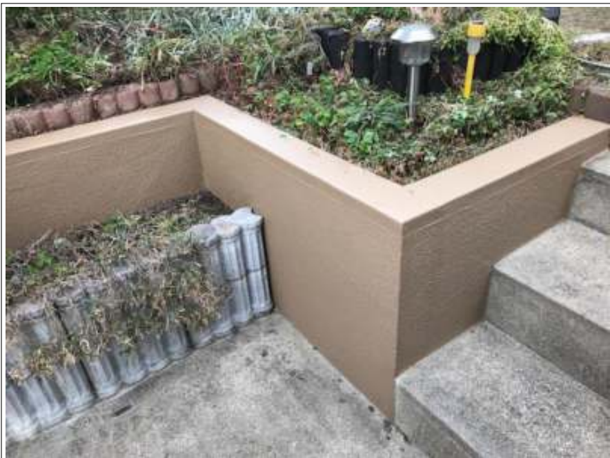
塀 上塗り施工後
