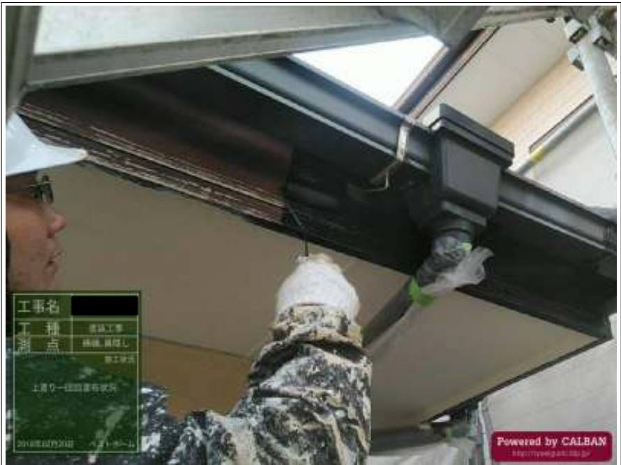
破風板 上塗り（1回目）施工中
