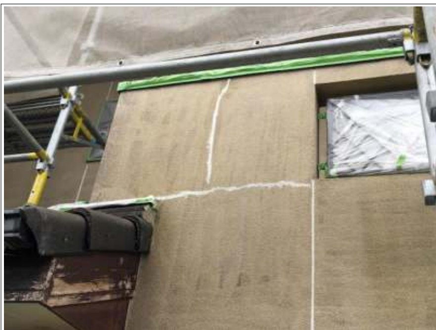
クラック補修 施工完了
