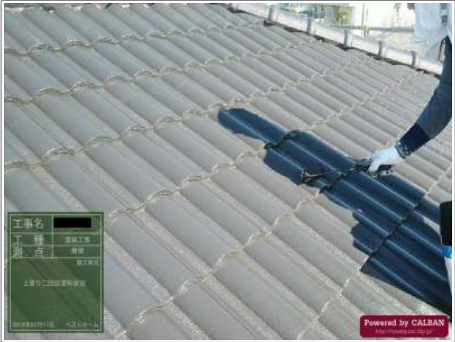
屋根 上塗り施工中
