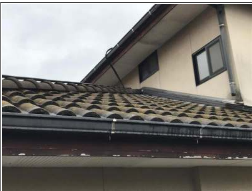
屋根 洋風コンクリート瓦
