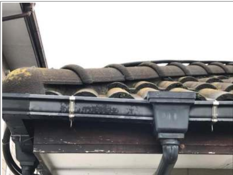
屋根 洋風コンクリート瓦
