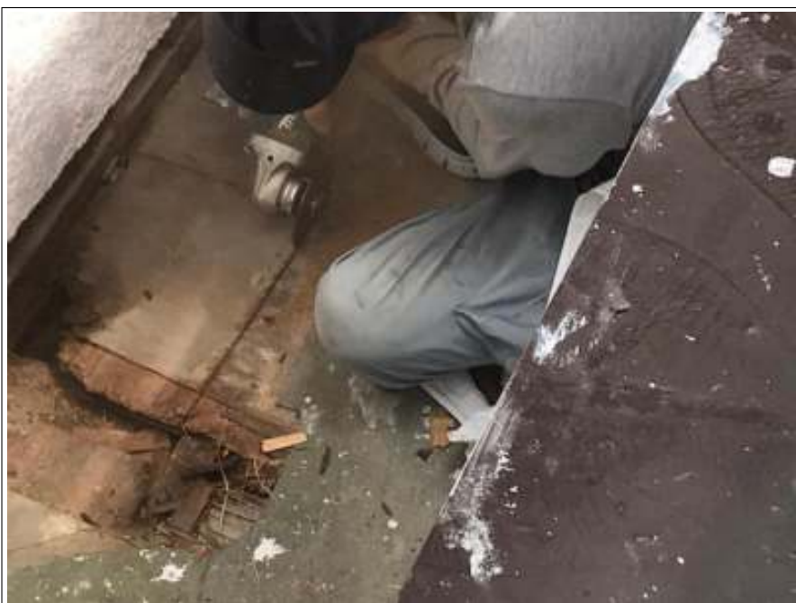
ベランダ 土間工事施工中
