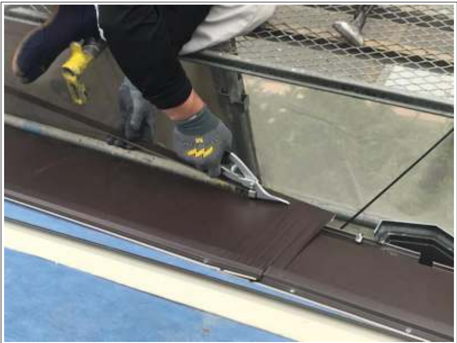
屋根カバー工法 施工
