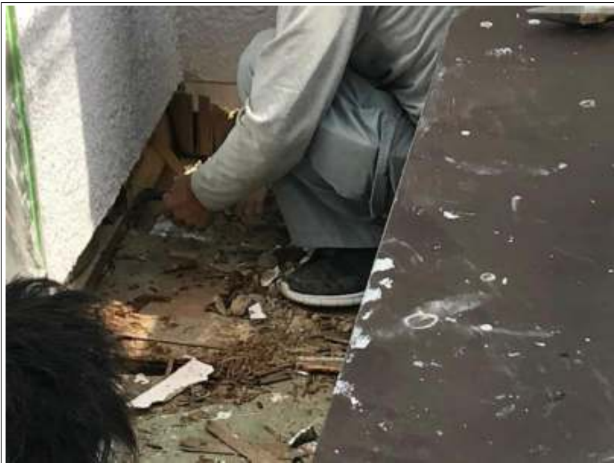
ベランダ 土間工事施工中
