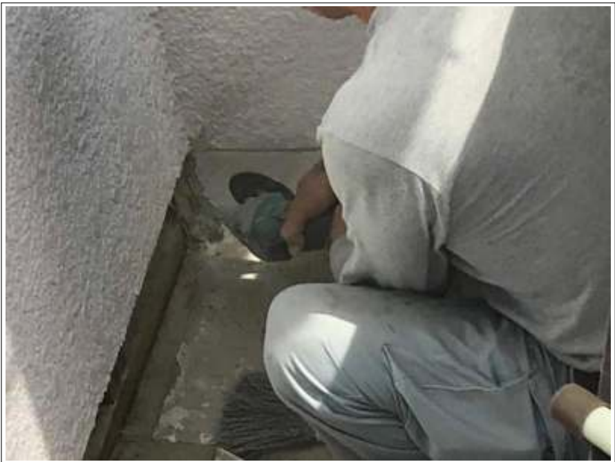
ベランダ 土間工事施工中
