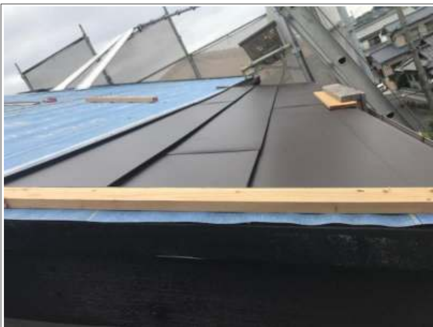
屋根カバー工法 施工
