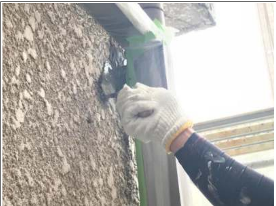
外壁 補修施工中
