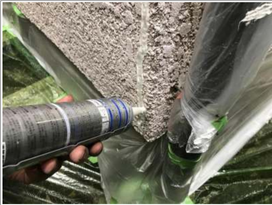
外壁 クラック補修施工中
