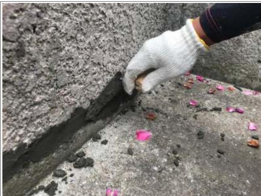
塀 壁 補修施工中
