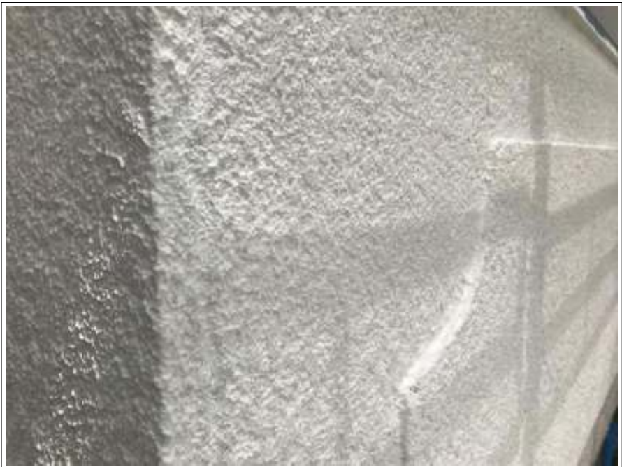
外壁 下地調整 施工完了
