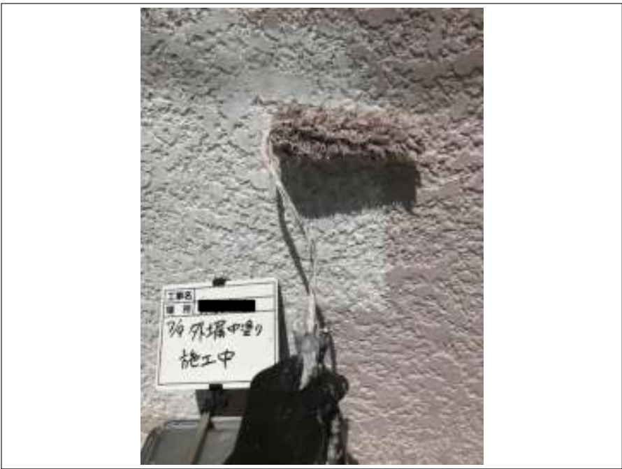
外壁 中塗 施工中
