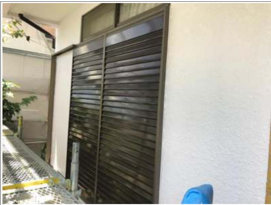
雨戸 塗装完了
