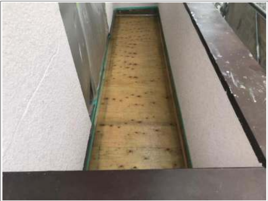
ベランダ 防水工事施工中
