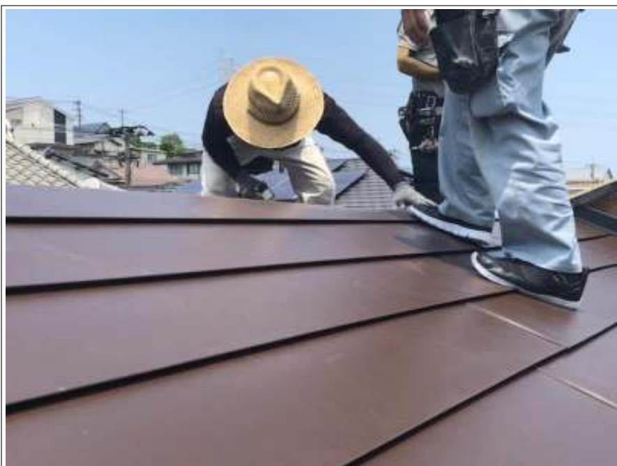
屋根カバー工法 施工
