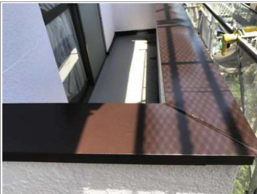
ベランダ手摺 塗装完了
