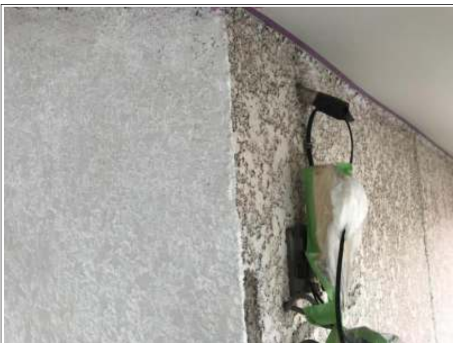
外壁 下塗 施工中
