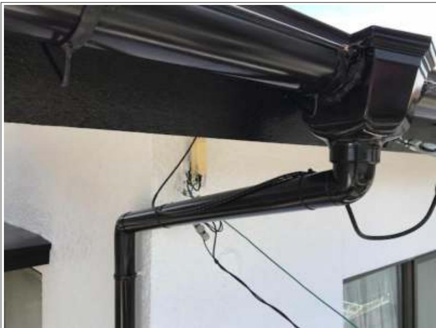
雨樋 塗装完了
