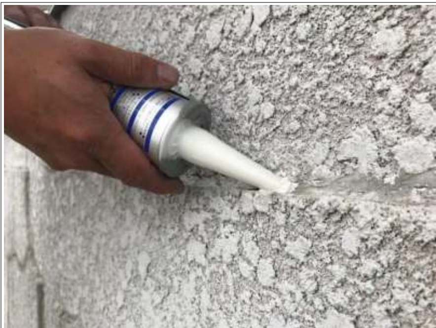
外壁 クラック補修施工中
