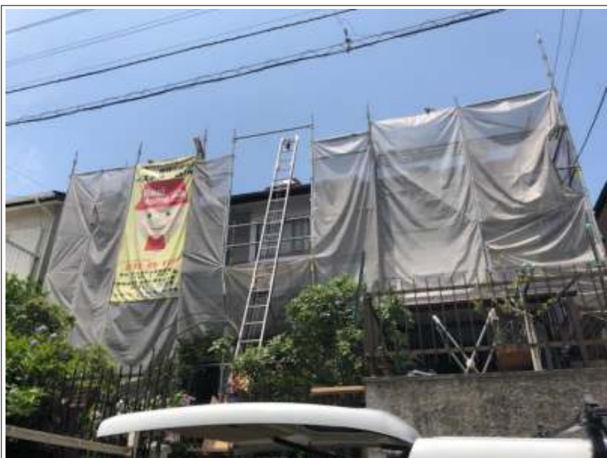
屋根カバー工法 施工
