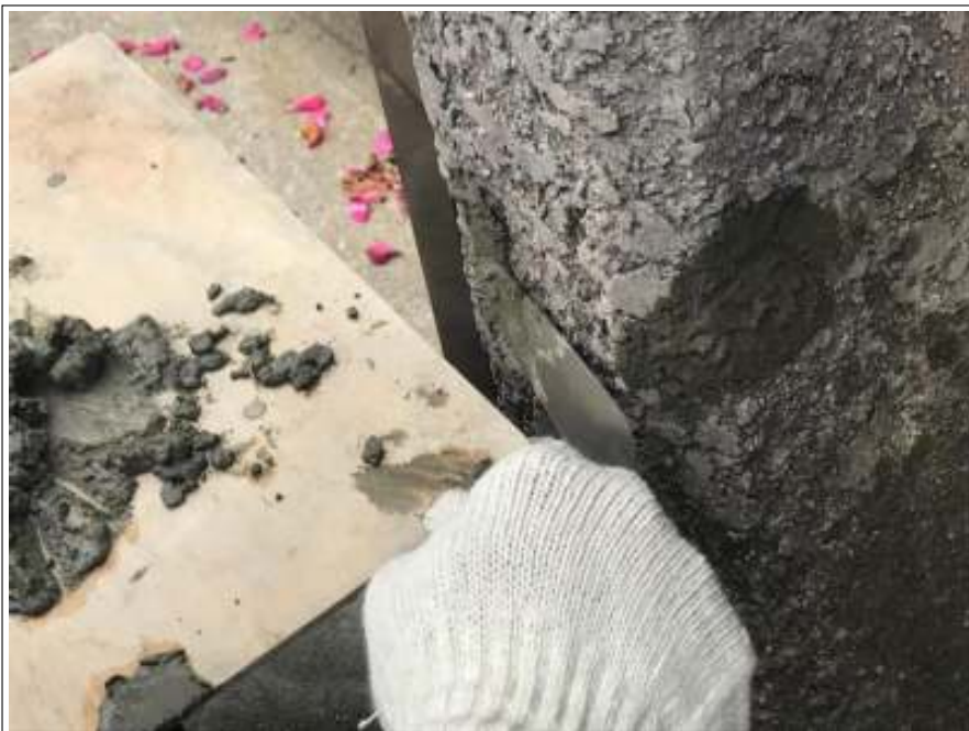
車庫 壁 補修施工中
