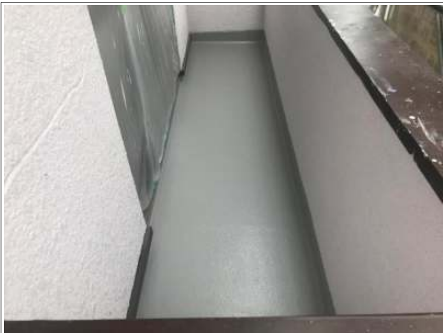
ベランダ 防水工事施工完了
