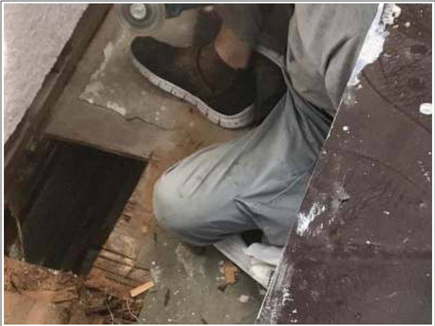
ベランダ 土間工事施工中
