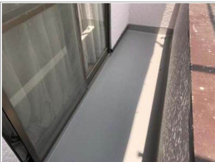
ベランダ 防水工事施工完了
