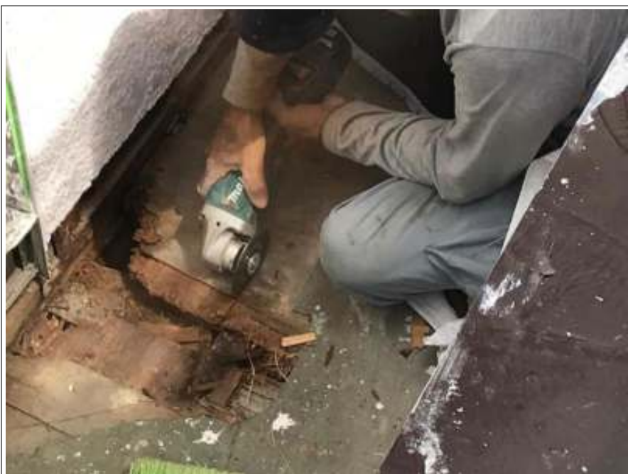
ベランダ 土間工事施工中
