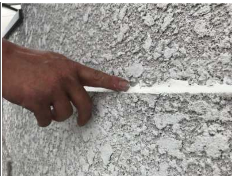
外壁 クラック補修施工中
