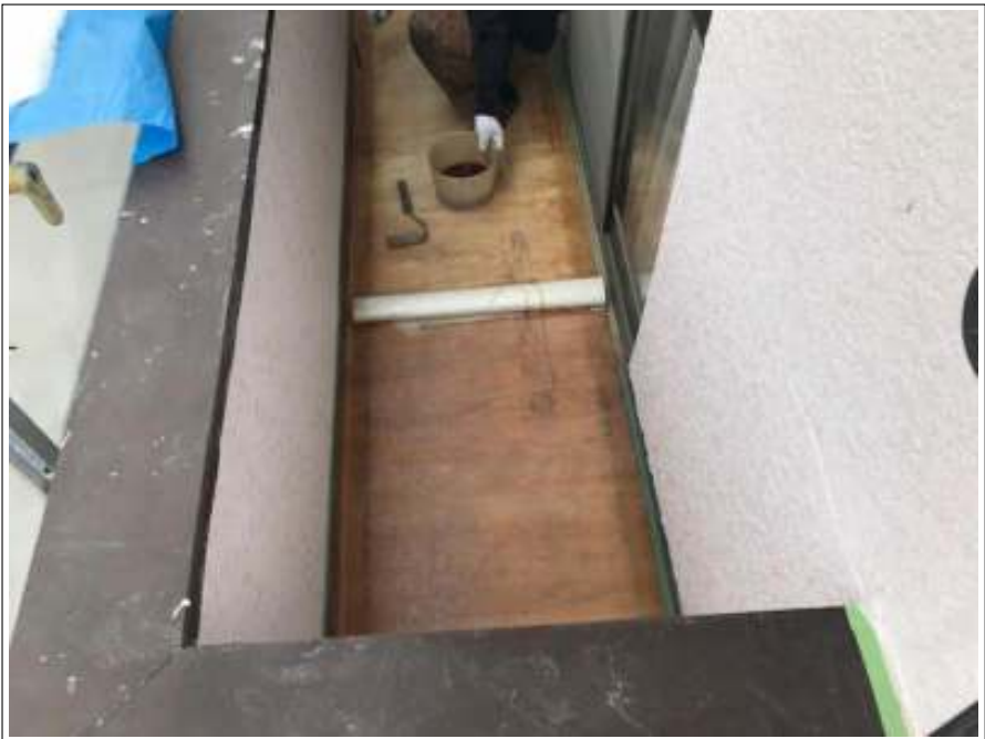
ベランダ 防水工事施工中
