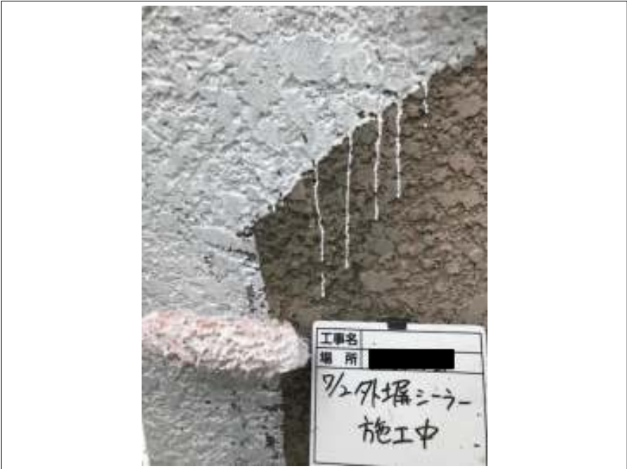
外壁 下塗 施工中
