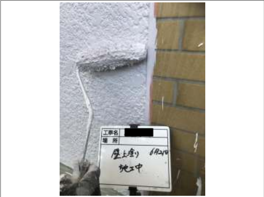
外壁 上塗 施工中
