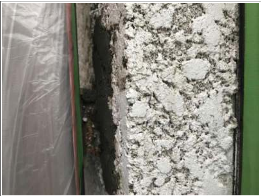
外壁 補修施工完了
