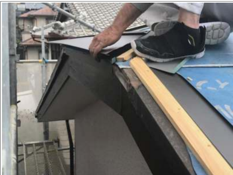
屋根カバー工法 施工
