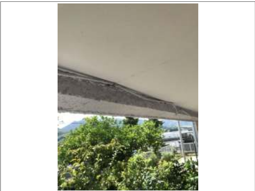
軒天 塗装施工中
