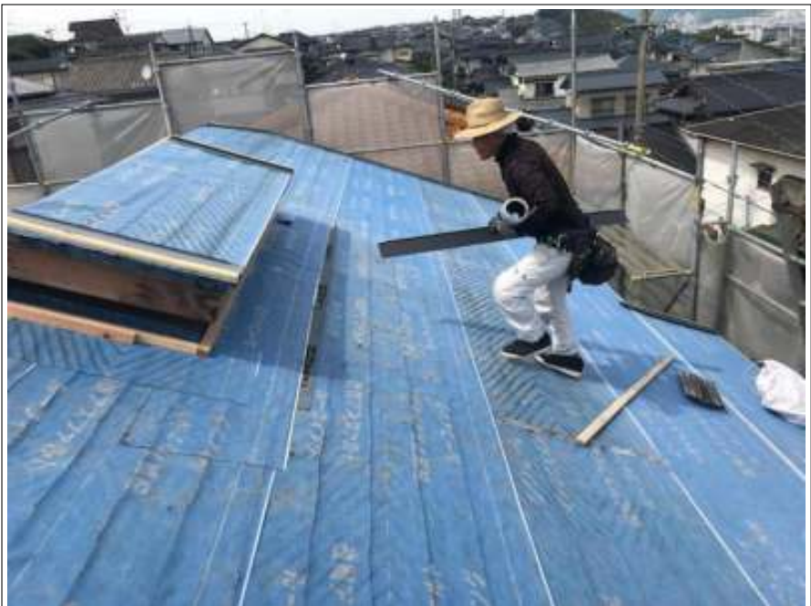
屋根カバー工法 施工
