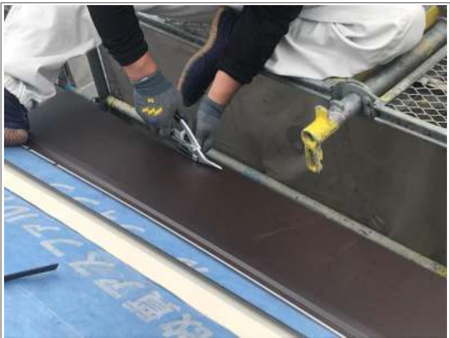
屋根カバー工法 施工
