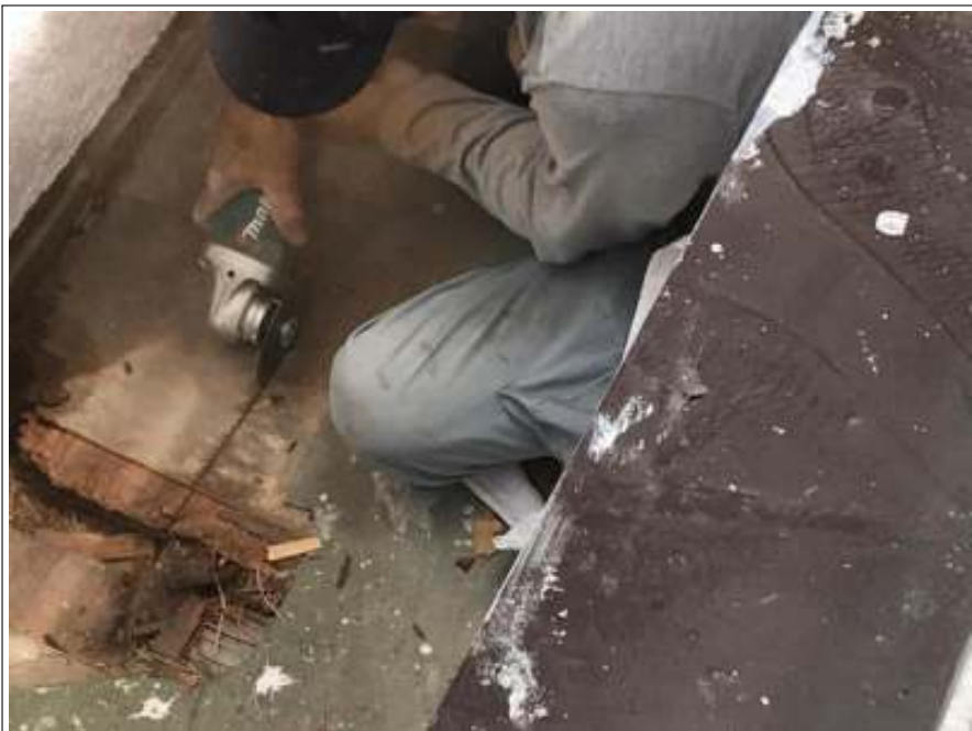
ベランダ 土間工事施工中
