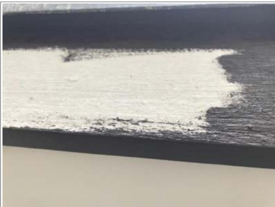
破風板 塗装施工中
