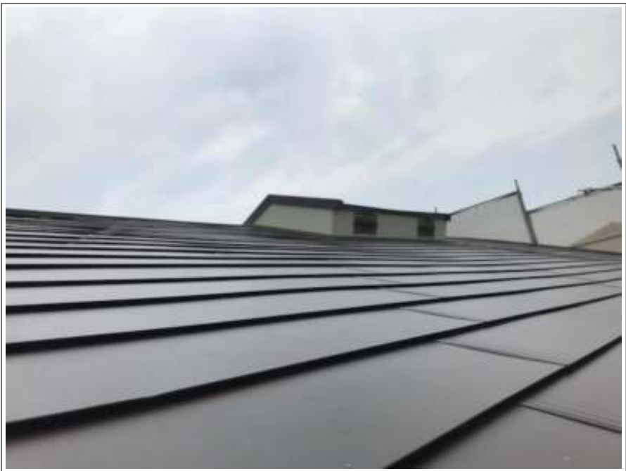
屋根カバー工法 施工後
