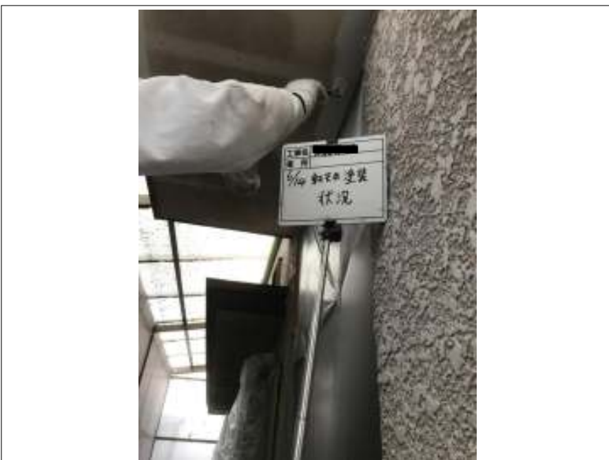
軒天 塗装施工中
