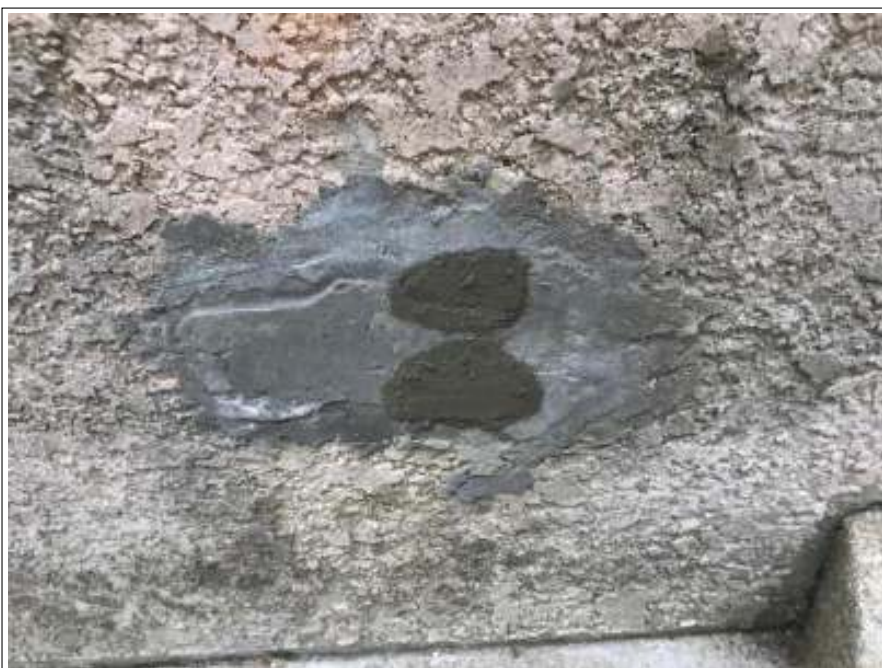
塀・車庫 壁 補修施工完了
