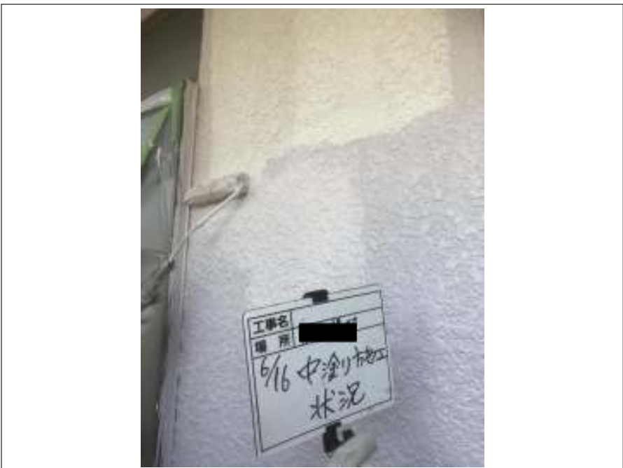
外壁 中塗 施工中
