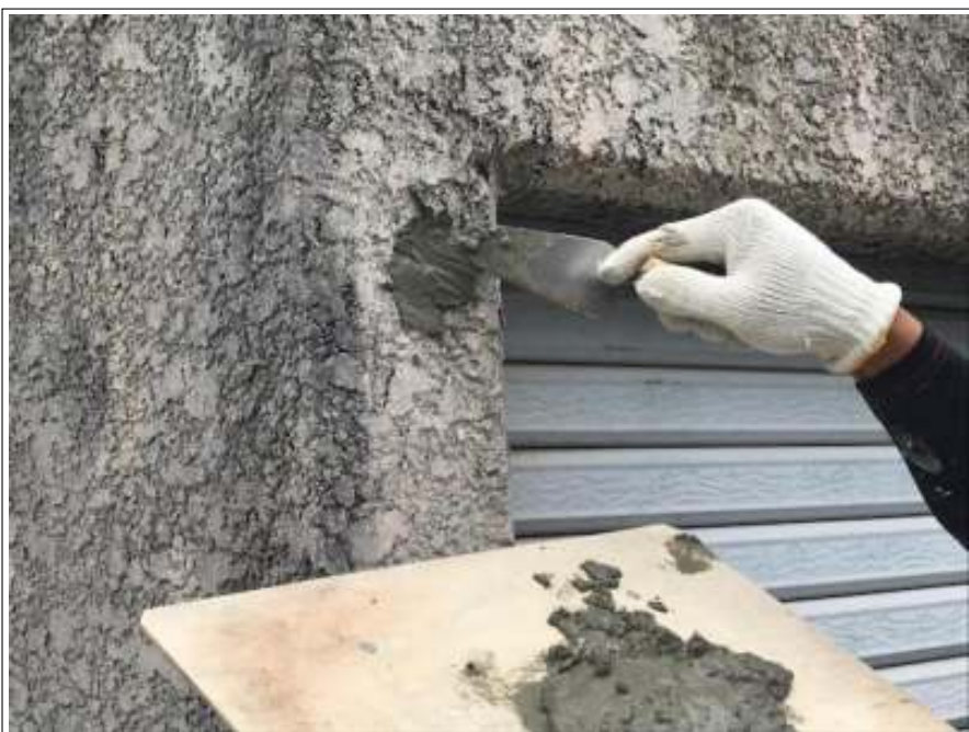
車庫 壁 補修施工中
