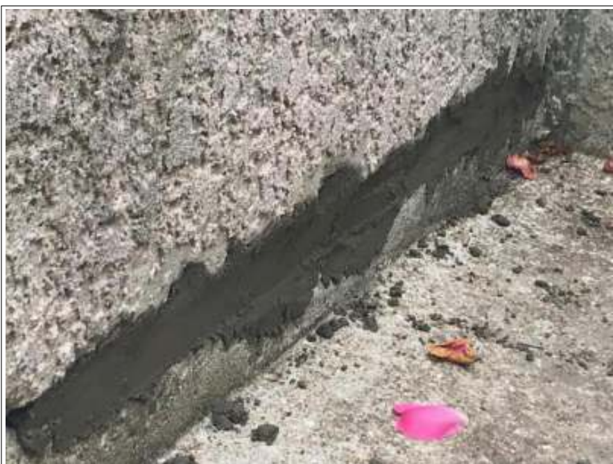
塀 壁 補修施工完了
