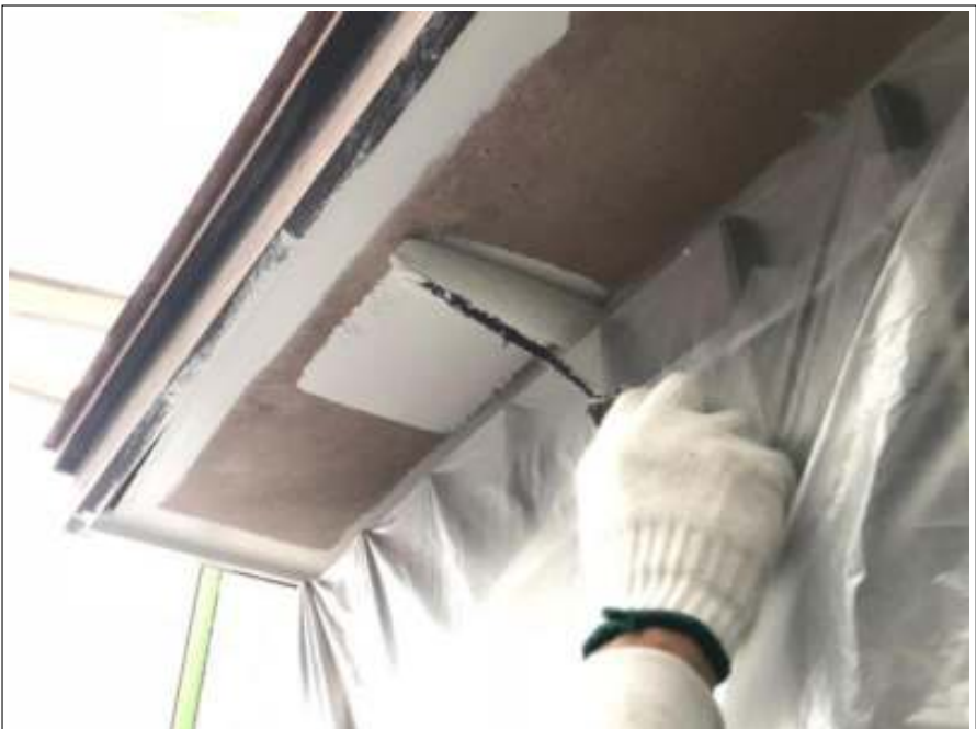
軒天 塗装施工中
