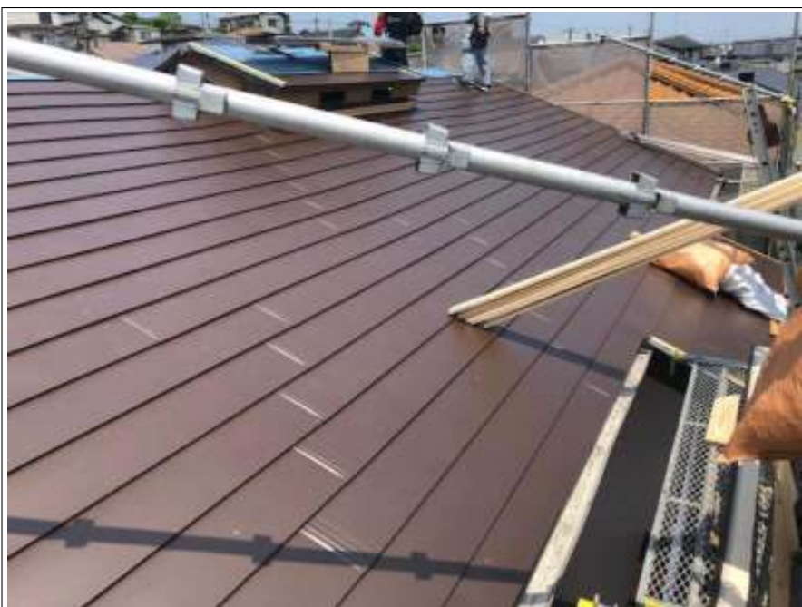
屋根カバー工法 施工
