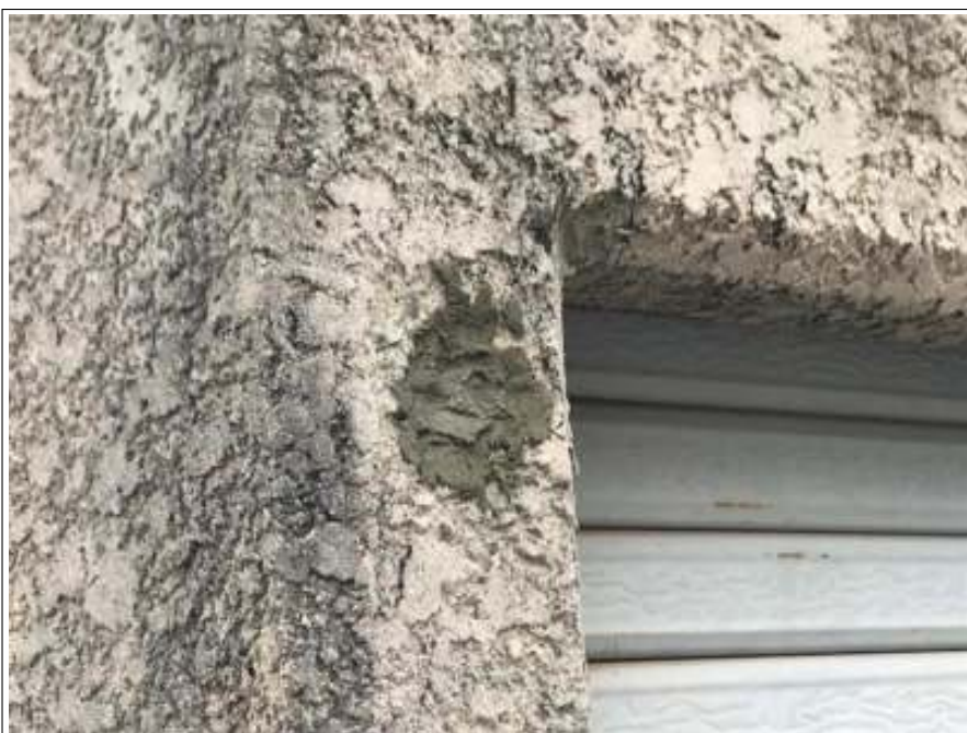
車庫 壁 補修施工完了
