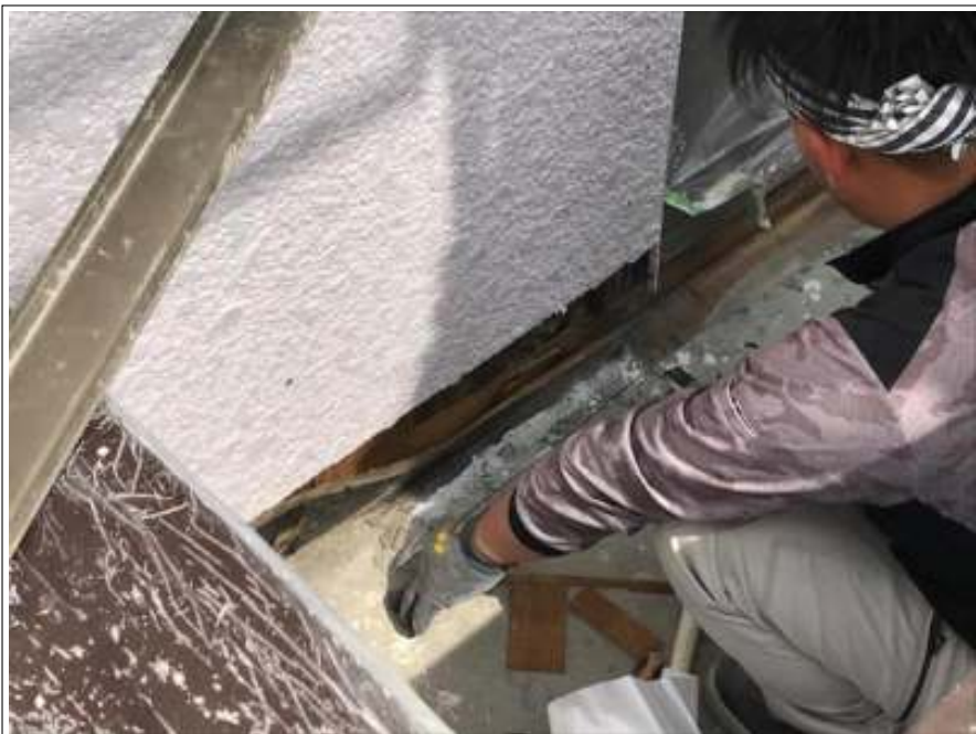
ベランダ 土間工事施工中
