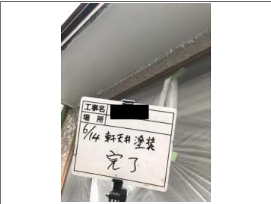
軒天 塗装施工完了
