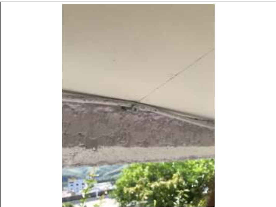
軒天 塗装施工中
