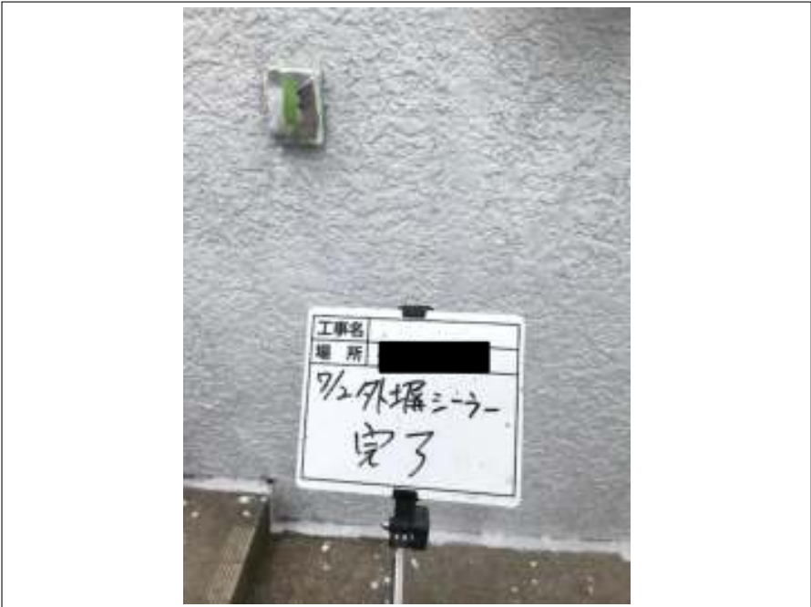
外壁 下塗 施工完了
