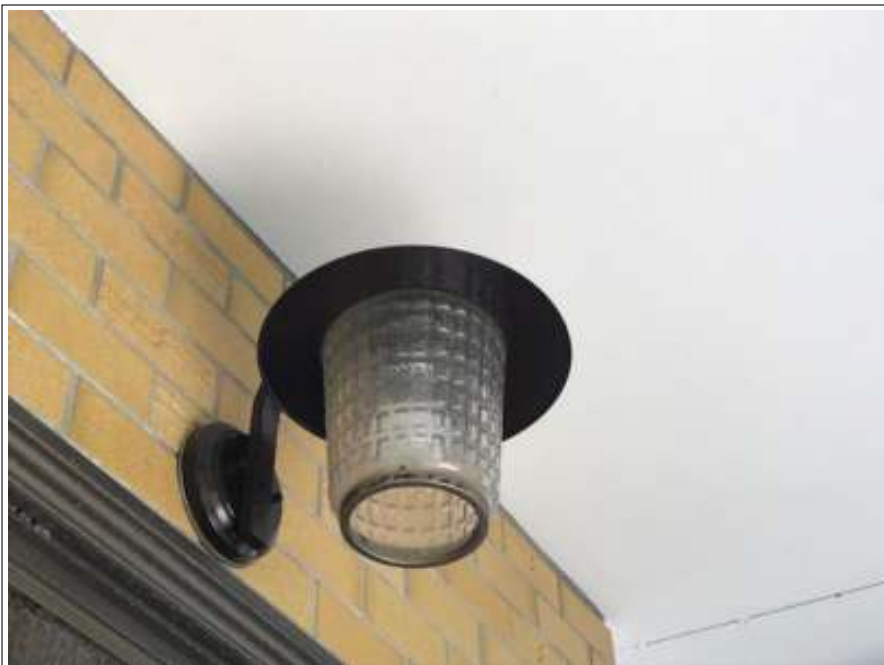
玄関ライト 塗装施工完了
