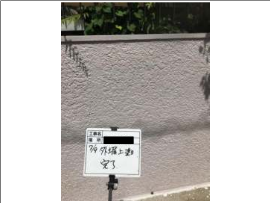
塀 上塗 施工完了
