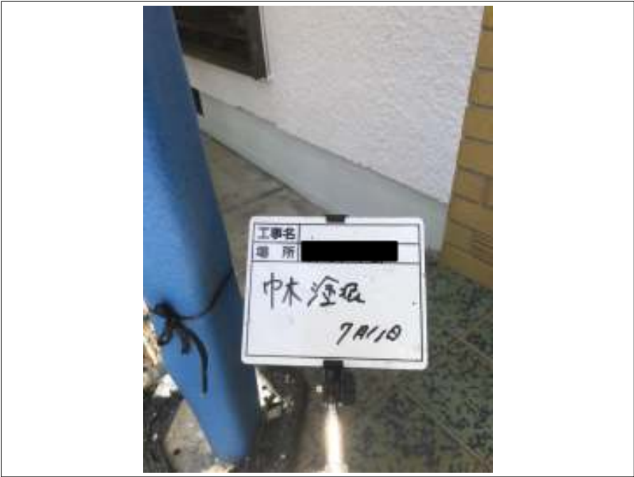
基礎 塗装 施工完了
