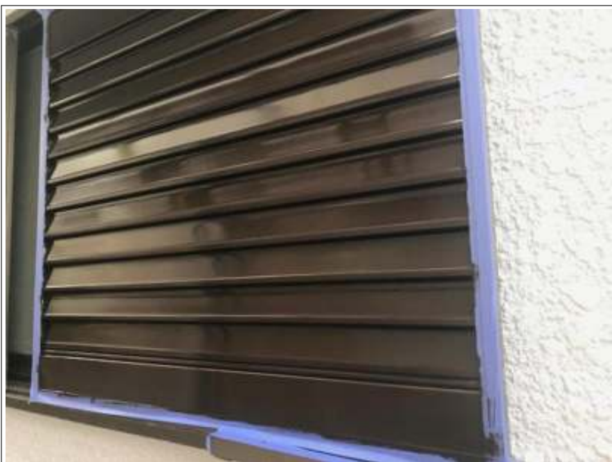
雨戸 塗装完了
