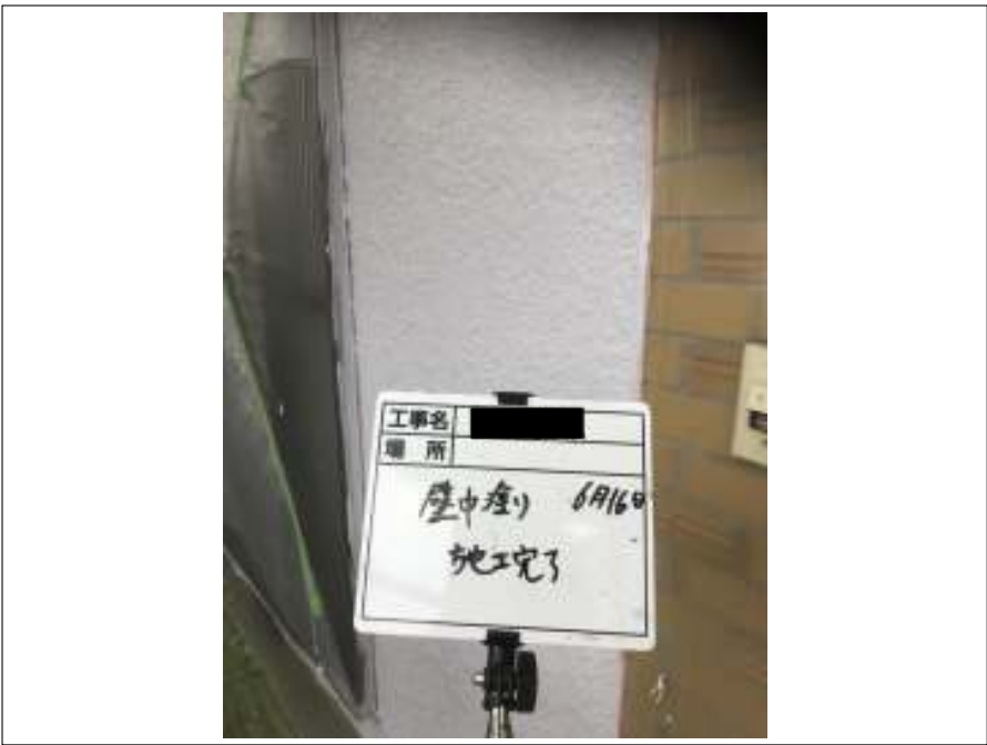
外壁 中塗 施工完了
