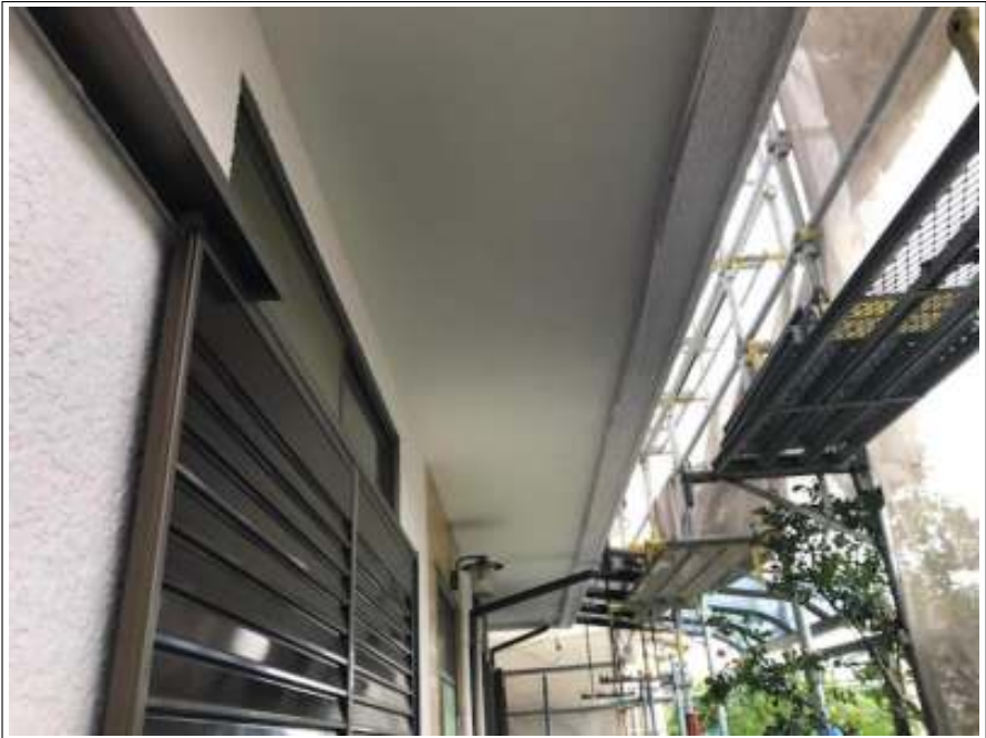
軒天 塗装施工完了
