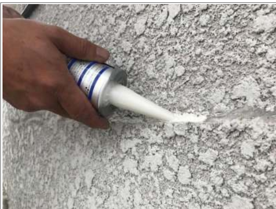
外壁 クラック補修施工中
