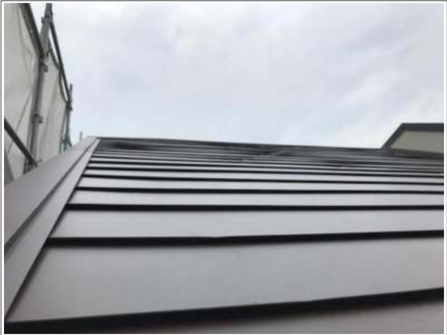
屋根カバー工法 施工後
