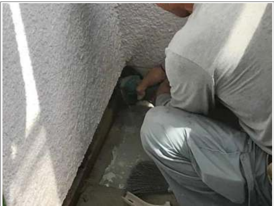
ベランダ 土間工事施工中
