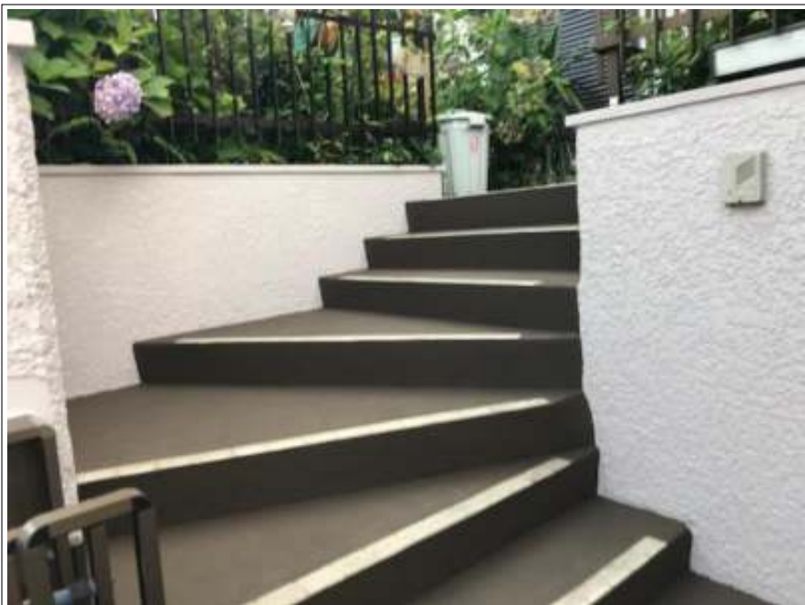
アプローチ 塗装施工完了
