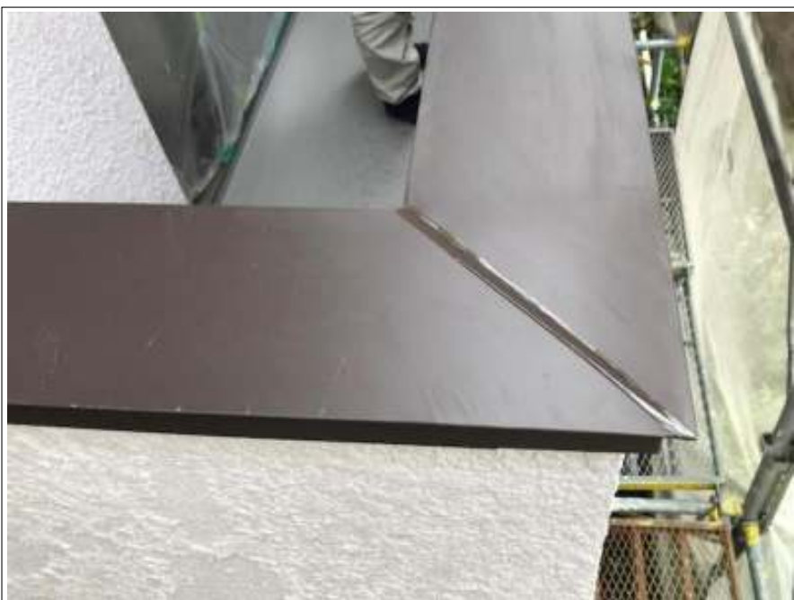
ベランダ 手摺施工完了
