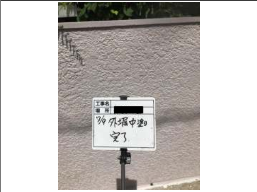
塀 中塗 施工完了
