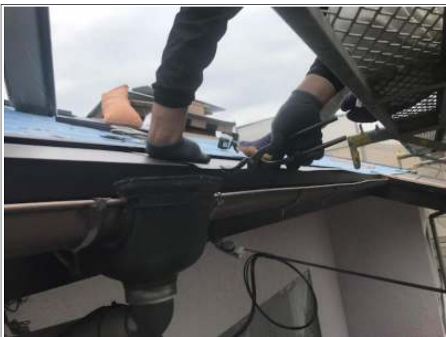
屋根カバー工法 施工
