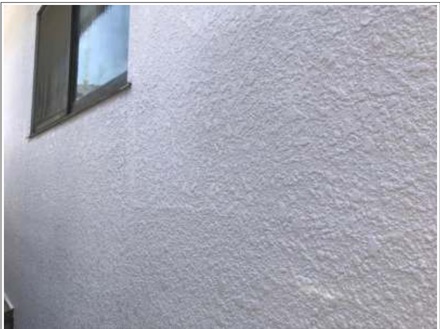
外壁 上塗り 施工完了
