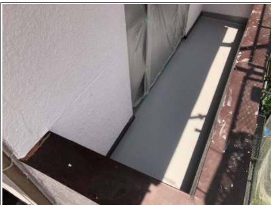
ベランダ 防水工事施工完了
