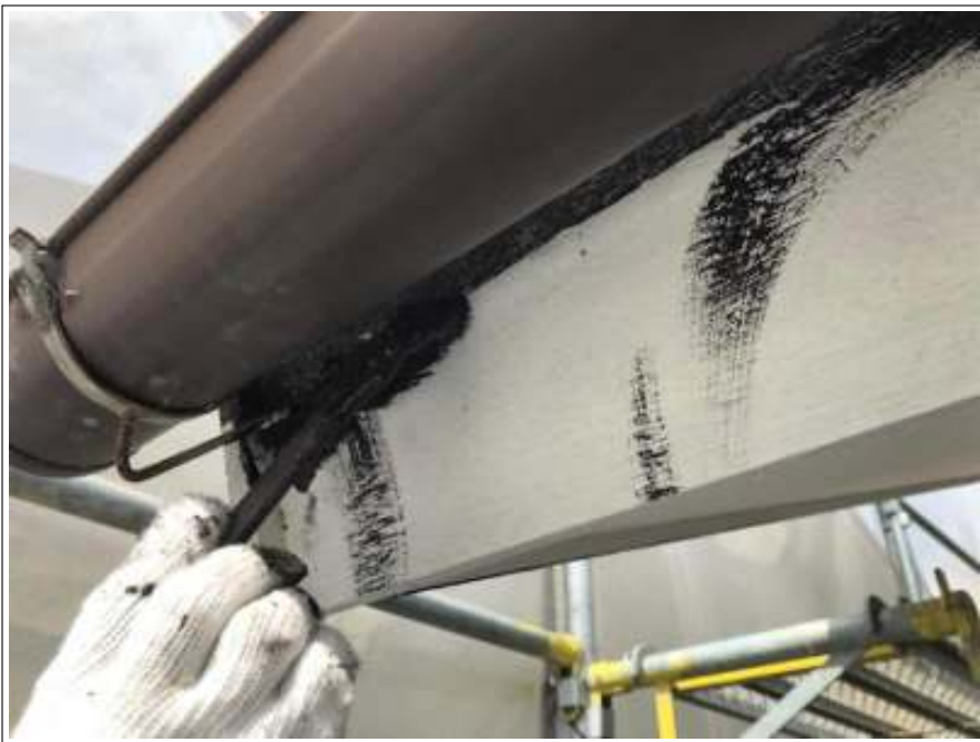
破風板 塗装施工中
