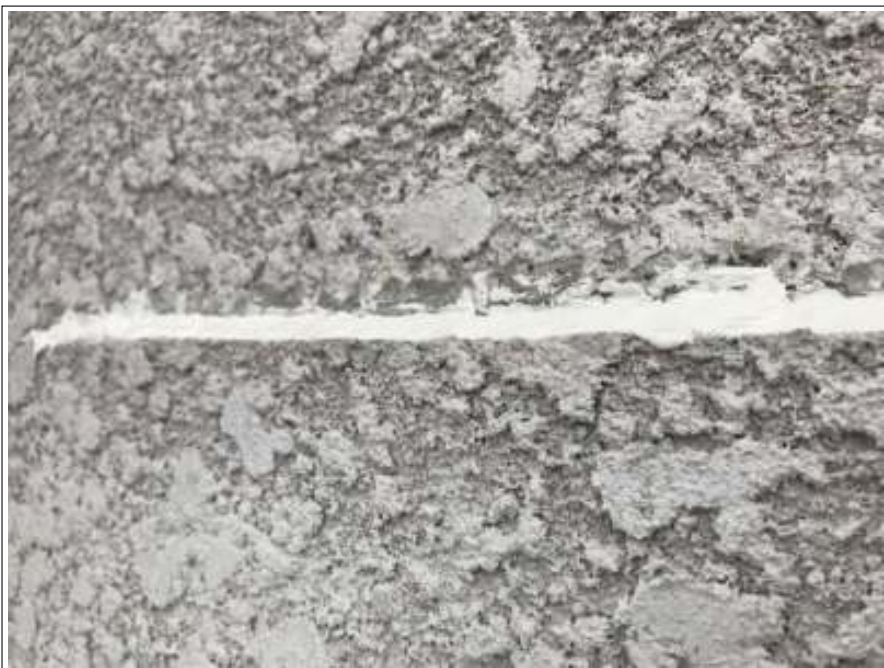
外壁 クラック補修施工完了
