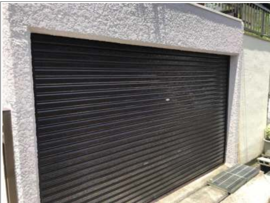
車庫シャッター 塗装完了
