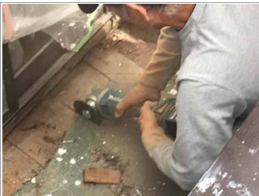
ベランダ 土間工事施工中
