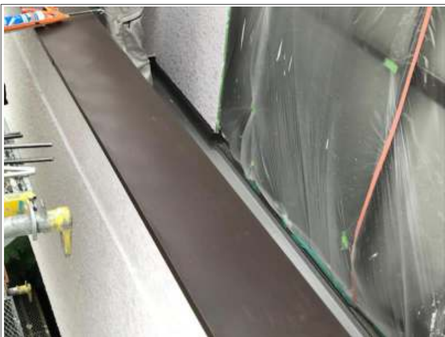
ベランダ 手摺施工中
