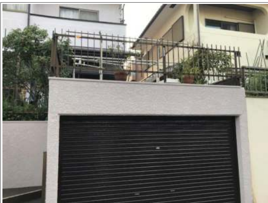
車庫シャッター 塗装完了
