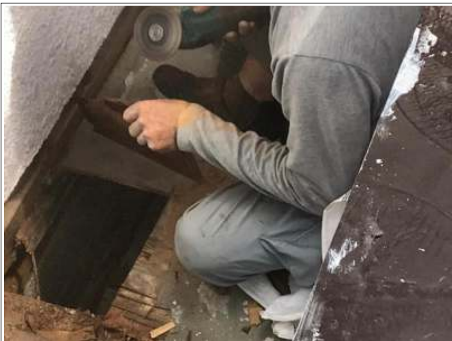
ベランダ 土間工事施工中
