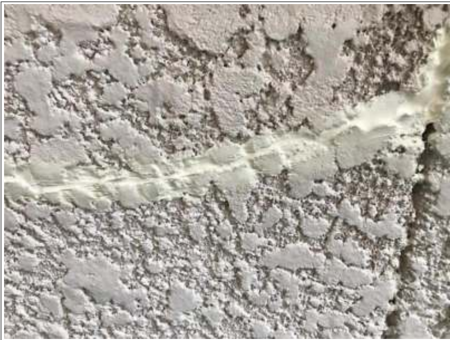
外壁 クラック補修施工完了
