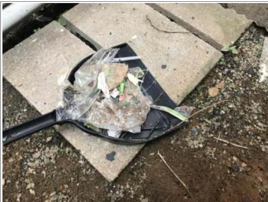
足場解体後 掃除
