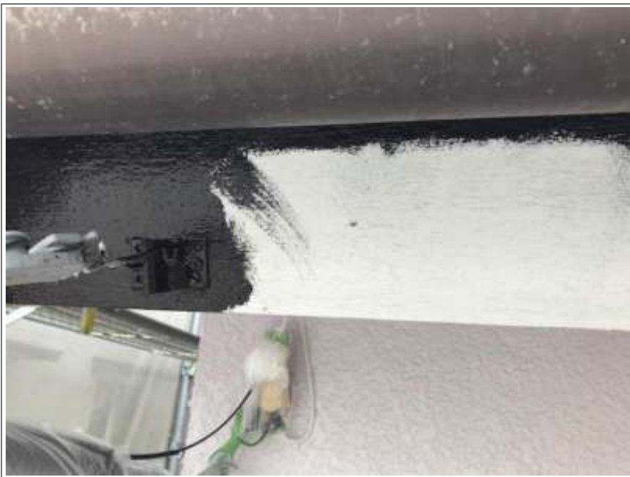
破風板 塗装施工中
