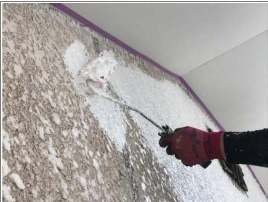
外壁 下塗 施工中
