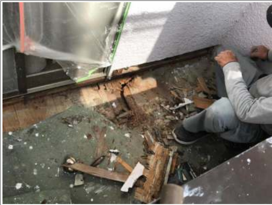
ベランダ 土間工事施工中
