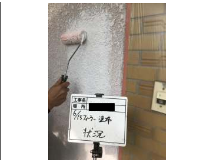
外壁 下地調整 施工中
