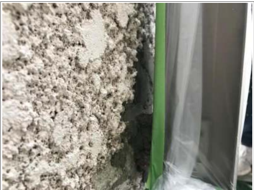
外壁 補修施工完了
