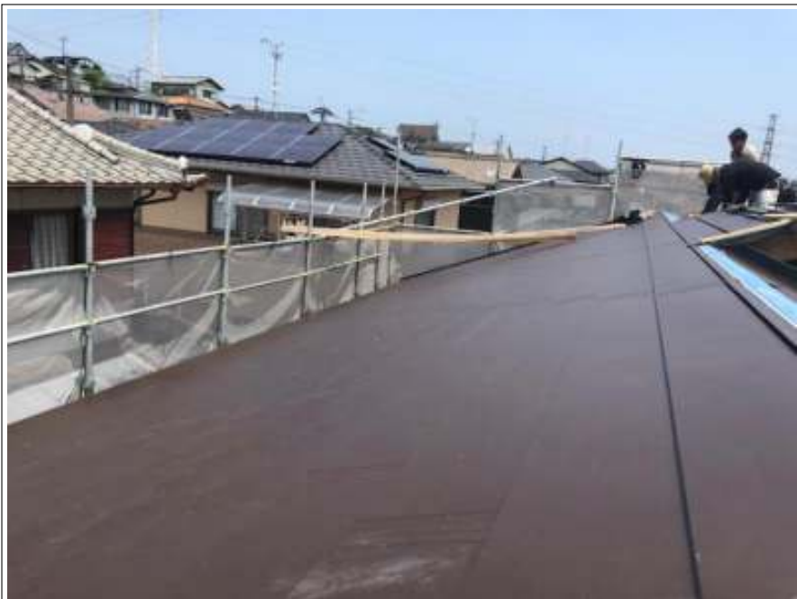
屋根カバー工法 施工
