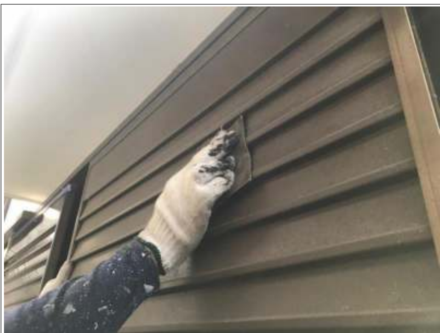
雨戸 ケレン施工中
