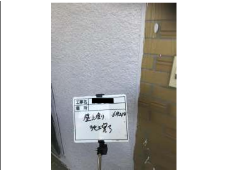
外壁 上塗 施工完了
