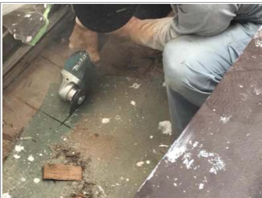
ベランダ 土間工事施工中
