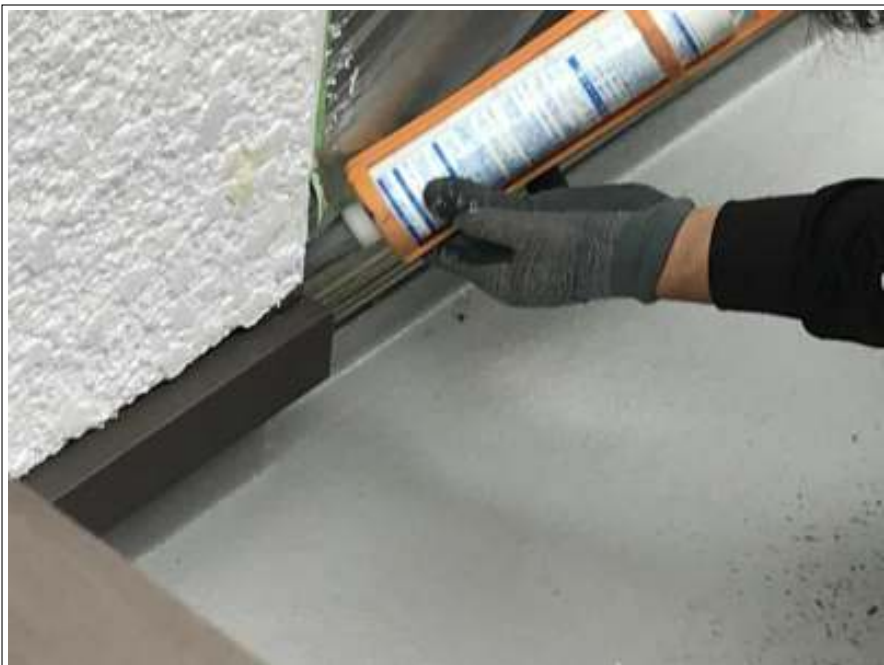
ベランダ コーキング施工中
