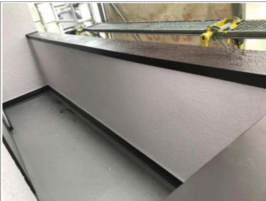
ベランダ手摺 塗装完了
