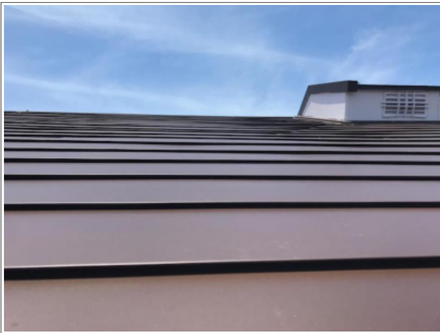
屋根工事完了
