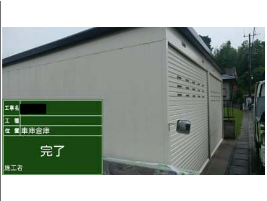
車庫 施工完了
