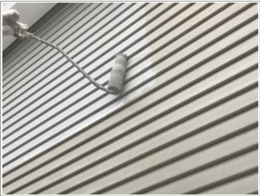
シャッター 下塗り
