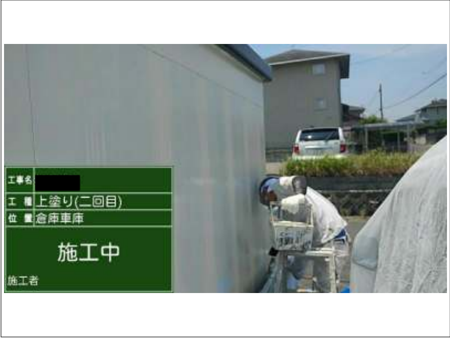
倉庫・車庫 上塗り2回目
