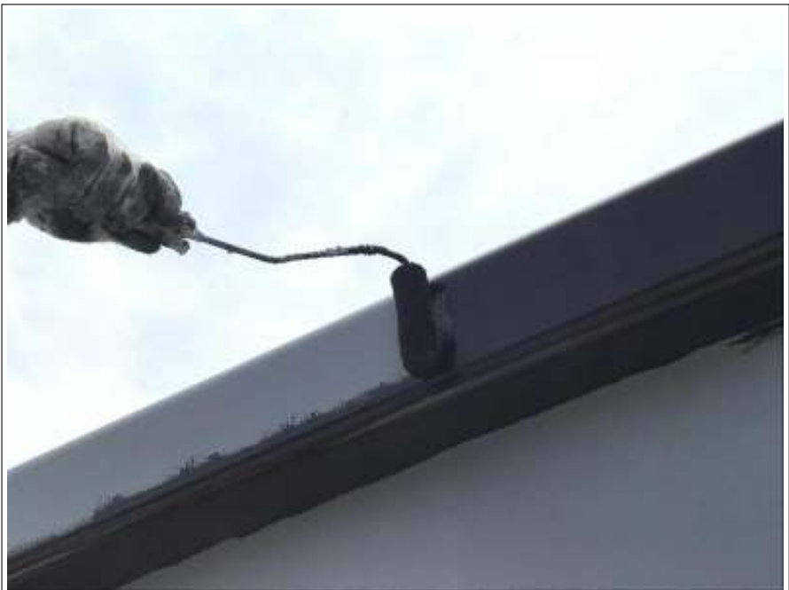
倉庫・車庫 上塗り
