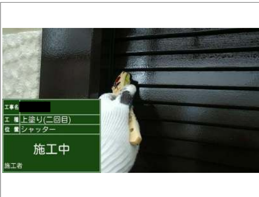
シャッター 上塗り2回目
