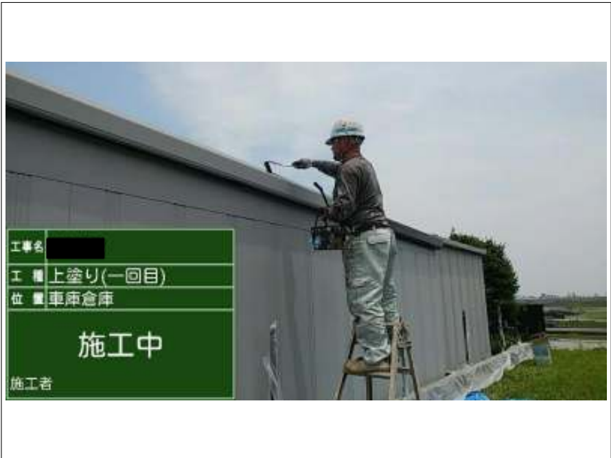
倉庫・車庫 上塗り1回目
