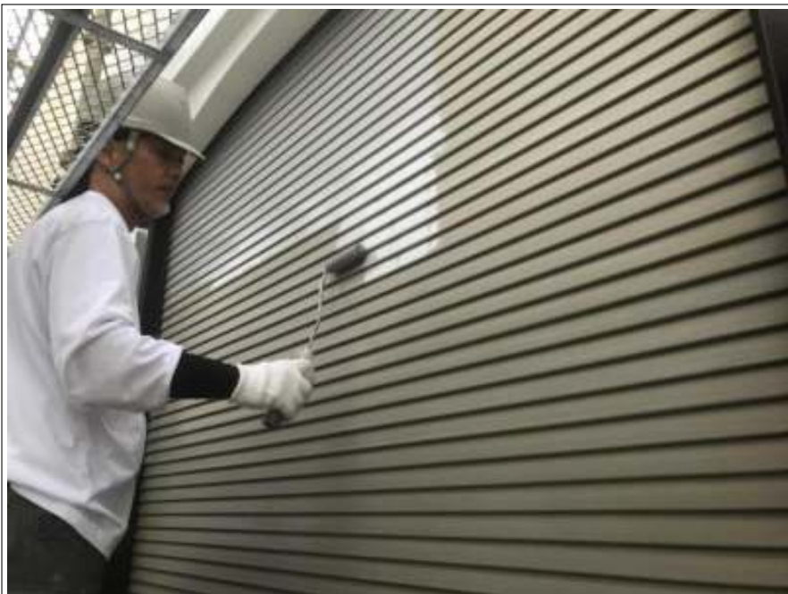
シャッター 下塗り
