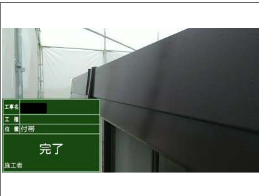
付帯 施工完了
