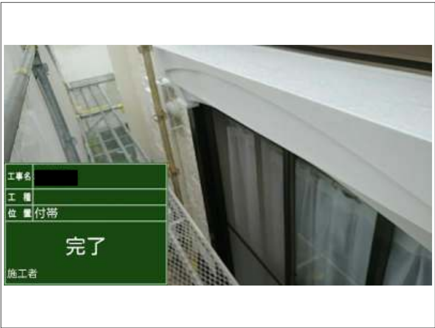
付帯 施工完了
