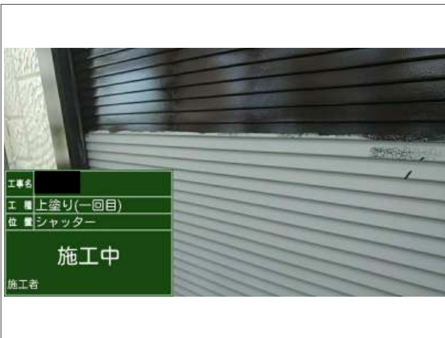
シャッター 上塗り1回目
