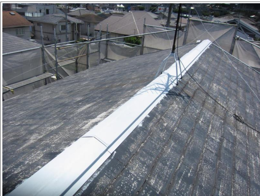
屋根 板金 錆止め
