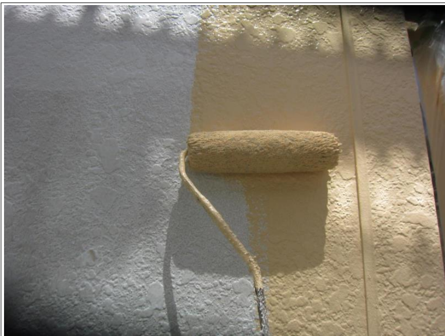
1階外壁 中塗り
