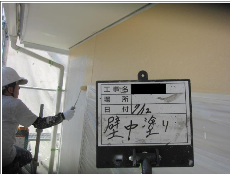
1階外壁 中塗り
