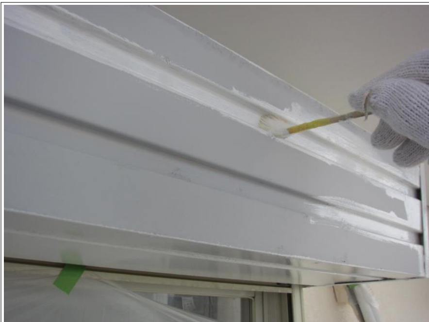
シャッターBOX 上塗り
