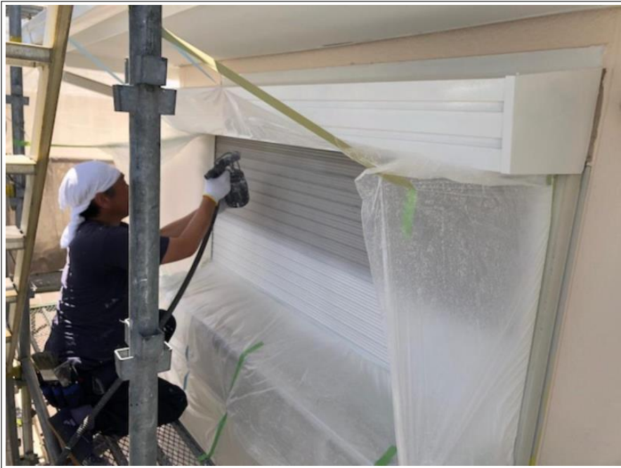
シャッター 塗装
