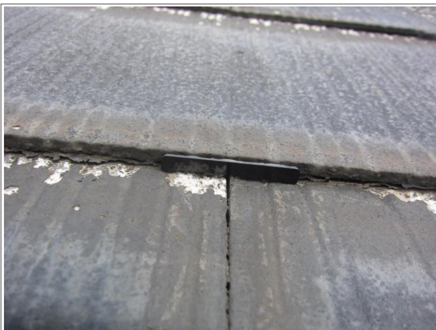
屋根 タスペーサー取付
