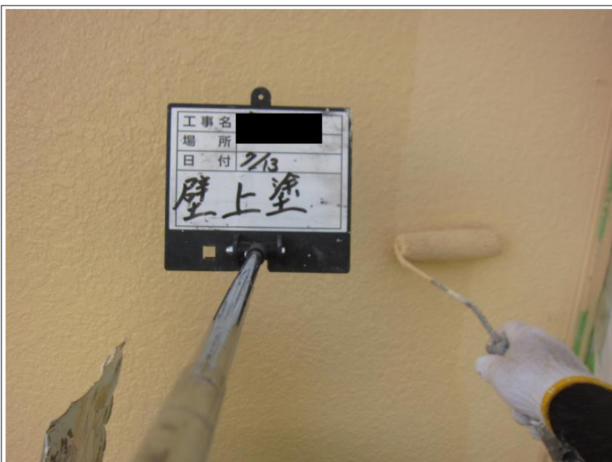
1階外壁 上塗り
