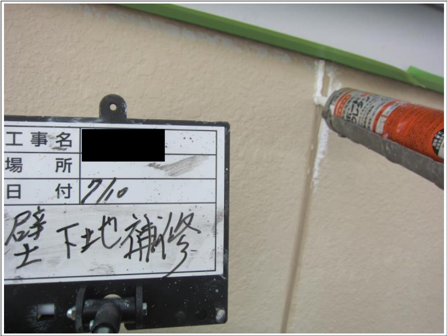
外壁 下地補修
