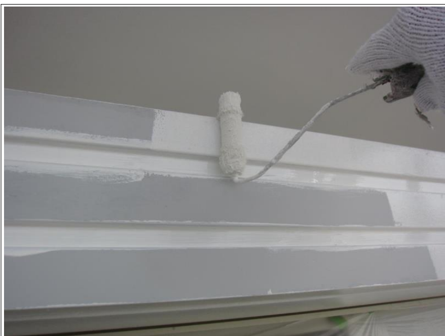
シャッターBOX 上塗り
