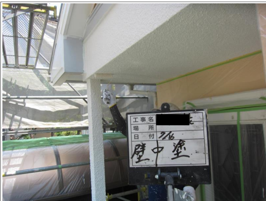
玄関外壁 中塗り
