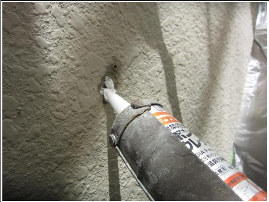
外壁 下地補修
