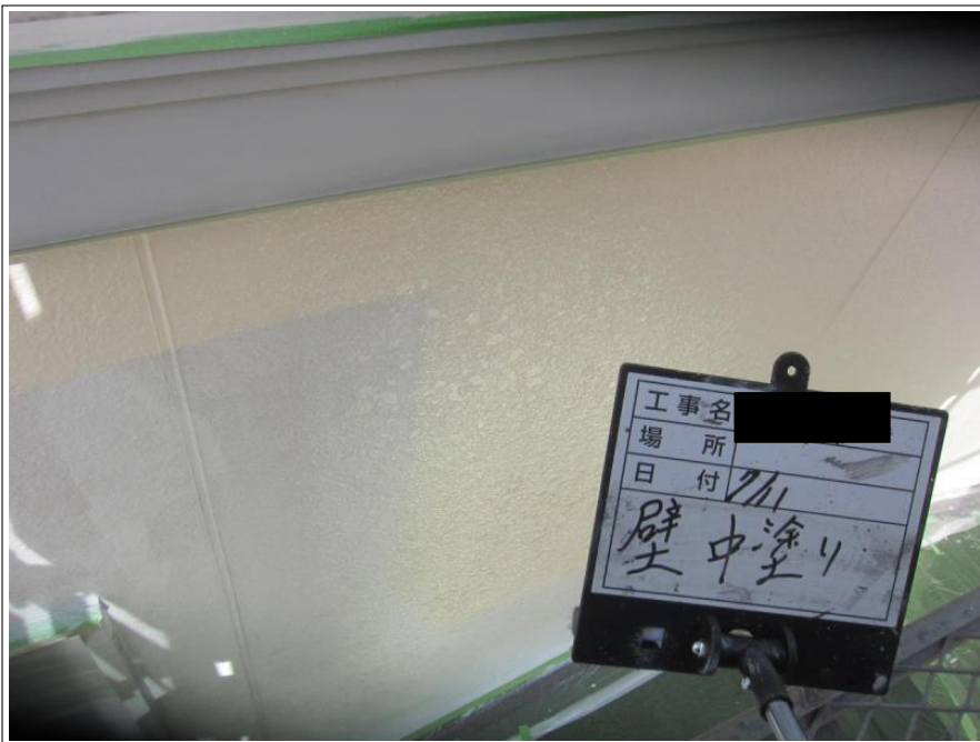
2階外壁 中塗り
