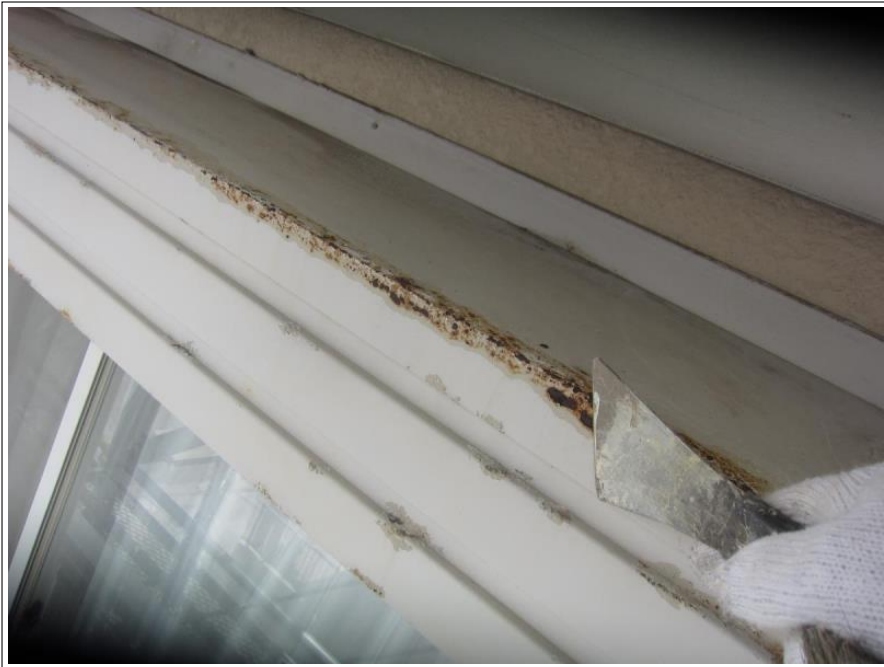
シャッターBOX ケレン
