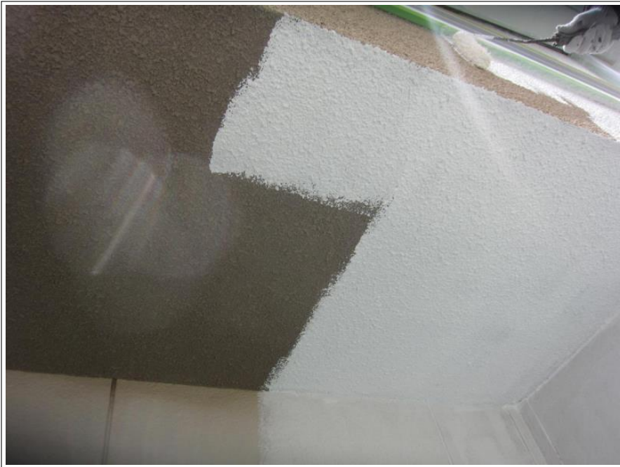
玄関外壁 下塗り
