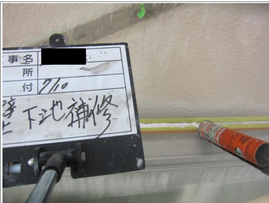
外壁 下地補修
