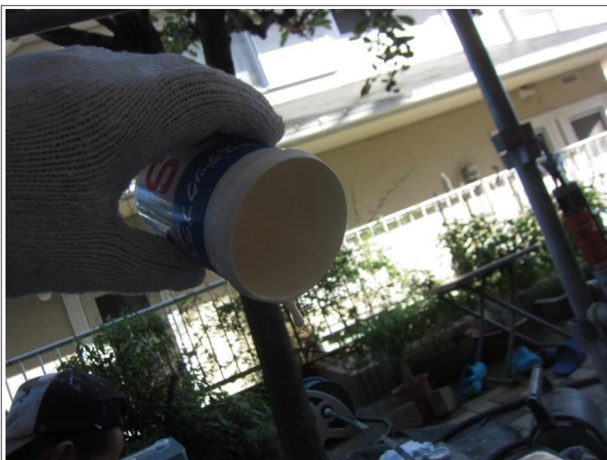
外壁 防カビ上塗り
