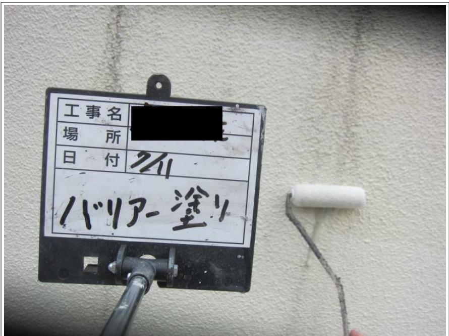
外壁 防カビ下塗り
