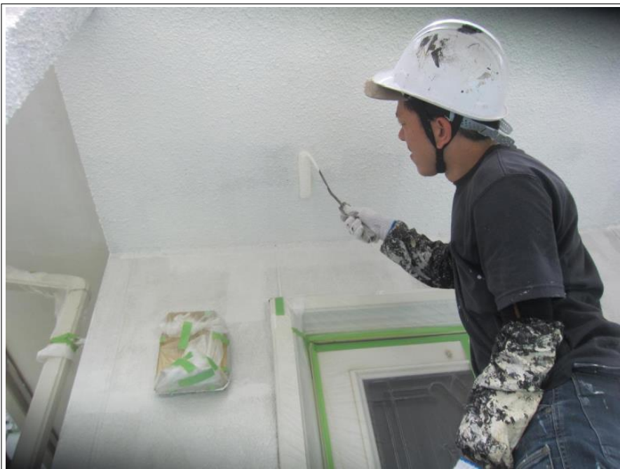
玄関外壁 下塗り
