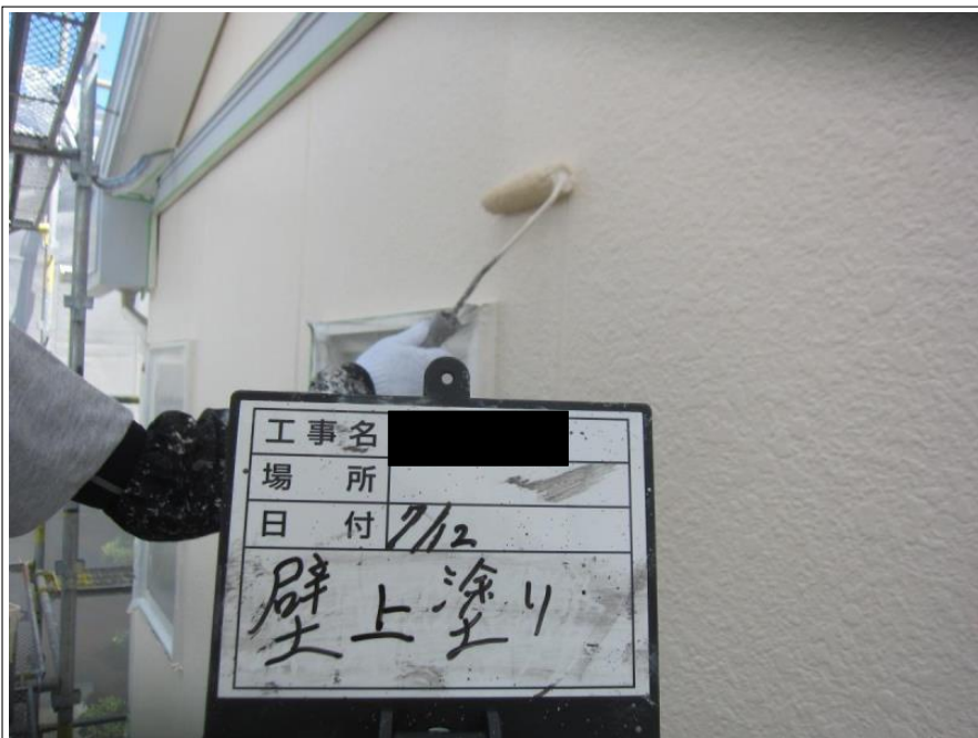
2階外壁 上塗り
