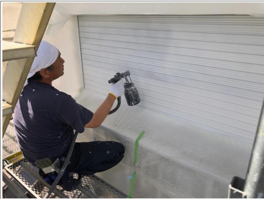
シャッター 塗装
