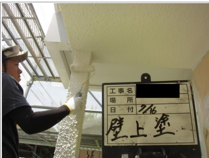
玄関外壁 上塗り
