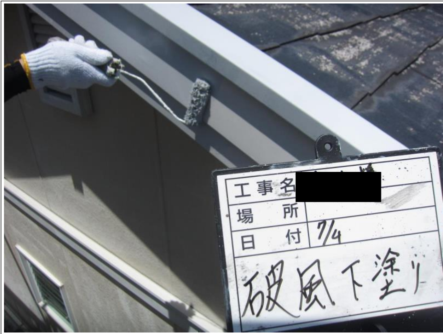
破風 錆止め下塗り
