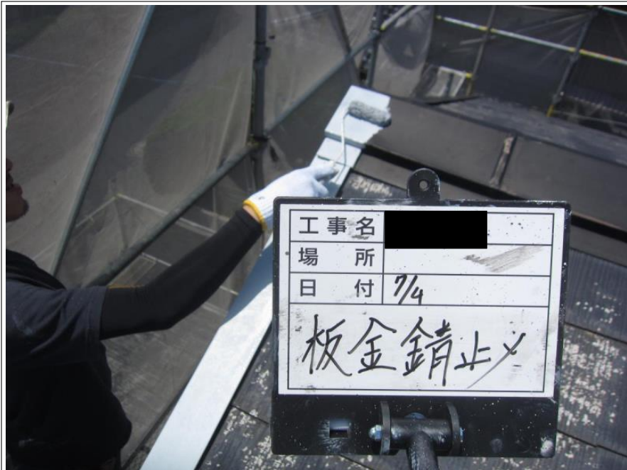
屋根 板金 錆止め
