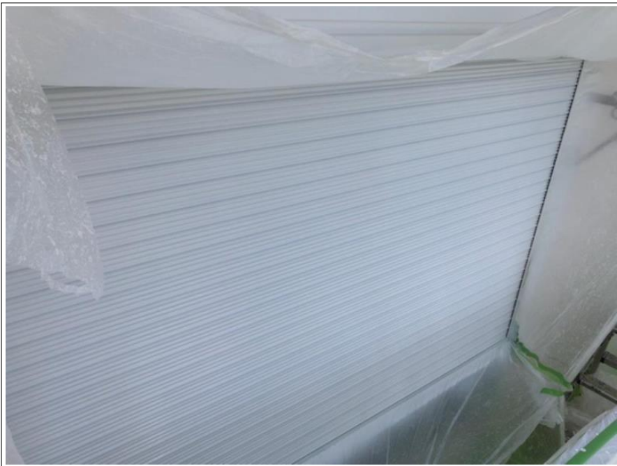
シャッター 塗装完了
