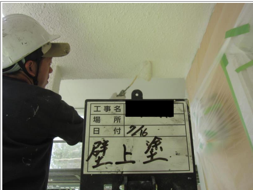
玄関外壁 上塗り
