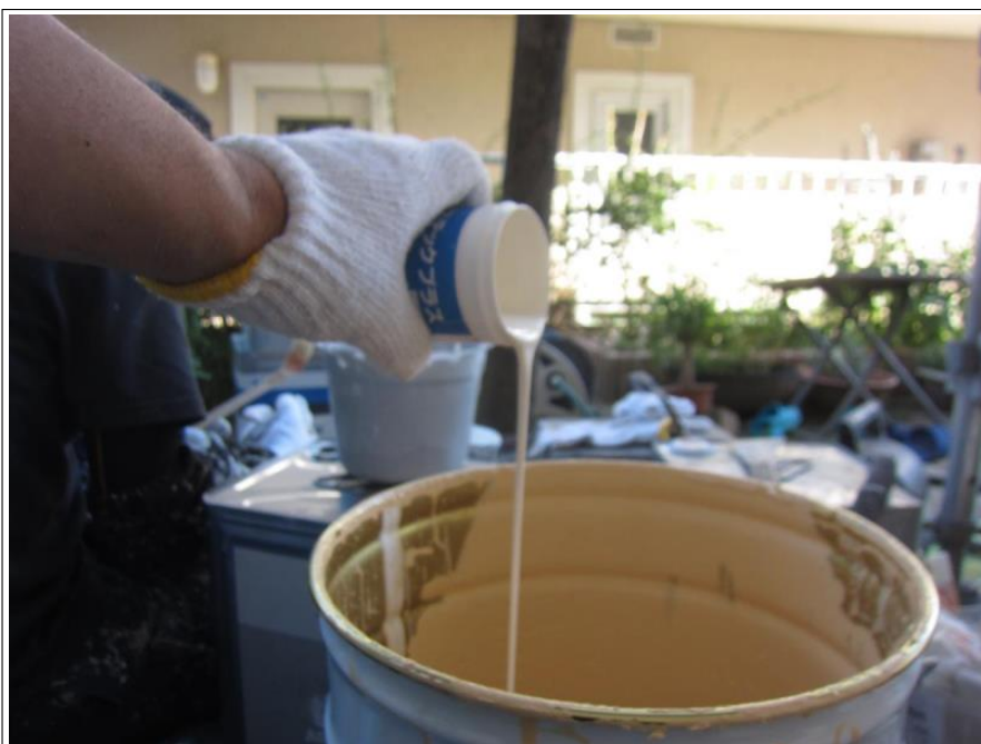
外壁 防カビ上塗り
