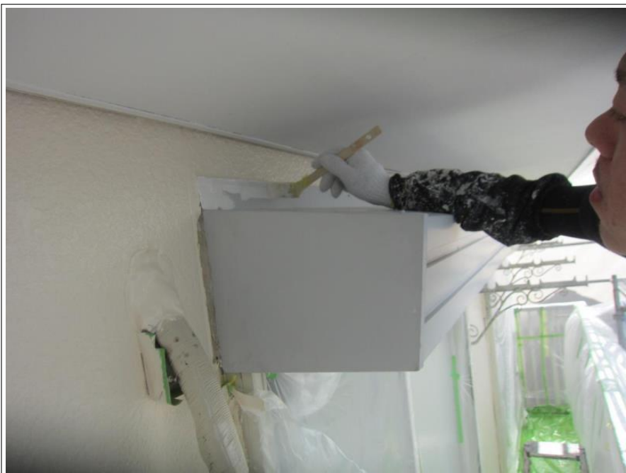
シャッターBOX 上塗り
