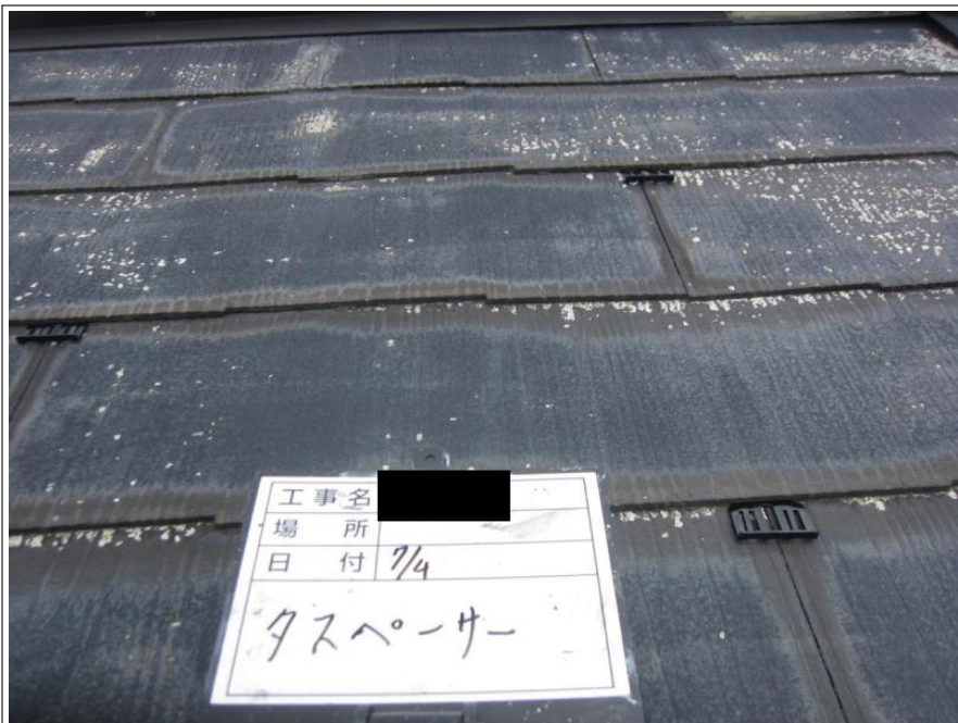
屋根 タスペーサー取付
