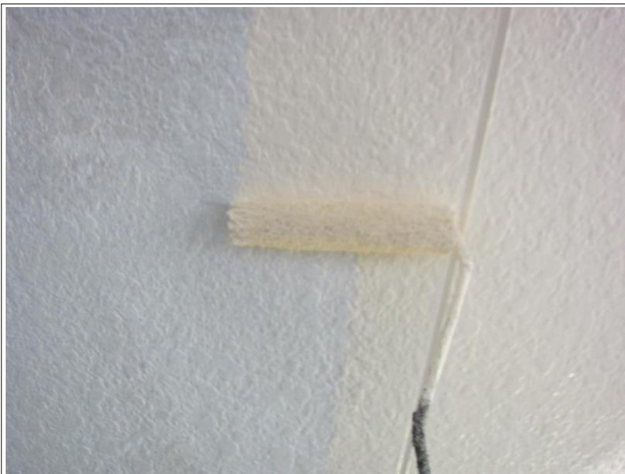
2階外壁 中塗り
