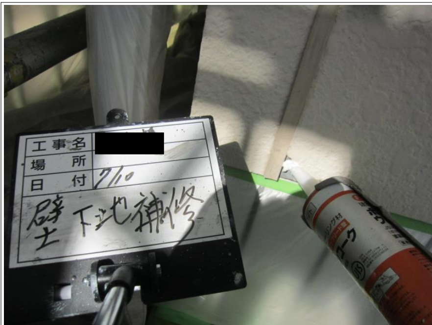
外壁 下地補修
