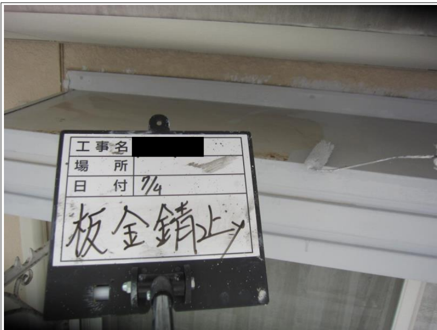
シャッターBOX 錆止め
